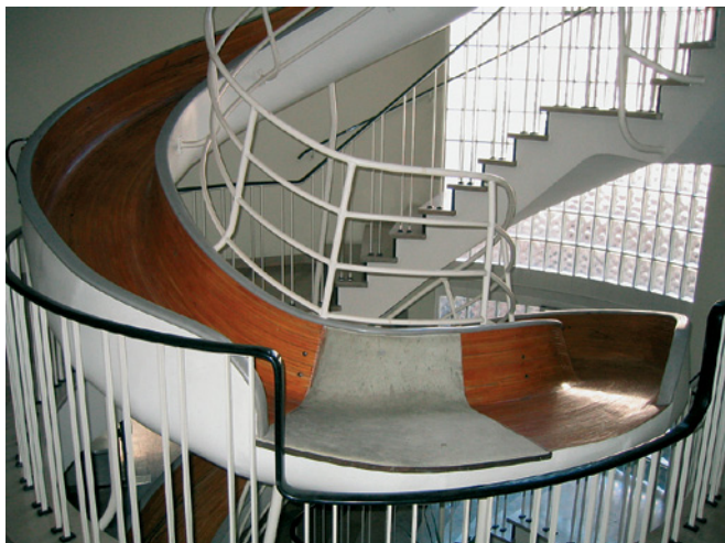
Abb. 5-24: Treppenhaus mit Notfallrutsche
