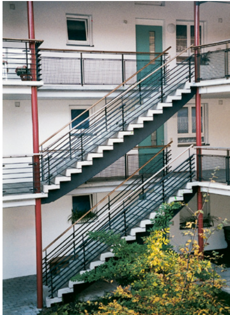
Abb. 5-26: Außentreppen (Winkelstufen) in einer Wohnanlage, Stufen nicht unterschritten
