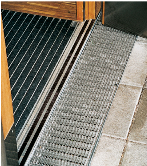
Abb. 5-62: Zugang mit Drainrost und Magnetschiene; für Rollstuhlbenutzer gut geeignet
