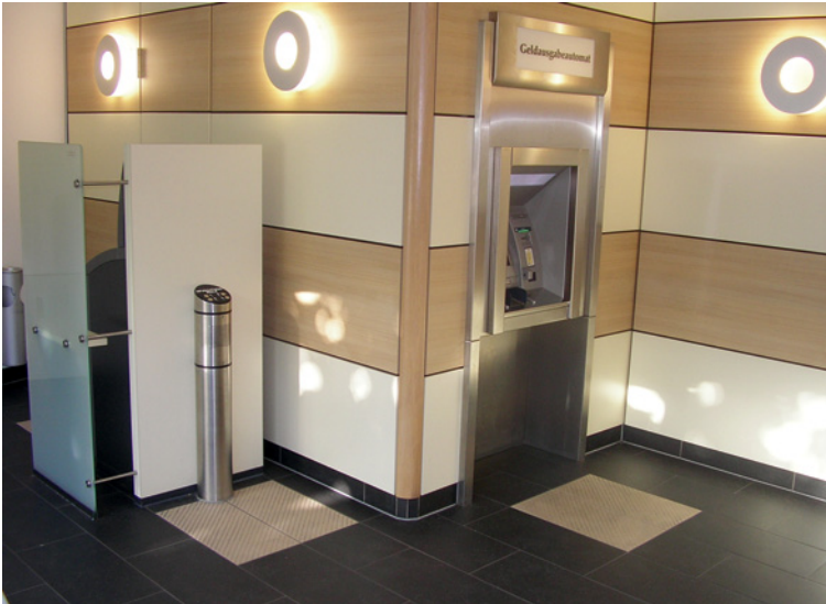
Abb. 5-86-2: Informationssäule mit Sprachausgabe einschließlich baulich abgesetzt - unterfahrbar gestalteter Geldautomat - durch taktil und kontrastreiche Bodenelemente leicht erkennbar
