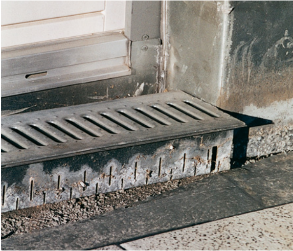
Abb. 5-58: Einlaufrinne als Schlitzrinne mit seitlichem Spritzschutz im aufgehenden Wandbereich ausgebildet
