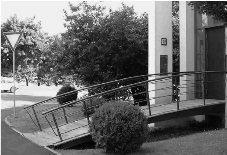
Abb. 5-32: Gebogene Rampe zur Erschließung eines Neubaus, Stahlkonstruktion mit Holzbelag
