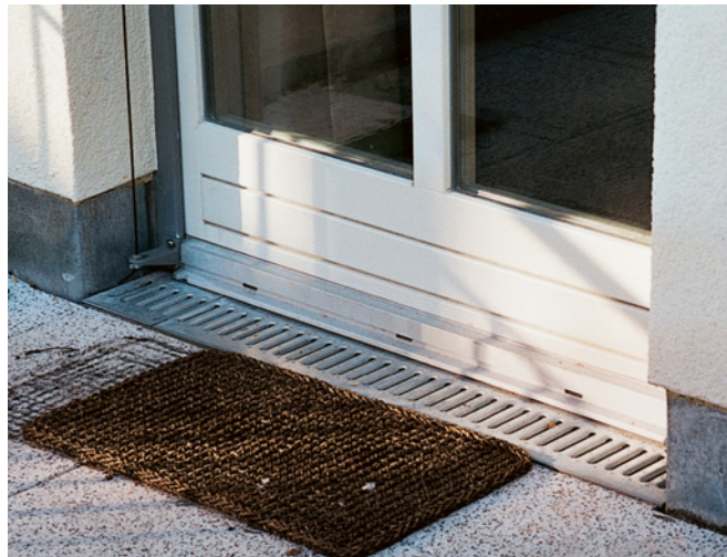
Abb. 5-57: Terrassentür mit Einlaufrinne, 5 cm Anschlag; für Rollstuhl bedingt geeignet
