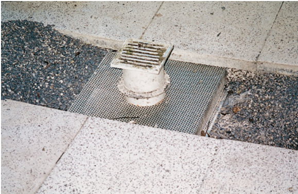
Abb. 5-59: Flächeneinlauf mit Gitterrost gegen »zusetzen« mit Kies geschützt
