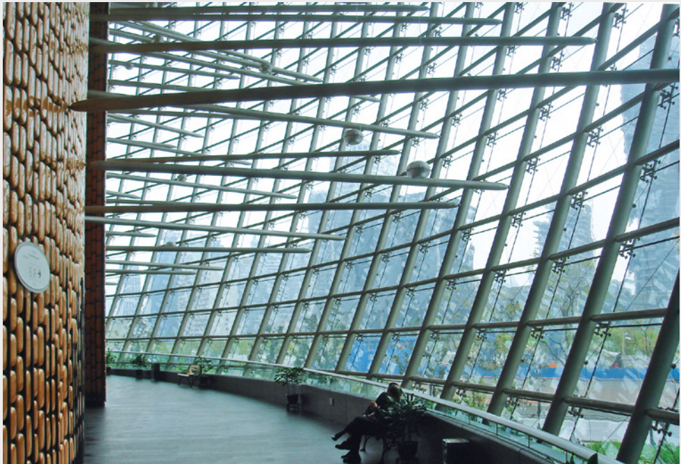
Abb. 82: Punktförmig gelagerte Isolierverglasung in China. Architekt: Gérard Andreu ADP
