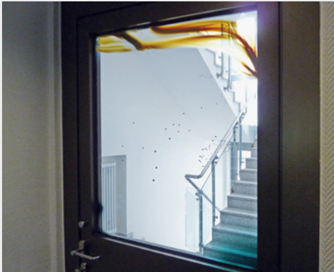
Abb. 112: Brandschutzglas mit Verfärbung durch UV-Strahlung
