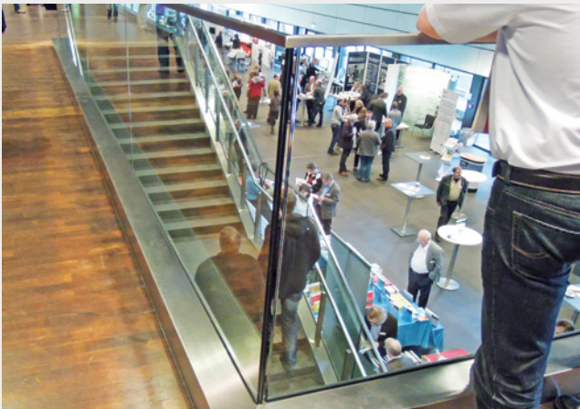
Abb. 93: Ungeschützte Glas- kante an einer Geländerecke
