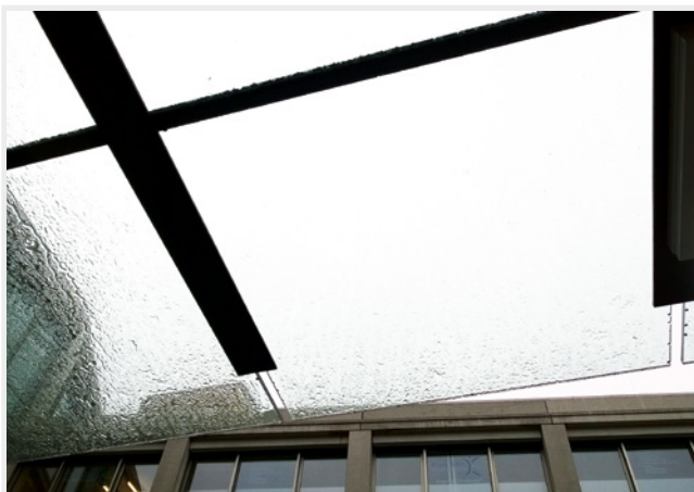
Abb. 76: Auskragung eines VSG über die Lagerung hinaus
