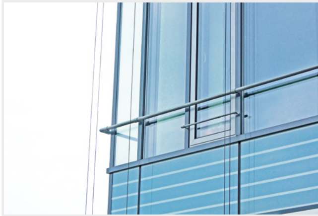
Abb. 97: Absturzsichernde Glasecke ohne Pfosten, zweiseitig gelagert, Holm außen (Architekten ARP)
