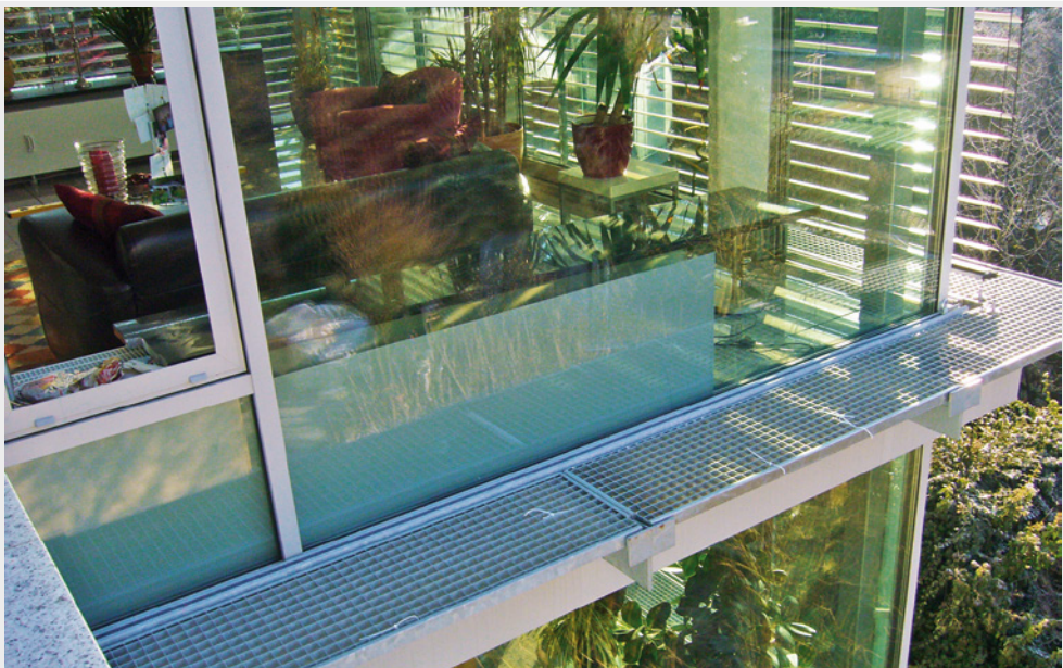
Abb. 68: Diese Teilbeschichtung muss zum Sprung durch Temperaturunterschied entlang der Grenze der grauen Beschichtung führen
