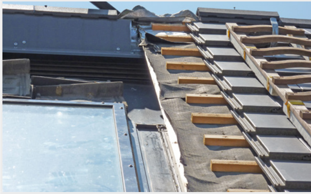
Abb. 59: Unterdach und zweite Entwässerungsebene finden nicht zueinander
