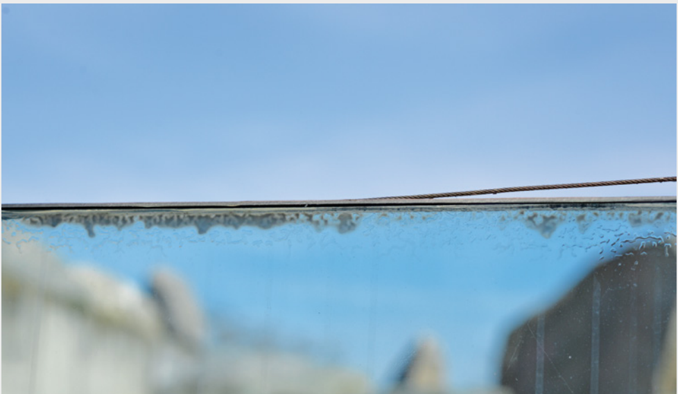
Abb. 14: Erosion einer Brüstung aus VSG
