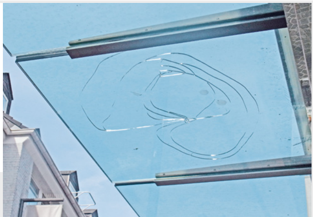
Abb. 79: Überkopfverglasung aus VSG aus Float nach dem Aufprall einer Last
