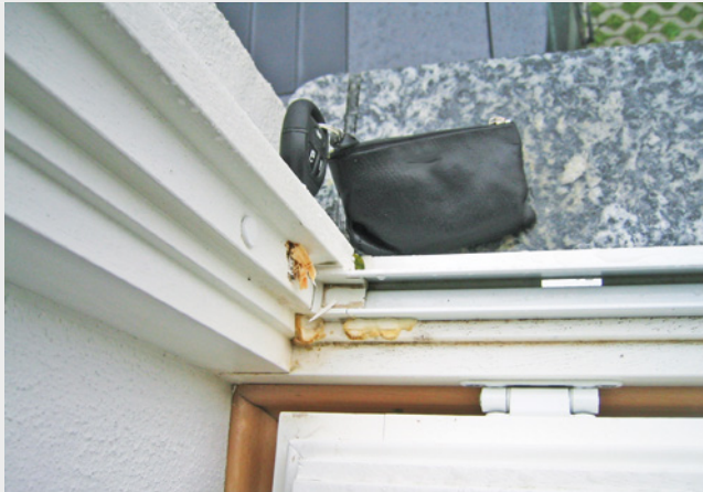
Abb. 54: Pilze sprießen in der Fensterecke
