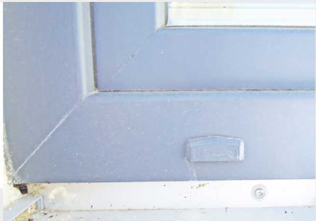
Abb. 49: Entwässerung eines Kunststofffensterprofils
