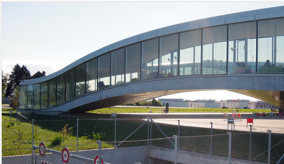
Abb. 90: Absturzsichernde Verglasung, vierseitig gelagert, nicht rechteckiger Zuschnitt. Bibliothek ETH Lausanne (Architekten Sanaa). Abweichungen von der Rechteckform sind in begrenzter Weise genormt.
