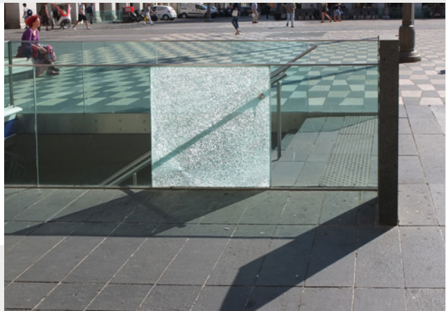
Abb. 18: VSG aus ESG beweist als Vertikalverglasung ausreichende Resttragfähigkeit
