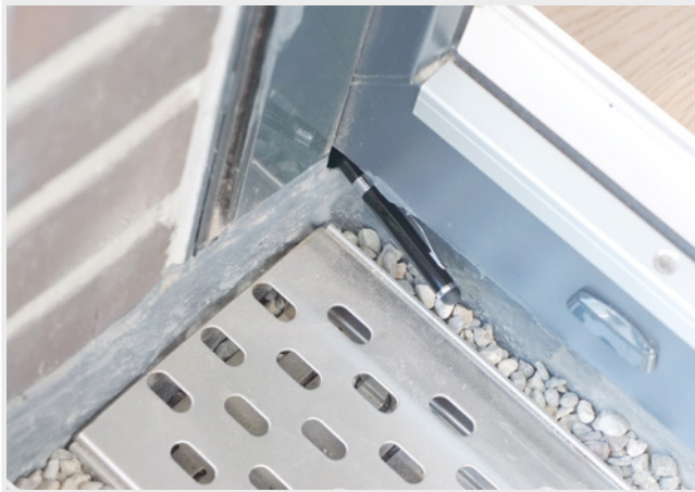
Abb. 28: Gewerkelücke: Wo der Kuli steckt, kann auch Wasser reinlaufen
