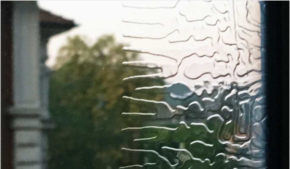
Abb. 13: Ausgelaufene Verbundschicht eines Verbundglases [Quelle: Dilanas]
