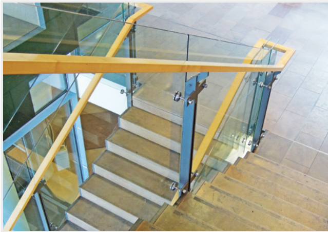
Abb. 96: Glasgeländer punktbefestigt ohne Randholm
