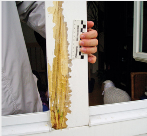
Abb. 21: Nach nur 2 Jahren verrottetes Splintholz an einem Fenster
