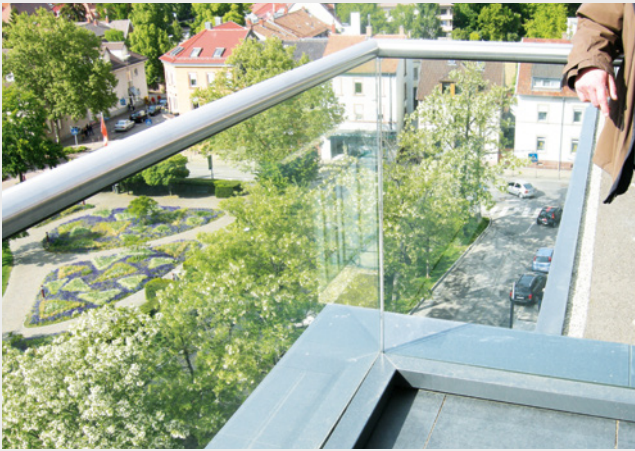
Abb. 92: Ungeschützte Glas- kante an einer Geländerecke außerhalb der Norm
