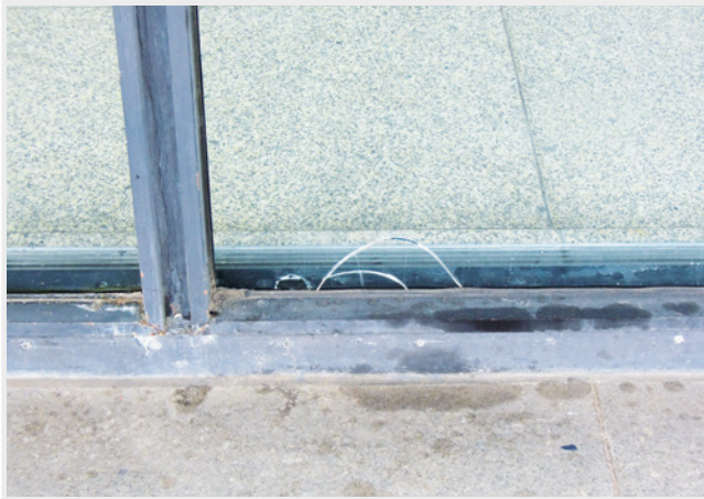
Abb. 70: Bruch an der Glaskante nach Korrosion des Rahmenmaterials
