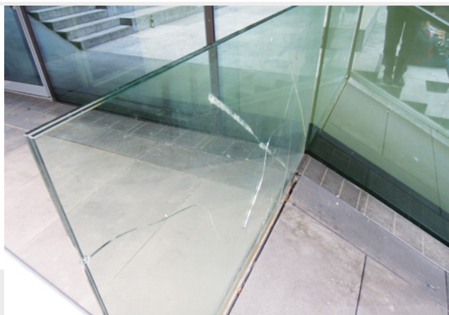
Abb. 5: Versagende Glasbrüstung
