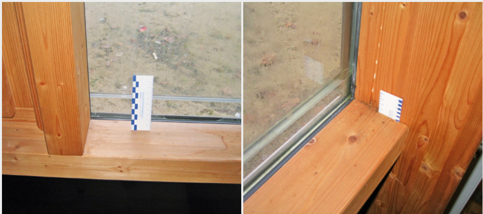
Abb. 45: Wasser im Scheibenzwischenraum eines Isolierglases
