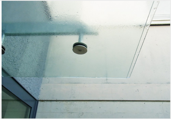
Abb. 77: Auskragung einer Scheibe eines VSG über den Verbundbereich hinaus
