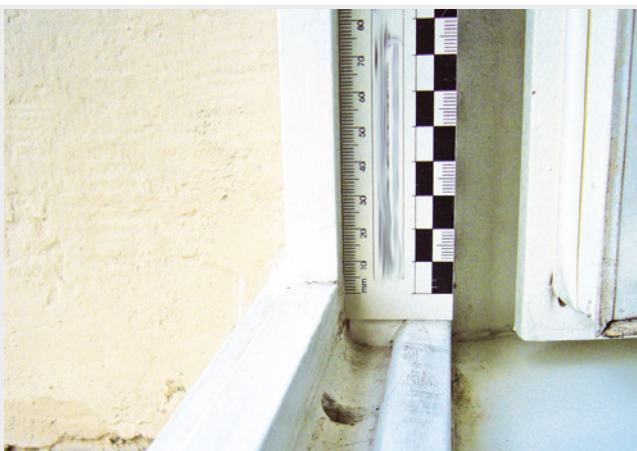
Abb. 55: Innenliegender Wetterschenkel aus Holz
