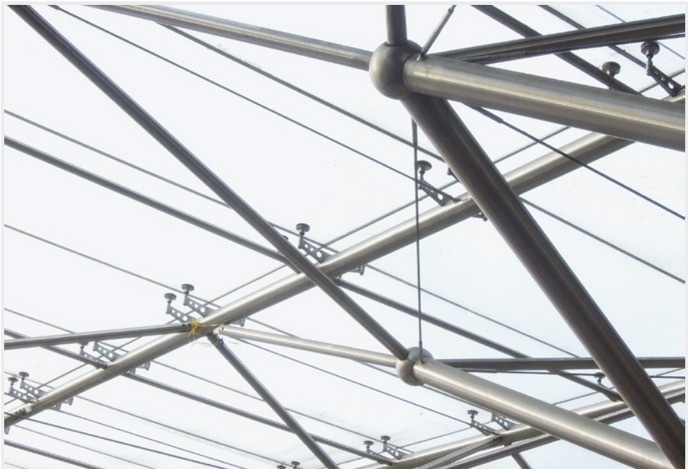
Abb. 62: Punktgehaltene Verglasung
