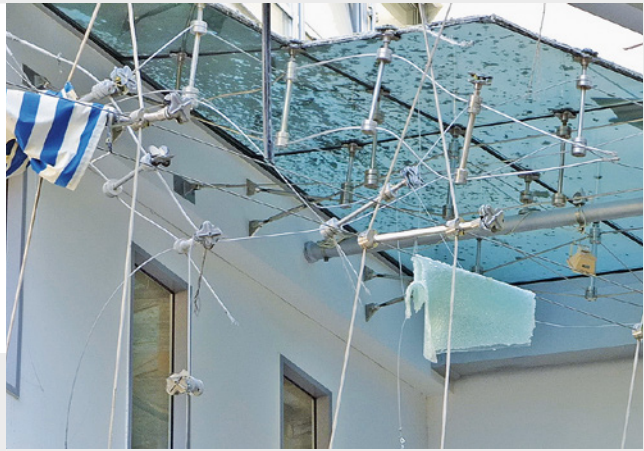
Abb. 17: Horizontalverglasung aus VSG aus ESG faltet sich wie ein Tuch
