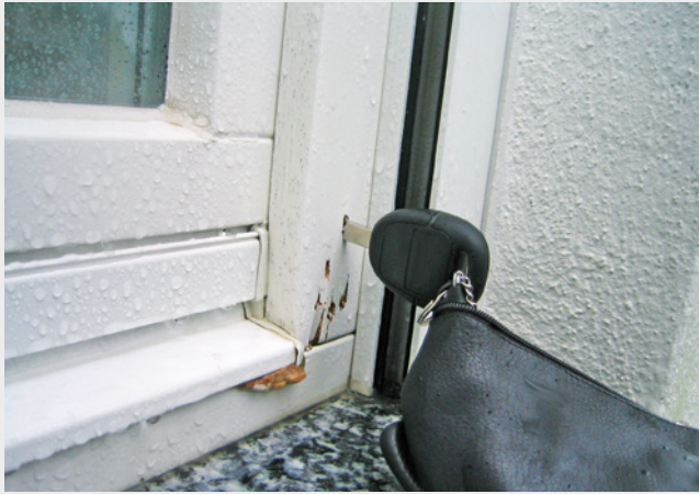
Abb. 53: Durch Fäulnis zerstörte Fensterecke
