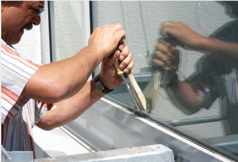
Abb. 107: Glasausbau mit schwerem Werkzeug
