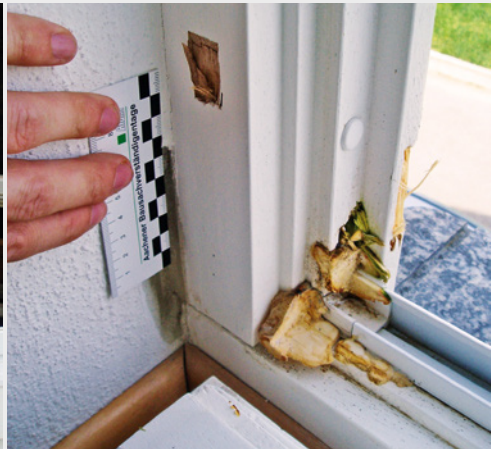
Abb. 22: Pilzwachstum auf verrottetem Splintholz eines Fensters
