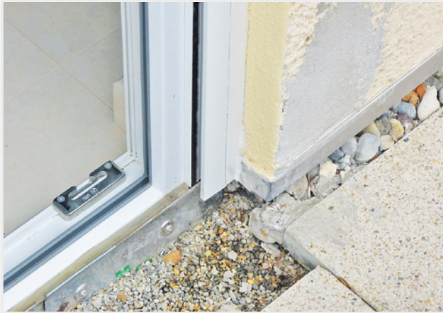
Abb. 57: Profilentwässerung durch Abdichtung verklebt und durch Sockelblech abgedeckt
