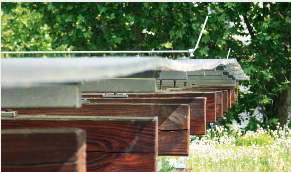
Abb. 74: Glasdach mit Durchbiegung unter Eigenlast
