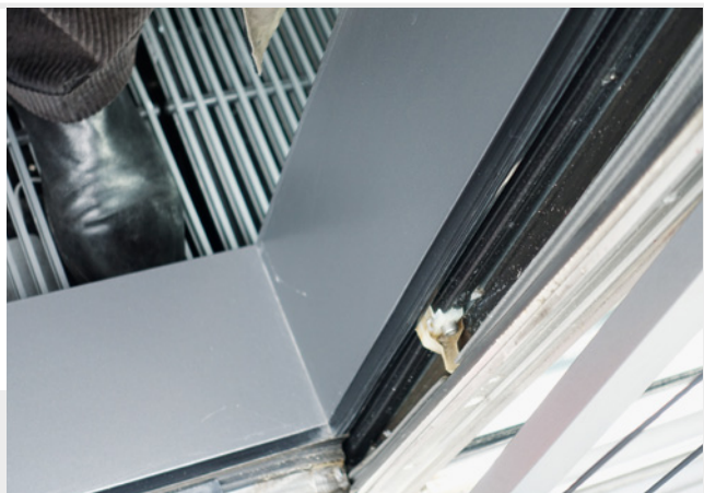
Abb. 50: Die Entwässerungstülle einer Systemfassade wird dem Laien nicht auffallen
