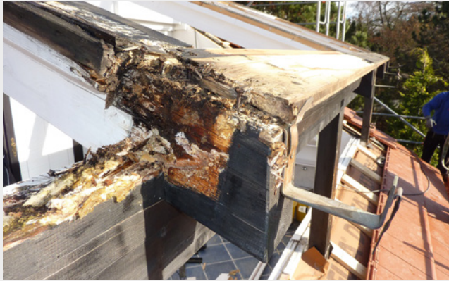
Abb. 41: Schrägverglasungen ohne Kondensatabführung verrotten schnell
