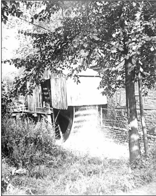
Abb. 5: Radstube mit einem eingebauten Wasserrad der Wassermühle Luhn in Heven bei Witten, um 1930.
