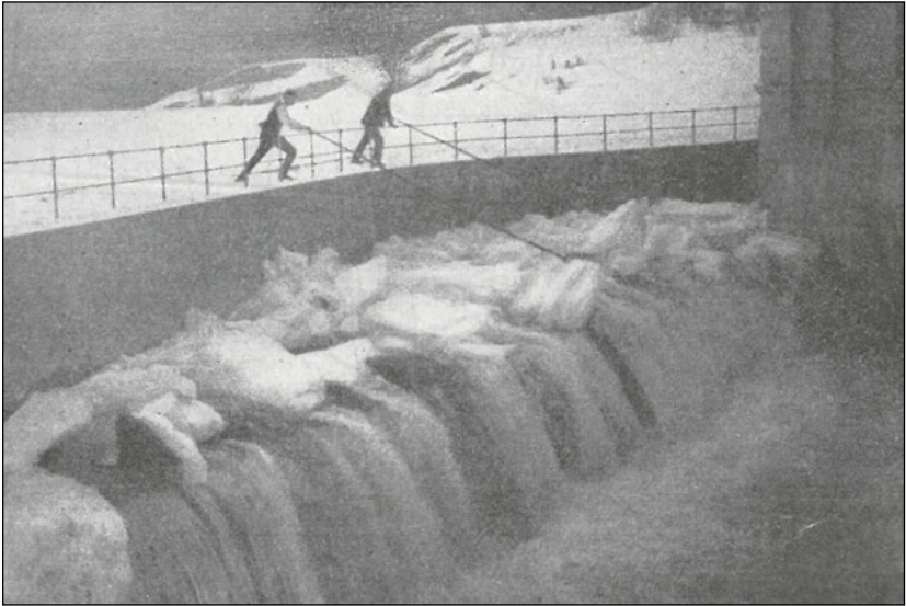
Abb. 6: Eiswaechter beim »Picken«, wie das Entfernen von Eisanhäufungen an Wasserkraftanlagen in den Quellen bezeichnet wurde.
