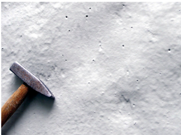
Bild 92 ■ Pin holes an der Oberfläche einer EP-Beschichtung, die auf die PCC-Oberfläche gemäß Bild 91 appliziert worden ist
