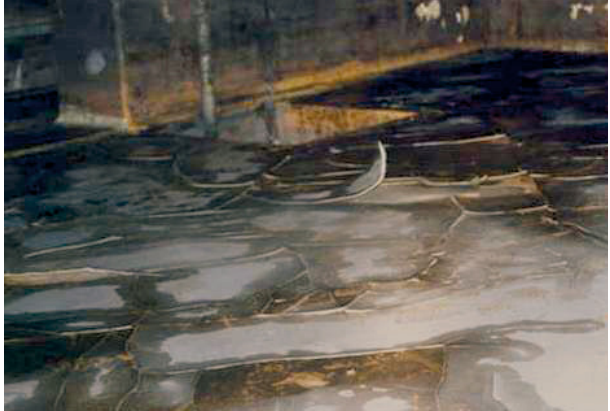
Bild 68 ■ Mehrlagige Bodenbeschichtung in einem Behälter nach WHG; Deckschicht reißt ein und schüsselt auf
