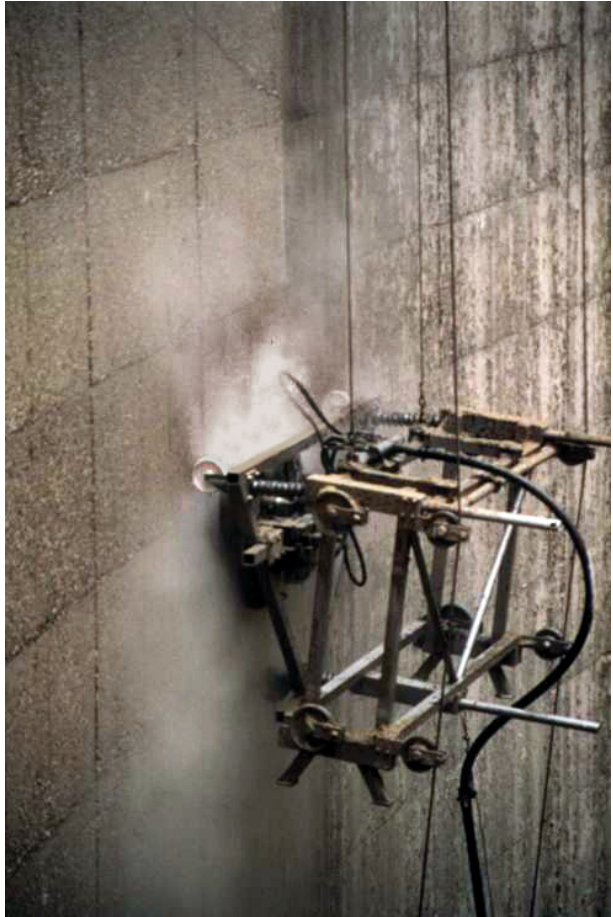
Bild 10 ■ Seilgeführte, ferngesteuerte Hochdruckwasserstrahlanlage
