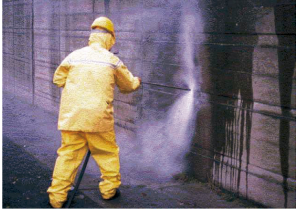
Bild 9 ■ Hochdruckwasserstrahlanwendung per Hand; ab 300 bar Druck wegen Rückstoß und Rückprall von Wasser und Sekundärabfall schwierig handhabbar; wird möglich durch Sonderkonstruktionen
