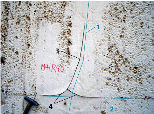
Bild 78 ■ Schaleninnenseite eines Naturzugkühlturms im Abgasbetrieb 1 ungefähre Verlauf des Meridianrisses 2 ungefähre Verlauf des Betonierfugenrisses 3 Verlauf des Risses der Beschichtung über dem Meridianriss 4 Verlauf des Risses der Beschichtung über der Betonierfuge
