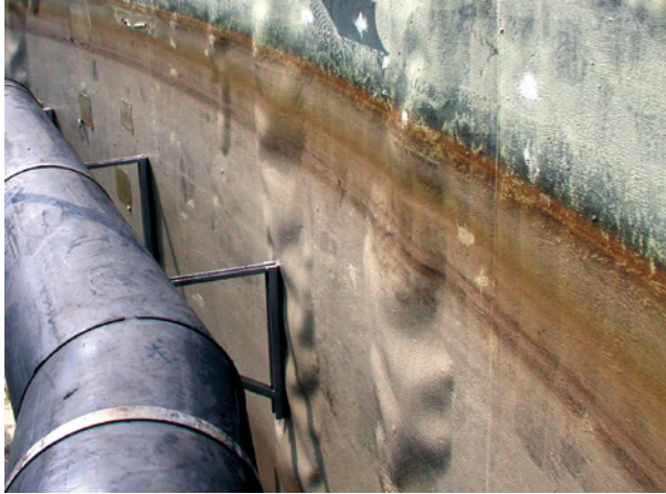
Bild 143 ■ Klärbeckenwand mit Beulenbildung in der PUA-Beschichtung
