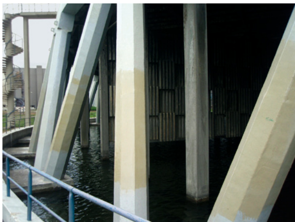
Bild 21 ■ Rissüberbrückende Polyurea-Beschichtung auf Kühlturm-Schalenzstützen; vergilbte Beschichtungsgebiete, auf denen der Beschichtungsstoff mit disproportional angesetzten Ausgangskomponenten zum Einsatz gebracht wurde
