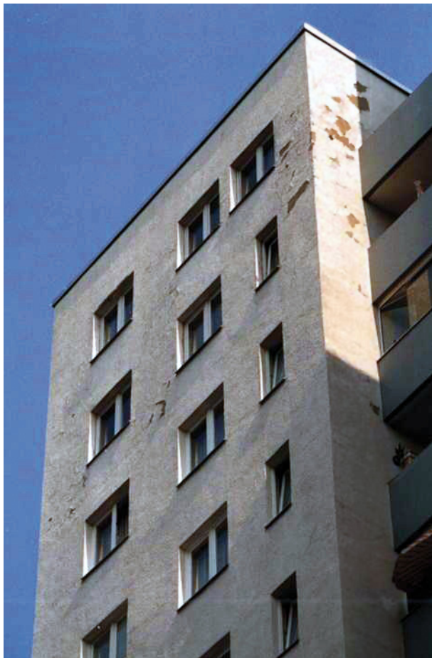
Bild 121 ■ Verputzte und beschichtete Fassade; witterungsbedingte Abplatzungen mit zunehmender Gebäudehöhe
