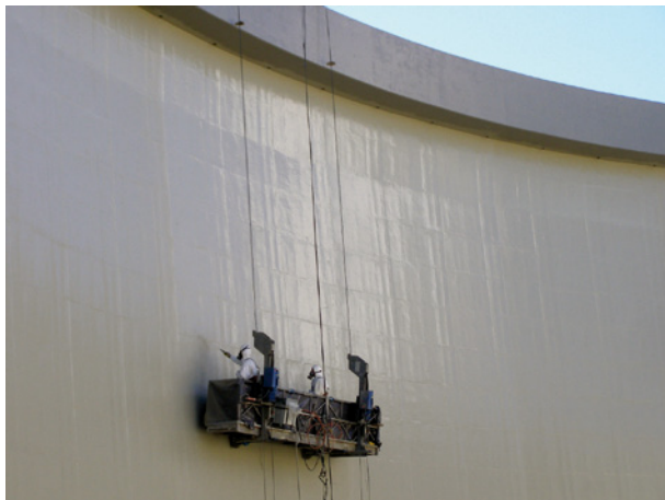
Bild 15 ■ Airlessspritzverfahren zur Applikation von lösemittelbasierten EP- bzw. PUR-Beschichtungsstoffen auf großen Flächen von Naturzugkühltürmen
