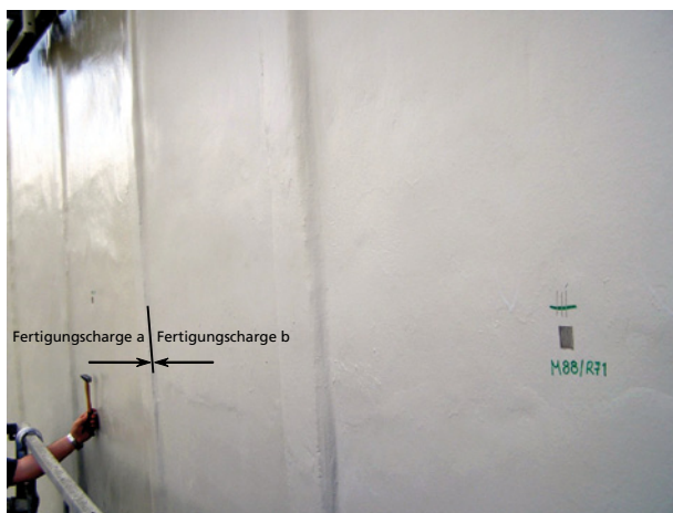
Bild 25 ■ Deutlich unterschiedliches Glanzvermögen von zwei Fertigungschargen unmittelbar nach der Anwendung des gleichnamigen Produktes
