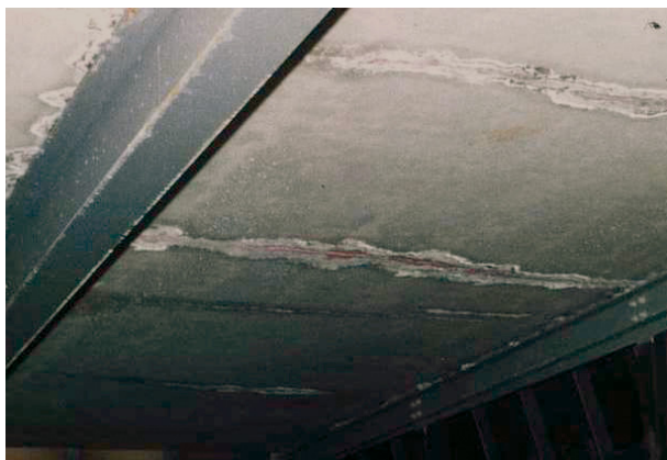
Bild 72 ■ Parkdeck- untersicht mit wasser- führenden Trennrissen in Betonplatten
