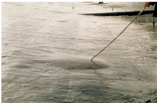
Bild 81 ■ Örtliche, durch Wärmeeinwirkung bedingte Verlängerung einer flexiblen Polymerdachbeschichtung bei parallel verlaufender Erweichung durch Erwärmen und Quellen mit der Folge der Beulenbildung
