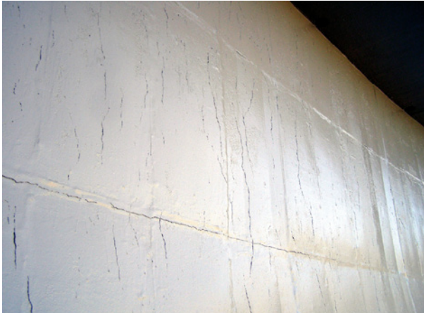
Bild 55 ■ Vertikal scharenartig auftretende Risse in der Stahlbetonschale eines Naturzugkühlturms unterhalb des oberen Randglieds als Folge schwind- und temperaturbedingter Ringzugspannungen
