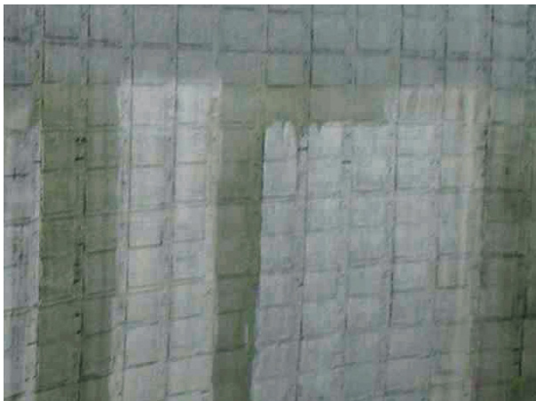
Bild 22 ■ Amingehärtete Epoxidbeschichtung erlitt weißliche Trübung, weil in statu nascendi zu geringe Temperatur und zu hohe Luftfeuchte herrschten; dadurch Wassereinlagerung in das Bindemittel der Oberflächenzone mit irreversibler, diffuser Streuung des auftreffenden Lichts
