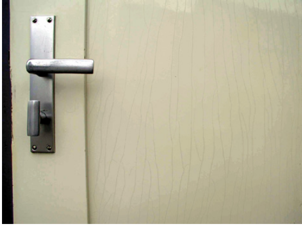
Bild 54 ■ Parallel zur Holzmaserung auftretende Risscharen in einer Türlackierung, die auf den ausgeprägt anisotrop sich verlängernden Holzuntergrund zurückgehen
