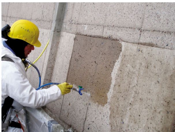
Bild 17 ■ Flutanwendung von niederviskosen »wasserdünnen« Hydrophobierungsmitteln auf saugendem Beton
