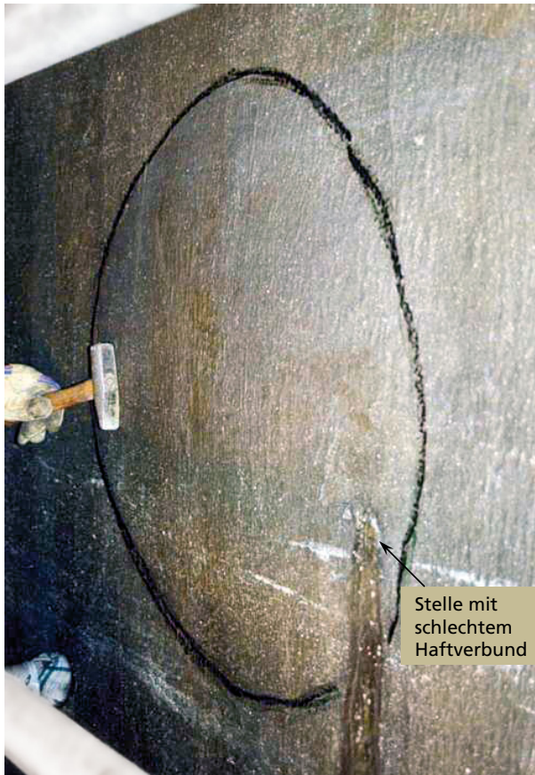
Bild 89 ■ Mit Epoxidbeschichtung versehene Betonwand eines Abwasserbeckens ca. 6 m unterhalb des außenseitigen Grundwasserspiegels; planmäßig als WU-Beton erstellte Wanne hat kavernöse Zonen; an Stelle mit schwachem Haftverbund hat hydrostatischer Druck Enthaftung verursacht; durch Unterwanderung entstand eine Blase mit ca. 60 cm Durchmesser und einem Ausbeulungsstich von ca. 20 mm
