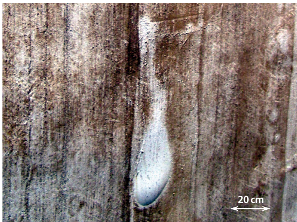
Bild 90 ■ Flexibel formulierte Polyurethanbeschichtung, die sich unter geringem Druck, der Schwerkraft örtlich rückwärtig eingesickerten Wassers folgend, in der vorliegenden Form eines Blasensacks ausgebildet hat
