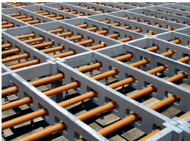
Bild 104 ■ Stahlbeton-Tragkonstruktion der Rieseleinbauten eines Naturzugkühlturms.
