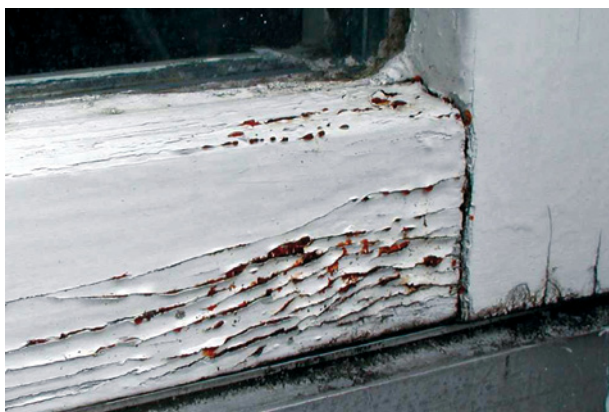
Bild 84 ■ Ausschwitzen von harzhaltigen Holz-inhaltsstoffen, die zu pustelartigen Erhebungen der Beschichtung geführt haben
