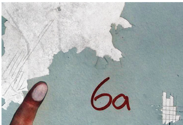
Bild 122 ■ Acrylfassadenbeschichtung auf kreidendem Untergrund, Abblättern und Gitterschnittkennwert zeigen schlechten Haftverbund an
