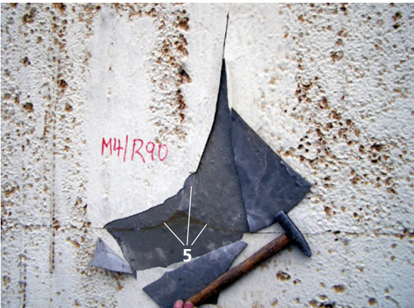
Bild 79 ■ Schalenabschnitt (Bild 78) nach Abnahme des enthafteten Beschichtungsteils 5 keine Risse in der verbliebenen rissüberbrückenden Teilschicht
