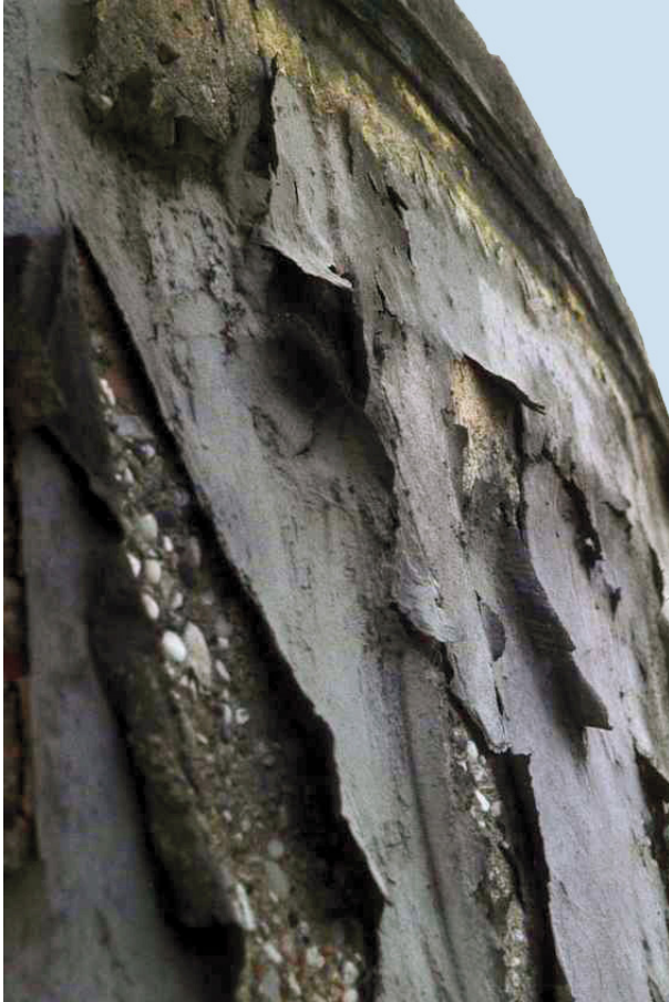
Bild 116 ■ Die Beschichtung einer Schornsteinmündung ist als Folge der chemischen Belastung und der damit verbundenen Versprödung gerissen, aufgeschlüsselt und zum Teil abgeblättert.
