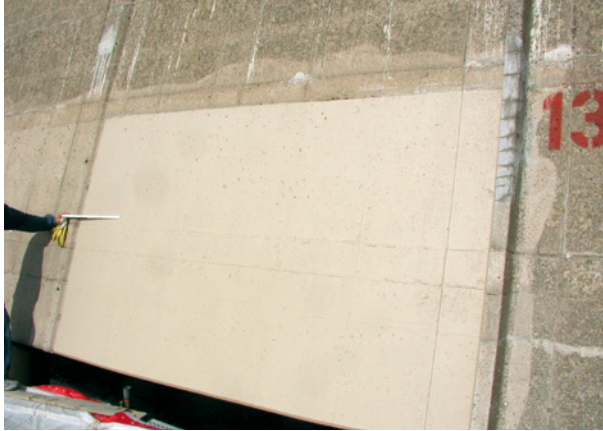
Bild 19 ■ Referenzfläche einer vereinbarten Beschichtung mit vereinbartem Sonderfarbton
