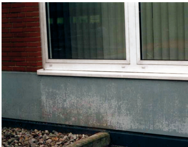
Bild 29 ■ Lösliche Anteile sind flächig (mit Regenwasserunterstützung) aus dem Beton durch die Beschichtung migriert und zu glattem Belag (säurelöslich) versintert.
