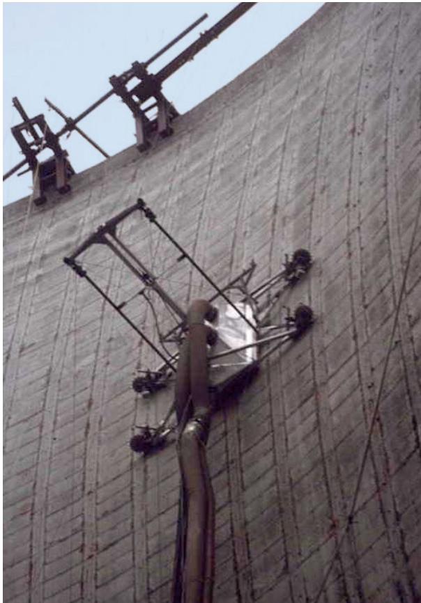
Bild 12 ■ Ferngesteuertes Druckluftstrahlen mit festem Strahlmittel und besonderer Absaugvorrichtung für Strahlmittel und Sekundärabfall
