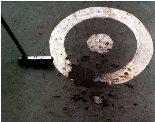
Bild 129 ■ Unzureichend bemessene Schicht und Schichtdicke einer Bodenbeschichtung, die örtlich einer starken Schlagbeanspruchung ausgesetzt ist
