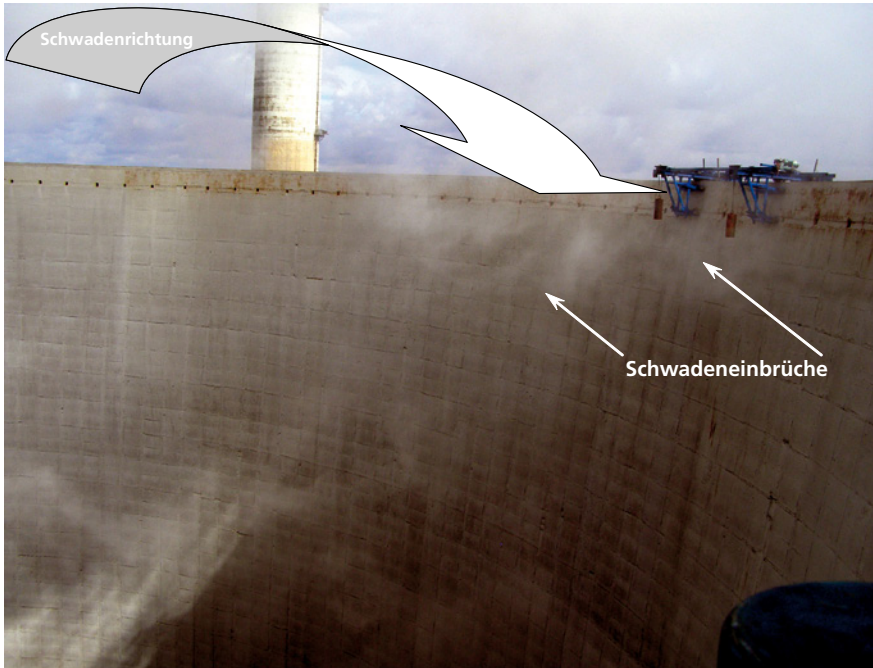
Bild 96 ■ Schaleninnenseite eines Kühlturms; Schwadeneinbrüche aus dem Betrieb des Nachbar-kühlturms beeinträchtigen Beschichtungsmaßnahmen
