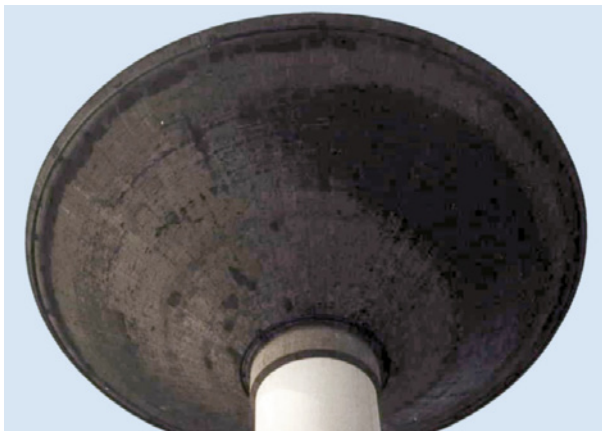
Bild 119 ■ Tauwasserbildung (dunkle Teilfläche der Kegelschale, rechts) an einem Trinkwasserbehälter während der Instandsetzungs- und Beschichtungsarbeiten
