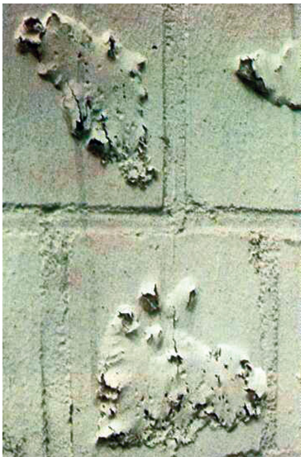
Bild 85 ■ Pustelartiges Anheben der Kunststoffdispersions-Fassadenbeschichtung durch Salze, die über Fehlstellen herausgelöst wurden und an der Steinoberfläche nach Luftzutritt versinterten
