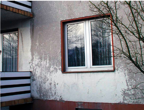
Bild 126 ■ Abwitterung einer Fassadenbeschichtung, die an regengeschützten Teilflächen (dunkel) schneller abläuft als an regengeschützten Teilflächen (hell)
