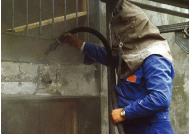
Bild 11 ■ Druckluftfreistrahlen mit festem Strahlmittel; nennenswerte Umfeldbelastung durch Strahlmittel und Sekundärabfall
