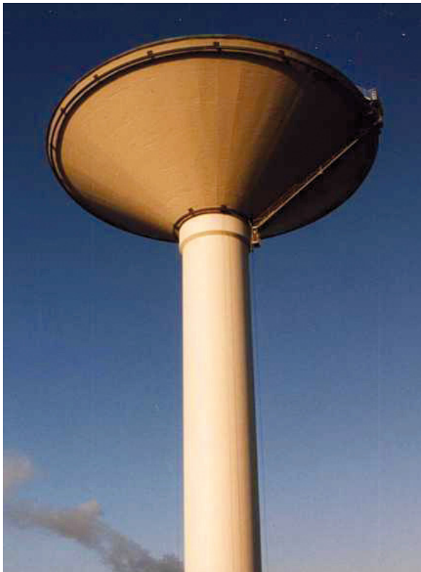
Bild 136 ■ Trinkwasser-Hochbehälter; innenseitig ohne, außenseitig mit Beschichtung, erfordert besondere Betrachtungen zur Wassergehaltsverteilung in der Stahlbeton-Kegelschale des Behälters
