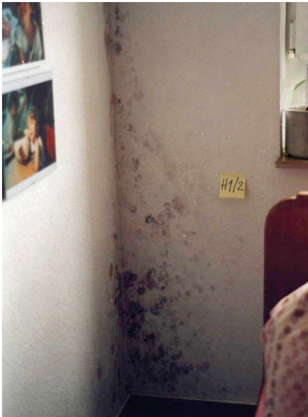
Bild 33 ■ Pilzbelag (sogenannte Stockflecken) auf feuchten Oberflächen von Außenwandinnenseiten als Folge einer Wärmebrückenwirkung; Betauung im Eckbereich ist durch hohe Baufeuchte nach Bauwerkserstellung und durch ungünstiges Wohnverhalten (Heizung/Lüftung) im Schlafzimmer begünstigt worden
