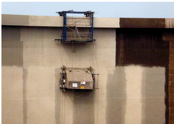
Bild 16 ■ Seilgeführte Airlessspritzkabine mit Absaug- und Filtervorrichtung
