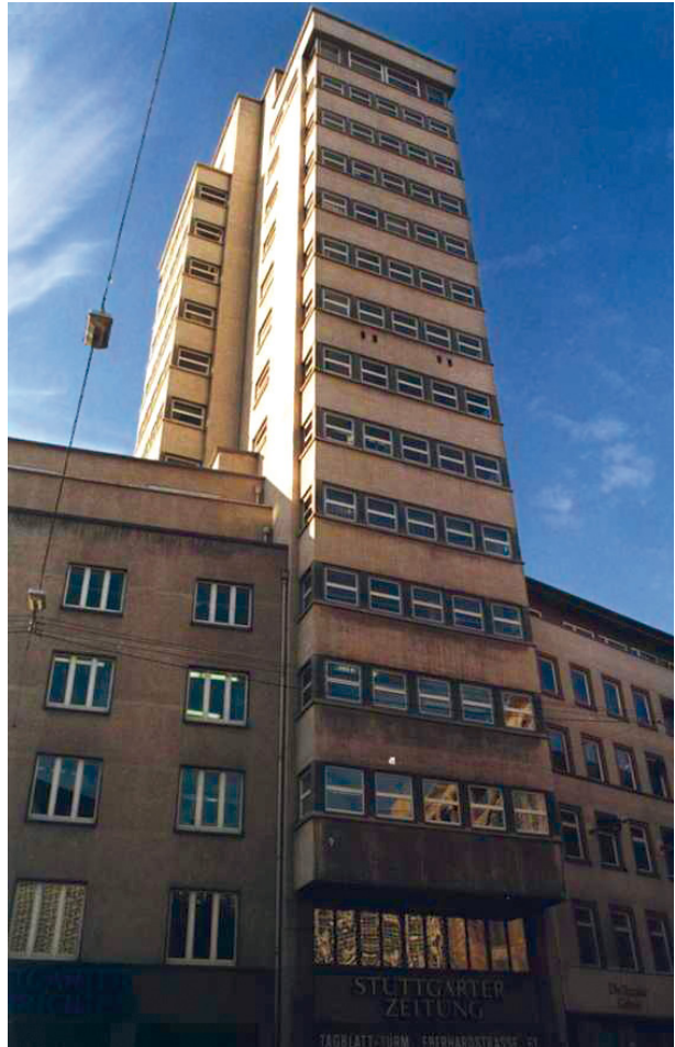
Bild 27 ■ Fassade, die im Turmbereich durch Regeneinwirkung sauber gehalten wird, während sie im unteren Bereich im »Regenschatten« eine deutliche Anschmutzung erfährt
