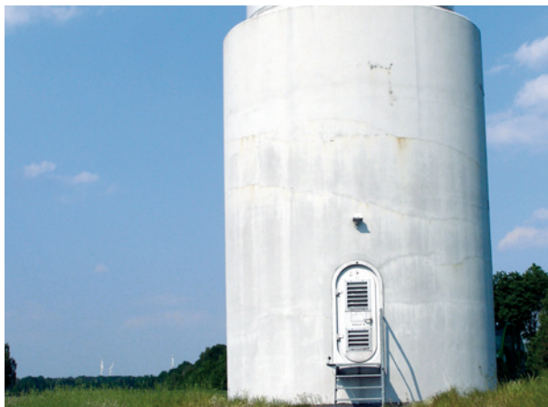
Bild 56 ■ Ringförmige Risse im Stahlbetonsockel einer Windenergieanlage auf der Luvseite als Folge der windbedingten Pendelwirkung
