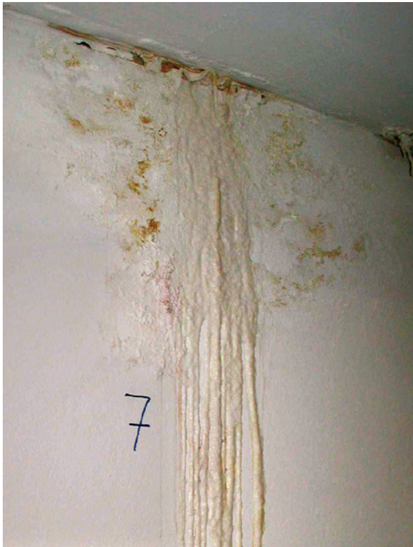
Bild 28 ■ Kalksinterablagung auf der Wandbeschichtung als Folge eines Abdichtungsfehlers und eines daraus resultierenden HerauslöSENS von Kalk \text{Ca(OH)}_2 aus einem Zementestrich, der nach Zutritt von Luftkohlen-säure \text{CO}_2 zu Kalkstein \text{CaCO}_3 versintert
