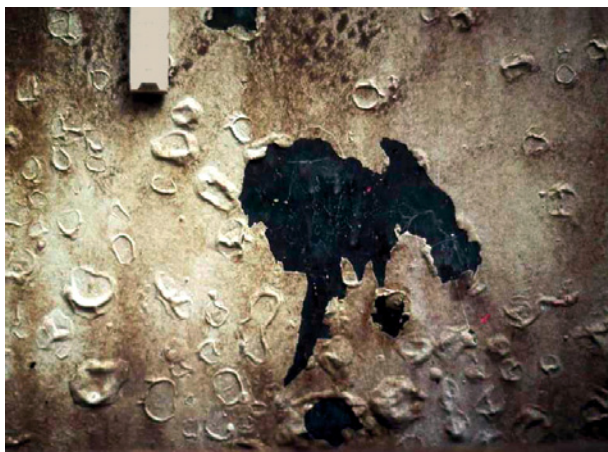
Bild 105 ■ Osmotische Blasen in der EP-Beschichtung der Beton-Tragkonstruktion; Blasenhohlraum liegt zwischen Grund- und Deckbeschichtung; Haftverbund ist wegen dickschichtiger und sehr glatter Grundbeschichtung mäßig; Blasen sind nach Trocknung partiell zusammengefallen
