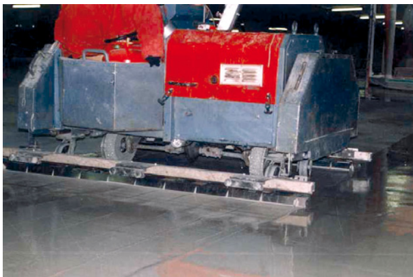
Bild 18 ■ Einbaufertiger, der den aufgegossenen Beschichtungsstoff über Zahnleistensegmente aufzieht
