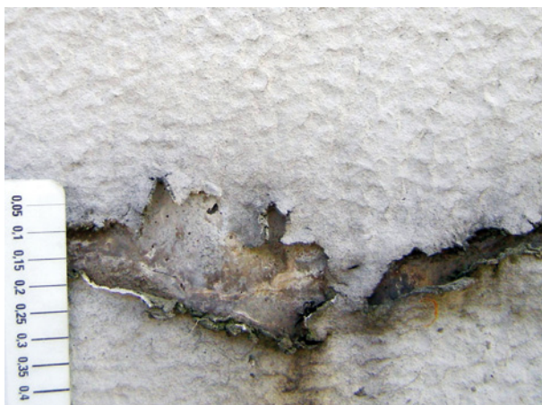
Bild 57 ■ Totalversagen einer regelwerkskonform rissüberbrückenden Beschichtung, weil die in-situ-Rissbreitenänderungscharakteristik die Regelwerksvorgaben weit überschreitet
