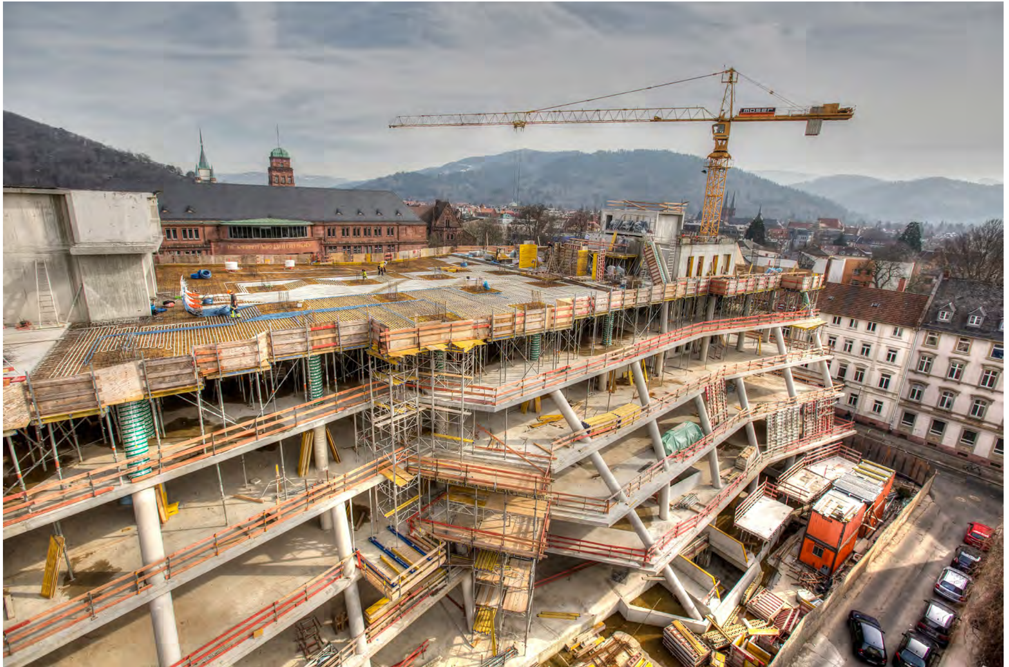
Abb. 6: Rohbauarbeiten im Wohnumfeld
