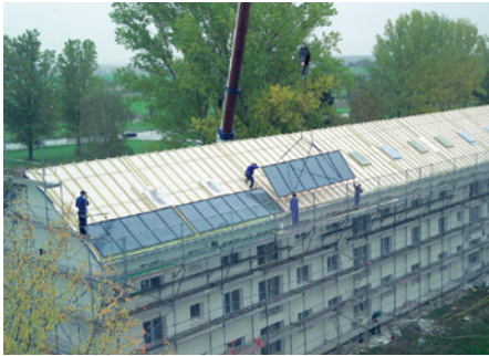
Montage von Großkollektoren auf einem der Kasernengebäude auf konventionellem Unterdach
