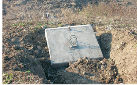
Oberes Fundament eines Kollektorfeldes als Fertigteil, auf Wall gestellt
