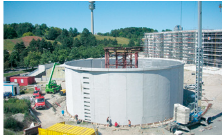
Gegenüberliegend angeordnete Spannnischen, durch die die Spannlitzen in die Lehrrohre eingefädelt wurden
