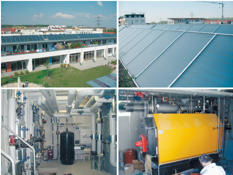
■ Abb. 49: (von links oben im UZS) Kollektorfeld Groß- und Nahaufnahme, Blick in die Heizzentrale während der Montage und Pelletkessel der solar unterstützten Nahwärmeversorgung Holzgerlingen.
