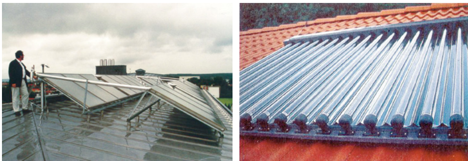
■ Abb. 16: Kollektorbauarten für den Einsatz in Anlagen zur Erwärmung von Trinkwarmwasser (links Flachkollektoren) und für Prozesswärme wie Kühlung oder thermische Produktionsprozesse (rechts Vakuumröhrenkollektor)
