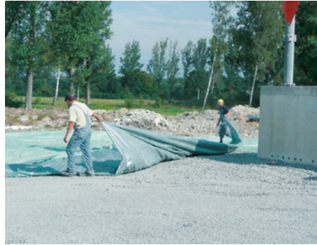
Immer: Schutz der Wärmedämmung vor Regen und Feuchtigkeit durch Abdecken mit Plane
