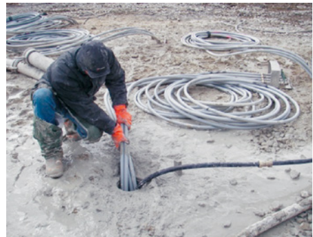
Nachverfüllung der oberen Meter mit Dämmen. Die noch übrigen Erdwärmesondenrohre dienen zur horizontalen Verbindung der Rohrleitungen.
