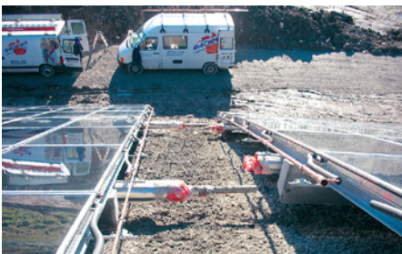
Kollektorfeld-Verrohrung ohne Tichelmann mit entsprechender Rohrleitungsführung und -dimensionierung
