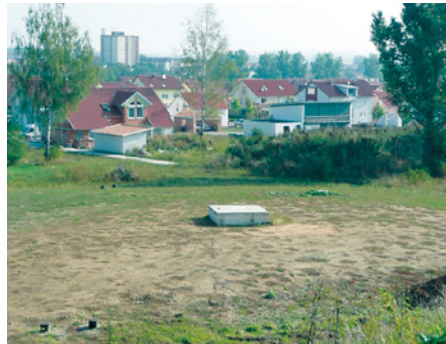
Fertig gestellter Erdsonden-Wärmespeicher mit zentralem Anschlussschacht
