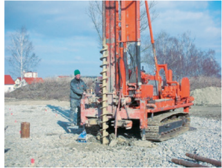
Erstellen der oberen 5 m Schutzverrohrung mit Brunnenbohrgerät (Schneckenbohrung)
