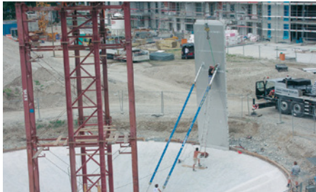
Montage der Wandfertigteile (Wandstärke 16 cm) mit vormontierter innerer Edelstahlauskleidung aus 1,2 mm Edelstahlblech, überlappend verschweißt
