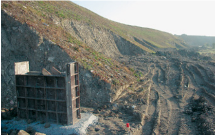
Längssicht des Walls mit unterem Fundament, das durch Mikroverpressanker in gewachsenem Boden rückverankert ist.
