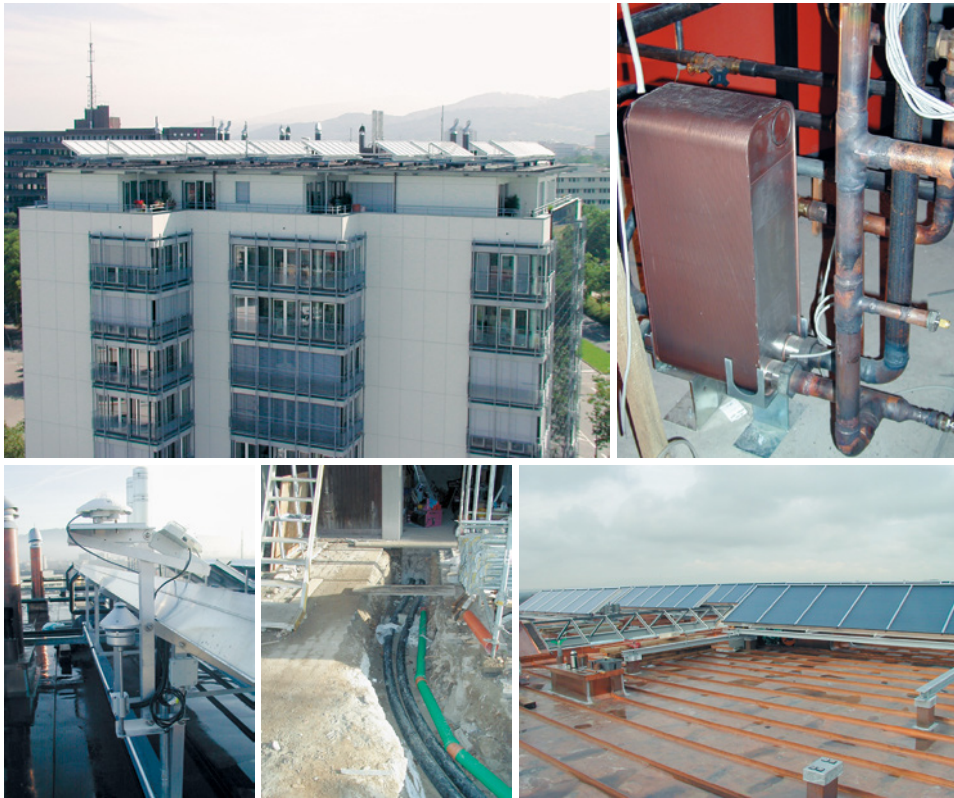
■ Abb. 41: Anlagenansichten (von links oben nach rechts unten): Ansicht des Kollektorfelds, Detailansicht eines Plattenwärmetauschers während der Montage, Pyranometer und Außentemperaturfühler, erdverlegte Solarleitungen, Kollektormontage auf dem Gebäude Wilmersdorfer Straße 3.
