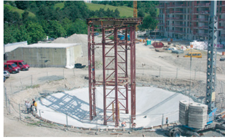
Betonierter unterer Kegelstumpf, manuell abgezogen, mit Rüstturm
