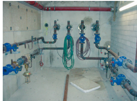
Hausanschluss mit Nahwärmenetz (links) und Solarnetz (rechts)
