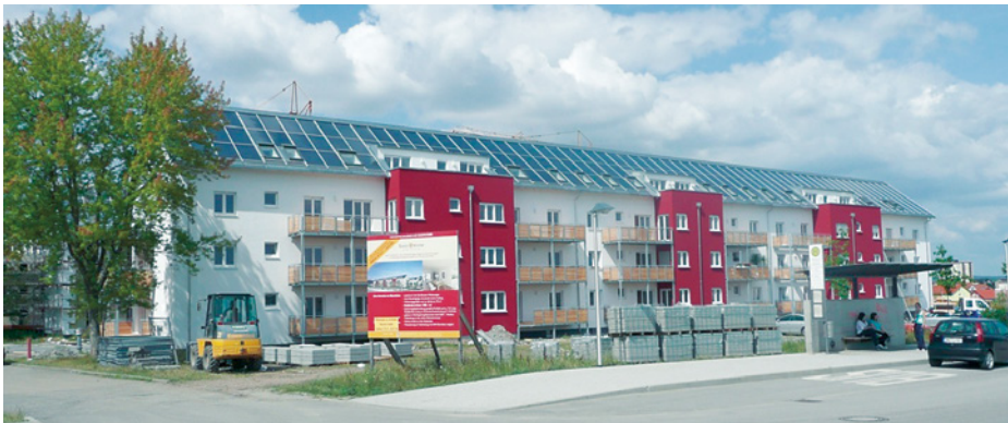
Variante der energetischen Sanierung von Kasernengebäuden mit hochintegriertem Solardach
