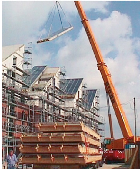
■ Abb. 62: Ausführung großer Kollektorfelder (links: Großkollektoren, rechts: Solardach)
