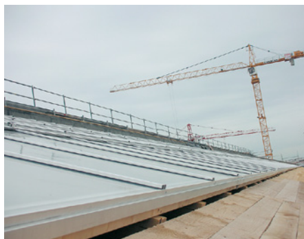
Unterer Abschluss der Kollektorfelder mit einzieblechem Regenauslauf, darunter Regenrinne
