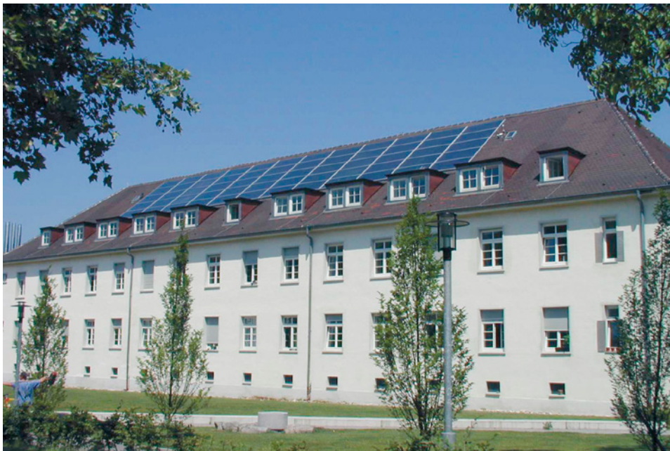
■ Abb. 1: Ansicht des Studentenwohnheims Freiburg-Vauban mit dachintegrierter Kollektorfläche zur solaren Trinkwassererwärmung
