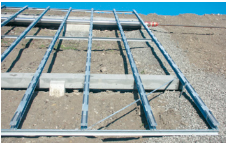
Nebenträger des Kollektorlieferanten aus Stahl-Doppel-T-Trägern
