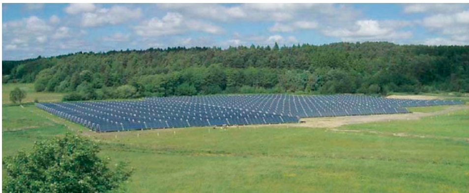
■ Abb. 67: Kollektorfeld der solar unterstützten Nahwärme Kungälv mit 10.000\text{ m}^2 Kollektoraperturfläche
