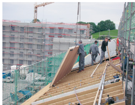
Ablegen der Großkollektoren, Ausrichten und Festschrauben
