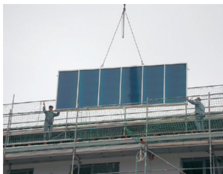
Heben der Großkollektoren mit Autokran, Halteschleifen sind im Kollektor verschraubt
