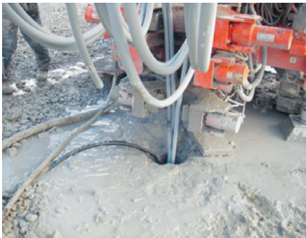
Verfüllen des Bohrlochs. Die Erdwärmesonde wird von der Haspel am Bohrgerät gehalten.
