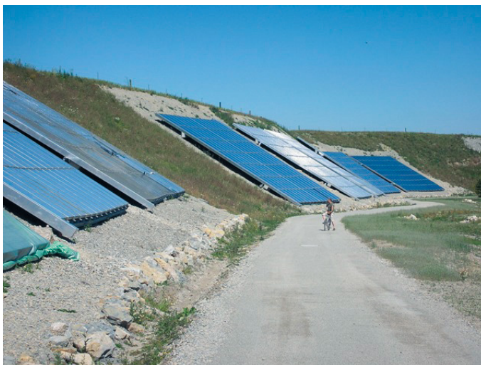
■ Abb. 83: Lage der Kollektorfelder auf dem Lärmschutzwall: Das Ökokonzept beinhaltet um die Kollektorfelder herum eine Schüttung aus Haufwerk und niederen Trockenrasenbewuchs in den größeren Grünflächen zwischen den einzelnen Kollektorfeldgruppen. Vorn links ist zu erkennen, dass die Kollektorfelder vor Inbetriebnahme zum Schutz vor zu hohen Stagnationstemperaturen mit Folie abgedeckt waren.
