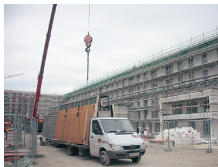
Anlieferung der Großkollektoren nach Baufortschritt des Gebäudes
