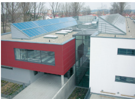
Kollektorflächen auf dem Lise-Meitner-Gymnasium auf Shed-Dach mit Nordverglasung
