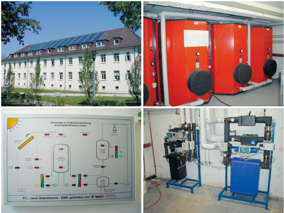
Abb. 45: Ansichten der Solaranlage des Studentendorfs Freiburg-Vauban (von links oben nach rechts unten): Kollektorfeld (dachintegriert), Solar-Pufferspeicher, Anzeigetafel und Kompaktstationen mit Wärmetauschern.
