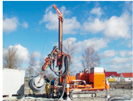
Einbringen der Erdwärmesonde von der Haspel
