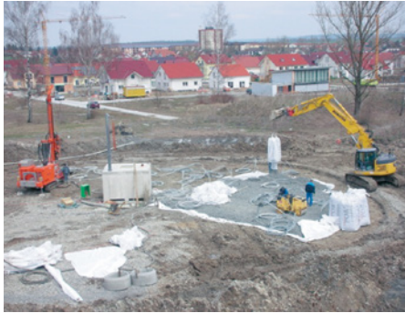
Bohrarbeiten auf der zweiten Speicherhälfte und parallele Dämmarbeiten auf der ersten Speicherhälfte durch Schütten von Schaumglasschotter
