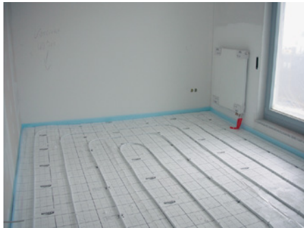
Wandheizkörper, kombiniert mit Fußbodenheizung zur Rücklaufauskühlung
