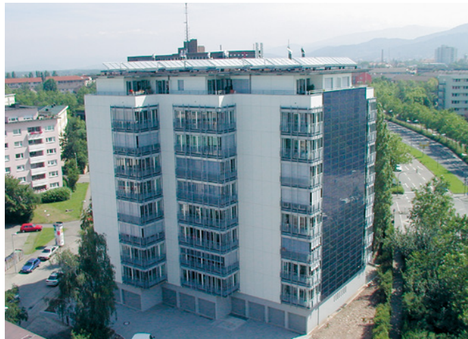
■ Abb. 7: Ansicht des Wohngebäudes des Familienheimes Freiburg Baugenossenschaft e. G. in der Wilmersdorfer Straße in Freiburg, mit den auf dem Dach aufgestellten Flachkollektoren und einer PV-Fassade.
