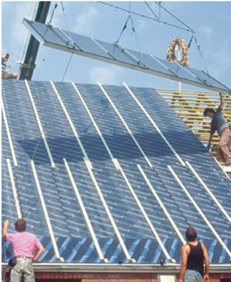
■ Abb. 62: Ausführung großer Kollektorfelder (links: Großkollektoren, rechts: Solardach)
