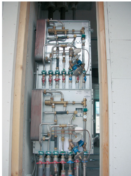
Zwei Wohnungsübergabestationen mit großem Wärmeübertrager, eine von mehreren Ausführungsvarianten
