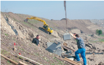
Montage der Querbalken als 18m langes Betonfertigteil auf untere Fundamentträger.
