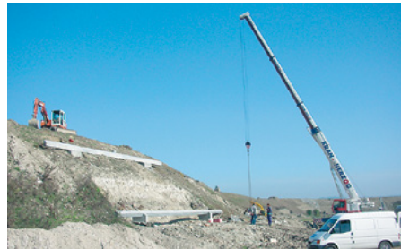
Abschluss der Montage der bauseits gestellten Unterkonstruktion eines 250 m² großen Kollektorfeldes
