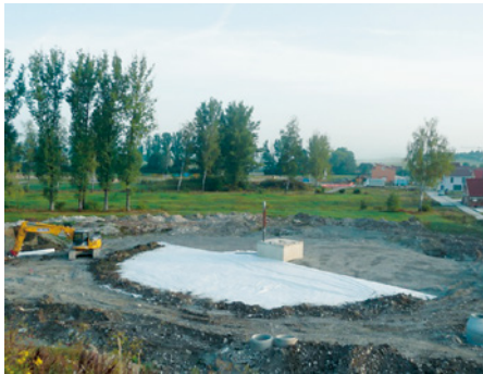
Beginn der Erdauffüllung auf Drainage
