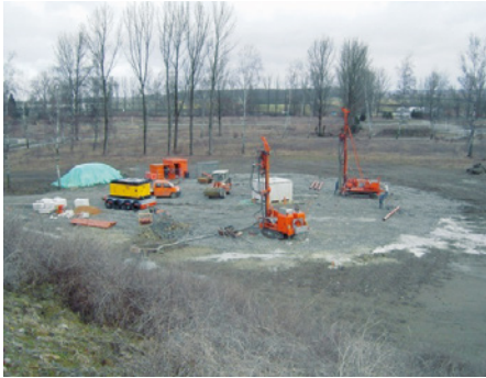
Paralleles Bohren mit Brunnen- und Erdwärmesonden-Bohrgerät auf der Speicherfläche
