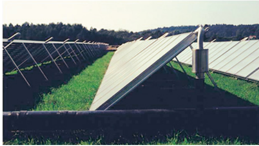
■ Abb. 58: Kollektorfeld der solar unterstützten Nahwärme in Kungälv, Schweden (10.000 m 2 Aperturfläche)
