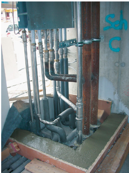
Vertikaler Installationsschacht im Treppenhaus zur Führung des Nahwärmenetzes
