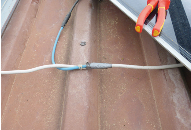
Bild 44: Selbstgefertigtes Abzweigstück lose auf dem Dach verlegt
