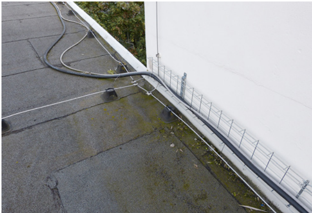
Bild 68: Lose auf der Dachfläche verlegte Leitungen
