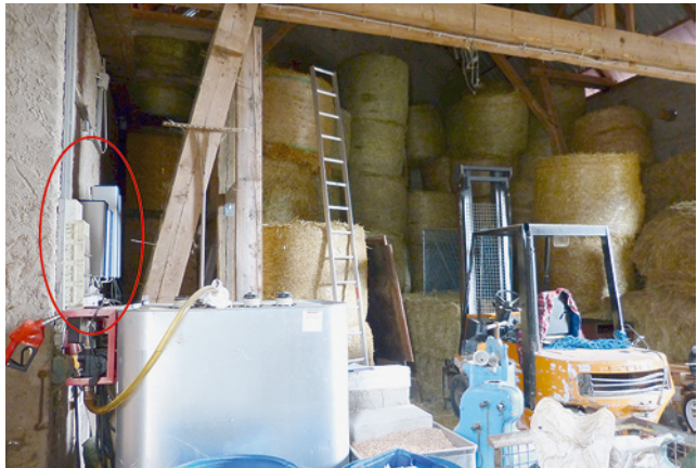
Bild 91: Auch Wechselrichter im Strohlagerraum erhöhen das Risiko für Brände.
