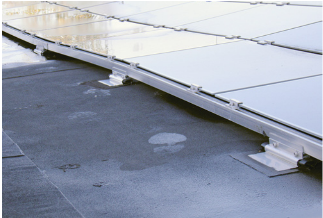
Bild 80: Immer kritisch: punktuelle Auflager auf Bitumenbahnen
