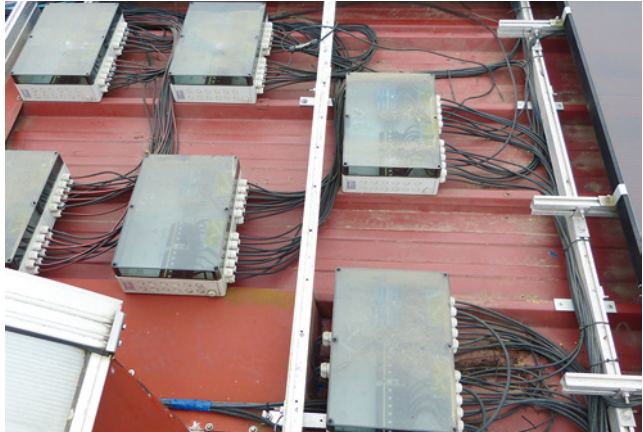
Bild 50: Kondenswasserbildung in Generatoranschlusskästen bei gleichzeitigem ungeschützten, exponierten Montageort und nicht fachgerechter Leitungsverlegung
