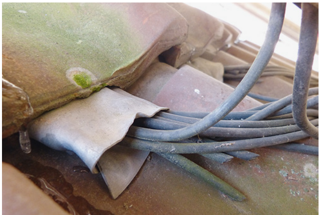
Bild 47: Ungeeigneter Leitungsschutz an der Dachdurchführung
