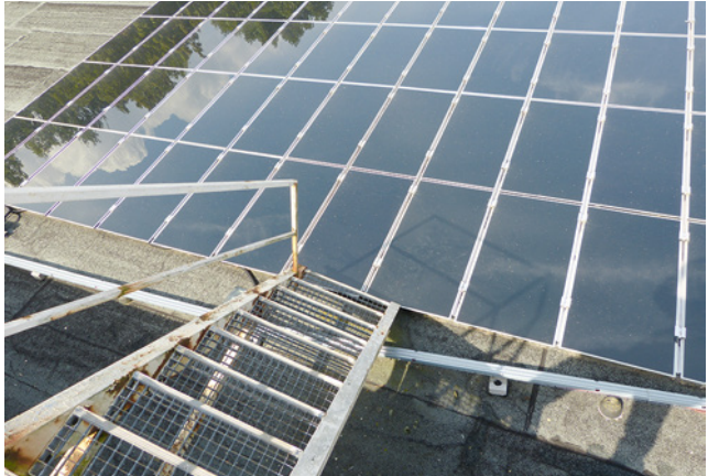
Bild 106: Fatale Situation für Rettungskräfte, wenn der Zugang durch Modulfelder versperrt ist
