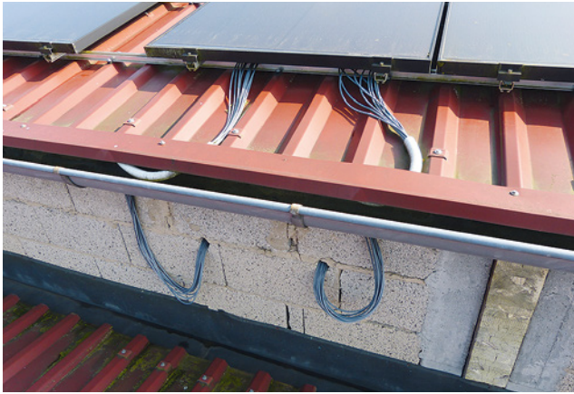
Bild 25: Eigenwillige Leitungsverlegung: Sie ist weder dauerhaft noch zulässig.
