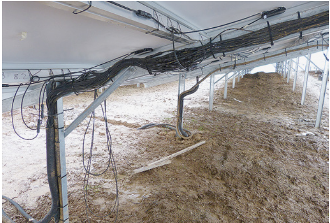
Bild 32: Keine dauerhafte Leitungsbefestigung; ein Abreißen ist vorprogrammiert
