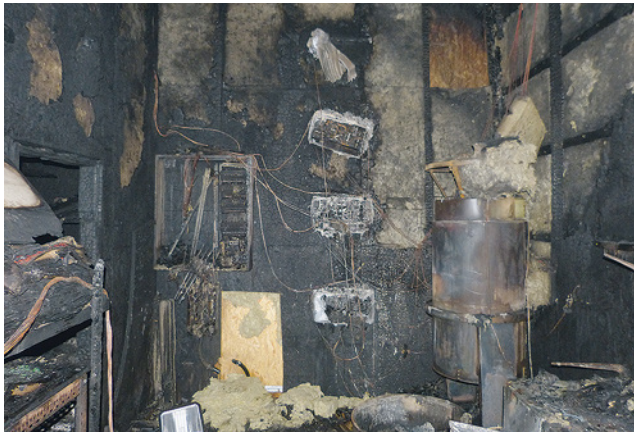
Bild 136: Meistens bleibt nach einem Brand nicht viel übrig. Das Bild zeigt die Reste von vier Wechselrichtern und der Unterverteilung.
