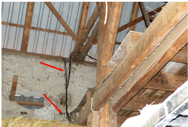
Bild 84: Kritische Leitungsverlegung von Gleichstromleitungen über Holzgebälk und Strohlager ohne Befestigung
