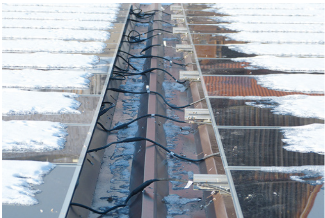
Bild 24: Rutscht Schnee im Bereich lose verlegter Leitungen ab, können Steckverbindungen oder sogar Modulanschlussdosen mit abgerissen werden.
