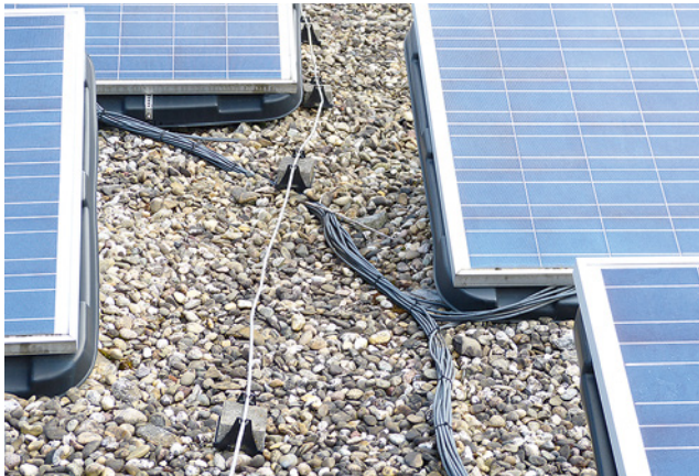
Bild 115: Mangelhafte Leitungsverlegung und fehlender Trennungsabstand zum Blitzschutz
