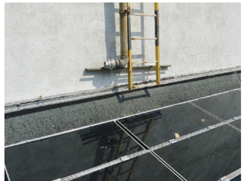
Bild 107 und 108: Problematisch für die Feuerwehr: Die stationäre Löschmittelzuführung wird durch das Modulfeld behindert.
