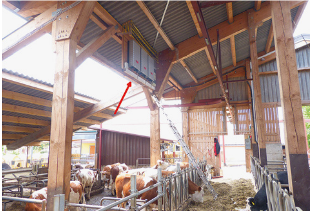
Bild 92: Hier ist kein sicherer Zugang zu den Wechselrichtern möglich.
