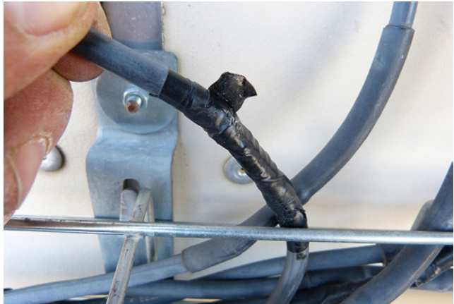
Bild 43: Mit Isolierband nachisolierte Verbindung an einer Leitungsverlängerung
