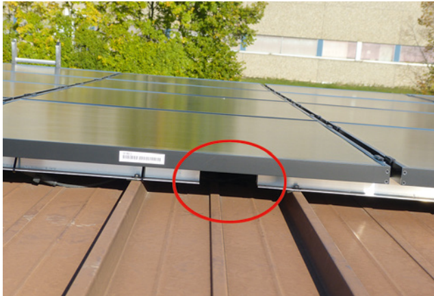
Bild 16: Falsche Anordnung einer Dehnungsfuge unterhalb einer Modulreihe
