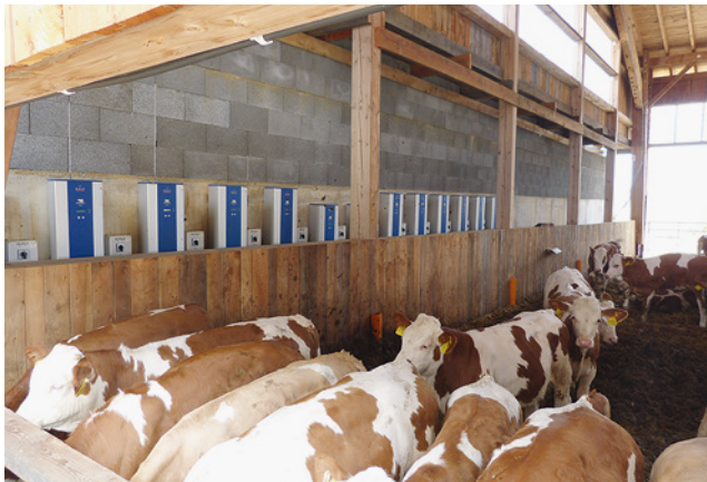
Bild 98: Kritischer Standort der Wechselrichter
