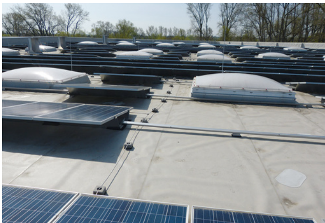
Bild 116: Der überbaute Blitzschutz ist in seiner Funktion eingeschränkt.
