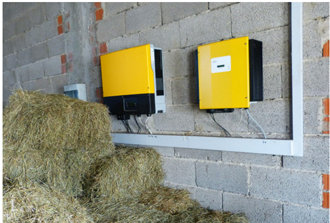
Bild 90: Die Heulagerung direkt bei den Wechselrichtern birgt ein hohes Gefahrenpotenzial.
