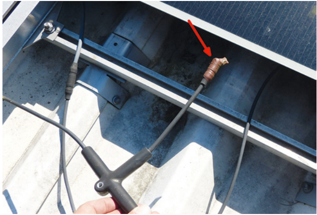
Bild 53: Mit Isolierband verschlossener Steckanschluss
