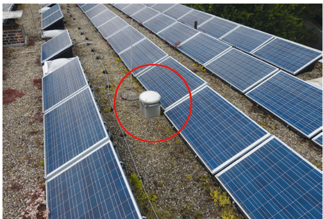
Bild 5: »Harte« Verschattung durch Nahinstallation an einen Dachentlüfter
