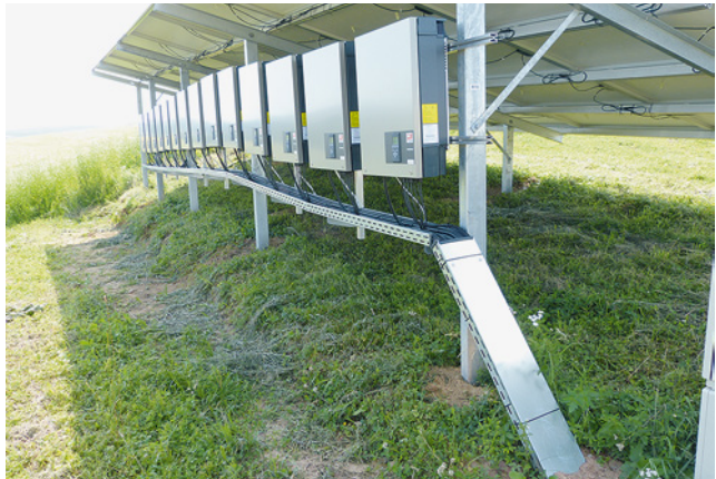
Bild 38: Bessere Lösung mit bis in das Erdreich reichendem metallenen Kabelschutz
