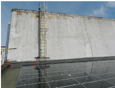
Bild 107 und 108: Problematisch für die Feuerwehr: Die stationäre Löschmittelzuführung wird durch das Modulfeld behindert.
