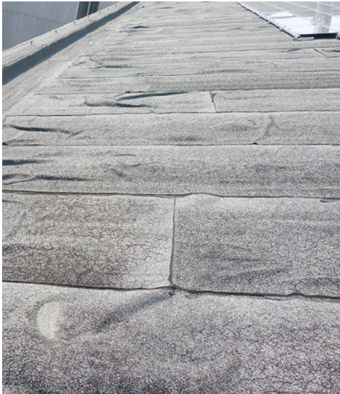
Bild 77: Kritischer Zustand einer Flachdachabdichtung: Das Dach ist zumindest in diesem Zustand nicht für den Bau einer Photovoltaikanlage geeignet.
