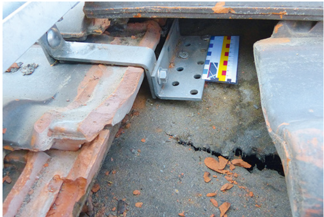
Bild 11: Ausgeschlagene Dachziegel mit beschädigter Unterspannbahn
