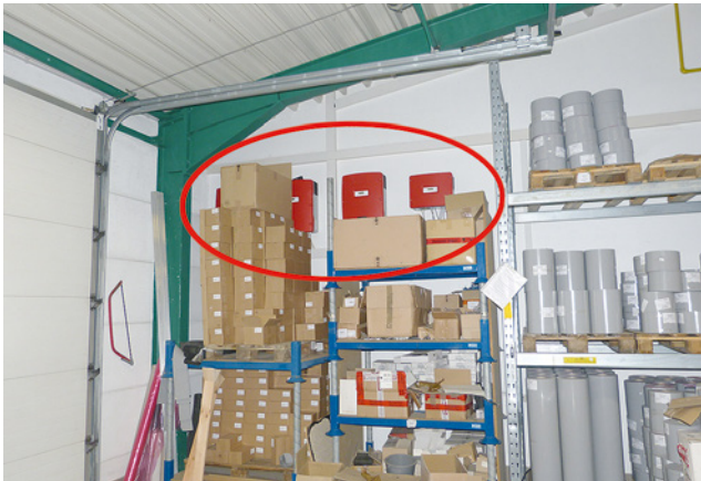
Bild 109: Die Wechselrichter sind hinter dem Lagergut aus brennbaren Materialien »versteckt«.
