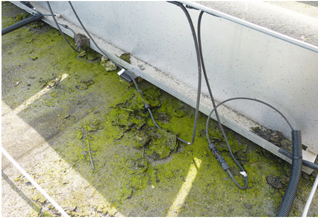
Bild 28: Leitungen und Stecker in einem bereits vermoosten Stauwasserbereich auf einem Flachdach mit Bitumenbahnen
