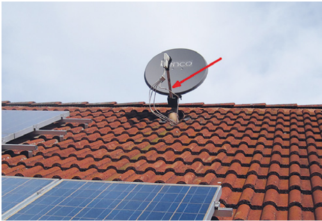
Bild 125: Blitzeinschlag in SAT-Schüssel ...
