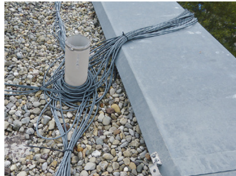
Bild 29 und 30: Auch diese innovative »Befestigung« vor einem ca. 10 m tiefen Kabelabgang wurde völlig unsachgemäß ausgeführt.
