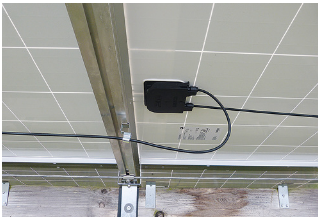
Bild 36: Beispielhaft zugfrei verlegte Modulanschlussleitung
