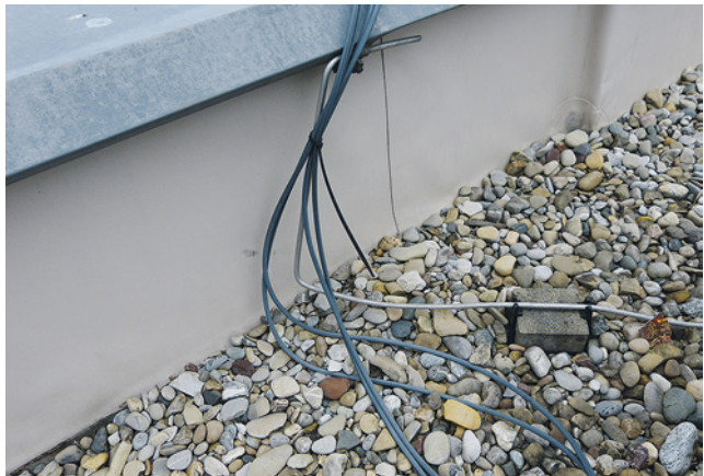
Bild 117: Auch solche Bilder sind nicht selten: Die Solarleitungen sind an Blitzschutzeinrichtung befestigt.
