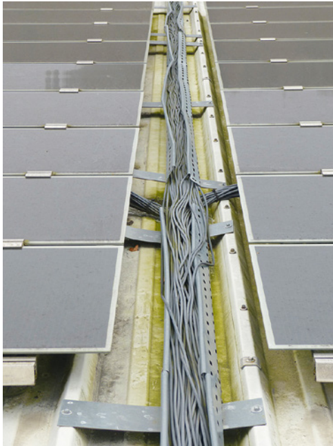
Bild 39 und 40: Fraglicher Leitungsschutz: überfüllte, nicht verschlossene und zudem durch Begehung zertretene Kabelrinne mit scharfen Metallkanten
