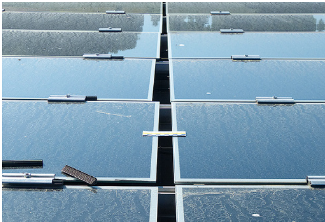
Bild 17: »Wandernde Module« durch Längenschiebungen der Querschienen
