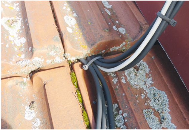
Bild 48: Durch Ziegel gequetschte Leitungen im Bereich der Dacheinführung
