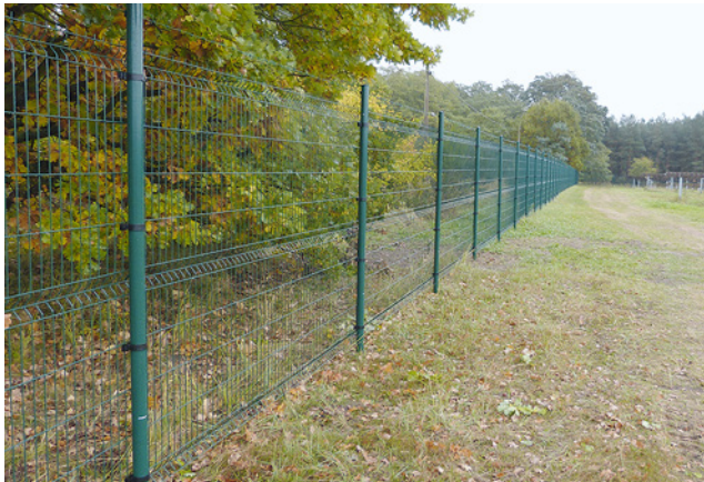
Bild 129: Stabgitterzaun mit Übersteigenschutz
