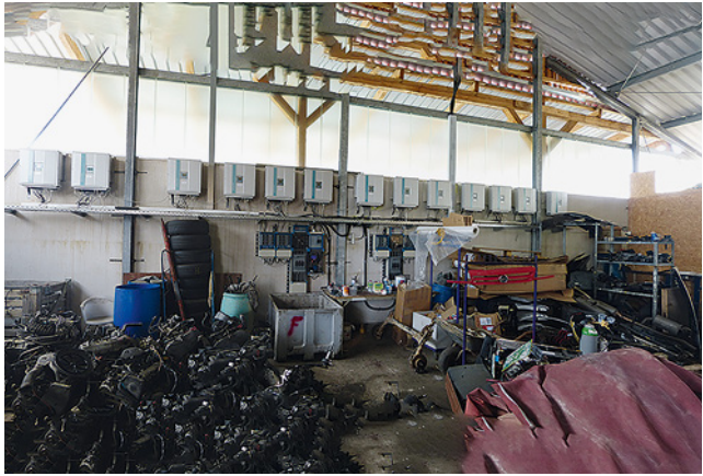
Bild 66: Beschädigungs- und Verletzungsgefahr in einer Werkstatt durch ungünstige Anbringung der Wechselrichter
