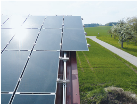
Bild 12 und 13: Die überstehende Modulanordnung bietet ideale Windangriffsflächen.
