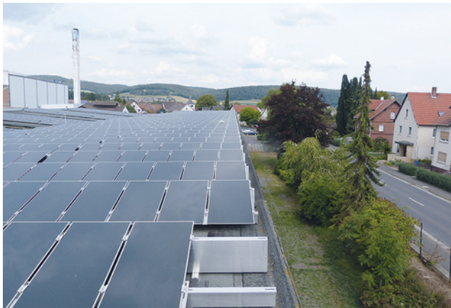
Bild 75: Module auf einem Betriebsgebäude, die bis zur Absturzkante reichen
