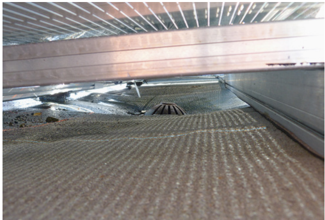
Bild 79: Überbaute Dachabläufe: Hier besteht keine Möglichkeit der Wartung.
