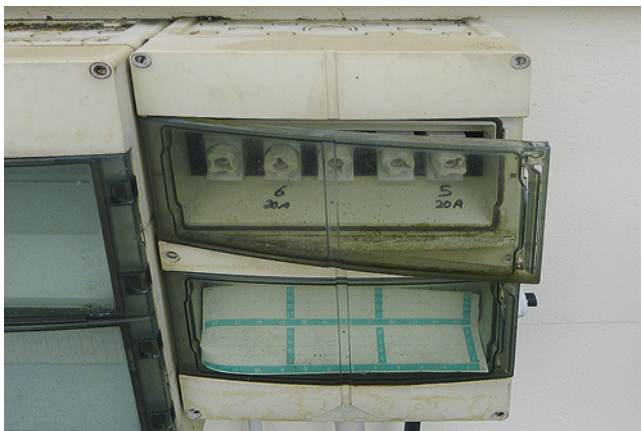
Bild 71: Verwitterte Unterverteilungen mit defekter Tür
