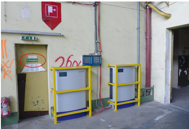
Bild 105: Das Anbringen von Wechsellrichtern und Leitungen im Bereich von Fluren und Notausgängen dieser Industriehalle ist nicht erlaubt.
