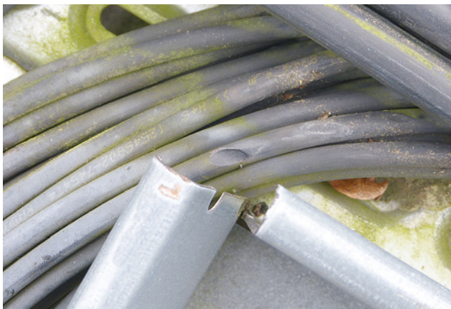
Bild 39 und 40: Fraglicher Leitungsschutz: überfüllte, nicht verschlossene und zudem durch Begehung zertretene Kabelrinne mit scharfen Metallkanten
