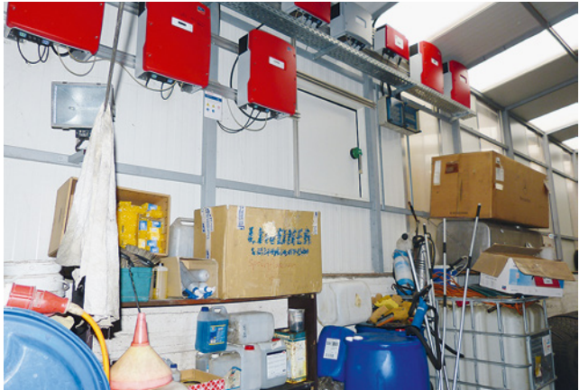
Bild 67: Problematisch: Verschiedene Materialien werden in der Nähe einer elektrischen Anlage gelagert und erschweren den Zugang.
