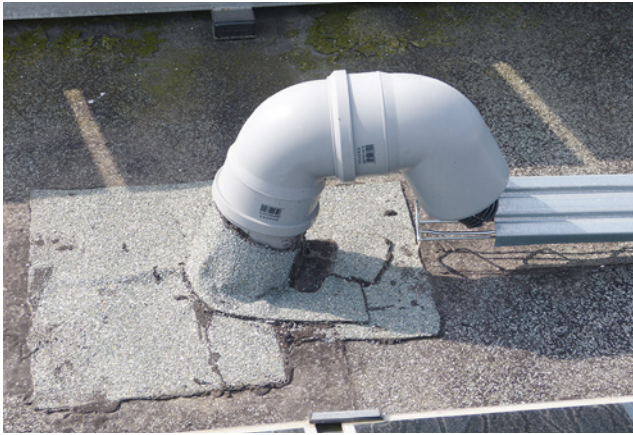
Bild 104: Die Kabeldurchführung durch das Dach ist nicht brandsicher.
