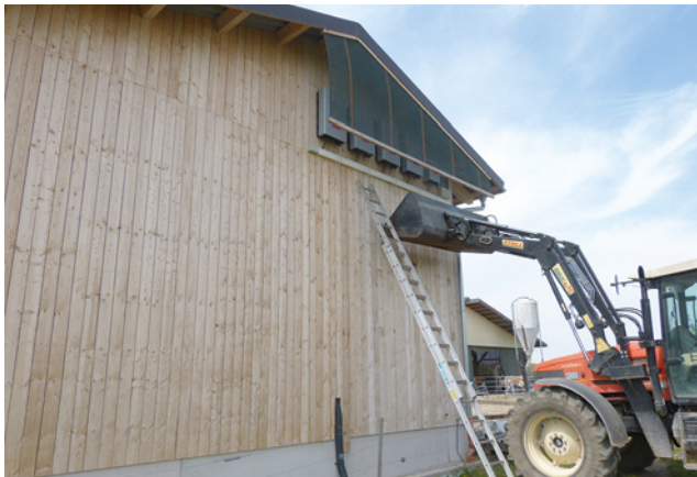
Bild 93: Der Zugang zu den Wechselrichtern ist gefährlich.
