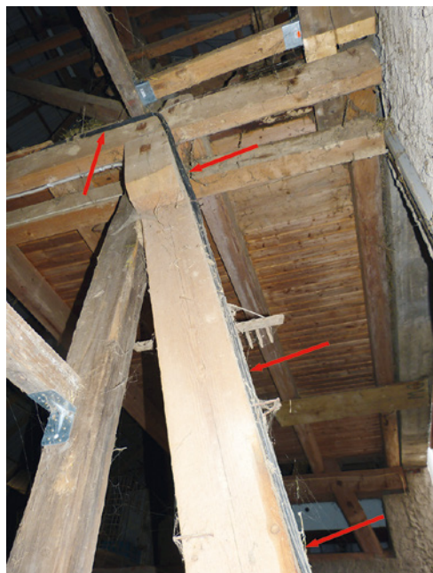
Bild 85 und 86: Leitung ohne normgemäße Befestigung zwischen schräg eingeslagenen Nägeln
