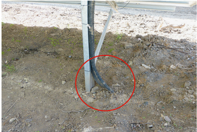
Bild 37: Kabelgänge von Freifeldanlagen, die nur mit Kunststoffrohren geschützt sind, können bei Mäharbeiten zerstört werden.
