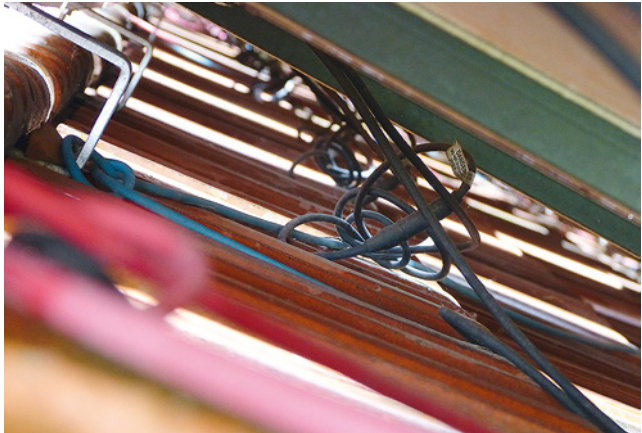
Bild 22: Typisches Bild unter dem Generatorfeld: auf der Dachfläche aufliegende Leitungen
