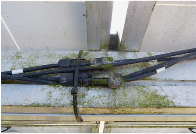
Bild 34: Dauernässe führt zur Beeinträchtigung der Dauerhaftigkeit.
