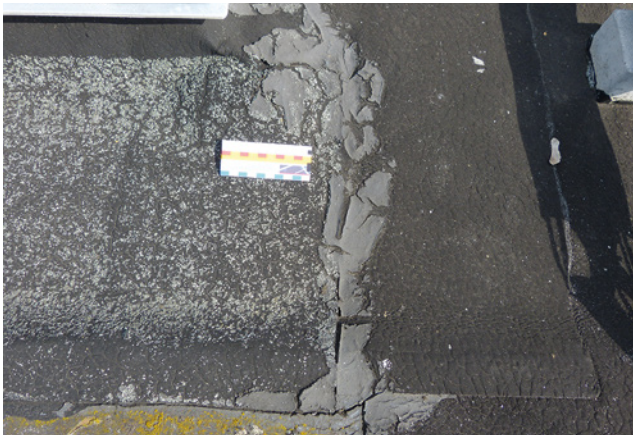
Bild 114: Der schlechte Zustand der Dachhaut kann schwere Brände nach sich ziehen.
