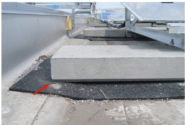
Bild 78: Das punktuelle Auflager im Abdichtungsrandbereich führt früher oder später zu Schäden.
