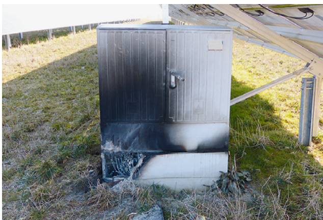
Bild 137: Brandschaden an einem Generatoranschlusskasten einer Freifeldanlage
