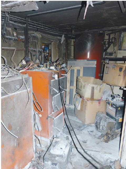
Bild 165: Heizungsraum nach einem Brand an einem Lithium-Ionen-Akku
