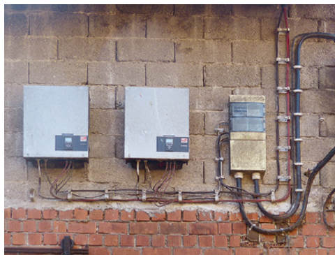
Bild 99: Außerhalb des Gebäudes angebrachte Wechselrichter
