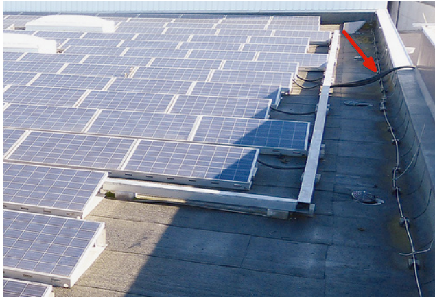
Bild 122: Fehler bei Leitungsverlegung, Leitungsschutz und Trennungsabstand: Der Schutz gegen Witterungseinflüsse fehlt und die Leitungen liegen parallel zum Blitzableiterdraht.
