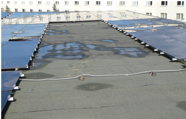
Bild 119: Häufiger Fehler: ein überbauter äußerer Blitzschutz
