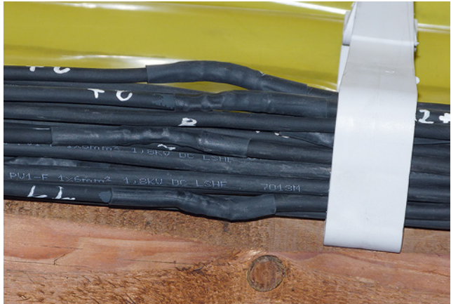
Bild 42: Nicht statthafte Leitungsverlängerung und Isolierung mit Schrumpfschlauch
