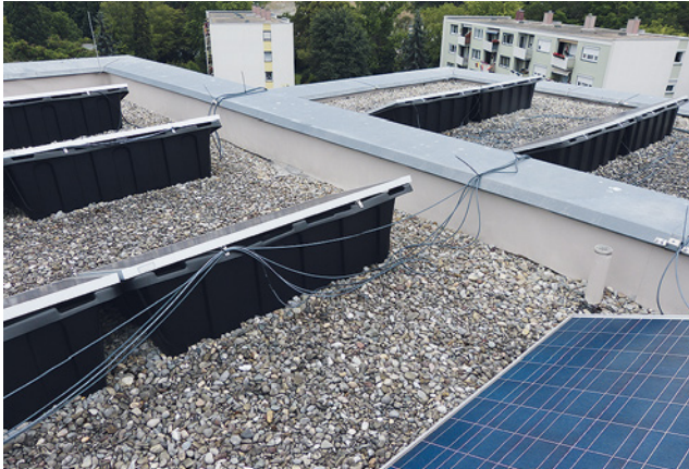
Bild 118: Mit Leitungen überführte Brandwand, die zudem keinen ausreichenden Leitungsschutz hat
