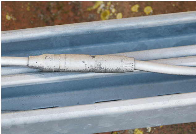
Bild 21: Ausgeblichene Gleichstromleitung, 10 Jahre alt
