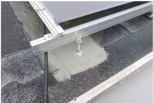
Bild 81: Direktbefestigungen mittels Stockschrauben sind nur kurzfristig dicht, wie man an der bereits erfolgten Nachbesserung erkennen kann.
