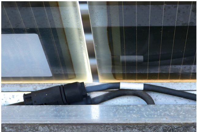
Bild 33: Auch kleine Lichteinfälle hinterlassen eine UV-schädigende Wirkung.
