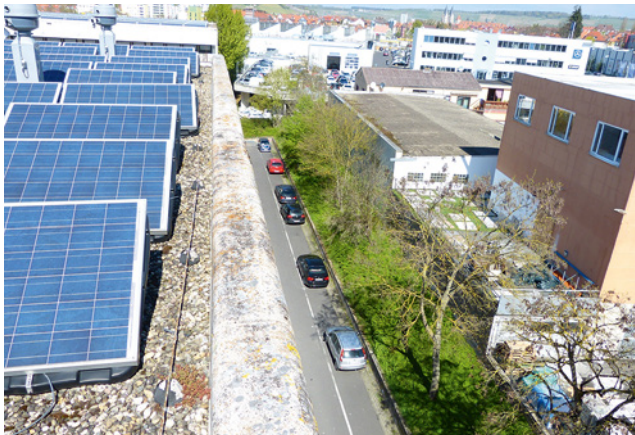
Bild 74: Module, die bis zur Absturzkante gebaut wurden
