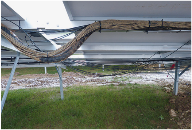
Bild 31: Nicht ausreichend befestigte Kabelbündelungen und ungeschützt über Metallkanten geführte Leitungen verkürzen deren Dauerhaftigkeit.
