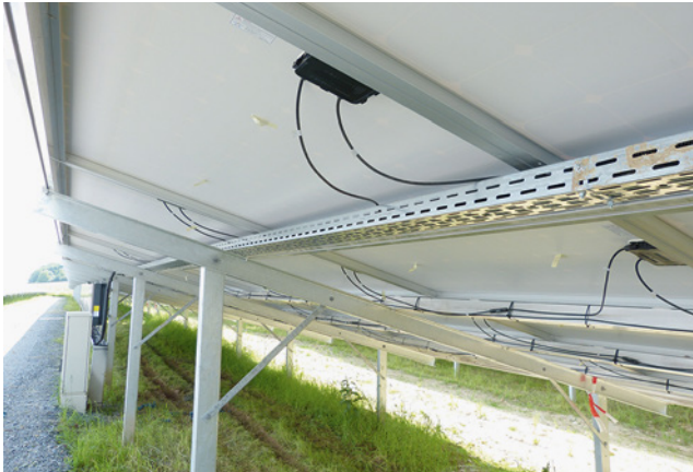
Bild 35: Gutes Beispiel einer fachgerechten Leitungsverlegung bei Leitungsbündelungen und deren Schutz
