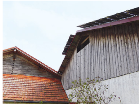
Bild 12 und 13: Die überstehende Modulanordnung bietet ideale Windangriffsflächen.
