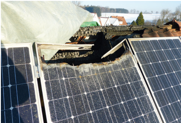
Bild 131: Brand an einer Photovoltaikanlage: Die Ursache war ein technischer Defekt im Modulbereich.
