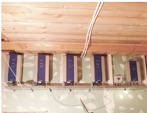
Bild 64 und 65: Durch den zu geringen Abstand zur oberen Begrenzung entsteht ein erheblicher Wärmestau. In Verbindung mit der Holzdecke ist das bei einer gemessenen Temperatur von 70 °C in brandschutztechnischer Hinsicht problematisch.
