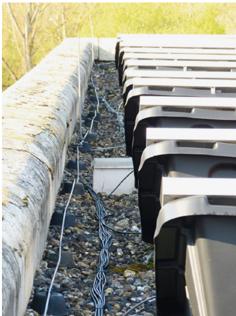
Bild 122: Fehler bei Leitungsverlegung, Leitungsschutz und Trennungsabstand: Der Schutz gegen Witterungseinflüsse fehlt und die Leitungen liegen parallel zum Blitzableiterdraht.
