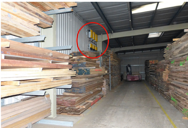
Bild 110: Die Wechselrichter innerhalb eines Holzlagers sind nicht zulässig.
