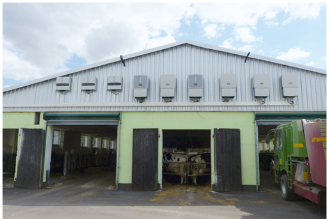
Bild 62: Der Zugang zu den Wechselrichtern ist erheblich eingeschränkt.
