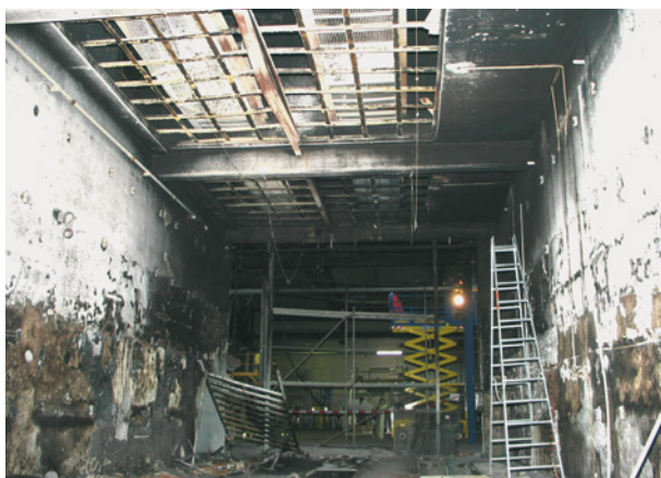
Bild 84 ■ Zustand der Spritzkabine nach dem Brand
