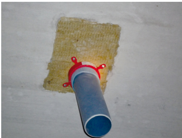
Bild 53 ■ Fehlerhaft eingebaute Schottung (Befestigung entspricht nicht der abZ)
