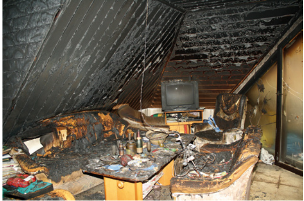
Bild 71 ■ Brandentstehungsbereich im Dachgeschoss
