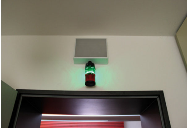
Bild 37 ■ Informationsleuchte für Gehörlose im Notfall
