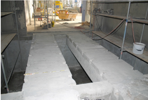
Bild 88 ■ Fertiggestellte Betonsanierung
