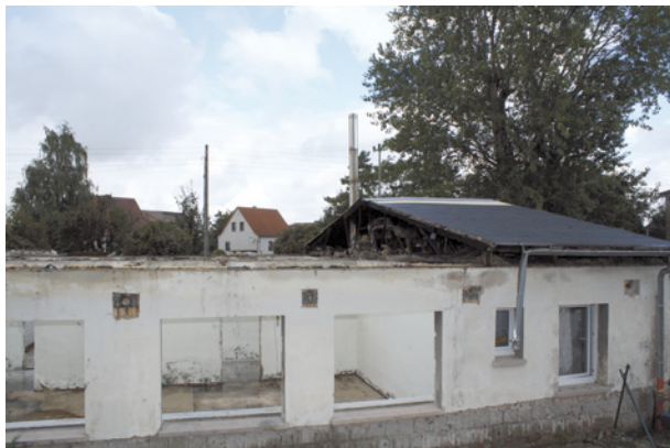
Bild 77 ■ Östlicher Gebäudeteil zwischen der Kita und dem Bereich Heizung/Öllager ohne Trennwand im Dachraum
