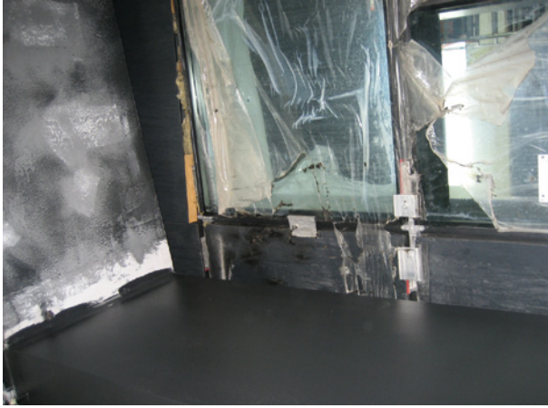
Bild 100 ■ Brandschaden an neuen Bauteilen
