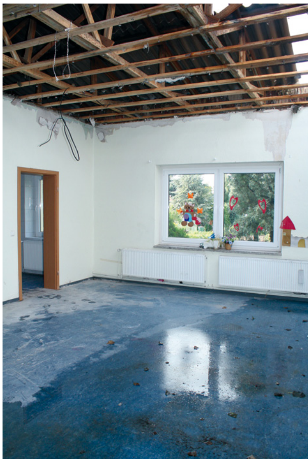
Bild 79 ■ Dachkonstruktion von innen nach dem Entfernen des Dachaufbaus
