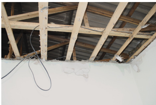
Bild 80 ■ Unterkonstruktion der Trockenbaudecke mit Verbindung über den Trennwänden im Dachraum
