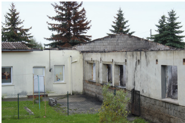
Bild 78 ■ Außengiebel der Mieterbereiche ohne Trennwand im Dachraum
