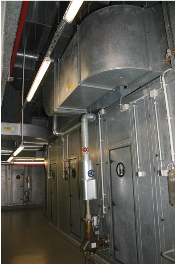
Bild 92 ■ Komplexe Lüftungsanlage mit teilweiser Kontamination
