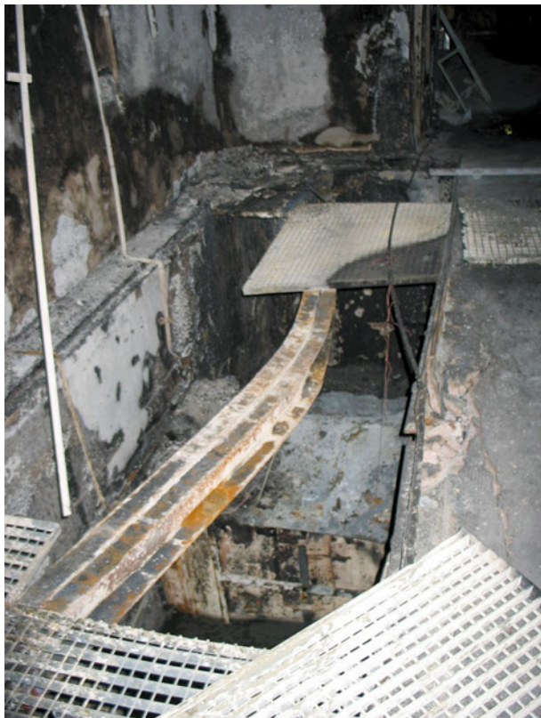
Bild 85 ■ Betongrube mit verformtem Stahlträger der Unterflurabsaugung nach dem Brand
