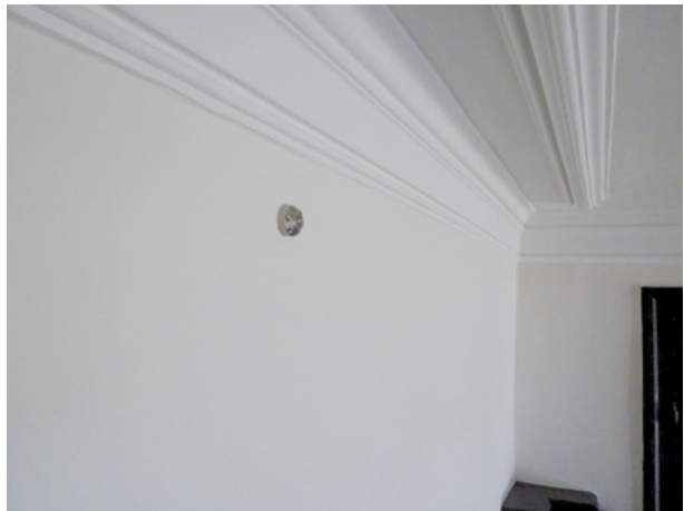
Bild 31 ■ Düse einer Hochdruck-Wassernebel-Löschanlage
