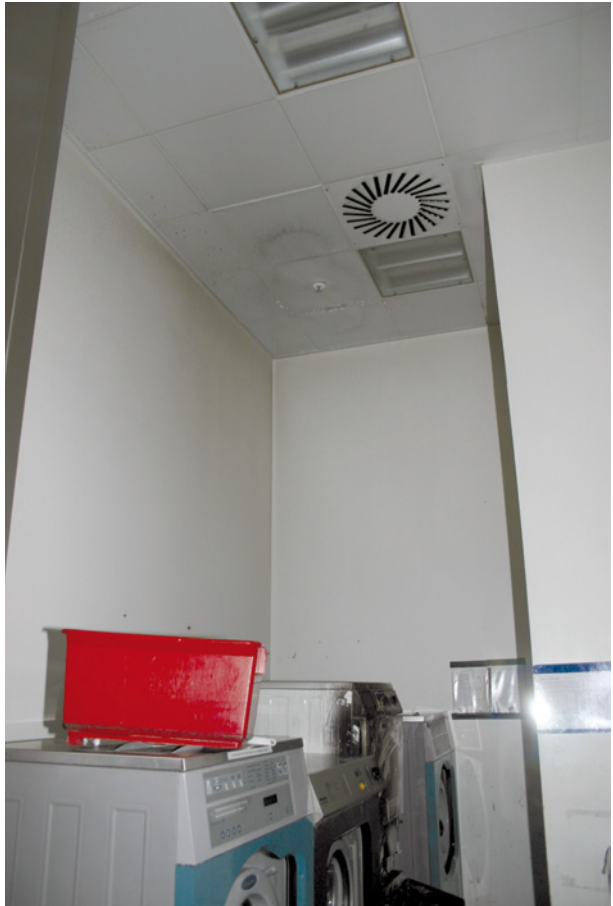
Bild 90 ■ Rußbeaufschlagung und Lüftungsöffnung im Deckenbereich
