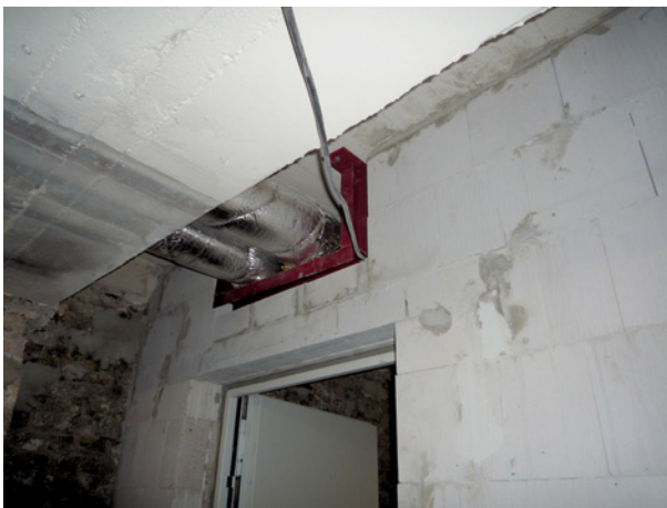
Bild 44 ■ Nicht koordinierte Durchführung muss zurückgebaut werden
