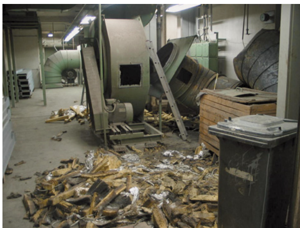
Bild 86 ■ Zustand der Lüftungsanlage nach dem Brand
