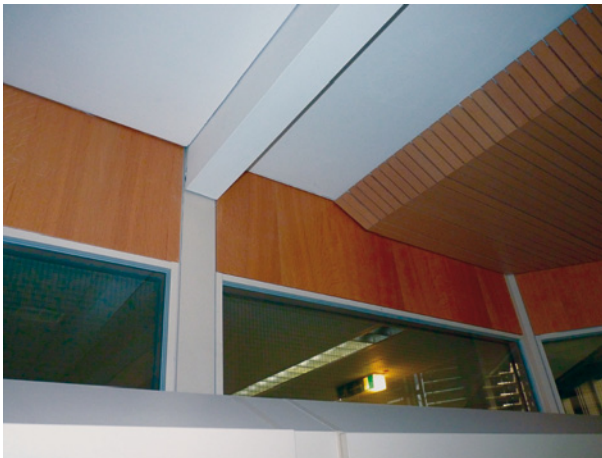
Bild 48 ■ Vorhandenes Trennwandsystem ohne brandschutztechnische Klassifikation
