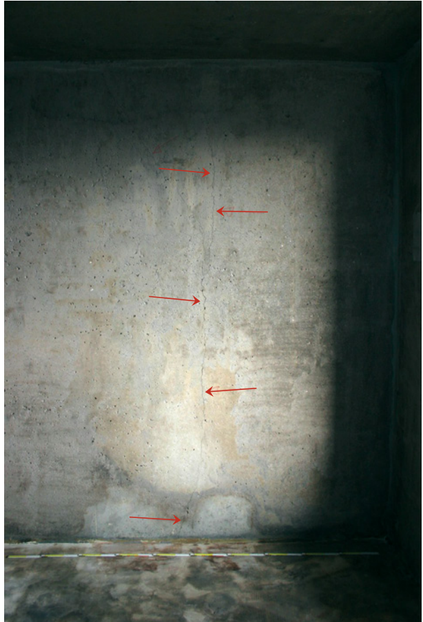
Bild 69 ■ Standort des TV-Gerätes nach der Sa- nierung (Vertikalriss in Betonwand)
