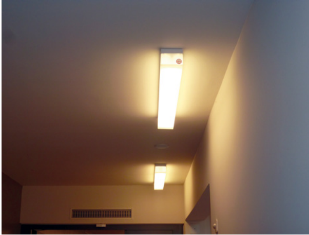
Bild 28 ■ Sicherheitsbeleuchtung in einem notwendigen Flur
