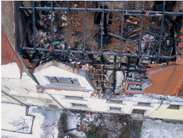
Bild 74 ■ Dachstuhlbrand aufgrund Feuerwerkseinwirkung
