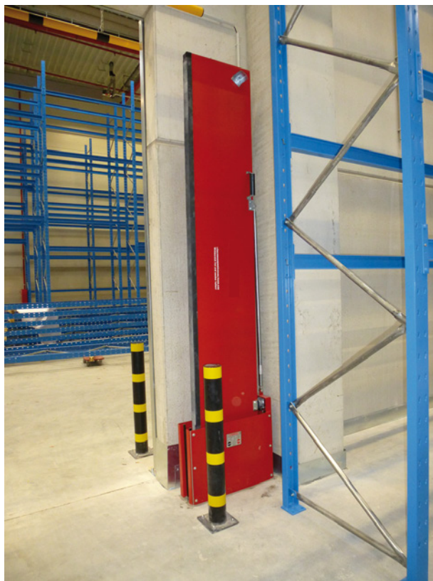
Bild 11 ■ Löschwasser-rückhalteinlage innerhalb einer Lagerhalle
