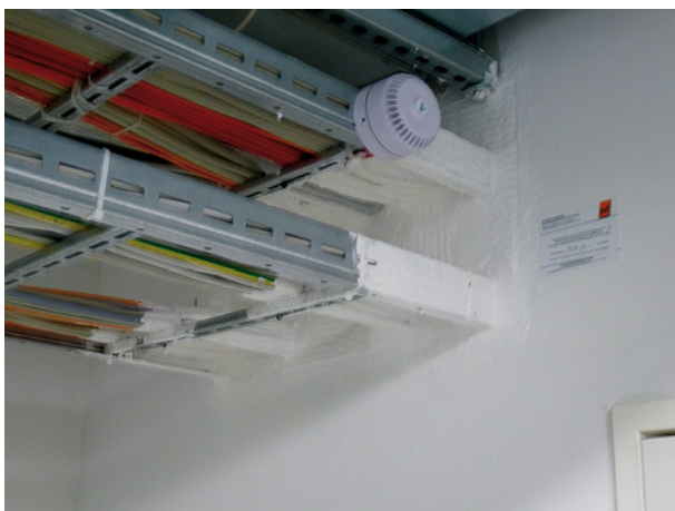
Bild 20 ■ Ordnungsge- mäßige Leitungsschottung gemäß dazugehöriger allgemeiner bauaufsicht- licher Zulassung (abZ)
