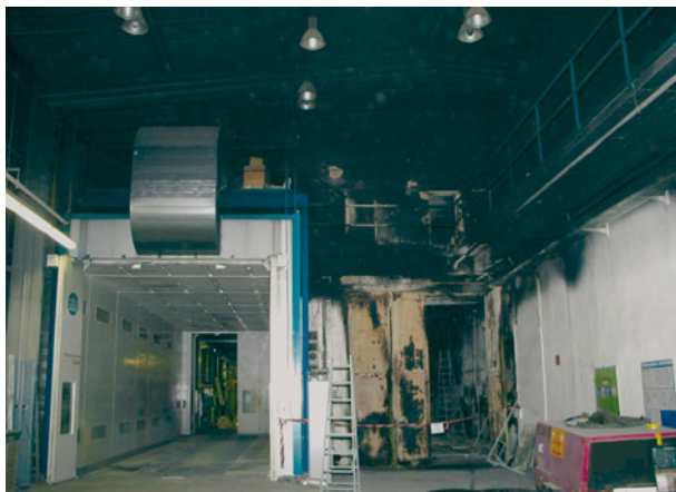
Bild 83 ■ Spritzkabine mit starker Rauchgasverschmutzung
