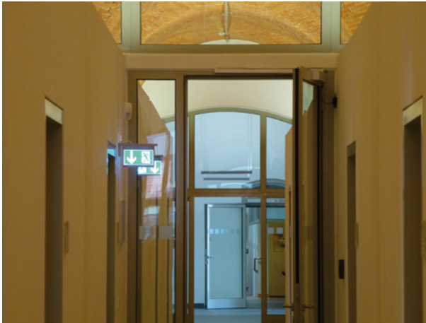
Bild 29 ■ Rettungswegausweisung mit einem hinterleuchteten Rettungswegkennzeichen
