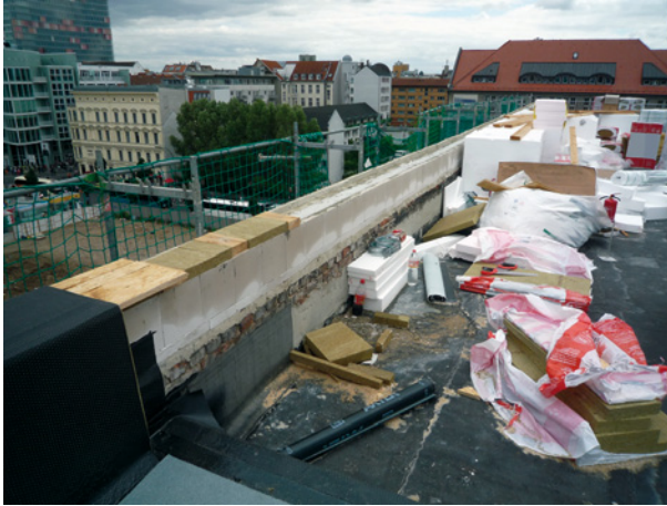
Bild 47 ■ Brandwand wurde mit brennbaren Bauteilen überbaut (Rückbau erforderlich)
