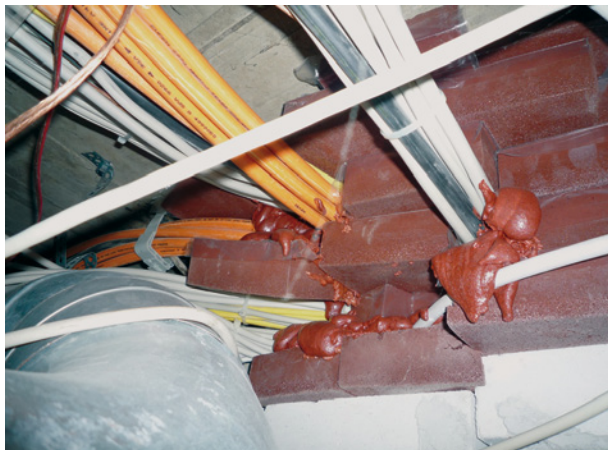
Bild 54 ■ Abschlottung nicht gemäß abZ ausgeführt
