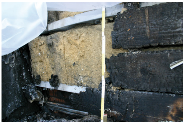
Bild 63 ■ Abdeckung im Bereich des Brandherdes
