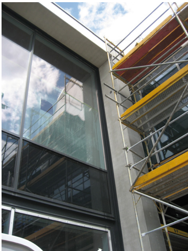
Bild 98 ■ Unbeschädigte Bandrasterfassade
