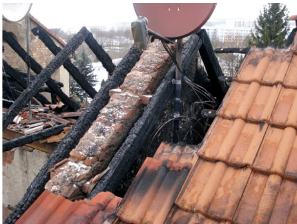
Bild 76 ■ Brandweiterleitung über Dachlattung
