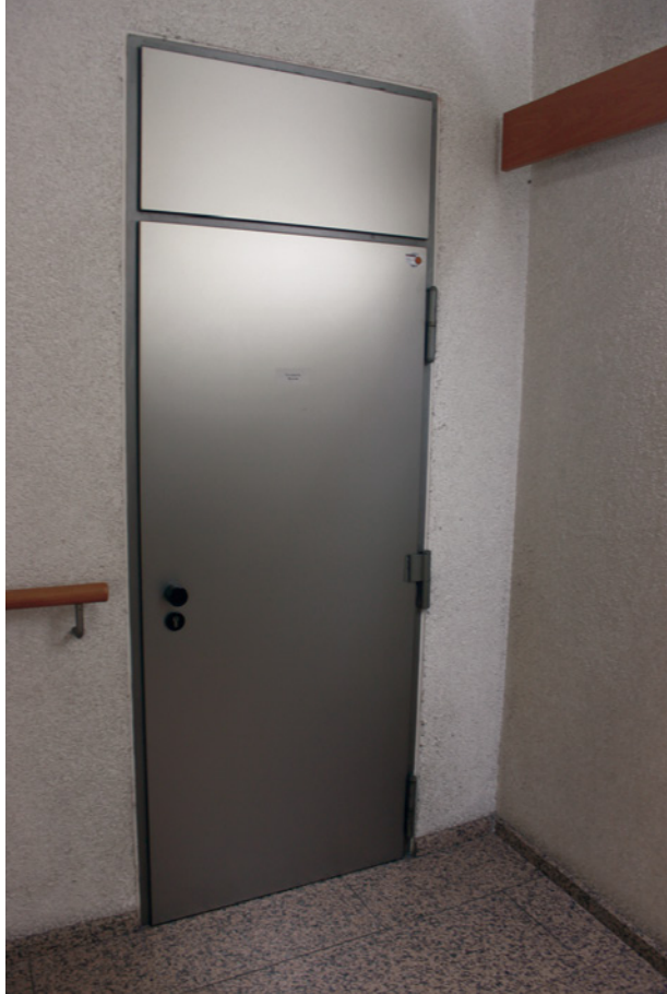
Bild 49 ■ Feuerschutztür nicht zulassungskonform eingebaut
