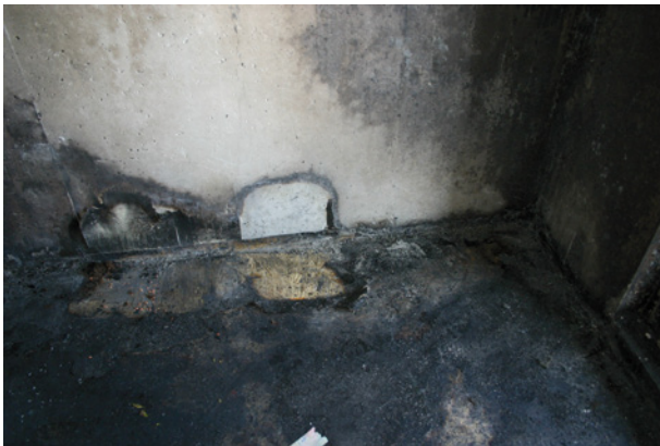
Bild 68 ■ Standort des TV-Gerätes mit Hauptbrandwirkung
