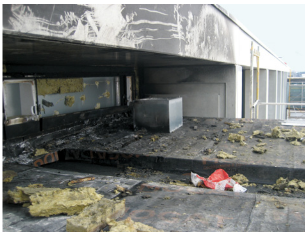
Bild 99 ■ Oberer Fassa- denanschluss mit Beton- bauteilen
