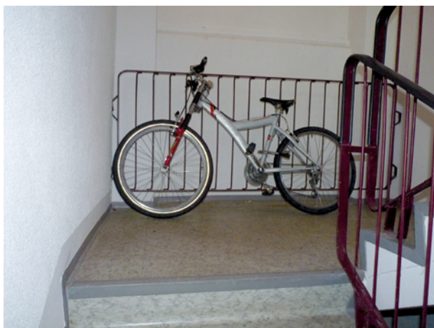
Bild 57 ■ Brandlasten im Treppenraum, zudem Rettung erschwert
