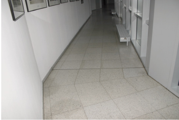
Bild 91 ■ Verfärbung des Natursteinbodenbelags infolge Feuchte
