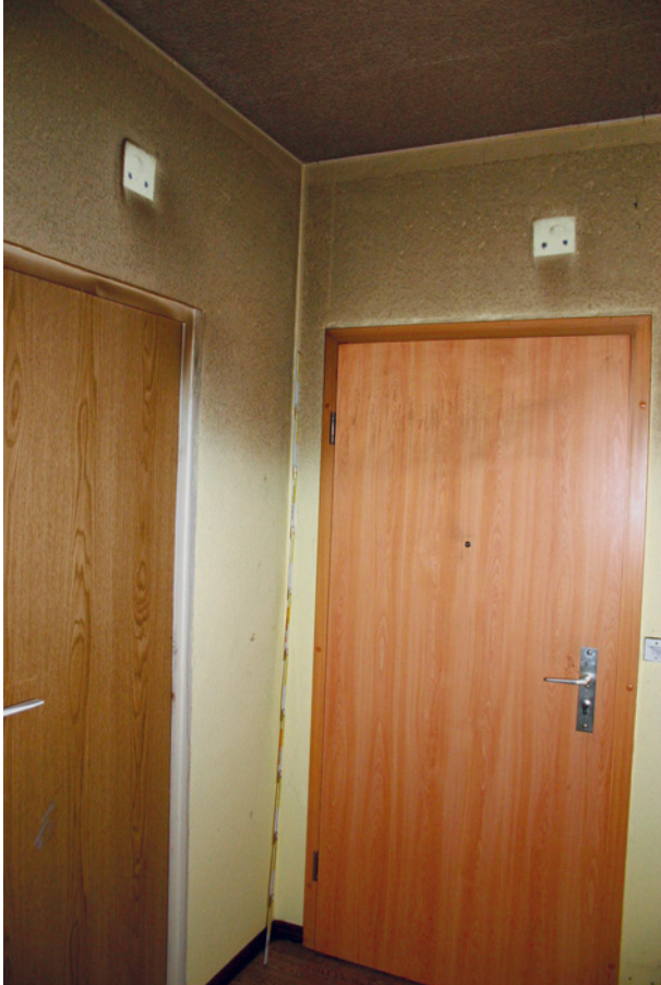
Bild 67 ■ Rußablagerungen im Decken- und Wandbereich
