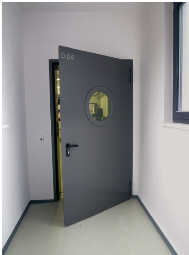
Bild 2 ■ Mangel an einer baulichen Brandschutzmaßnahme (Tür war nicht selbstschließend)
