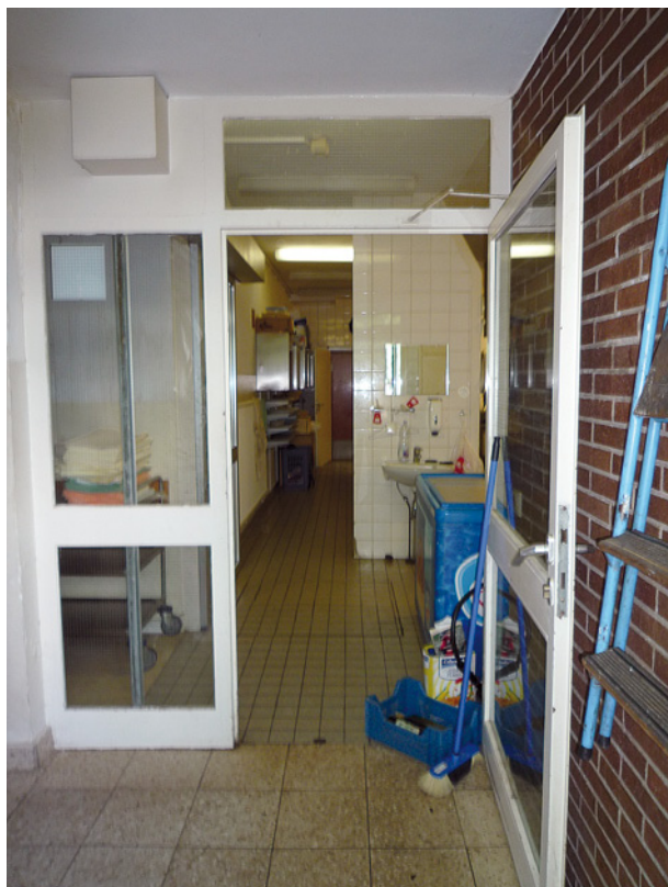
Bild 58 ■ Selbstschließung außer Betrieb gesetzt
