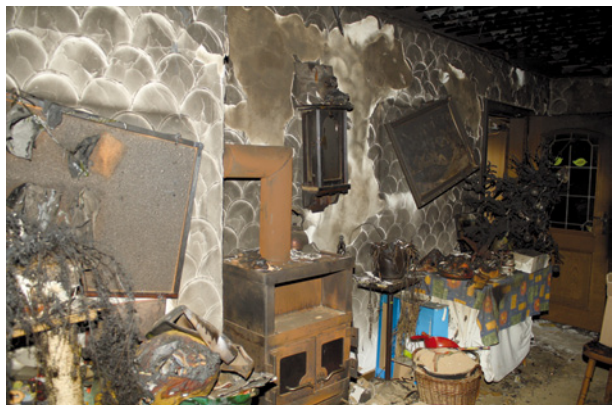
Bild 73 ■ Weiterleitung des Brandes im Wohnraum
