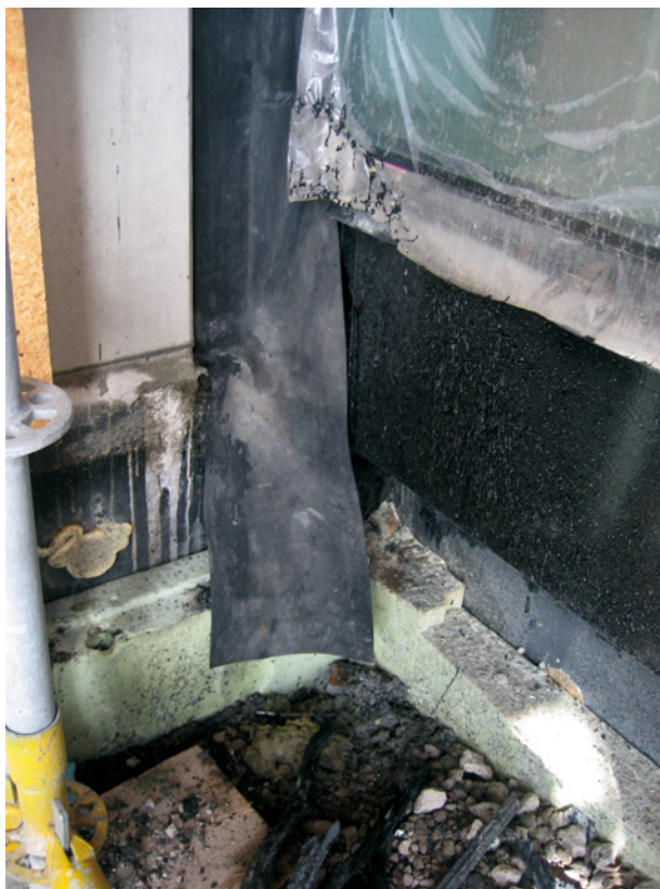
Bild 97 ■ Fassadensockel mit Abdichtung (Brandentstehungsbereich)
