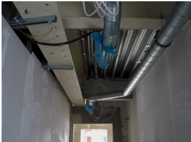
Bild 50 ■ Trockenbau- wand an Träger mit nicht nachzuweisender Be- schichtung (Rückbau erforderlich)
