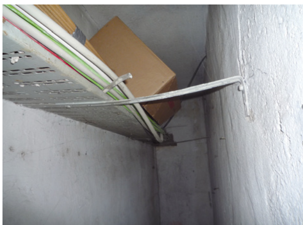
Bild 56 ■ Unzulässige Belegung einer Kabeltrasse
