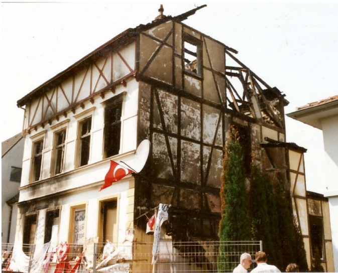
Abb. 2: »Das abgebrannte Haus der Familie Genç auf der Unteren Wernerstr. 81 in Solingen«.
