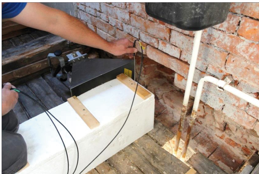
Abb. 27: Einsetzen der Messfühler in den bereits gedämmten Deckenbalken
