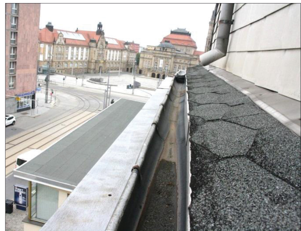
Abb. 4: neu ausgebildete Dachentwässerung
