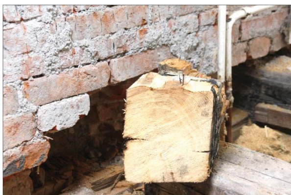
Abb. 11: Schnittstelle des Deckenbalkens
