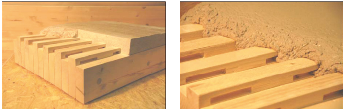
Abb. 10: Flächenverbund in Brettstapel-Verbunddecken 4
