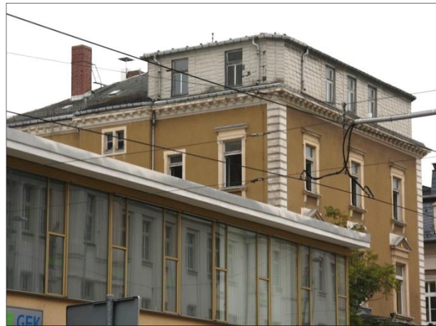
Abb. 2: Erkennbare Anbindung des bauzeitgerechten Zeltdachs an die Aufstockung
