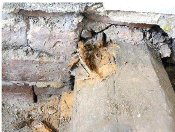
Abb. 6: Befall durch den Braunen Keller- oder Warzenschwamm, in Vergesellschaftung mit den Larven des Trotzkopfs
