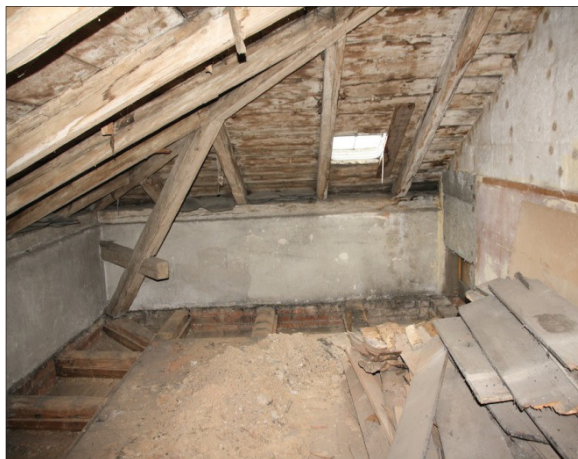
Abb. 3: historischer Dachaufbau
