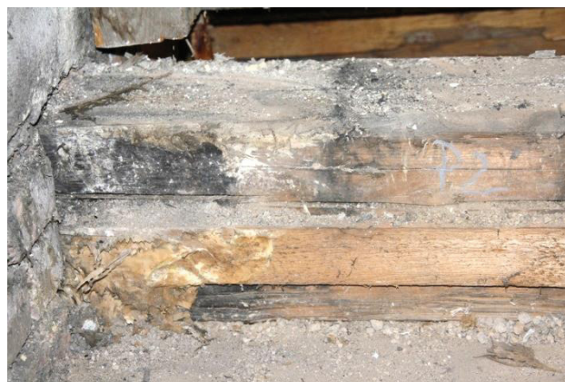
Abb. 7: Befall durch den Echten Hausschwamm
