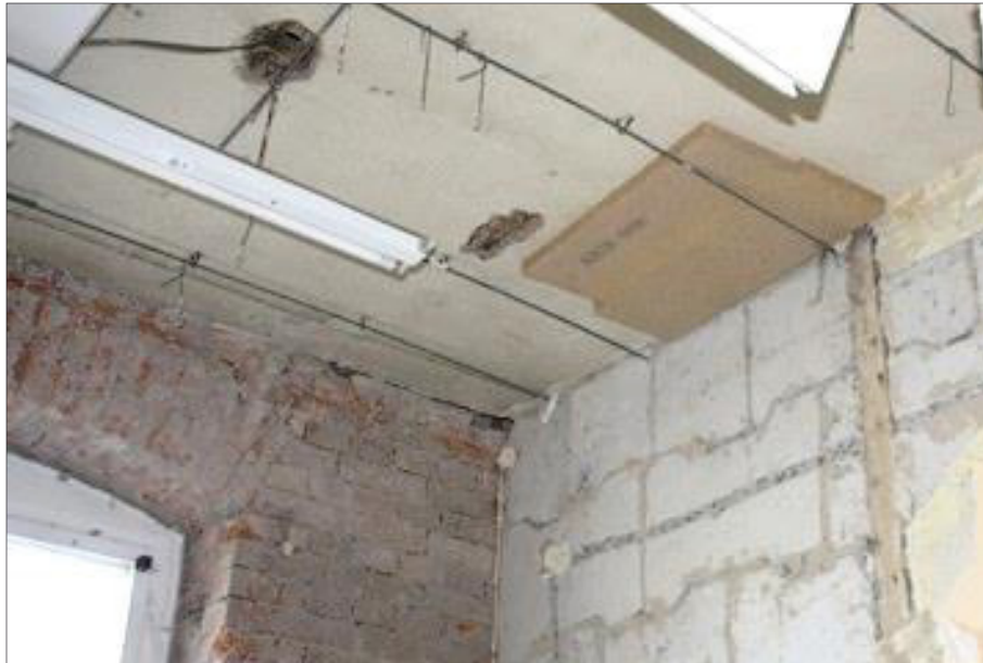
Abb. 35: Deckenunterseite in Versuch 4 mit Wärmedämmung durch Holzweichfaserplatte (Foto: Baumann-Ebert)
