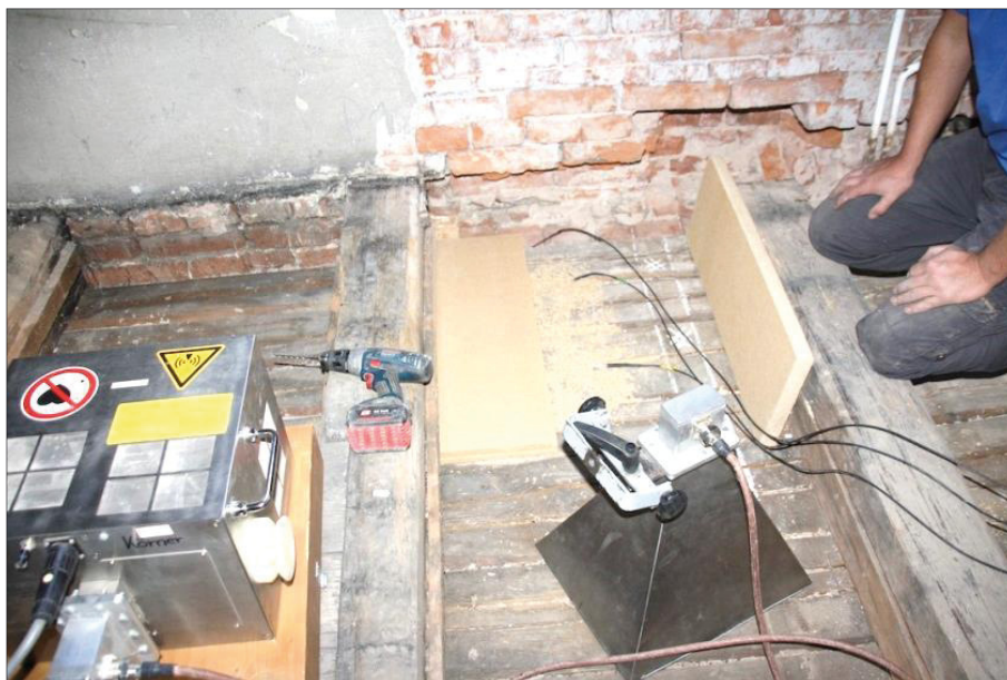
Abb. 32: Deckenoberseite in Versuch 3 während der Vorbereitung für die Behandlung, Fugen mit Hobelspänen aufgefüllt, Messfühler in Sparschalung eingesetzt, Abdeckung mit Holzweichfaserplatte
