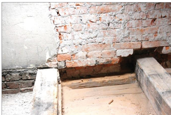
Abb. 9: Balkenfeld zwischen DB 3 + 4 geschädigte Mauerschwelle
