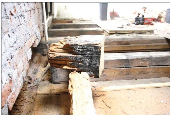
Abb. 10: aus dem Befallsbereich herausgeschnittener Balkenkopf und entfernte Mauerschwelle
