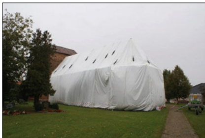
Abb. 37: Fertiggestellte Schiffeinhausung Kirche Kletznick
