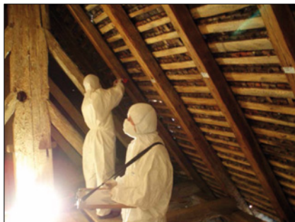
Foto 4: Erfassung und Dokumentation aller Holzbauteile vor dem Rückbau der historischen Konstruktion – auch diese Arbeiten erfolgten aufgrund der Gesundheitsgefährdung als Arbeiten im kontaminierten Bereichen unter Verwendung entsprechen der persönlicher Schutzausrüstung.
