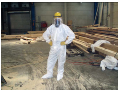
Foto 13: In der angemieteten Montagehalle wurden die Hölzer eingelagert und bearbeitet, wobei die Arbeiten bis zur Dekontamination anfangs grundsätzlich als Arbeiten im kontaminierten Bereich ausgeführt werden mussten.
