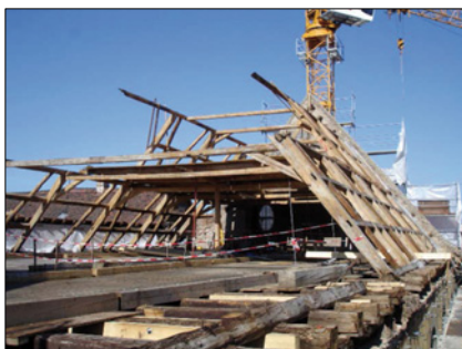
Foto 12: Nach Demontage der Sparrenlage wurde die liegende Stuhlkonstruktion abschnittsweise ebenfalls rückgebaut, zum Erdboden transportiert und von dort in eine Montagehalle am Rande der Stadt verbracht.
