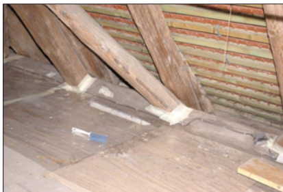
Abb. 38: Oberseitige Deckenabklebung Kirche Kletznick
