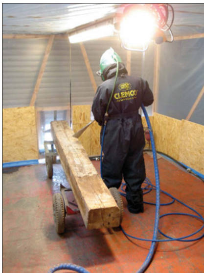
Foto 14: Reinigung der holzschutzmittelbelasteten Hölzer im Trockeneisstrahlverfahren.
