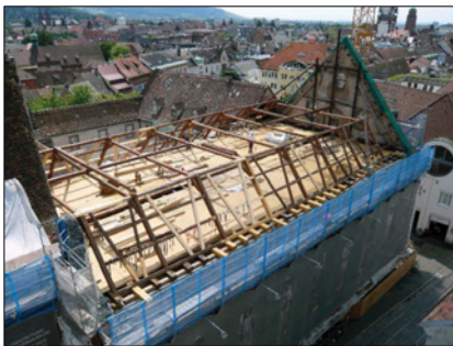
Foto 18: Die dekontaminierten und maskierten Hölzer wurden wieder zur Baustelle transportiert und klassisch zimmermannsmäßig aufgerichtet, hier steht schon der liegende Stuhl der ersten Dachebene.
