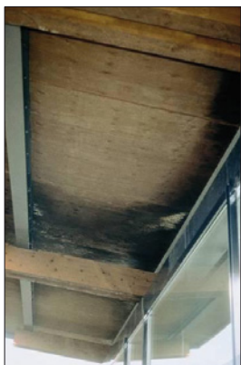
Abb. 7: Feuchteschaden wegen konvektiv eingetragener Feuchte an einem belüfteten Flachdach, aus [Borsch-Laacs 2011]
