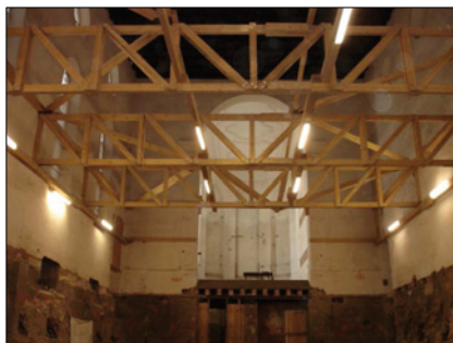
Foto 1: Langhaus der gotischen Hallenkirche vor den Umbaumaßnahmen, die Aussteifungsebene wurde im Zuge der Fundamentertüchtigung als bauzeitliche Sicherung eingebaut.
