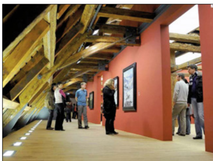
Foto 22: Im Dachgeschoss konnten zusätzliche Ausstellungsflächen geschaffen, die historische Holzkonstruktion sichtbar belassen und die Schadstoffbelastung entsprechend der Sanierungszielstellung minimiert werden.
