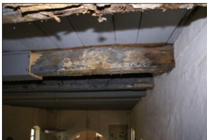
Abb. 36: Typisches Schadbild nach Demontage der Deckenbalkenverkleidung
