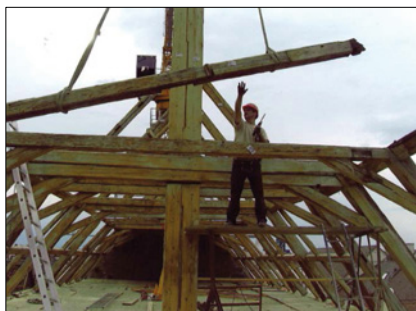
Foto 10: In Abstimmung mit der BG konnten die Schutzmaßnahmen beim Rückbau auf Handschuhe reduziert werden, da die Liegestäube bereits entfernt worden waren, keine staubenden Tätigkeiten stattfanden und hier in freier Außenluft gearbeitet werden konnte.
