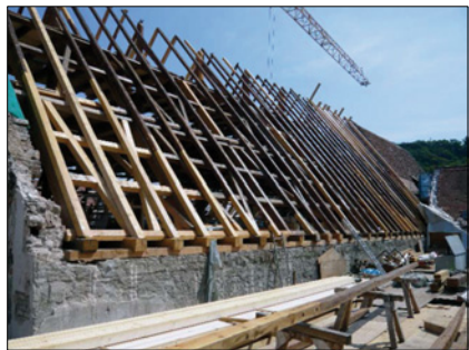
Foto 19: Nach dem Aufschlagen der Sparrenlage war die zimmermannsmäßige Instandsetzung des Langhauses im Wesentlichen abgeschlossen.
