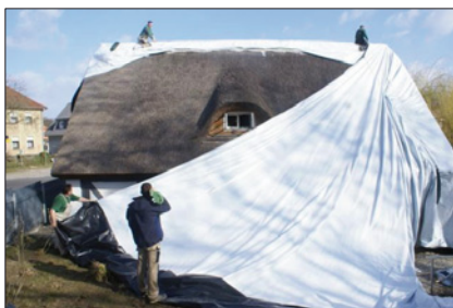
Abb. 18: Kossätenhaus in Ferch während der händischen Einhausung
