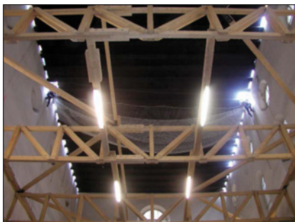
Foto 9: Mittels Seilzugangstechnik wurden vor dem Rückbau des Dachstuhls zunächst Absturznetze unterhalb der Holzbalkendecke über dem Langhaus montiert.
