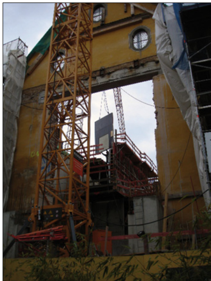
Foto 7: Der Westgiebel wurde geöffnet und erhielt einen erkerartigen Anbau, der nunmehr zur Haupteingangsöffnung genutzt wird.
