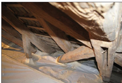
Abb. 21: Neuendorfer Anger, Potsdam – geklebter Anschluss zur Balkenlage
