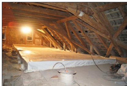
Abb. 22: Neuendorfer Anger, Potsdam – zusätzlich eingehauster Pilzbereich
