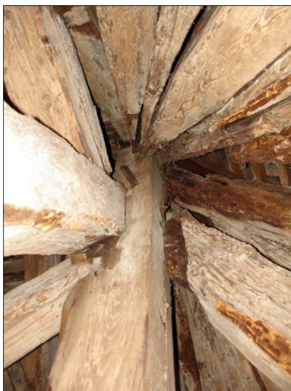
Foto 3: Die historische Holzkonstruktion wurde im Verlauf ihrer Baugeschichte mit gesundheits-schädlichen Holzschutzmitteln behandelt. Es wurden im Zuge der Begutachtung und Planung PCP, Lindan und Chlornaphtalin als Schadstoffe festgestellt.
