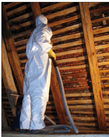
Foto 8: Die historische Holzkonstruktion wurde vor dem Rückbau einer gründlichen Dekontaminationsmaßnahme durch Absaugen aller Oberflächen unterzogen.
