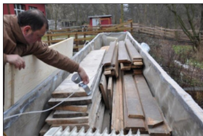
Abb. 33: Montage der Gaszuleitung
