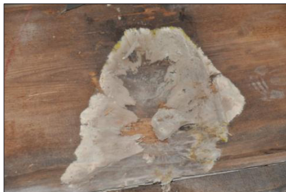
Abb. 30: Nachweislich aktives Mycel des Echten Hausschwamms
