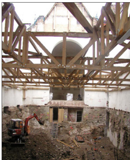
Foto 5: Langhaus der gotischen Hallenkirche, nachdem die Dachkonstruktion abgenommen worden war, konnte die Rohbaufirma mit den Einbauten beginnen.
