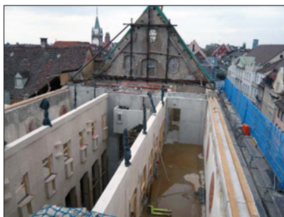
Foto 6: Langhaus nach Einbau der neuen emporenartigen Ausstellungsebenen in Sichtbetonqualität.
