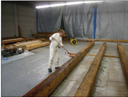
Foto 16: Maskierung der gestrahlten Hölzer mit einem PU-Harz und abschließendem Acrylatanstrich.
