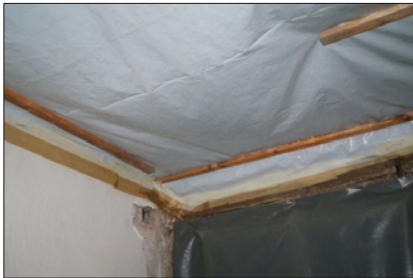
Abb. 23: Neuendorfer Anger, Potsdam – mit Leisten und Klebebändern gesicherter Wandanschluss
