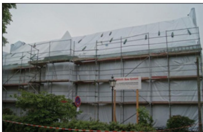
Abb. 17: Neuendorfer Anger, Potsdam – Komplett einhausung
