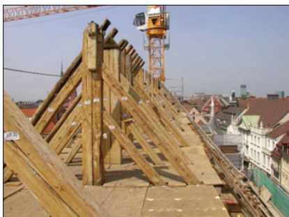
Foto 11: Alle Holzbauteile wurden beginnend mit der Sparrenlage zimmermannsmäßig einzeln und in umgekehrter Reihenfolge zum historischen Aufschlagen der Dachkonstruktion wiederzurückgebaut.
