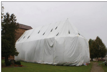
Abb. 12: Kirche Kietznick – Einhausung Kirchenschiff
