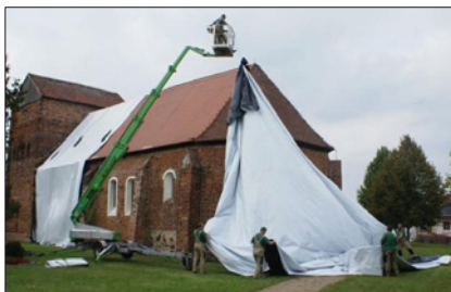
Abb. 16: Kirche Kietznick – Hebebühne zur Planenmontage
