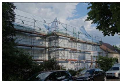
Abb. 41: Fertig eingehautes Gebäude
