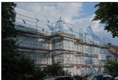
Abb. 14: Neuendorfer Anger, Potsdam – Einhausung Gebäude von außen
