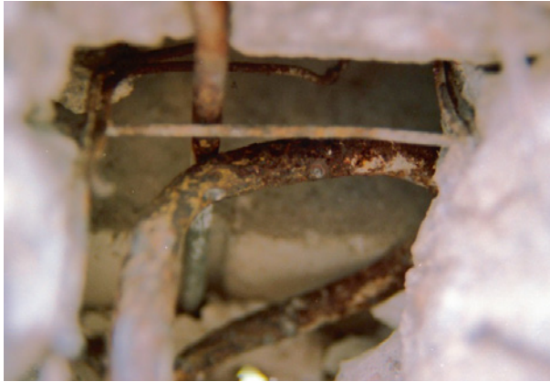
Bild 34 ■ Korrosion eines Stahlstabs (Ø 14 mm) im Verankerungssystem Camus-Dietsch
