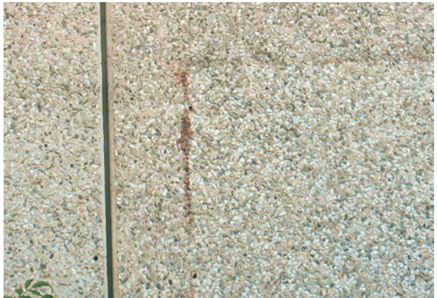
Bild 14 ■ Korrosions- spuren oberhalb eines Bewehrungsstahls
