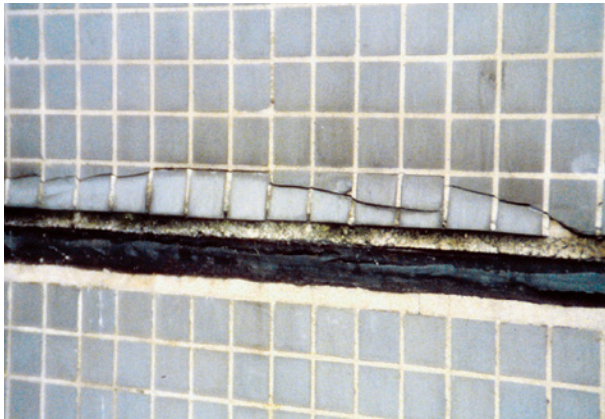
Bild 20 ■ Aufwölbungen der Fliesen und Absprengungen der Fliesenbekleidung am Plattenrand von Wetterschutzschichten; der Schaden ist ca. fünf bis acht Jahre nach der Fertigstellung entstanden
