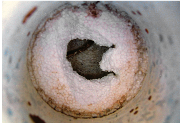
Bild 29 ■ Hohllage zwischen Tragschale und Polystyrol-Wärmedämmung durch Verwölbung der Wetterschutzschicht
