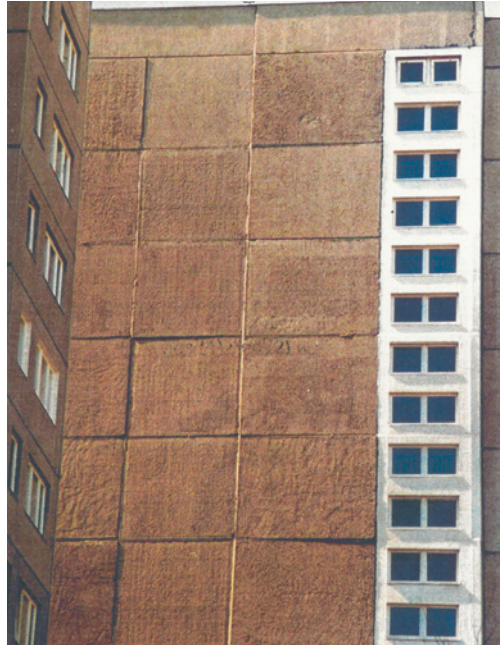
Bild 32 ■ Versprünge bzw. Versätze der Wetterschutzschichten an einem Gebäude des Typs WBS 70
