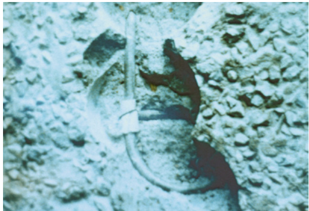
Bild 57 ■ Stichpunktartiges Aufstemmen der Wetterschutzschichten zur Bestimmung des Typs, der Abmessung und des Materials der Traganker
