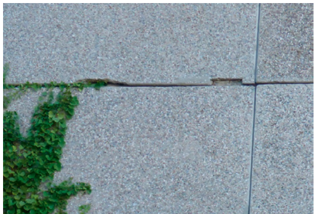
Bild 17 ■ Abplatzungen der Betonnase am unteren Rand einer Wetterschutzschicht an einem Gebäude des Typs WBS 70
