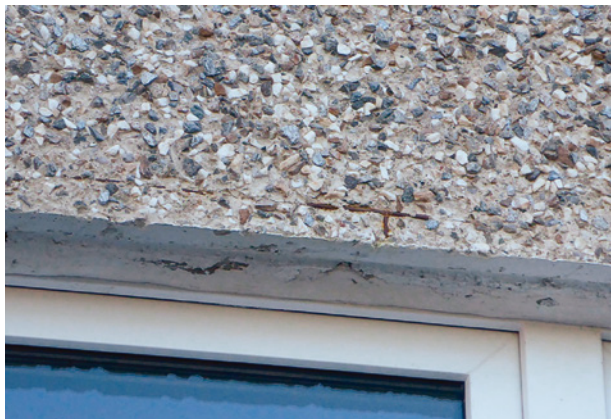
Bild 15 ■ Betonabplat- zungen aufgrund von Bewehrungskorrosion an der Oberfläche von Wetterschutzschichten
