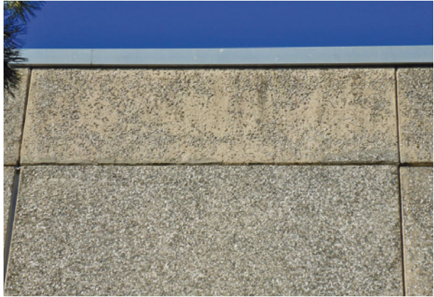
Bild 24 ■ Abfallen einzelner Kiesel und Splittkörner von der Oberfläche der Wetterschutzschichten
