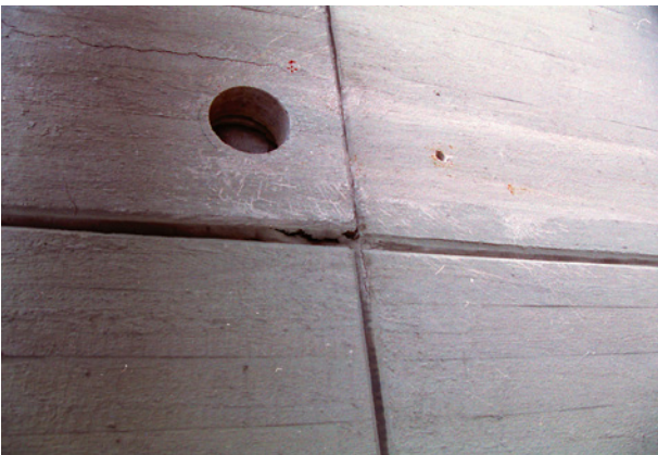
Bild 28 ■ Verwölbung der Wetterschutzschicht mit dadurch bedingtem Abriss des Fugendichtstoffs (Untersuchung durch Bohrkernentnahme, siehe Bild 29)
