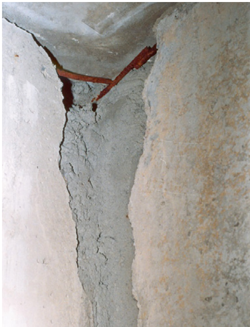
Bild 41 ■ Unzureichender Betonverguss und freiliegende Bewehrung in einer Vertikalfuge zwischen zwei Wandelementen
