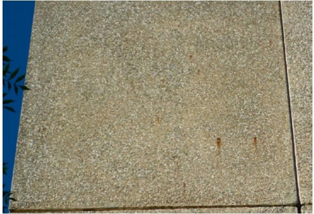
Bild 13 ■ Korrosions- spuren auf der Oberfläche von Wetterschutzschichten
