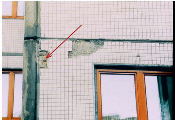
Bild 23 ■ Die Korrosion von Einbauteilen führte zur Absprengung der keramischen Beläge.
