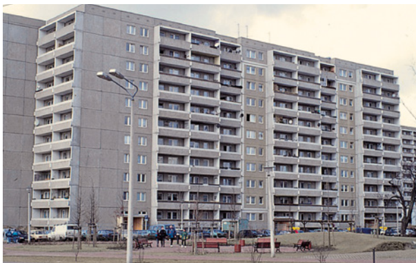
Bild 3 ■ Großtafelbauten des Typs WBS 70 im östlichen Teil Deutschlands (Beispiel aus Berlin)
