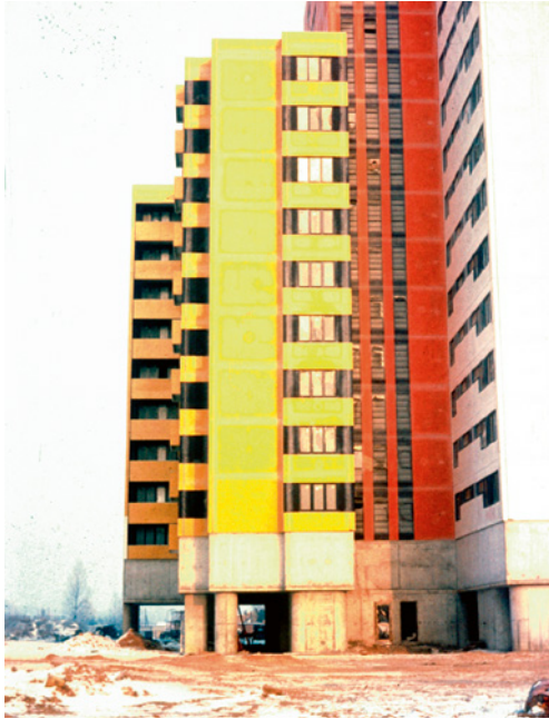
Bild 38 ■ Traganker der Witterschutzschichten und Fugen zwischen Fertigteillementen zeichnen sich als Wärmebrücken an einer mit Raureif überzogenen Großtafelbauwand ab. In den Wärmebrückenbereichen taut der Raureifüberzug durch erhöhten Wärmefluss schneller ab.
