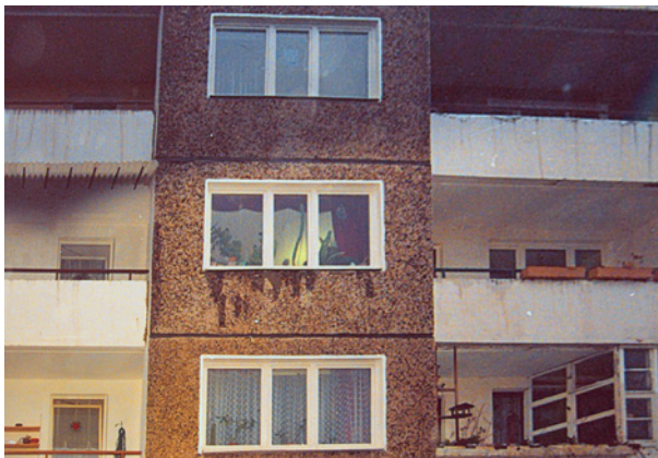
Bild 35 ■ Wasserablaufspuren an der Außenwand im Bereich eines unzureichend eingedichteten Fensterbretts
