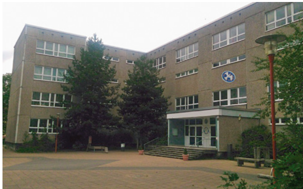
Bild 4 ■ Großtafelbauten des Typs WBS 70 im östlichen Teil Deutschlands (Beispiel aus Rostock)
