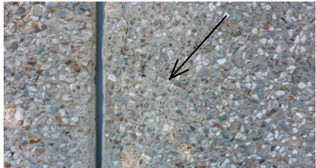
Bild 11 ■ Risse in den Wetterschutzschichten von Giebelwandelementen
