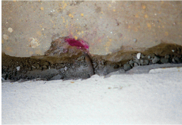
Bild 43 ■ Bewehrungs- anschluss Loggiaboden- platte/Tragschale mit unzureichender Beton- deckung und mangel- haftem Betonverguss
