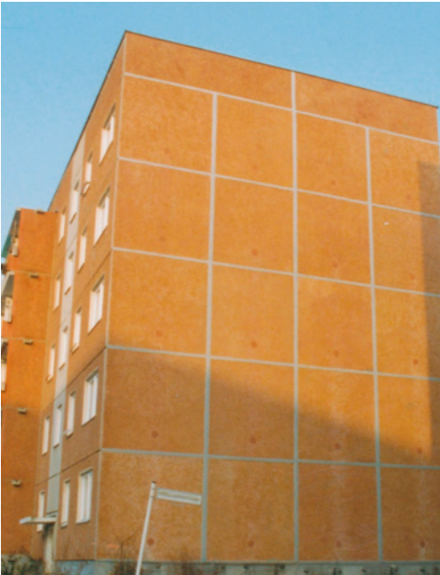
Bild 64 ■ Beispiel eines nachträglich eingebauten Ankers des Typs A; der Zusatzanker ist hier ungünstig angeordnet. Da die ursprünglichen »alten« Traganker in der oberen Hälfte des Wandelements angeordnet sind, entstehen durch den nachträglich eingebauten Anker schädliche Zwangsspannungen (Bild 67).
