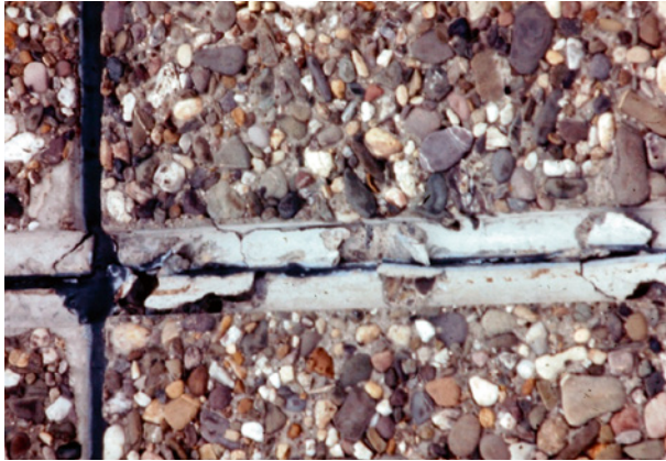
Bild 18 ■ Betonabplatzungen im Fugenbereich der Wetterschutzschicht eines Großtafelbaus
