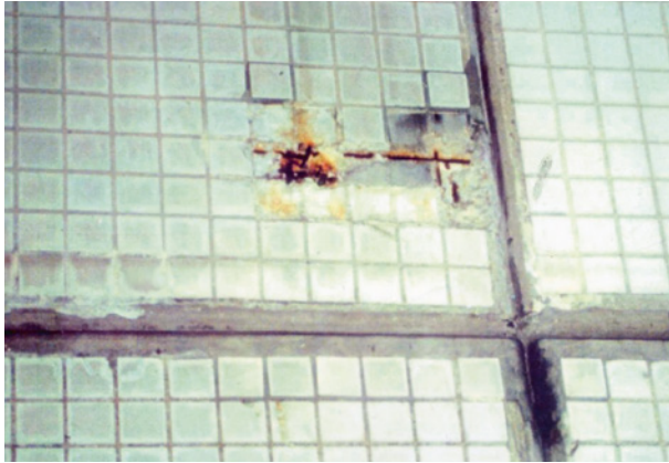
Bild 19 ■ Fliesenabplatzungen infolge korrodierender Bewehrung
