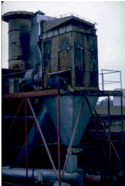
Bild 1: Brandschaden ungeschützte oder nicht richtig geschützte Absauganlage
