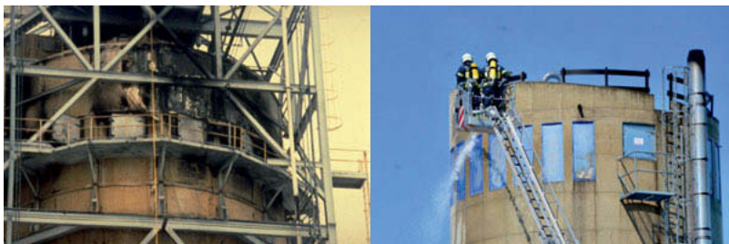
Bild 3: Silobrand: links nach einer Explosion, rechts Brand ohne Explosion
