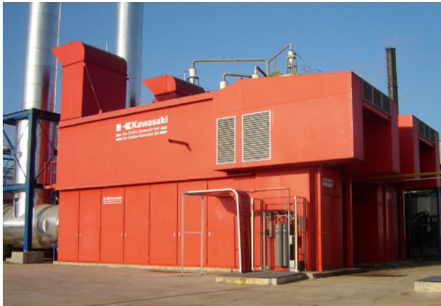
■ Abb. 26: Gasturbine mit 2 · 6,8 MW el und einer Sattdampfleistung von 2 · 15 t/h
