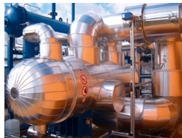
■ Abb. 89: Verdampfer-ORC-Prozess mit Abgaswärmezufuhr aus einem Gasmotor
