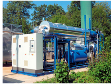
■ Abb. 88: ORC an einem Deponiegas-Biogasmotor am Standort Deponie Altenberge
