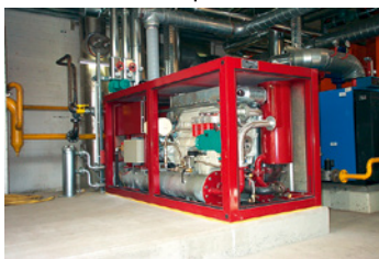
BHKW Modul mit 50 kW el
