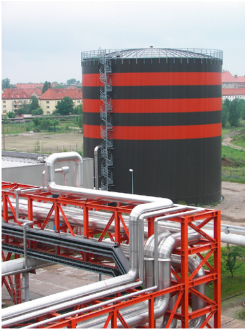
■ Abb. 87: Tagesspeicher der LowEx-Wärmeversorgung in Halle
