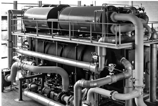
■ Abb. 58: Wärme- und Kälteerzeugung mit einem BHKW
