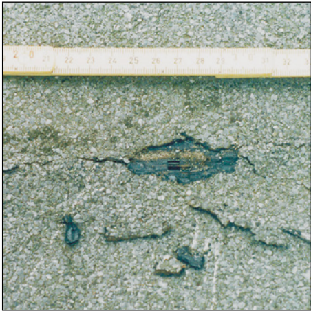
Abb. 46: Schollenförmiges Abblättern der Deckschicht einer Elastomerbitumenschweißbahn
