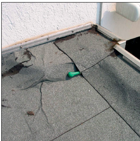
Abb. 222 (li.): Ungenügende, nicht homogene Verklebung
