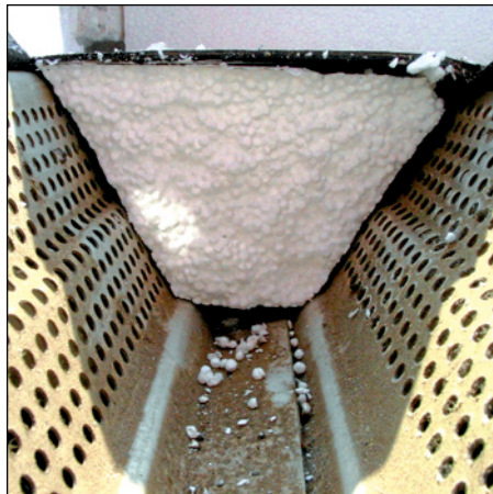
Abb. 92e: Sickenfüller als Drucklager für die Quernaht
