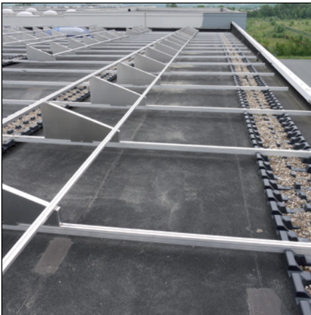
Abb. 428 bis 430: Flachdach- Auflagersystem; Sandkörner als Kerbkeime verursachen Kerbbruch- schäden an Abdichtungen. [Quelle: FDT- Flachdach]
