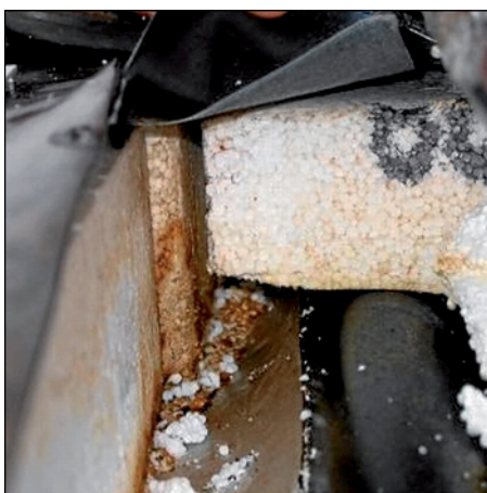
Abb. 243: Wasserspuren (braune Ränder) an Hartschaumdämmstoff deuten auf Außenwasser durch eingespülten Schmutz
