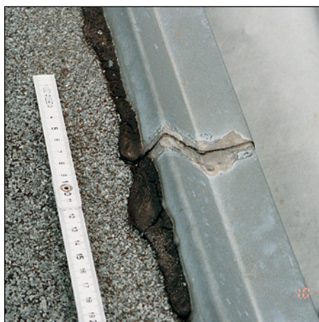
Abb. 381 (li.): Direkt eingeklebte Zinkrand- blende mit offenen Schä- den und Un- dichtigkeiten
