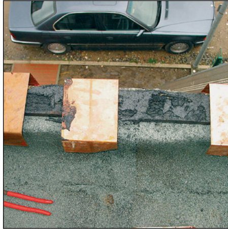
Abb. 377 (li.): Abtropfabstand mind. 2 cm, bei Kupfer mind. 5 cm
