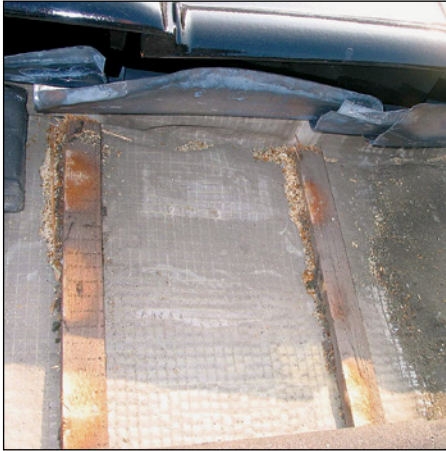
Abb. 148 (li): Wasserspuren auf einer Unter- spannbahn
