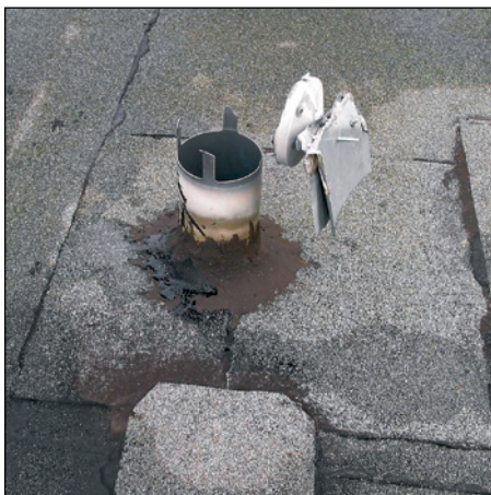
Abb. 220 (li.) und Abb. 221 (re.): Dachsanierung ohne Erneue- rung der Lüfter; Bitumenkitt ist keine dauerhafte Anschluss- dichtung.
