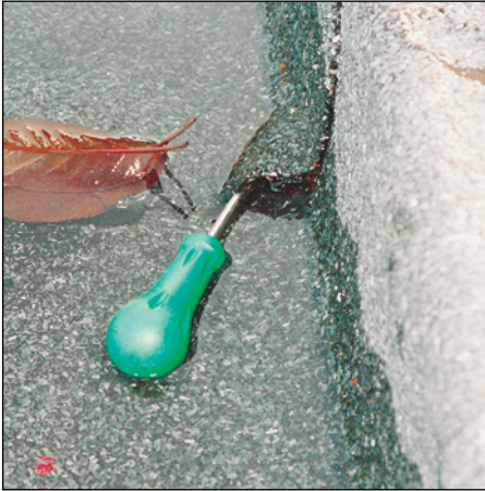
Abb. 130 (li.): Bituminöse Terrassenab- dichtung: Schweißfehler in der Bahnen- überlappung.
