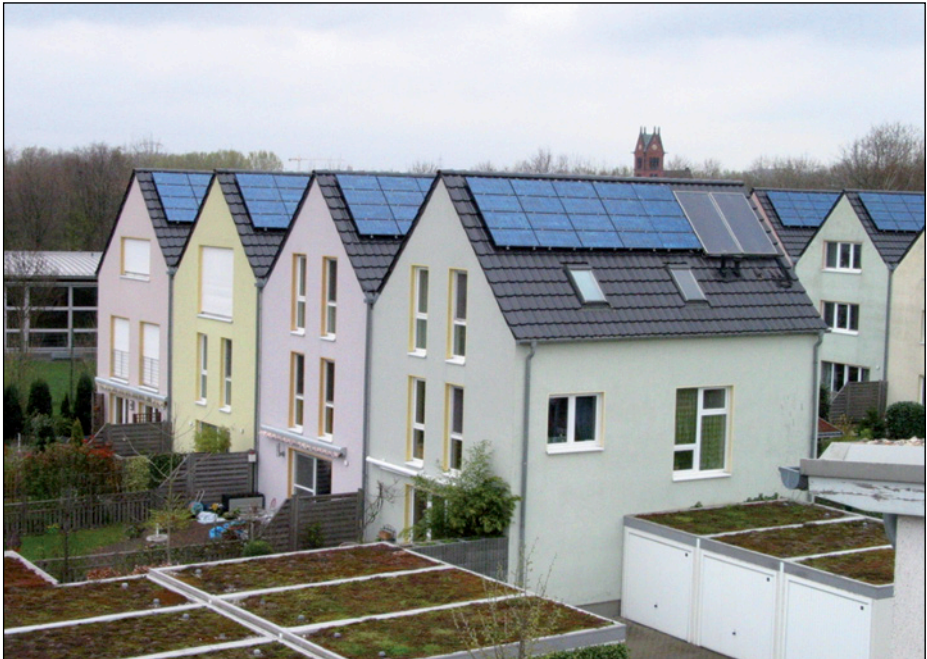
Abb. 405: Photovoltaik- und Solar- thermiekollek- toren auf einer Wohnanlage
