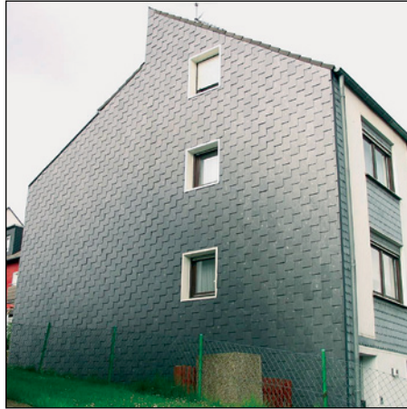
Abb. 465 u. 466: Fleckbildung an einer Schiefer- bekleidung
