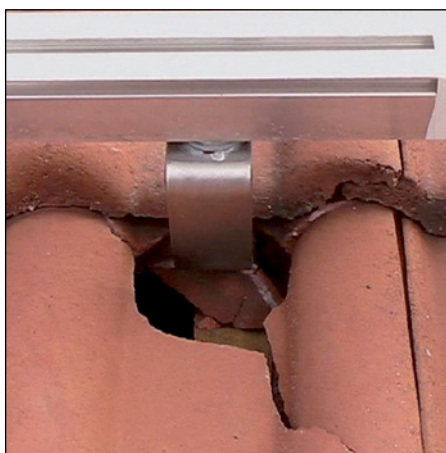
Abb. 407 (li.): Haltewinkel dürfen nicht an der Konterlatte befestigt wer- den.
