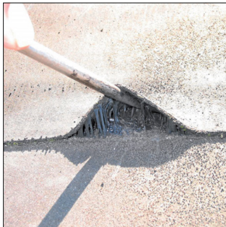
Abb. 211 (li.) und Abb. 212 (re.): Nahtablösungen unter stehen- dem Wasser (PIB)
