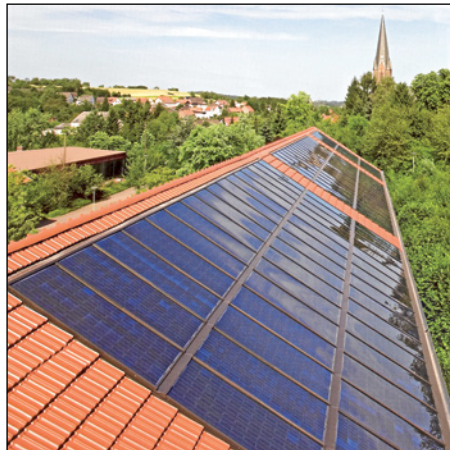
Abb. 417: Kollektorplatten als integriertes Dachsystem [Quelle: ROTO Sunroof GmbH & Co. KG]
