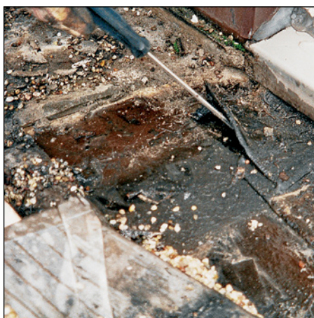
Abb. 271b (li.): Stark unebener Plattenbelag auf Stetzelager über Bitumenabdichtung
