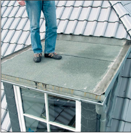
Abb. 373 bis 375: Gaubendach mit unkontrollierter Wasserführung
