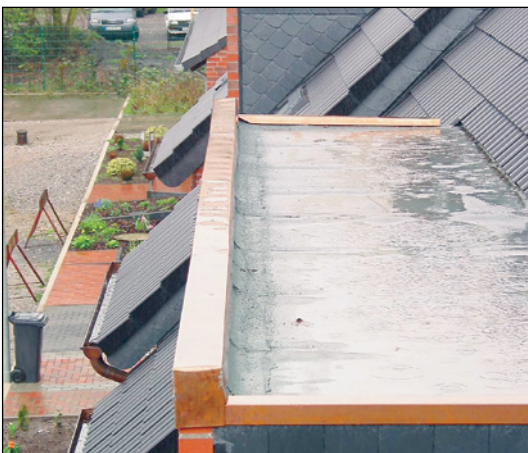
Abb. 376: 4 Fehler an einer Flach- dachgaube: – Entwässer- ungsgefälle fehlt – unkontrollier- ter Wasserab- lauf an den Gaubenschul- tern – zu niedere Wangendach- kanten – fehlerhafte Mauerabde- ckung (siehe auch Abb. 377 bis 378)
