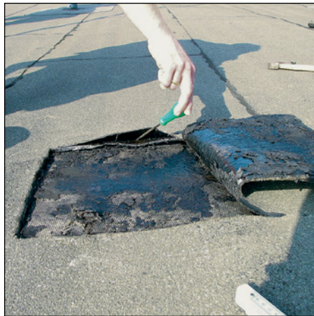
Abb. 218 u. 219: Homogene Verschmelzung der Dachbahnen ist nicht herge- stellt; Conse- quenz: undichte Abdichtung
