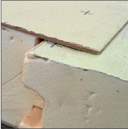
Abb. 189 (li.): Stoßausbildung bei Aufdach- dämmplatten: Regensicherheit und Luftdicht- heit?
