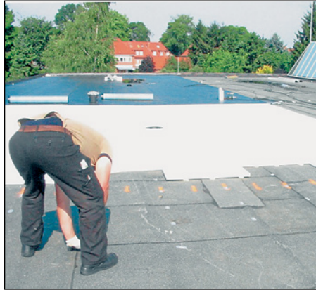
Abb. 53 (li.): Dampfdruckaus- gleich herge- stellt durch Kaltselfstklebe- bahn mit Klebe- streifen
