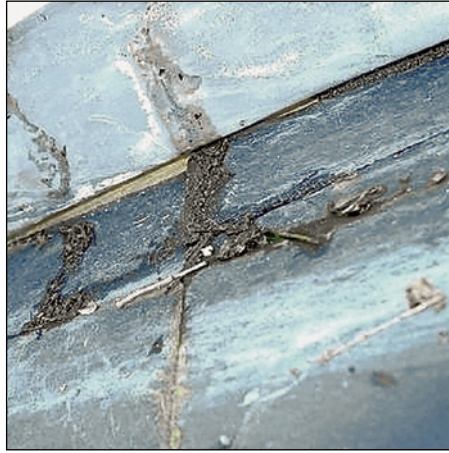
Abb. 291 (li.): Ursache der Undichtigkeit: Aufliegende Anschlussbleche und fehlende wasserabweisende Schnitte an den Schieferkanten
