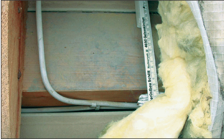
Abb. 352 bis 355: Luft- und Dampfsperren fehlen ganz oder sind nicht angeschlossen.
