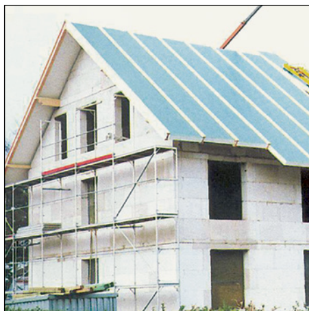
Abb. 186 (li.): Fertigelemente als Deckenab- schlüsse haben ihre Schwächen in unvermeid- baren Fugenan- teilen und den Schwierig- keiten, diese dauerhaft abzu- dichten.
