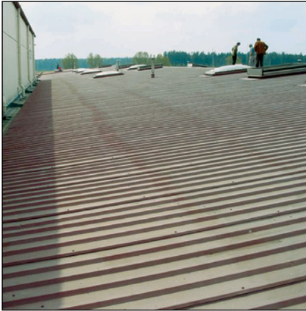
Abb. 484: Fleckige Dach- beschichtung mit Beschich- tungsschäden
