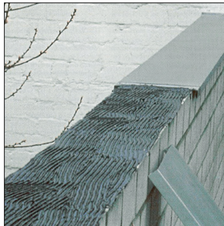
Abb. 330: Enkolit-Klebe- verfahren
