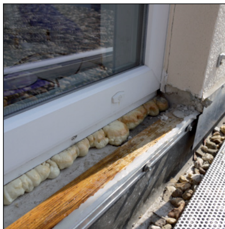
Abb. 369 u. 370: Offene Fenster- bankaufkän- tung, nicht eingefügte Anschlussdich- tung und als Ergebnis Durch- nässung des Fensterbank- lagers.
