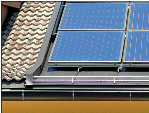
Abb. 421: Wanne aus Kupferblech- scharen unter Kollektorele- menten
