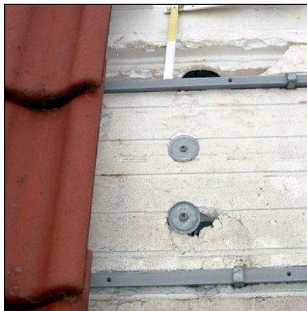
Abb. 195 (li.): Mineralfaser- dämmstoffe dürfen nicht statisch belas- tet werden; gleichwohl werden Dämm- platten mit aufzunagelnden Konterlatten angeboten und verkauft.
