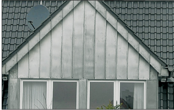
Abb. 334: Fleckiger Zu- stand einer Zinkbekleidung während der Patinabildung.
