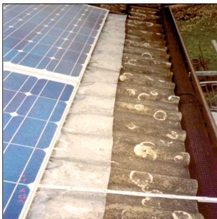
Abb. 422 bis 424: Grob fehlerhafte Wannenanschlüsse führen zu Wasserschäden.
