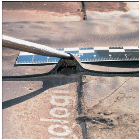
Abb. 209 (li.) und Abb. 210 (re.): Offene Nahtka- pillare an einer PIB-Dachbahn
