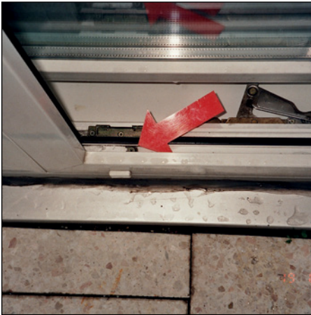
Abb. 268 (li.) Ungenügende Einpressung der Flügeldichtungen gestatten Wassereintritt in das Blendrahmenprofil.
