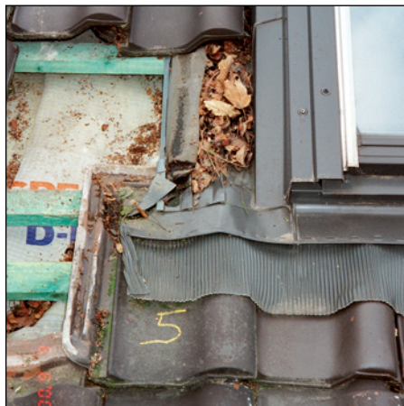
Abb. 170a (li.): Bei flacher Dachneigung und stark profiliertem Deck- material ist mit Eindeckrahmen die Wasserfüh- rung über den Brustanschluss nicht schaden- frei möglich.
