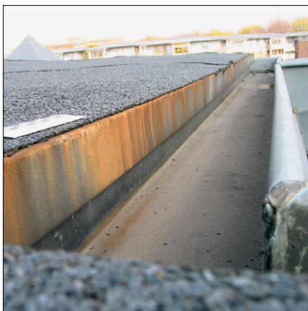
Abb. 159 (li.): Zerstörung des Rinneneinhangs durch »Bitu- menkorrosion«
