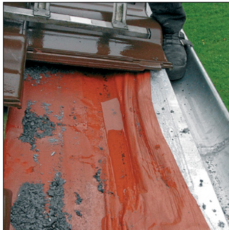
Abb. 303 (li.): Typischer Aus- führungsfehler mit Wassersack in der Unter- deckbahn über der Traufbohle
