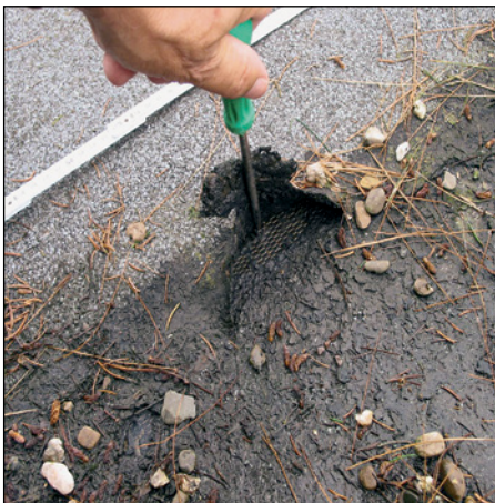
Abb. 232 u. 233: Unter stehen- dem Wasser verrottete Glas- gewebe- schweißbahn
