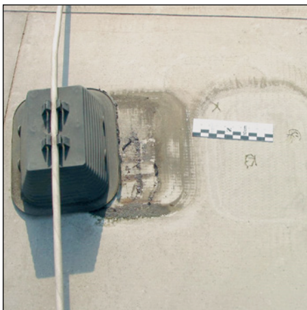
Abb. 239 u. 240: Schrumpfungskerbung in einer PVC-Dachbahn aus Aktivkohle-Effekt
