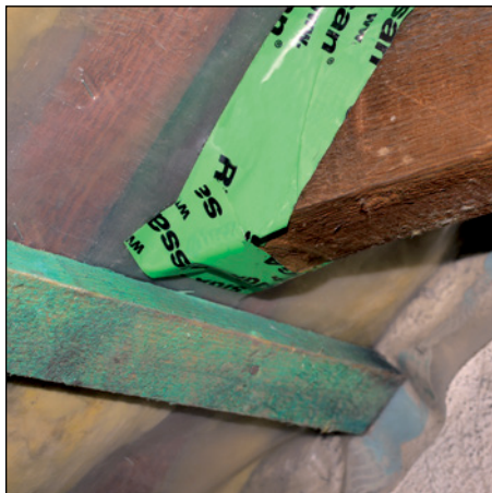
Abb. 175 (ti. u. re.): An übliches Bauholz kann ein luftdichter Anschluss nicht hergestellt werden.
