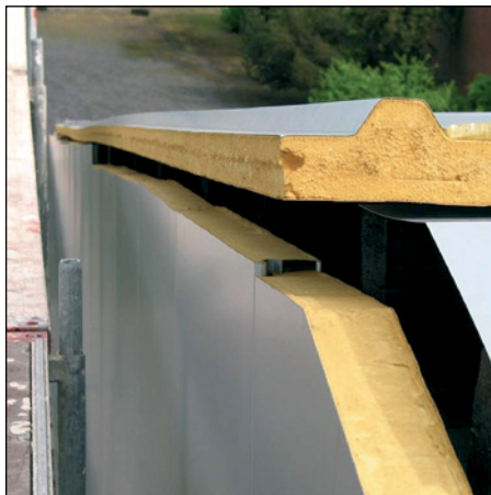
Abb. 113: Giebelanschluss in der bauübli- chen Ausfüh- rung
