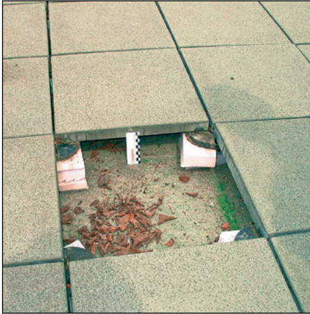
Abb. 277 u. 278: Ungeeignete Plattenstetz- lager aus Hartschaum
