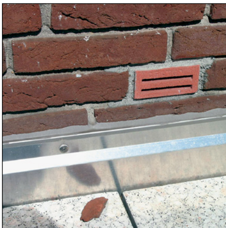
Abb. 249 (li.): Wandsperre fehlt, Verblend- wand entwäs- sert hinter den Anschluss.
