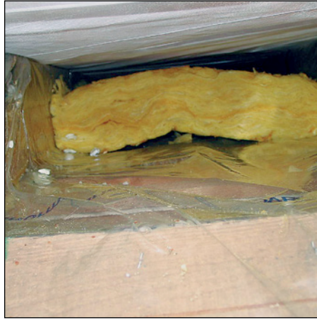
Abb. 336 (li.): Verschraubt eingebaute Sperrfolie; Deckenbeklei- dung oder min- destens Spar- lattung als Auflager sind notwendig.
