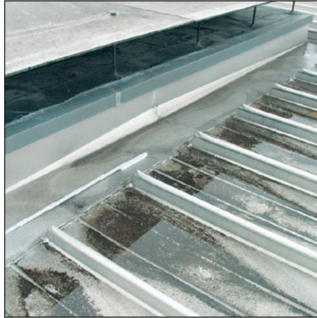
Abb. 116 (li.): Profildeckung mit Lüfterkamin- nen
