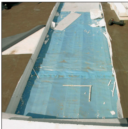
Abb. 57: Gefahrenge- eig- te Ausfüh- rung der Dampf- und Luftsperr- e auf einem Leicht- dach: hier Folienüberlappung quer zum Trapezprofil
