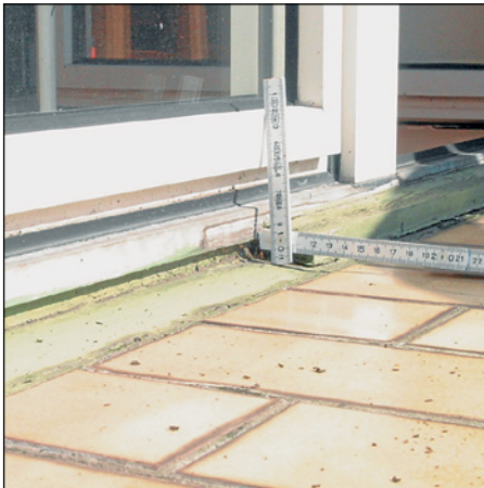
Abb. 120: Tür mit Abweisblech, jedoch ohne Anschluss- höhe
