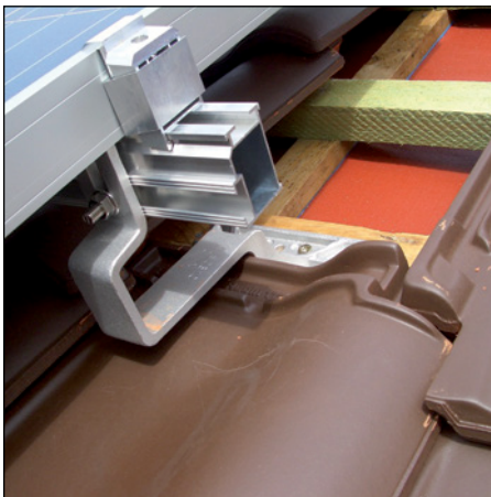
Abb. 409 u. 410: Fachgerechte Trägermontage auf Tragbohle mit Durchgang- ziegel [Quelle: SV Ulrich Daniel]
