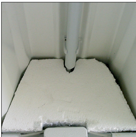
Abb. 90 (li.): Sickenfüller sollen mindes- tens über Außen- wänden luftdicht sein, nicht so wie auf diesem Beispiel.
