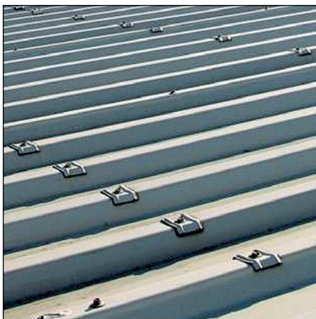
Abb. 392 (li.): Befestigung mit Kalotten auf Obergurten
