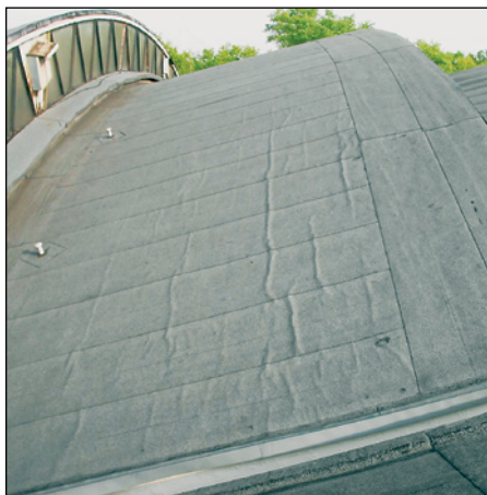
Abb. 52: Fehlende Schubsicherung auf Tonnen- Sheddach
