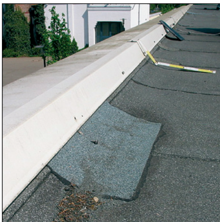
Abb. 390 u. 391: Direktbefesti- gungen sind meist nicht sicher und insbesondere nicht dauerhaft dicht.
