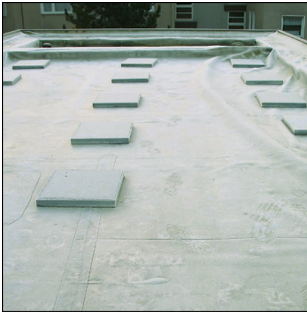
Abb. 58 (li.): Kunststoffabdichtung ohne Lagesicherung
