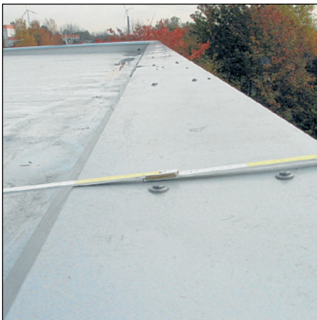
Abb. 326 u. 327: Abdeckungen dürfen nicht mit Dicht- schrauben befestigt wer- den und müssen mit Dehn- stücken ausge- stattet sein.
