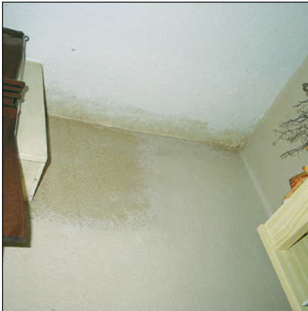
Abb. 444: Abgewischter Pilzbesatz, durch Wischen mit Schwamm oder Lappen werden Pilzbe- satz und Pilz- sporen weiter verbreitet.
