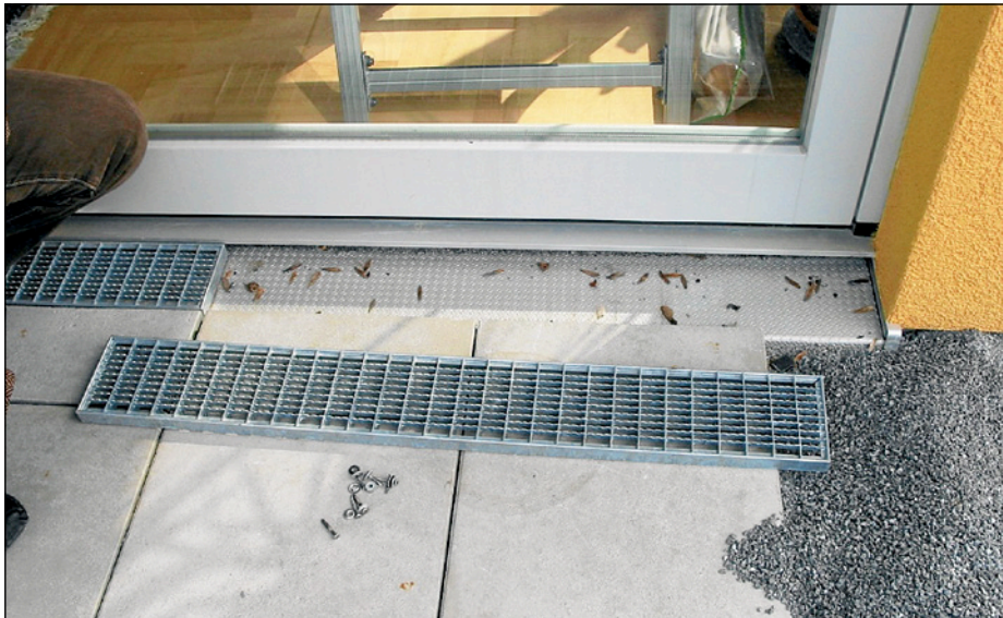
Abb. 264: Gitterroste auf Abweisblech oder in Kiesbett liegend sind unwirksam. Dränrinnen benötigen direkten Anschluss an einen Ablauf.
