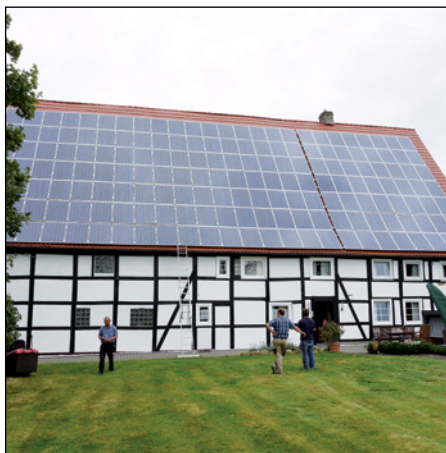
Abb. 406: Aufdachkon- struktion auf Dachziegel- deckung
