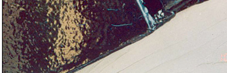
Abb. 479 (re.): Farbanstrich der Schnittkanten an der Kehle weicht von Ziegelfarbe ab.
