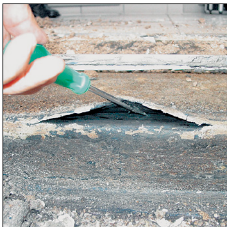
Abb. 235 (li.) Kunststoff und Bitumenbahnen gehen keinen dauerhaften Klebeverbund ein.
