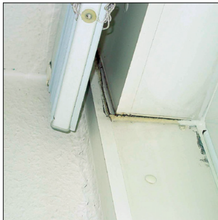
Abb. 345 u. 346: Altbaugauben sind meist luftundicht; das Schließen offener Fugen setzt die Komplett- erneuerung der Innenbeklei- dungen voraus.
