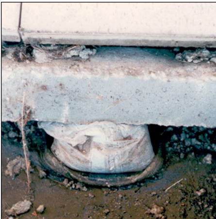
Abb. 132 (li.): Mörtelsäcke zerquetschen die Bitumen- schicht.
