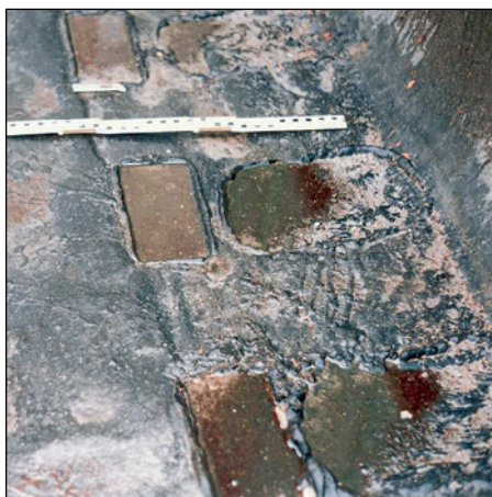
Abb. 270 (li.): Hohlliegen der Kunststoffdachbahn wegen fehlender Randfixierung
