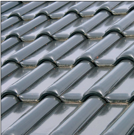
Abb. 155 (li.): Deckbild aus glasierten Flachdach- ziegeln
