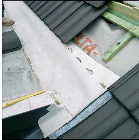
Abb. 371 u. 372: Gaubendach mit Kapitalfehlern; Mängelbeseiti- gung mit Total- erneuerung der Dachabdichtung
