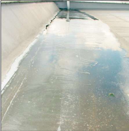
Abb. 32 (li.): Dachmulde mit Kunststoffdach- bahnen; hier wurden Kerb- rissschäden festgestellt.
