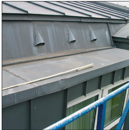
Abb. 151 (li.): Typischer Konstruktionsfehler: Der First-/Traufenan- schluss ist in dieser Form nicht lösbar.
