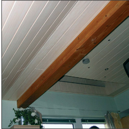
Abb. 174: Deckenbekleidung mit Dampfsperre und Seitenanschlüssen an eine Mittelpfette: Hier machbar, weil die Pfette aus rissfreiem Leimholz besteht.
