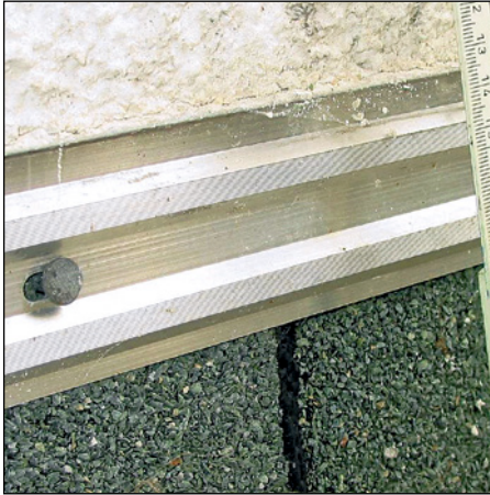
Abb. 257 (li.): Angeputzte Anschlussleiste und offene Bohrlöcher ohne Abdich- tung, Nägel statt Schrauben
