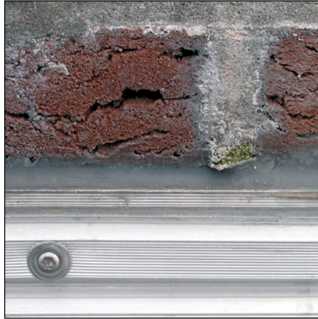
Abb. 139 (li.): Silicon-Dichtstoff wird durch Bitumen zerstört.
