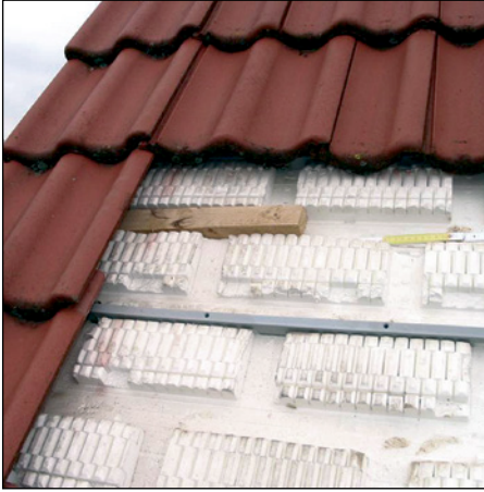
Abb. 197 (li.): Lattenknaggen als Windsiche- rung an der Dachkante, auf Geheiß des Dämmsystem- Herstellers und auf Risiko von Planer, Hand- werker und Bauherr
