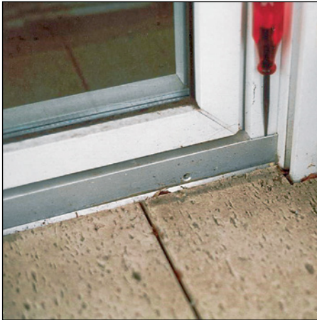
Abb. 259: Türschwellen- blech gegen Blendrahmen gesetzt und nach oben offen un- dicht, Rollladen- führung kann nicht unterfangen und nicht einge- dichtet werden.
