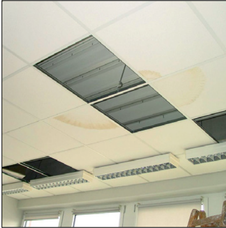
Abb. 204: Wasserschaden unter einem Leichtflachdach
