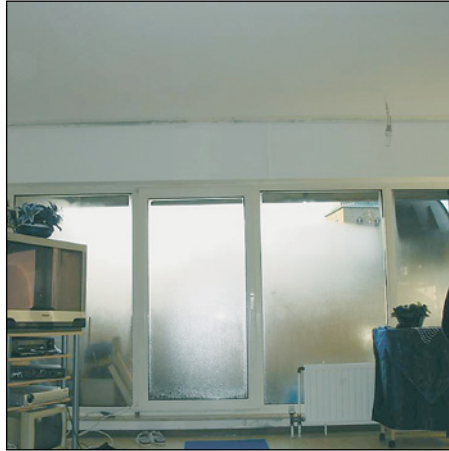
Abb. 445 (li.): Wärmebrücken durch unsach- gemäßen Dämmstoffein- bau
