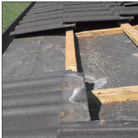
Abb. 305 (li.): Unterdeckter Kupferanschluss ist zu schmal, nicht unterfüt- tert und hat ungenügenden Rückfalz
