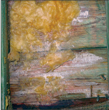
Abb. 481: Pilzbefall an der Holzschalung: Schimmel oder holzerstörender Pilz?
