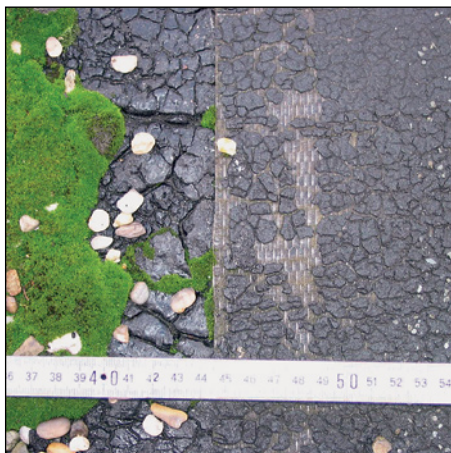
Abb. 234: Nahezu restlos abgewitterte Bitumendeck- schicht: Die Abdichtung ist nicht mehr wasserdicht.
