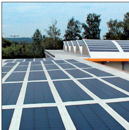
Abb. 435 bis 437: Solardicht- system mit Kunststoffdach- bahn [Quelle: Evalon-solar, alwitra GmbH & Co. Klaus Göbel]
