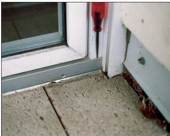
Abb. 126: Türschwelle mit Abweisblech, das jedoch an den Blendrah- men nach oben offen und damit undicht ist.
