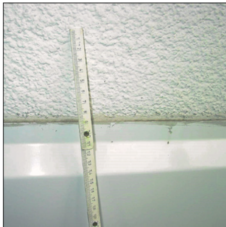
Abb. 255 u. 256: Ungeeignete Anschlussleiste mit zu kleinem Fugenraum
