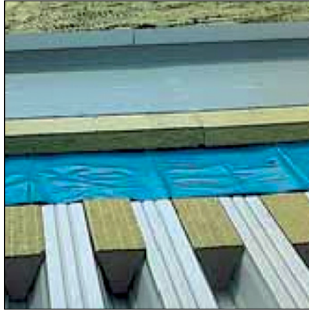
Abb. 92c (li.): Typische Ausführungsfehler: feuchte Sperrfolie, Querstoß ohne druckfeste Unterlage, zu schmales Klebeband
