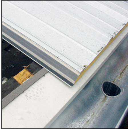
Abb. 109 (li.): Luftoffene Langfugen in Wandprofilen
