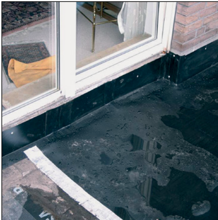
Abb. 137 (li.) und 138 (re.): Tür- und Leibungsanschluss mit Verbundblech und PVC-Dichtbahnen
