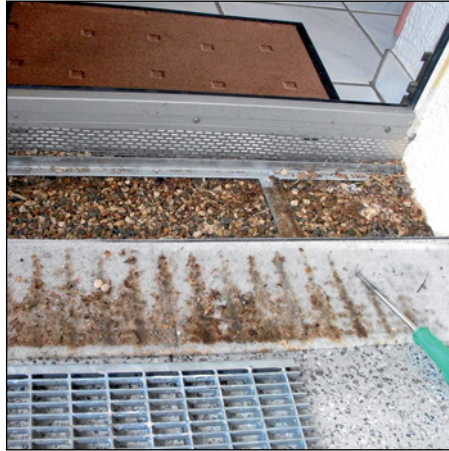
Abb. 262 u. 263: Dränrinnen sind nur wirk- sam, wenn sie direkt entwäs- sert werden (Anschluss an Ablauf oder Rinne).
