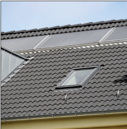
Abb. 418 bis 420: Konstruktiv fehlerhafte Anschlüsse der Kollektor- rahmen: In Rahmennut eingesetzte Dichtprofile sind unge- eignet.
