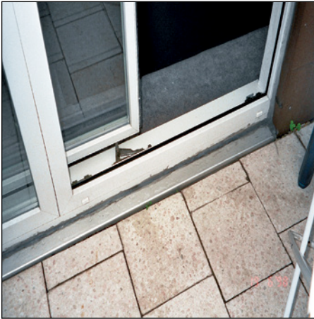
Abb. 266 (li.) Wasserschäden durch undichte Terrassentür
