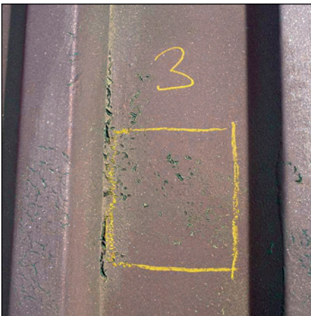
Abb. 485 u. 486: Abblättern der Beschichtung infolge Mate- rialfehlern und fehlerhafter Applikation
