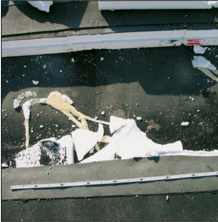
Abb. 65 (li.): Wechselnde Auftragsmengen bewirken Haft- mängel.
