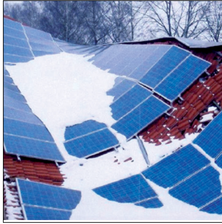
Abb. 440 (li.): Bruchschaden durch Schnee- last [Quelle: SV Mischok, VHV- Versicherung]
