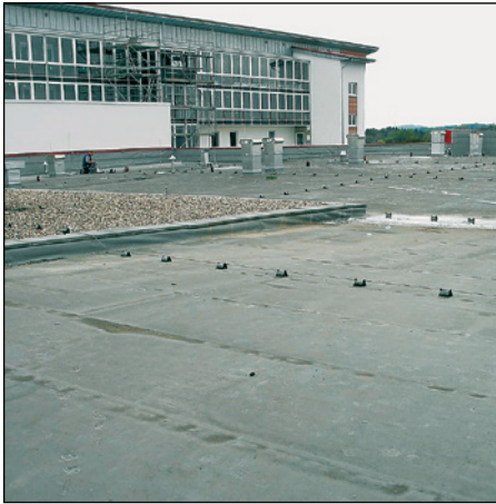
Abb. 27: Flachdachab- dichtung aus Kunststoff- dachbahnen
