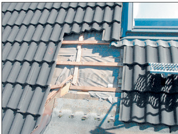
Abb. 166: Mit kleinem Holzkeil als Übergang zur Kehlschalung hätte dieser schadhafte Gaubendachanschluss regensicher gemacht werden können.
