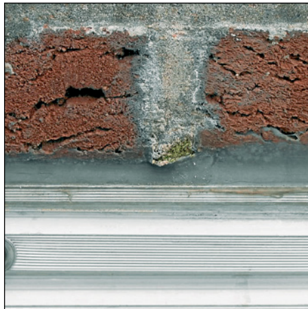
Abb. 253 u. 254: Sandige Mörtel- fugen, Versiege- lung löst sich ab
