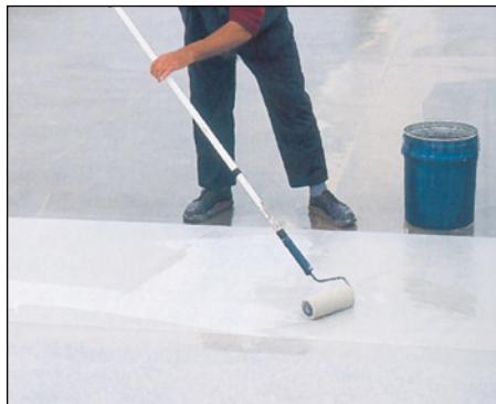
Abb. 49 (re.): Vliesbahn anrol- len und noch- mals deckend beschichten.
