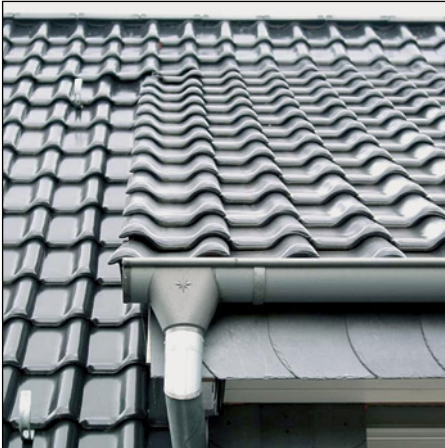
Abb. 473 (o. re.) bis 475 (u. re): Konkavbogen am Ortgang (re.), ausge- stellter Giebel- ziegel an der Traufe und welliger Dach- first (li.)
