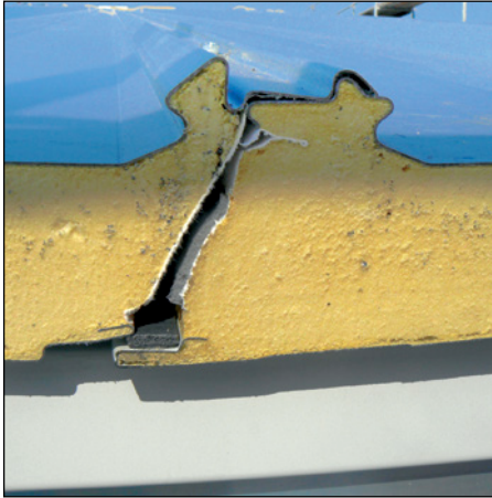
Abb. 106 (li.): Tatsächliche Ausführung (Luftoffen) am Objekt
