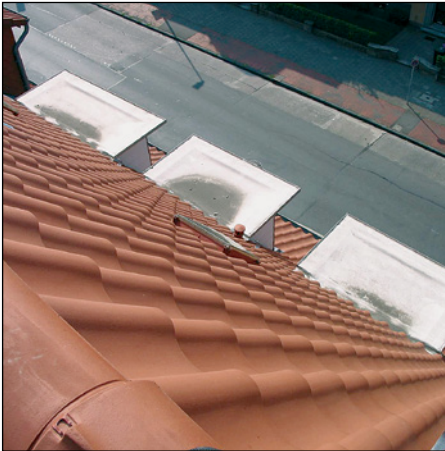
Abb. 384 u. 385: Gaubendächer mit Abdichtun- gen aus Kunst- stoffdach- bahnen. Wasser bleibt stehen, Schmutz sam- melt sich auf den Gauben- dächern.
