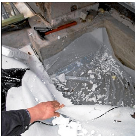
Abb. 92 a (li.): Lose eingelegte Kunststoffolie ist keine Dampfsperre.
