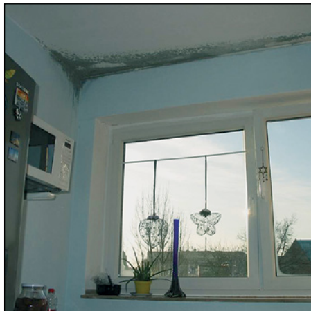
Abb. 447 (li.): Flächig mit Was- ser beschlagenes Isolierglasfenster als sicherer Indi- kator für dauernd überhöhte Innen- raumfeuchte.
