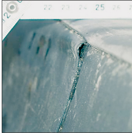
Abb. 207 (li.) und Abb. 208 (re.): Offene Naht in einer Hohlkehle (Dachbahn fehlerhaft an der Attika hoch- geführt)
