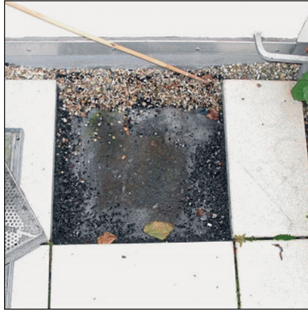
Abb. 281 (li.): Abrutschende Betonplatten auf Feinkies mit einfachem Lochblech als Randleiste
