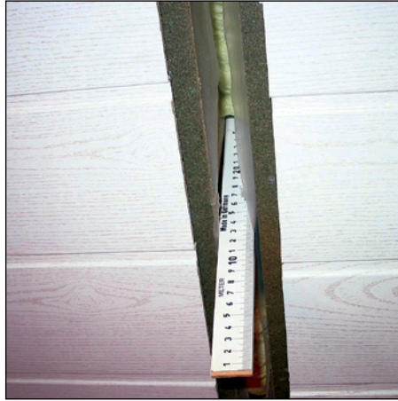
Abb. 199 (li.): Elementstoß von außen 3 bis 5 cm tief mit Ortschaum verfüllt: Der ca. 20 cm hohe Fugenquer- schnitt ist luftoffen.
