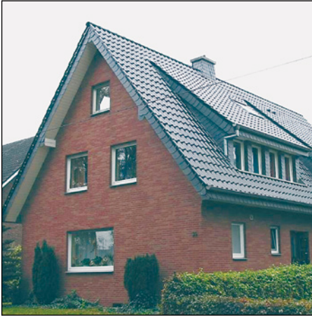
Abb. 472 (li.): Wegen krummer Deckung be- mängeltes Dach
