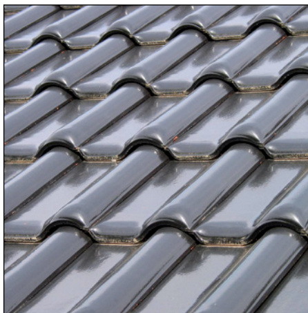
Abb. 2: Wasserableitung bei Dachpfan- nen: Wasser wird in die Wasser- mulde und von dort zur Traufe geleitet.
