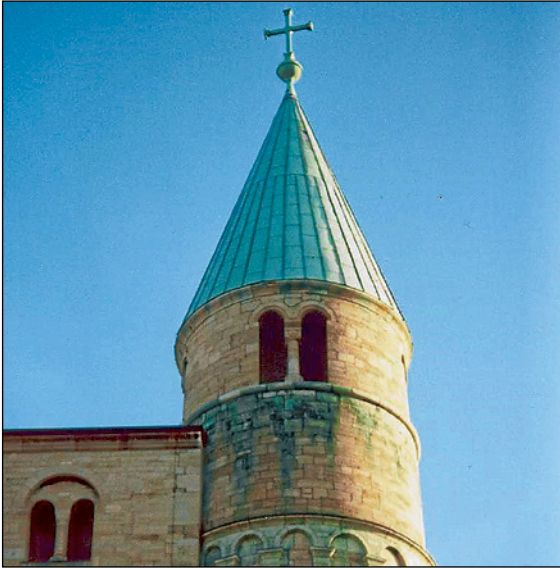
Abb. 464: Grünläufer unter einem Kupferhelm
