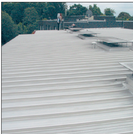
Abb. 396 u. 397: Hier undichte Profilüberlap- pfung trotz Nietung und Silicon
