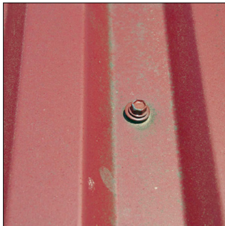
Abb. 386 u. 387: Profildach mit fehlerhafter Schraubbefesti- gung im Was- serlauf (Unter- gurt)
