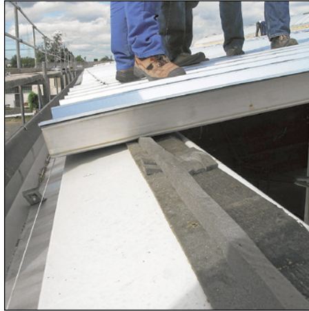
Abb. 401 u. 402: Traufenausbildung ist trotz Dichtbändern fehlerhaft: Profilabkantung und Traufblechaufkantung fehlen.
