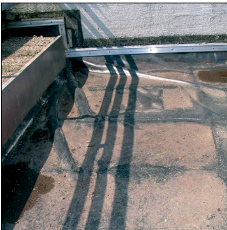
Abb. 134: Abdichtung mit Kunststoffbah- nen: Hier Zug- falten wegen fehlender Rand- fixierung
