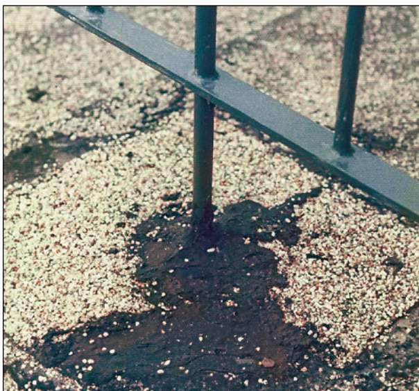
Abb. 274: Untauglicher Dichtversuch mit Bitumenkitt
