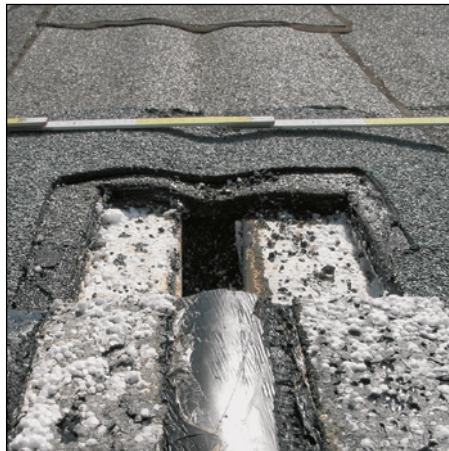
Abb. 70 (li.): Dehnzone aus Dachverschiebung
