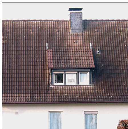
Abb. 462 u. 463: Dachsteine än- dern kontinuier- lich ihre Farbe; später ersetzte Dachsteine sind immer erkenn- bar.
