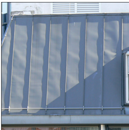
Abb. 315: Dehnwellen in der Zinkdeckung
