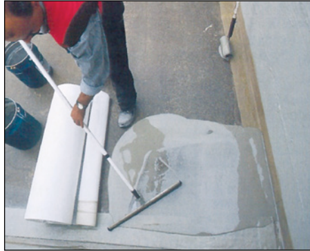
Abb. 47 (li.): Üblicher Appli- kationsvorgang bei Flüssig- kunststoff: Deckend auf- tragen ...
