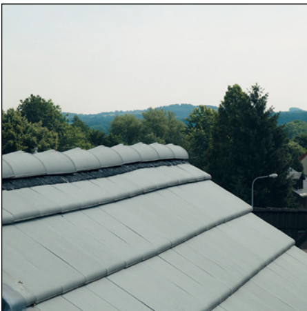
Abb. 470 (re.): Eingesunkener Dachteil durch konstruktive Änderung des Dachstuhls
