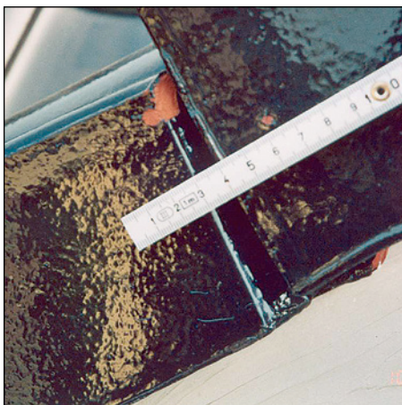
Abb. 478 (li.): Absplitterung am Wetter- schenkel des Giebelziegels
