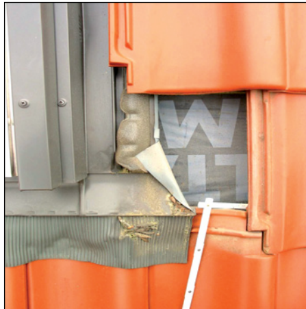
Abb. 169 (li.): Unterdeckmaß bei handelsüblichen Eindeck- rahmen weicht von der Vorgabe der Fachregel (100 mm) ab.
