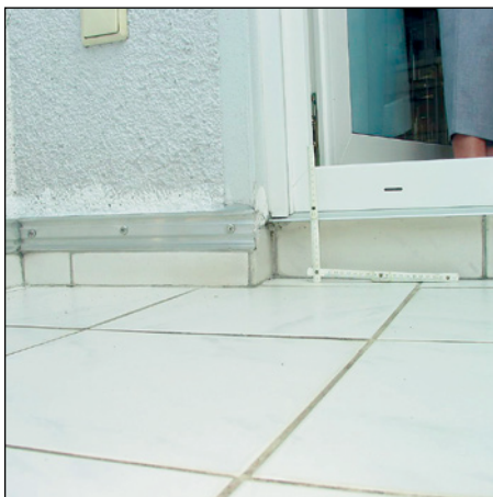
Abb. 284 (li.): Hartbeläge in Mörtelbett oder auf Estrich benötigen Rand- und Feldbegren- zungsfugen.
