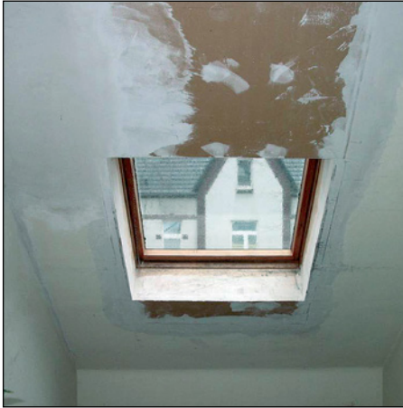
Abb. 364 u. 365: Senkrechte Sturz- und Brüstungs- kleidungen sind fehlerhaft (links). Richtig sind waagerechte Sturz und lot- rechte Brüstung [Quelle: Abb. 365: ZVDH].
