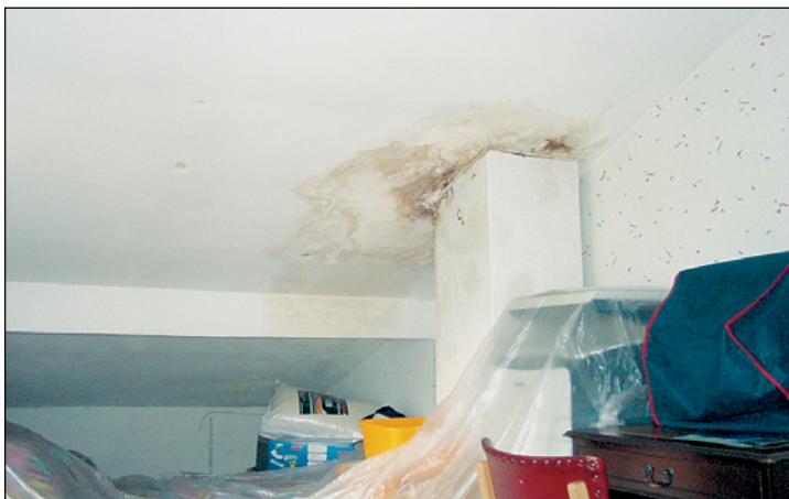
Abb. 288: Kapitaler Wasserschaden unter Schiefer- dach
