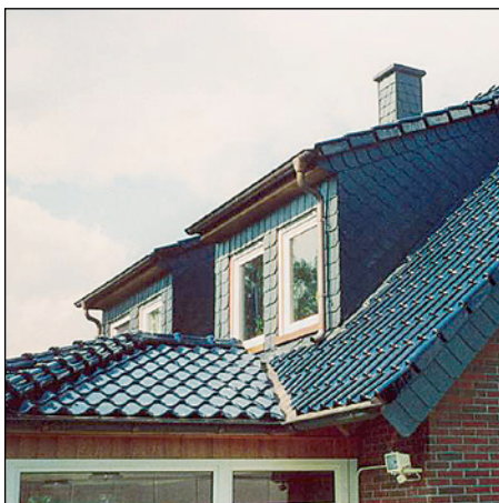
Abb. 458: Blauschwarz glasiertes Zie- geldach mit grauweißem Schleier
