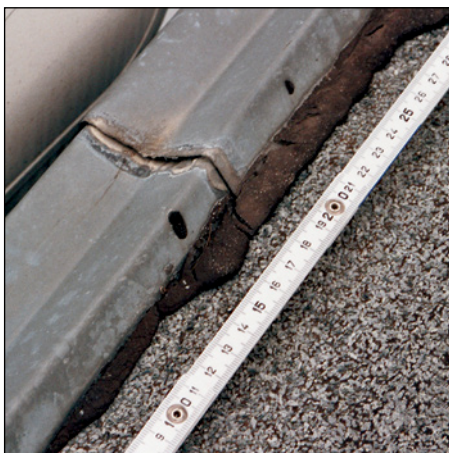
Abb. 224 (li.): Fest einge- klebtes Zinkrandprofil mit offener Lötnaht
