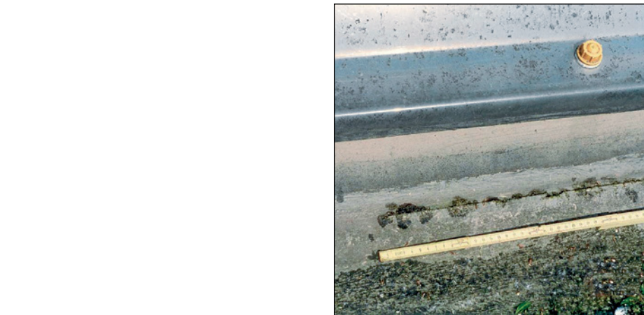
Abb. 248: Bruch einer PMMA-Be- schichtung auf einem Lichtkup- pelaufsatzkranz
