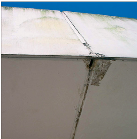
Abb. 118 (li.): Wasserschäden am Balkon
