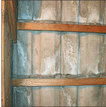
Abb. 17 und 18: Wasserspuren im Überdeckungsbereich, auf Lattung und Unterspannbahn, und an der Innenseite der Dachsteine.
