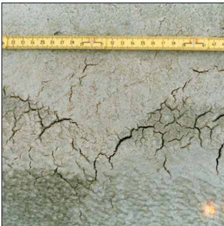
Abb. 482: PU-Dachbe- schichtung mit Rissen
