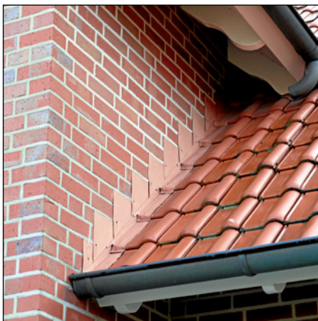
Abb. 296 (li.): Anschluss mit Fugenschnitt- Anschlussstü- cken
