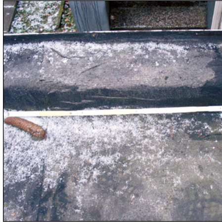
Abb. 228 (li.): Beschichtung über nicht lagesicherem Untergrund
