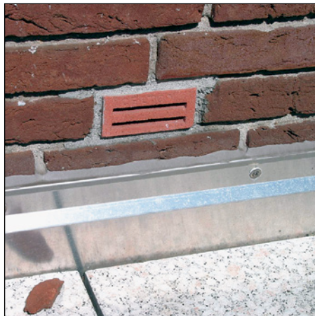
Abb. 141 (li.): Kalksandsteinmauerwerk ist für seine hohe Wasseraufnahmefähigkeit und Wasserspeichereigenschaft bekannt. Aufgesetzte Wandanschlüsse können nicht regensicher sein.
