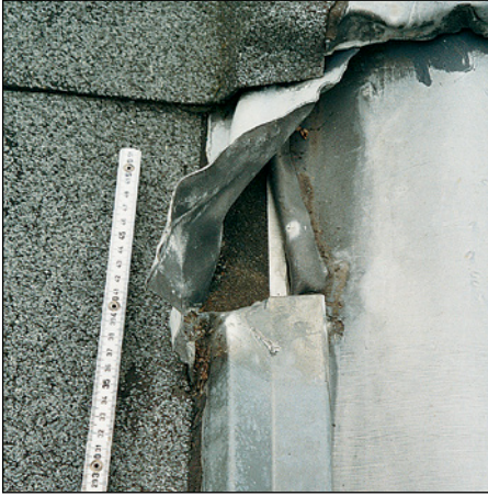
Abb. 383: Offener (= un- dichter) Über- gang von Rand- blende und Kehlauslauf an der Gauben- schulter
