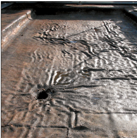
Abb. 77: Plastische Ver- formung einer Abdichtung aus Bitumen- schweißbahnen
