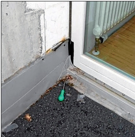
Abb. 260 u. 261: Türschwelle kann nicht eingedichtet werden, weil Abweisblech und Leibungs- einbindung fehlen.
