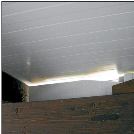
Abb. 111 (li.): Luftdichte Anschlüsse unter der Traufe sind nicht her- stellbar, wenn sie nicht kons- truktiv vorge- plant sind.
