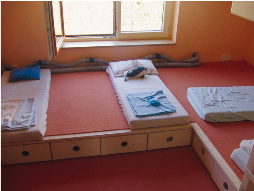
Abb. 7.29c: Schlauchverlegung an Schlafplätzen
