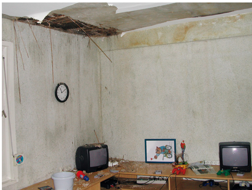
Abb. 7.5: Holzbalkendecke von unten, Putz löst sich von den Strohmatten
