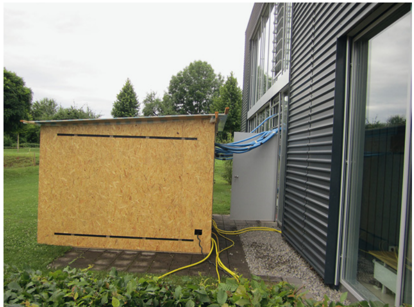
Abb. 9.3: Holzhaus zur externen Unterbringung und zum Schutz der Trocknungs- anlage
