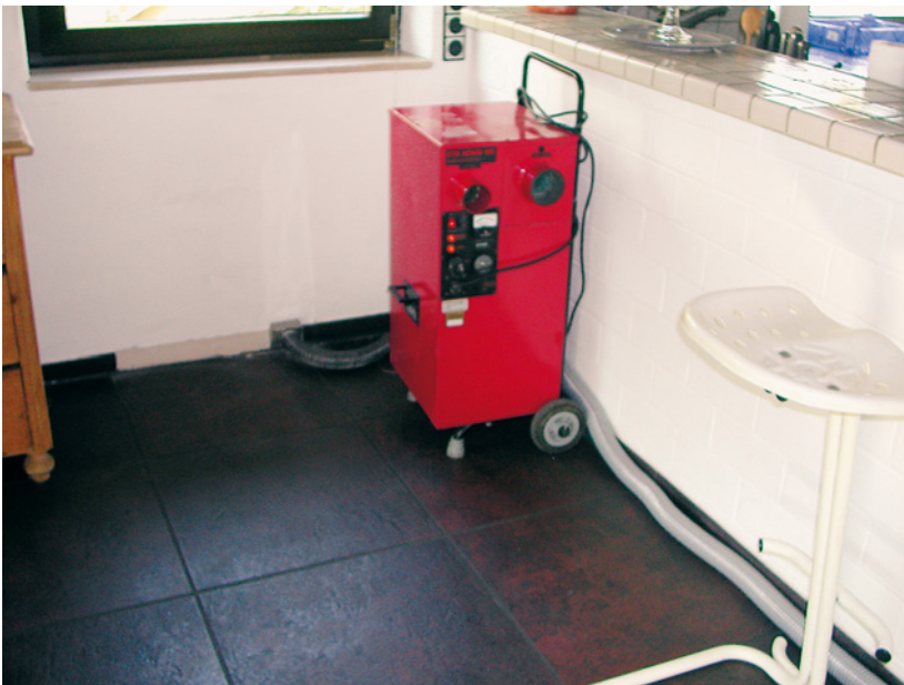
Abb. 6.29: Kombigerät für Dämm- schichttrocknung
