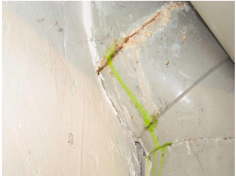
Abb. 4.36: Austritt von Uratin aus der Verbindung des Abwasserrohres
