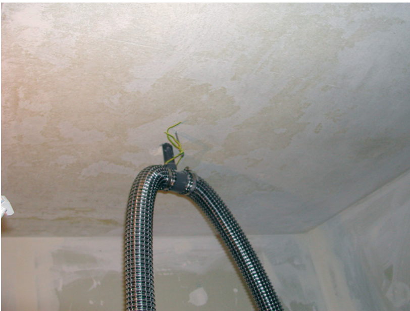
Abb. 7.10: Trocknung einer Holzbalkendecke von unten
