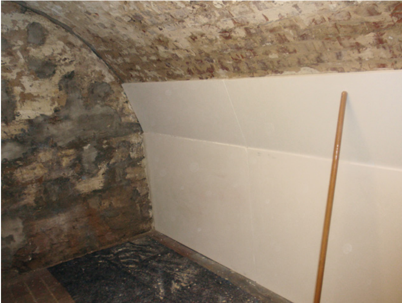
Abb. 10.5: Einbau von Klima- platten in einem Gewölbekeller
