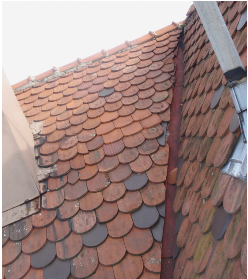
Abb. 2.46: Dachziegel, die nach einem Sturm nachgerichtet wurden. Der Eigentümer hatte keine Versicherung für sein Gebäude abgeschlossen. Somit wurde der Sturmschaden mit geringstem Kostenaufwand repariert. Viele unterschiedliche Dachziegel. Fehlender Mörtel bei Firstziegel wurde nicht ausgebessert!
