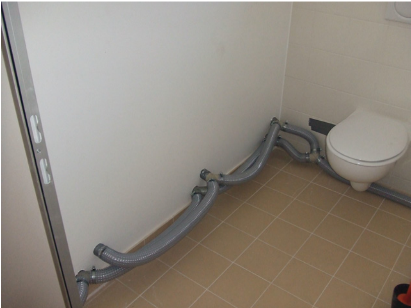
Abb. 7.29d: Schlauchverlegung in WC-Anlagen
