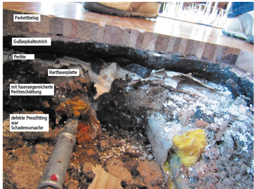
Abb. 6.26: Schichtenaufbau, mit Fasern angereicherte Perliteschüttung, darauf Gußasphaltestrich
