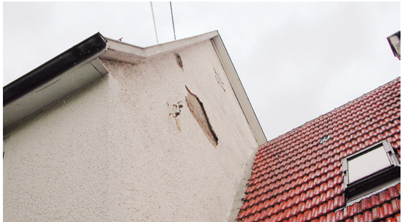
Abb. 7.28: Hier unterwanderte Regenwasser den Außenputz auf Ziegelmauerwerk.
