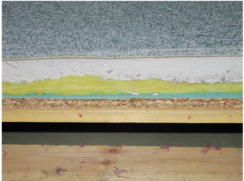
Abb. 7.7: Aufbau auf Holzbalkendecke: Spanplatte auf Holzkonstruktion, Folie, Dämmschicht aus Mineralfaser, Anhydritestrich, darauf als Oberbelag ein Teppichboden.
