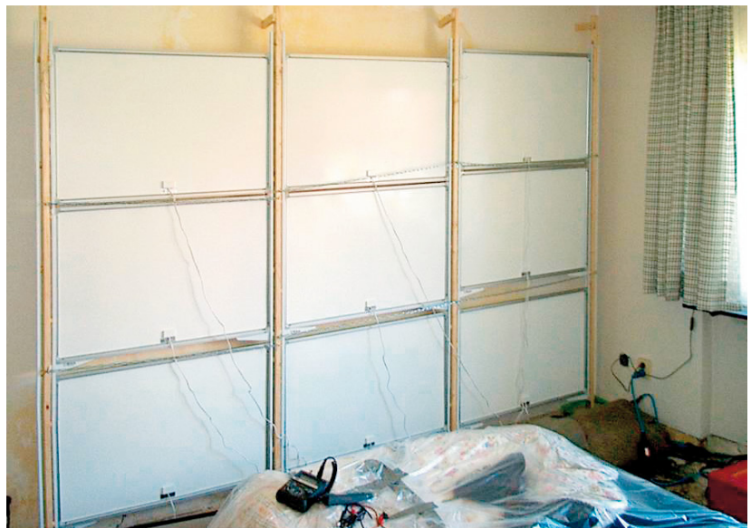
Abb. 5.9: Trocknungsart mit auch als Dunkelfeldstrahlern bezeichneten Wärme- platten, aufgestellt in einem Abstand von ca. 5 cm vor der zu trocknenden Wand.
