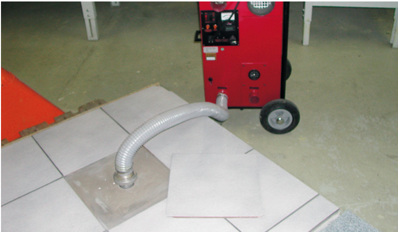
Abb. 5.30: Trocknung von oben: b) Bohren eines Zugangs zum Dämm- material; hier ist der Schlauch vom Kom- bigerät (Turbine mit Adsorptionstrockner) angeschlossen.
