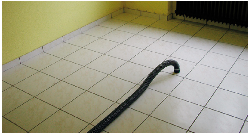
Abb. 5.28: Bohrung in Fliesen für eine Trocknung von oben
