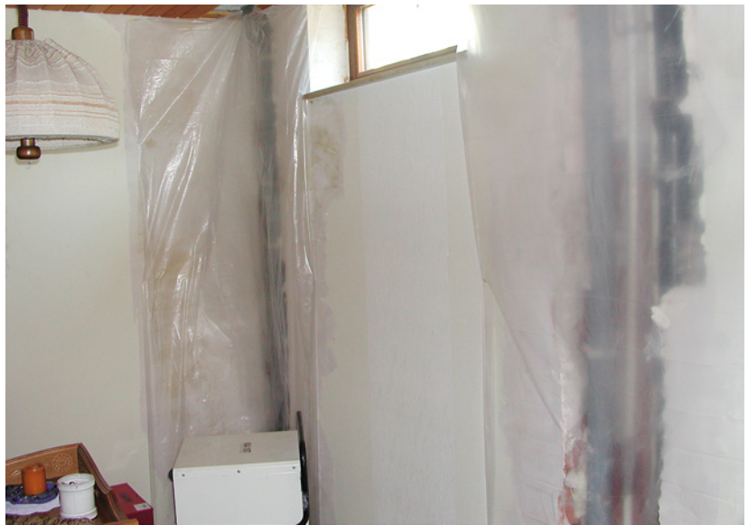
Abb. 7.26: c) Verschiedene Beispiele für die Trocknung von Wänden unter einem Folienzelt; Schlauchführung unter Folienzelt oder Kondensations- trockner unter Folienzelt gestellt.
