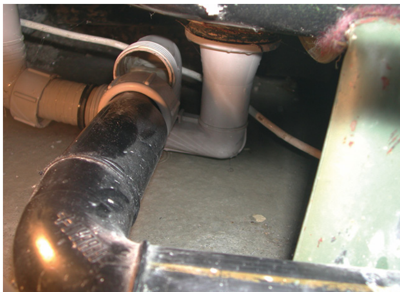
Abb. 2.40: Hier wurde der Abfluss nach einer Reinigung nicht wieder richtig angeschlossen.
