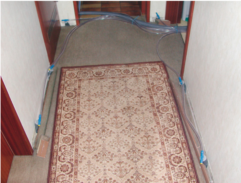
Abb. 5.14: Dämmschichttrocknung über die Randfugen. Die hier dargestellte Trocknung über die Randfuge ist nicht ideal, dennoch in der Praxis erfolgreich. Dieses Verfahren eignet sich für eine Flurbreite von max. 1,5 bis 2 m. Hier ist exakt die austretende Luftgeschwindigkeit zu ermitteln.
