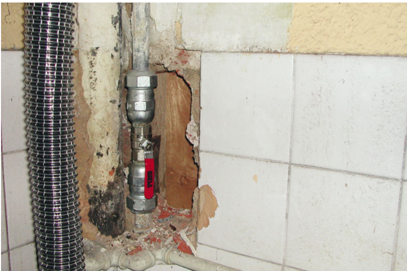
Abb. 4.14: Nach erfolgreicher Rohrbruchreparatur wurde eine anschließende Druckprobe der restlichen Leitung mit eingebauten Schiebern durchgeführt, um weitere Rohrbrüche auszuschließen.
