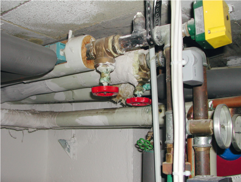
Abb. 2.26: Abstellhähne mit Grünspanansatz aufgrund von Undichtigkeiten. Alte Zuleitungen können brechen, weil die konstruktive Lebensdauer überschritten ist.
