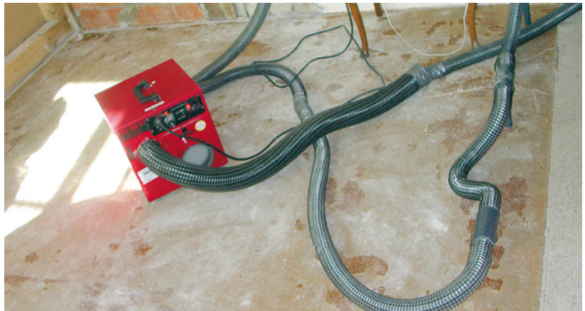
Abb. 5.29: Trocknung eines Fehlbodens von oben: Der Oberbelag ist bereits entfernt. Der Fehlboden (Holzbalkendecke mit Spanplatten) wird in jedem Balkenfeld angebohrt und mit warmer trockener Luft durchlüftet.
