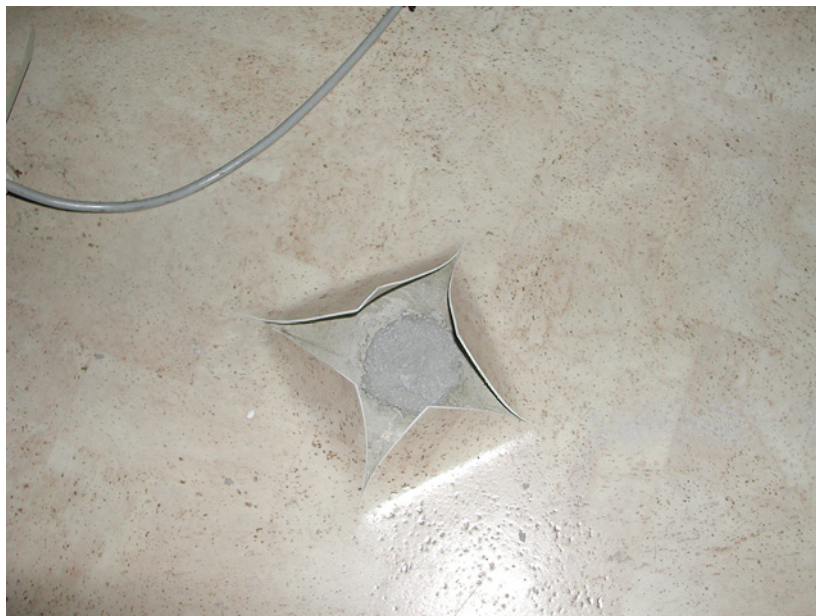
Abb. 6.12: PVC-Belag mit Kreuz- schnitt aufgeschnitten. Die angebrachte Boh- rung wurde nach der Trocknung mit Schnell- estrich verschlossen und der PVC-Belag wieder angeklebt.
