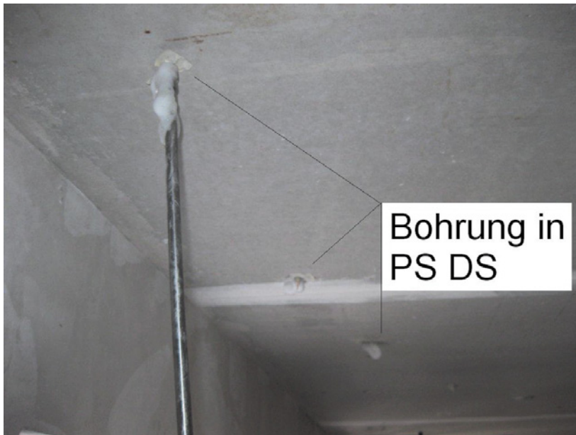
Abb. 11.2: Bohrungen von unten durch die Stahlbeton- decke in 1 m Abstand
