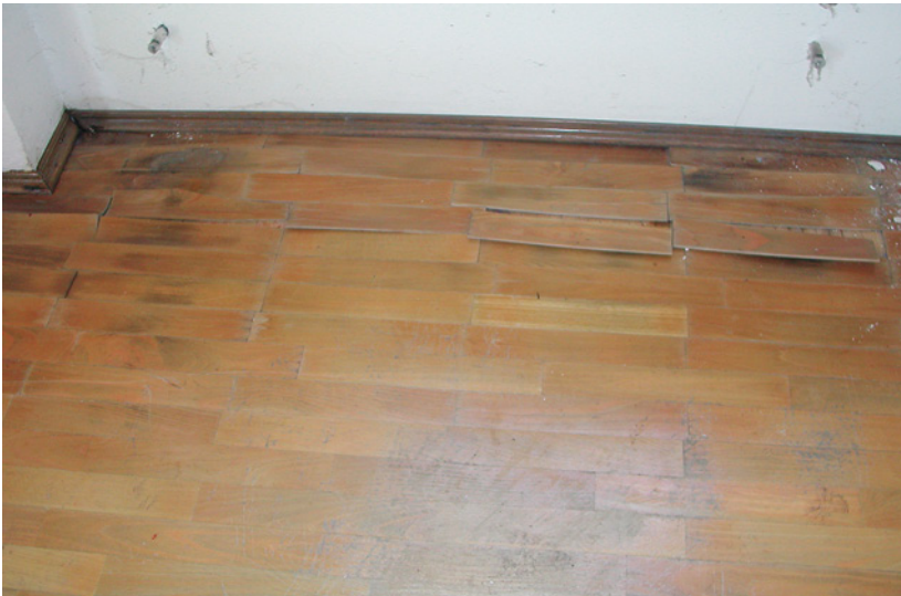
Abb. 6.20: Abgelöste Parkett- schicht, kein Abschleifen möglich
