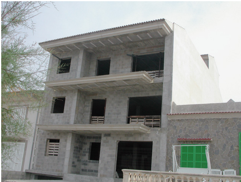
Abb. 2.18: Völlig ungeschützter Rohbau – Durch- nässung möglich
