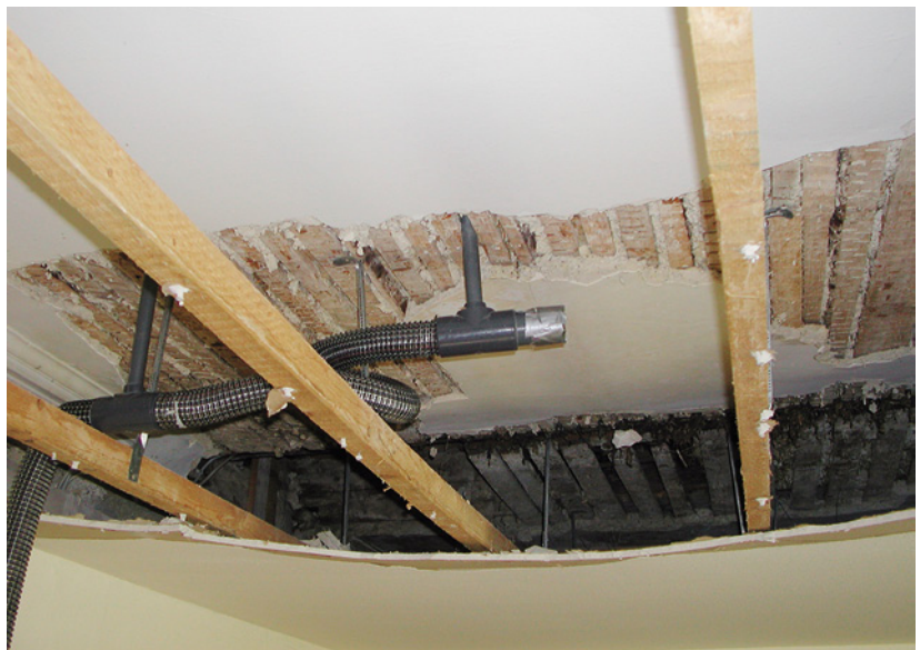
Abb. 7.17: Trocknung einer Holzbalkendecke, Deckenputz auf Putzträger; darunter im Rahmen einer Altbau- sanierung abgehängte Gipskartondecke
