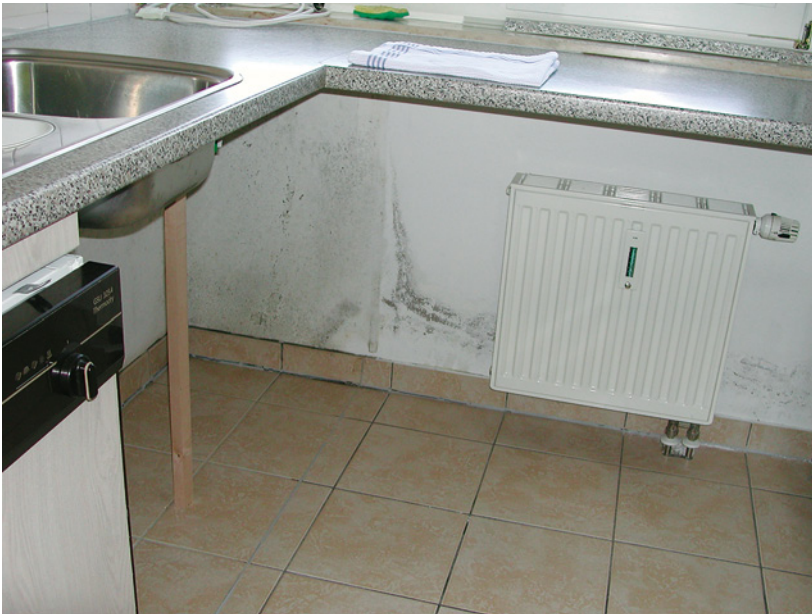
Abb. 2.43: Aufsteigende Feuchtigkeit an Wänden
