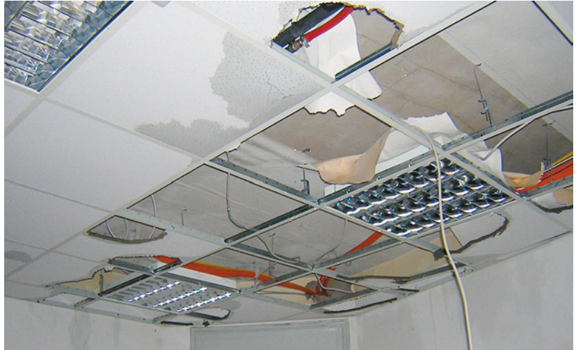
Abb. 7.13: Durch einen Rohrbruch durchnässte Odenwalddecke im Raster 60 × 60. Einzelne Platten können ausgetauscht werden.
