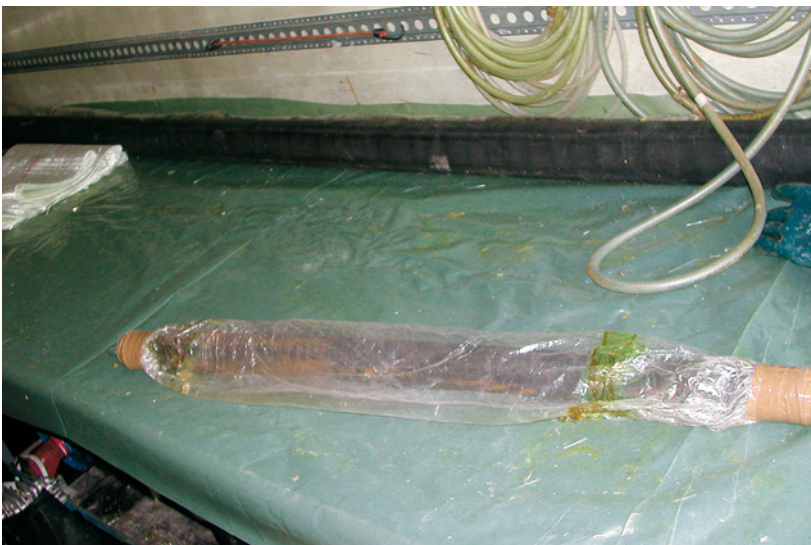
Abb. 6.35: Reparatur von Abwasserleitungen mittels Partliner a) Packer, um Partliner zu platzieren
