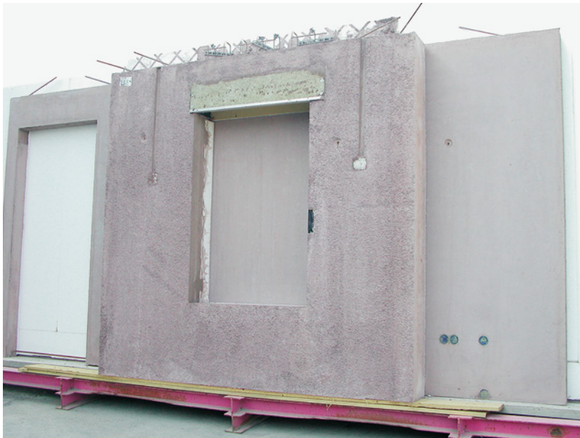
Abb. 7.23: Werkseitig vorge- fertigtes Fertigbeton- Wandelement
