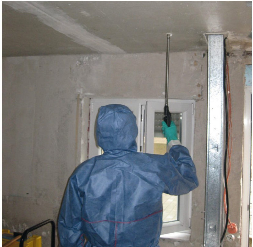
Abb. 11.3: Einbringen des Desinfektionsschaums durch die Bohrungen
