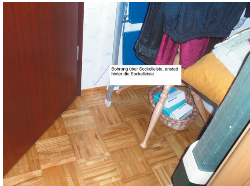
Abb. 5.1: Bohrung über der Sockelleiste
