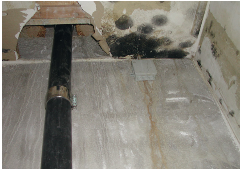
Abb. 7.14: Schimmelpilzbefall auf einer Gipskartonplattendecke
