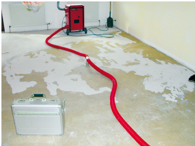
Abb. 6.3: Der Oberbelag wurde bereits vor der Trocknung vollständig entfernt.
