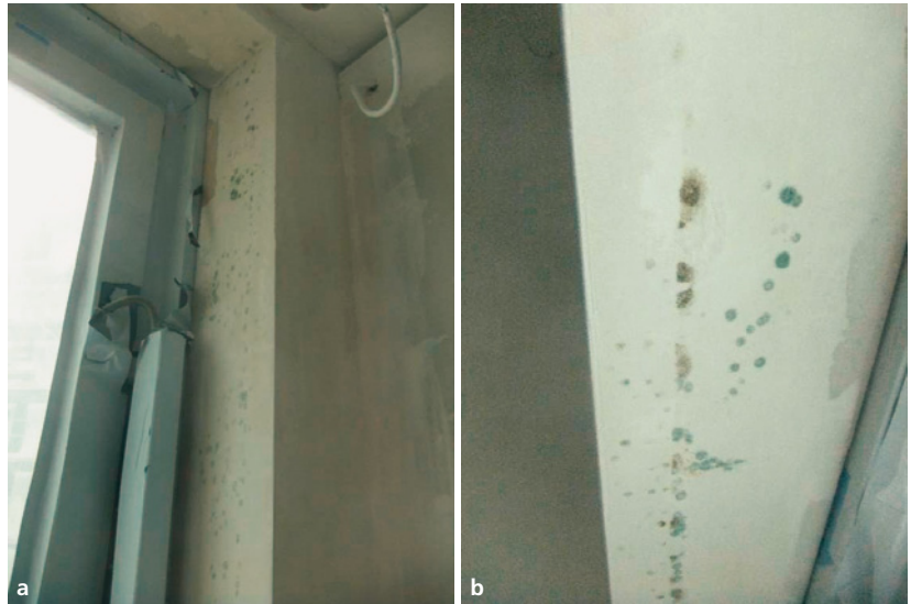
Abb. 2.1a, b: Schimmelbefall an Gipskartonlaibungen. Hier wurden im Neubau Gipskartonplatten mit Ansetzbinder an der Wand und am Sturz angeklebt. Überall dort, wo der Ansetzbinder ist, ist nach kurzer Zeit auf- grund von Restfeuchte aus dem Baukörper und Feuchte des Ansetzbinder Schimmel sichtbar.
