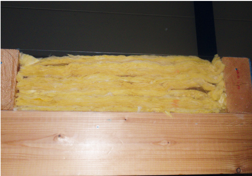
Abb. 7.2a: Holzbalkendecke mit Mineralfaserdämmung
