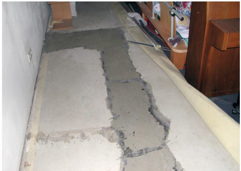
Abb. 6.22: Reparatur mit Reaktionsharz nach erfolgter Rohrbruch- reparatur und Trocknung
