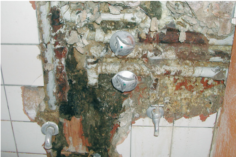
Abb. 2.16: Zuleitungsrohre durch defekte Abdichtung unter Fliesen korrodiert
