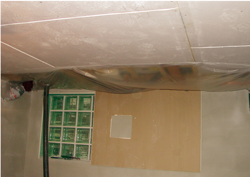
Abb. 7.15: Hinterlüftung einer Gipskartonplattendecke. Die Decke war teilweise demontiert bzw. noch nicht fertig gestellt.
