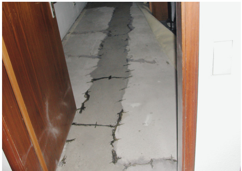
Abb. 6.23: Reparatur mit Reaktionsharz nach erfolgter Rohrbruch- reparatur und Trocknung
