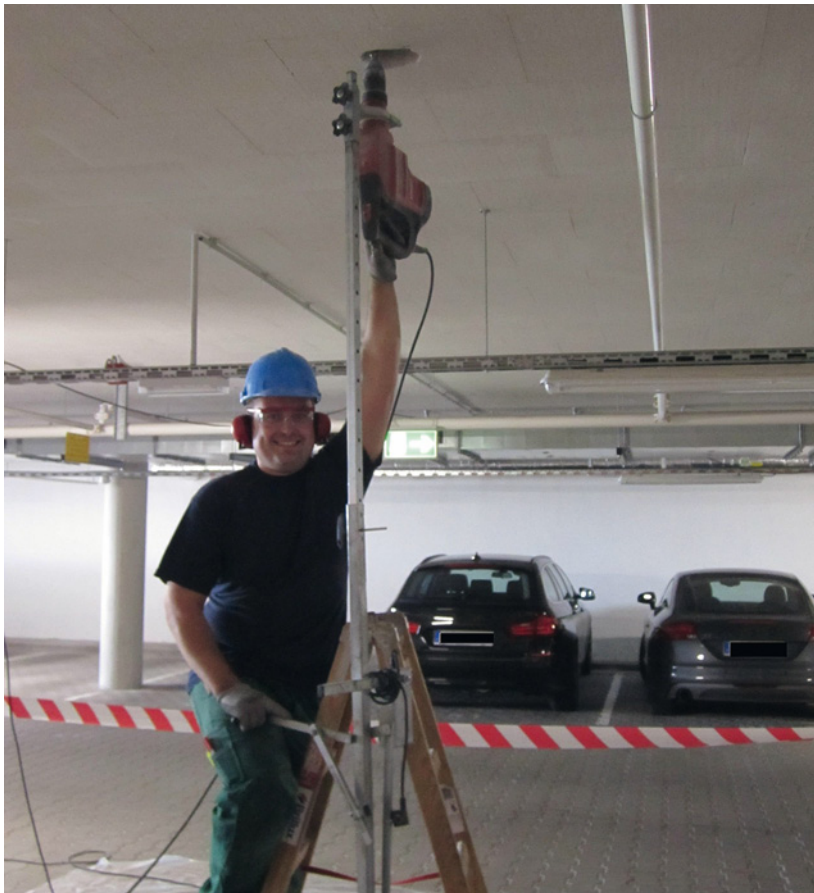
Abb. 5.33: Bohrung von unten in eine Stahlbetondecke. Die Bohrmaschine ist in eine Überkopfbohrereinrichtung eingespannt. Der Handwerker muss bei der Arbeit eine Schutzbrille tragen.
