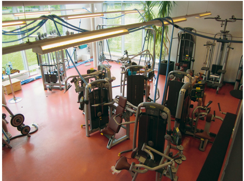
Abb. 9.2: Schlauchverlegung im Fitnesscenter über den Randbereich oder von oben
