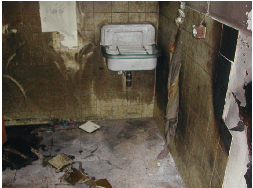
Abb. 2.48: Brandschaden in einer Waschküche: Die Wandfliesen waren auf Raufasertapete verlegt. Durch die Hitze löste sich die Tapete vom Untergrund ab. An den Fliesen entstand nur eine Beaufschlagung mit Ruß, welcher gereinigt werden kann.
