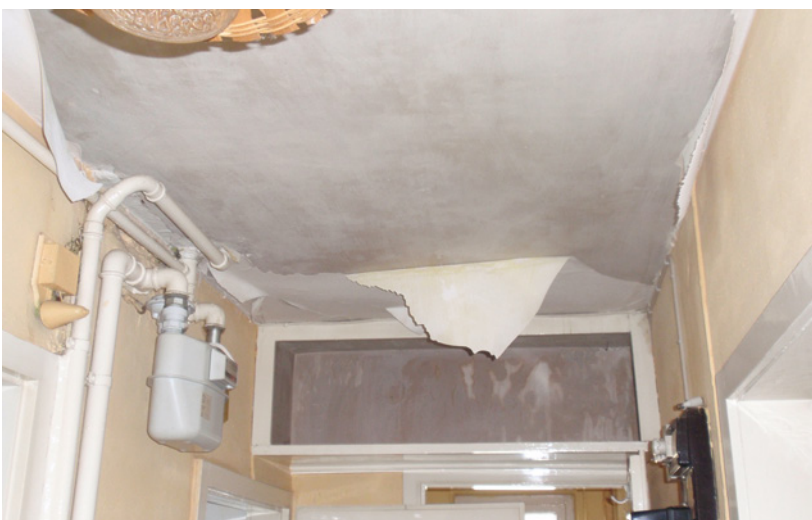
Abb. 7.19: Durchnässter Deckenputz, noch im tragfähigen Zustand.
