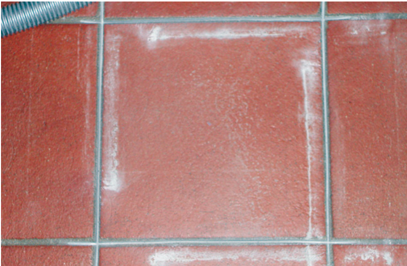
Abb. 6.5: Cottoplatte mit bereits aufgesägte Fuge
