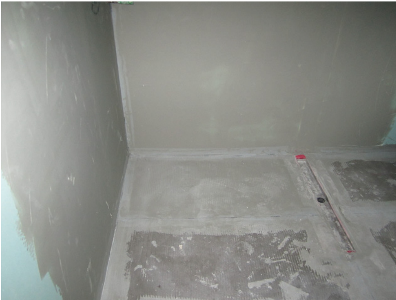
Abb. 2.14: Oberflächenabdichtung der Wand im Eckbereich: Abwasser mit Bodenschienensystem. Hier ist ein Dichtlappen an dem Bodenschienensystem angebracht, welches mit der Oberflächenabdichtung eingearbeitet werden muss.
