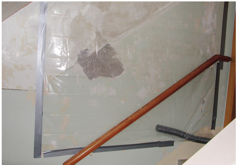
Abb. 7.26: d) Verschiedene Beispiele für die Trocknung von Wänden unter einem Folienzelt; Schlauchführung unter Folienzelt oder Kondensations- trockner unter Folienzelt gestellt.
