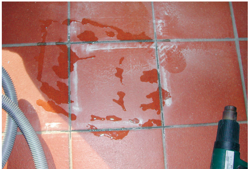
Abb. 5.57: b) Durchnässen der Fugen
