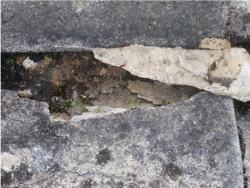
Abb. 2.23: Schichtenablösung einer Faserwellzementplatte durch Witterungsein- flüsse.
