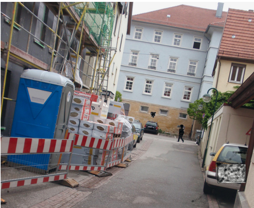
Abb. 2.21: Im Freien gelagerte Dämmstoffe
