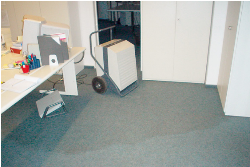
Abb. 5.4: Kondensationstrockner bei einer Raum-trocknung
