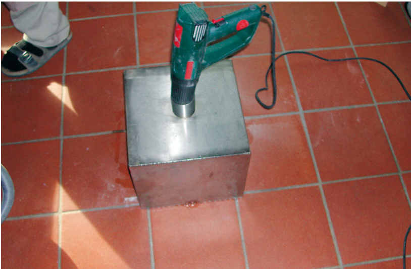
Abb. 5.57: c) Glocke zum Erhitzen der Fliese
