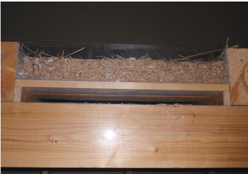
Abb. 7.2b: Holzbalkendecke mit Spreueinlage (Getreide)
