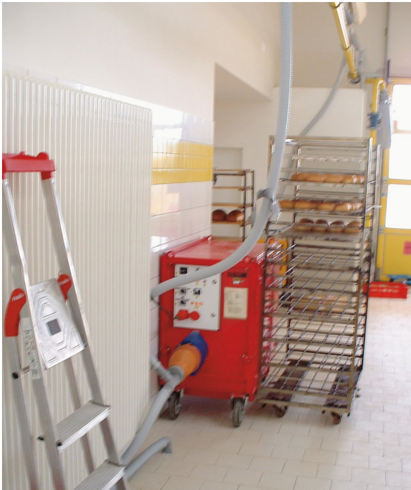
Abb. 5.45: Die Trockenluft wurde unzulässig – auf einen zu kleinen Querschnitt und auf zu kurzem Weg – reduziert. Daher konnte das Gerät nur auf Stufe I gefahren werden.
