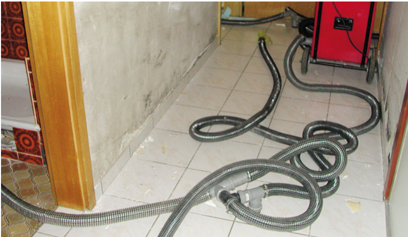
Abb. 5.54b: Ungünstige Schlauchverlegung: Pro Schleife ist ein Reibungsverlust von ca. 8 % vorhanden. Außerdem entstehen Stolperstellen für den Mieter.
