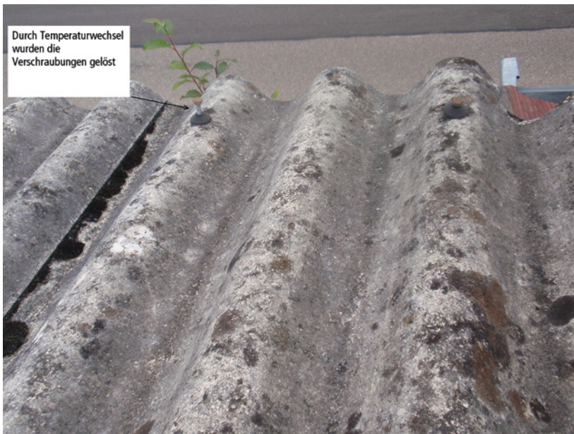
Abb. 2.24: Hier wurden durch über die Jahre einwirkende Windkräfte und Tempe- raturunterschiede die Befestigungsschrauben langsam herausgedreht.
