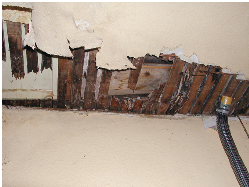
Abb. 7.6: Holzbalkendecke, von unten mit Gipskarton- platte beplankt und mit Raufaser tapeziert
