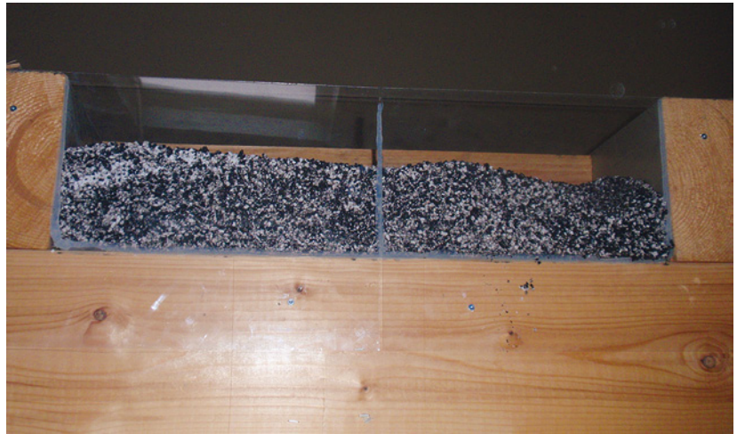
Abb. 7.2c: Holzbalkendecke mit Perliteschüttung
