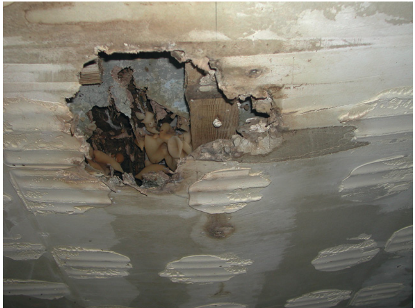
Abb. 7.8: Schimmelpilzbefall in einer Holzbalkendecke mit Schlackenschüttung. Hier muss vor Trocknungsaufbau das kontaminierte Material entfernt werden.
