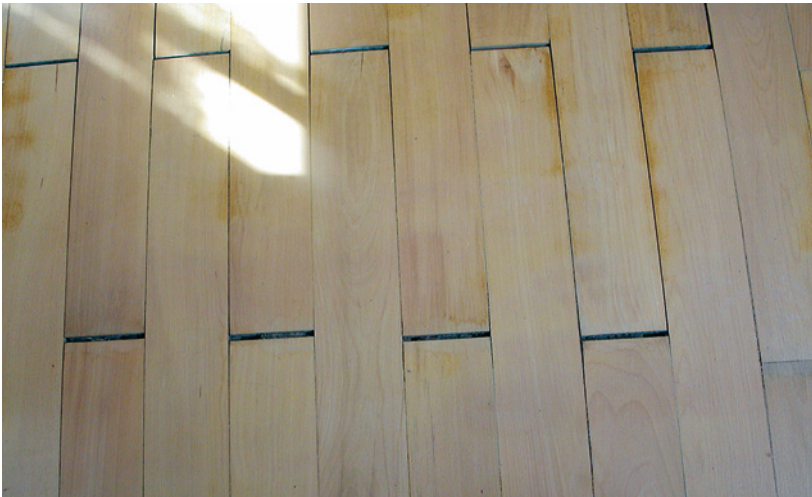
Abb. 5.55: Von einer Trocknungsfirma zu stark getrocknetes Parkett
