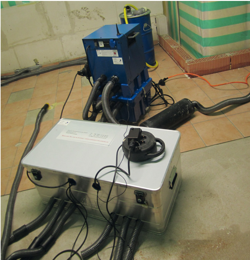
Abb. 5.22: Trocknungseinheit mit vorgeschalteter Messseinheit
