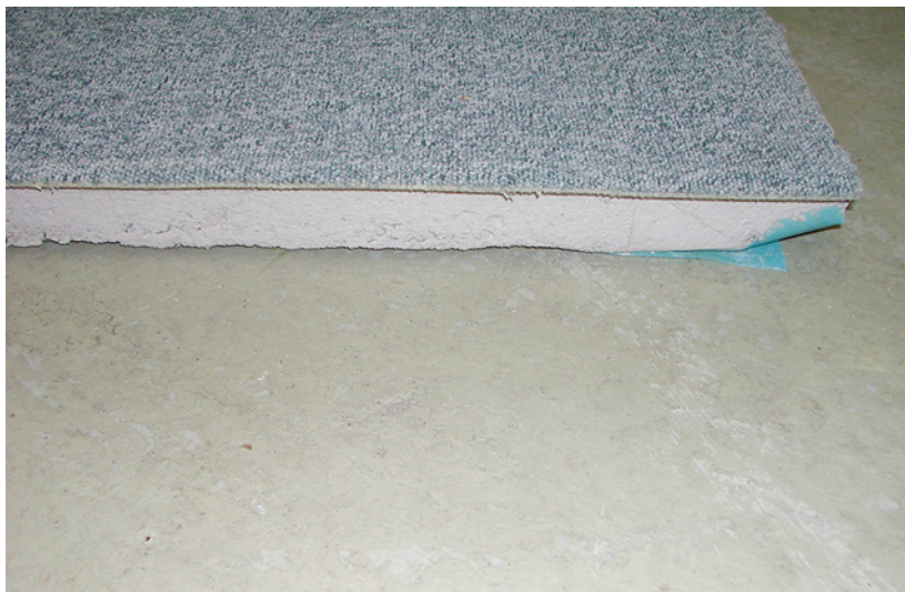
Abb. 7.20: Estrich auf Trennlage
