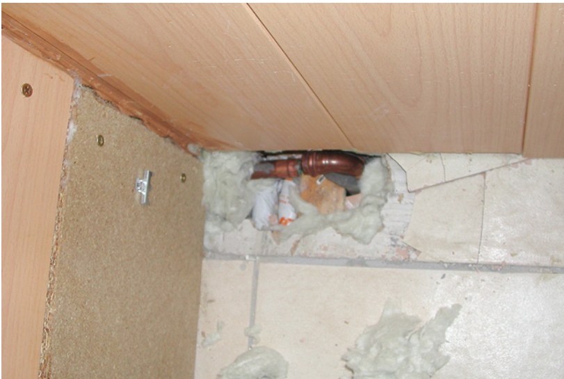
Abb. 2.41: Frostschaden: Hier wurde durch Ausdehnung beim Gefrieren des Wassers innerhalb der Zuleitung eine Pressverbindung auseinander gedrückt.
