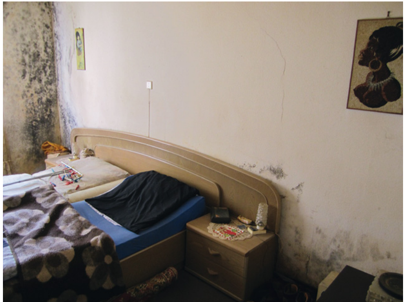
Abb. 10.3: Schimmel in einem Schlafzimmer durch falsches Lüften
