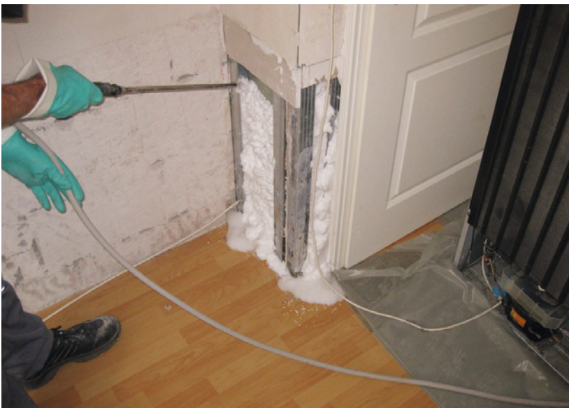
Abb. 11.6: Desinfektion der Trenn- wand bis in 1 m Höhe
