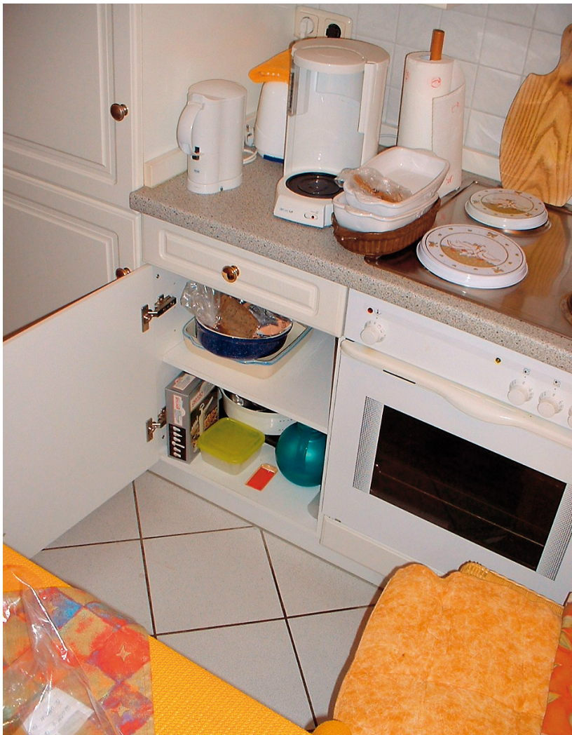
Abb. 10.15: Möbel aus beschichteter Spanplatte werden gereinigt, die offenen Kanten auf der Rückseite werden mit Kantenumleimern verschlossen, Rückseiten werden bei hochwertigen Küchen ersetzt.
