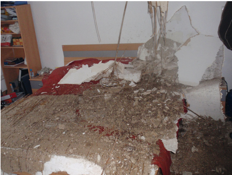
Abb. 6.33: Nach Durchnässung abgestürzte Decken- unterseite
