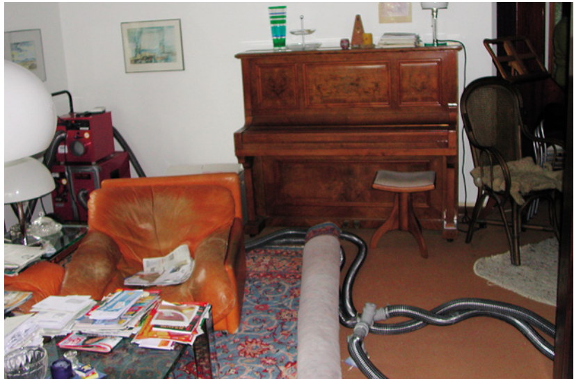
Abb. 6.34: Das Klavier wurde nicht aus dem Raum entfernt und auch nicht vakuumiert. Dadurch entstanden Risse an der Innenseite am Holz und das Klavier war verstimmt.
