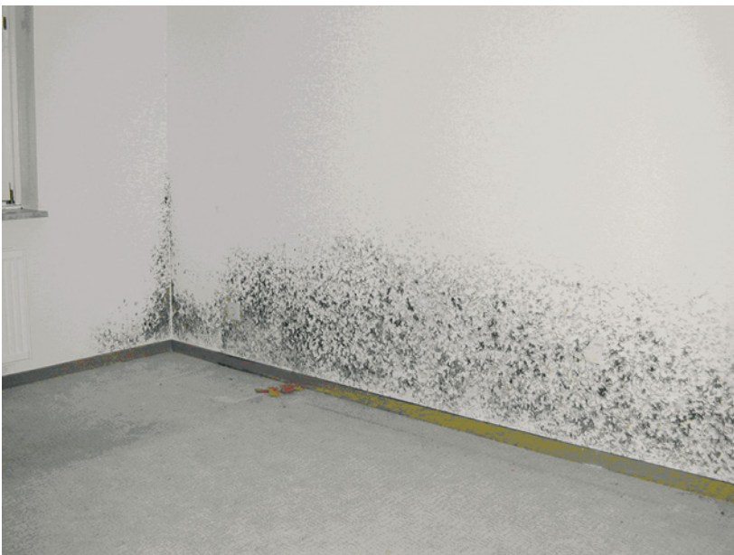
Abb. 2.29: Diese Wand wurde zweimal trockengelegt und saniert. Hier half am Ende nur die Klima- platte, weil die Nutzer nicht heizen und lüften.
