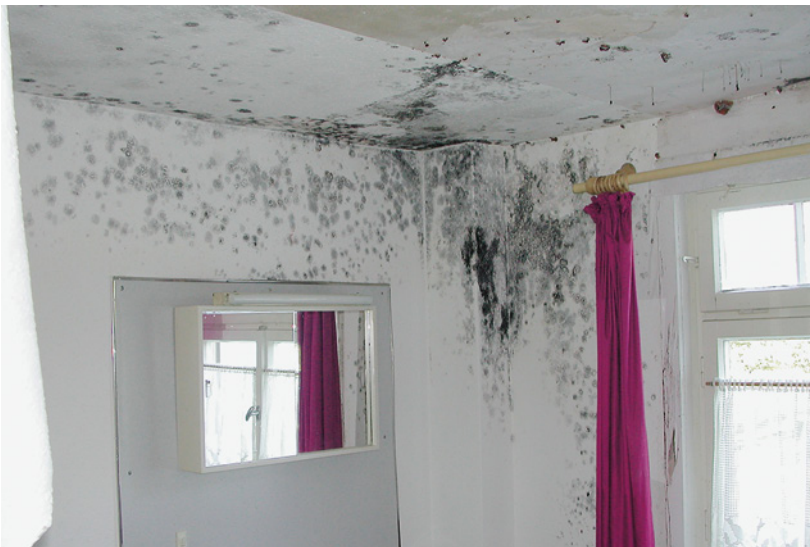
Abb. 10.1: Schimmelpilzbefall an einer tapezierten Wand
