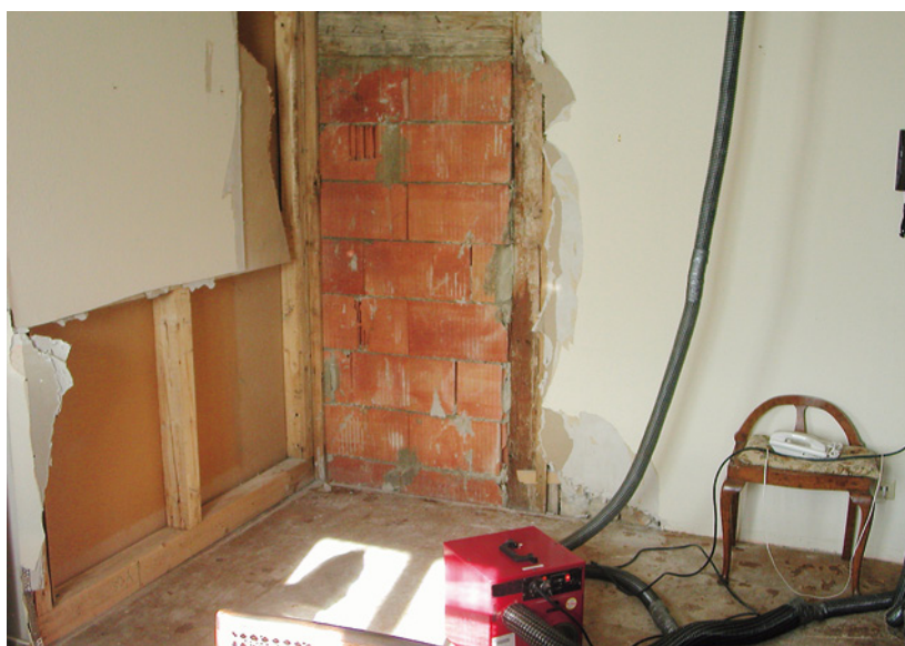
Abb. 7.25: Unterschiedlicher Wand- aufbau, empfohlener Trocknungsaufbau mit Folienzelt und Ad- sorptionstrockner. Das Mauerwerk war nicht durchnässt.
