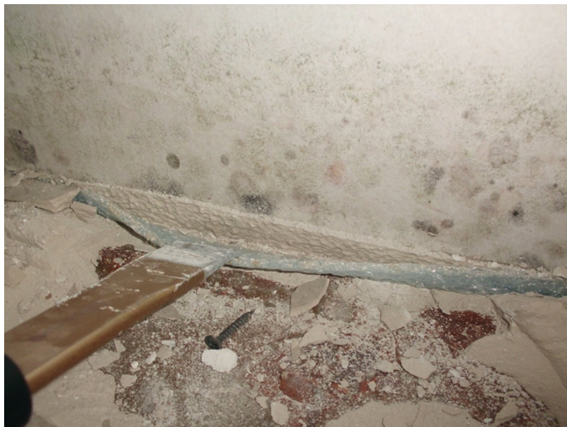
Abb. 2.22: Schimmel hinter dem Randstreifen bei Einbau
