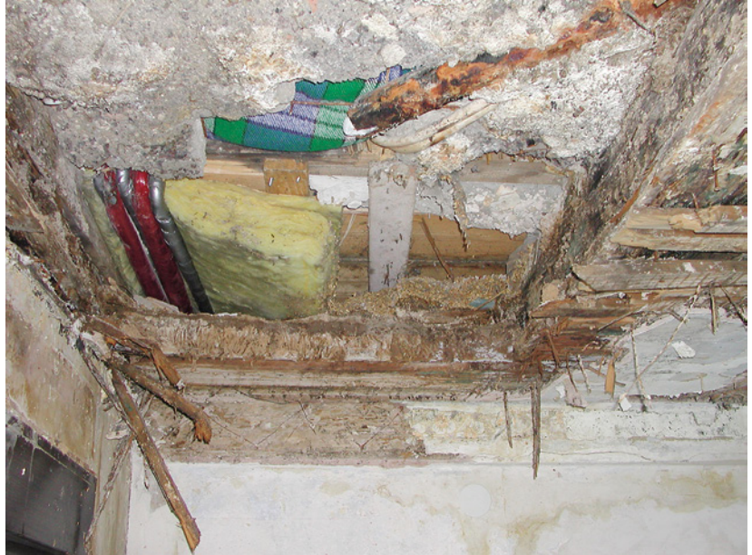
Abb. 6.31: Verrottete Holzbalken- decke mit Lehmwickel und Schimmelpilzbefall
