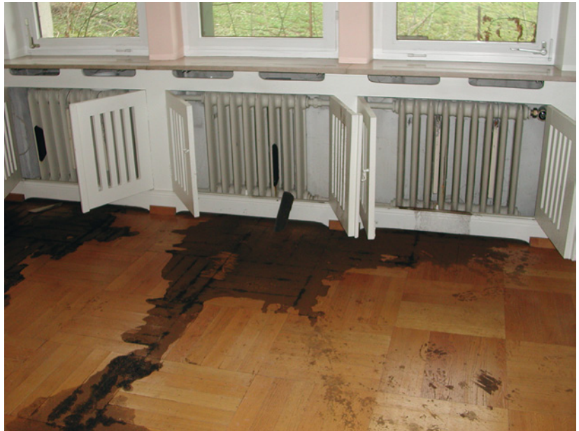
Abb. 2.36: Heizkörper, durch Frosteinwirkung auf- geplatzt
