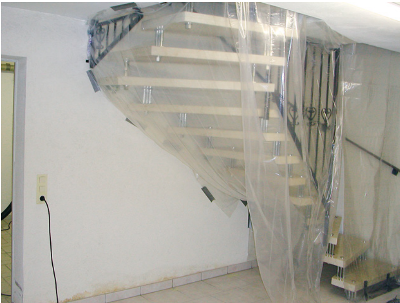
Abb. 5.15: Folientüre im Treppenhaus: Da nur das Untergeschoss zu trocknen war, wurde so der Luftraum eingegrenzt. Außerdem verhindern Folientüren das Vertragen von Schmutz und Schimmelpilzsporen im übrigen Haus.
