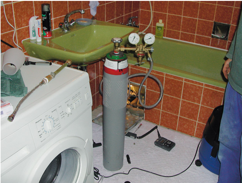
Abb. 4.24: Gasflasche (mit Tracergas); sie wird an das Wasser oder an die Heizungsleitung angeschlossen
