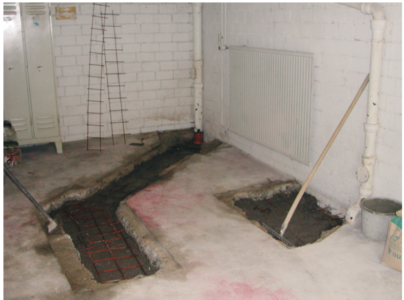
Abb. 4.37: Konventionelle Rohrbruchsuche und -reparatur einer Ab- wasserleitung (Kosten ca. bei 3.500 EUR). Eine Reparatur wäre mit einem Partliner einfach möglich gewesen (Kosten wären dann in Höhe von ca. 1.000 bis 1.300 EUR entstanden)
