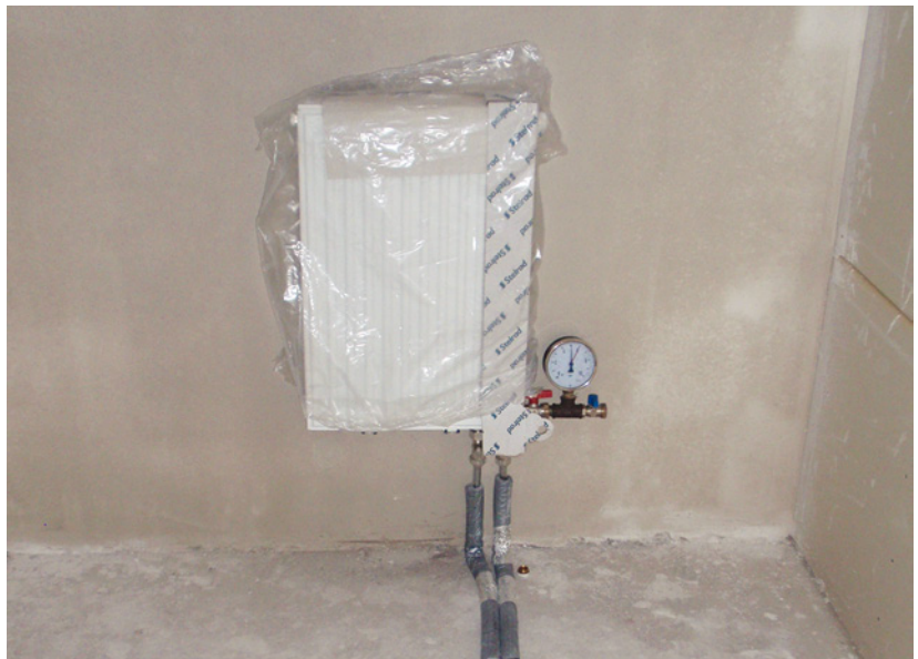
Abb. 4.16: Durchführung von Druckproben mit eingebautem Manometer am Heizkörper
