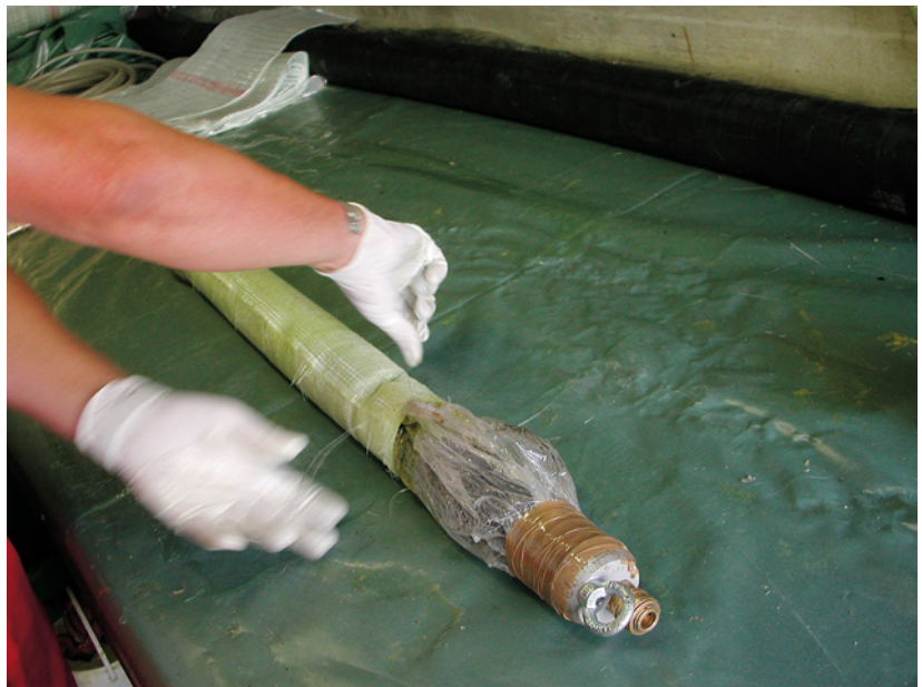
Abb. 6.35: c) das Gewebe wird um den Packer gewickelt.
