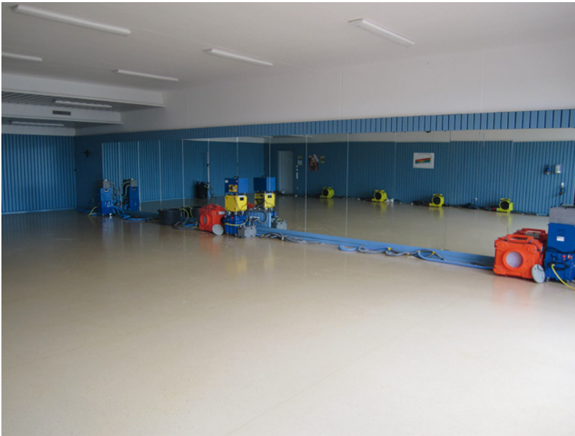
Abb. 9.4: Trocknungsanlage im Bereich der Schwing- böden; während der Trainingszeiten wurde die Anlage abgestellt.
