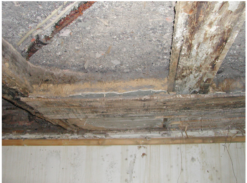
Abb. 6.32: Verrottete Holzbalken- decke mit Lehmwickel und Schimmelpilzbefall
