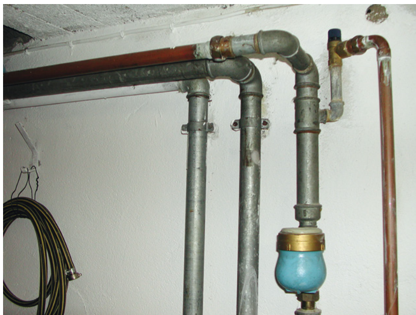
Abb. 2.11: Mischinstallationen von Rohrleitungsmaterialien sind bedingt zulässig. Hier muss immer die Materialverträglichkeit berücksichtigt werden.
