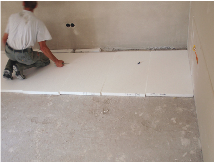
Abb. 2.20: Direkt aufgelegte Dämmschichtplatte. (Bei Perliteschüttungen werden meist weder Gipsreste noch son- stige Verunreinigungen entfernt und einfach überschüttet.) Laut VOB muss der Untergrund trocken, tragfähig, staubfrei usw. sein. In diesem Gebäude wur- den noch nicht einmal große Gipsrückstände auf der Rohdecke entfernt.
