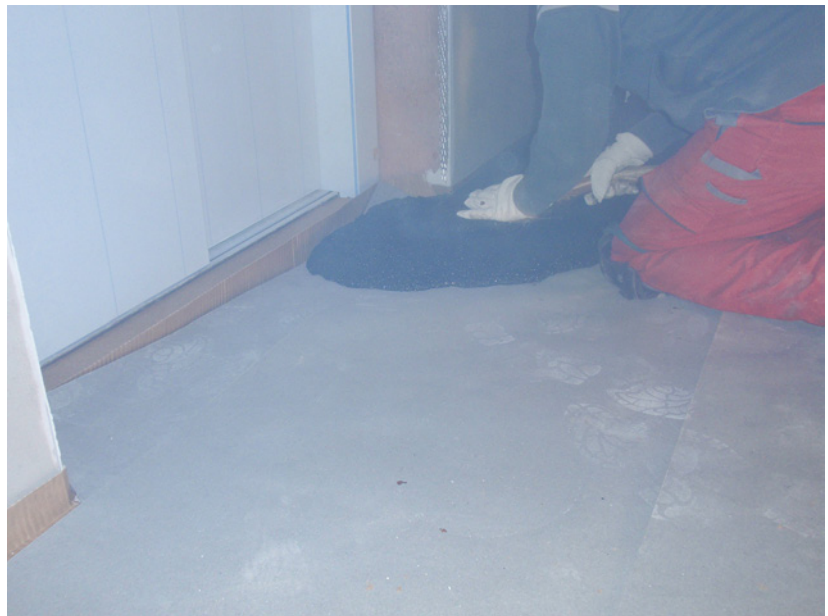
Abb. 6.27: Einbau von Gußasphaltestrich
