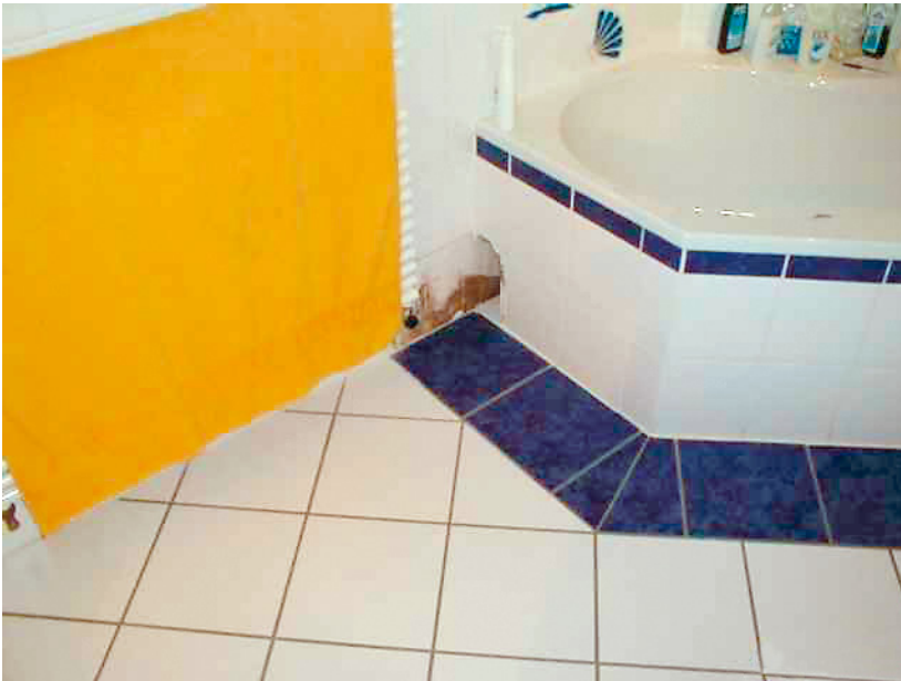
Abb. 4.20: Rohrbruchstelle ist nach Ortung freigelegt (Foto: Thermo Time GmbH, Sinzheim). Dies ist fachgerecht und als erfolgreich anzusehen.
