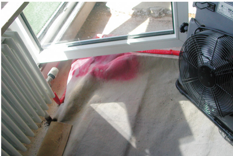
Abb. 6.7: Verfärbter Teppichbelag, bei dem eine Erhaltung nicht möglich ist.
