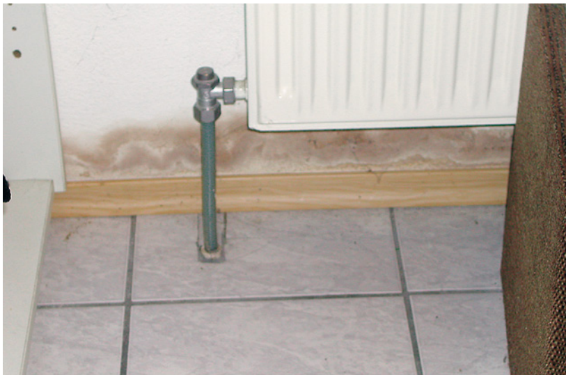
Abb. 3.1: Typisches Erscheinungsbild bei einem Wasserschaden, nachdem die Dämmschicht unter dem Estrich gesättigt ist und in den Wänden aufsteigt
