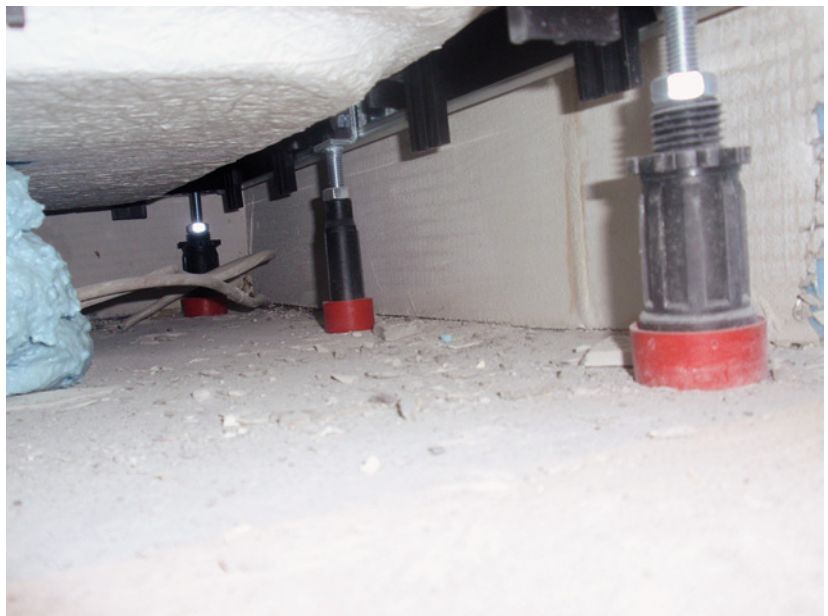
Abb. 2.7: Wannenrandbefesti- gung ordnungsgemäß ausgeführt. Hier ist der Wannenrand der Acrylwanne gegen ein Absenken gesichert.
