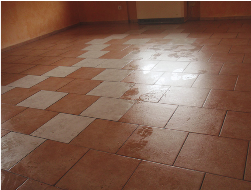
Abb. 2.39: Nässe auf den Fliesen (Kondenswasser- bildung)
