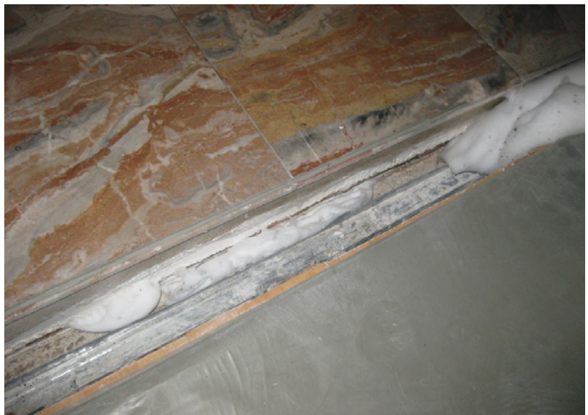
Abb. 11.4: Austritt des Desinfek- tionsschaums aus den offenen Randfugen an der entfernten Trennwand
