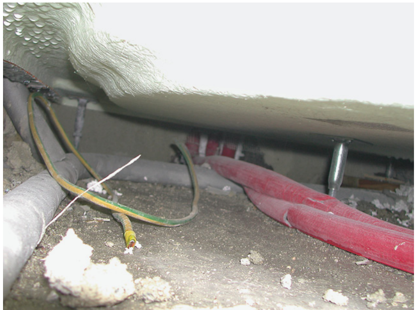
Abb. 2.6: Fehlende Wannenrand- befestigung nicht ord- nungsgemäß befestigt. Dadurch Abriss der elas- tischen Wartungsfuge. So konnte nach jedem Duschvorgang Wasser durch die abgerissene Verfugung unter die Duschwanne gelangen.
