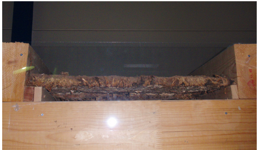
Abb. 7.2d: Holzbalkendecke mit Lehmwickleinlage
