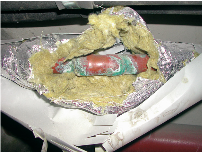
Abb. 2.12: Nicht fachgerecht verlötetes Kupferrohr mit Grünspanansatz (dieser ist durch ausge- tretenes Leitungswasser entstanden).
