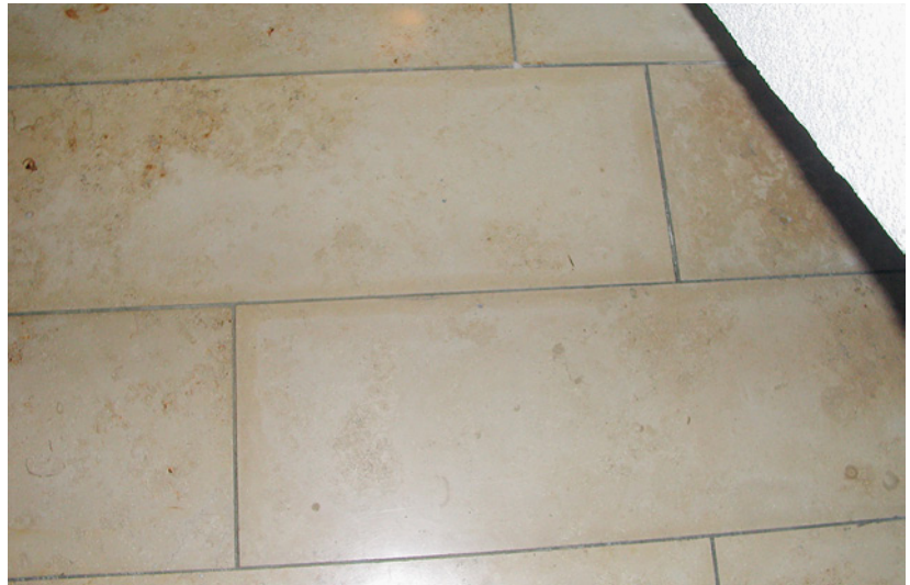
Abb. 6.6: Marmor in einem Treppenhaus nach einer Trocknung. Die Reparatur einzelner Platten war möglich.
