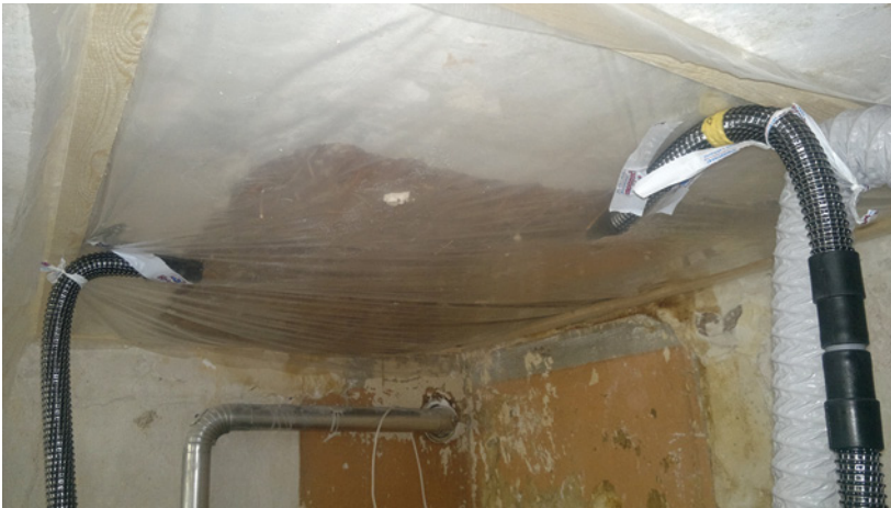
Abb. 7.9: Dämmschichttrocknung einer Holzbalkendecke, blasend. Aufbau vom darunter liegenden Raum; Feuchtluftab- führung in den oberen Raum
