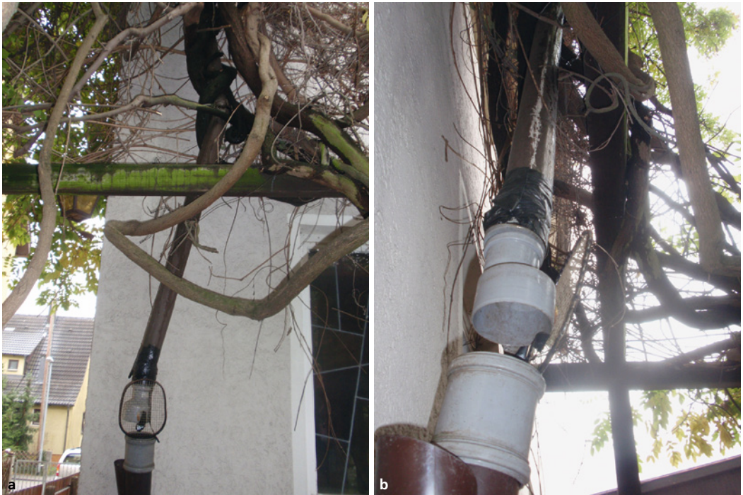
Abb. 2.27a, b: Eine außen am Gebäude angebrachte Regenfallleitung, etwas verwachsen mit einem Versatz
