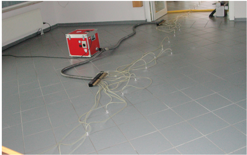
Abb. 5.32: Spinnentrocknung: Es wurden jedoch zu wenige Bohrungen gefertigt. eine lange Trockenzeit war die Folge.
