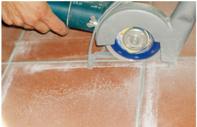
Abb. 5.57: Fliesenentfernung am Beispiel einer Cottoplatte a) Aufsägen der Fugen
