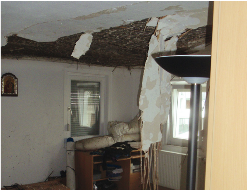
Abb. 7.18: Abgelöster Deckenputz
