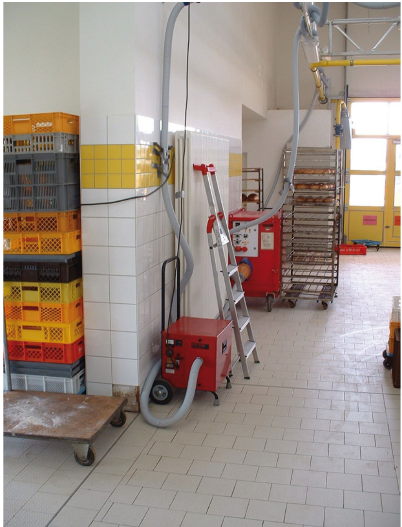
Abb. 5.46: Die Knoten in der Verlegung führten zu vermeidbaren Druckverlusten.
