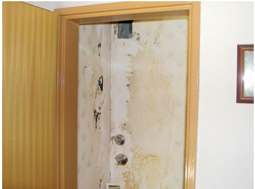
Abb. 3.2: Schimmelpilzbildung nach einem Wasserschaden
