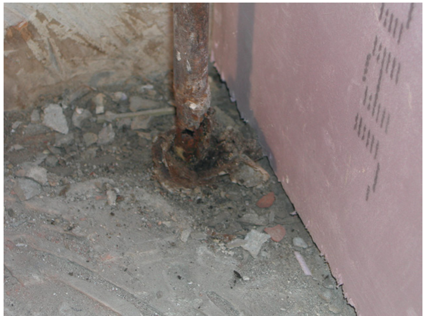
Abb. 2.25: Ein ca. 40 Jahre altes, vollständig korrodier- tes Heizungsrohr am Anschluss Estrich- Oberkante
