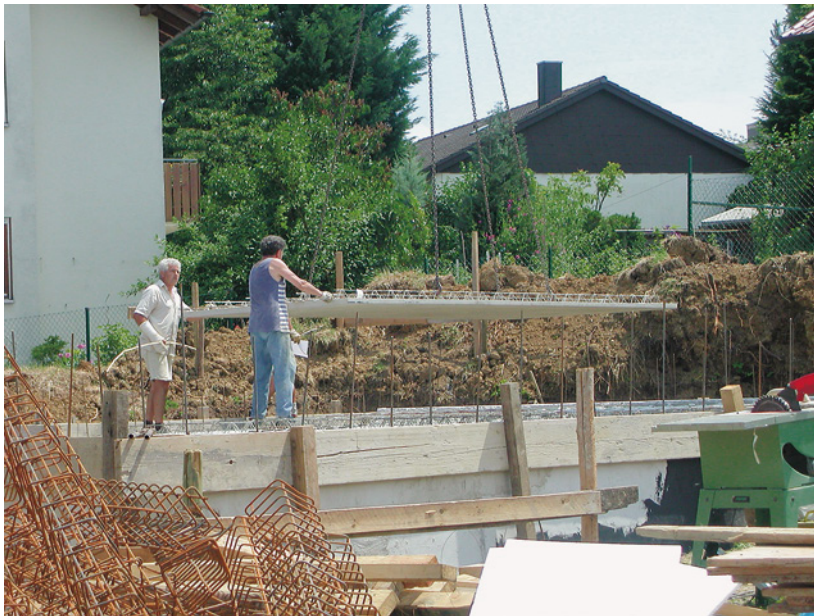
Abb. 7.1: Fertigteildecken- montage
