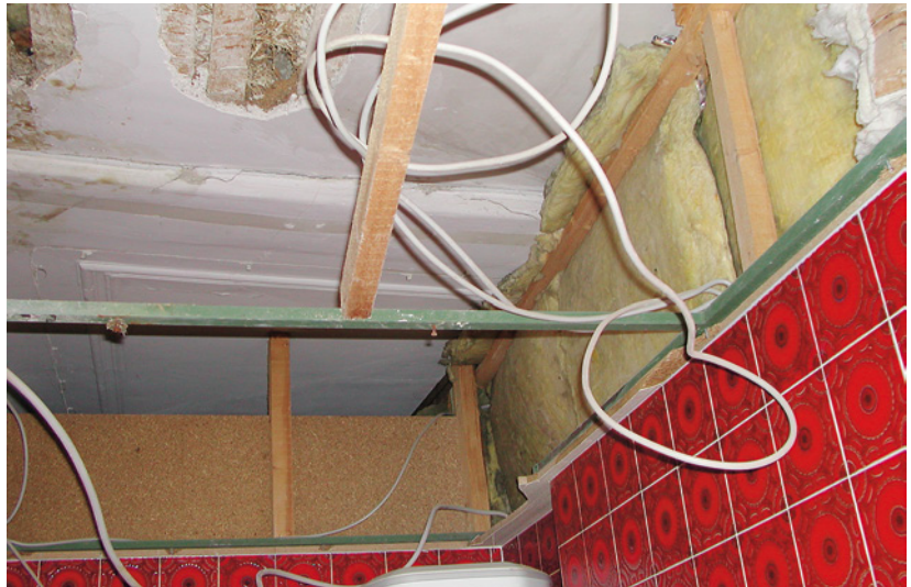
Abb. 7.16: Unterkonstruktion: abgehängte Decke auf Spanplatte mit Raufaser, tapeziert in demontier- tem Zustand
