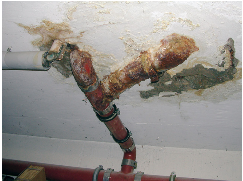
Abb. 2.4: Falsch gewähltes Rohrmaterial: Die in einer Bäckerei anfal- lende Lauge wurde über die Abwasserrohre abgeführt. Die Lauge hat das Rohrmaterial angegriffen.
