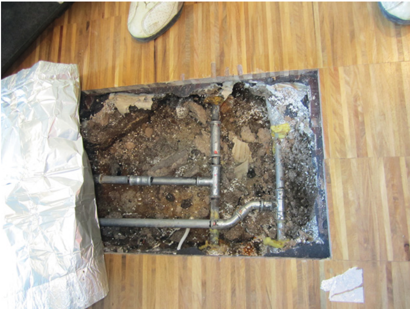
Abb. 6.25: Perliteschüttung mit Fasern und Hartfaser- platte, darauf Gussas- phalt. Hier wurde eine technische Trocknung in 14 Tagen erfolgreich durchgeführt.
