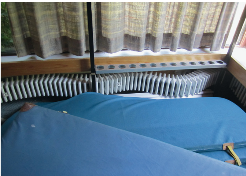
Abb. 2.35: Noch installierter Heizkörper, nach Frosteinwirkung verformt
