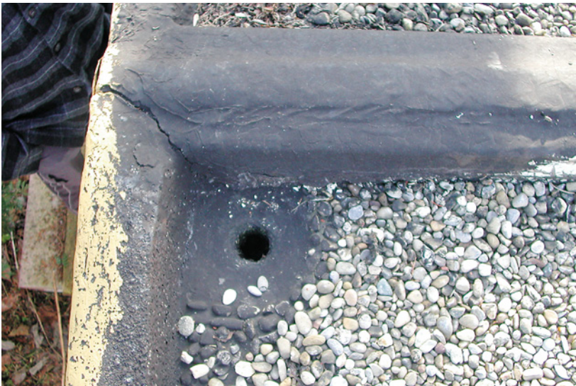
Abb. 7.30: Defekte Abdichtung mit Rissbildung auf einer Garage
