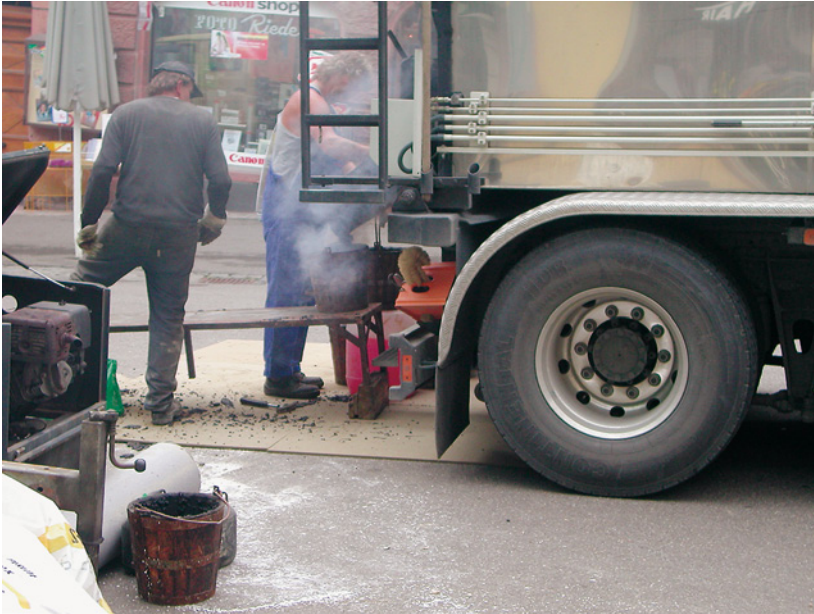
Abb. 6.24: Anlieferung von Gussasphaltestrich in heißer Form
