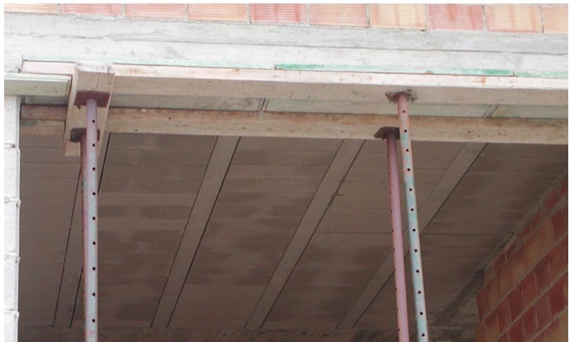
Abb. 7.11: Hohlkörperdecken- platten, zwischen Stahlträgern eingesetzt
