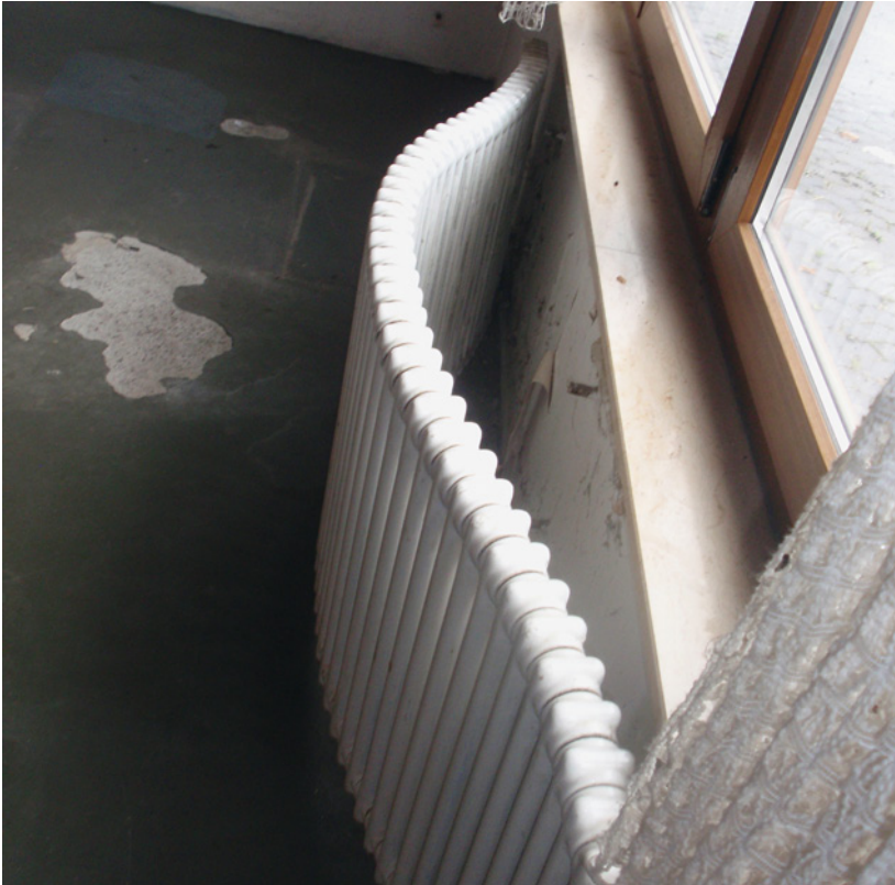
Abb. 2.34: Noch installierter Heizkörper, nach Frosteinwirkung verformt
