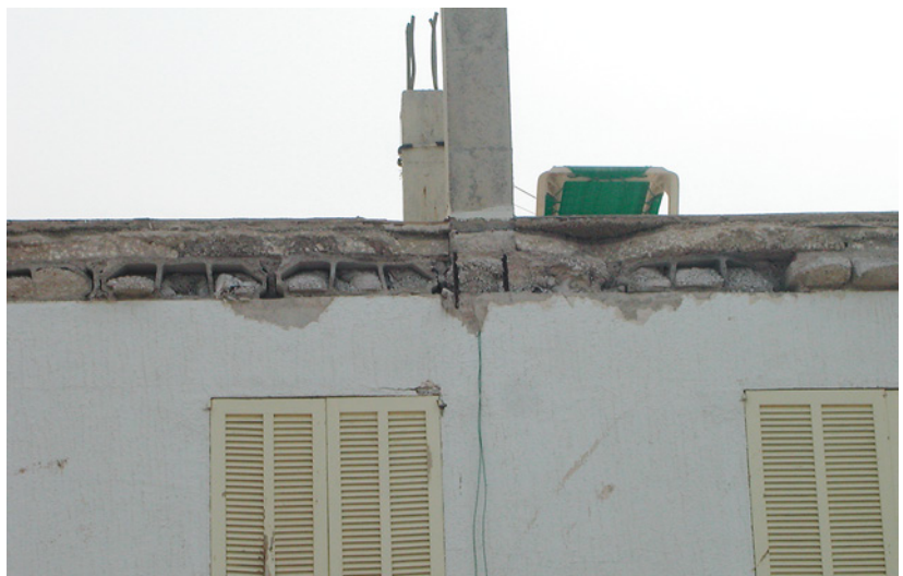
Abb. 7.12: Offener Rand einer Hohlkörperdecke
