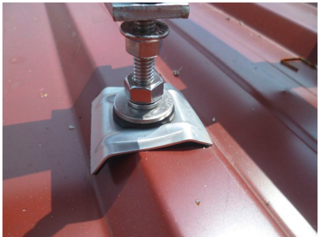
Bild 55: verschobene und deformierte Befestigungskalotte
