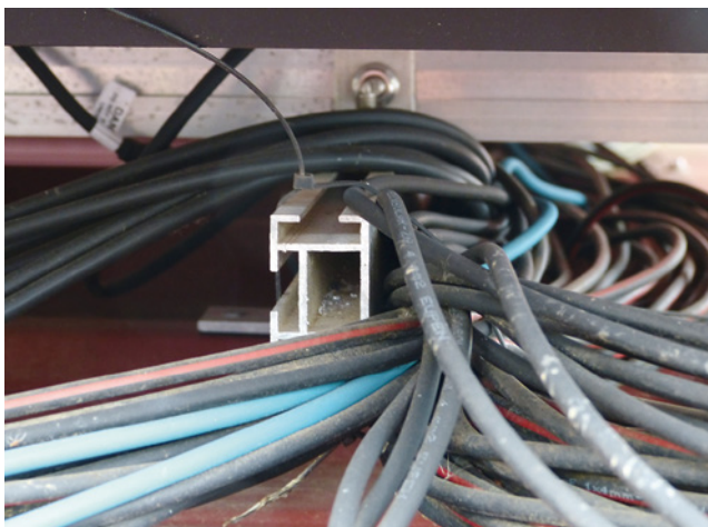
Bild 63: Bei so viel Kabelgewirr kann man sicherlich nicht von einer kurzschluss sicheren Verlegung sprechen.
