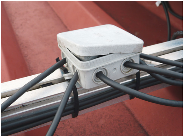
Bild 82: nicht geeignete Ausführung eines Generatoranschlusskastens mit nicht fest schließendem Deckel und fehlenden wasserdichten Kabeleinführungen
