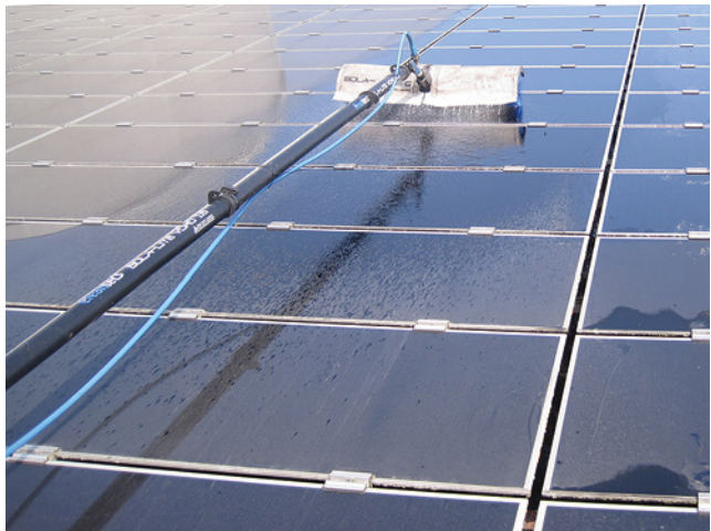
Bild 135: professionelle Reinigung mit aufbereitetem Wasser
