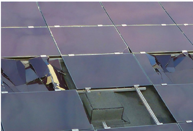
Bild 43: zerbrochene Module aufgrund falscher oder fehlender Schneelastberücksichtigung
