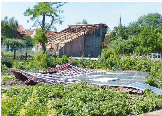
Bild 45: PV-Anlage und Dach vom Winde verweht – Ursache: fehlerhafte Dachkonstruktion und Befestigung der Photovoltaikanlage nur auf dem Dachblech
