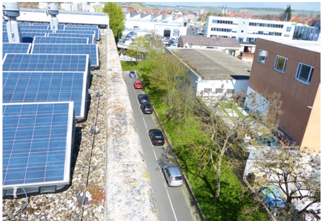
Bild 35: Modulmontage bis an exponierter Stelle am Dachrand – Absturzsicherung?
