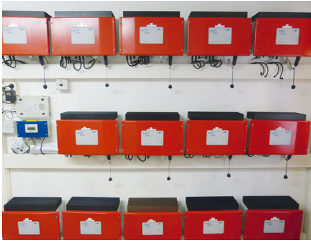
Bild 103: Hier heizen sich die Wechselrichter gegenseitig auf.
