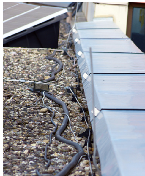
Bild 118: Leitungen ohne Abstand zum Blitzschutz
