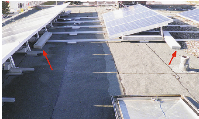
Bild 57: unterschiedliche Beschwerungsanordnungen – ohne feste und dauerhafte Auflagerung
