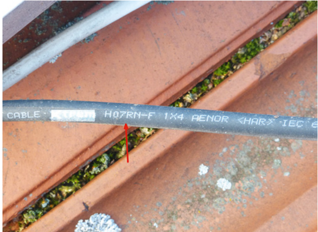
Bild 79: problematisch: Gummischlauchleitungen auf Dachflächen
