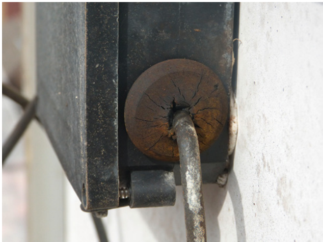
Bild 100: rissige, verwitterte Dichtungen bei den Kabeleinführungen
