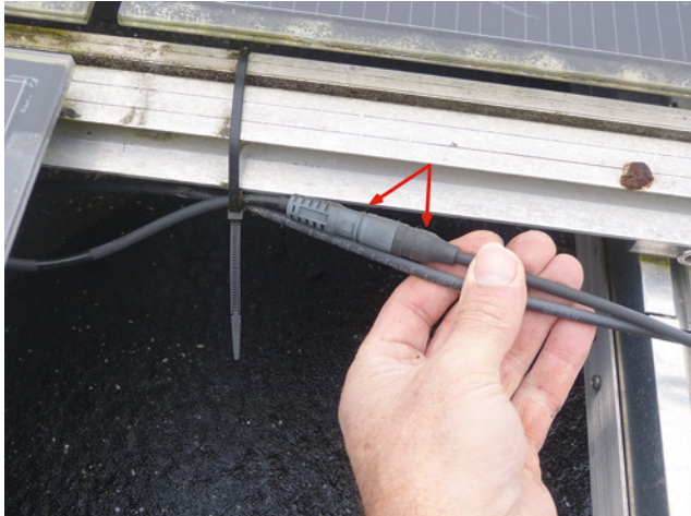
Bild 84: unterschiedliche Steckerfabrikate
