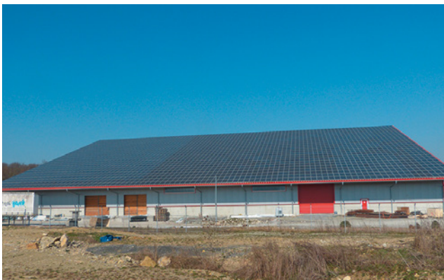
Bild 34: Module soweit das Auge reicht – Wartungsgänge?
