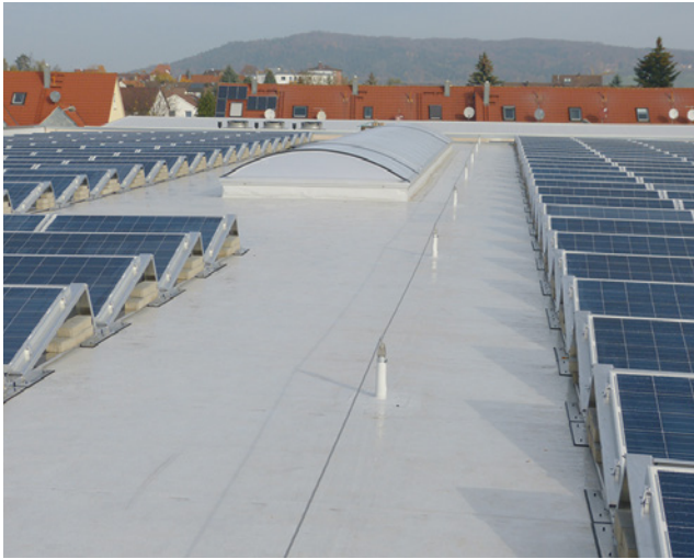
Bild 33: seltener Anblick: Flachdach mit Sicherungseinrichtung
