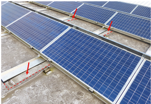
Bild 59: Lageverschiebung von sogenannten Leichtbausystemen
