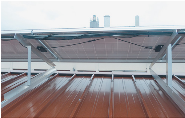
Bild 73: querverstringte Module mit von der Anschlussdose gegenläufiger und auf Zug befestigter Kabelführung
