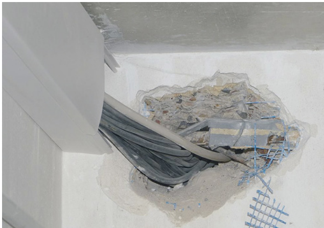
Bild 114: Wanddurchführung ohne Leitungsschutz
