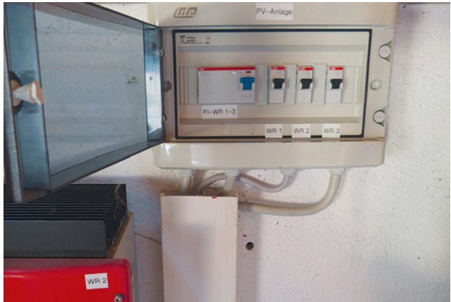
Bild 109: einfache und übersichtliche Anlagenkennzeichnung
