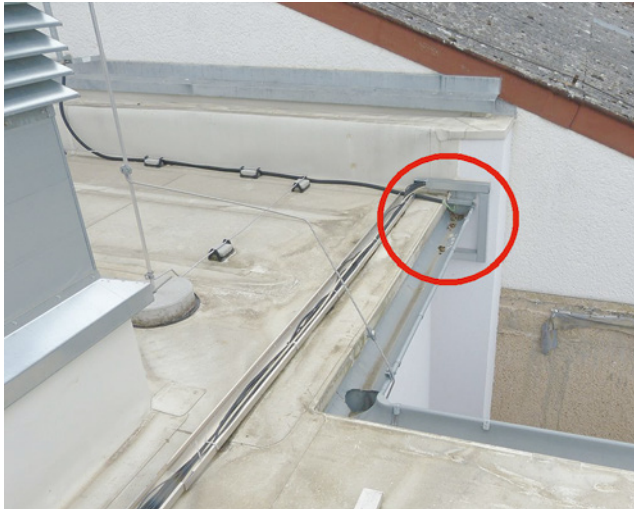
Bild 113: nicht eingehaltener Trennungsabstand zur Blitzschutzanlage (Kreuzung Dachabgang Kabelrinne zur Dachrinne)
