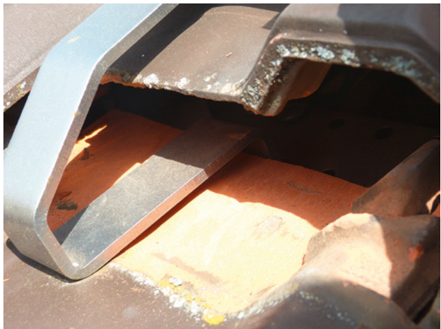
Bild 51: Komplette ausgeschliffene Kopfverfaltung am Ziegel begünstigt den Eintrieb von Niederschlag.
