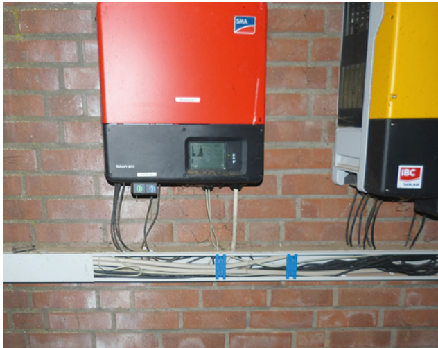
Bild 105: vermischte Leitungsverlegung (DC-AC-Datenleitung) in einem Kabelkanal
