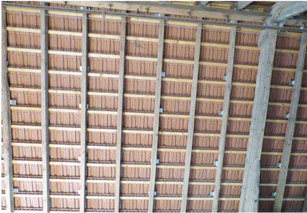
Bild 49: Situation vor Ort mit lastfreiem Dachsparren (Sparren ohne Dachhaken) und über alle Sparren verteilt angeordnete Befestigungspunkte
