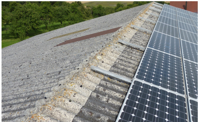
Bild 32: bereits bei der Errichtung nicht zulässig: überbaute Asbestzementdächer
