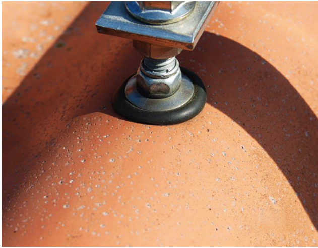
Bild 56: zu fest angezogene Stockschraube mit Überbeanspruchung der Dichtung und Oberwelle der Dacheindeckung
