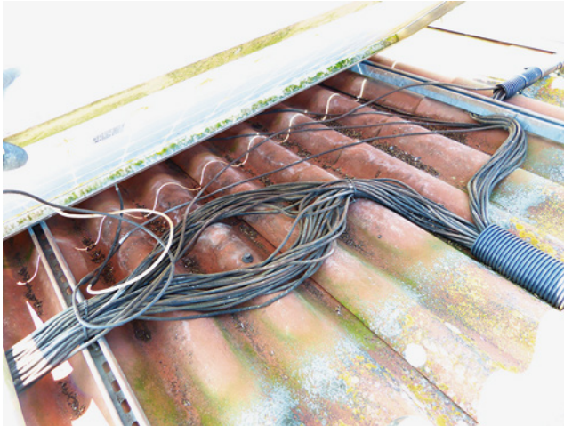
Bild 65: ungeschützte, auf Dachhaut aufliegende Leitungen entsprechen keiner kurzschluss sicheren Verlegung
