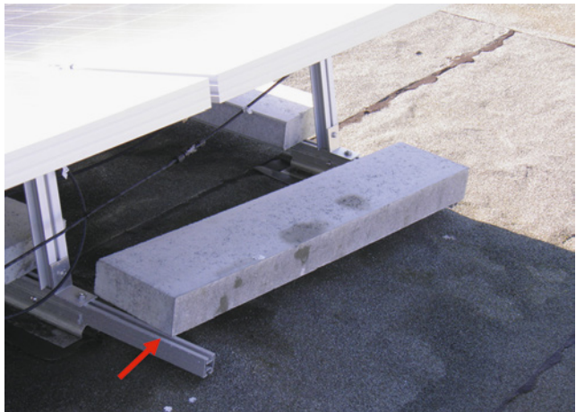
Bild 58: Balanceakt – Lagesicherheit der Beschwerung unzureichend
