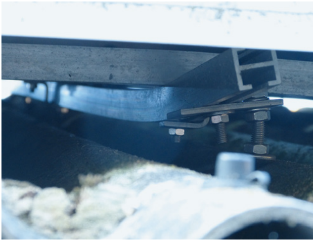
Bild 42: deformierte Tragschiene infolge zu weiter Befestigungsabstände
