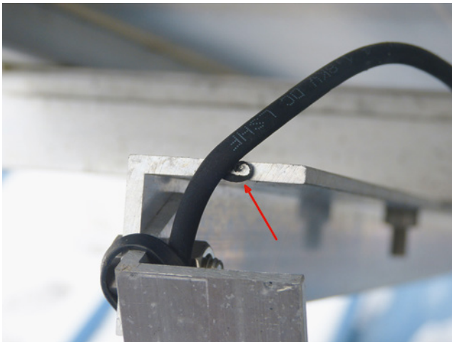
Bild 66: häufige Beanstandung: Leitungen an scharfen Metallkanten anliegend
