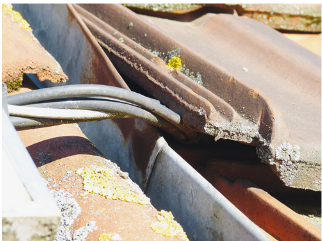
Bild 76: Leitungseinführung in Dachraum: durch Ziegel gequetschte Leitungen
