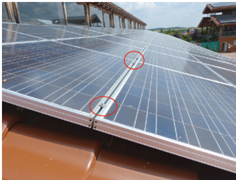
Bild 60: problematisch: Klemmbefestigung mit Beilagscheibe
