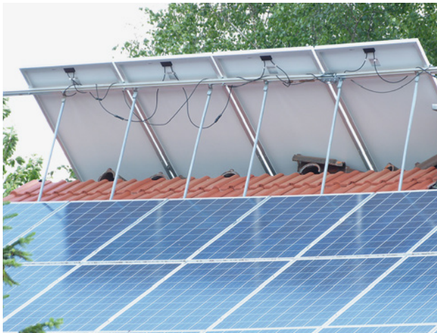
Bild 46: Solche »windigen« Konstruktionen gehen selten gut.
