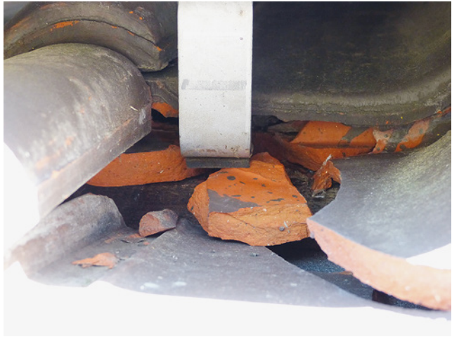
Bild 50: Aufliegende Dachhaken begünstigen Ziegelbruch.
