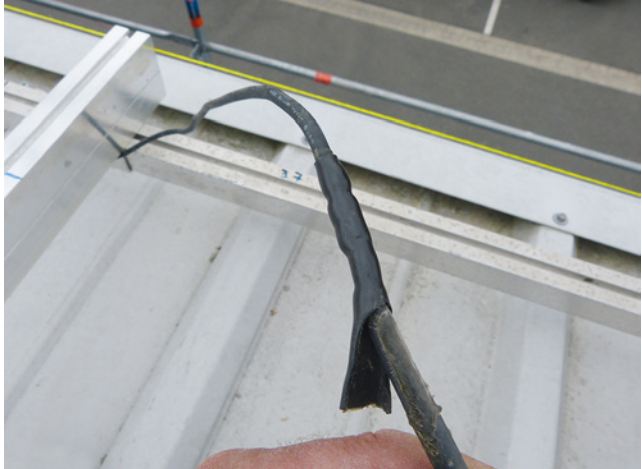
Bild 75: nicht zulässige Leitungsverbindung mit Schrumpfschlauch
