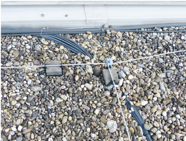
Bild 120: Ungeschützte Gleichstromleitungen kreuzen Blitzschutzanlage.
