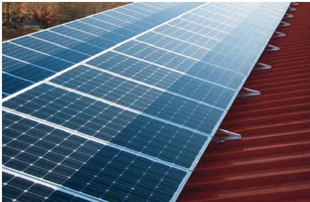
Bild 39: zu geringer Reihenabstand und Hochkantmontage der Module bewirken »Vollverschattung« der Module
