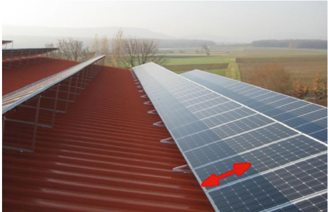
Bild 10: zu enger Reihenabstand und falsche Modullage erzeugt »Vollverschattung«
