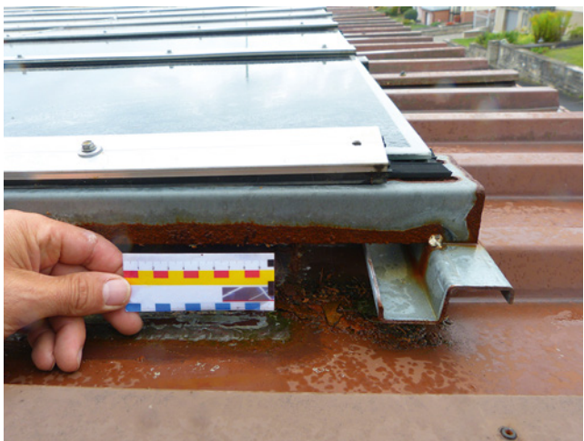
Bild 40: Korrodierte Tragkonstruktion, ca. 5 Jahre alt!
