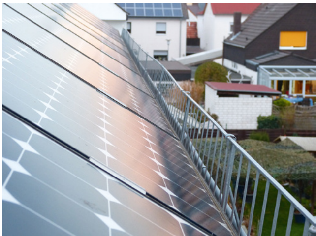
Bild 11: Auch kleine Verschattungen haben große Wirkung, wie hier ein Schneefanggitter.
