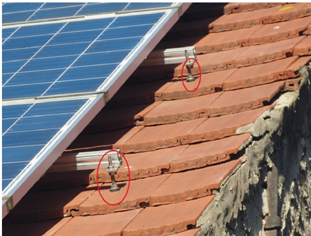
Bild 53: Stockschraubenbefestigung bei Dachziegel geht selten gut.
