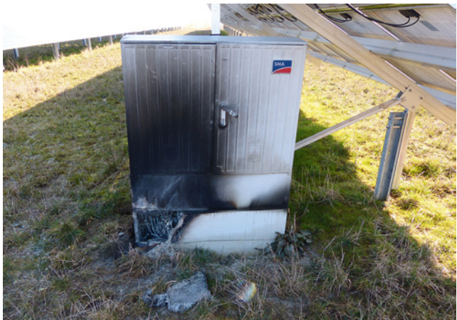
Bild 20: Auch bei Freifeldanlagen können Fehler einen Brand verursachen.
