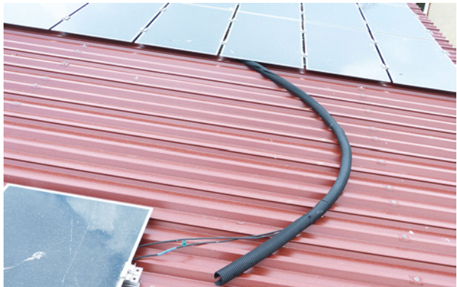
Bild 71: keine ausreichende Befestigung des Schutzrohrs mit Beschädigungspotenzial an Dachhaut und Leitung
