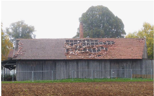
Bild 44: durch Sturm teilweise abgedecktes Ziegeldach mit Ziegelwurf insbesondere in den Eckbereichen und ausgehend vom Firstbereich
