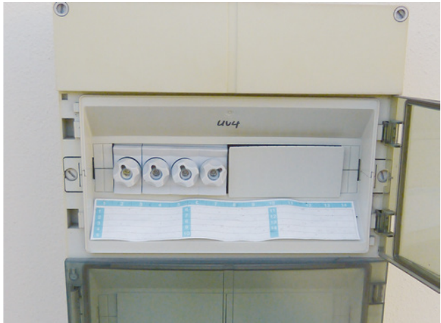
Bild 106: in vielen Fällen nicht zulässig: Schraubsicherungen – dazu noch fehlender Abstand
