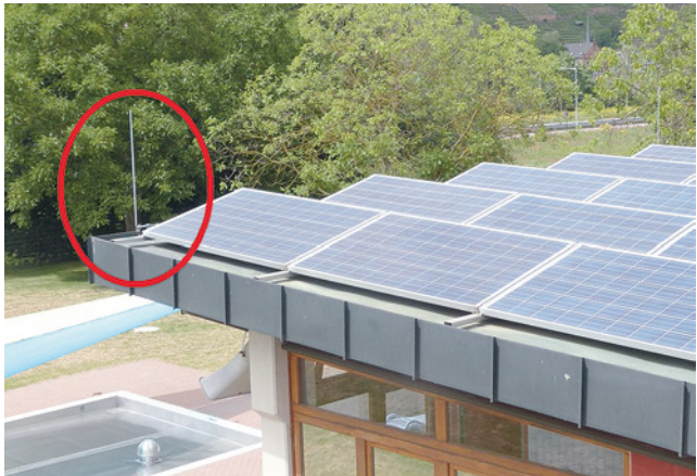
Bild 115: PV-Anlage ohne Trennungsabstand zur BSA
