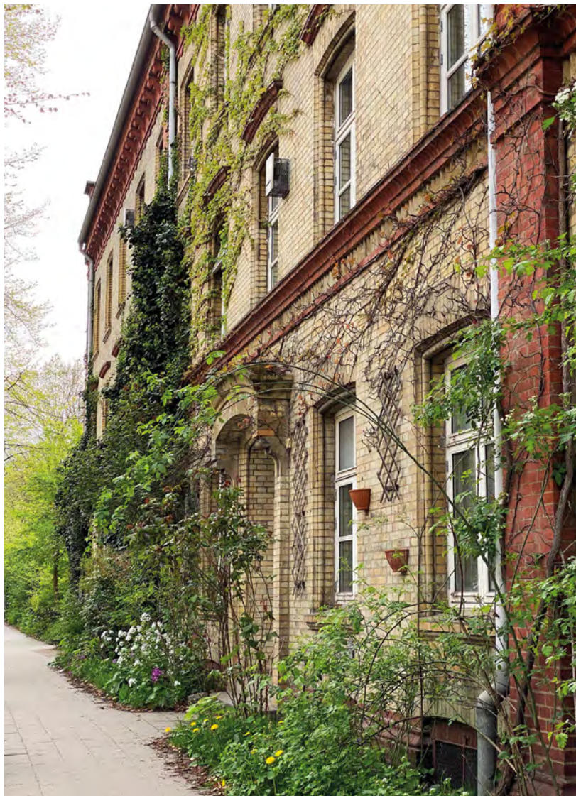
Abb. 70: Hamburg Eimsbüttel, Schröderstift, Straßenansicht (eigene Aufnahme, April 2024)
