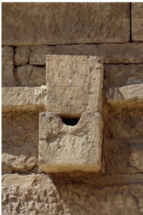
Abb. 5 a: Zweiteiliger Wasserspeier an GB 44, Vorderansicht; 2021
