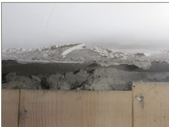
Bild 135: Salzbelastete Putzreste vom Abschlagen des unteren Putzstreifens aus dem Jahr 2006 wurden nicht entfernt und liegen im Spalt zwischen Holz und Wand.
