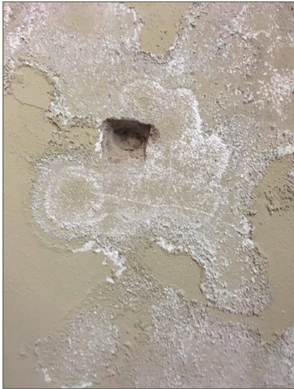
Bild 67: Durchschlagen von Salzen durch frischen Putz
