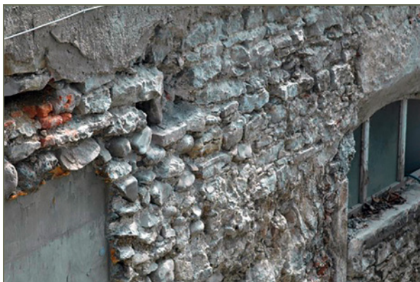
Bild 34: Freigeschachtete, unregelmäßige Kelleraußenwand aus Mischmauerwerk
