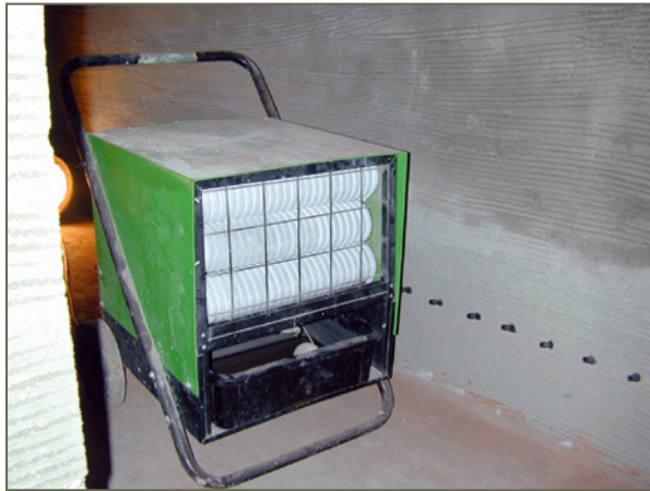
Bild 40: Einsatz eines Bautrockners. Hier nach einer Horizontalabdichtung
