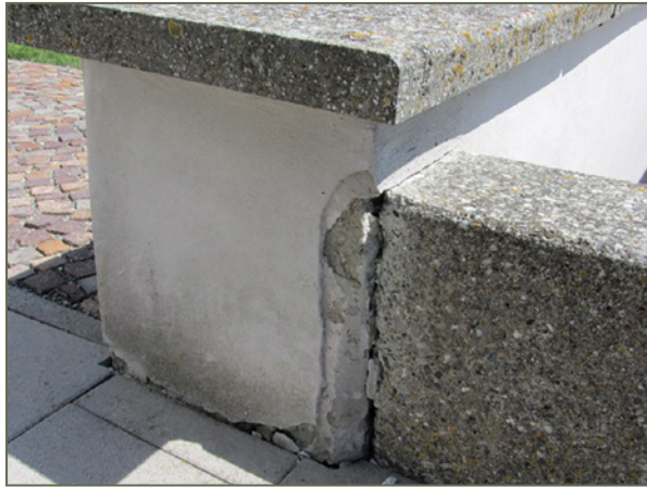
Bild 126: Nicht fachgerechte Anschlussgestaltung zwischen Treppe und Kirchhofmauer, über die Oberflächenwasser in die Fuge und hinter den Putz gelangen kann
