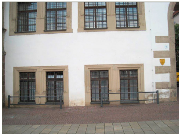
Bild 149: Lediglich am Sockel der Marktfassade im Spritzwasserbereich sind Tausalzschäden vorhanden
