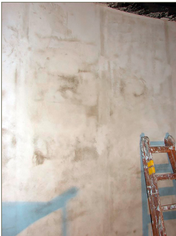
Bild 85: Lokale Durchfeuchtungen durch Tauwasser
