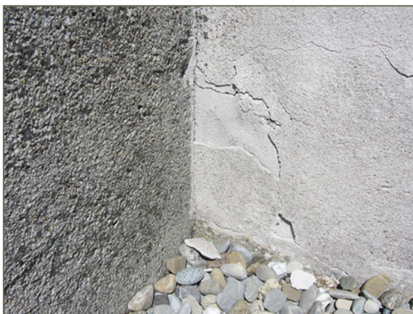
Bild 125: Hohl liegende bzw. zum Teil bereits abgeplatzte Putzschichten im unteren Spritzwasserbereich der Ecke (Westseite)
