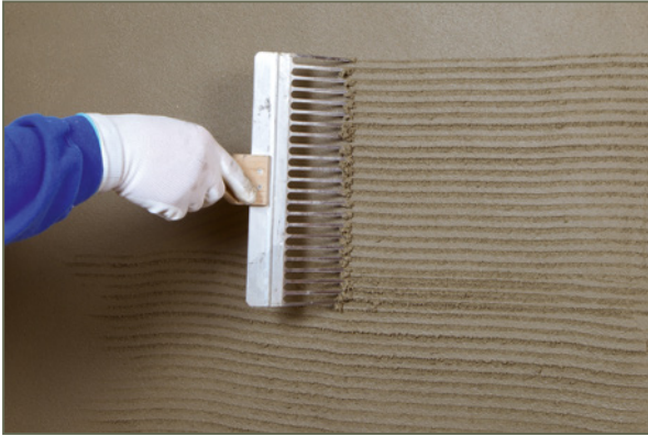
Bild 58: Richtiges Aufrauen des Porengrundputzes mit einem Putzkamm nach dem Ansteifen der Putzschicht
