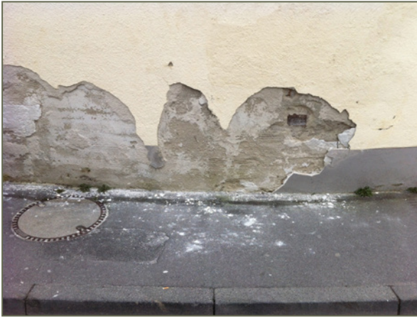
Bild 6: Ein zu dichter Zementputz am Gebäudesockel bewirkt ein Aufsteigen der Feuchte- und Salzfront in höher gelegene Bereiche und Putzschäden.
