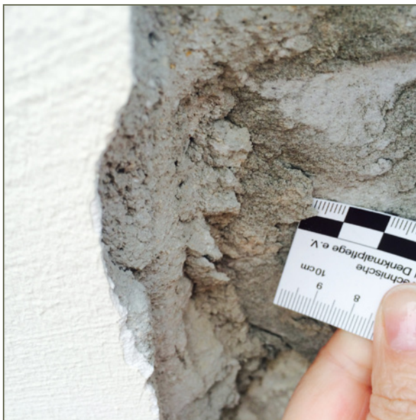
Bild 77: Mangelhafter Verbund des Spritzbewurfs zur Mauerwerksoberfläche
