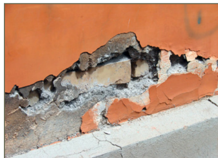
Bild 2: Beginnende Mauerwerkschäden: Die schützende Putzschicht ist nicht mehr vorhanden.
