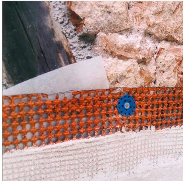
Bild 42: Entkopplung des Putzsystems durch Trennvlies und Putzträger
