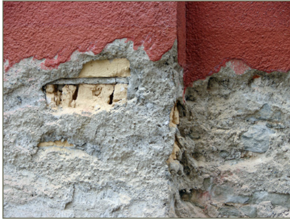
Bild 45: Detail aus Bild 44 mit beschädigten Ziegeln
