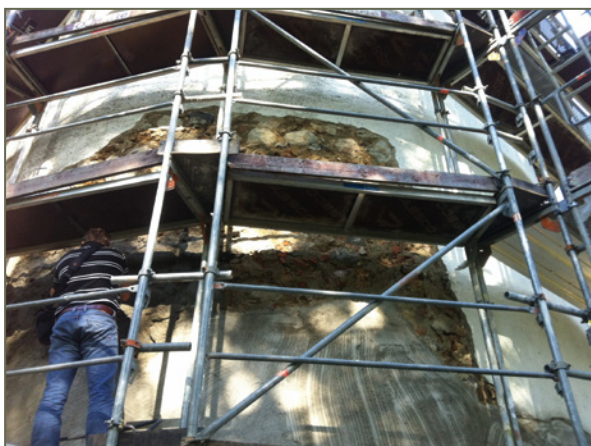
Bild 112: Zustand nach dem Aufrauen der ersten, egalisierenden Lage aus sulfatbeständigem Sanierputz
