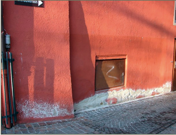
Bild 43: Salzbelasteter Sockelputz
