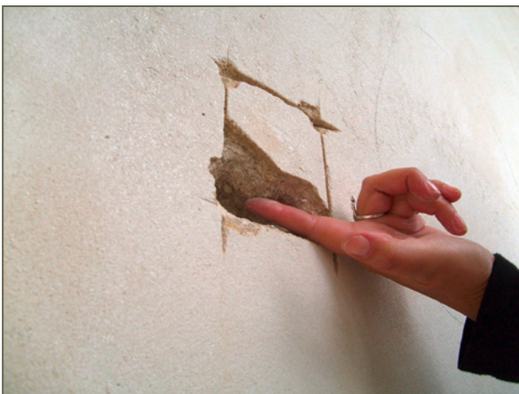
Bild 53: Neuer Kalkputz haftet fest auf dem Original-Unterputz, dennoch finden sich Ablösungen innerhalb des buntkörnigen Barockputzes.
