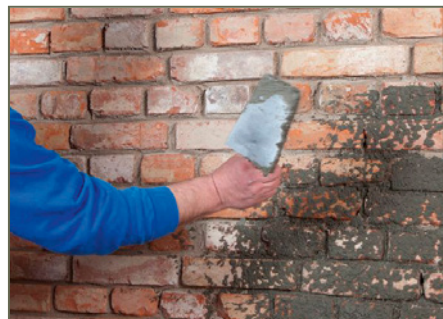
Bild 49: Netzförmiger Spritzbewurf auf Vollziegelmauerwerk.
