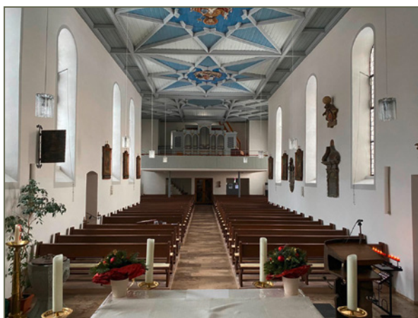
Bild 132: Weiß beschichtete, intakte Sanierputzflächen neben den Bänken
