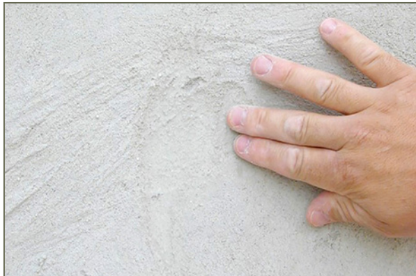
Bild 84: Absanden infolge von Wasserentzug in der Erhärtungsphase.
