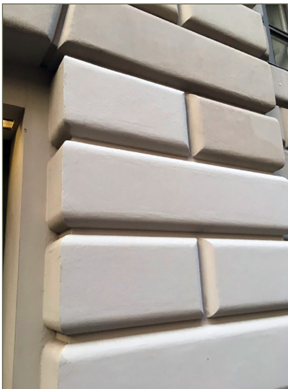
Bild 63: Mit Sanierputzen können auch Putzquaderungen hergestellt werden.
