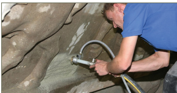
Bild 10: Maschinelles Auftragen des Kompressenputzes
