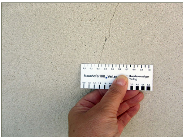
Bild 123: Detail des kirchhofseitig aufgetragenen Sanierputzes mit Einzelriss bis 0,2 mm Breite
