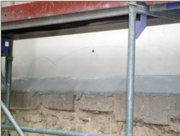
Bild 52: Netzartige Risse mit großen Netzabständen, Rissbreiten bis ca. 0,2 mm und Hohlstellen, die zur Visualisierung mit Bleistift markiert wurden.
