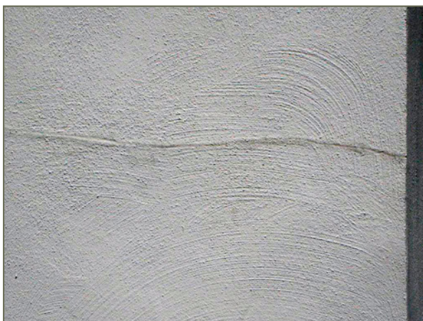
Bild 80: Die unzureichende und ungleichmäßige Rissfüllung verstärkt die optische Wahrnehmung des Risses.
