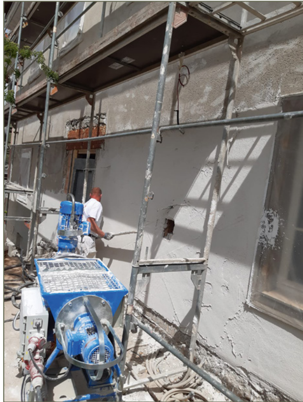
Bild 56: Moderne Mischpumpenmaschine mit unten angebautem Nachmischer
