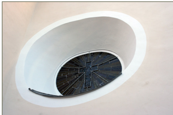
Bild 66: Sanierschlämme an der Laibung eines Kirchenfensters
