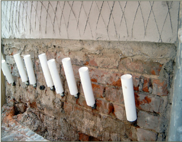
Bild 35: Bohrlochinjektion, druckloses Einbringen der Bohrlochflüssigkeit mithilfe von Vorratsgefäßen
