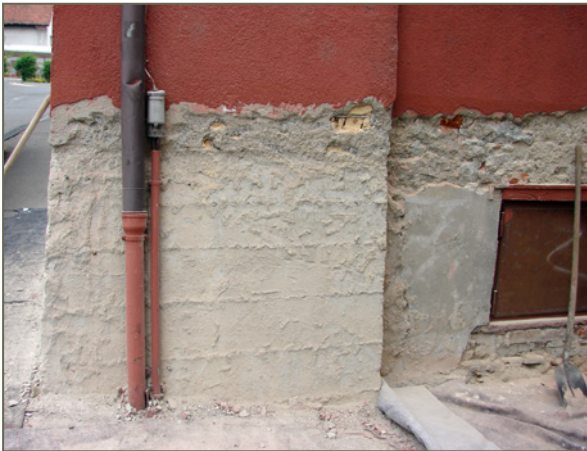
Bild 44: Gemischter Untergrund nach dem Putzabschlagen, z. T. beschädigt
