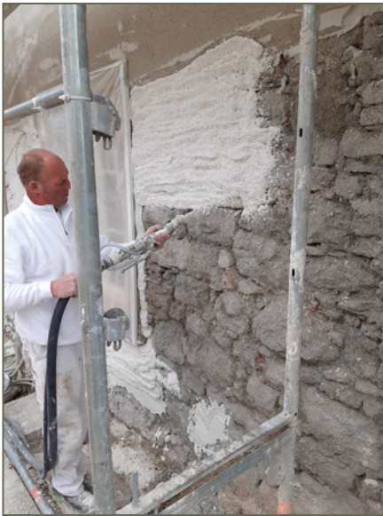
Bild 59: Maschineller Auftrag von Sanierputz
