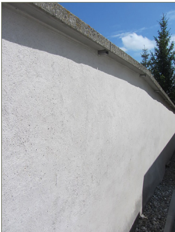
Bild 124: Intakte Sanierputzflächen der Westseite
