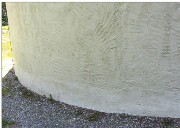
Bild 111: Der untere, mit Sperrputz abgedichtete Bereich ist aufgrund der Materialunterschiede erkennbar (Zustand 2020).
