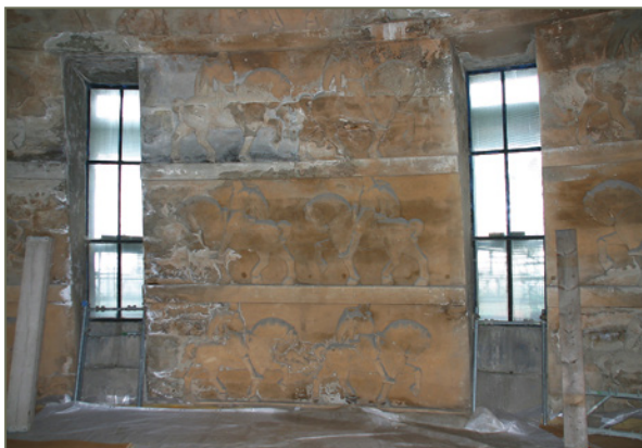
Bild 9: Feuchte- und Salzschäden an den Reiterreliefs im Innenbereich des Völkerschlachtdenkmals
