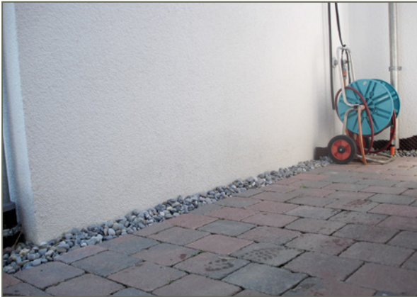
Bild 28: Keine Veränderungen am Sockelputz erkennbar
