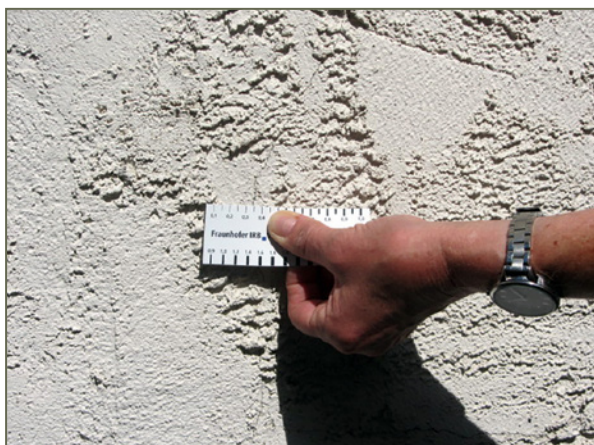
Bild 116: Einzelrisse (hier: ca. 0,35 mm breit) mit trockenen und nicht verschmutzten Rissflanken
