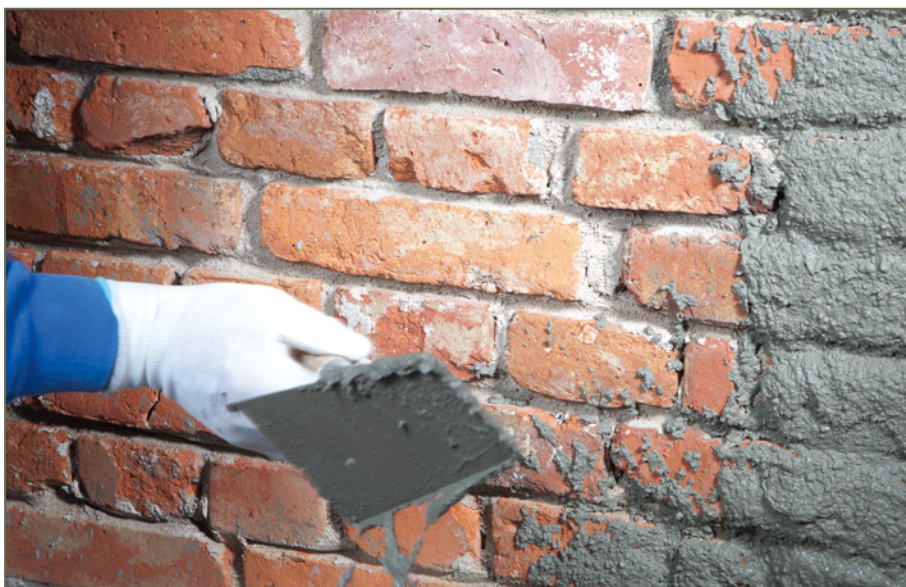
Bild 82: Zu dick aufgetragener, volldeckender Spritzbewurf
