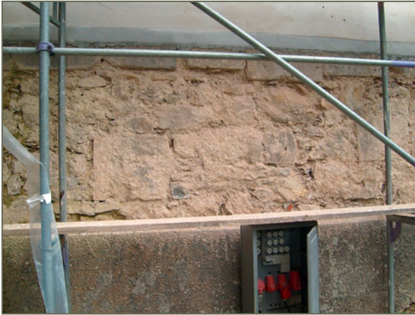
Bild 51: Fassadenabschnitt einer Kirche: Der geschädigte Sockelputz wurde entfernt und der gefestigte barocke Bestandsputz darüber überputzt.
