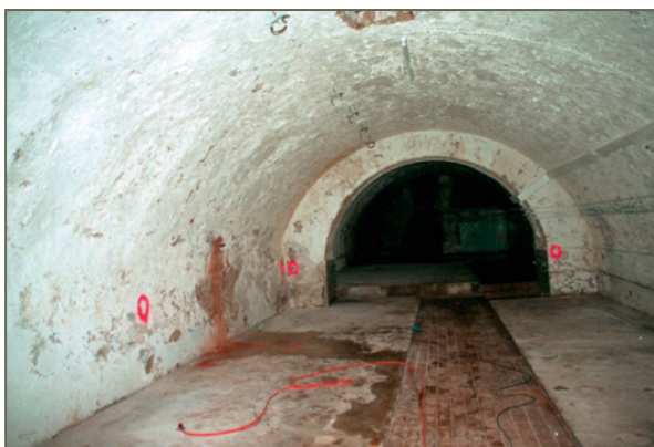
Bild 99: Tonnengewölbe im 2. UG vor der Instandsetzung
