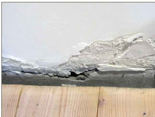
Bild 133: Salzkristallisation und Abplatzungen des weißen Anstrichsystems: Der graue Sperrputz und der hellere Sanierputz darüber sind nicht sauber angearbeitet.
