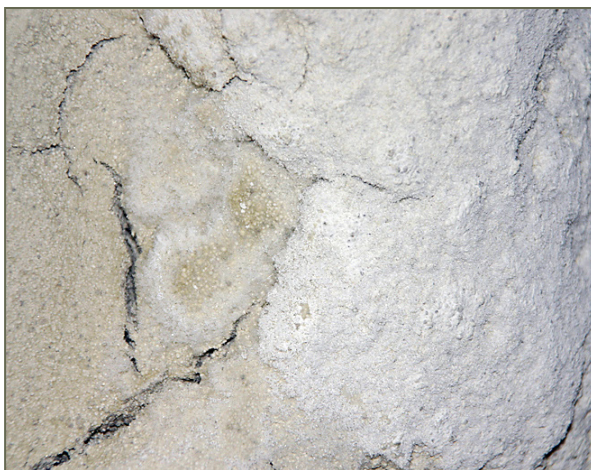
Bild 11: Salzanreicherungen auf dem abgetrockneten Kompressenputz
