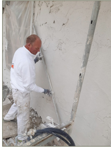
Bild 60: Einebnen des Sanierputzes
