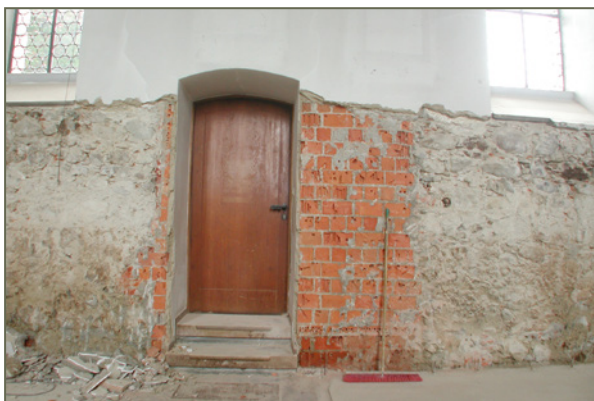
Bild 130: Mauerwerk nach dem Entfernen des Putzes bis zur Unterkante der Fenster
