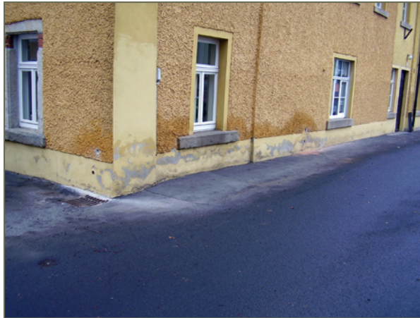
Bild 4: Schäden infolge hygroskopischer Feuchtigkeitsaufnahme von Salzen im Putz und im Mauerwerk
