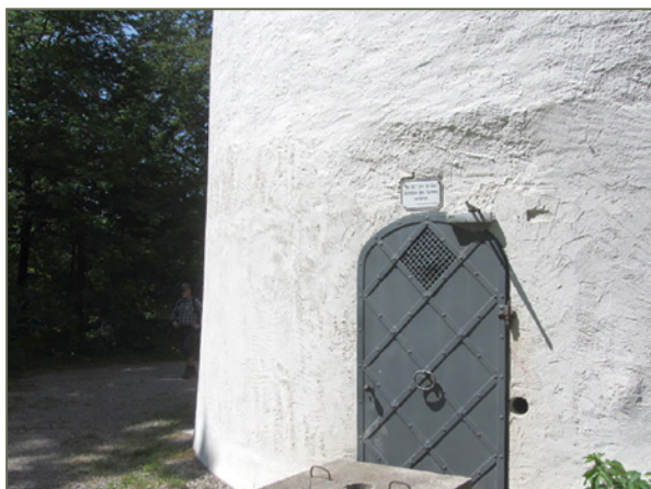
Bild 115: Lebendige Putzoberflächen im unteren Bereich des Turms: Strukturunterschiede zwischen dem Sanierputz und dem Bestandsputz sind erkennbar (vgl. mit den Bereichen aus Bild 110)
