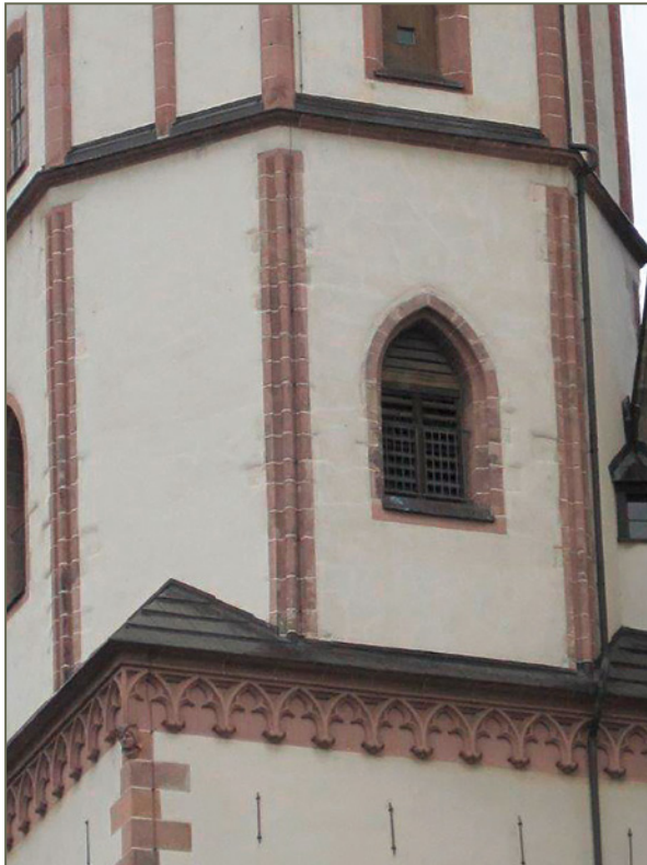
Bild 140: Im Bereich E des Turms ist das ehemalige Rissbild sichtbar (helle Bereiche)
