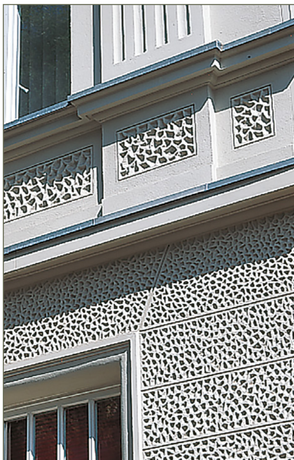
Bild 89: Jugendstiltech- putz als Oberputz auf Sanierputz
