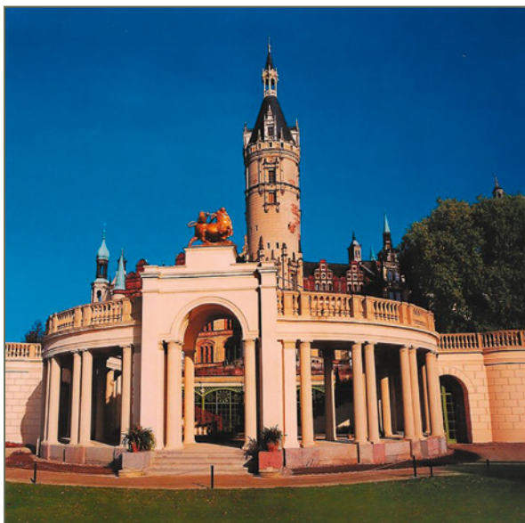
Bild 87: Baudenkmal Schloss Schwerin – für die Diamantbassen, auch im Sockelbereich, wurde ein Sanierputzsystem eingesetzt.
