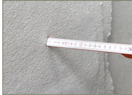
Bild 62: Überprüfung der vorgeschriebenen Mindestputzdicke
