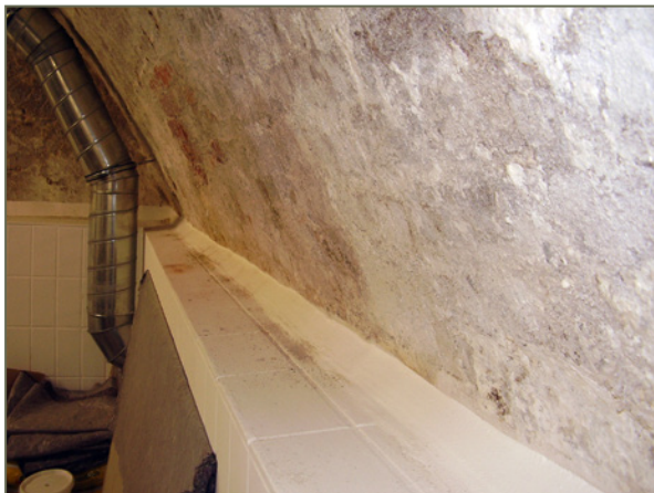
Bild 108: Absanden an der Oberfläche des unveränderten Bestandsmauerwerks nach der Instandsetzungsmaßnahme
