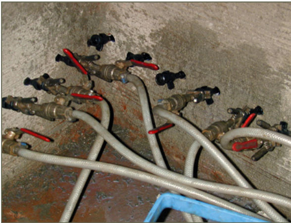
Bild 36: Ansetzen des Injektionsschlauches an die Packer während der Mehrstufeninjektion mit Druckbeaufschlagung
