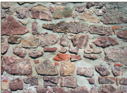
Bild 48: Im Altbaubereich häufig vorhandenes Bruchsteinmauerwerk
