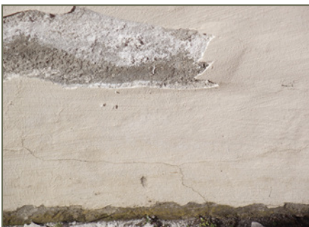
Bild 1: Salzbedingte Risse und Anstrichabplatzungen, beginnende Putzschäden
