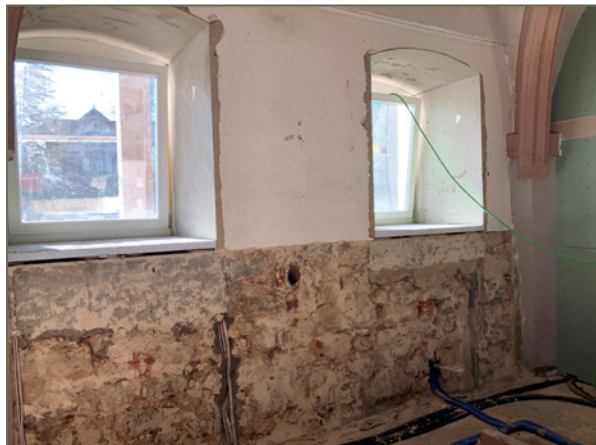
Bild 55: Der Altputz sollte bis zu einer vorab festgelegten horizontalen Linie entfernt werden.
