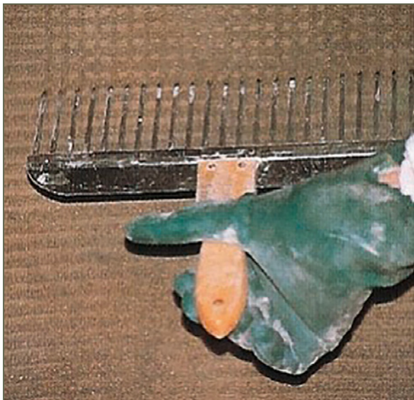
Bild 83: Sorgfältiges Aufrauen des Unterputzes
