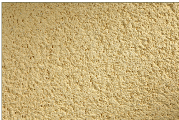
Bild 88: Kratzputz aus Sanierputz
