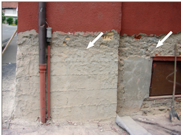
Bild 81: Reste einer früheren Putzinzandsetzung (Pfeile). Vor dem Aufbringen eines Sanierputzsystems muss der Altputz bis über diese Höhe hinaus entfernt werden.
