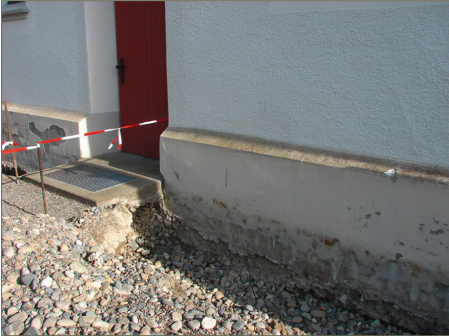
Bild 69: Flecken und Abplatzungen an einem Sanierputz ohne Abdichtung im Übergang vom erdberührten zum spritzwasserbelasteten Bereich.
