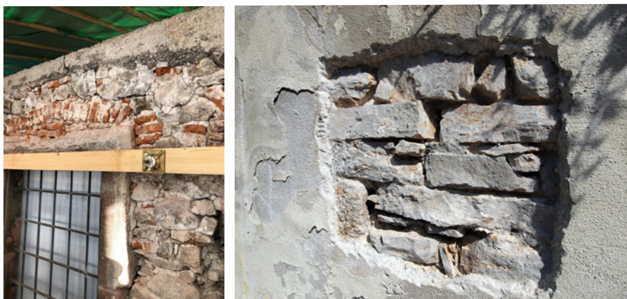
Bild 41: Konstruktionsbedingte Risse, für deren Beurteilung der Tragwerksplaner hinzugezogen werden sollte
