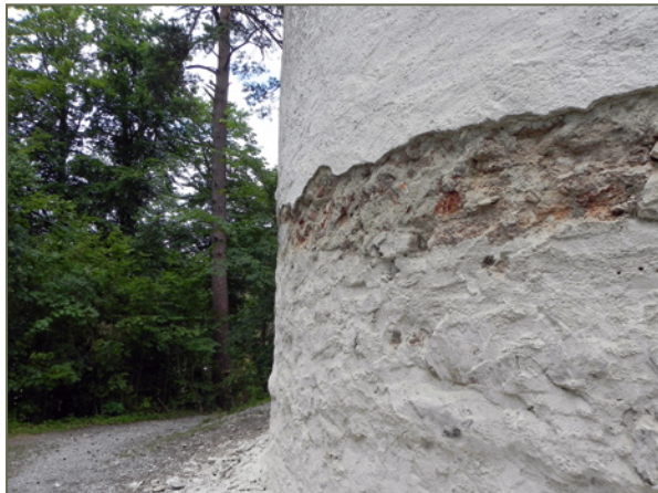
Bild 110: Mauerwerk nach dem Abschlagen des Putzes in den geschädigten unteren Bereichen
