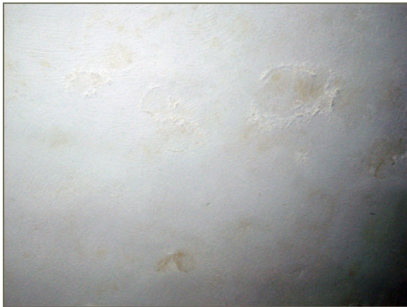
Bild 107: Vereinzelte Flecken im Sanierputz, zum Teil mit Durchsalzungen auf nicht abgedichtetem Untergrund
