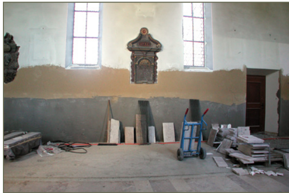
Bild 131: Sanierputz (grau), darüber die »Alarmzone« aus Kalkputz (ocker) bis zur Unterkante der Fenster und darüber verbleibender Bestandsputz (weiß beschichtet)
