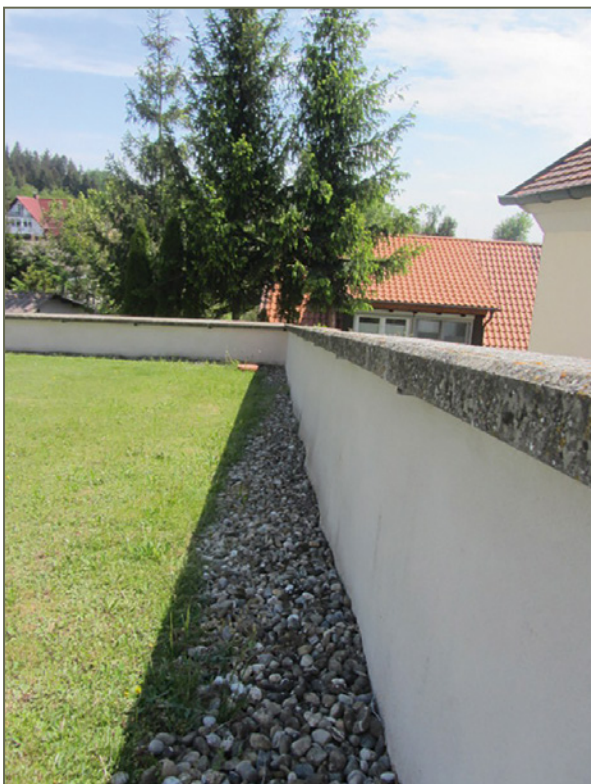
Bild 122: Sanierputzoberflächen entlang der nachträglich abgedichteten Kirchhofmauer (vormals Bereich mit Gräbern)
