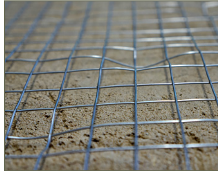
Bild 47: Putzträger aus Edelstahlgewebe, befestigt mit Abstandhalter
