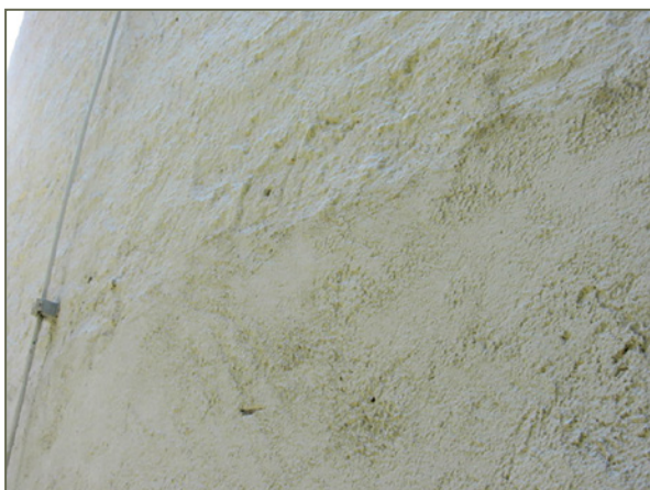
Bild 113: Oberfläche nach dem Anarbeiten des Sanierputzes (rechtes unteres Bilddrittel) an den Bestandsputz
