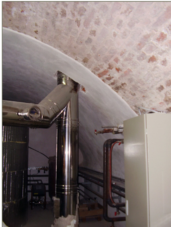
Bild 102: Gewölbekeller mit Haustechnik nach der Sanierung: Neben den weißen Sanierputzflächen blieben Gewölbeflächen steinsichtig.
