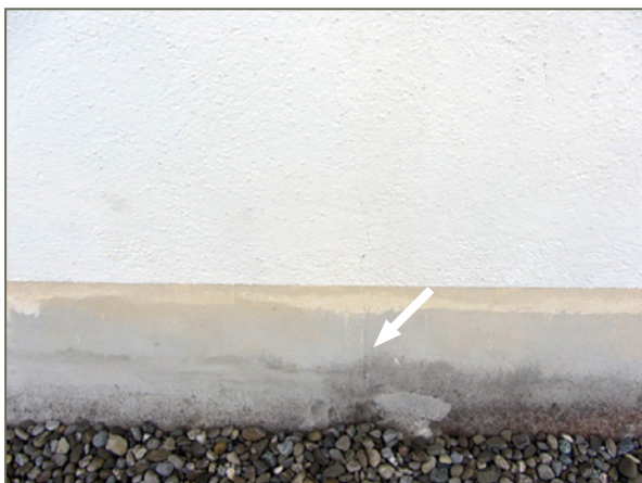
Bild 134: Sperrputz im Spritzwasserbereich außen mit Einzelrissen (Pfeil)
