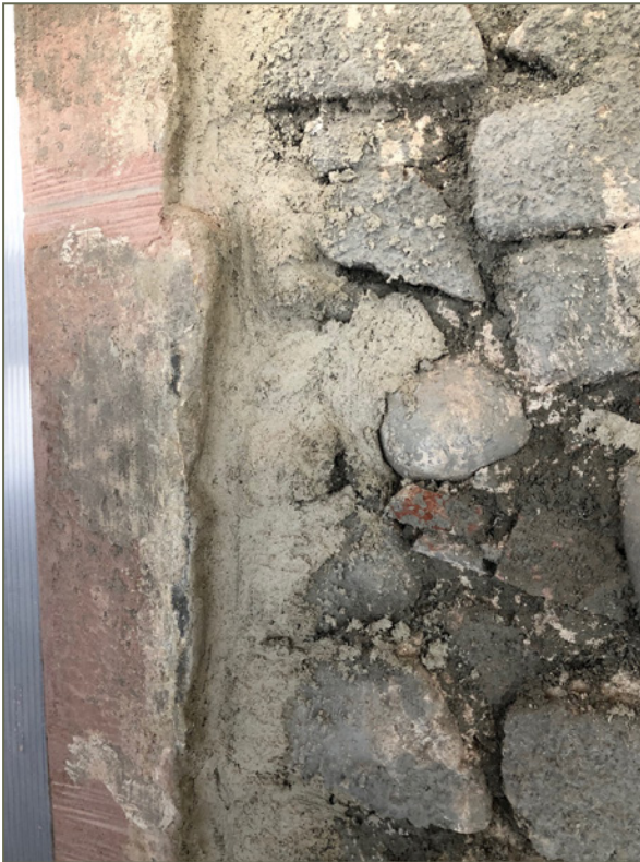
Bild 65: Nach dem Abspitzen eines Teils der Mauerwerksoberfläche, für eine gleichmäßige und ausreichende Dicke des Putzsystems und dem »Auswerfen« des Anschlussbereichs zur Sandsteineinfassung mit einem Grundputz
