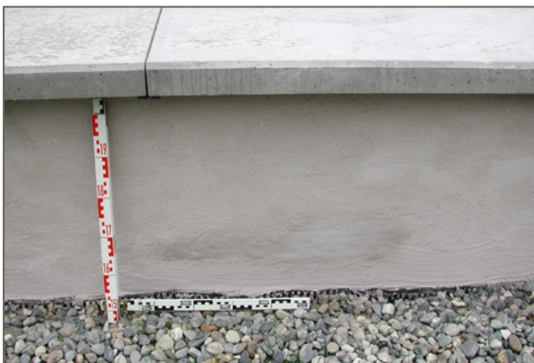
Bild 121: Strukturierte Sanierputzoberfläche und Betonabdeckungen mit u-förmigen Blechrinnen unter den offenen Fugen
