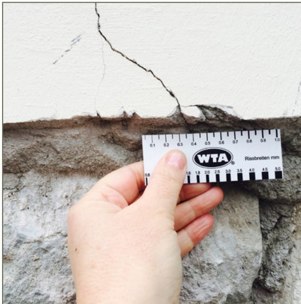
Bild 76: Risse in einem Sanierputzsystem auf Bruchsteinmauerwerk als Folge eines hohl liegenden Spritzbewurfs
