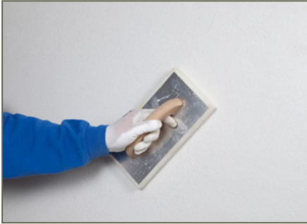
Bild 61: Filzen nach dem Einebnen des Sanierputzes
