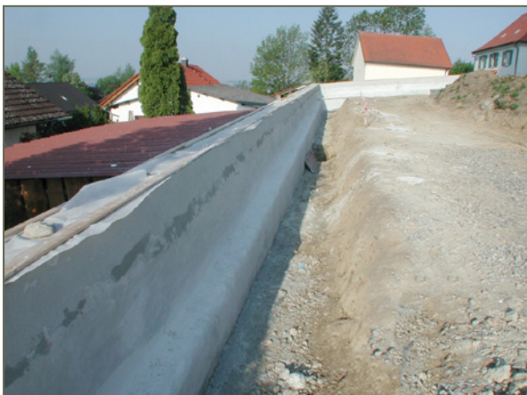
Bild 120: Zustand nach dem Aufbringen der ersten Sanierputzlage
