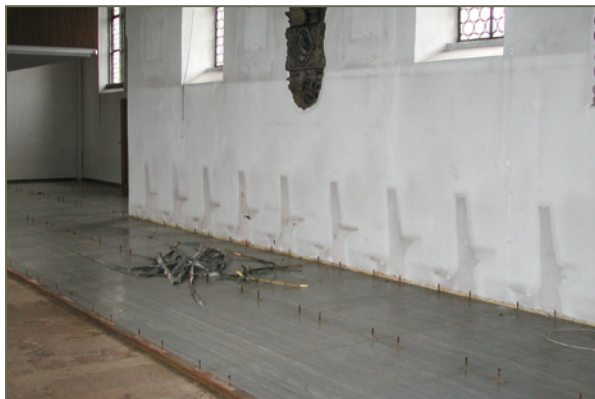
Bild 128: Früherer Innenputz an der Nordseite des Schiffs nach dem Entfernen der Bänke
