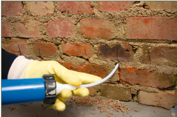
Bild 38: Hohlraumfreie Verfüllung aus der Tiefe bis an die Oberfläche
