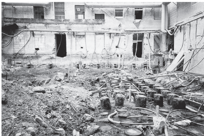
Abb. 3: Gründungssanierung, Freilegung der alten Kiefernpfähle
