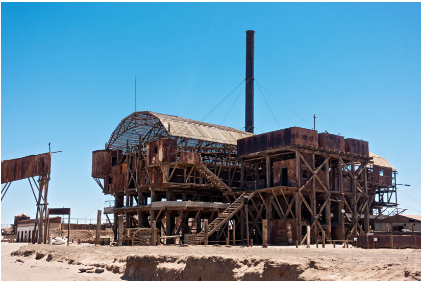
Abbildung 12: Verarbeitungsanlage der Oficina Santa Laura
