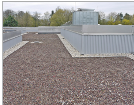
Abb. 755 (re) und 756: Frisch aufgebrachte Substratschicht über Dränmatte
