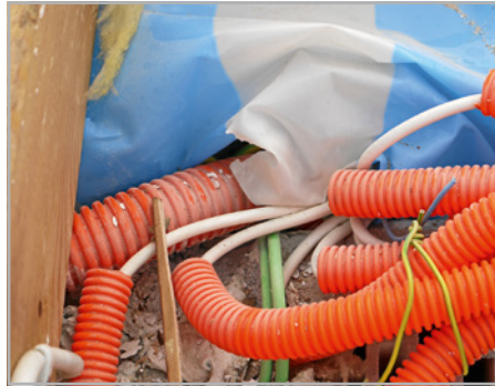
Abb. 220 bis 222: Kabeldurchgänge können nicht abgedichtet werden.
