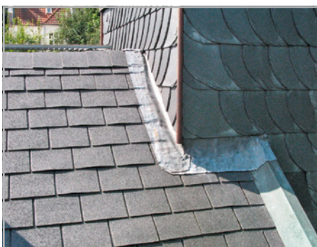
Abb. 114 und 115: Aufliegender Anschluss an Bitumenschindeln wird kapillar unterlaufen.
