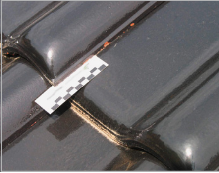
Abb. 379 und 380: Kanten- absplitterungen sind nicht immer ein Mangel
