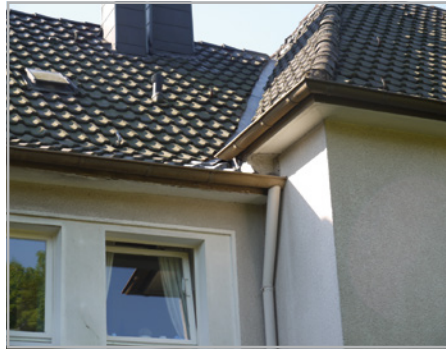
Abb. 35: Stark verschnittene Dachformen erfordern höherwertige Schutzmaßnahmen für Dachdeckung und Unterdach.
