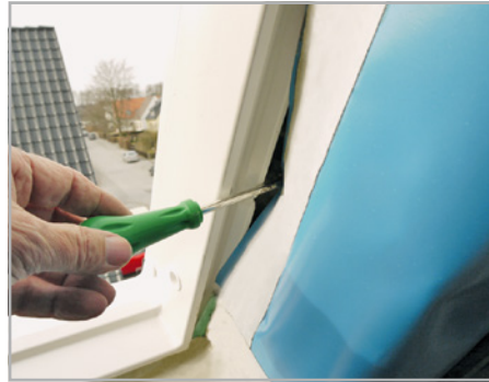
Abb. 201: Kleband- ablösung aus Schrumpf des Klebandrückens
