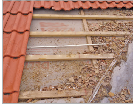
Abb. 140 und 141: Unterlegte Kehlen erfordern erhöhte Maßnahmen gegen eintreibende Niederschläge, Schmutz und gegen Schwallwasser aus den Dachflächen.
