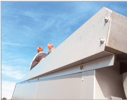
Abb. 266: (re) Luftdichtigkeit an der Traufe ist nicht herstellbar.
