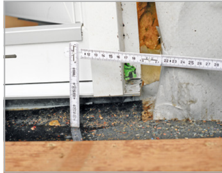
Abb. 330 und 331: Türschwelle mit Wasserabweisprofil, aber nur 4 cm Anschluss-höhe zur Abdichtung, seitlicher Blendrahmen-anschluss ist nicht herstellbar.
