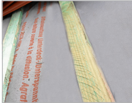
Abb. 62: Der Wassersack an der Traufe kann zu Wasserschäden führen.
