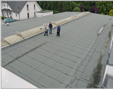
Abb. 405 und 406: Stauchung in einer einlagigen mechanisch verankerten Abdichtung aus Bitumenschweißbahnen. Bei kalter Witterung wurden die steifen Bahnen verlegt und haben sich nach Erwärmen gelängt.
