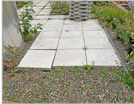
Abb. 762: Gehbeläge müssen konstruktiv entwässert werden, wenn sie nicht verwildern sollen.
