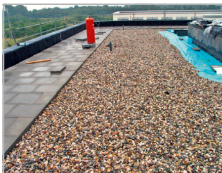
Abb. 690 und 691: Deckschicht und Windsog-sicherung aus Grobkies 16/32 und Betonplatten-randsicherung
