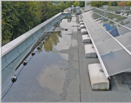
Abb. 562 bis 564: Vor Attika-abläufen bleibt (fast) immer großflächig Wasser stehen:
