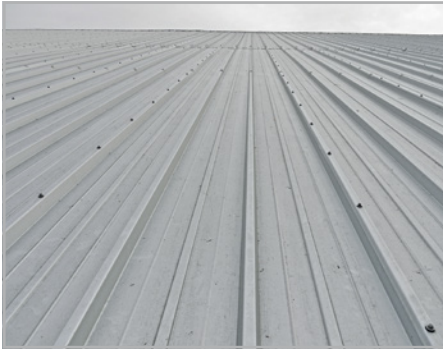
Abb. 30 und 31: Direktverschraubungen auf Blechprofilen können sich lockern und undicht werden.
