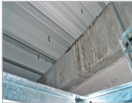
Abb. 586: (re) Tauwasserläufer am Ringanker des Leichtdaches
