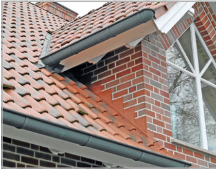
Abb. 130 und 131: Fachgerechter und optisch ansprechender Anschluss mit Fugenschnittstücken und Beispielskizze aus der Fachregel
