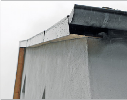
Abb. 89 und 90: Blechabdeckung ohne Unterkonstruktion und mit zu geringer Seitenüberdeckung: Der nächste ganze Dachziegel ist mindestens 10 cm weit zu überdecken.
