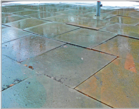
Abb. 353 bis 356: Stelzlagerbeläge auf Bitumenabdichtungen sind nicht stand- und lagesicher.
