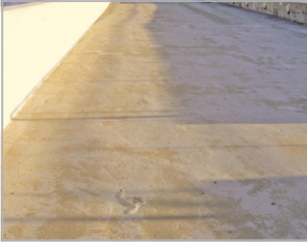
Abb. 522 und 523: blasige Beschichtung aus Flüssigkunststoff auf feuchtem Untergrund
