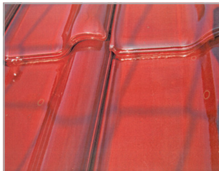
Abb. 365: Tatsächliche Farbabweichung der Giebelziegel
