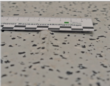
Abb. 527: (re) Schwindbrüche wegen fehlerhafter Mischung der Ausgangskomponenten
