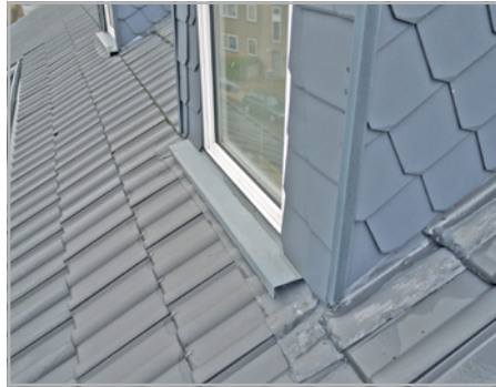
Abb. 295: Direkte Undichtigkeit an der Rollladenführung
