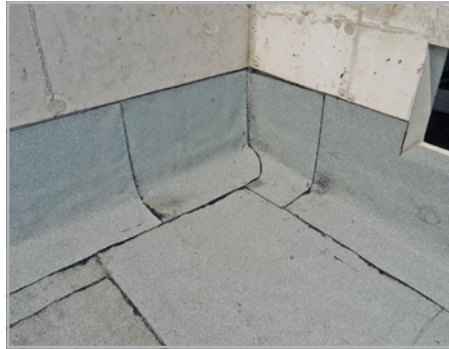
Abb. 683 bis 687: Bituminöse Verbundabdichtung, in Dämmelement eingesenkter Dachablauf, und fertiggestellte Abdichtung
