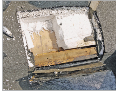
Abb. 595 bis 597: Holzdach mit Dachüberstand und durchlaufender Schalung: Die aufliegende Sperrfolie ist nicht an die Außenwand angeschlossen, und das System daher über Brettschalung und Brettfolgen luftoffen.
