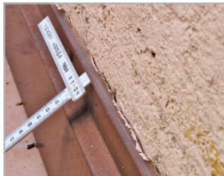
Abb. 137 und 138: Fugenversiegelungen lösen sich ab, wenn der Fugenraum zu klein und nicht hinterstopft ist, die Anschlussfläche nicht glatt und fest ist und die Fuge nicht vorbereitet (geprimert) wurde.
