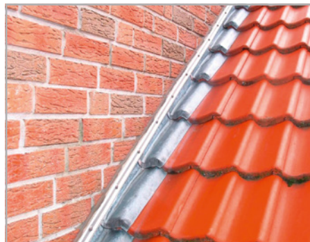
Abb. 139: (re) Anschlussdichtungen gegen Sichtmauerwerk sind höchst unsicher und sollten nicht ausgeführt werden.
