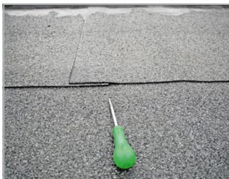
Abb. 408 bis 415: Mehrlagige Abdichtungen, die nicht vollflächig (= homogen) verschweißt sind, sind meist nicht wasserdicht.
