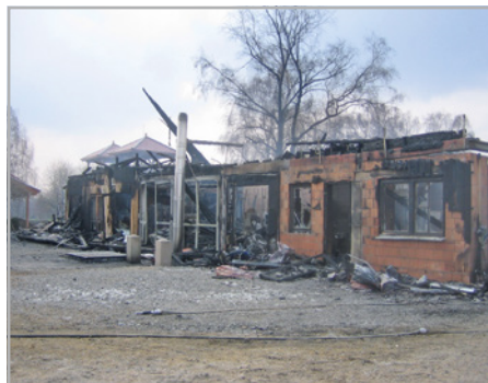
Abb. 807: (re) Brandschaden durch Solaranlage (Quelle: Jochen Zimmermann, Mannheimer Versicherung)
