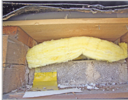
Abb. 629 bis 632: Vorsicht bei Dachsanierung mit eingeschlaufte Sperrfolie: Luftleckagen an Außenwänden und überstehenden Deckenbalken lassen sich nicht vermeiden.
