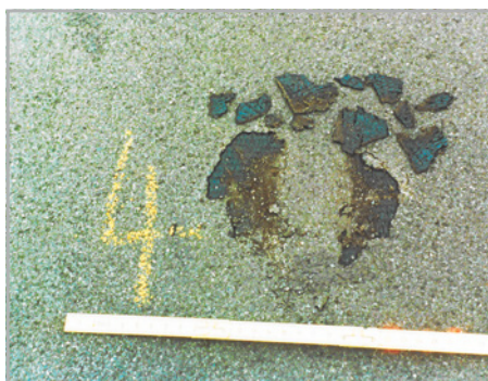
Abb. 420: (re) Großflächig stehendes Wasser und Schmutzsammmlung schädigen jede Dachabdichtung.
