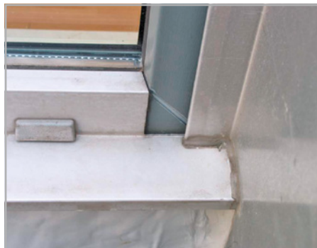
Abb. 326: Wasser, das in den Blendrahmenfalz dringt, gelangt auch durch Bohrlöcher der Blendrahmenbefestigung nach innen.
