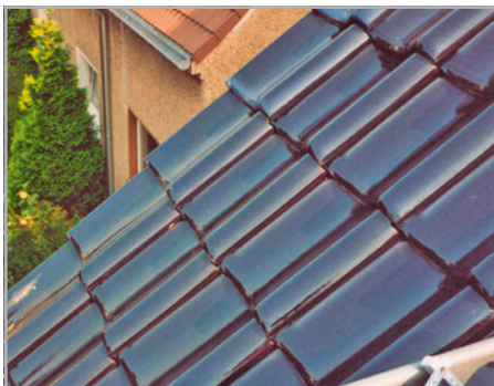
Abb. 367 und 368: Scheinbare Farbabweichung der Giebelziegel aus Lichtreflexion
