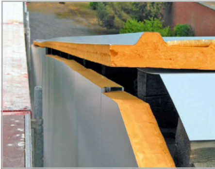
Abb. 263 bis 265: Bauwirklichkeit an der Giebelkante: Luftdichte Anschlüsse sind auch bei passgenauen Anschnitten nicht herstellbar. Die Randblende deckt den Anschlussmangel schamhaft ab.
