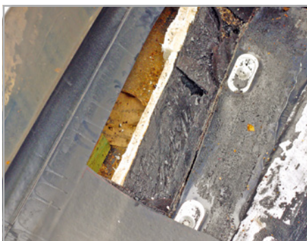
Abb. 461 und 462: Die Telleranker durch Dämmschicht in Trapezblech verankert sind auf Biegung beansprucht und seitlich verzogen.
