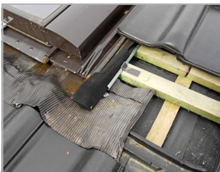
Abb. 149 bis 153: Handelsübliche Eindeckrahmen haben von der Fachregel abweichende verminderte Sicherheit im Seitenanschluss, insbesondere bei flacher Dachneigung, Verschmutzung durch Laub und Moos und am Dachknick.
