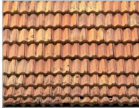
Abb. 10: Dachdeckung aus glasierten Falzpfannen
