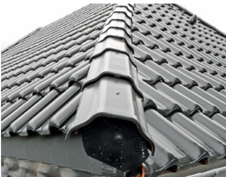
Abb. 100: Mehrfachfehler: schief liegender Grat, Verdrehung über Dachknick, ungleiche Traufhöhen
