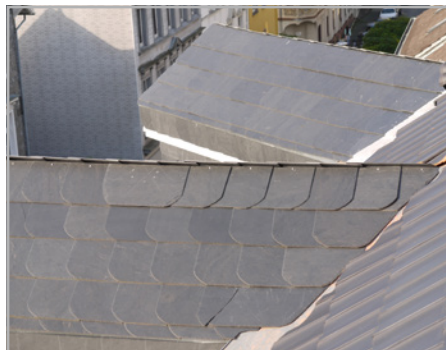
Abb. 104: Die Latteneinteilung am First muss sich auf den lotrechten Scheitel beziehen, nicht auf die Oberkante der Konterlatte. Bei unterschiedlichen Dachneigungen muss die Steilseite höher hinaufgedeckt werden, um einen geraden Dachfirst zu ermöglichen
