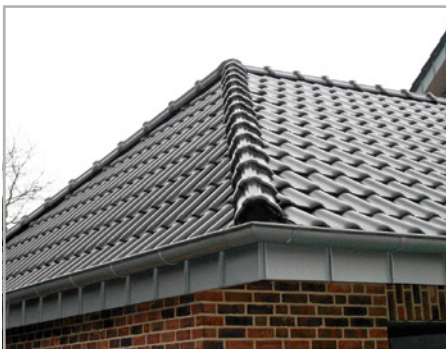
Abb. 95: Schief sitzender Grat wegen fehlerhafter Lage der Gratlatte
