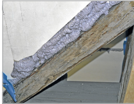
Abb. 240 bis 242: Luftdichtigkeit ist mit Dachdämmelementen allein nicht herstellbar; das betrifft sowohl die Plattenfugen wie auch alle An- und Abschlüsse
