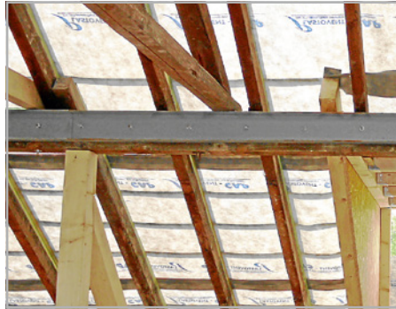
Abb. 160: Sparren- auffütterungen mit Dachlatten sind falsch und nicht zulässig.
