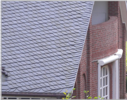
Abb. 86: Eingebundene Orte in der Altdeutschen Schieferdeckung (Quelle: Rathschek)
