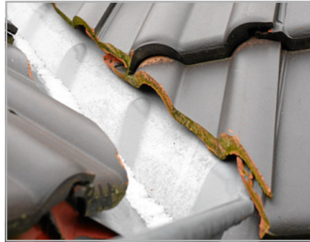
Abb. 389: leicht welliger First; Fluchtabweichungen, die man nicht sieht, sind kein Mangel.
