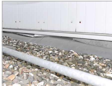
Abb. 503 (re) bis 505: Anschlusspressleisten sind meist ungeeignete Mittel zum Regenschutz; technisch richtig das das Hinterschneiden (Hinterfahren) der Fassadenbauteile.
