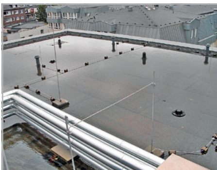
Abb. 558 und 559: Druckentwässerungen benötigen stehendes Wasser, um voll wirksam zu werden.
