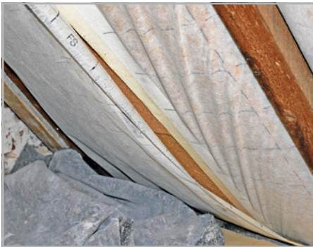
Abb. 199: Klebebandablösung aus Eigenlast
