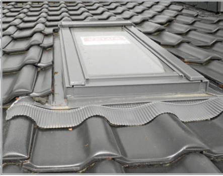
Abb. 391: Unterdeckte Anschlüsse, wie hier am Eindeck- rahmen, bewirken Schrägliegen der andeckenden Dachziegel.
