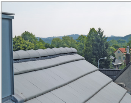
Abb. 78: Dachüberstand aus Dachlatten hängt nach außen
