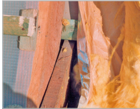
Abb. 224 bis 227: Bei der vermeintlich unkomplizierten Gefachdämmung treten Probleme an Trägern und Trennwänden, Kehlbalkendecken und an sichtbaren Sparren, Pfetten und Deckenbalken auf.
