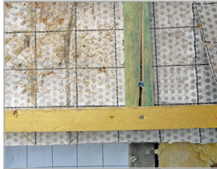
Abb. 246 bis 248: Die Verankerung der Aufdachdämmung muss konstruktiv geplant und vorbereitet werden, um Mängel wie die gezeigten zu vermeiden.
