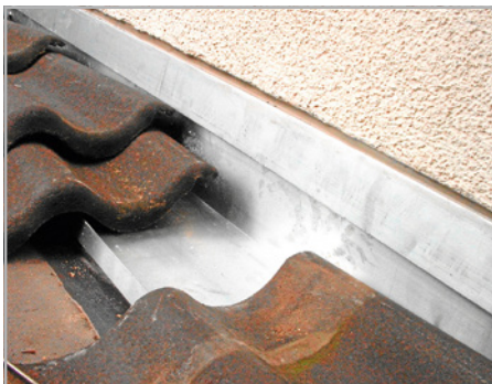
Abb. 116: Unterliegender Blechanschluss mit Rinne (Quelle: ZVD)
