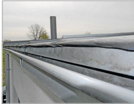
Abb. 70 bis 74: Traufeinfalzung am Zinkscharen- dach zu eng, daher dringt Kapillarwasser unter die Blech- schare
