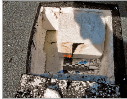
Abb. 713 und 714: Dachfuge aus Seitenverschiebung im Dach wegen plastischer – verschieblicher – Kaltklebung.
