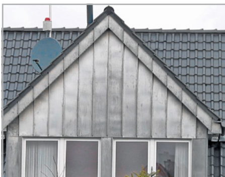
Abb. 283: Eingefalzte Zinkbekleidung im Zustand der (fleckigen) Patinabildung
