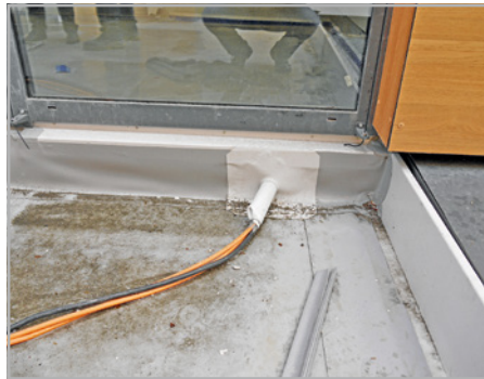
Abb. 769 und 770: Ungeeignete Kabeldurchgänge in der Abdichtung
