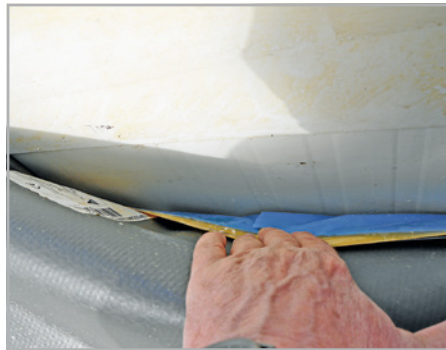
Abb. 579 bis 582: Mit Klebebändern und Klebekitten lassen sich luftdichte Anschlüsse nicht dauerhaft herstellen.
