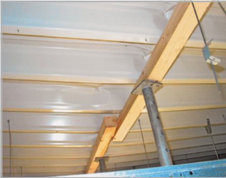
Abb. 748 bis 750: Bauschaden an einem Einkaufsmarkt: Zugewachsene Abläufe haben zu Wasseranstand und zum Einbruch der Trapezprofildecke geführt.
