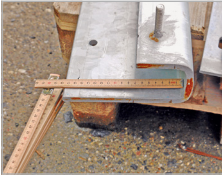
Abb. 438 und 439: Ansicht und Einbau der Fest-/Losflansch- Dehnfuge
