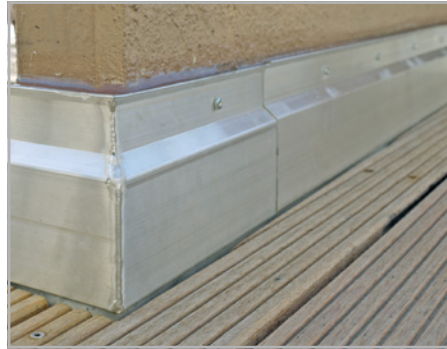
Abb. 320: Vorschlag für einen wasserab- weisenden So- ckelanschluss (hier ohne Trittschutz)
