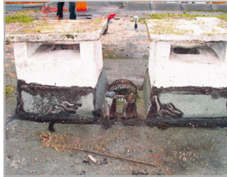
Abb. 442: Dachablauf mit Pressdichtung, hier für Druck- entwässerung
