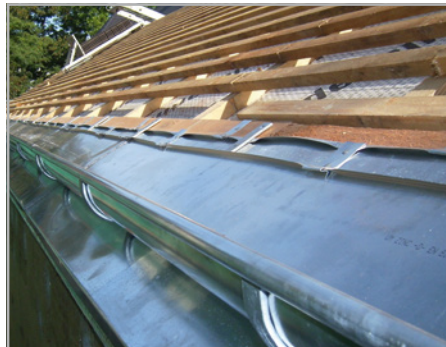
Abb. 75: (re) Aufliegerinne, mit Haften verschieb- lich montiert, Unterdeckung ist auf das Unter- blech geführt
