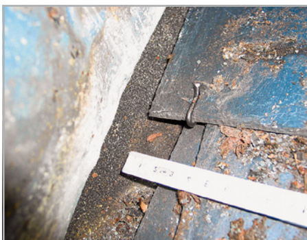
Abb. 112 und 113: Aufliegender Bleianschluss im Schieferdach wird kapillar unterlaufen, Wasser tropft an nicht abgerundeten Kanten nach innen ab.
