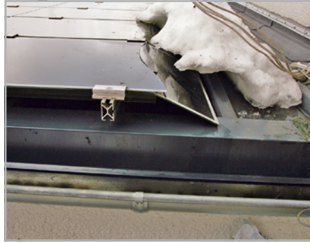
Abb. 808 bis 810: Schäden durch Schneelasten: Dacheinbruch, Bruch der PV-Kollektoren, Bruch eines Dachsteins unter einem Systemhalter (Quelle: Jochen Zimmermann, Mannheimer Versicherung)
