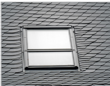
Abb. 147 und 148: Kapitalfehler im Schieferdach: Fensteranschluss mit unterlegtem Eindeckrahmen und Dachundichtigkeit wegen ungenügender Seitenunterdeckung.
