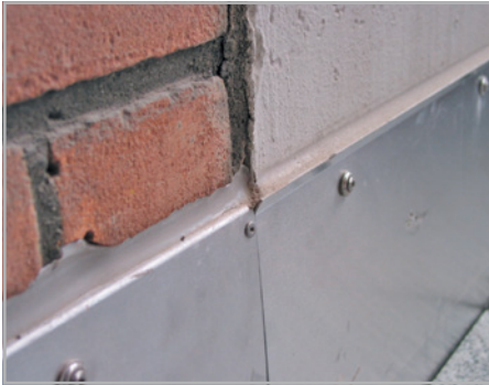
Abb. 322 und 323: Vorsicht bei selbst angefertigten Trittschutzblechen: Scharfe Blechkanten führen zu Verletzungen.
