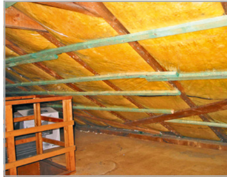
Abb. 234 und 235: Indachdämmungen dürfen nicht frei durchhängen und benötigen Deckenbekleidung als Auflager oder mindestens Stützlattungen.
