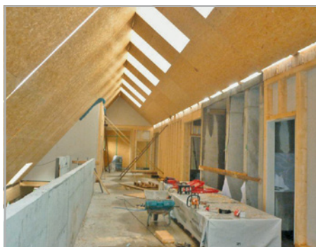
Abb. 569 bis 571: Fehlkonstruktion einer Kindertagesstätte: Flachdach aus genuteten Holzbohlen mit aufliegender Dampf- und Luftsperr, Dampf-/Luftstrom dringt durch die Deckenfugen in den Steildachraum und läuft als Tauwasser zurück.
