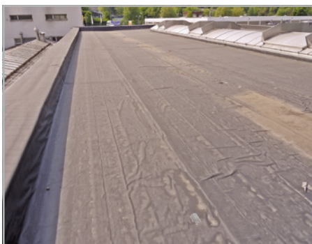
Abb. 458 bis 460: Kautschukdachbahn mit plastischer Selbstklebeschicht und verklebten Nähten: Dehn- und Schrumpfspannung führen zum Aufscheren der Klebnähte.
