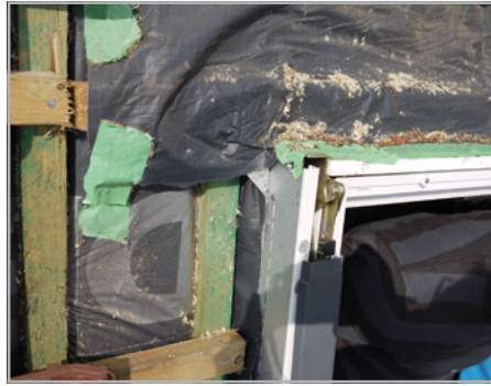
Abb. 154 bis 156: Anschlüsse des Unterdaches bedürfen besonderer Wasserabweiser über dem Fensterkasten. Fehlen die Wasserabweiser oder sind sie durch Überlappungen oder Klebänder ersetzt, können Undichtigkeiten auftreten.
