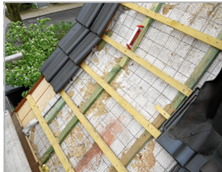
Abb. 245 : (re) Aufdachdämmungen ohne zusätzliche Unterdeckung erfüllen an Taufen und Dachrändern nicht die Forderungen des Wasser-schutzes und der Wasserableitung.
