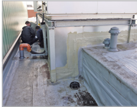
Abb. 767: Aufgelagerte Konstruktionen belasten (und schädigen) nicht nur die Abdichtung, sie machen auch jegliche Kontrolle, Reinigung und Ausbesserung unmöglich.
