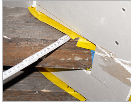
Abb. 269 bis 271: Luftdichte Anschlüsse an Bauholz sind nicht möglich.
