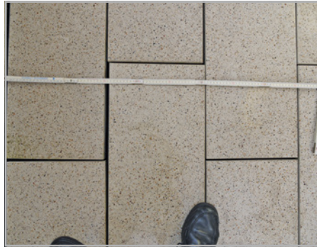
Abb. 357 bis 359: Plattenbeläge müssen immer gegen seitliches Verschieben gesichert (abgestützt) sein. Hier Seitenverschiebung der nur lose verlegten Platten.
