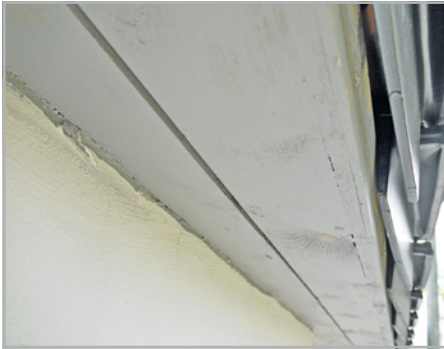
Abb. 80 und 81: Untersicht- bekleidung mit Systemfehlern: Bretter sind nicht genutet, Stirn- brett hat keine Abtropfkante, Pilzbesatz wegen ungenügender und nicht fungizider Holzschutz- behandlung
