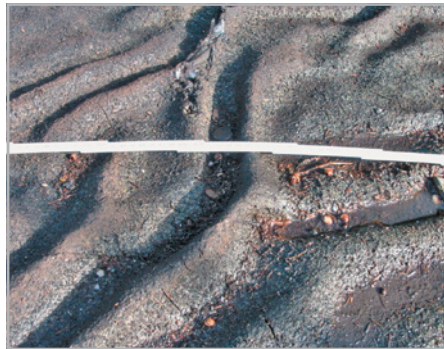
Abb. 727 und 728: Quellen und Schwinden bei Kunststoff- und Bitumenabdich- tungen
