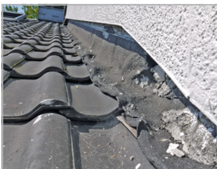
Abb. 110: Zustand eines Klebebandanschlusses nach längerer Liegezeit.
