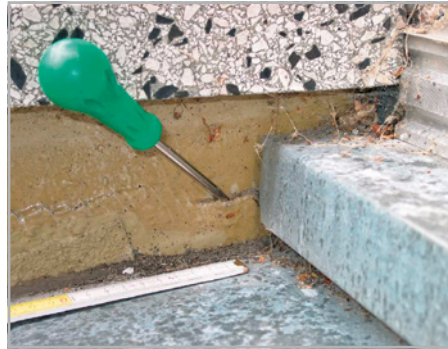
Abb. 537: Fachgemäßer Anschluss mit Anschlussbahn (Quelle: Triflex)
