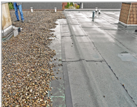
Abb. 480 und 481: Glasbruch an einer Kunststoffdachbahn; Auslöser war der Bitumenklebeanschluss vom Nachbardach.
