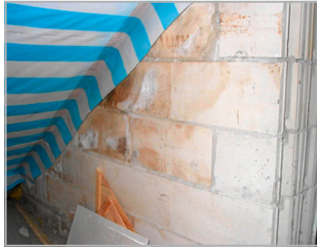
Abb. 128 und 129: Anschlüsse gegen Sichtmauerwerk ohne waagerechte Wandsperre sind meist undicht.
