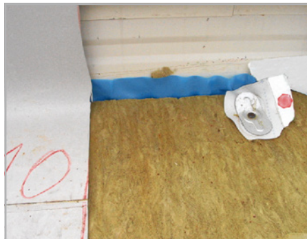
Abb. 590: (re) Luftdichter Anschluss am Dachrand nicht hergestellt.
