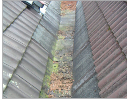
Abb. 57: Die aus optischen Gründen beliebte innenliegende Rinne ist latent rückstaugefährdet.
