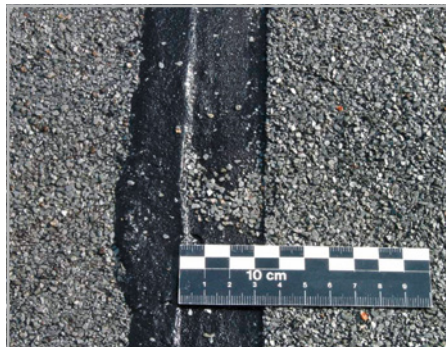
Abb. 425 und 426: Polymerbitumenschweißbahnen mit dehnfähiger (PV-)Trägereinlage und Bahnschrumpfung nach Verlegung.
