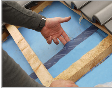
Abb. 49 bis 52: Verklebte Naht- überlappungen gegen den Wasserlauf sind nicht haltbar.
