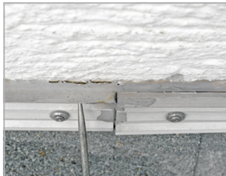
Abb. 650: (re) Kittfugendichtungen sind immer ein Risiko, insbesondere auf mehligem oder rissigem Untergrund.
