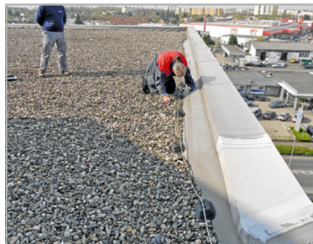
Abb. 492 und 493: Fehlt die Randfixierung in der Ebene der Dachbahn, sind Abspannung, Zugfalten und Schäden unvermeidlich.
