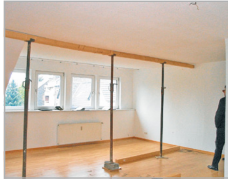
Abb. 164 und 165: An diesem Kehlbalkendach hatte ein Dachdecker die Sparren für den Einbau der Dachgaube ausgetrennt. Vor dem Einsturz bewahrten das Dach nur zwei Trennwände und eine Notabstützung.
