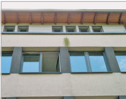
Abb. 541 und 542: Anschlüsse aus Flüssigkunststoff über Metallprofilstoß können nicht wasserdicht sein.
