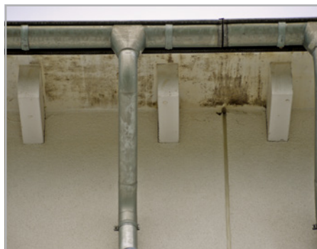
Abb. 402: Beplankung des Dachüberstandes aus Holzwerkstoff- platten: Typische Schimmel- und Algenverfärbung aus Tauwasser durch Auskühlung, poriger Werkstoff- platte und ungeeignetem Anstrich.
