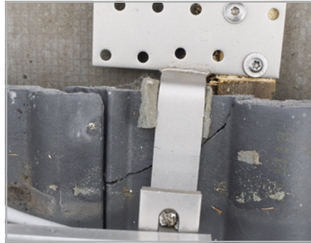
Abb. 774: Die Verankerung der Tragkonstruktion am Dachsparren darf nicht wie hier gezeigt ausgeführt werden.
