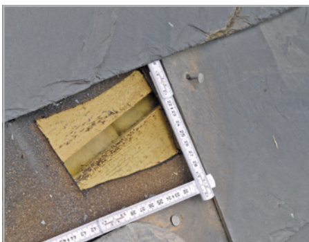
Abb. 189: (re) Holzschalungen müssen trocken eingebaut und trocken gehalten werden. Andauernde Tauwasserfeuchte, wie hier im nicht belüfteten Dach, führen zur Verrottung der Dachschalung aus Holz und Holzwerkstoff
