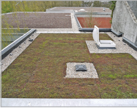
Abb. 758 und 759: Wuchsfortschritte und fachgerechte Randeinfassungen und Sickerfilter
