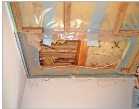
Abb. 620 (re) bis 622: Massive Holzzerstörung an einem nicht belüfteten Flachdach
