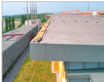
Abb. 514: (ii) Randblenden müssen auf Randbohle verschraubt werden; Befestigung auf Schalung – wie hier – ist nicht ausreichend windsogsicher. (Quelle: Christian Müller)
