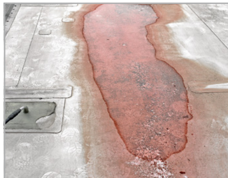
Abb. 476: Kerbschaden aus Aktivkohle-Effekt wegen Schmutz- auflage
