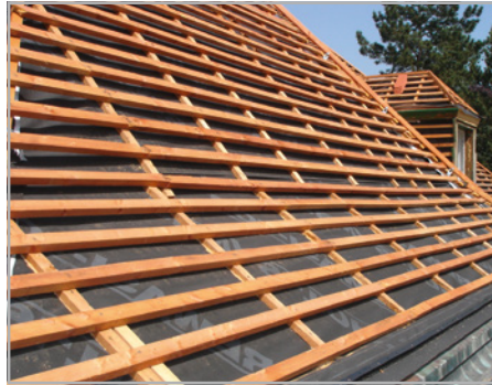
Abb. 43: Prinzip des regenableitenden Unterdaches auf Schalung (Quelle: ZVD)
