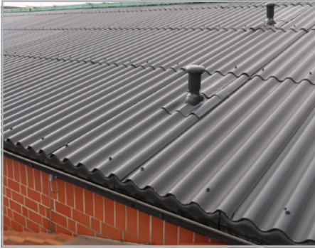
Abb. 18 bis 20: Wellplatten- deckung und kapillarer Wasser- einzug über die Höhenüber- deckung
