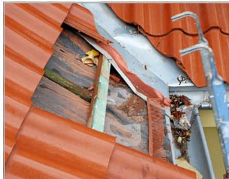
Abb. 142: Wenn die Unterdeckung gegen die Kehl-schalung geführt wird, erzeugt man damit Wasserrinnen an der Kehle. Besser wird die Unterdeckung unter der Kehl-schalung und unter die Trauf-bohle geführt.
