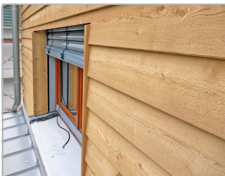
Abb. 287 bis 290: Fachgemäße Holzbekleidung als Stülpdeckung aus Fichtenbret- tern mit abge- schrägter Tropf- kante und Hinter- lüftung am Fenstersturz, überstehendem Leibungsbrett und Tropfkante über der Fensterbank.
