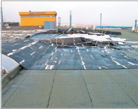
Abb. 681 und 682: Werkseitige Dämmstoffkaschierungen sind nicht immer windsogsicher verklebt. Handprüfung (Abreißprüfung) vor Einbau ist zu empfehlen.
