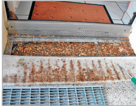
Abb. 337 bis 340: Sickerroste auf Kies- oder Splittbettung sind zur Wasserabführung nicht geeignet.
