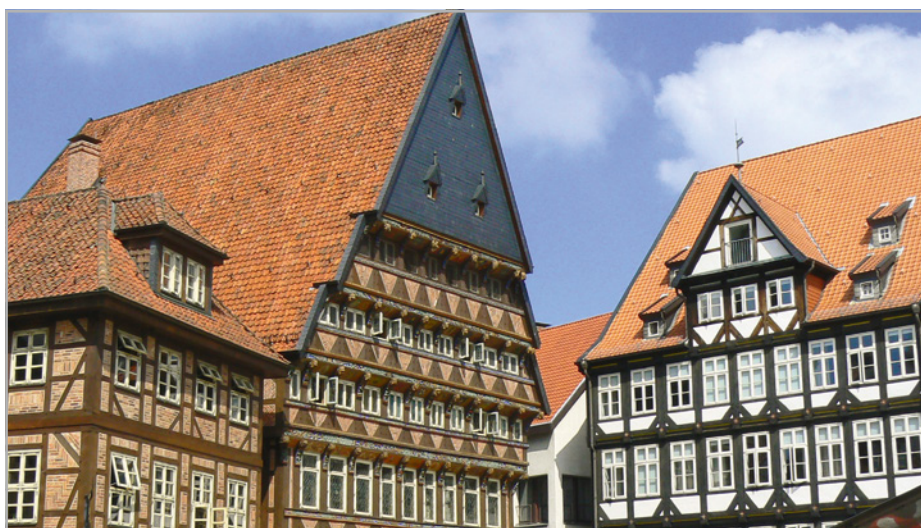
Abb. 1: Historische Dächer zeigen das Prinzip der Dachdeckung; Ableiten des Regenwassers in Richtung Dach- traufe
