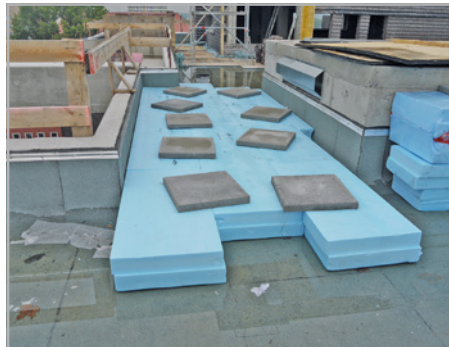
Abb. 688: Verlegung der XPS-Dämmplatten für die Aufdachdämmung
