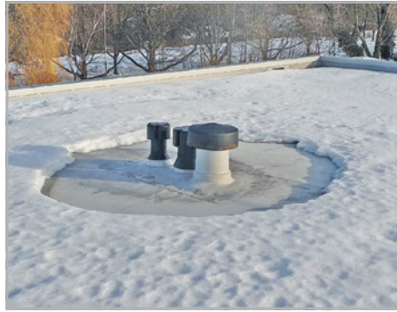
Abb. 577 und 578: Wärmebrücken aus warmem Luftstrom durch die luft-offene Leicht-dachdecke
