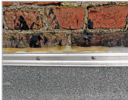
Abb. 647 bis 649: Anschlussleisten auf Sichtmauerwerk sind grobe Konstruktions- und Ausführungsfehler.
