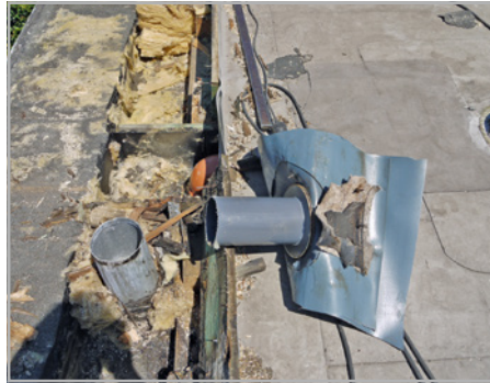
Abb. 510 und 511: Wasserschaden am Lüfterrohr: Der Lüfter war nur lose eingesteckt.
