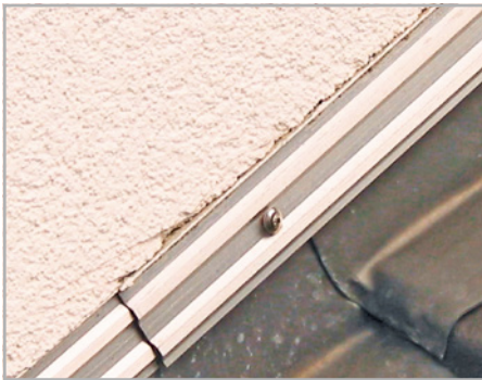
Abb. 132: Putz direkt gegen Anschlussleiste geführt, erzeugt Abrisse und Undichtigkeit
