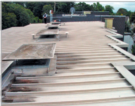
Abb. 32: Dachdeckung aus Klemmfalzprofilen; stehen bleibendes Wasser deutet auf Anschlussprobleme hin
