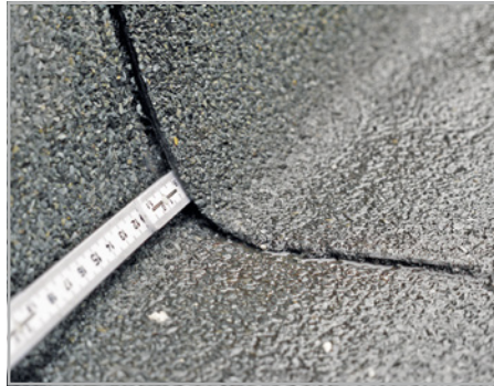
Abb. 432: Anschlussbahnen über 1 m Länge lassen sich nicht mehr vollflächig aufschweißen.
