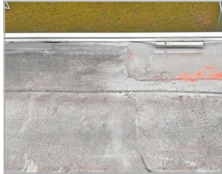
Abb. 512 und 513: Windsogschaden an einteiliger Randblende mit ungeeignetem Einklemmprofil (Quelle: Christian Müller)
