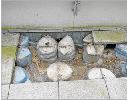
Abb. 307 und 308: Stehendes Wasser auf der Abdichtung durch Attika-Ablauf mit Gegengefälle im Ablaufrohr
