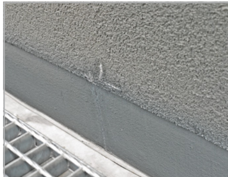
Abb. 659 bis 661: Putzrisse lassen Wasser eindringen, das über eine ungeeignete Lochsockelleiste mit Außenaufkantung hinter den Wandanschluss hereinfließt.
