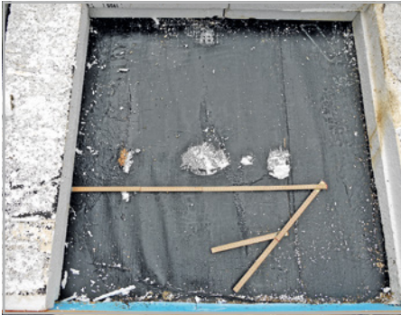
Abb. 711 und 712: Ungenügende Schmelzklebhaftung wegen zu großer Dämmplatten. Schmelzklebung ist nur sinnvoll bei ebenem Untergrund und mit Dämmplatten nicht über 0,5 m 2 .
