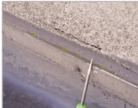
Abb. 646: (re) Direkt angeputzte – undichte – Anschlussleiste
