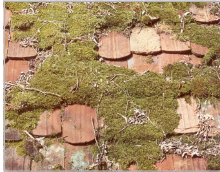
Abb. 403 und 404: auf Dachziegeln: Flechten auf Mönch-Nonnen-Deckung; Fortgeschrittene Vermoosung gefährdet Wasserablauf und Regensicherheit.
