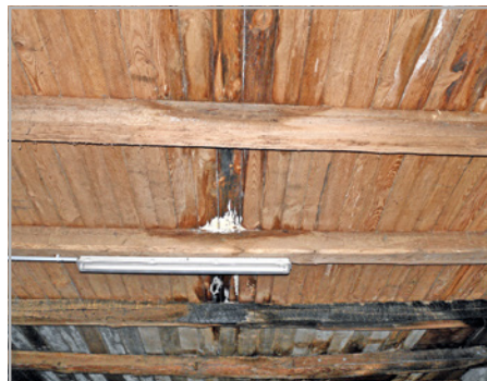
Abb. 179: Holzzerstörender Pilz oder Schimmelpilz? Pilzbesatz ist immer von einem Fachinstitut zu überprüfen.
