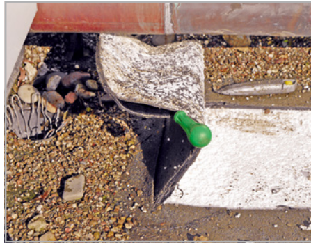
Abb. 311 und 312: Bitumenabdichtungen sind als Balkon- und Terrassenabdichtungen ungeeignet, weil Schweißfehler (fast) unvermeidlich sind.
