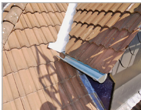
Abb. 144 und 145: Sattelkehlen dürfen nie direkt auf die Dachdeckung entwässert werden (Ausnahme bei Kleingauben).
