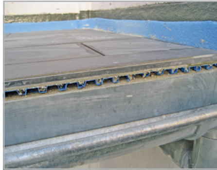
Abb. 361 und 362: Hartbeläge müssen direkt und über die Abdichtung entwässert und hydraulisch entkoppelt werden (Dränplatten).
