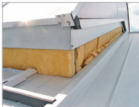
Abb. 262: (re) Luftdichte Anschlüsse sind mit ISO-Profilen nicht herstellbar.
