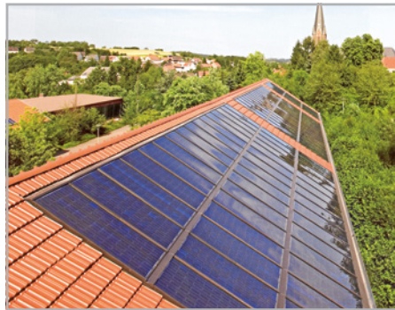
Abb. 784: (re) PV-Kollektorplatten als integriertes Dachsystem (Quelle: RotoSunroof GmbH & Co. KG)
