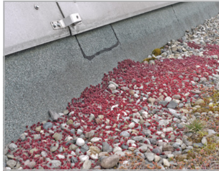
Abb. 736 bis 738: Nicht wurzelfeste Abdichtungen bedürfen einer Wurzelschutzabdeckung, die an Dachrändern und Deckenöffnungen nicht enden darf. Dachränder und Anschlüsse sind sorgsam wuchsfrei zu halten, damit die Wurzelschutzbahn nicht unterwachsen wird.
