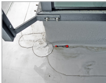
Abb. 734 und 735: Vor Aufbrin- gen der Grün- schicht empfiehlt sich in jedem Fall eine Leckage- prüfung.
