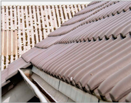
Abb. 383 und 384: Dachdurchhang als technischer und optischer Mangel
