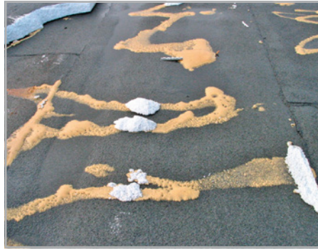
Abb. 716 bis 718: Flüssigkleber schäumt räumlich auf, unterschiedliche Auftragsmengen und unebener Untergrund erzeugen ungenügende Punkthaftung.
