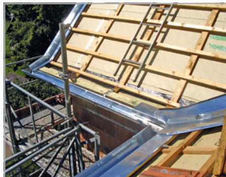
Abb. 236: Vorbereitung einer Aufdachdämmung auf Schalung mit vorgedeckter Dampf- und Luftsperr
