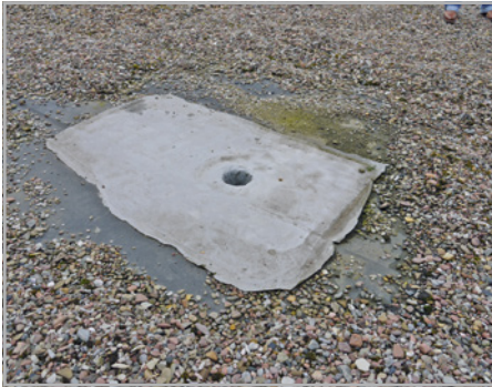
Abb. 520: Flüssigkunststoff zeigt auf Kautschuk- dachbahn keine ausreichende Haftung.
