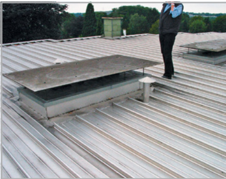
Abb. 126: In Dächern mit Metallprofildeckungen sind Querstöße, Lüfter, Kamine immer problembehaftet und möglichst zu vermeiden.
