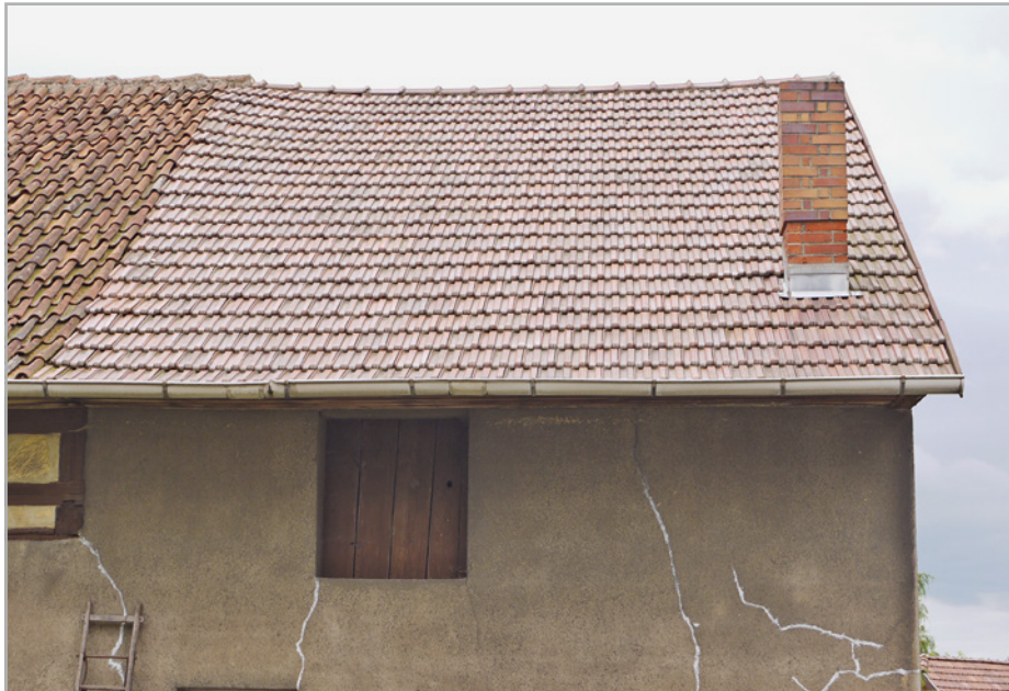
Abb. 159: Exakt ebenflächige Dachstühle sind nicht herstellbar. Ältere Dachstühle hängen oft deutlich durch. Ursachen sind zu kleine Querschnitte, abgerostete Holzverbinder oder bauliche Änderungen.
