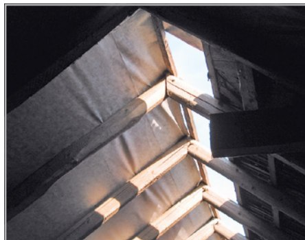
Abb. 169 und 170: Winkelverbinder sind bei Sparrenwechseln nur in biegesteifer Vernagelung einsetzbar. Grundsätzlich sollten Balkenschuhe verwendet werden.
