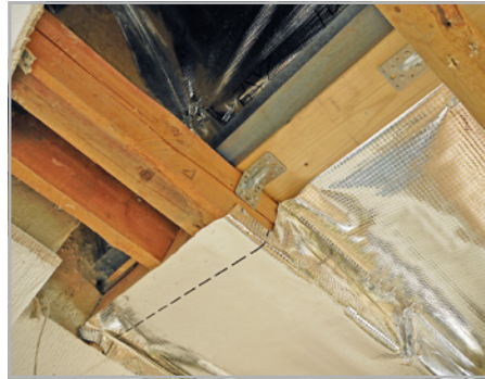
Abb. 216 und 217: An Bauholz und an Leimholzträgern mit Stoßverbindungen sind luftdichte Anschlüsse nicht möglich.
