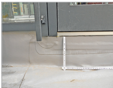
Abb. 328 und 329: Türschwellen ohne Wasserabweisprofil sind nicht eindichtungsfähig.
