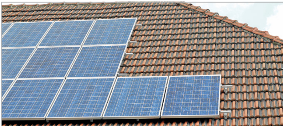
Abb. 773: Aufdachkonstruktionen erschweren Kontrolle, Wartung und Instandhaltung der Dachdeckungen
