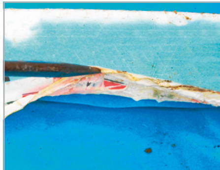
Abb. 575 und 576: Innendruck aus dem Bauwerk bläht hier die Sperrfolie auf; Die Nahtverklebung hat sich gelöst.
