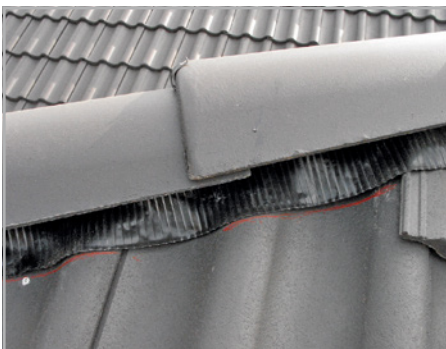
Abb. 96 und 97: Gratziegel und Gratsteine müssen die Flächenziegel und Flächensteine in der Höhe der jeweiligen Mindestüberdeckung überlappen. Hier zu geringe Überlappung.
