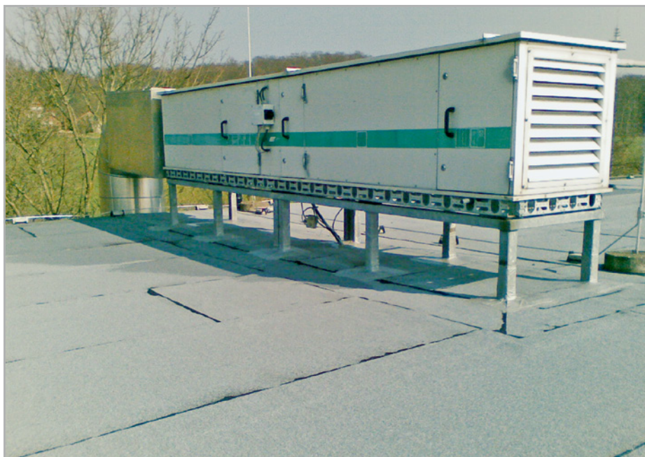
Abb. 766: Das aufgeständerte Kühlaggregat mit eindichtungsfähigen Stützen erlaubt die Wartung und Instandhaltung der Abdichtung.
