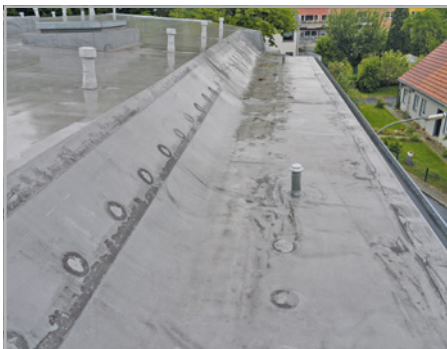
Abb. 695 und 696: Schaden aus Dachverankerung in Holzschalung: Die Anker haben sich ausgedreht.
