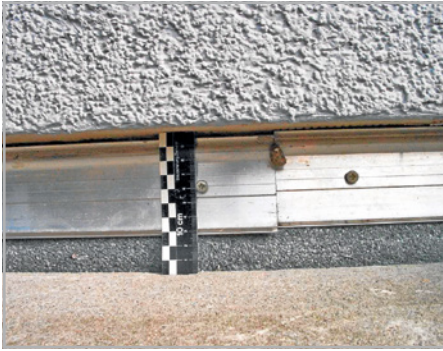
Abb. 318 und 319: Fehlerhafte Anschlussausbildungen an WDVS: Wärmebrücke, ungenügende Anschlusshöhen, Sockelleisten fehlen.
