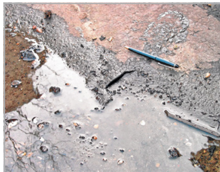
Abb. 452 und 453: Alte Bitu- menabdichtung mit aufstehendem und eingeschlos- senem Wasser
