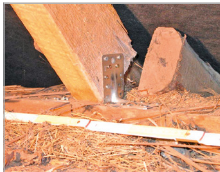
Abb. 173: (re) Winkelverbinder sind für Anschlüsse von Dachsparren an Pfetten ungeeignet. Richtig sind zwei versetzte Sparrenpfettenanker oder vorgebohrte Sparrennägeln.
