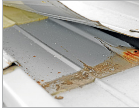
Abb. 256 und 257: Überlappte Querstöße und offene Verschraubungen führen zu kapillarem Wassereinzug.
