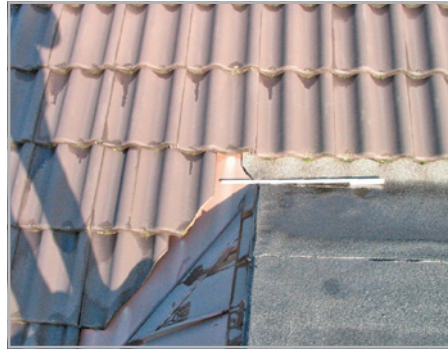
Abb. 300: (li) Die hier gezeigte Ausführung entwässert die Unterdeckung unter das Gauben- dach. Unterdach und Unterdeckung müssen auf die Gaubenkehle entwässern.
