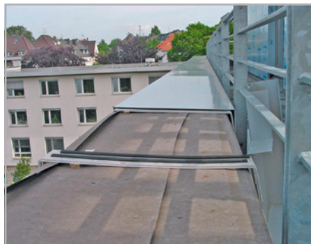
Abb. 643: (re) Selbsttragende Abdeckung aus Aluminiumblech auf Klemmhaltern; Hier sind die Halter jedoch ungenügend unterlegt und befestigt.
