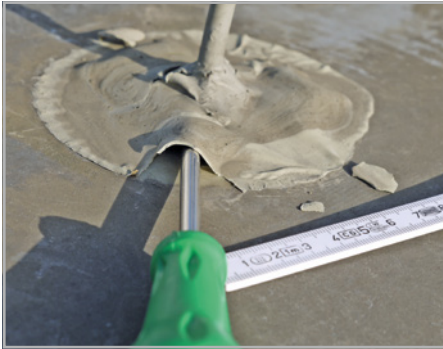
Abb. 539 und 540: Anschlüsse mit Flüssigkunststoff an Kunststoffdachbahnen und beschieferte Bitumenbahnen sind meist nicht dauerhaft dicht.
