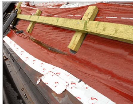
Abb. 45: Wasserspuren auf Unterdeckplatten
