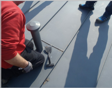
Abb. 26 und 27: Falsch angelegter Querfalz: Der Falz muss mit dem Doppelfalz eingefalzt werden.
