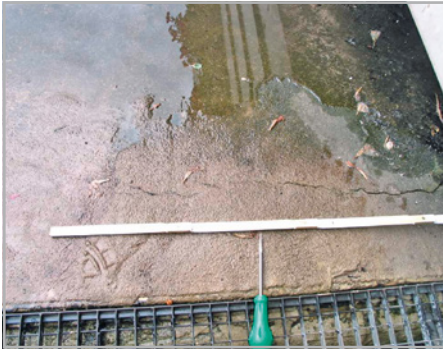
Abb. 533 bis 536: Risse in der Dichtschicht, weil Verstärkungsstreifen vergessen wurden.
