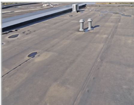
Abb. 700 und 701: Gefälledämmung ist geschrumpft, Ankerschrauben zeichnen sich unter der Abdichtung ab.
