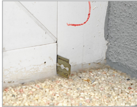
Abb. 324 und 325: Oft liegt der Mangel im Türelement selbst, wie hier mit offenen Stoßfugen.
