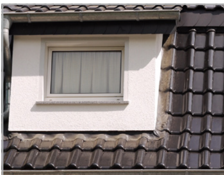
Abb. 108 und 109: Anschlüsse mit Klebebändern sind technisch und optisch ungenügend und sollten vermieden werden.
