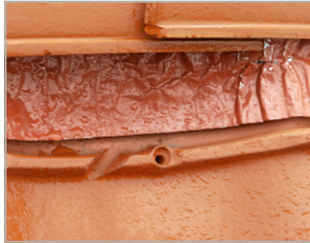
Abb. 102 und 103: Fehlerhafte Latteneinteilung führt hier zu ungenügender Überdeckung am First
