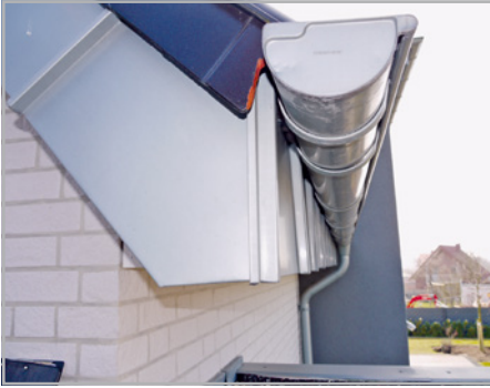
Abb. 381 und 382: schief angebrachte Zinkbekleidung infolge unsauber hergestellter Unterkonstruktion
