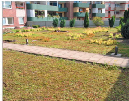
Abb. 739: Leckschaden im Gründach über Einkaufsmarkt. Weil keine abgeschotteten Teilflächen hergestellt waren, musste die Gesamtbegrünung abgeräumt werden.
