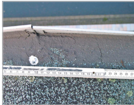
Abb. 303: (re) Einteilige direkt eingeklebte Randprofile sind unfachgemäß und schadanfällig.
