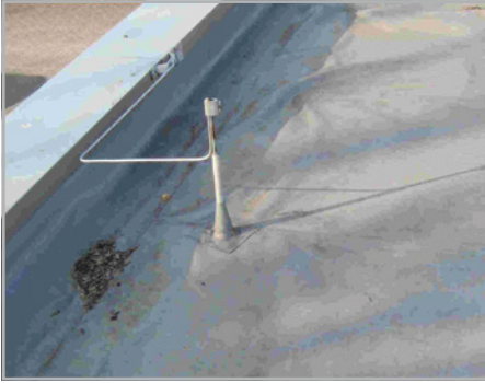
Abb. 771: Fachgerechte Anschluss- manschette am Blitzableiterdraht
