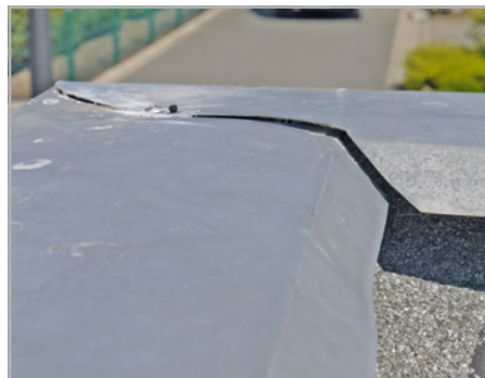
Abb. 636 und 637: Eckstücke müssen verlötet, geschweißt oder verfalzt sein. Dichtkitt ist unzulässig.
