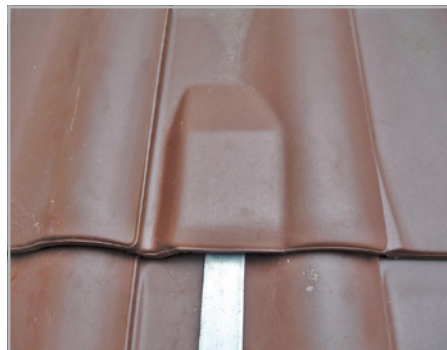
Abb. 776 und 777: Fachgerechte Halterung auf Montagebohle und regensichere Dachdurchführung mit Durchgangsziegel (hier Lüfterziegel) (Quelle: SV Ulrich Daniel)
