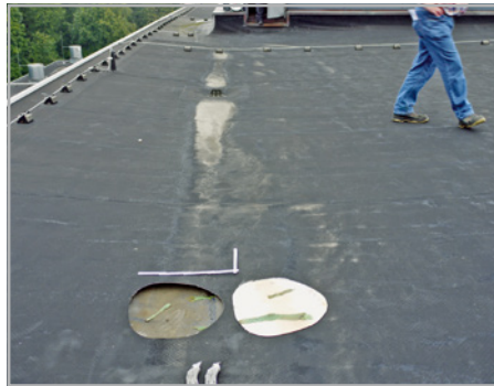
Abb. 719 bis 721: Verklebte Abdichtung; Der Handwerker hatte nicht bedacht, dass Kunststoffbahnen schrumpfen und keine Rand- und Muldenfixierungen eingebaut. Die Bahnnenspannung hat die Klebeverbindungen abgelöst
