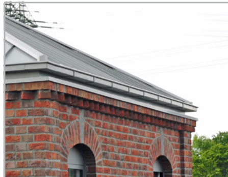
Abb. 59 und 60: Die Rinne mit wasserableitendem Unterblech ist die bessere Lösung und auch optisch ansprechend. (Quelle Bild links: ZVD)
