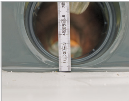
Abb. 567: (re) Auch wenn die Fachregel die Anschlussan- keilung nur emp- fiehlt, scharfkan- tige Bitumenan- schlüsse sind meist undicht.
