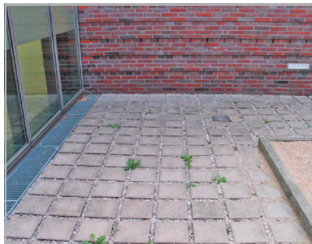
Abb. 765: (re) Dieses Pflaster wurde auf Feinsplitt ohne Dränung und ohne Oberflächengefälle verlegt; Wasserschäden im Gebäude sind die Folge.
