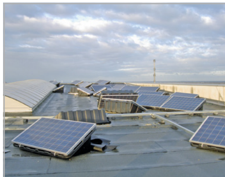
Abb. 796 und 797: (mitte li) Auflagersystem: Die einfachste aber für die Abdichtung auch schadenanfälligste Konstruktionsweise; Wartung des Daches, Reinigung und Instandsetzung sind ohne Abbau der Tragkonstruktion nicht möglich.
