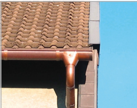
Abb. 91: Regenwasser muss vom Deckblech in die Dachrinne ablaufen: Hier sind Rinne und Abdeckblech zu kurz.
