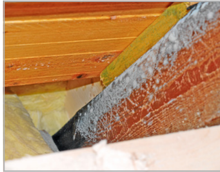
Abb. 277 bis 279: Schimmelpilzbefall im Spitzboden: Anschlüsse gegen leichte Trennwände und rohes Mauerwerk können nicht luft- und nicht dampfdicht sein; Feuchteintrag in den Spitzbodenraum ist die Folge.
