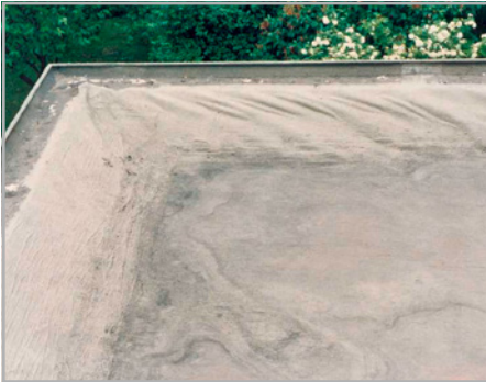
Abb. 524: (li) Auf nicht lagesicherem Untergrund kann keine dauerhafte Flüssigkunststoffbeschichtung aufgebracht werden.
