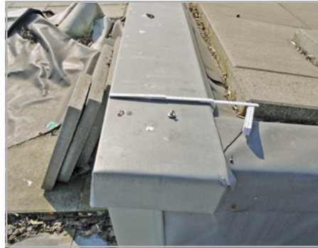
Abb. 633: Mauerabdeckungen müssen Neigung zum Dach haben, damit Wasser und Schmutz nicht an der Fassade ablaufen.
