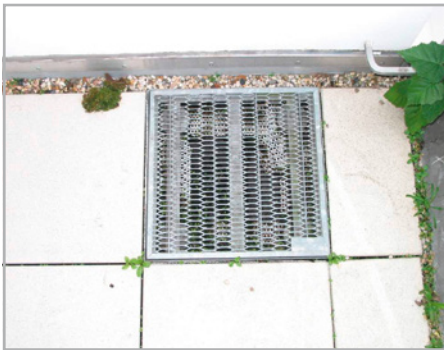
Abb. 309 und 310: Ablaufsiebe mit unterlegtem Filtervlies sind zwecklos.
