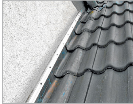
Abb. 134: (li) Anschluss unter WDVS: massive Wärmebrücke; heilbar mit Sockeldämmung, Druckplatte und wasserabweisender Blechschürze
