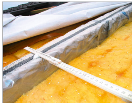
Abb. 228 und 229: Indachdämmung zwischen Dachsparren mit eingeschlaufener Sperrfolie
