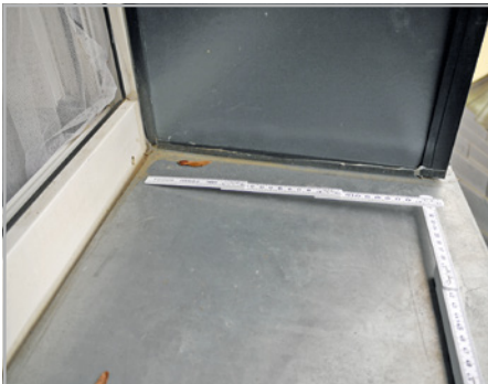
Abb. 293 und 294: Fenster- bankblech ist nicht aufgekantet und nicht im Blendrahmenfalz verwahrt.
