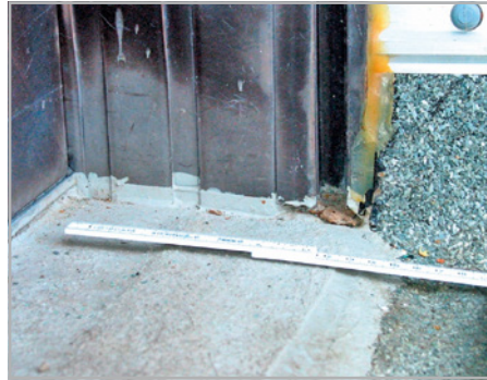
Abb. 347 bis 350: Unwirksame Anschlüsse mit Flüssigkunststoff auf Schwellenprofil und gegen Holzblendrahmen.
