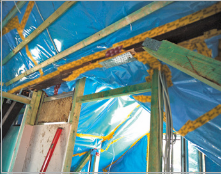
Abb. 274 bis 276: Konstruktive Unbrauchbarkeit: Ständerwerk lässt sich nicht luft- dichten.
