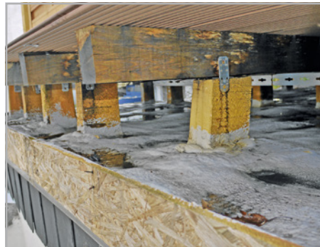
Abb. 530 bis 532: Misslungener Versuch einer Dachbeschichtung aus PU-Ortschaum
