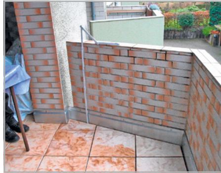
Abb. 313: Balkonabdichtung aus Flüssigkunst- stoff
