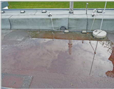
Abb. 565 und 566: Ursachen können der Rohransatz, Klebenaut oder schief sitzendes Ablaufrohr sein.
