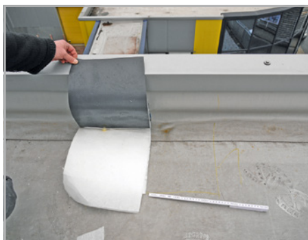
Abb. 601 bis 604: Luftdichte Anschlüsse gegen ISO-Wandelemente sind nicht herstellbar; Stoßfugen der Wandelemente sind offene Luftdüsen.
