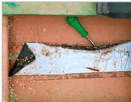
Abb. 53 und 54: Stoß- oder Anschluss- klebungen auf Unterdeckplatten sind nicht haltbar.
