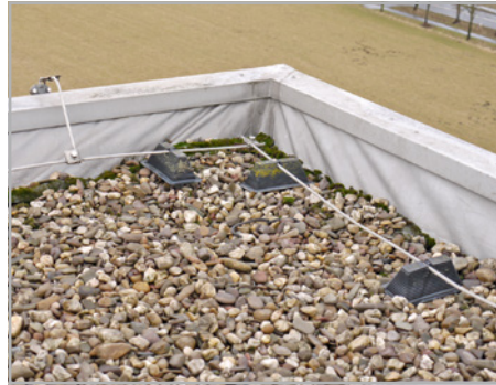
Abb. 454: Kontaktschaden einer PVC-Abdichtung auf EPS-Dämmstoff ohne Trennlage
