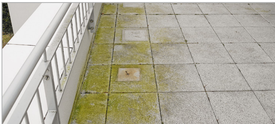
Abb. 306: Gefällelose Nutzbeläge ohne direkten Wasser- ablauf verschmut- zen rasch.
