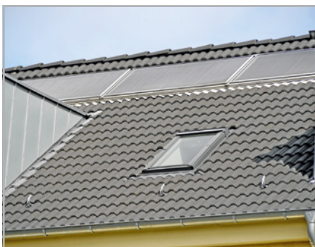
Abb. 787 bis 789: Konstruktiv fehlerhafte Anschlüsse der Kollektorrahmen: In Rahmennut eingesetzte Dichtprofile auf Metallblechkehle sind ungeeignet
