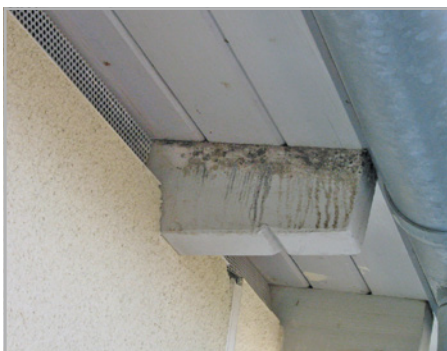
Abb. 607 bis 615: Das zweischalige unbelüftete Flachdach auf Holzkonstruktion ist eine gefahren-geneigte Ausführung mit »geringer Fehlertole-ranz«. Schaden-quellen liegen in Anschlussmängeln der Dampf- und Luftsperr und in zu geringem Austrocknungsver-mögen des Deckenquer-schnitts.
