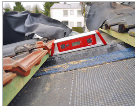
Abb. 39: Wasser- dichtetes Unterdach aus Kunststoff- dachbahnen mit Entwässerung unter der Traufe
