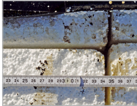
Abb. 676 und 677: EPS-Dämmplatten mit Stufenfalz und Schrumpffugen
