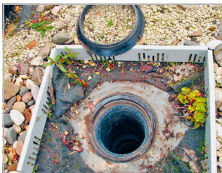
Abb. 506 bis 509: Anschlüsse mit Klemmdichtungen (Dreh- und Bajonettverschluss, Klemmring mit Flügelschrauben) sind nicht (oder nicht dauerhaft) wasserdicht.
