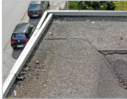
Abb. 450: Randprofil und abgesicherte Bitumenbahn
