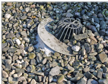
Abb. 692 und 693: Auswirkungen der Schrumpfspannungen auf Abläufe und Lüfter
