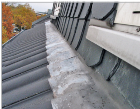
Abb. 118: (li) Fachgerechte Ausführung des Anschlusses mit Bitumenschindeln (Quelle: ZVD)
