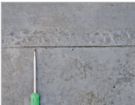
Abb. 467 bis 470: Verklebte Bahnennähte sind unter stehendem Wasser nicht dauerhaft.
