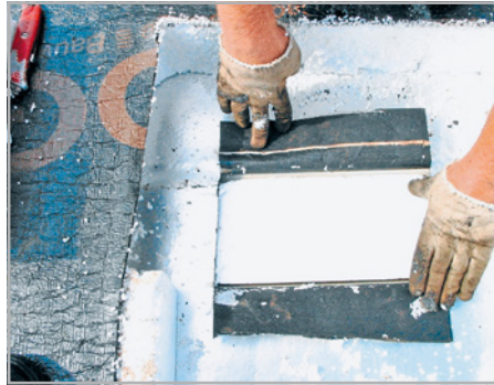
Abb. 605 und 606: Druckfeste Sickenfüller ermöglichen dauerhaften Nahtverschluss der Sperrfolien und -bahnen.
