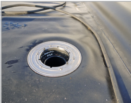
Abb. 552 und 553: Dachabläufe müssen an der Dachdecke lagesicher verankert werden; nicht lose eingesteckt.
