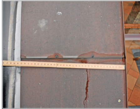
Abb. 93 und 94: Verdeckt befestigte Kupferblechabdeckung, jedoch mit kapillaraktiver unverfalzter Blechüberlappung
