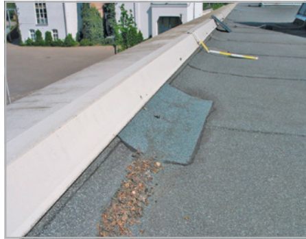
Abb. 638: (li) Selbsttragende verdeckt befestigte Abdeckung, jedoch mit Neigung nach außen und Wasserläufern an der Fassade.
