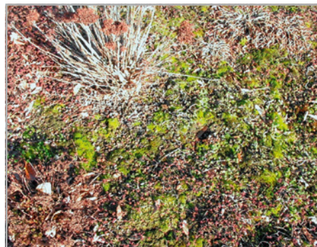
Abb. 744 und 745: Vernässte und vermooste Begrünung über gefällelosem Dach
