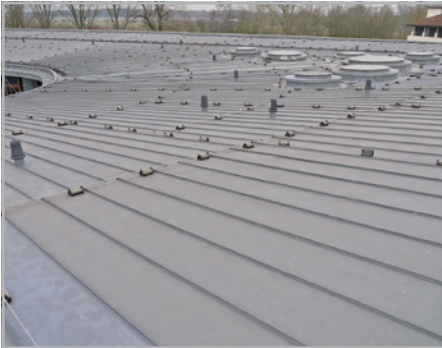
Abb. 24 und 25: Mängel und Wasserschäden an einem Großdach mit 3,5°-flacher Dachneigung und doppelten Querfalzen. Regensicherheit ist hier nicht herstellbar.
