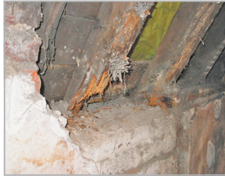
Abb. 176 bis 178: Hölzer mit Holzschäden durch zerstörenden Pilz (li oben) oder Insekten (re oben u. li unten) müssen ca. 30 cm über den erkennbaren Befall hinaus ausgetrennt und ersetzt werden.
