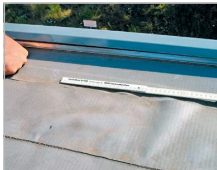
Abb. 515 bis 519: Windsogschaden an der Dachrandblende: Die Blendenhalter hatten zu weite Abstände und ungenügende Einklemmung von Blende und Dachbahn.
