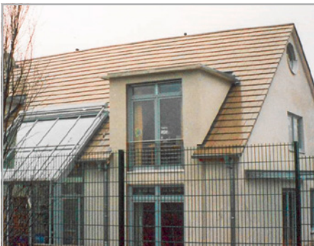
Abb. 387 und 388: grobe Fluchtabweichung an der Dachkante, durch unsauber vermessenes Betonpolster für die Mittelpfette
