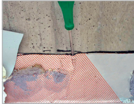
Abb. 572 bis 574: Bitumensperrbahnen sind einfach zu verlegen, verlangen jedoch auch gegen Dachränder luftdicht verklebte Anschlüsse (hier Luftdüse aus Bahnenfalte)
