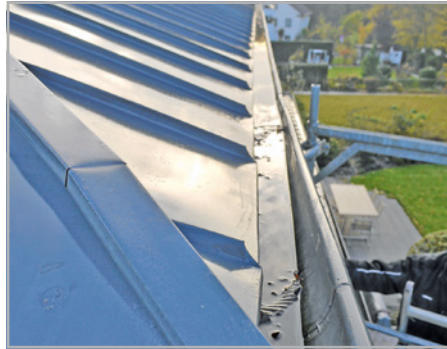
Abb. 55: unfachgemäß verlegte Behelfsdeckung verursachte Wasserschaden
