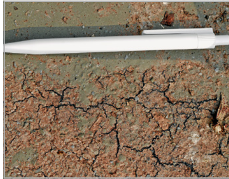
Abb. 421 bis 423: Chemische Zerstörung einer Abdichtung aus Elastomerbitumenschweißbahnen durch biologisch aktive Schmutzauflagen (»Kuhfladen-Effekt«).
