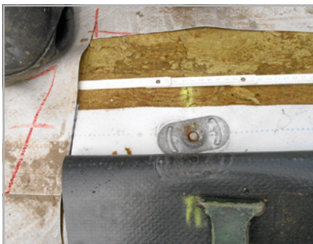
Abb. 697 und 698: Ankerschrauben mit Stützgewinde sind nicht trittfest.
