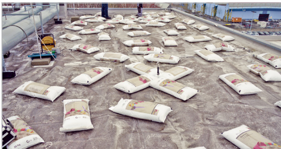
Abb. 689: Vom Wind hochgerissene Abdichtung aus Kunststoffdachbahnen und Notsicherung mit Sandsäcken
