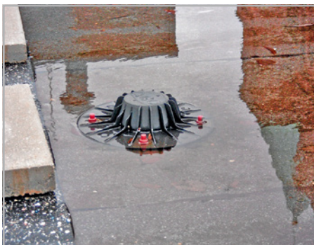
Abb. 560 und 561: Nachteil der Druckwasserabläufe: Sie neigen zur Verschmutzung, verstopft sind sie nicht mehr wirksam.
