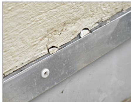
Abb. 315 bis 317: Fehlende Putzsockelleiste am Außenputz führte zum Wasserschaden.
