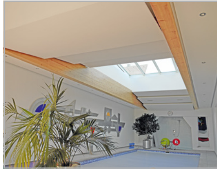
Abb. 616 (re) bis 619: Privatschwimmhalle mit unbelüftetem zweischaligem Holzflachdach; Luftlöcher in der Luftdichtheitschicht und ungenügende Austrocknung haben die Dachkonstruktion zerstört.
