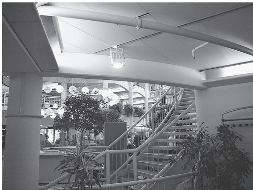
Abb. 5: Sprinkleranlage in der Stadtbibliothek Gütersloh; Foto: privat
