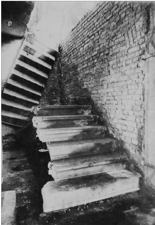
Abbildung 19: Befund der hängenden Eisenblechtreppe und der Kunststeinstufen 169
