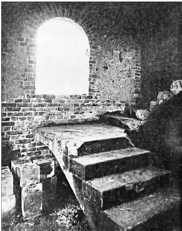
Abbildungen 20-23: Zustand der Treppen nach dem Brand (v.l.n.r.): erste Beschädigungen an Sandsteinstufen; herabgefallene Sandsteintrümmer (durch Ablöschen); nahezu unveränderte Kunststeinstufen; Eisenbeton- und Eisenstufen im Vergleich 172
