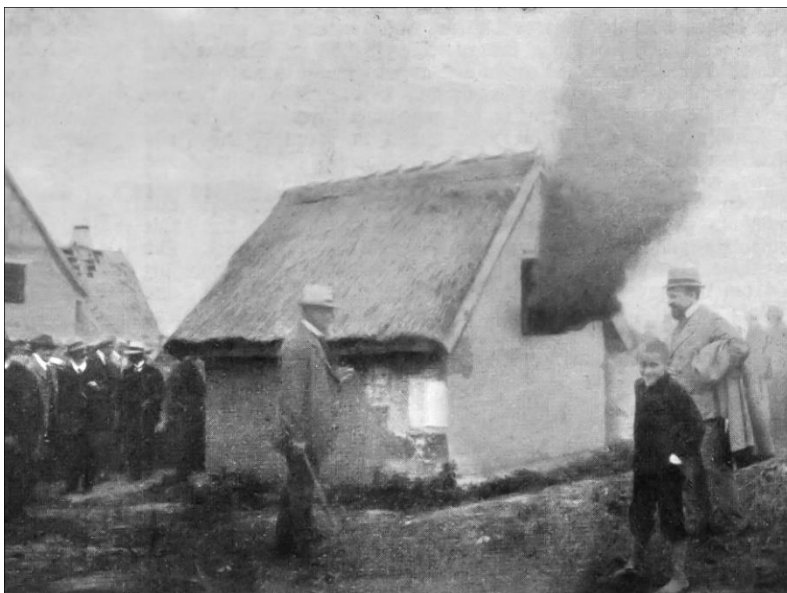
Abbildung 32: Dritte Brandprobe: Feuer im Inneren des Häuschens bei starker Rauchbildung 216
