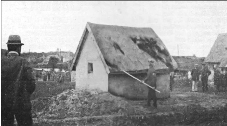
Abbildung 30: Erste Brandprobe: Entzündung der äußeren Oberfläche des Lehm-schindeldaches 214
