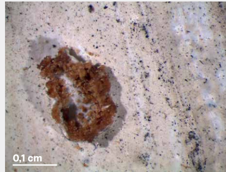
Abb. 5.10 Detail Schadensbild (Stereomikroskop). Die Malschicht bildet um den Krater eine Begrenzung, indem sie – durch das austretende Material plastisch deformiert – eine Art Kranz bildet. Dieses Phänomen ist an vielen Kratern festzustellen, manchmal bildet die Malschicht auch kleine Dächer, die vom austretenden Material weggeschoben werden. Es weist darauf hin, dass die Malschicht in noch nicht getrocknetem Zustand bereits deformiert worden ist. Im Bereich der Malschichtdeformationen sind vielfach Risse und Malschichtausbrüche vorhanden. Die Konglomerate lagern sich an der Innenseite der Kraterwände an.
