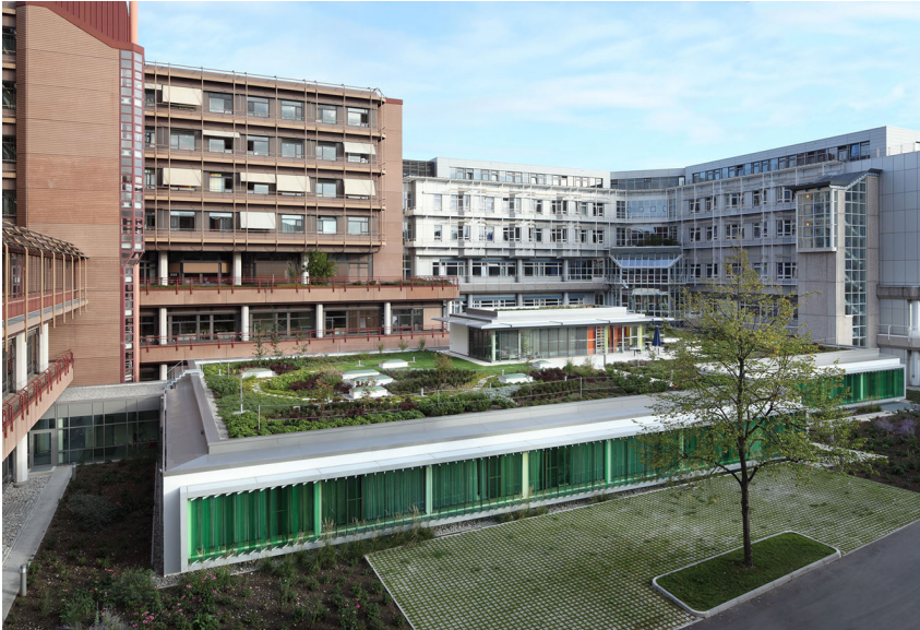
Abbildung 4: Die Dachfläche auf dem Neubau der Intensivstation des Universitätsklinikums Tübingen dient dem Personal für Rückzug und Erholung mit geschützten Innen- und Aussenräumen (als sander.hofrichter architekten, Foto: Markus Bachmann)
