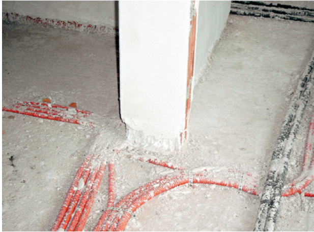
Abb. 93 ■ Elektroleitungen auf der Rohdecke
