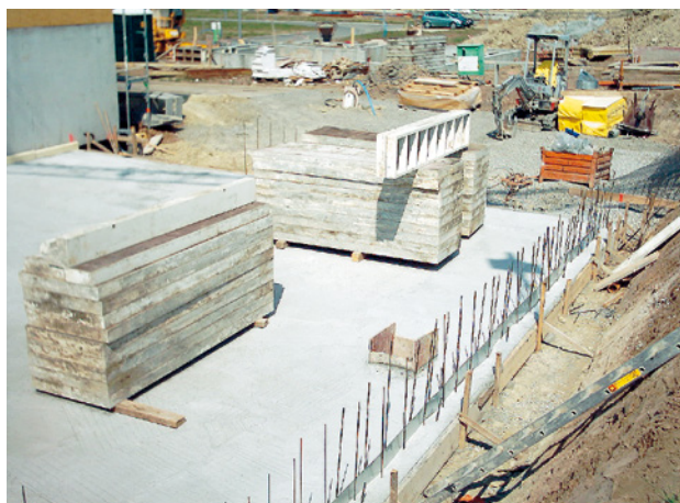
Abb. 9 ■ Bodenplatte mit Fugenblech
