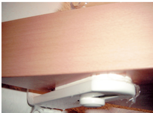
Abb. 107 ■ Stufenwandaufleger
