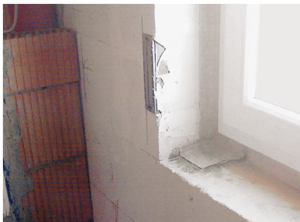
Abb. 95 ■ Nachträglich ausgebesserte Fensterverklebung
