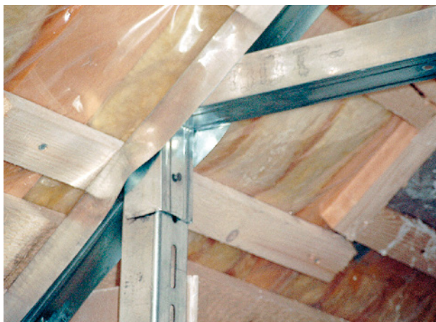
Abb. 105 ■ Trennwandbefestigung
