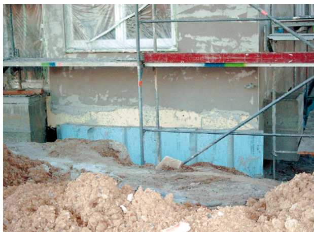
Abb. 22 ■ Unterer Putzanschluss an Perimeterdämmung auf der Südseite
