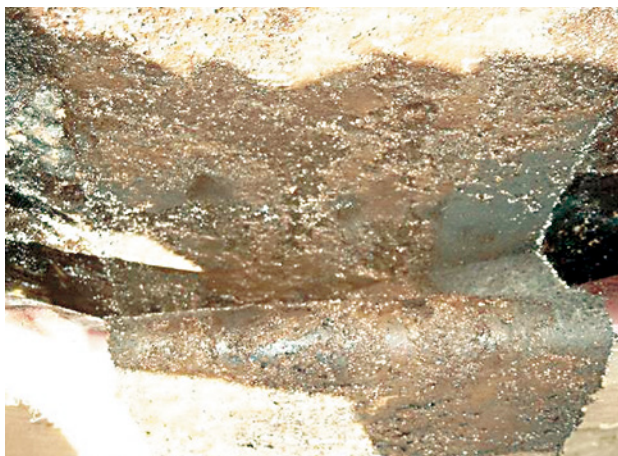
Abb. 15 ■ Abgelöstes Fugenband
