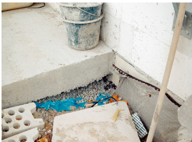
Abb. 13 ■ Fehlende Abdichtung unter Terrassenplatte
