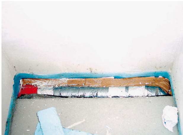
Abb. 61 ■ Abwasserleitung in der Speisekammer
