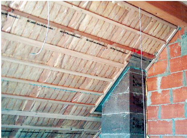
Abb. 33 ■ Variable Luftdichtheitsbahn
