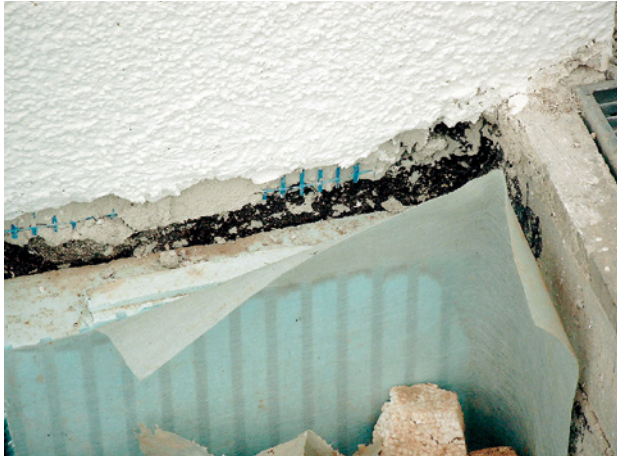
Abb. 56 ■ Unterer Außenputzabschluss
