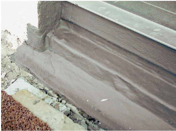
Abb. 97 ■ Untere Abdichtung der Terrassentür ge- gen Bodenfeuchte
