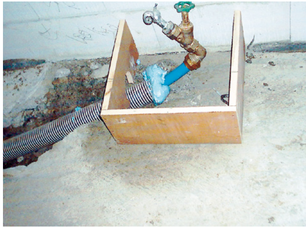
Abb. 80 ■ Schachtschalung auf der Bodenplatte
