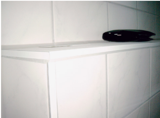
Abb. 74 ■ Vormauerungseck- detail
