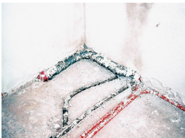
Abb. 59 ■ Wasserleitungen
