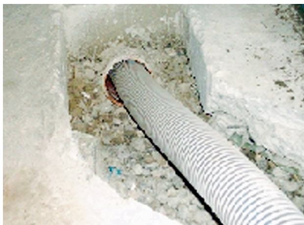
Abb. 78 ■ Wasserleitungs- einführung im UG
