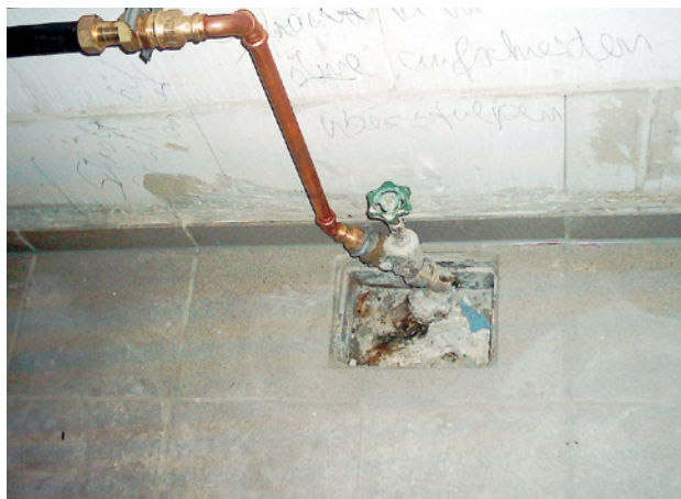
Abb. 82 ■ Fertiger Wasser- leitungsanschluss mit verschmutztem Absperrventil
