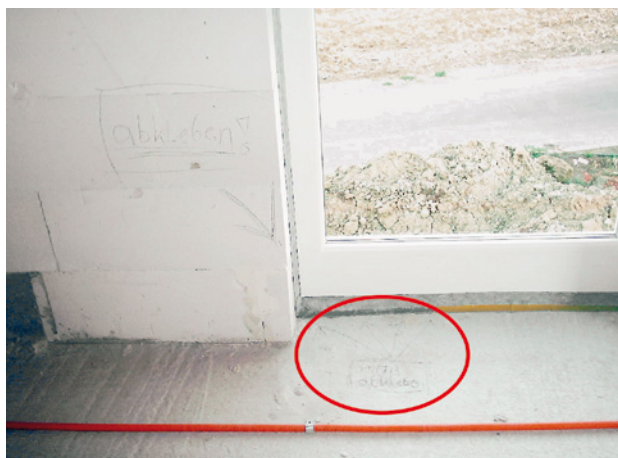
Abb. 94 ■ Offene Fensterverklebung
