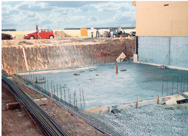
Abb. 3 ■ Bodenplatte
