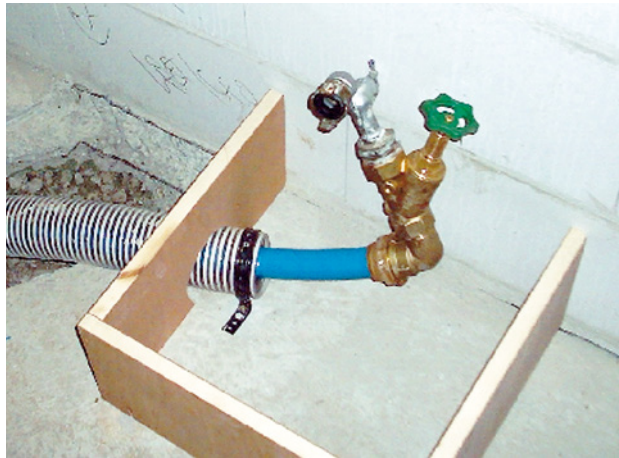
Abb. 81 ■ Erster Wasserleitungs- anschlusspunkt
