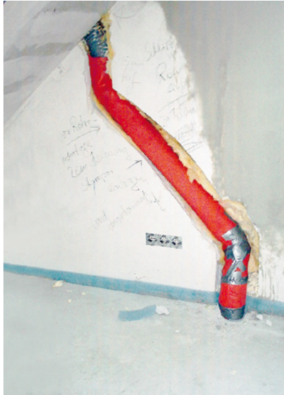
Abb. 86 ■ Unter Putz verlegte Abluftleitung im Dachgeschoss
