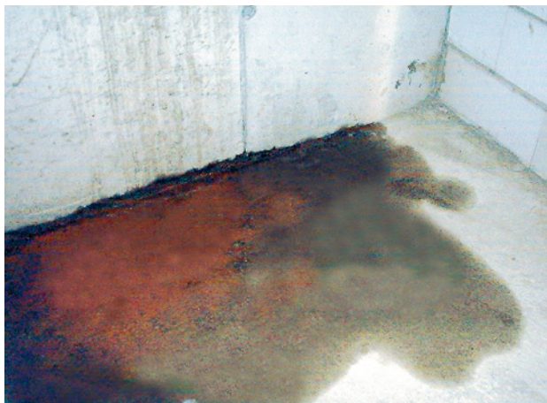
Abb. 14 ■ Wasser auf der Bodenplatte
