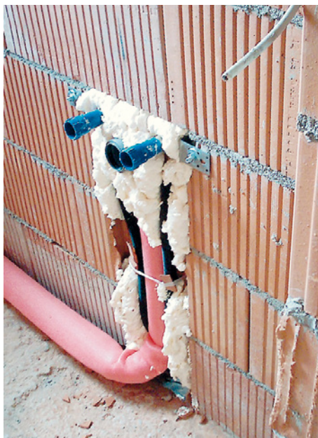
Abb. 89 ■ Wasser- und Abwasseranschluss in der Küche
