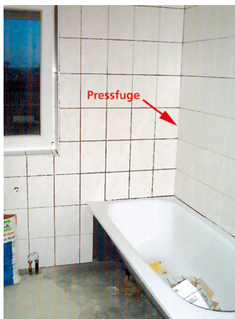
Abb. 72 ■ Vertikale Raumecke
