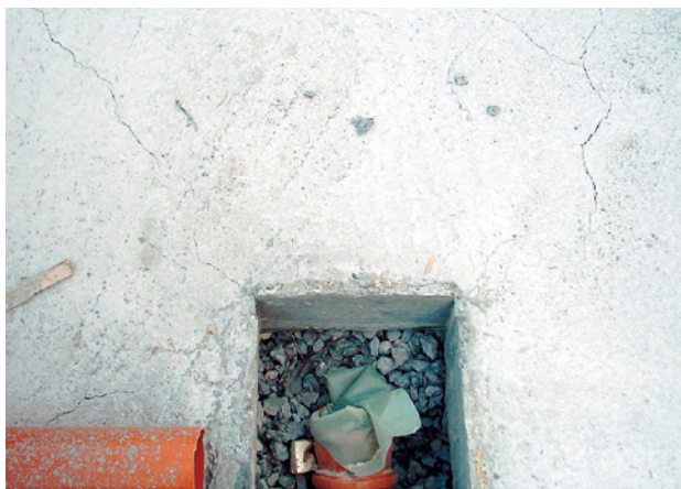
Abb. 4 ■ Gerissene Bodenplatte
