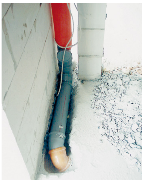
Abb. 19 ■ Rohrdurchdringung ohne Abdichtung
