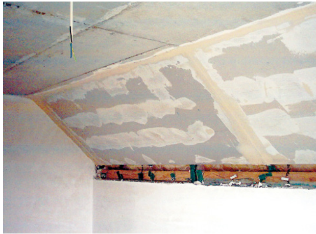
Abb. 51 ■ Unfertige Bekleidung
