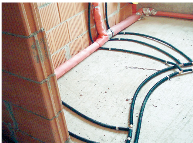
Abb. 84 ■ Abwasser und Wasserleitungen auf der Decke
