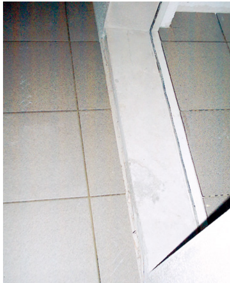
Abb. 77 ■ Garagenbodenwandanschluss
