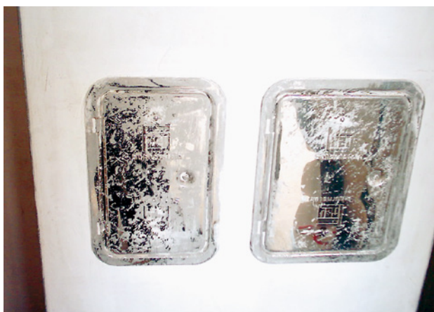
Abb. 55 ■ Verschmutzte Schorn- steinputztürchen
