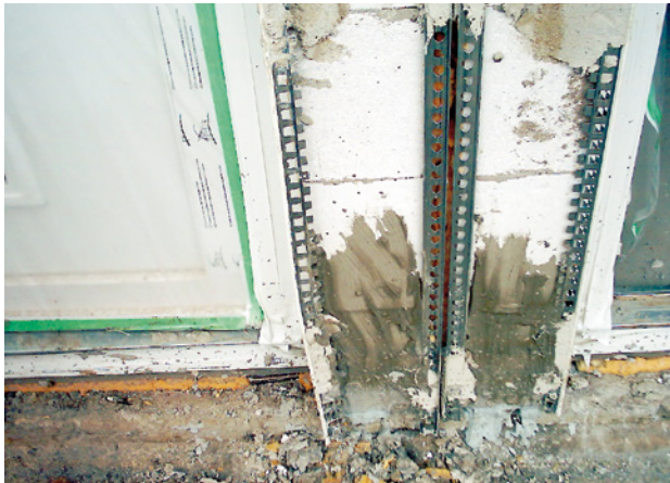
Abb. 57 ■ Eckschutzschienenabschluss
