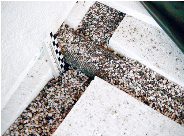
Abb. 63 ■ Dämm- platten mit aufgefüll- ten Bodenleitungen
