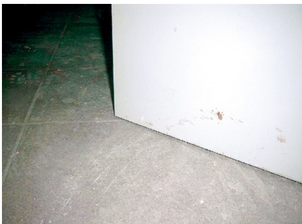
Abb. 67 ■ Auflaufen- des Garagentürblatt
