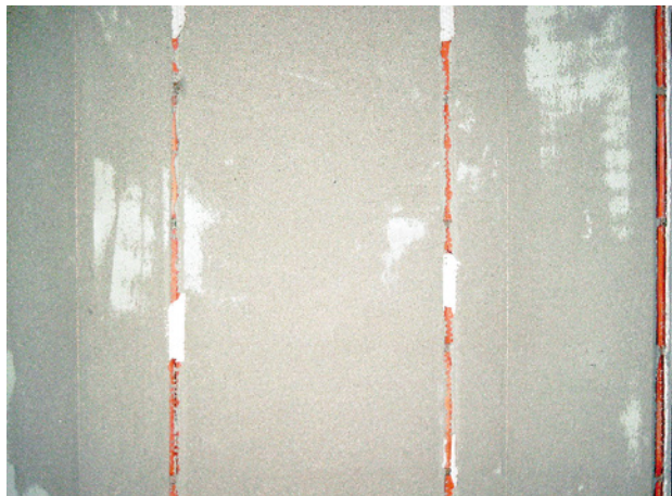
Abb. 53 ■ Gipsreste im Kalkzementputz nach Entfernen der Putzleisten
