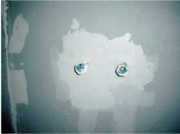
Abb. 70 ■ Nachträglich abgedichtete Durchdringungen
