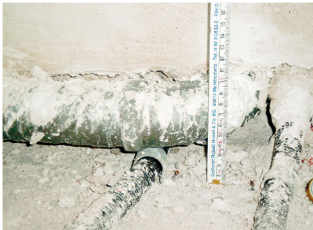
Abb. 48 ■ Verschmutzte Rohrleitungen
