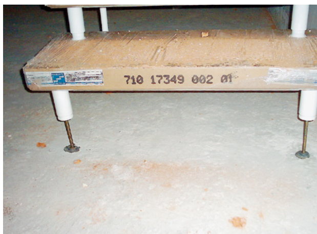
Abb. 103 ■ Antritts- stufenbefestigung
