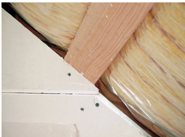
Abb. 106 ■ Wandanschluss an Tragplatte der Dachflächenbekleidung
