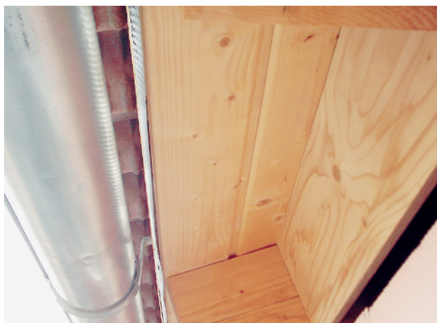
Abb. 42 ■ Insekten- schutzgitter
