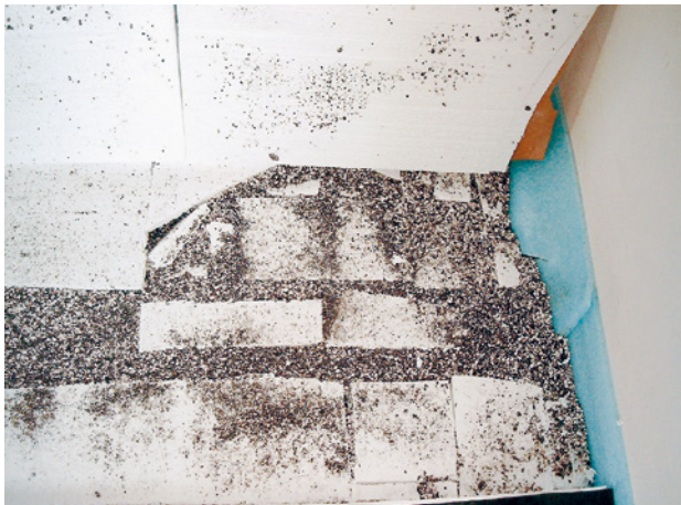
Abb. 64 ■ Gestückelte Dämmplatten mit Auffüllbereichen
