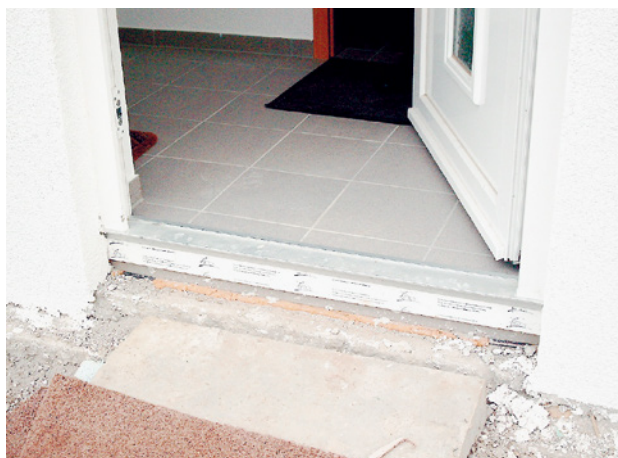
Abb. 96 ■ Fehlende Türabdichtung gegen Bodenfeuchte
