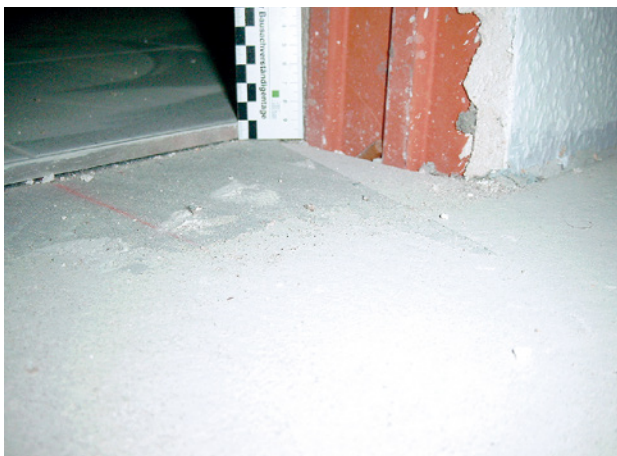
Abb. 66 ■ Fertiger Fliesen- belagabschluss
