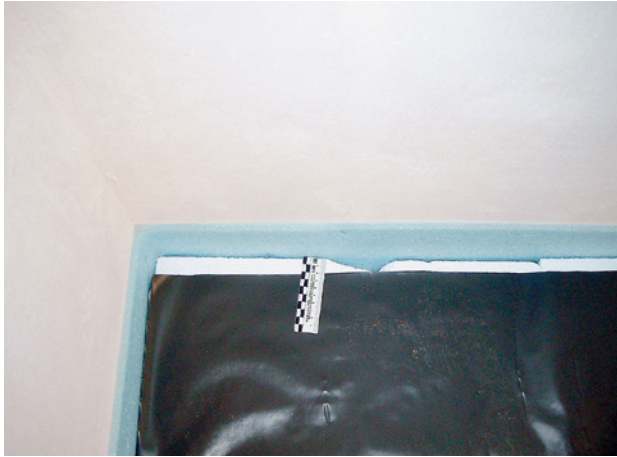
Abb. 62 ■ Estrichtrennfolien- wandanschluss
