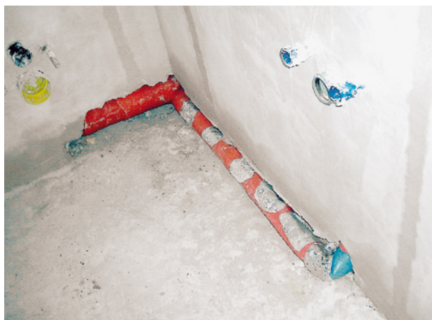
Abb. 58 ■ Abwasserleitungen im Bad
