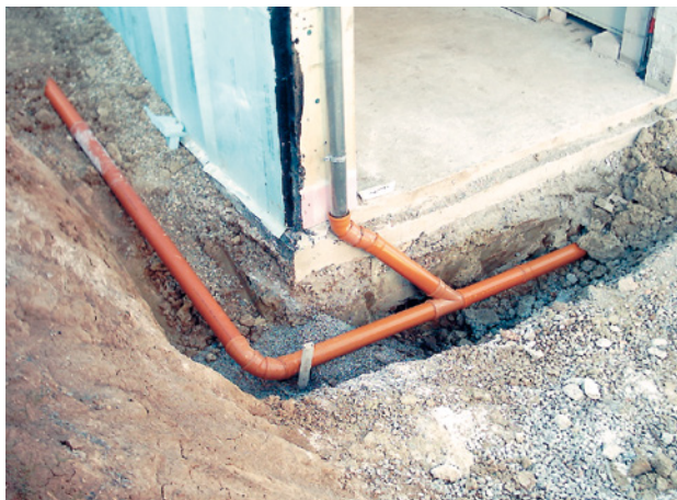
Abb. 6 ■ Fliegende Regen- leitung
