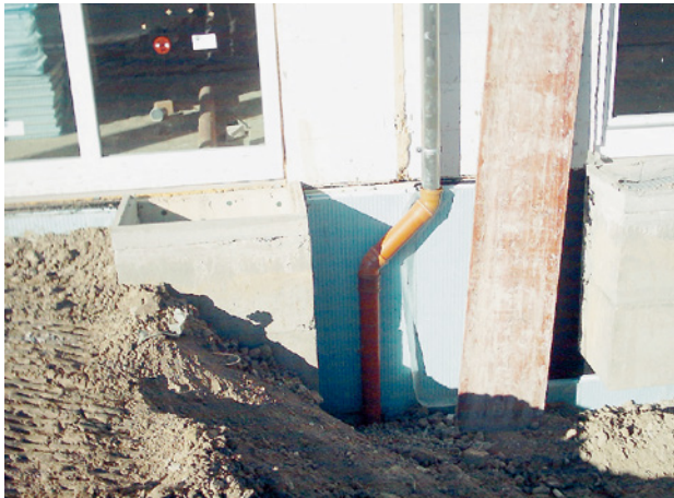
Abb. 44 ■ Fallrohranschluss
