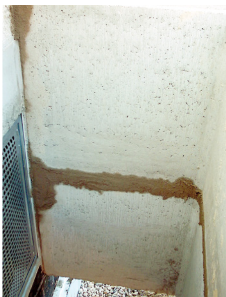
Abb. 28 ■ Nachgebesserte Betonabplatzung
