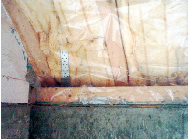
Abb. 49 ■ Holzpfetten mit Luftdichtheitsbahn auf Kniestock
