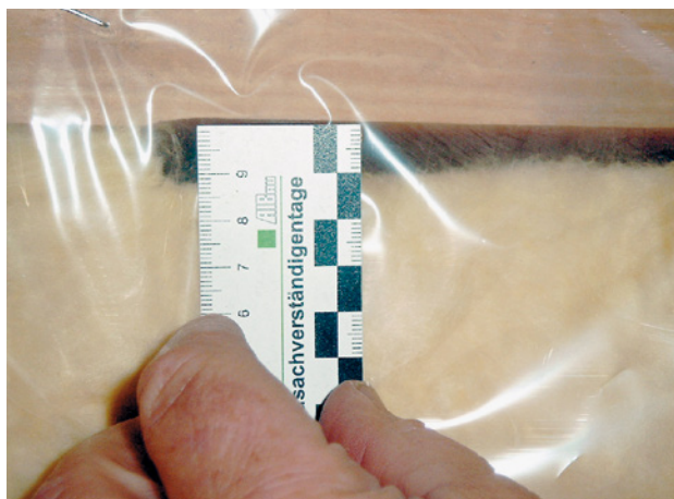
Abb. 34 ■ Wärme- dämmung mit Fehl- stellen
