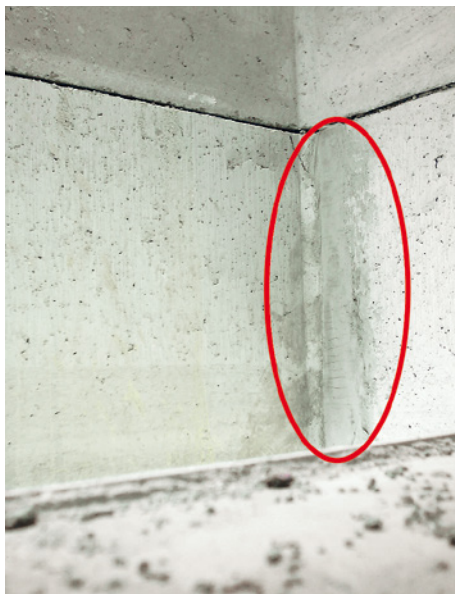
Abb. 27 ■ Nachgebesserter Riss
