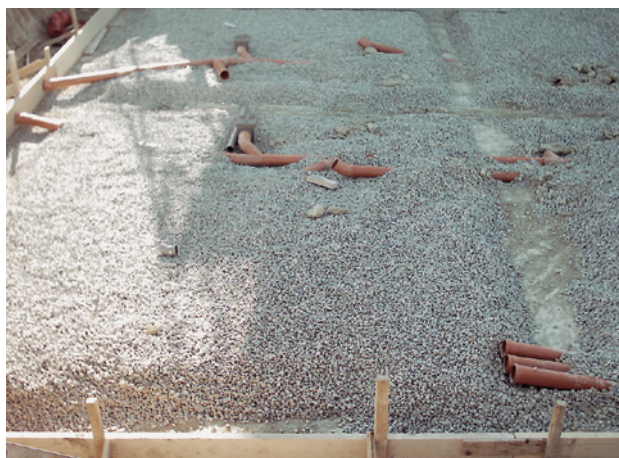
Abb. 5 ■ Grundleitungen in der kapillarbrechen- den Schottersschicht
