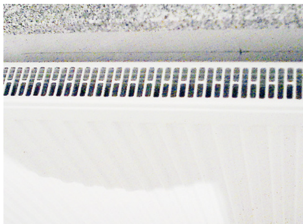
Abb. 98 ■ Heizkörperrückwand ohne Anstrich
