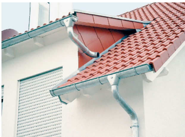
Abb. 45 ■ Dachgaubenablauf
