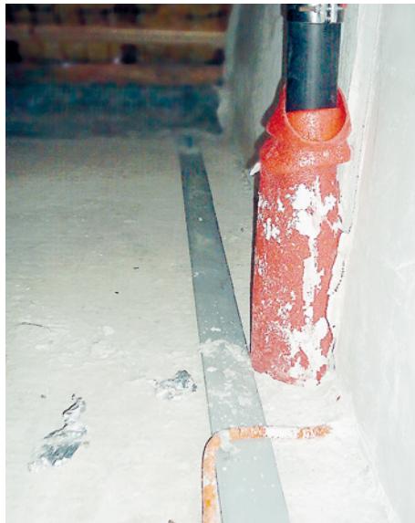
Abb. 24 ■ Nachträglich auf der Decke verlegter Flachstahlringanker
