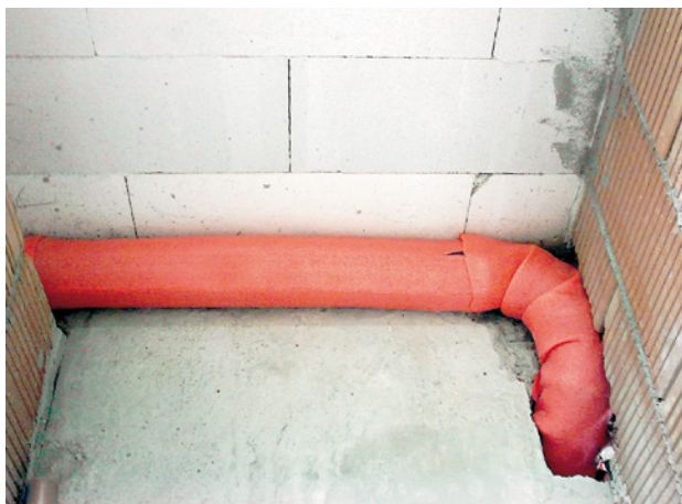
Abb. 83 ■ Abwasserleitung auf der Rohdecke
