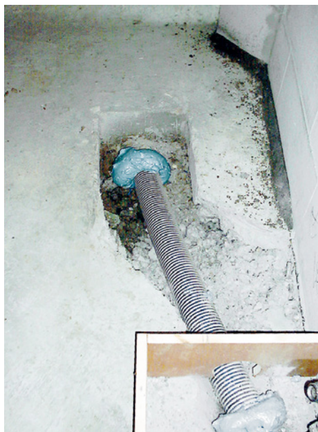
Abb. 79 ■ Leitungsschlitzverlängerung mit »Abdichtungen«
