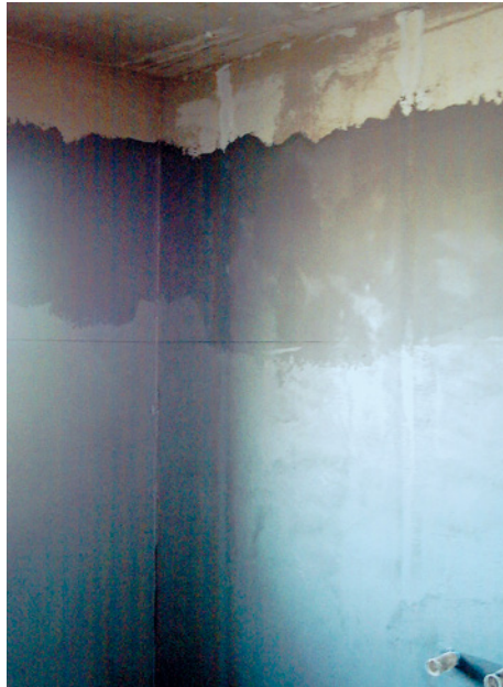
Abb. 71 ■ Nachgearbeitete Wandabdichtung
