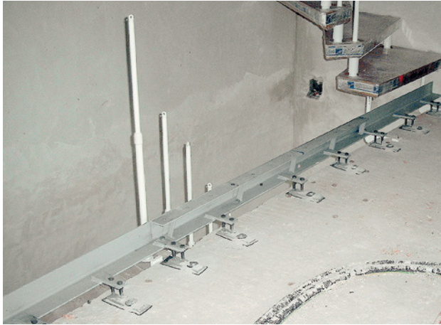
Abb. 99 ■ Randabschlussprofil
