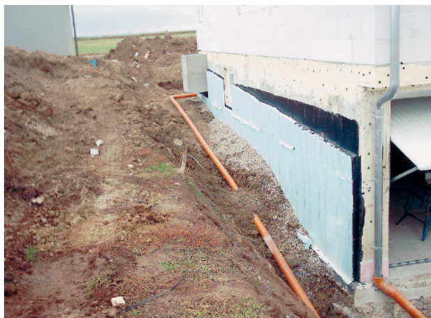
Abb. 7 ■ Neue Regenleitung im Arbeitsraum
