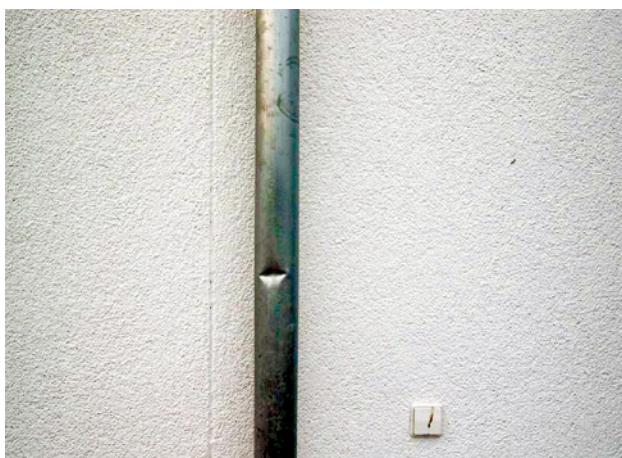
Abb. 46 ■ Verbeultes Fallrohr
