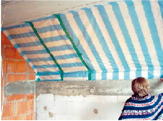
Abb. 32 ■ Dampfsperre
