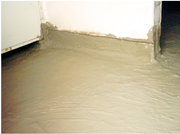
Abb. 20 ■ Verkieselung der Bodenplatte
