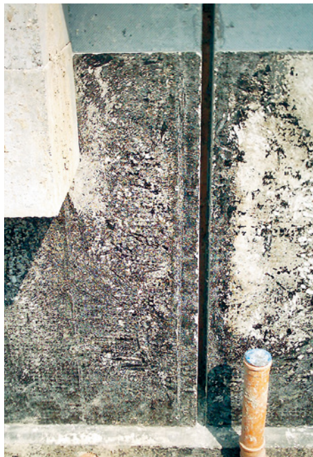
Abb. 17 ■ Haustrennfuge ohne Fugenband
