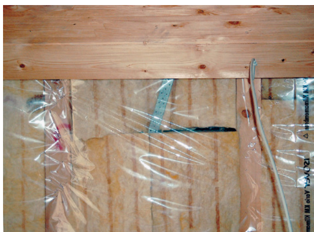
Abb. 35 ■ Risen- band als Wärmeleiter in der Dämmung
