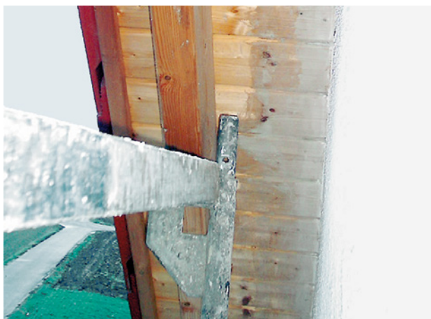
Abb. 54 ■ Verschmutzte Ortgangschalung
