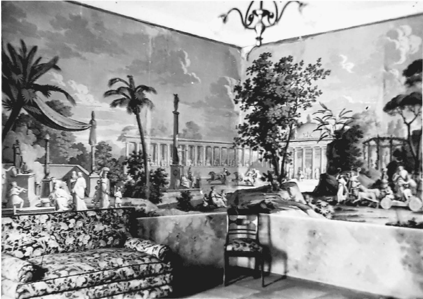
Abb. 24: Schirgiswalde, Herrenhaus des Domstifts, Tapetenzimmer (mittleres Zimmer), südliche Seite, Foto von 1936
