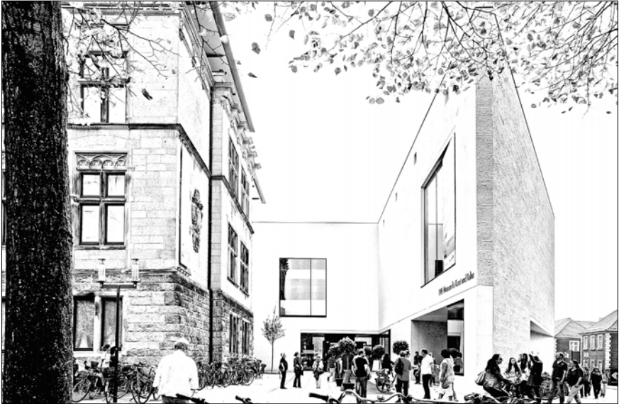
Abb. 1: LWL-Museum für Kunst und Kultur, Münster, Eingangsbereich zum Domplatz, links der Altbau von 1908, rechts der Neubau von Volker Staab Architekten, 2014. Foto: LWL-MKuK/Hanna Neander.
