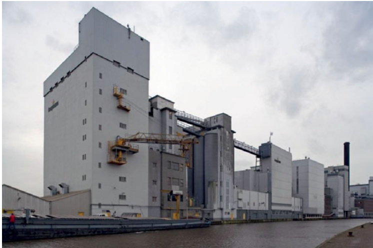
Abbildung 1-5: Getreidemühle in den Niederlanden mit Silozellen [Bühler AG]
