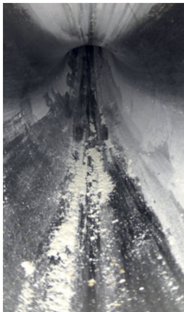
Abbildung 5-50: Geringe Ablagerungen im Steigrohr, ohne feste Anlagerungen (linke Darstellung) und Anlagerungen im Rohrbogen (rechte Darstellung)
