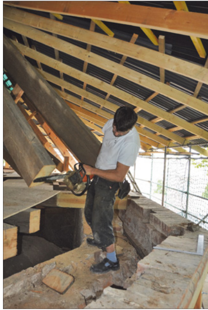
Abb. 20: Die Schäftung der Sparrenfüße sowie Deckenbalkenköpfe konnte im verspäteten Frühjahr endlich beginnen (DREGER, 2017)
