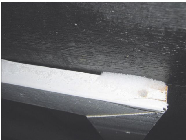
Abb. 2: Beispiel für ein hinterläufiges Fensterfutter. Die Verarbeitungsqualität ist ebenfalls mangelhaft.
