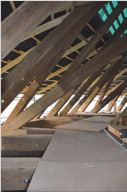
Abb. 19: Stehende Blattverbindung mit sechs Stabdübeln und statisch nicht wirksamen zwei Spaltbolzen (DREGER, 2017)
