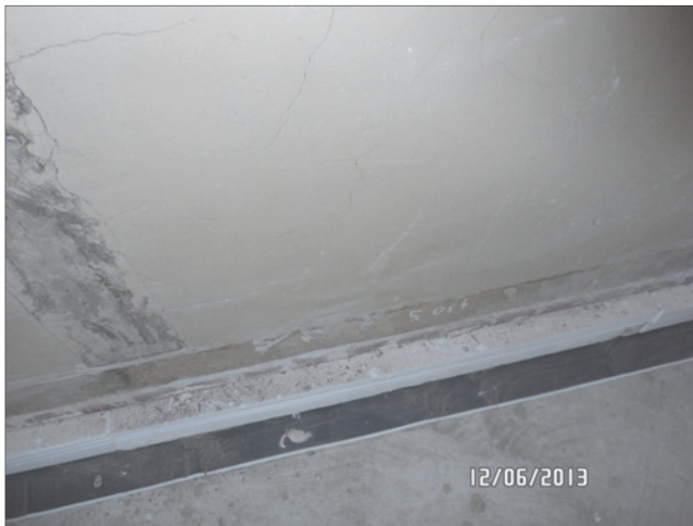
Abb. 11: Ausgleichsputz als Vorbereitung einer Innendämmung. Die noch sichtbaren Holzoberflächen werden später noch durch den vollflächig aufzutragenden Kopplungsmörtel der Calciumsilikat-Dämmplatten überdeckt.
