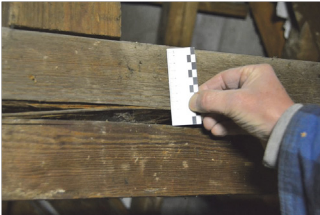
Abb. 7: Correnzplatz 1, Umweltbundesamt Berlin-Dahlem, auffälliges Schwindmaß als Indiz für hohe Einbau-feuchten (DREGER, 2018)
