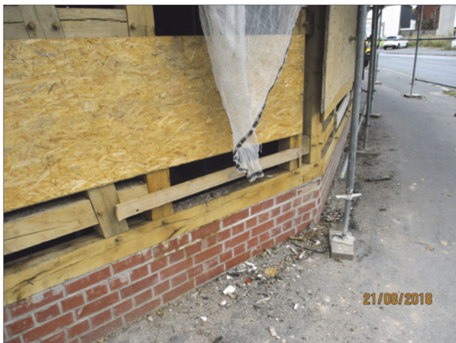
Abb. 9: Die öffentliche Verkehrsfläche ist in den letzten Jahrzehnten bis in Schwellenhöhe angehoben worden. Bei der anstehenden Sanierung des Fachwerks wurde die Holzkonstruktion unten eingekürzt und ein höherer Sockel ausgeführt. Darunter leidet jedoch die Proportion des Fachwerkbilds. Erkennbar sind auch dunkle Gerbstoffauswaschungen an den sonst hellen Fugen.
