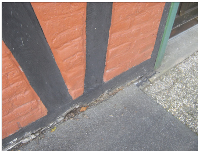
Abb. 4: Das Gelände ist im Laufe der Jahrhunderte höher angetragen worden, als die Schwellenunterkante. Solche Konstruktionen müssen versagen.
