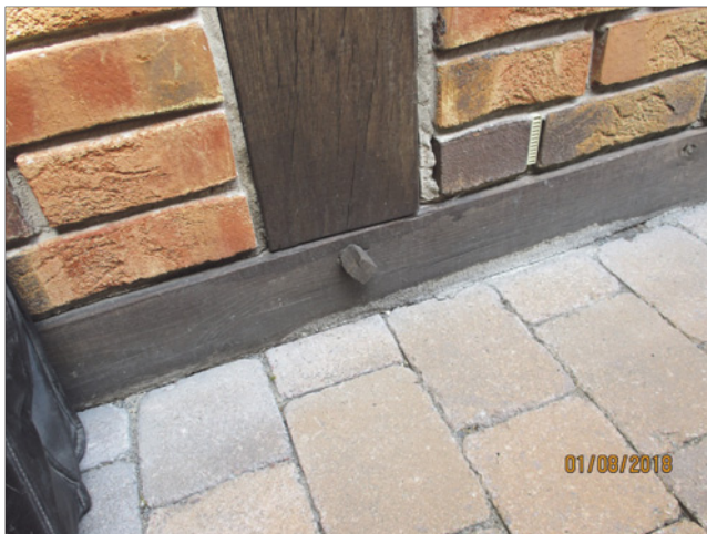
Abb. 5: Neubau in „Fachwerkstil“, das Holztragwerk ist Teil einer Vormauerschale mit Z-Folie auf der Schwelle. Außerdem gibt es keinen definierten Sockel. Diese Sonderkonstruktion kann nicht die gleiche Lebensdauer erreichen, wie eine „echte“ Vormauerschale.
