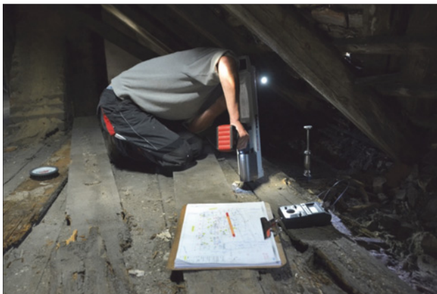
Abb. 23: Abgleich der Holzfeuchteverteilung mit den Schädigungen im Deckenbalkenquerschnitt in Görlitz am Obermarkt 1 (DREGER, 2017)
