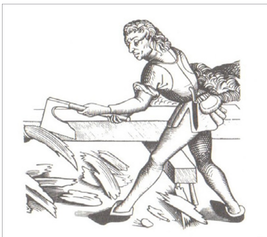
Abb. 3: Fasergerechte Bebeitung mit dem Breitbeil [FINSTERBUSCH/THIELE 1987, S. 84]
