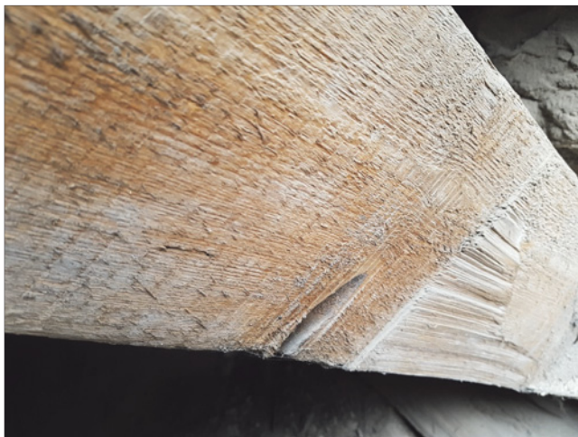
Abb. 4: Aufschieb- lingsbalken des Guts- hauses Zeesen (bei Königs Wusterhau- sen) mit erkennbarer typischer Neigung der Rahmensäge sowie dem Ausbruchskeil des Sägerichtungs- wechsels (DREGER, 2018)
