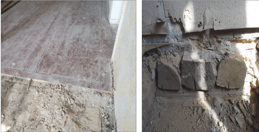
Abb. 1: Renaissance-Decke Görlitz, Obermarkt 23 mit deutlicher Trennung zwischen nicht maßhaltigen Deckenbalken (Mann-an-Mann-Decke) und maßhaltiger Friesdielung (DREGER, 2018)
