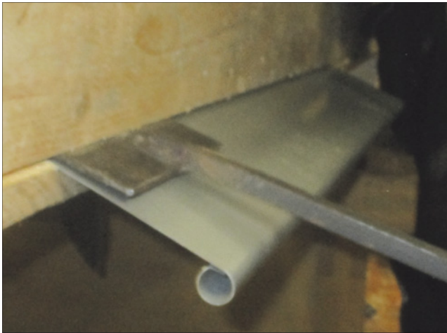
Abb. 6: Eintreiben eines gekanteten Blechs mit runder Abtropfwulst.
