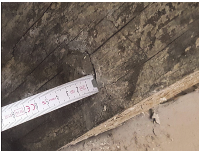
Abb. 2: Floßverbindung (Floßnagel) erkennbar an einem barocken Sparren (DREGER, 2016)
