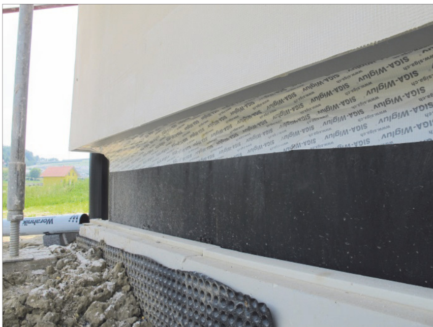
Abb. 2: Fugenverschluss Außenwand/ Kellerdecke (Bodenplatte) mittels Klebeband ( S_w \geq 150 mm) vor Montage der Sockeldämmung (Passtück)
