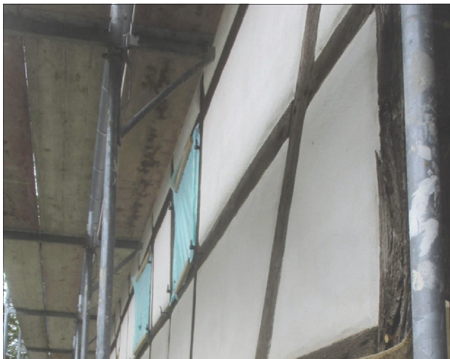
Abb. 8: Wiederherstellung eines Kissenputzes aus Luftkalkmörtel. Die Kanten wurden so an das Holz angeformt, dass der Wasserabfluss bei der grundsätzlich ungünstigen Ausführung wenigstens besser funktioniert als im Beispiel auf Abb. 3.
