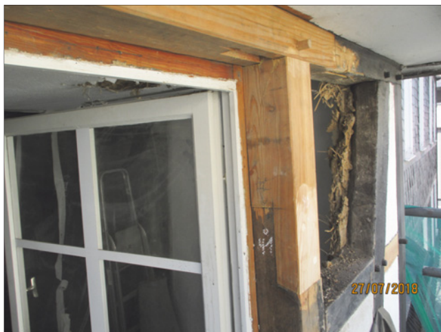
Abb. 1: Beispiel für Reparaturarbeiten nach einem Wassereinbruch an der Dachtraufe, der zu Folgeschäden an der Balkenlage, am Rähm und am Ständerende geführt hat.
