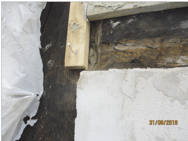
Abb. 3: Kissenputz an Abziehlatten angeformt. Hier entstehen an jeder Oberkante der Putzfelder waagerechte „Stauschwellen“ für ablaufendes Wasser.
