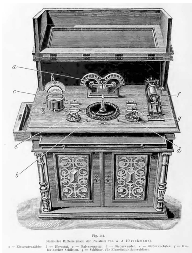
Abb. 13: Stationäre Batterie mit Legende zum Instrumentarium
