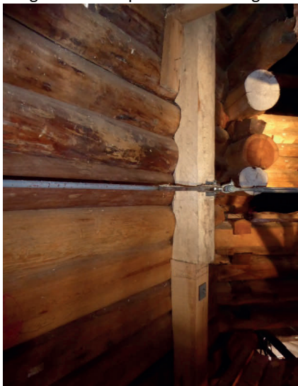
Bild 16 Die horizontale Verspannung im Bereich der obersten Blocklagen des unteren Achtecks ...
