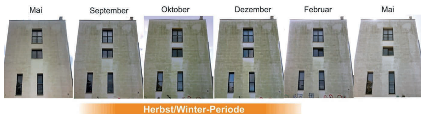
Bild 11 Auszug aus einer Langzeitstudie zu optischer Veränderung einer mikrobiell bewachsenen Fassade im Jahresverlauf. In der Herbst-/Winter-Periode zeigt sich eine hohe Wachstumsaktivität durch vergleichsweise intensive Grünfärbung
