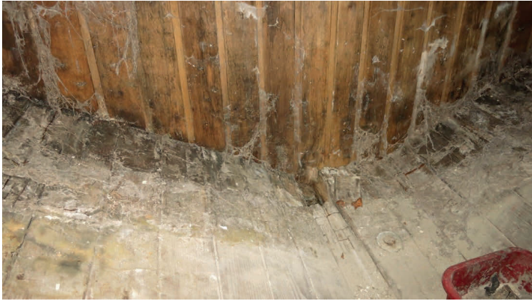
Bild 15 Befall Echter Hausschwamm am Schott zwischen Laderaum und Achterhütte, wo die Ziegel gelagert waren.
