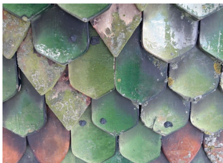
Bild 6 Nagelung durch Glasur mit schwarzer Abdichtungsmasse
