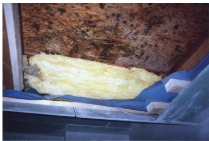
Bild 5 Der Belüftungsraum ist durch den expandierten Dämmstoff verschlossen. Schimmel ist deutlich
