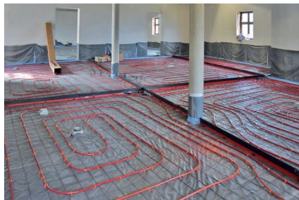
Bild 17 Heizleitung und Fugenprofile
