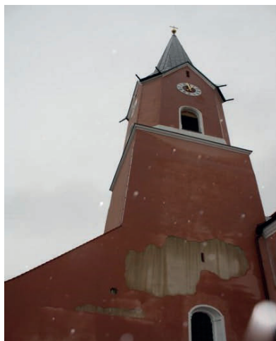
Bild 4 Oberhatzkofen, Kirche, bauwerksbedingte Rissbildung
