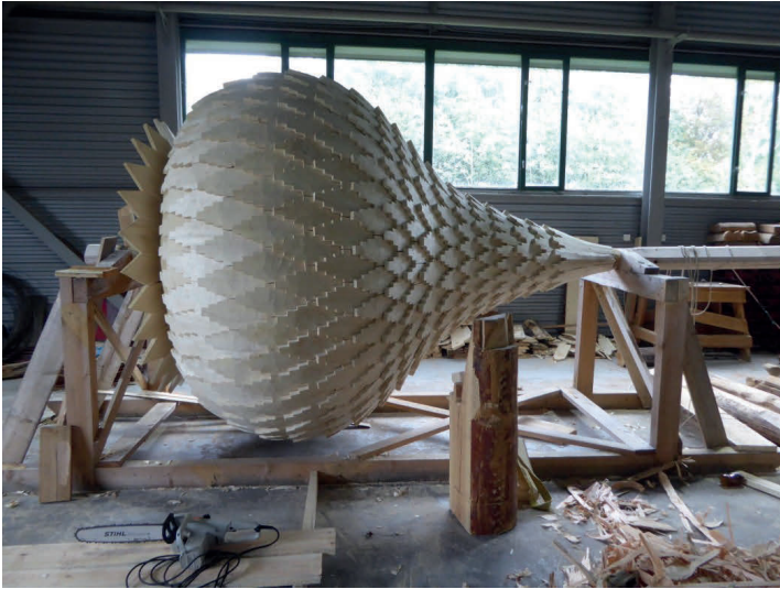
Bild 10 In der Werkstatt des Restaurierungszentrums fertiggestellte und bereits verschindelte Zwiebelkuppel.
