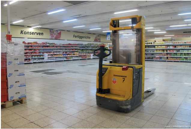
Bild 2 Betonwerkstein-Bestandsboden mit Fahrbeanspruchung
