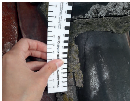
Bild 7 Rissbreite von 1,8mm am Mörtelfirst
