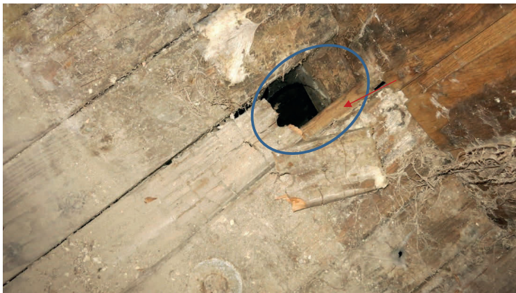
Bild 17 Lärche abgebaut, Eiche ohne Abbau
