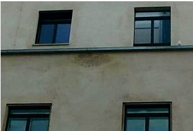
Bild 2 Berlin, Museumsinsel - Schäden durch Durchfeuchtung eines Luftkalkputzes
