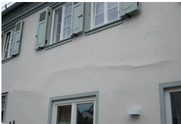
Bild 6 Bad Homburg - Ablösungen des Oberputzes vom Unterputz
