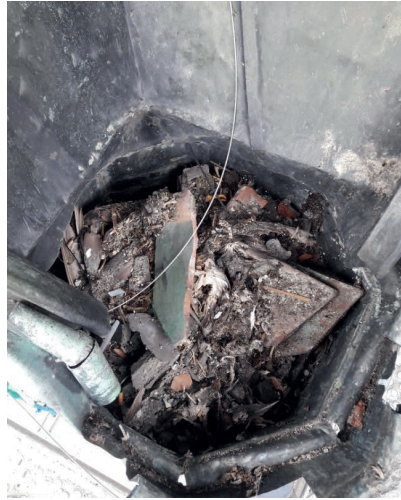
Bild 11 Verstopfter Abflusstrichter
