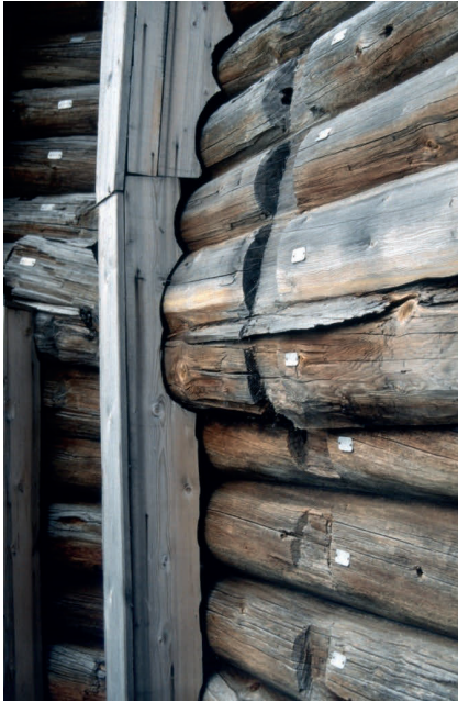
Bild 11 Notdürftig gehaltene Verformung einer nicht ausreichend steifen Wand
