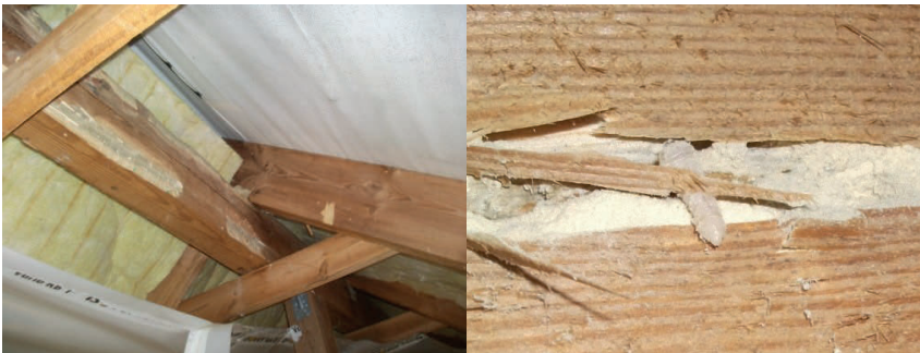
Bild 9 Hausbockbefall im belüfteten Dachraum
