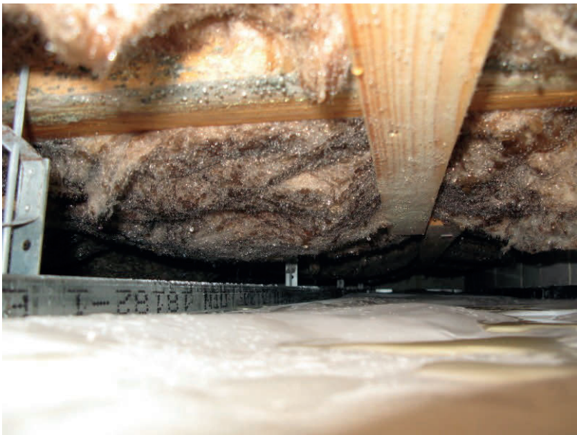
Bild 9 Schadhaftes Flach-dach mit durchnässter Dämmung und stehendem Wasser auf der Dampfbremse, Eigenes Gutachten. Schadensursache war ein Regenereignis am Wochenende, nachdem das Dach am Freitagabend mit Schalung, aber ohne Dachabdichtungsbahn verlassen worden war.
