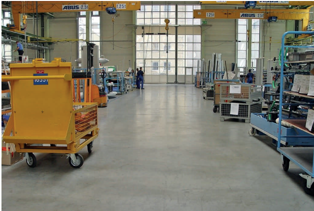
Bild 1 Betonboden mit einer Hartstoffschicht (Chemotechnik Abstatt GmbH)
