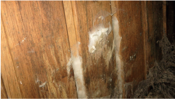
Bild 12 Befall Echter Hausschwamm Eichenholz Schott mit Myzel ohne Abbau
