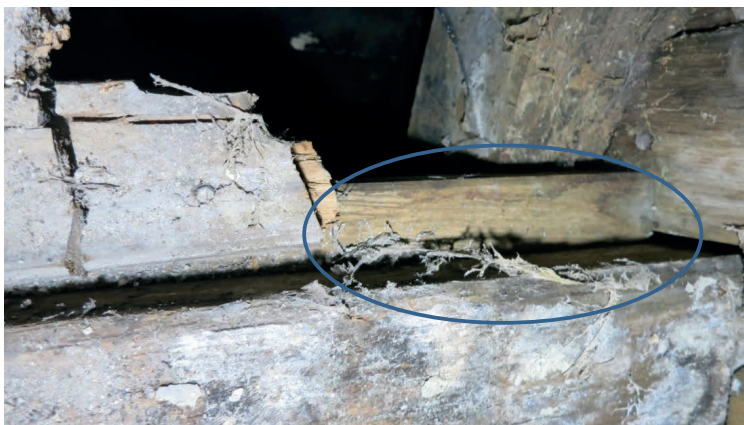
Bild 18 Lärche massiv abgebaut, darunterliegende Eiche ohne Abbau
