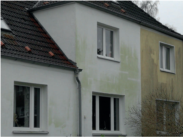
Bild 1 durch Grünalgen dominierte Fassadenbiofilme sind sehr häufig auf außenseitig gedämmten Bauwerken zu finden, dabei sind viele Farbspiele bis ins Rötliche möglich.
