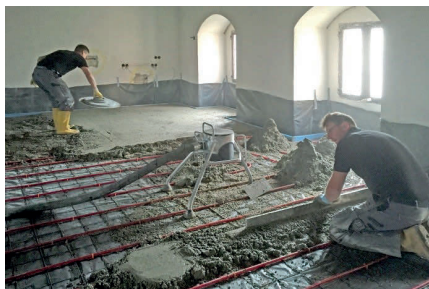
Bild 18 Verlegung Heizestrich
