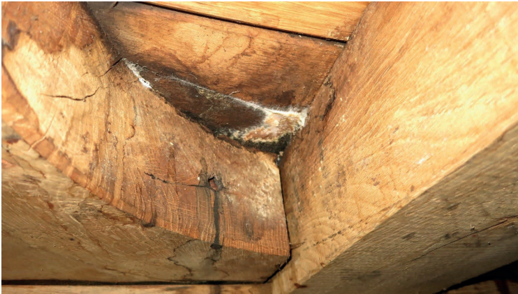
Bild 20 Fruchtkörper Kellerschwamm unter Deck an den Spanten aus Eiche
