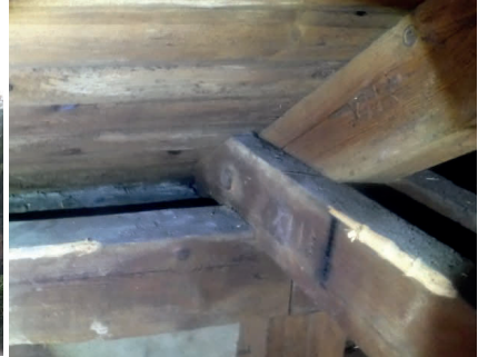
Bild 8 Der ungenutzte Dachstuhl weist keine Belüftungsöffnungen auf.
