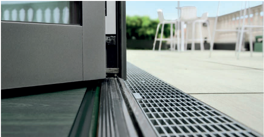
Bild 1 Schwellenloser Zugang zu einer Dachterrasse
