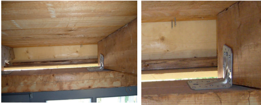
Bild 2 Die Traufbohle zwingt die Luft, um die Ecke zu strömen. Wird sie dem folgen? (Quelle D. Krause).
