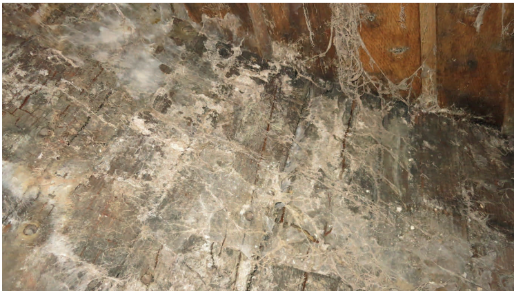
Bild 16 Befall Echter Hausschwamm am Schott zwischen Laderaum und Achterhütte, wo die Ziegel gelagert waren.
