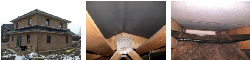
Bild 3 Für eine Belüftung wäre bei diesem Dach Platz. Traufen und First sind aber geschlossen (links sind die weiß gestrichenen Schalungsbretter sichtbar), der Schimmel gedeiht. Die Belüftung des Vordaches dieses Hauses im römischen Stil stellt dagegen ein Problem dar.
