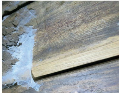
Bild 11 Eichenholz ohne Abbau mit Befallsgrenze
