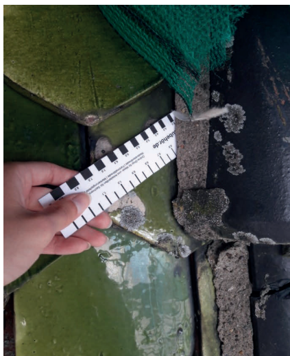
Bild 9 Deutlicher Abstand zwischen Dachziegel und Mörtel
