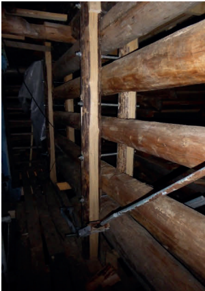
Bild 14 Details der ausgeführten Verstärkung mittels Hängewerk ...
