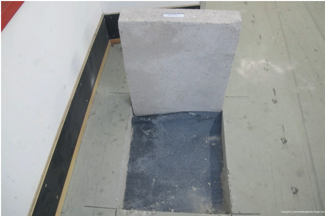
Bild 5 Entnahme Ausbauplatte aus Estrich
