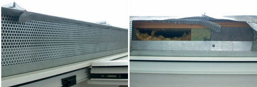
Bild 4 Ein Lüftungsgitter an der Traufe und der Blick dahinter, wieviel Luft strömt da wohl noch durch?
