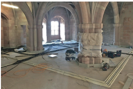
Bild 15 Leitungen auf dem Rohboden
