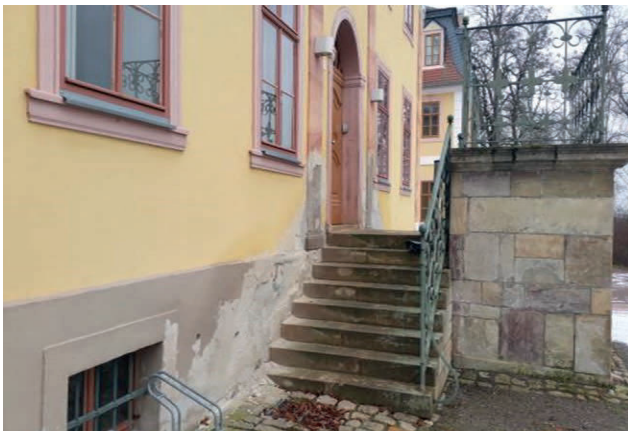
Bild 9 Weimar, Belvedere Kavaliershäuser - starke Schäden durch Streusalz und fehlende Putzabdichtung
