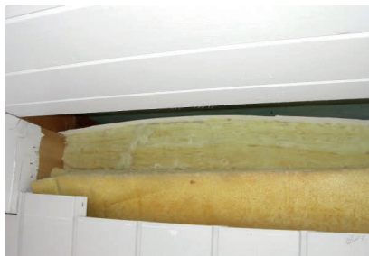
Bild 6 Unter dem expandierten Dämmstoff ist die Hinterlüftung der Fassade sichtbar
