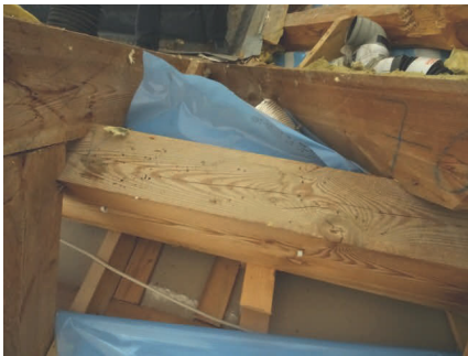
Bild 12 Die Dampfsperre liegt undefiniert im Dachraum. Kabel und Deckenstrahler sind in die raumseitige Gipskartonplatte durchgeführt: Undichtigkeiten ohne Ende. Und trotzdem keine Schäden.
