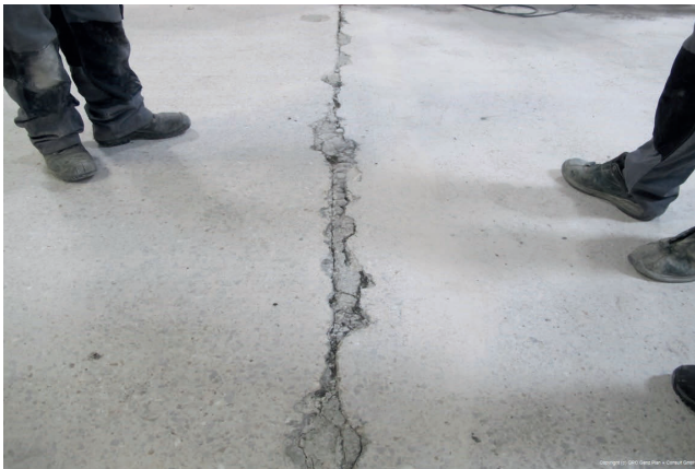
Bild 9 Betonboden mit Fuge vor Revitalisierung
