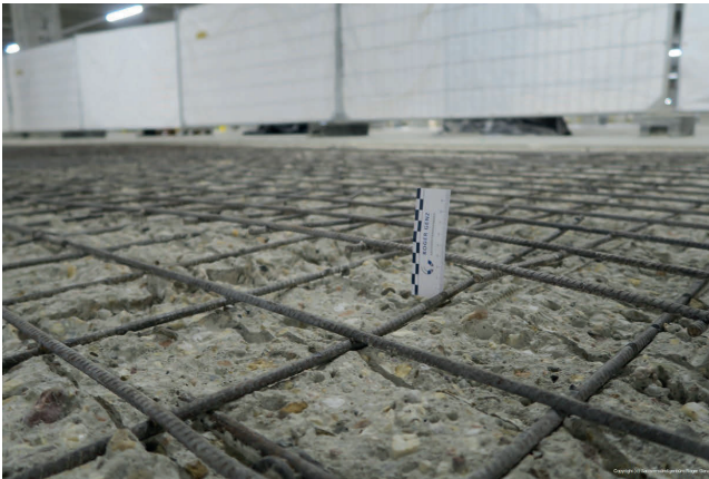
Bild 7 Oberfläche Geschossdecke nach Abtrag Betonrandzone bis 6 cm mittels Hochdruckwasserstrahlen und Feststoffstrahlen der Bewehrung
