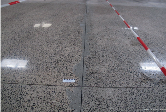
Bild 10 Betonboden mit Fuge nach Revitalisierung
