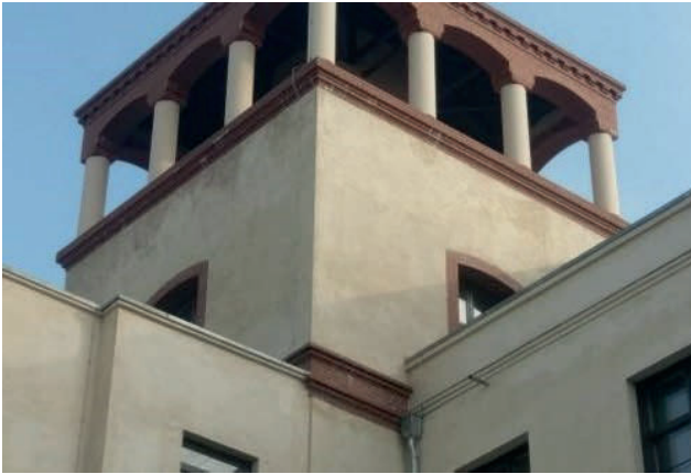
Bild 1 Berlin, Museumsinsel - Putzaufbau mit einem Luftkalkputz in stark feuchtebelasteten Bereiche
