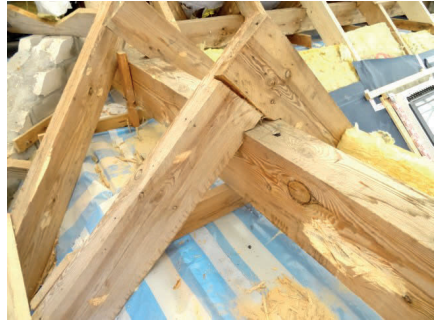
Bild 11 Firstpfette. Hausbockbefall, aber der interessiert hier jetzt nicht
