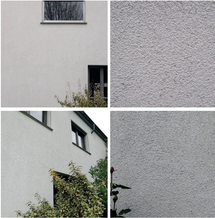
Bild 4 Ein Referenzobjekt, das im Jahr 2006 mit hydrohilen biozidfreen Fassadenbeschichtungen versehen wurden, die Testflächen in den Jahren 2008 (oben) und 2018 (unten) mit zufriedenstellendem Gesamteindruck, die hier ermittelten Zellzahlen blieben weitgehend konstant und lagen jeweils unter 10.000 Zellen pro \text{cm}^2 (ein sichtbarer vollflächiger Befall ist ab ca. 750.000 Zellen pro \text{cm}^2 mit bloßem Auge erkennbar)
