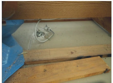
Bild 12 Die Dampfsperre liegt undefiniert im Dachraum. Kabel und Deckenstrahler sind in die raumseitige Gipskartonplatte durchgeführt: Undichtigkeiten ohne Ende. Und trotzdem keine Schäden.
