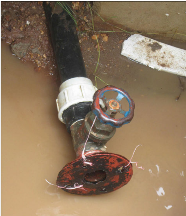
Abb. 2a u. 2b: Erster Reparaturversuch.
