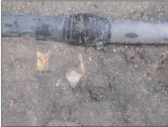
Abb. 1: Selbst repariertes Wasserrohr.
