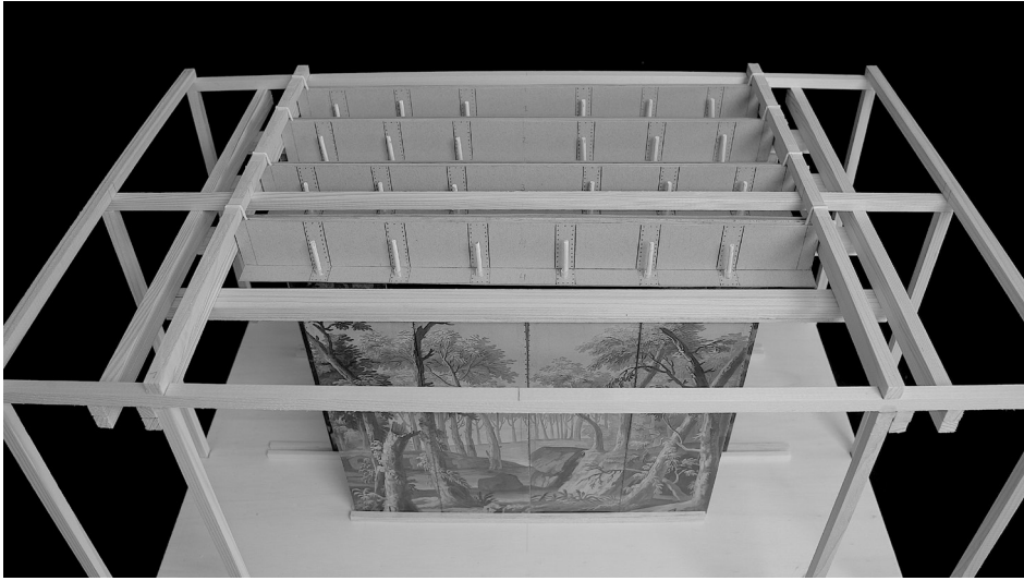
Fig. 37. Restitution hypothétique de la structure du théâtre « portable » d'Hauteville, détail du système d'éclairage par les herse (© maquette M.-H. Jordan, photo Florian Burion)
