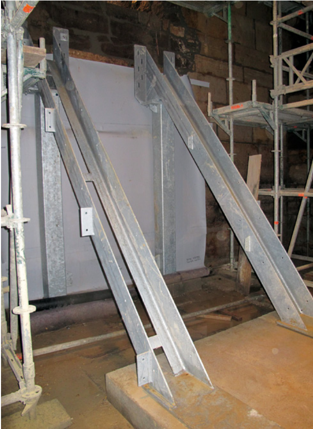
Abb. 22 Unterkonstruktion der Treppe
