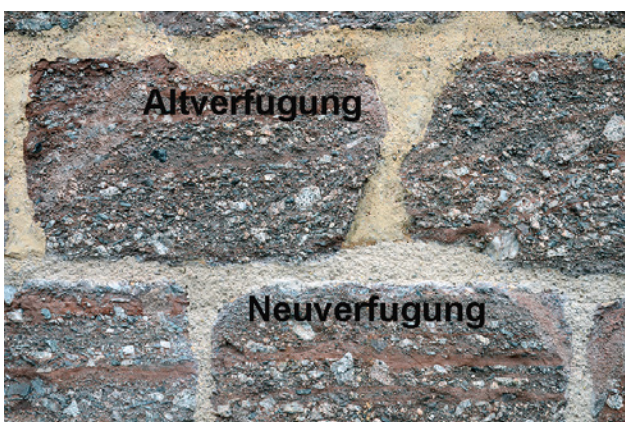
Abb. 26 Altverfugung mit Romanzementmörtel und pigmentierte Neuverfugung WART-MAX2
