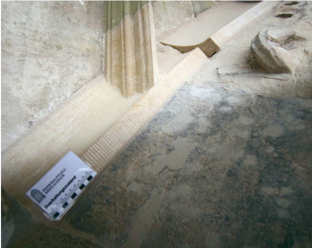
Abb. 27 Landshut St. Martin, Hauptportal, Neuteil Lisenenanläufer
