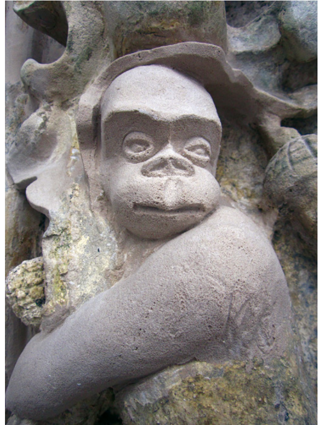
Abb. 19 Landshut St. Martin, Hauptportal, Detail Formergänzung „Äffchen“
