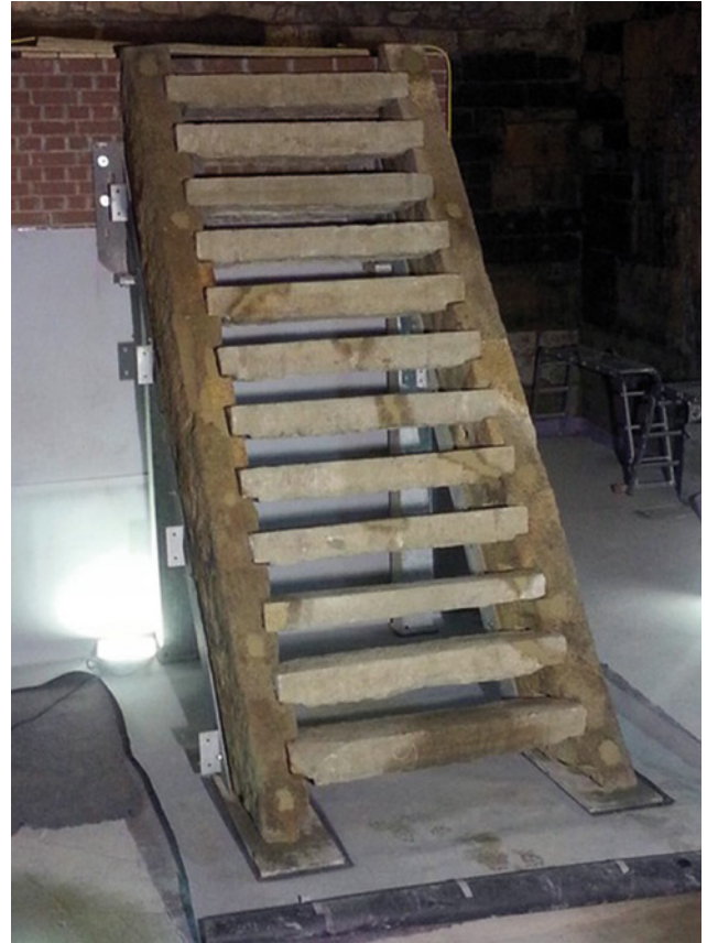
Abb. 23 Fertig eingebaute Treppe, ohne Geländer
