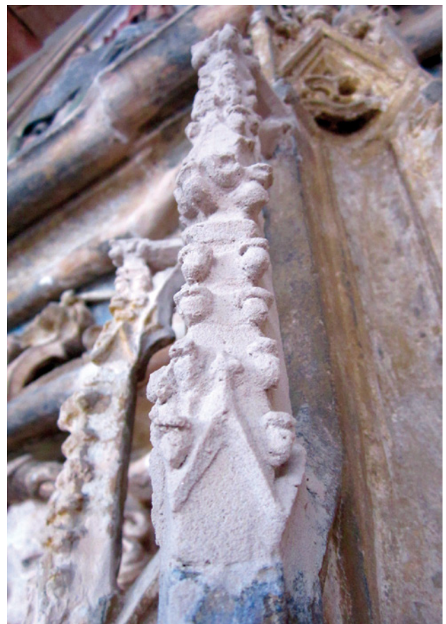
Abb. 21 Landshut St. Martin, Hauptportal, Detail Formergänzung Fiale am Baldachin
