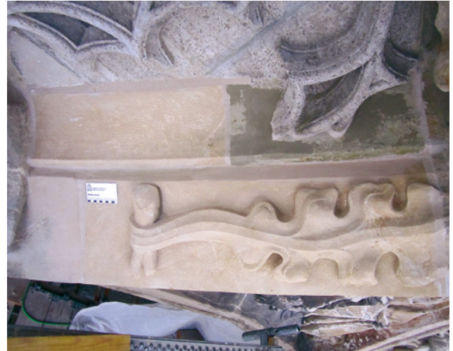
Abb. 28 Landshut St. Martin, Hauptportal, Neuteil Blattstiel
