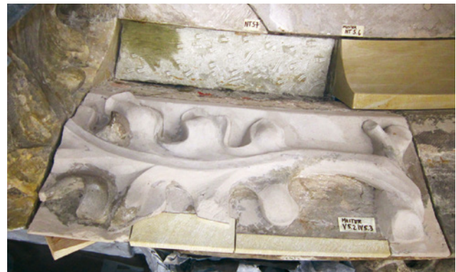
Abb. 24 Landshut St. Martin, Hauptportal, Vierungen Mittenwalder Sandstein
