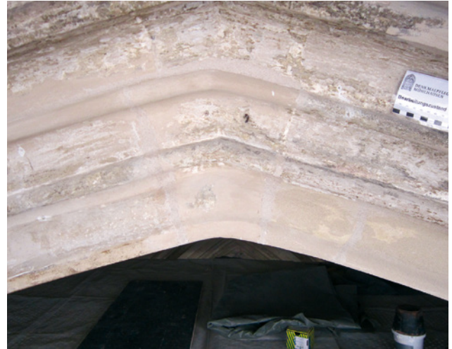
Abb. 32 Landshut St. Martin, Hauptportal, Endzustand Neuverfugung
