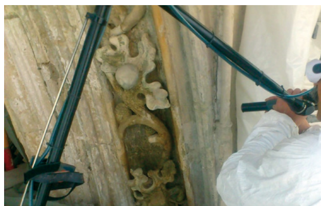
Abb. 9 Landshut St. Martin, Hauptportal, Ausführung der Laserreinigung
