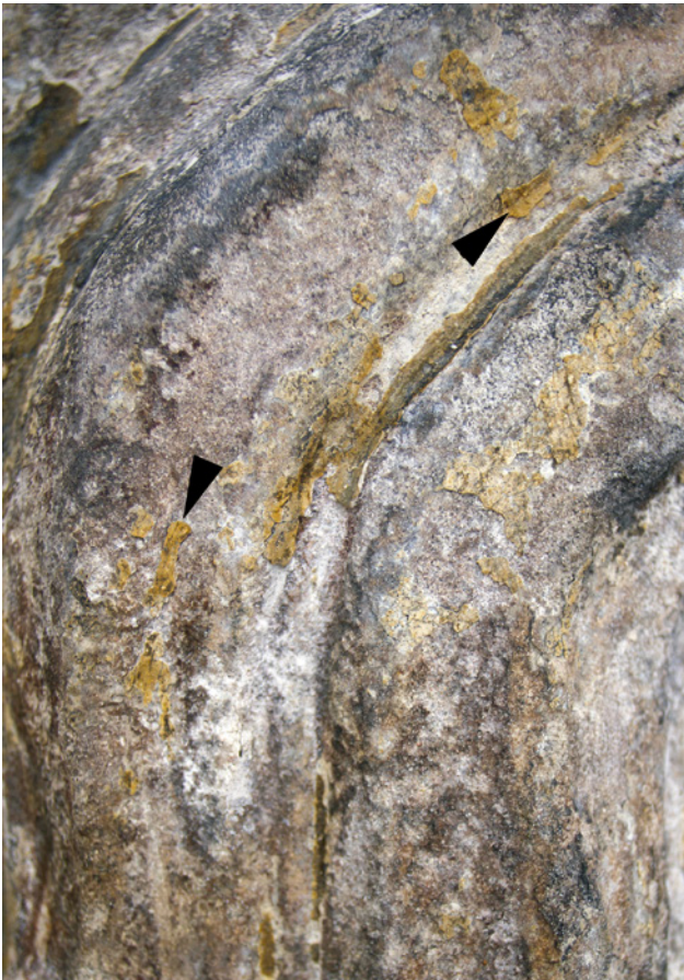
Abb. 46 Landshut St. Martin, Hauptportal, Malschichtschollen
