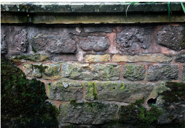
Abb. 16 Probeachse nach 10 Jahren Standzeit mit Baustellenmischung HK0-5
