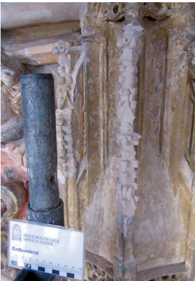
Abb. 20 Landshut St. Martin, Hauptportal, Formergänzung Fiale am Baldachin
