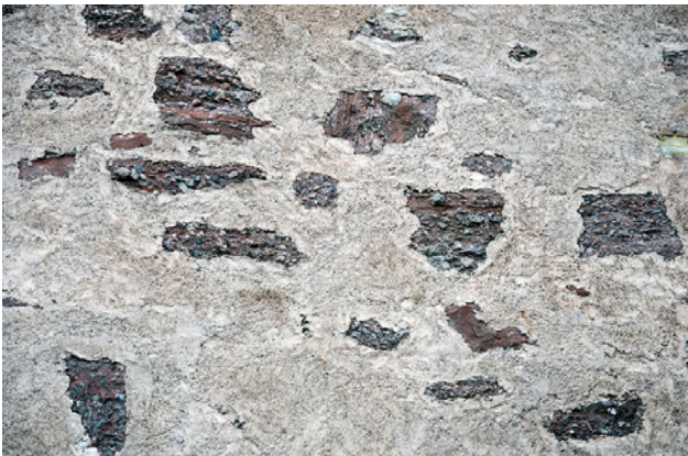
Abb. 24 Westliche Wehrmauer – putzartige Verfugung, anschließend gestrahlt
