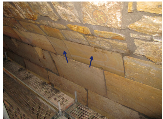
Abb. 18 Neue Werksteinquader aus Seeberger Sandstein im Kämpferbereich. Oberhalb der Quader sind die Bohrkernverschlüsse der Vernadelung zu erkennen.
