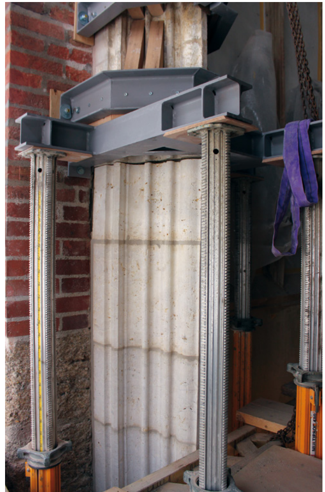
Abb. 30 Landshut St. Martin, Hauptportal, Abstützkonstruktion am Kielbogen
