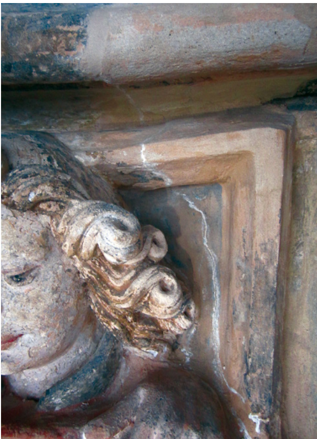
Abb. 13 Landshut St. Martin, Hauptportal, Rissinjektion Eselsrücken
