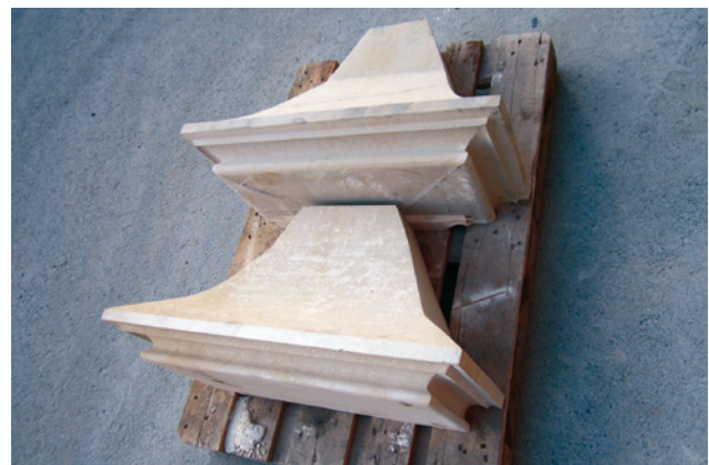
Abb. 26 Landshut St. Martin, Hauptportal, Vorarbeiten der Neuteile in der Werkstatt
