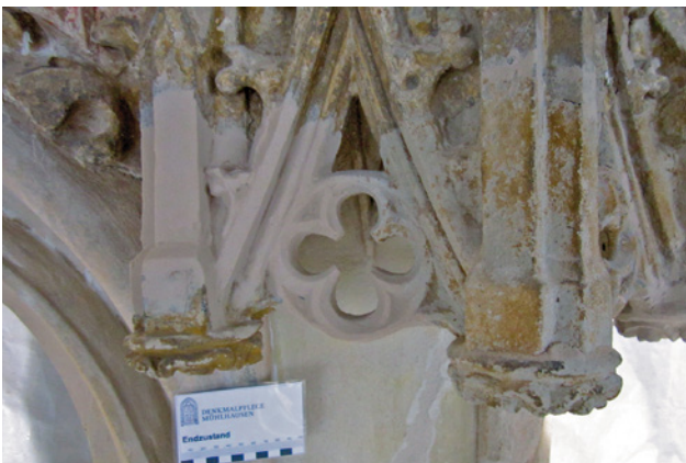
Abb. 5 Landshut St. Martin, Hauptportal, Kleben, Armieren und Ergänzen Endzustand
