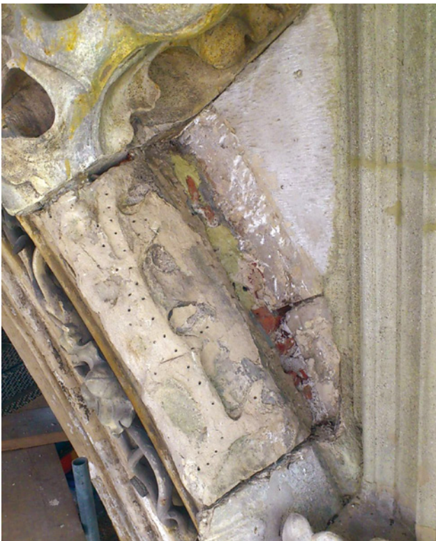
Abb. 7 Landshut St. Martin, Hauptportal, Abnahme Altergänzung Blattstiel
