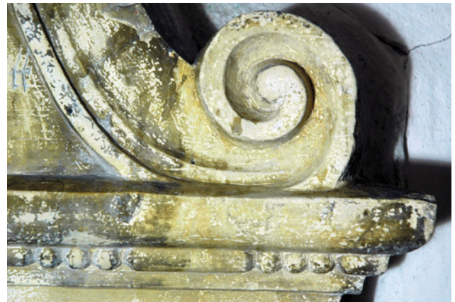
Abb. 4 Aufsatz, Detail mit Reinigungsmuster
