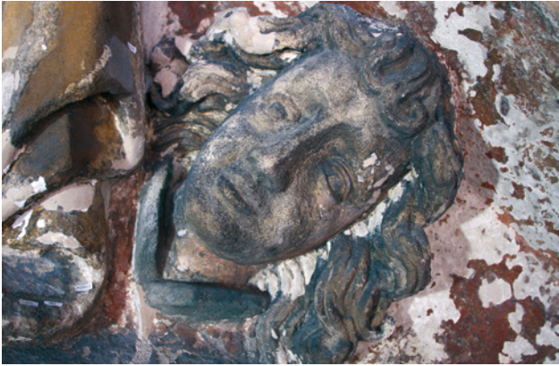
Abb. 42 Landshut St. Martin, Hauptportal, Vorzustand Engel Gipskruste
