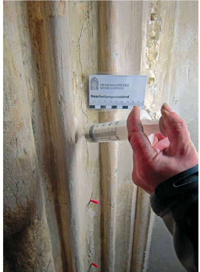
Abb. 12 Landshut St. Martin, Hauptportal, Rissinjektion Mittenwalder Sandstein
