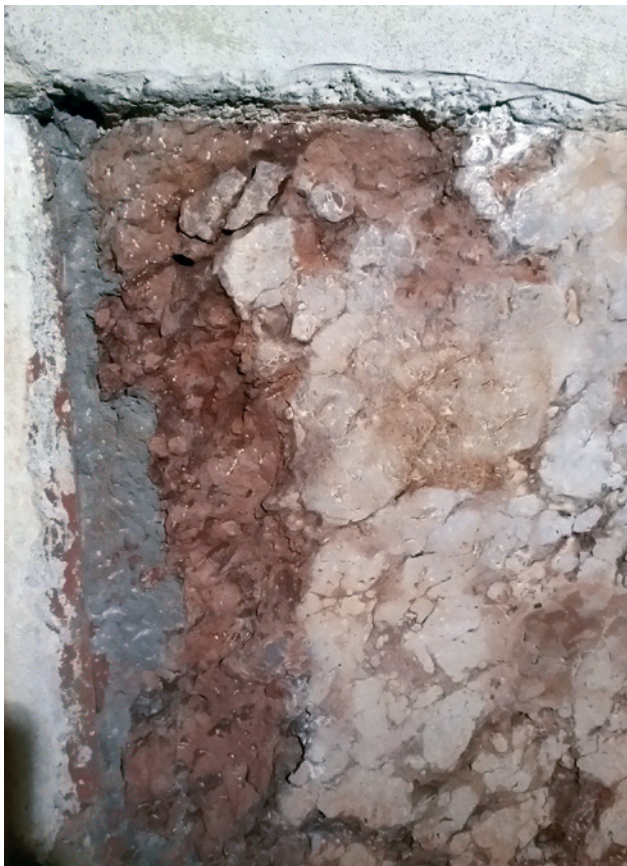
Abb. 36 Landshut St. Martin, Hauptportal, Entfernen Altergänzungen „Adneter Rotmarmor“
