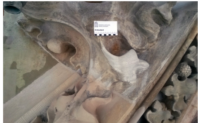
Abb. 23 Landshut St. Martin, Hauptportal, Formergänzungen quarzitischer Sandstein
