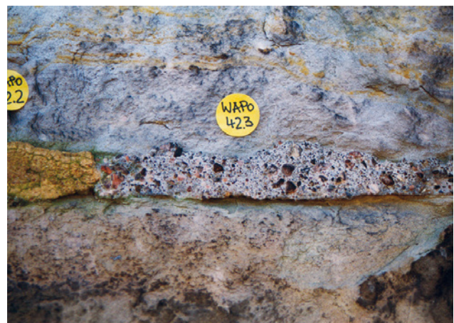
Abb. 3 Der Mörtel WAP042.3 befindet sich direkt neben dem braunen Mörtel und enthält sehr grobe Gesteinskörnungen.
