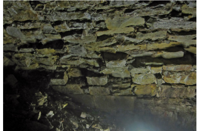
Abb. 8 Ausbrüche im Gewölbemauerwerk
