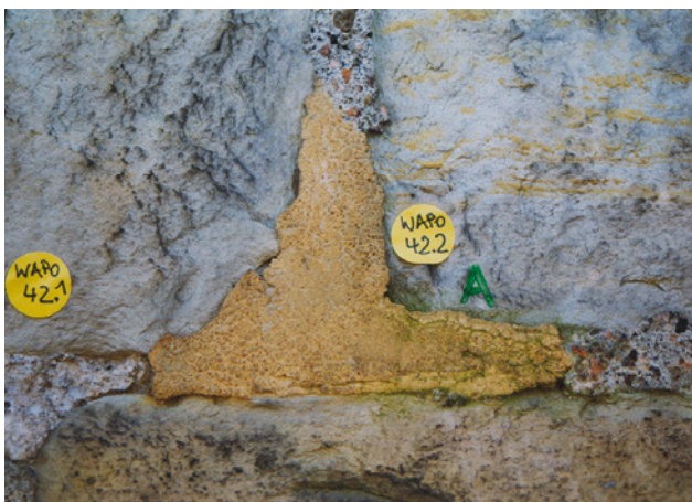
Abb. 2 Der Mörtel WAP042.1 ist ein Gipsmörtel und der braune Mörtel enthält Romanzement als Bindemittel.
