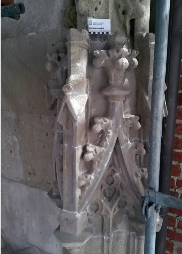
Abb. 11 Landshut St. Martin, Hauptportal, Rissinjektion Kunststein
