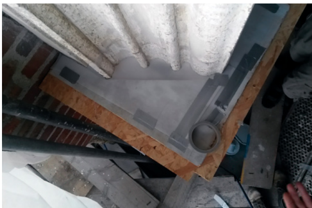
Abb. 25 Landshut St. Martin, Hauptportal, Schablonenherstellung
