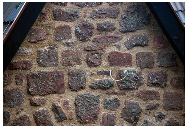
Abb. 17 Testfläche im Komplex des Wartburghotels auf der Basis „WART-MAX1“
