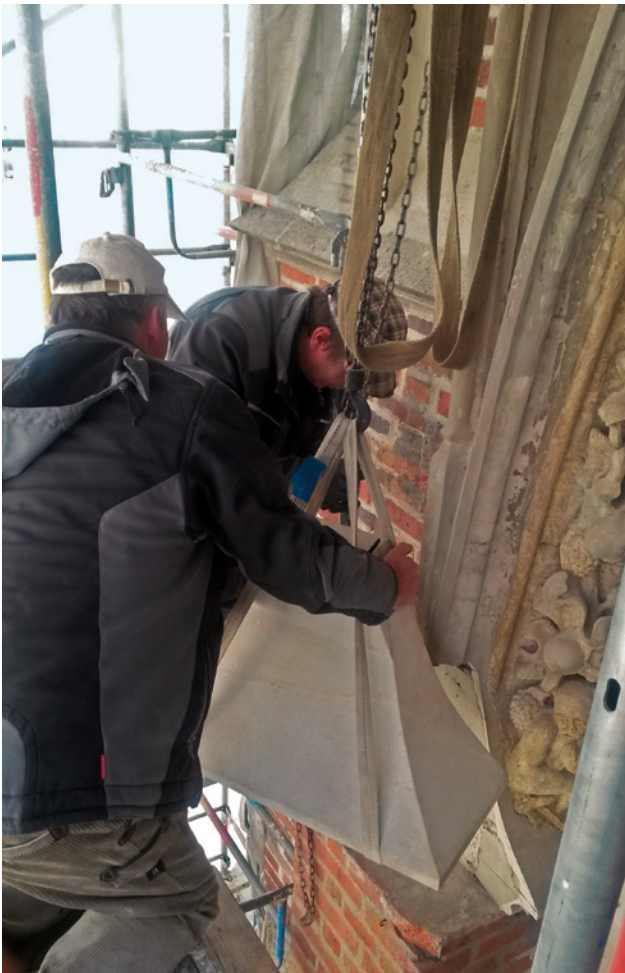
Abb. 29 Landshut St. Martin, Hauptportal, Versetzen der Neuteile
