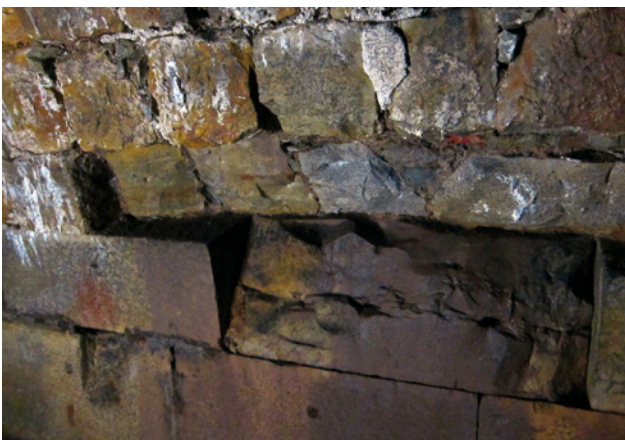
Abb. 9 Ausbruch an einem Werkstein des Kämpfers
