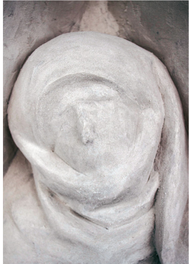
Abb. 45 Landshut St. Martin, Hauptportal, Kompressenaufgabe
