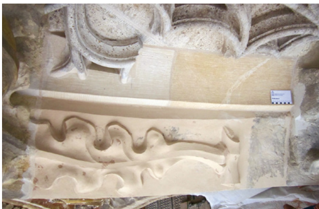
Abb. 15 Landshut St. Martin, Hauptportal, Formfindung und Formergänzung Blattstiel
