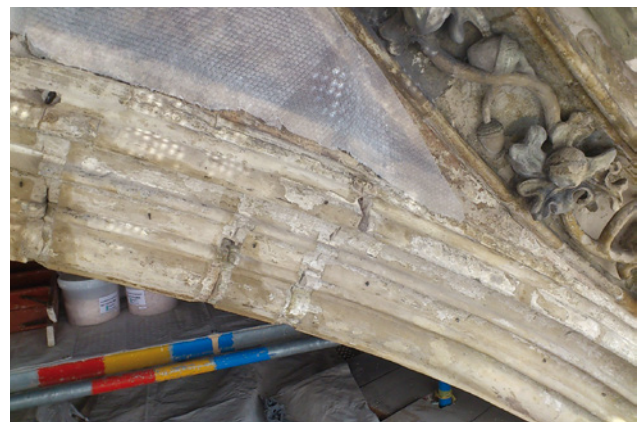
Abb. 6 Landshut St. Martin, Hauptportal, Abnahme nicht bauzeitlicher Mörtel
