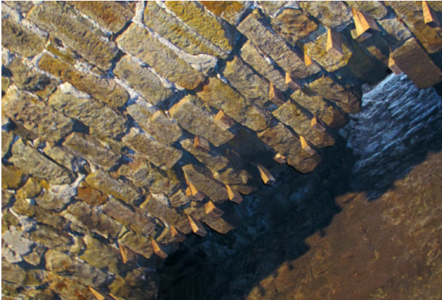
Abb. 7 Sehr stark geschädigte Verfugung, die zu einer Lockerung von Steinen geführt hat. Die Steine wurden während der Beräumung der Zisterne verkeilt.
