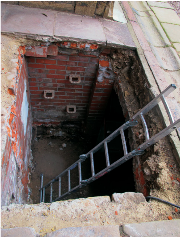
Abb. 13 Vergrößerter Zugangsschacht
