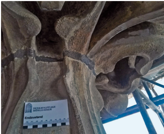
Abb. 35 Landshut St. Martin, Hauptportal, Bleiverfugung an der Kreuzblume
