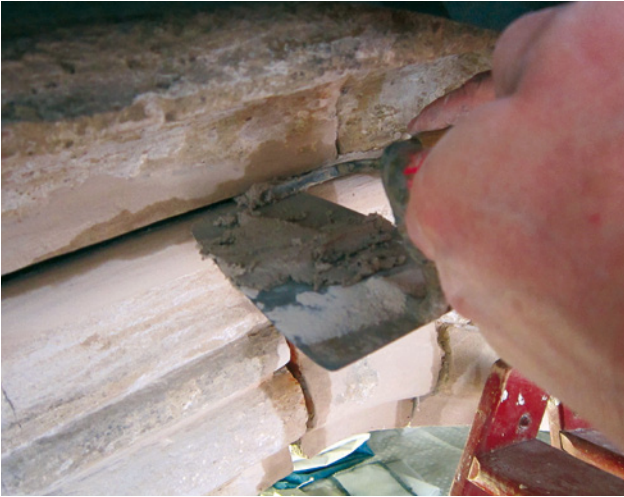
Abb. 31 Landshut St. Martin, Hauptportal, Verfugen
