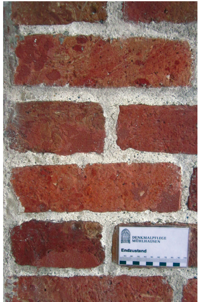
Abb. 34 Landshut St. Martin, Hauptportal, Verfugen Ziegel-MW
