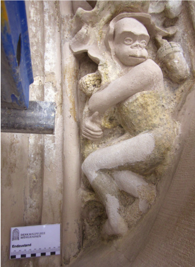
Abb. 18 Landshut St. Martin, Hauptportal, Endzustand Formergänzung „Äffchen“
