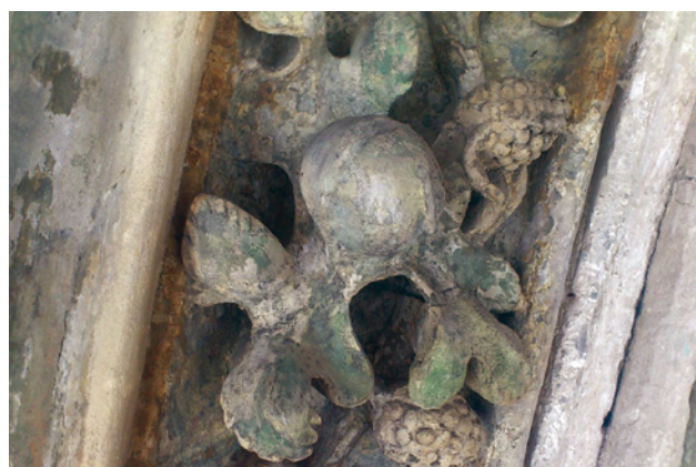
Abb. 10 Landshut St. Martin, Hauptportal, Ergebnis der Laserreinigung
