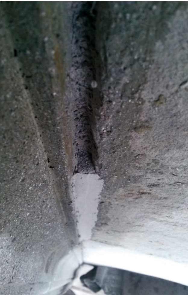
Abb. 33 Landshut St. Martin, Hauptportal, Tiefenverfugung mit Haarkalkmörtel
