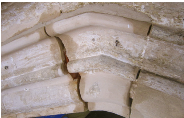
Abb. 16 Landshut St. Martin, Hauptportal, profilierte Formergänzungen Mittenwalder Sandstein
