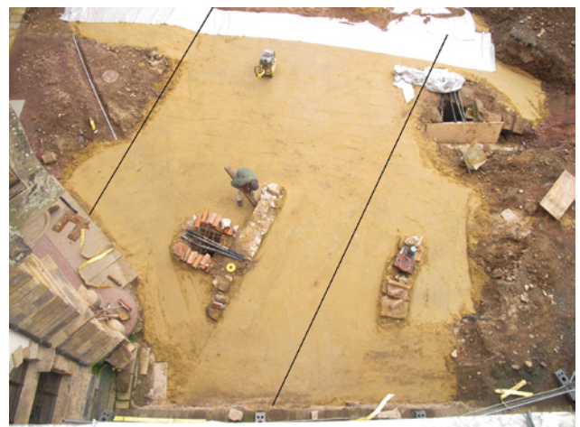
Abb. 15 Eingebaute und verdichtete Tonabdichtung
