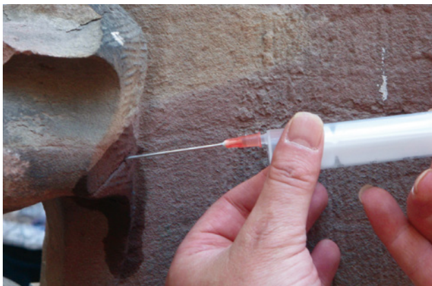
Abb. 6 Links: Vorbefeuchtung zwecks anschließender Rissverfüllung mit Injektionsnadel, rechts: Entsalzung eines gotischen Frieses mittels Kompressen
