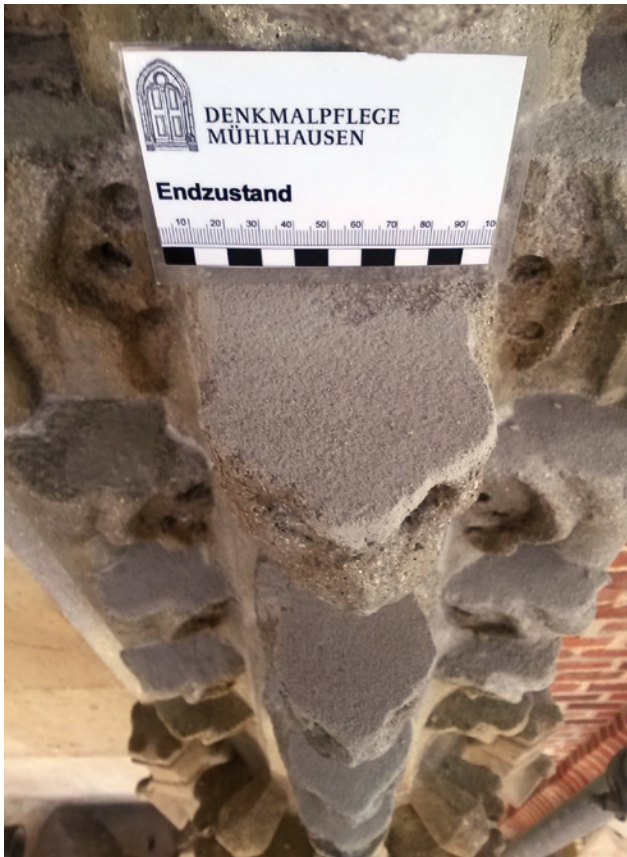
Abb. 22 Landshut St. Martin, Hauptportal, Formergänzungen Kunststein
