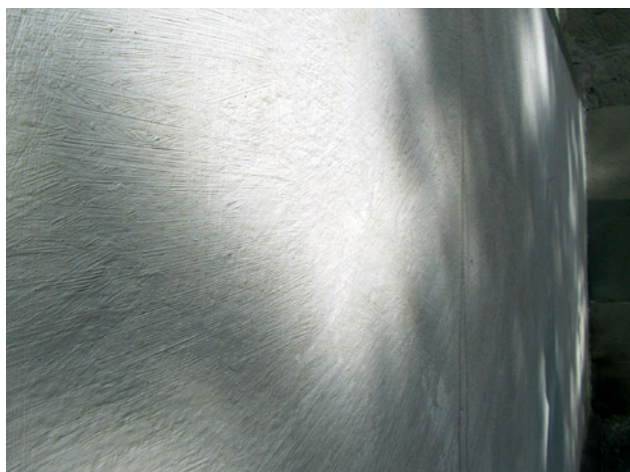
Abb. 5 Marmor-Gips-Mehl – auch eine reversible Farbe, kann abgebürstet werden
