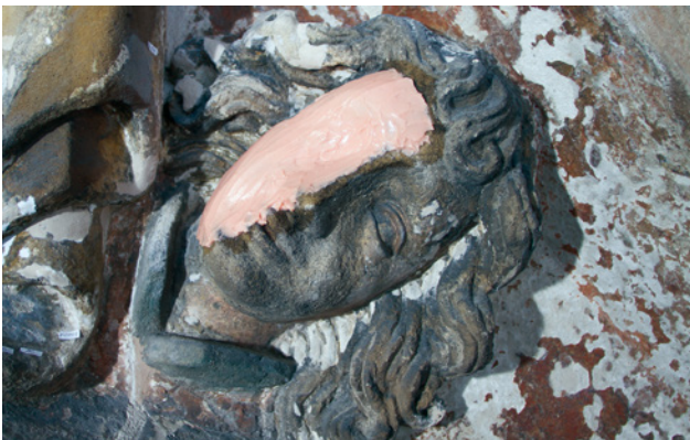
Abb. 43 Landshut St. Martin, Hauptportal, Bearbeitungszustand Engel Ionenaustauscher
