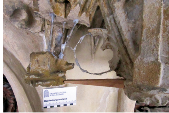
Abb. 4 Landshut St. Martin, Hauptportal, Kleben und Armieren Bearbeitungsstand
