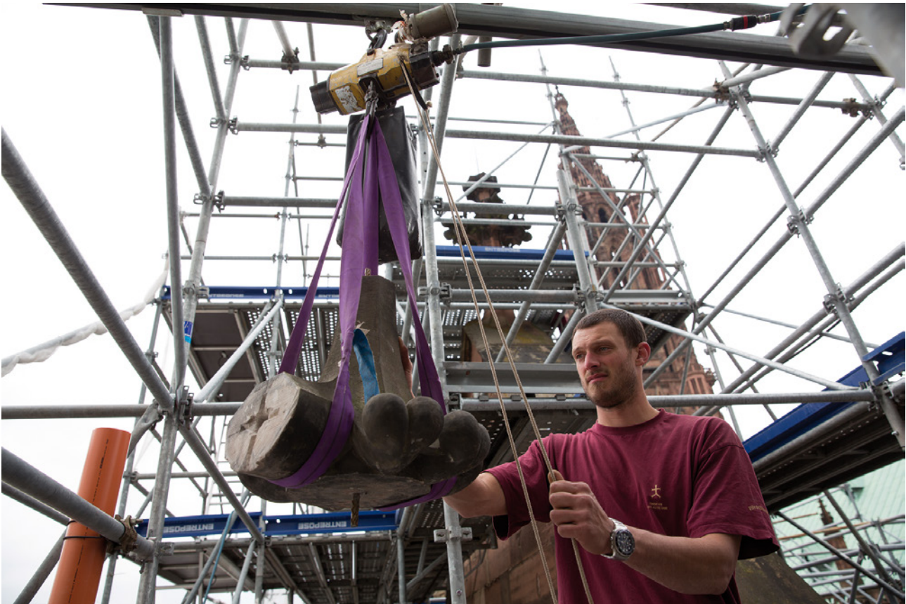
Abb. 8 Transport eines Steinelements auf der Baustelle des südlichen Querhauses, 2014
