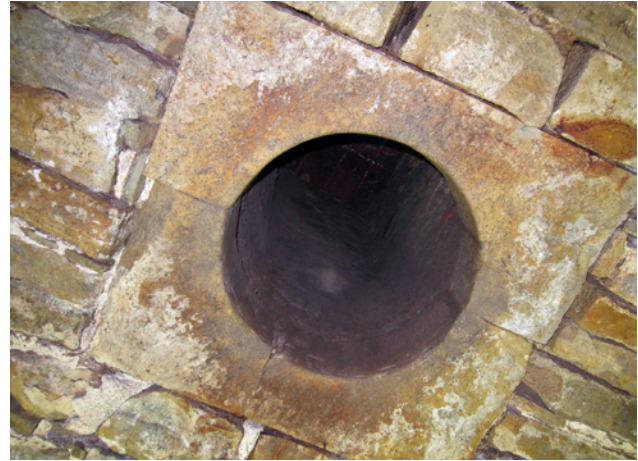
Abb. 4 Schöpfschacht im Scheitel des Gewölbes (Blick von unten)
