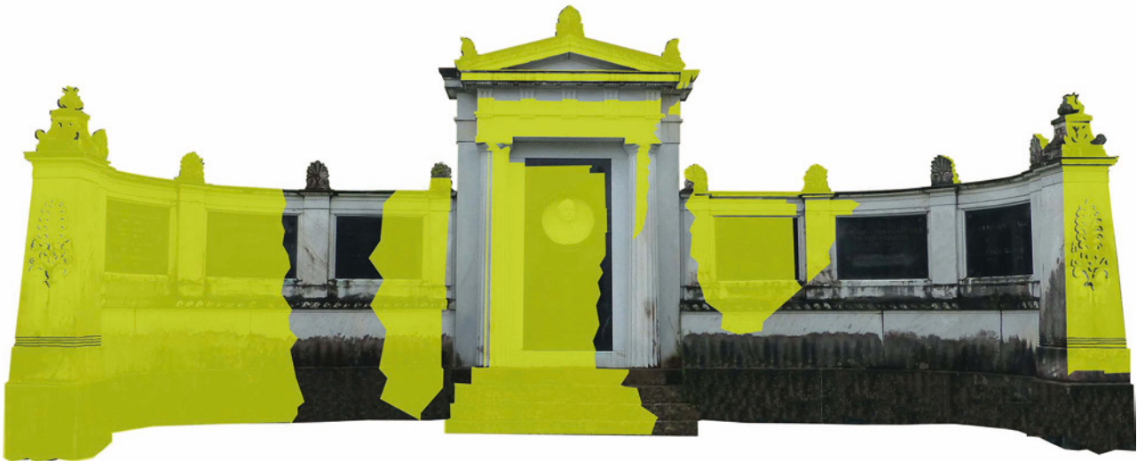
Abb. 13 Vorderseite des Grabmales mit Insolation um 18.00 Uhr (19.5.14). Gelb eingefärbt sind die von der Sonne bestrahlten Bereiche.
