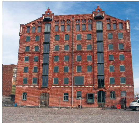
Bild 5 Thormann-Speicher Wismar nach der Sanierung zum Technologiezentrum (Mecklenburg-Vorpommern). Das Mauerwerk des Speichers wurde mit Injektionsmitteln behandelt, um eine nachträgliche Horizontalabdichtung herzustellen. In einem Zeitraum von 42 Monaten ist das Mauerwerk oberhalb der neuen Abdichtung so weit abgetrocknet, dass sich ein großer Feuchtegradient zwischen den Bereichen unter- und oberhalb der Abdichtung einstellt [Koss, Lesnych, 2013].
