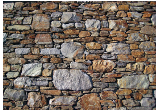
Bild 1 Findlingsmauerwerk
