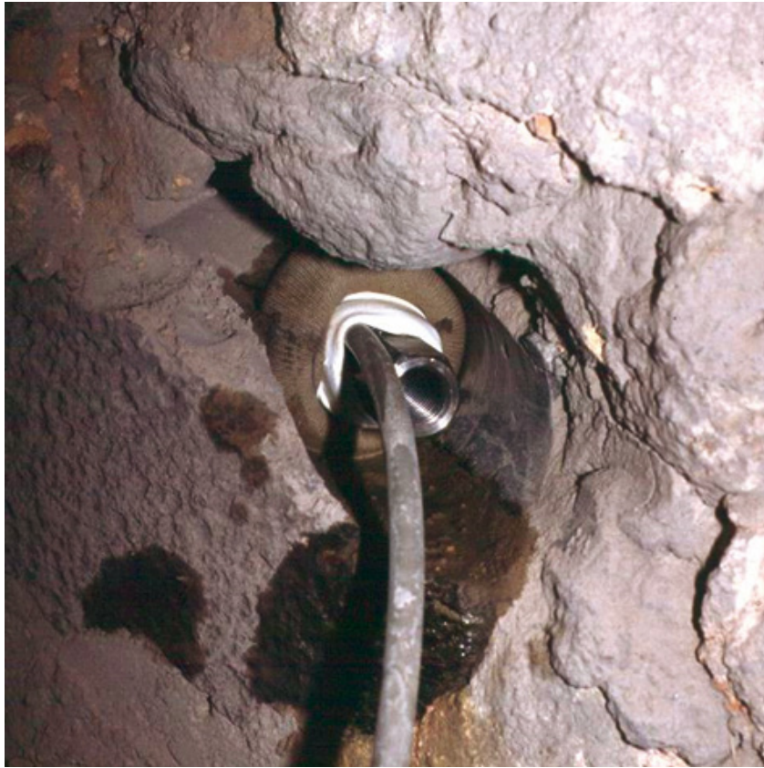
Bild 7 Beim Verpressen der Anker ist dafür zu sorgen, dass das Verpressen von der Tiefe aus erfolgt und dass die durch das Verpressen verdrängte Luft entweichen kann. Dies wird über die Verwendung von Verpress- und Entlüftungsschläuchen erreicht.
