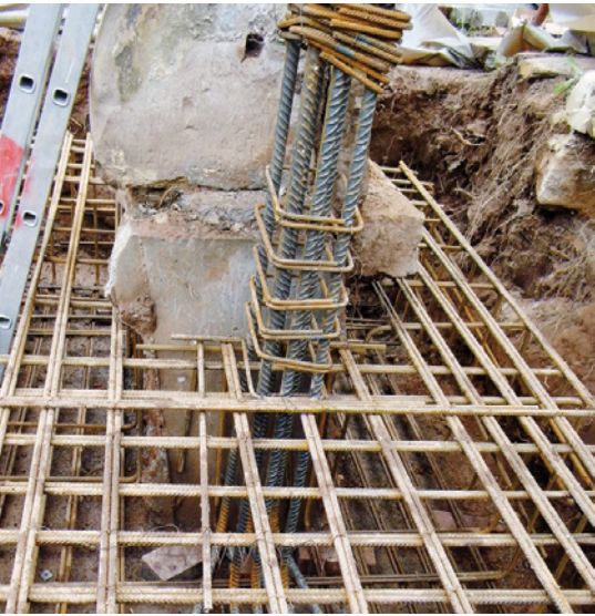
Bild 9 Einbau der Stahlbetonstützen in den Fundamentkörper
