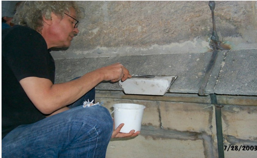
Bild 7 Bemusterung einer Steinsilikatklebung an der Oberhofenkirche Göppingen
