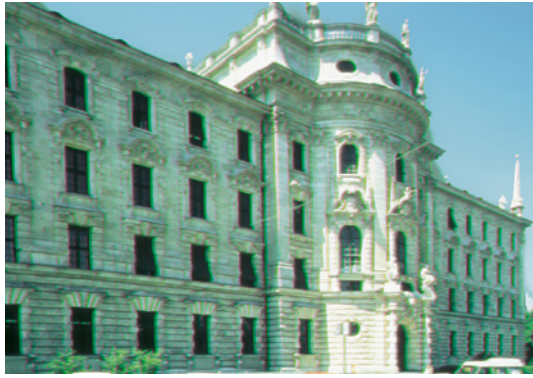
Bild 4 Der frisch gereinigte und hydrophobierte Justizpalast in München im Jahre 1987 (links) und mit deutlicher Wiederverschmutzung im Jahre 1995 (rechts) [Foto Wendler]
