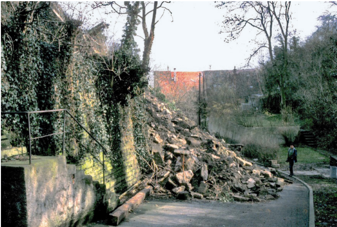
Bild 1 Teileinsturz einer Natursteinmauer durch Verlust der Tragfähigkeit
