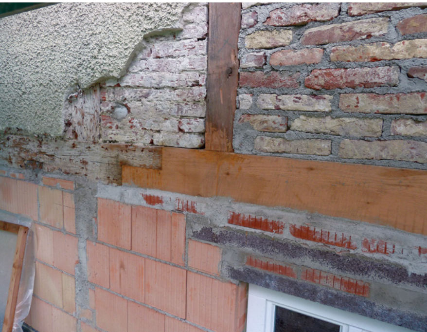
Bild 1 Sehr heterogener Untergrund aus alten und neuen Baustoffen, der den Einsatz von Putzträgern erfordert
