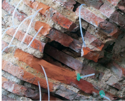
Bild 18 Ostseite des Bogens mit großflächigen Ziegelergänzungen in einer Stärke von ca. 4 cm (Pfeil)
