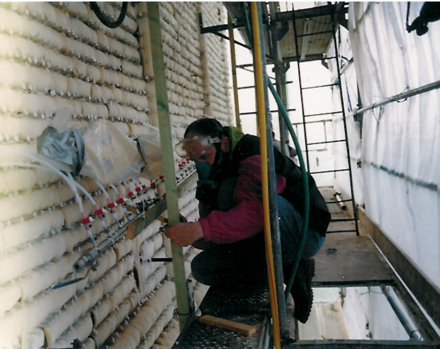
Bild 2 Ganzflächige Bedeckung entfestigter Mauerquader mit jeweils eigener Schaumstoffkompressen [Foto: Ewa Piaszczyński]
