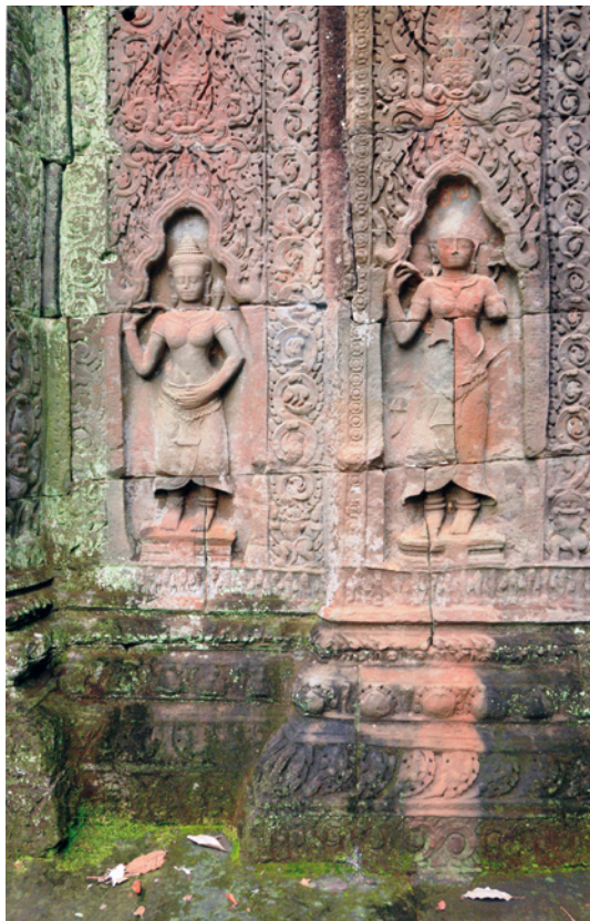
Bild 5 Nach einer hydrophobierenden Tränkung am Tempel Ta Nei in Kambodscha tritt vermehrt die stark rot gefärbte Grünalge Trentepohlia auf [Foto Leisen]
