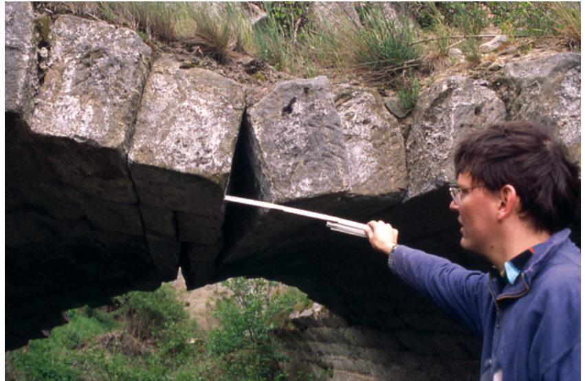
Bild 2 Klaffende Fuge am Scheitel infolge großer Auflagerverschiebungen [Jagfeld, 2000]
