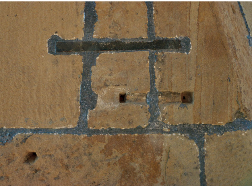
Bild 1 Detail Turmhelm mit wechsellagerter Steinbearbeitung und Ausparierungen für Verankerungen [strebeberg 2013]
