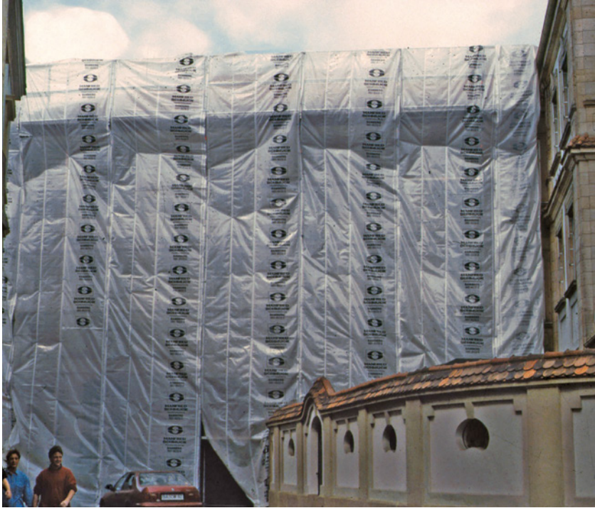
Bild 6 Abdeckung einer Fassade vor, während und nach der Festigung zum Schutz vor Regen, Wind und Sonne
