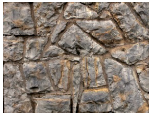
Bruchstein-Zyklopenmauerwerk N1
