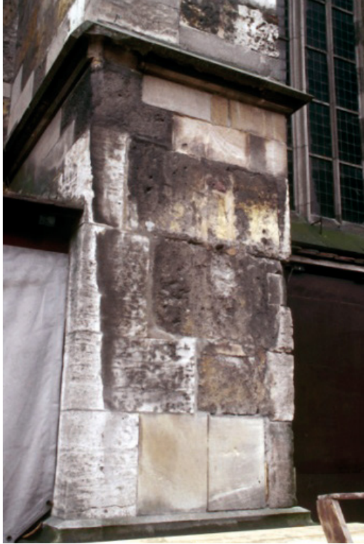
Bild 1 Verschmutzungen durch aufgewachsene Gips-Rußkrusten am Ulmer Münster, Pfeilerfläche
