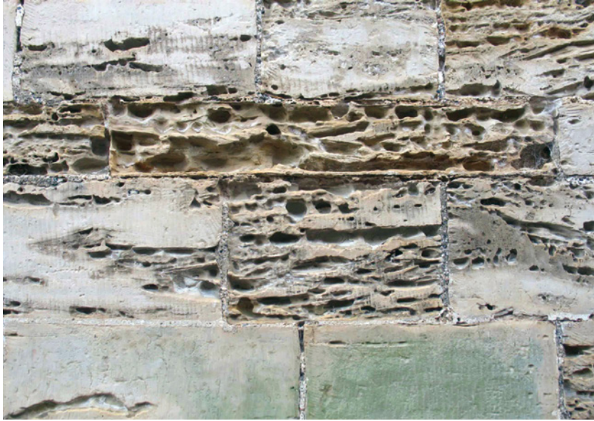
Bild 2 Alveolarverwitterung an Naturstein durch Salzkristallisation
