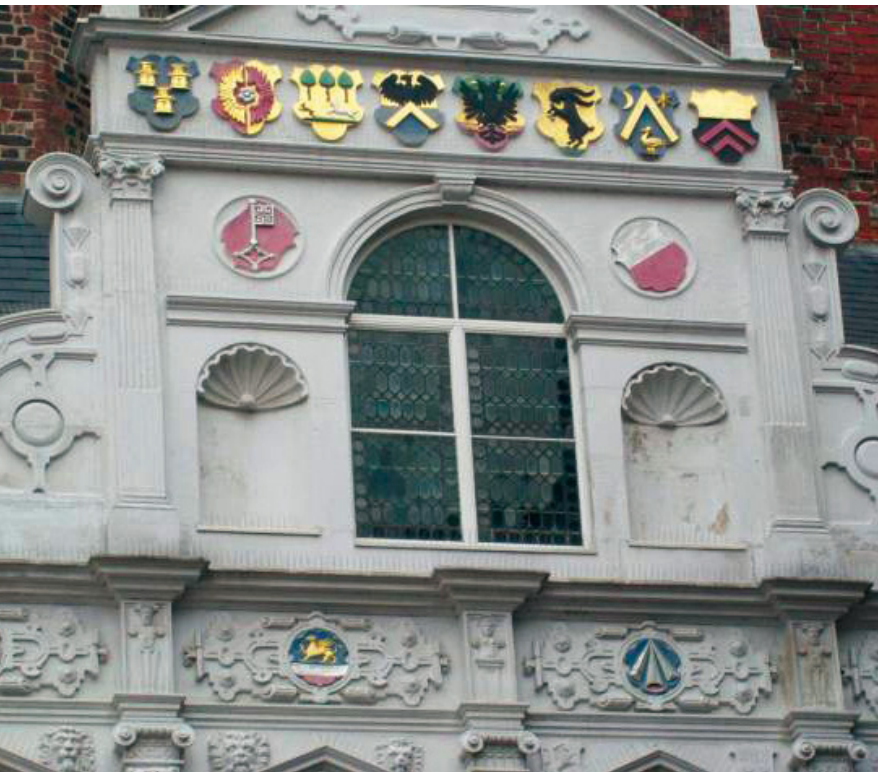
Bild 1 Rathaus Lübeck, Renaissance-Fassade mit Leinöl-Bleiweiß-Anstrich, Zustand 2010 nach sieben Jahren Standzeit
