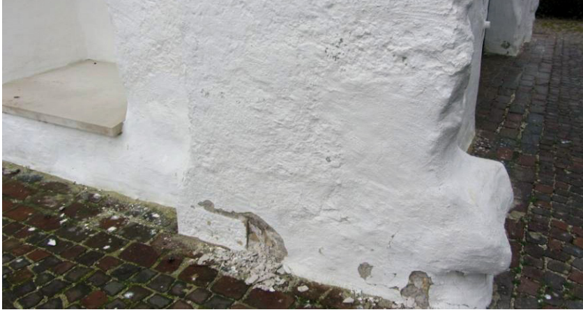
Bild 1 Risse, Hohllagen und Abplatzungen eines mit Kalkfarbe beschichteten Luftkalkputzes im Spritzwasserbereich
