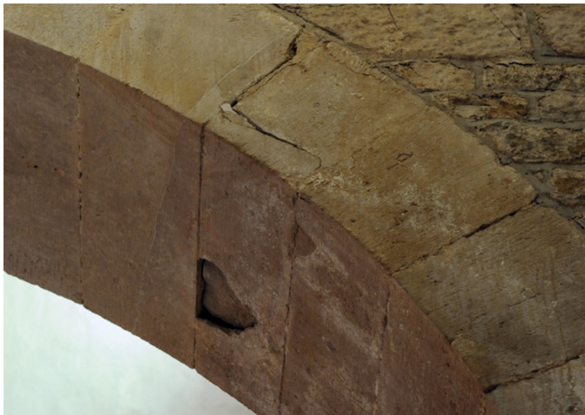
Bild 3 verschiebungen. Generell bilden sich die Risse früher und ausgeprägter je steifer die Konstruktion ist. Bogen im Seitenschiff der Abteikirche Fontenay
