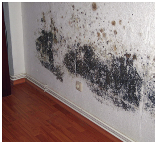
Bild 1 Kellerwand mit Schimmelfall – Abdichtungsmangel oder mangelnder Wärmeschutz
