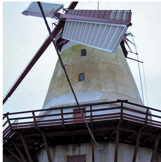
Bild 4 Windmühle Dübbøl-Sønderburg (Dänemark) Das zweischalige Mauerwerk der Holländermühle weist eine Hohlschicht auf, die mit Ostseesand verfüllt worden ist. Abdichtungen sind nicht vorhanden. Der Ostseesand speichert große Wassermassen im terrainenahen Bereich und belastet die innere und die äußere Mauerwerksschale [Koss, Lesnych, 2013].
