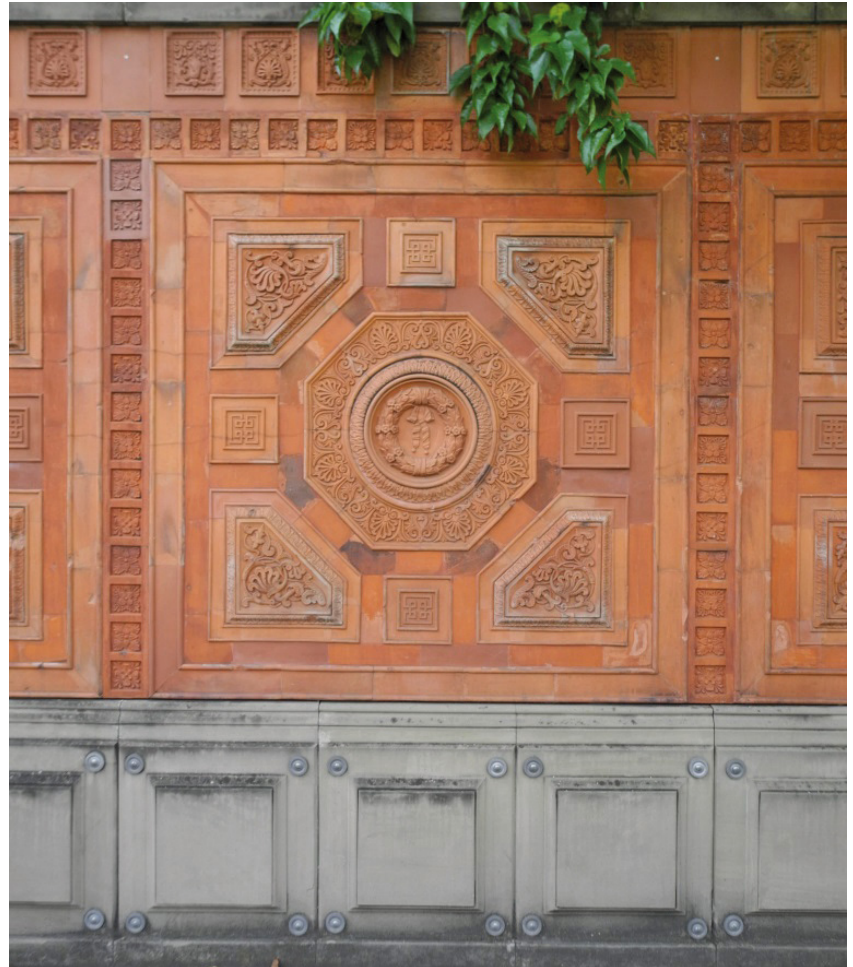
Bild 6 Terracottabelag, Umgebungsmauer an der Wilhelma, Stuttgart
