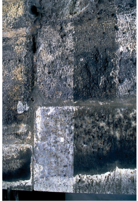
Bild 2 Graduelle, behutsame Reinigung der Fläche mit Partikelstrahlen (JOS-Technik)
