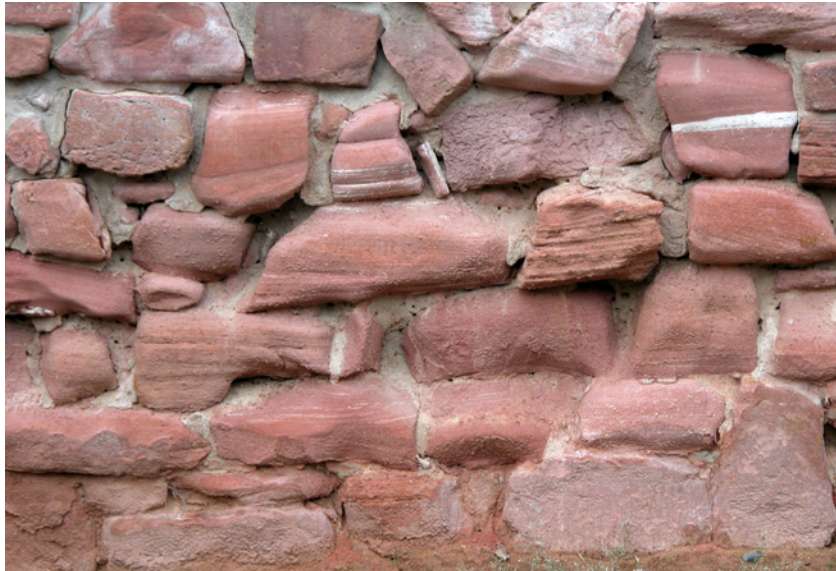
Bild 4 und -grundmauern im hohen Maße vom Stein- und Fugenmaterial sowie den Fugenverläufen ab. Grundsätzlich ist zwischen Bruchsteinmauerwerk mit unregelmäßigem Fugenverlauf (Bild 4a) oder Schichten- und Quadermauerwerk mit durchgehenden Lagerfugen (Bild 4b) zu unterscheiden und ob es sich um Vollmauerwerk oder mehrschalige Konstruktionen handelt.
