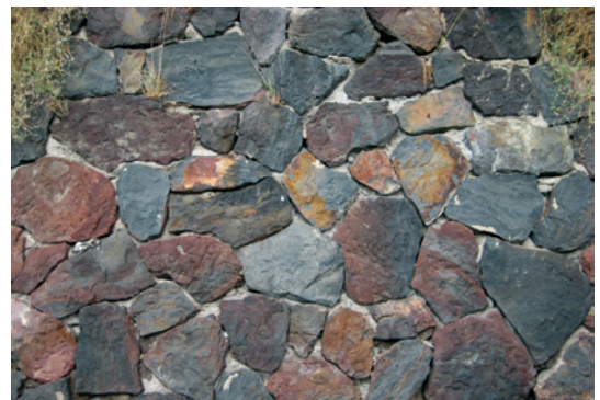
Bild 2 Bruchstein-Zyklopenmauerwerk
