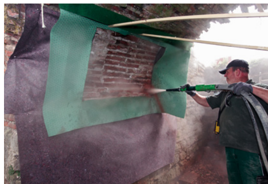
Bild 12 Musterfläche für das Trockenspritzverfahren, markiert auf der Untersicht des Gewölbes
