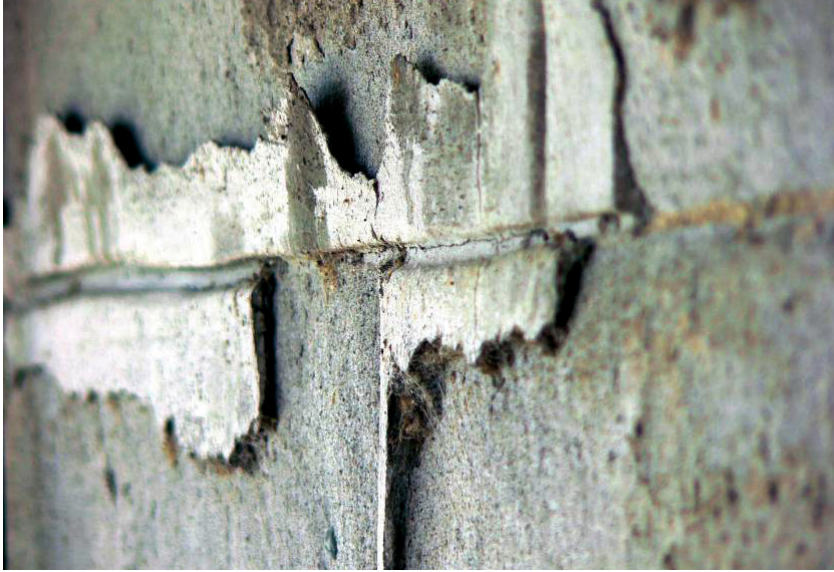
Bild 4 mit anschließender technischer und ästhetischer Bewertung aller Beteiligten zu empfehlen. Mit einem Abreißtest kann geprüft werden, ob der Bestandsputz für die neue Beschichtung ausreichend tragfähig und ob das Festigkeitsgefälle und der Haftverbund angemessen sind. Falscher Fugenmörtel und falsche Ausführung haben zu Millimeter tiefer Rückwitterung des Sandsteins geführt.
