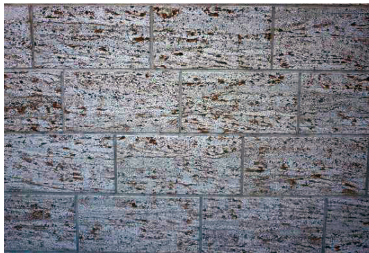
Bild 6 Quadermauerwerk
