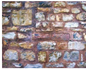
Bruchstein-Schichtenmauerwerk N1
