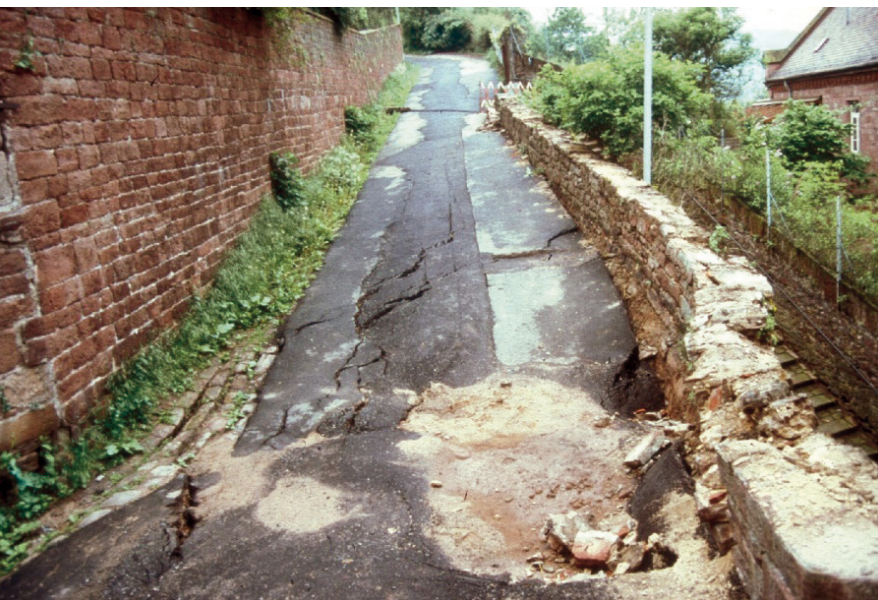
Bild 2 Versagen der Mauer in Teilen – Untersuchungprogramm erarbeitet werden Verlust der Gebrauchstauglichkeit [Schwing, 1991]. Ein allgemeingültiges Konzept kann nicht angegeben werden.
