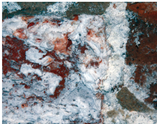
Bild 1 Salzkruste auf einem Ziegelmauerwerk
