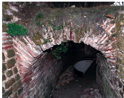
Bild 1 Ziegelmauerwerk in der Apsis des ehemaligen Caldariums
