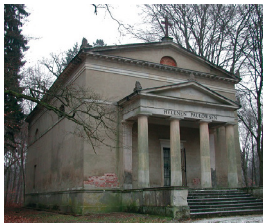
Bild 6 Mausoleum Ludwigslust »Heleen Paulownen« (Mecklenburg-Vorpommern) Das Bauwerk ist infolge fehlender Rinnen und Fallrohre stark durch das Niederschlagswasser belastet. Besonders hohe Feuchtegehalte ergeben sich in der Höhe des Fußbodens des Mausoleums (siehe Putzschaden) [Koss, Lesnych, 2013].
