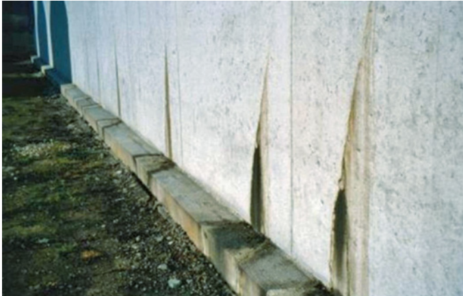
Bild 3.18 Wasserführende Risse in einer ausgedehnten Wand. Der Rissabstand ist relativ gleichmäßig und stellt die Scheibenteilung entsprechend dem Spannungsverlauf dar (Foto: T. Richter).
