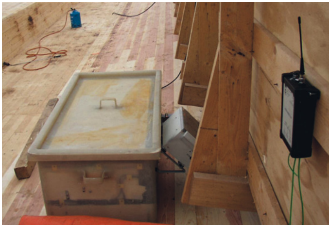
Bild 2.96 Einsatz der Klimatrube auf der Baustelle, Ansteuerung durch die Bauteiltemperatur [2.174]
