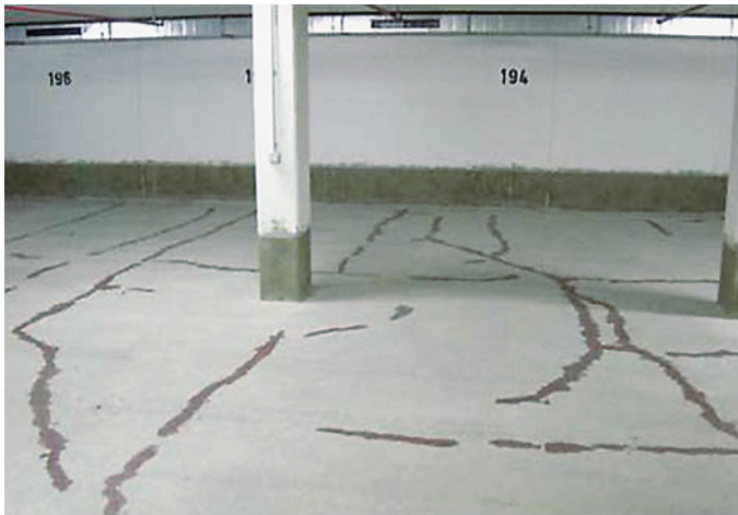
Bild 3.26 Tiefgaragenboden mit wasserführenden Rissbildungen infolge Zwängungen durch Stützen, Fundamenten und Wänden.
