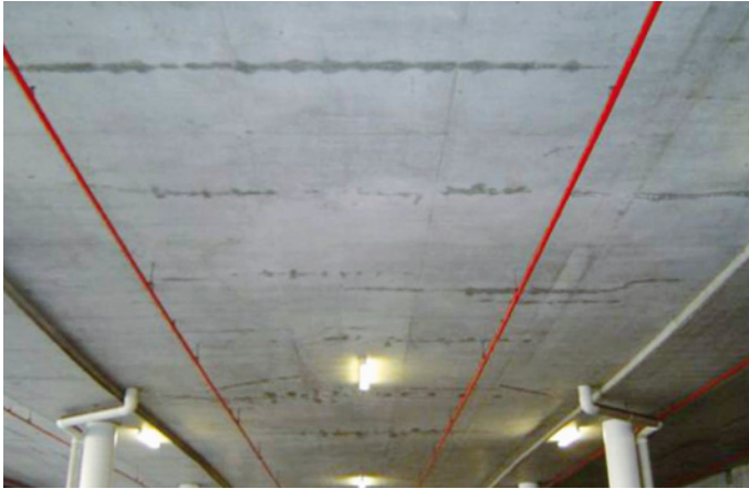
Bild 3.16 Rissbildungen parallel zur Deckenspannrichtung, d. h. senkrecht zur Längsrichtung des Bauwerkes und damit der Zwangsbeanspruchung
