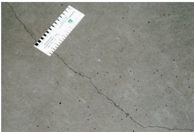
Bild 3.55 Im Rissverlauf wechselnde Rissbreite, Ermittlung der Rissbreite mit dem Linienstärkenmaßstab
