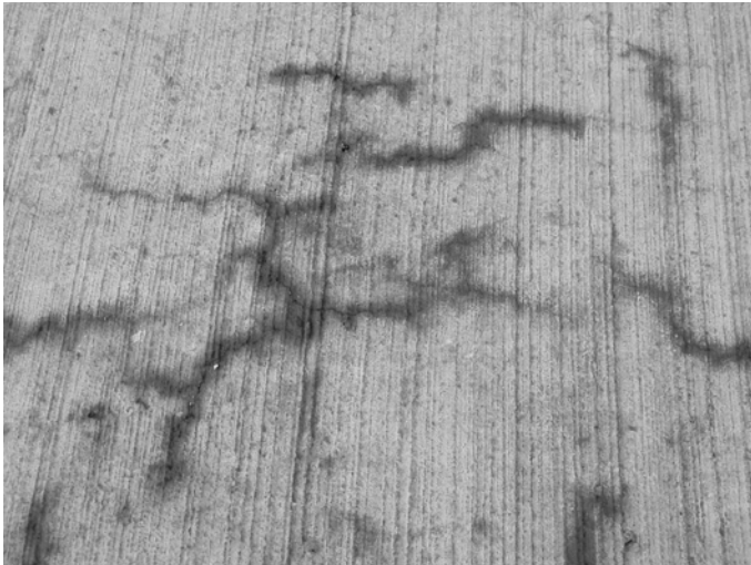
Bild 2.7 Frühschwindrisse in einer Stahlbeton-Fahrbahnplatte
