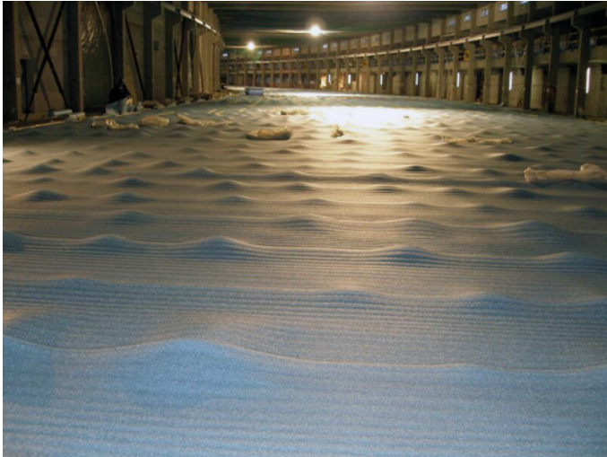
Bild 3.31 Isoliermatte zur Steuerung der Abkühlungsgeschwindigkeit einer dicken Bodenplatte (Foto: DESY Hamburg)
