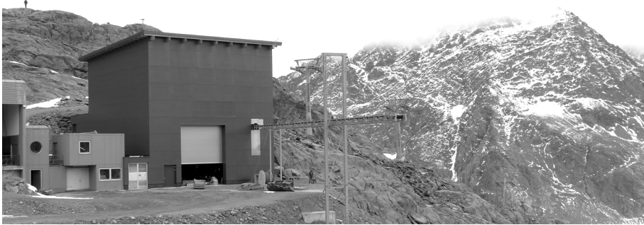
Abb. 2: Gebäude des All Weather Snowmaker von außen, mit Förderband-Konstruktion (© Herta Nöbauer 2014)
