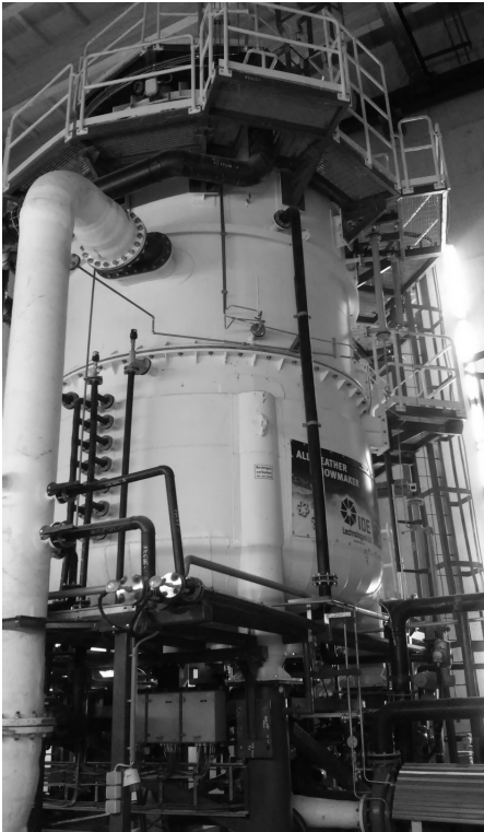
Abb. 1: All Weather Snowmaker im Gebäudeinneren, Pitztaler Gletscherskigebiet (© Herta Nöbauer 2016)
