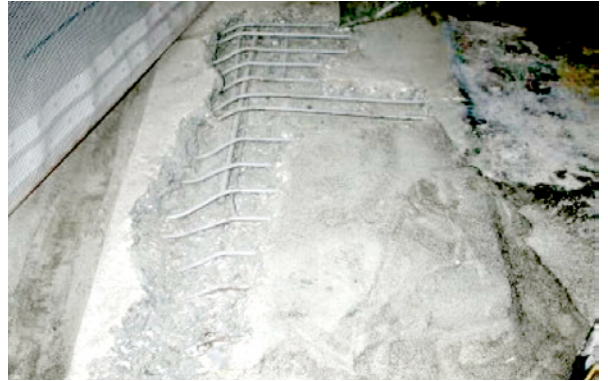
Bild 5.153: Zu geringe Betondeckung vor der Instandsetzung
