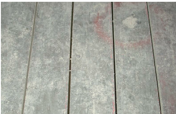
Bild 5.172: Längs eingeschnittene Schlitzte
