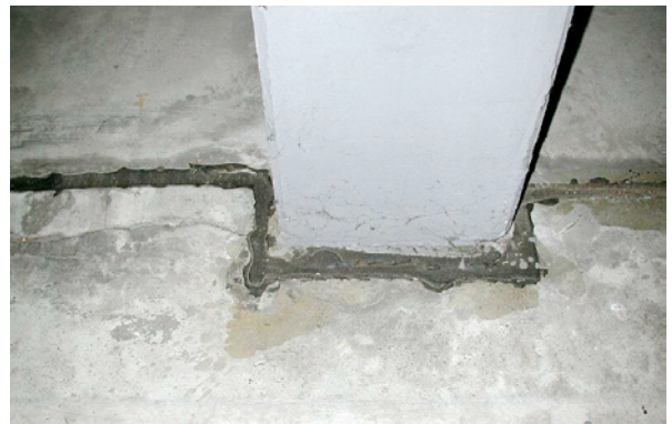
Bild 5.42: Ausgangszustand einer Randfuge mit erkennbaren Abplatzungen der Fugenflanken zwischen Bodenfläche und einer aufgehenden Stütze einer Tiefgarage vor der Instandsetzung
