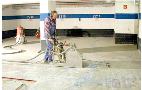
Bild 5.169: Trocken-Schneiden der Schlitzte zur Aufnahme der CFK-Verstärkungselemente
