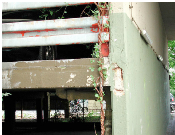
Bild 3.1: Nichteinhaltung der erforderlichen Mindestbetondeckung
