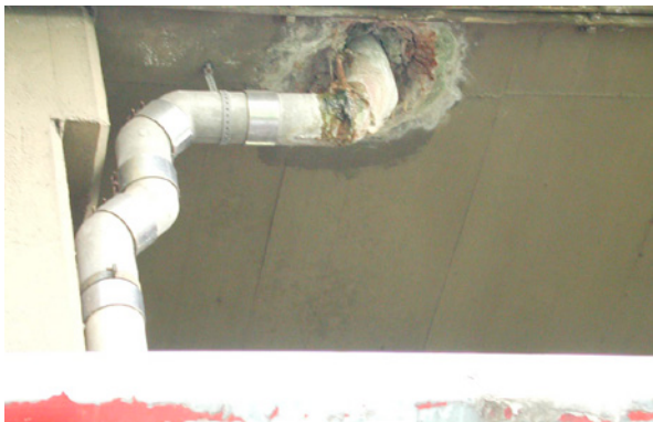
Bild 3.23: Undichtigkeit an Rohrleitungsanschlüssen und -durchdringungen
