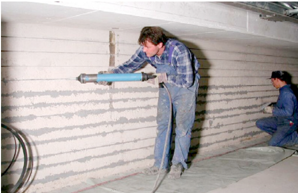
Bild 5.185: Verstärkung einer Wand einer Doppelparkergarbe
