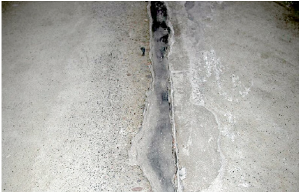
Bild 5.85: Ausgangszustand der Fugen einer Bodenfläche einer Tiefgarage vor der Instandsetzung
