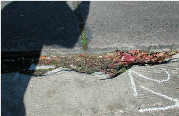
Bild 3.30: Ausbruchstelle in der angeschlossenen Betonplatte
