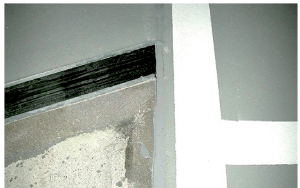
Bild 5.71: Anschluss einer Dehnfuge an eine Arbeitsfuge nach der Instandsetzung
