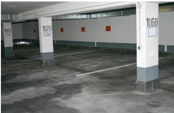
Bild 4.21: Mit Gussasphalt auf Schweißbahn sanierte Tiefgarage
