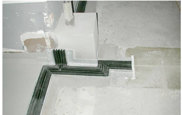
Bild 5.72: Eingebaute Dehnfugenkonstruktion im Anschlussbereich Bodenplatte – aufgehende Wand – Rohrleitungsdurchdringung (Ausgangszustand siehe Bild 5.50; Im Bild rechts ist die Abstimmung der Leistungsgrenze sichtbar!)
