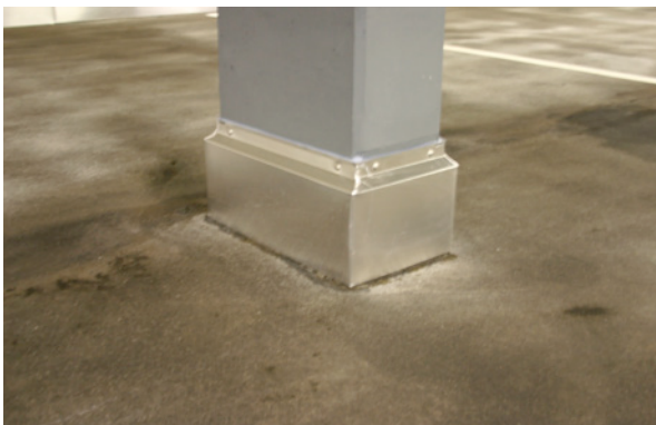
Bild 4.23: Sockelausbildung eine Stütze
