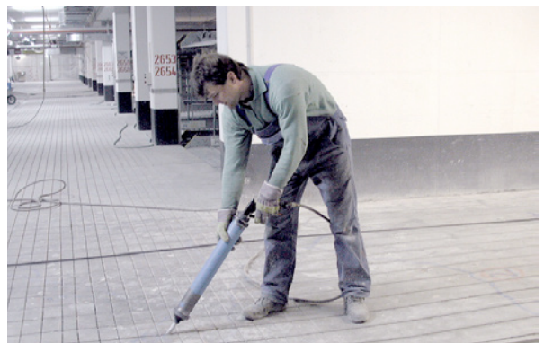
Bild 5.179: Einbringen des Epoxidharzklebers mittels Kleberpistole
