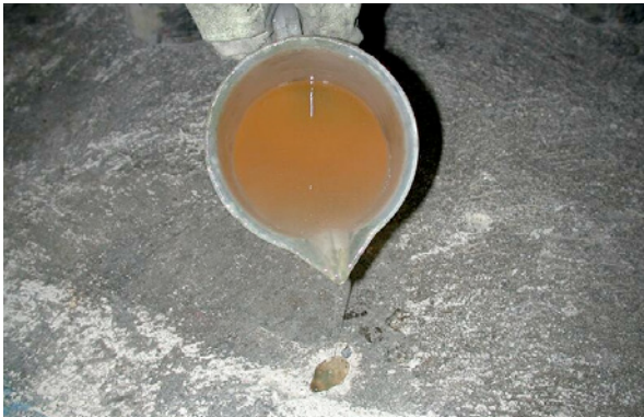
Bild 5.31: Nach der Beendigung der Rissinjektion (nach der Nachinjektion und dem Aushärten des Füllgutes) sind die Einfüllstutzen auszubauen. Die Bohrkanäle sind durch Vergießen mit dem Füllgut abzudichten.
