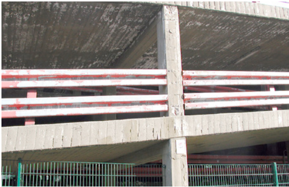
Bild 3.26: Mangelhafte Betondeckung an den Stützen der Rampenkonstruktion
