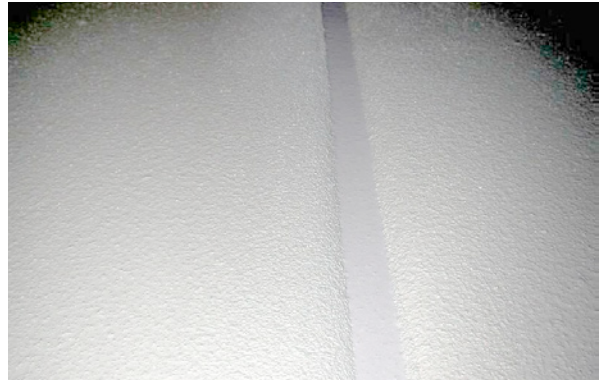
Bild 5.86: Fuge der Bodenfläche nach der Beendigung der Instandsetzung (einschließlich Oberflächenschutzsystem und Einbringen des Fugendichtstoffes)
