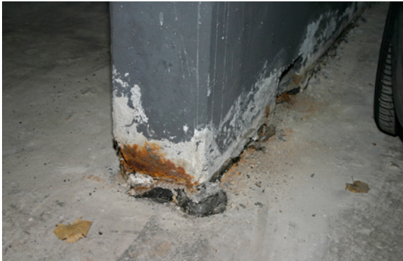
Bild 3.52: Rostflecke als Zeichen einer fortgeschrittenen Bewehrungskorrosion
