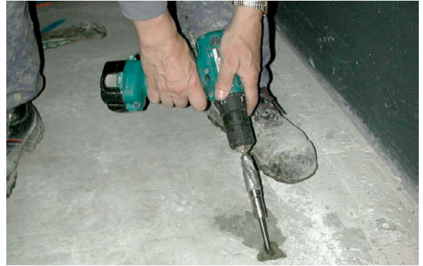
Bild 5.26: Abdichten des Bohrpackers durch Spannen der Gummimuffe des Einfüllstutzens
