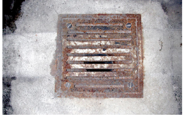
Bild 3.60: Stahlkorrosion an ungeschützten Stahleinbauteilen und Gusseisen
