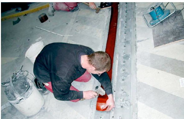
Bild 5.134: Vorbereitungen zum Einbau der Abdichtungen
