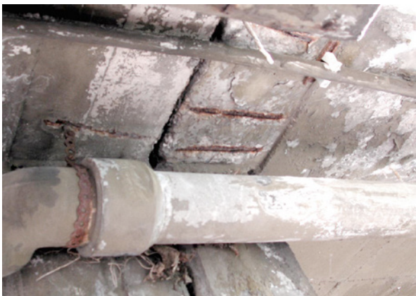
Bild 3.14: Undichte Bauwerksfuge und zu geringe Betondeckung im Fugenbereich
