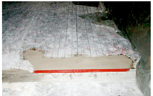
Bild 5.157: Mit Epoxidharzmörtel reprofilierte, zu verstärkende Bodenplattenfläche
