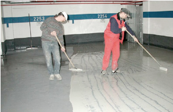
Bild 5.209: Aufbringen der Verschleißschicht
