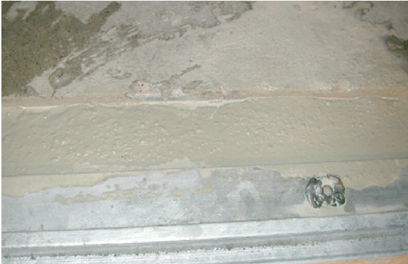
Bild 5.58: Vergussmörteloberflächen
