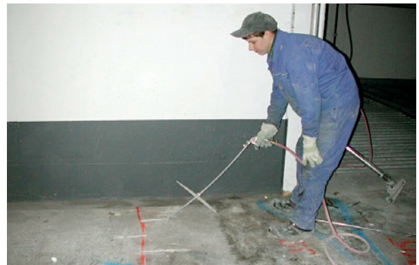
Bild 5.23: Entfernen von Bohrmehl durch Ausblasen der Bohrungen
