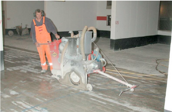
Bild 5.168: Nass-Schneiden der Schlitzte unter Beachtung der flächendeckenden Betondeckungsmessungen nach den Vorgaben des Statikers (blau markierte Risse)
