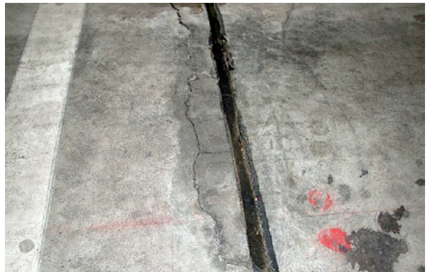
Bild 5.46: Mit Zementmörtel unwirksam ausgebesserte Abplatzungen
