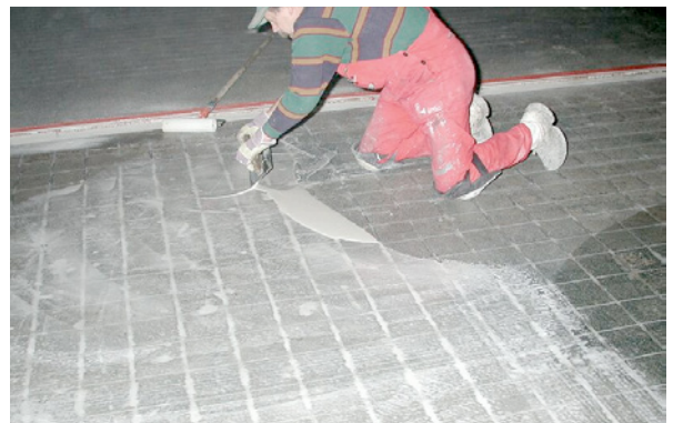
Bild 5.204: Einbringen einer Lunker- bzw. Kratzspachtelung zur Egalisierung der zu beschichtenden Betonfläche
