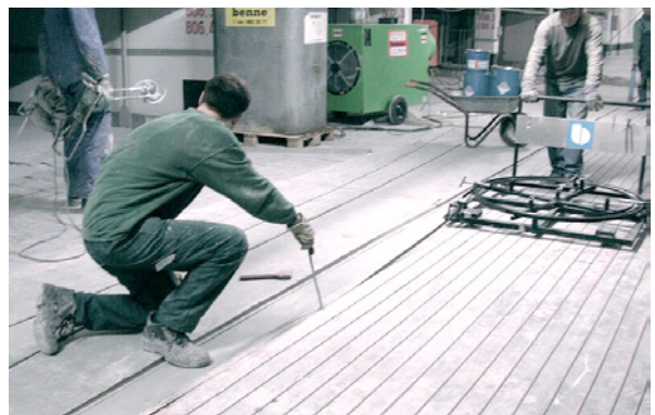
Bild 5.182: Korrektur der Lage des Verstärkungselementes
