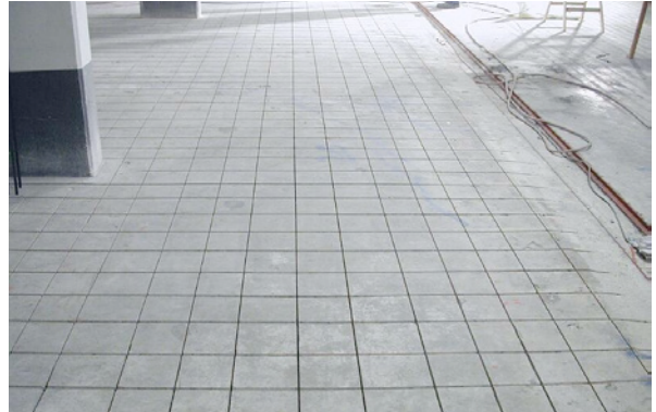
Bild 5.171: Eingeschnittene Schlitzte in aufgebrachter Mörtelschicht
