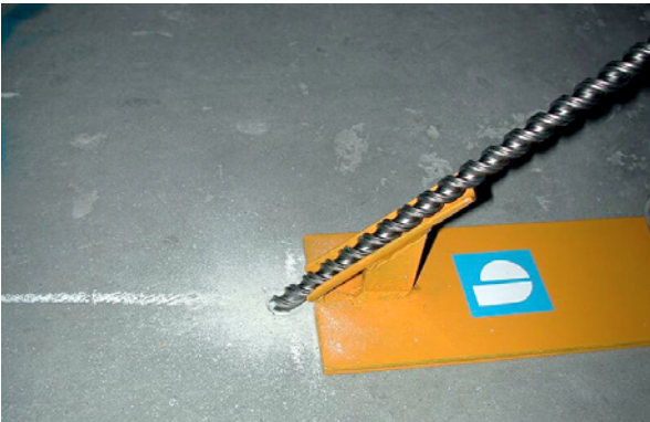
Bild 5.17: Zur Einhaltung der erforderlichen Neigung (45°) der Bohrkanaäle, um in Bauteilmitte den wasserführenden Trennriss zu treffen, haben sich entsprechende Lehren für das Personal bewährt.
