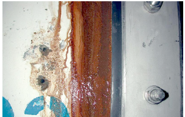
Bild 5.108: Örtliche Abdichtung von Wasserdurchtrittsstellen im Bereich der Dichtungsprofile
