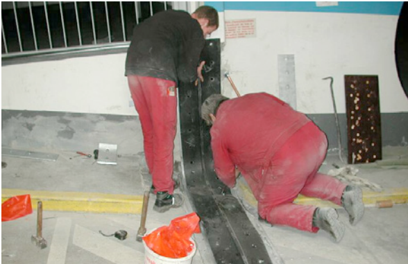
Bild 5.136: Einbringen des Abdichtungsfugenbandes
