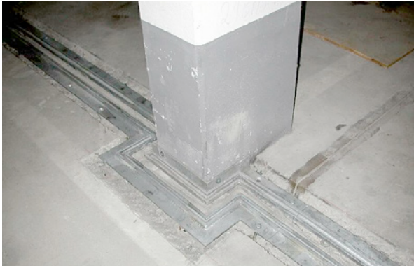
Bild 5.54: Montierte Stahlprofile im Bereich der aufgehenden Stütze (Ausgangszustand z. B. siehe Bild 5.51)
