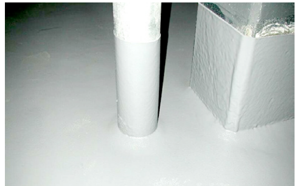
Bild 5.208: Ordnungsgemäße Sockelausbildung (Höhe mind. 15 cm) des Oberflächenschutzsystems
