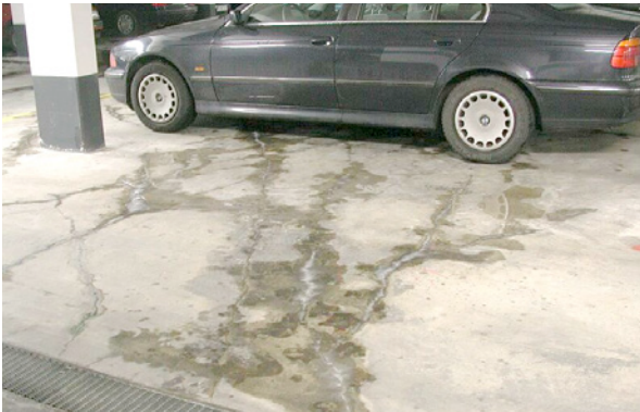
Bild 5.223: Wasserführende Risse in einer Tiefgarage vor der Instandsetzung
