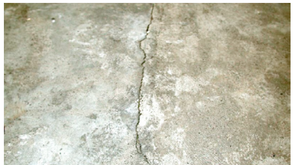
Bild 5.88: Abschnittsfuge zwischen zwei Betonierabschnitten
