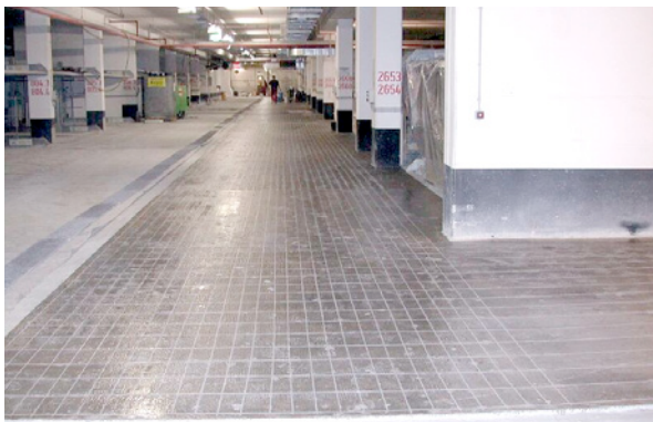
Bild 5.203: Verstärkter Tiefgaragenbereich nach dem Grundieren
