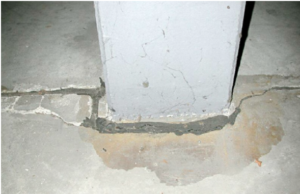
Bild 5.66: Ausgangszustand der Randfuge mit breiten Abplatzungen zwischen Bodenfläche und einer aufgehenden Stütze
