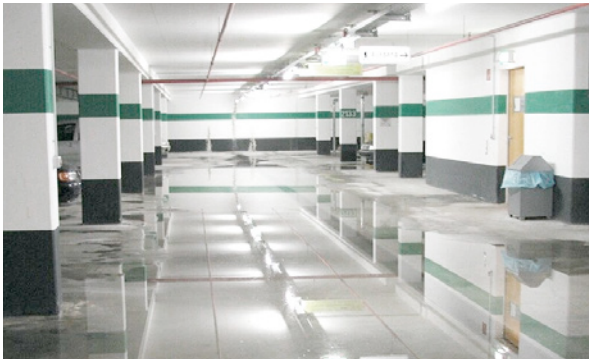
Bild 5.227: Zustand vor der Sanierung: Bei großer Rissöffnung infolge saisonbedingter Abkühlung der Stahlbetonkonstruktion traten erhebliche Wassermengen ein, die die Nutzung unmöglich machten.
