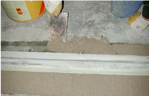
Bild 5.62: Einbringen des Epoxidharzmörtels bis an den Rand des Winkelprofils der Dehnfugenkonstruktion
