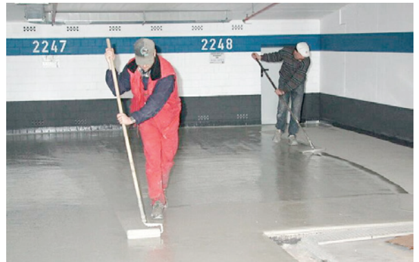
Bild 5.212: Kopfversiegelung
