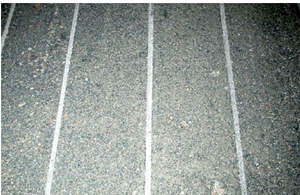
Bild 5.195: Zustand der Stahlbetonoberfläche nach dem Kugelstrahlen
