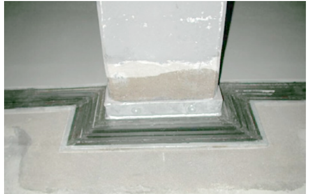
Bild 5.67: Randfuge mit aufgehender Stütze nach der Instandsetzung
