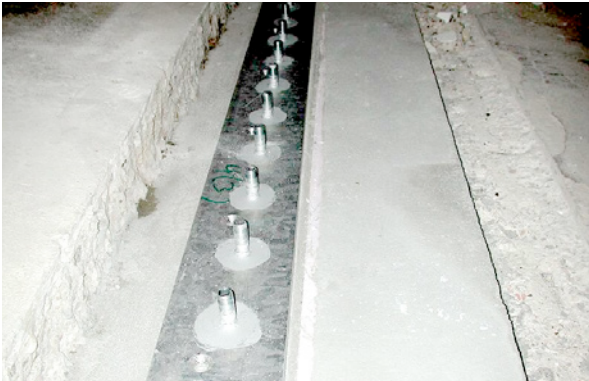
Bild 5.126: Einbau der unteren Abdichtungsprofile
