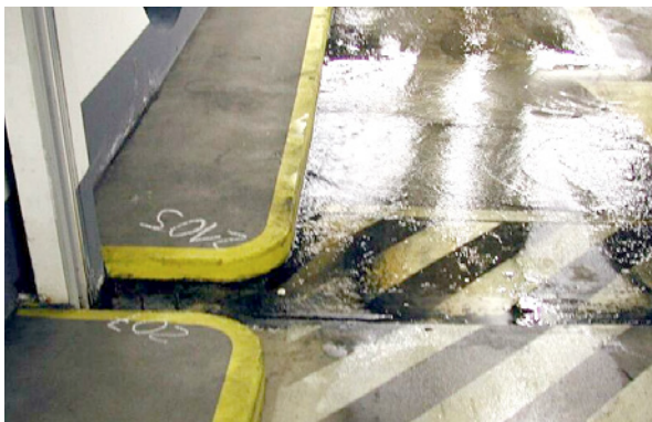
Bild 5.150: Stark wasserführende Dehnfuge vor der Instandsetzung
