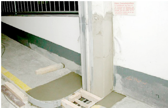
Bild 5.148: Ergänzen von abgebrochener Wandvorlage und Sockel
