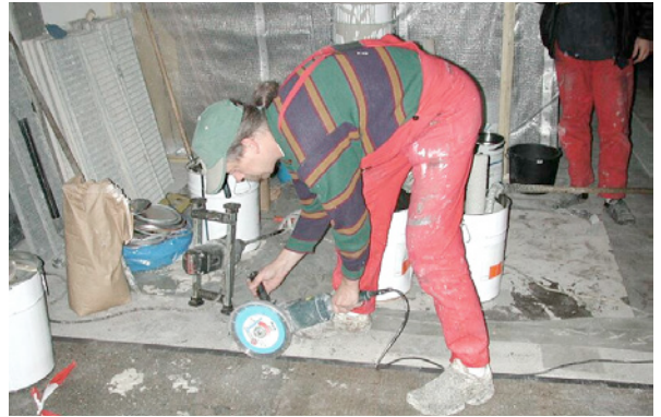
Bild 5.202: Einschnitten zur Begrenzung von Beschichtungsabschnitten
