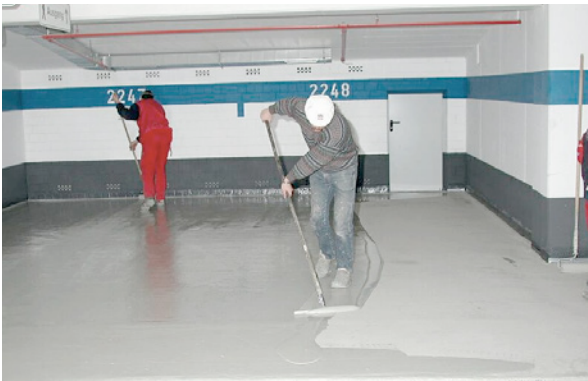
Bild 5.211: Aufbringen der Kopfversiegelung nach dem Entfernen des aufgetragenen Sandüberschusses
