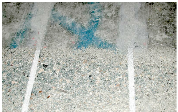
Bild 5.194: Zustand der verstärkten Stahlbetonoberfläche nach dem Kugelstrahlen
