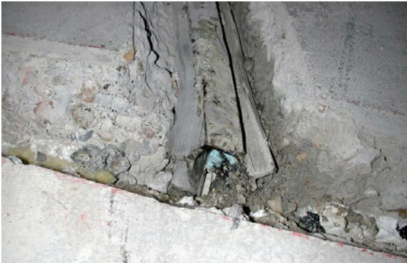
Bild 5.48: Freilegen des Dehnfugenbandes nach Entnahme des Fugenfüllstoffes und des eingeschnittenen Betons
