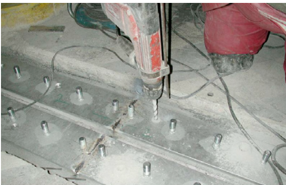
Bild 5.128: Bohren der Verankerungsstellen
