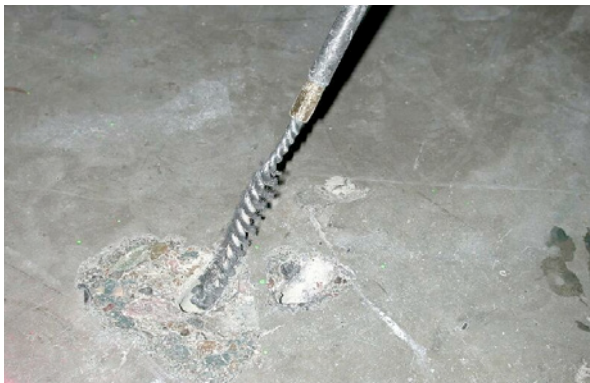
Bild 5.22: Reinigen der Bohrung von Bohrmehl durch rotierende Bürste
