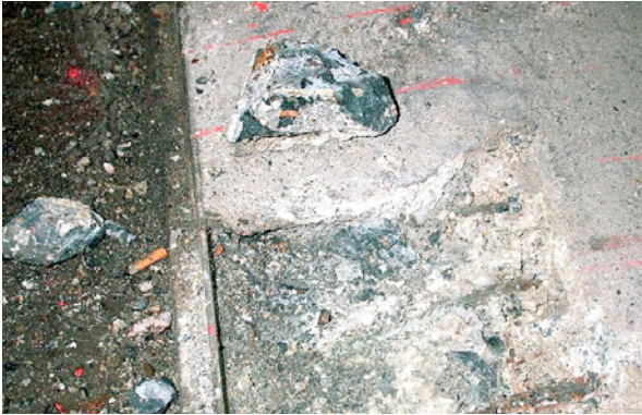
Bild 5.152: Zu geringe Betondeckung vor der Instandsetzung
