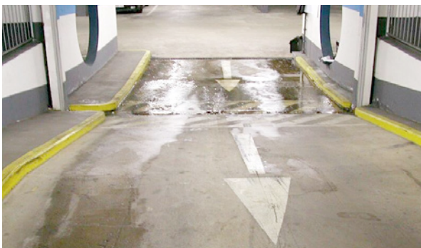
Bild 5.111: Erhebliches Eindringen von Wasser durch eine Dehnfuge bei hohem Wasserdruck im Rampenanschlussbereich in einer Tiefgarage
