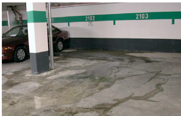
Bild 5.3: Die Wasserführung der Risse beginnt i. d. R. mit einer Befeuchtung der Rissufer und kann sich bis zur erheblichen Wasserführung steigern.
