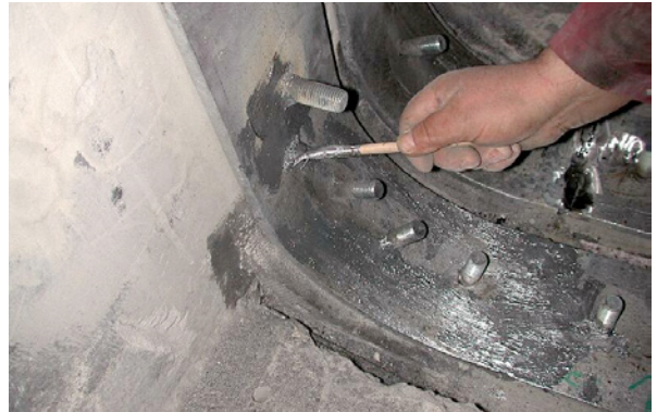
Bild 5.133: Einbau der Abdichtungsprofile im Sockelbereich
