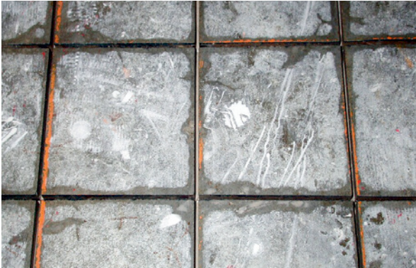
Bild 5.170: Oberfläche der zu verstärkenden Bodenplatte nach dem Schneiden der Schlitzte für das kreuzweise Verstärken
