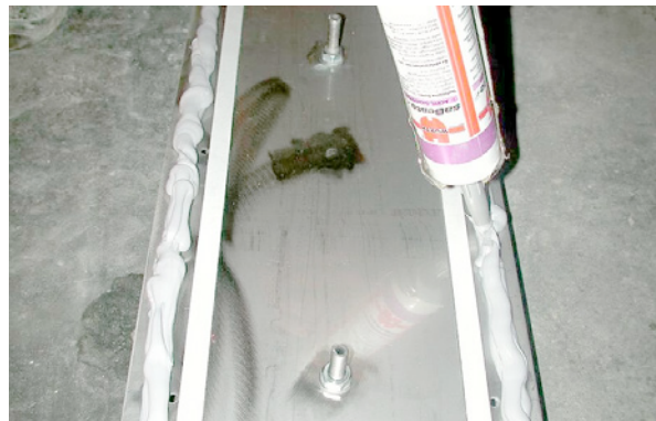
Bild 5.99: Abdichtung des Abdeckprofils
