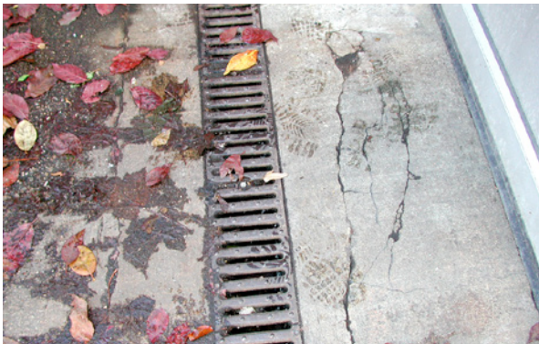
Bild 4.1: Wartung und Instandhaltung von Rinnen. Diese Risse parallel zu der Rinne sind ein deutliches Zeichen für zu erwartende Abplatzungen, hervorgerufen durch Frost.
