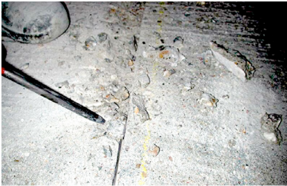
Bild 5.160: Herstellen eines Mörtelanschlusses nach dem Einschneiden durch Freistimmen
