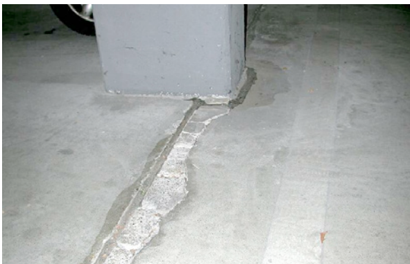
Bild 5.64: Zustand der Dehnungsfuge der Überfahrt vor der Instandsetzung
