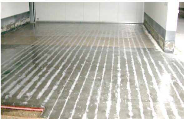
Bild 5.187: Bodenplattenbereich nach Beendigung der Verstärkungsarbeiten
