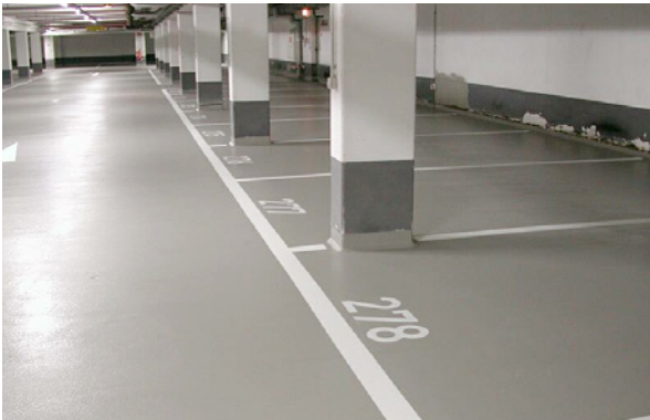
Bild 5.91: Tiefgarage nach der Instandsetzung (Bemerkung: Leistungsgrenze Sockelausbildung des Oberflächenschutzsystems bis 15 cm)
