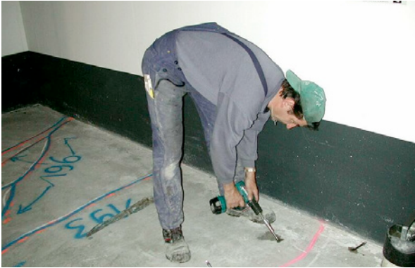
Bild 5.25: Wechselseitiges Setzen der Einfüllstutzen (Bohrpacker)
