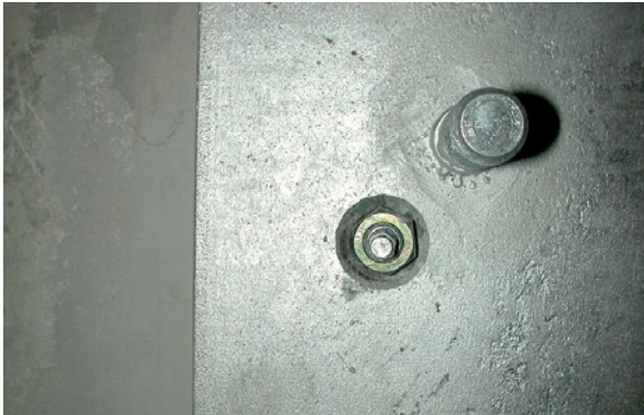
Bild 5.130: Einbau des Verbundankers
