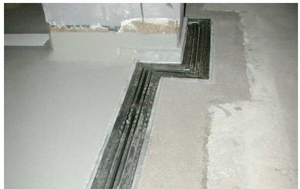
Bild 5.65: Zustand der Dehnungsfuge der Überfahrt nach der Instandsetzung (siehe Bild 5.45)
