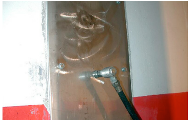
Bild 5.103: Vergelung über eingebaute Einfüllstutzen von unten beginnend nach oben
