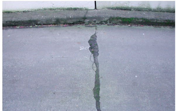
Bild 3.20: Fuge mit ausgebrochenen Fugenflanken und unterschiedlicher Fugenbreite
