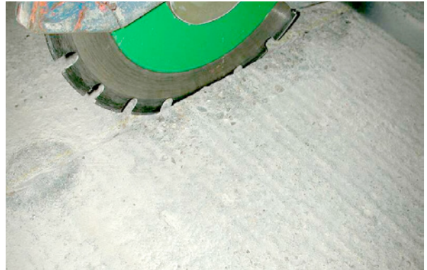
Bild 5.159: Einschneiden von Abschnittsgrenzen unter Beachtung der vorhandenen Betondeckung
