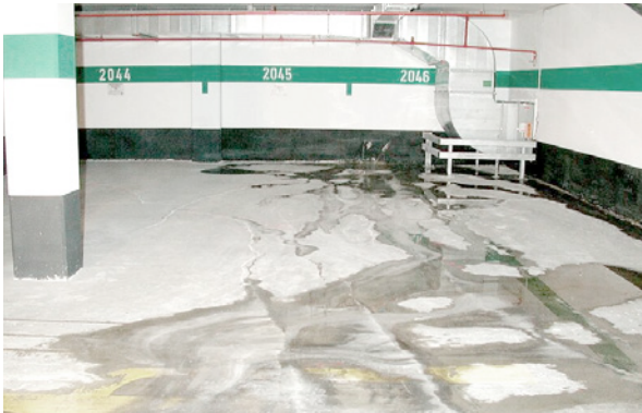
Bild 5.229: Wasserführender Bereich der Anschlussfuge Bodenplatte – Wand der wasserundurchlässigen Stahlbetonkonstruktion vor der Instandsetzung
