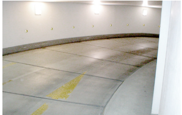
Bild 3.43: Mit einem Oberflächenenschutzsystem OS 11 beschichtete Zufahrtsrampe einer Tiefgarage
