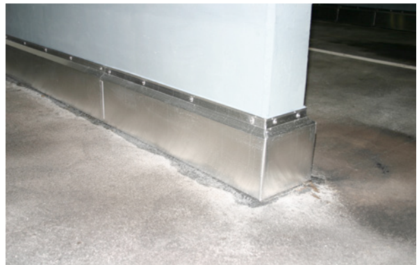
Bild 4.22: Sockelausbildung eines starren Wandanschlusses
