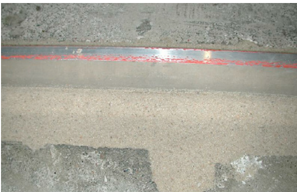
Bild 5.81: Abstellung der Fugenbreite durch ein im Gefälle ausgerichtetes Richtscheit
