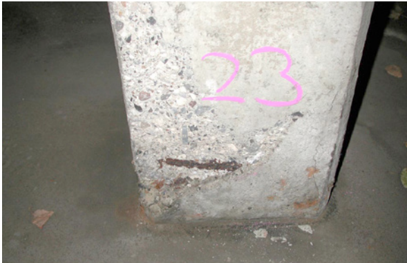
Bild 3.54: Rostflecke und Risse, Betonabplatzung über korrodiertem Bügel
