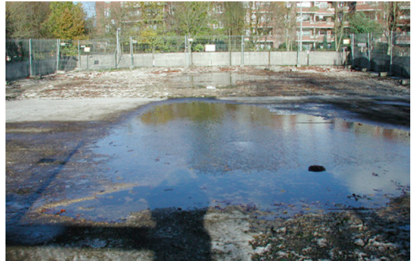
Bild 3.33: Hoher Verschleißzustand; langanhaltende Pfützenbildung durch fehlende Gefälleausbildung bewirkte diesen beträchtlichen Schaden der Stahlbetonkonstruktion.
