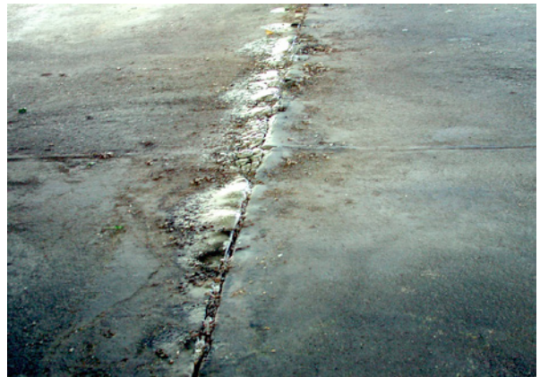
Bild 3.13: Fuge mit zu geringer Fugenbreite (Fugendichtstoff wird aus der Fuge herausgedrückt)
