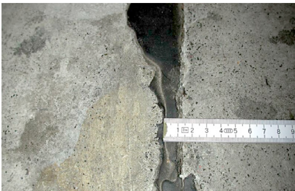
Bild 5.39: Ausgangszustand einer Bodenfuge, kleinste Fugenbreite: 10 mm
