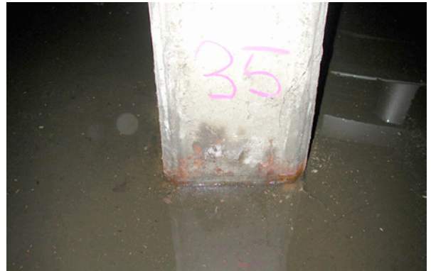
Bild 3.36: (Detail aus Bild 3.35) Sichtbare Rostflecke oberhalb der Stützenanschlussfuge zur Bodenplatte als Zeichen einer fortgeschrittenen Bewehrungskorrosion mit sichtbar beginnender typischer Rissbildung an den Stützenkanten
