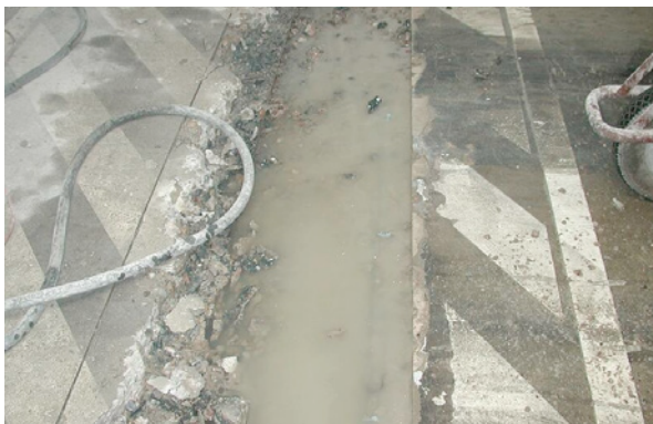
Bild 5.116: Anstehendes Wasser nach dem Freistemmen der Fugenflanken
