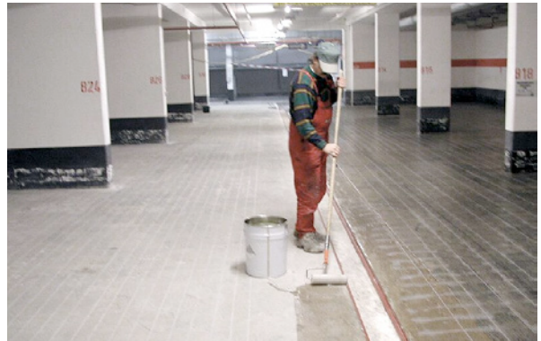
Bild 5.198: Grundieren der zu beschichtenden Oberfläche mit Epoxidharz
