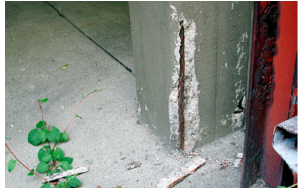
Bild 3.51: Typischer Stahlbetonschaden an Stützenfüßen im Parkdeck
