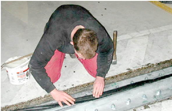
Bild 5.144: Einbringen des Schutzprofiles
