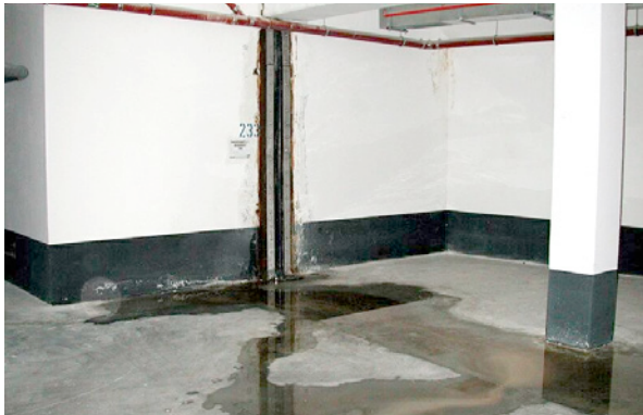
Bild 5.105: Permanenten Wasserdurchtritt durch eine Wanddehnfuge bei großem anstehenden Wasserdruck
