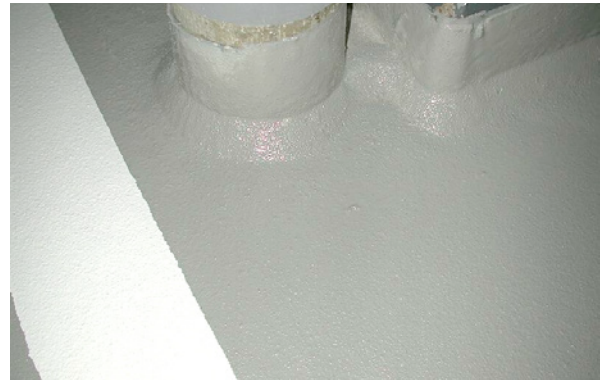
Bild 5.92: Detailausbildung im Sockelbereich (Höhe bis min. 15 cm) an einer Rohrdurchführung (Mörtelkeil im Anschluss zwischen horizontaler und vertikaler Fläche; siehe Bilder 5.199 und 5.200)
