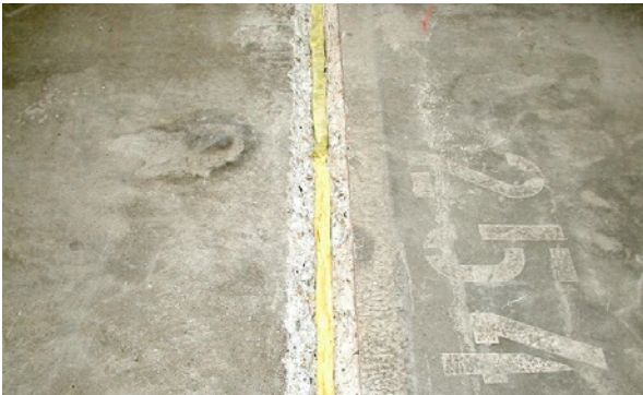
Bild 5.79: Abstellung bzw. Hinterfüllung der Fuge
