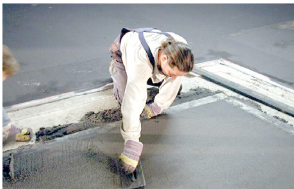
Bild 5.164: Ausreiben der Mörtelflächen zur Erhöhung der Betondeckung im Verstärkungsbereich
