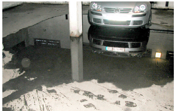
Bild 3.35: Typische Pfützenbildung in einer Tiefgarage mit großer Schädigung des Stützenfußes
