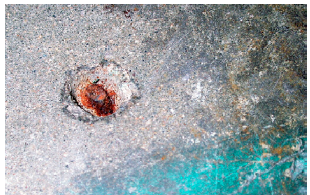
Bild 5.30: Nicht vollständig ausgebaute Einfüllstutzen können zu korrosionsbedingten Schäden der Betonoberfläche führen.
