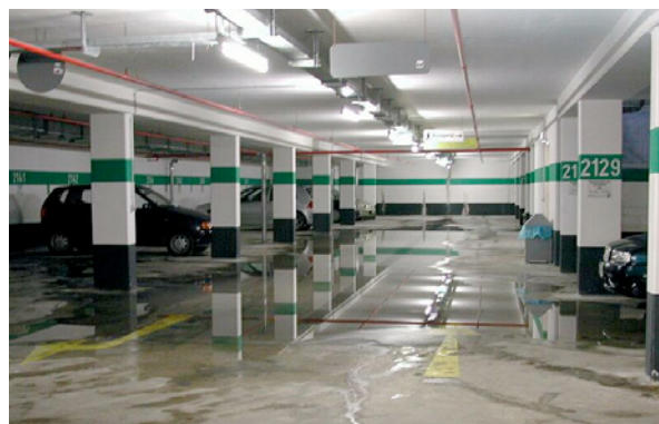
Bild 5.4: Im dargestellten Beispiel führte die durch die wasserundurchlässige Stahlbetonkonstruktion eindringende Wassermenge zur deutlichen Nutzungseinschränkung der Tiefgarage.
