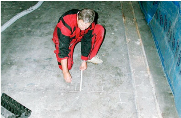
Bild 5.15: Zur korrekten Einhaltung des Verlaufes der Bohrkanaäle ist das wasserfeste Aufzeichnen der Bohrpunkte zu empfehlen.
