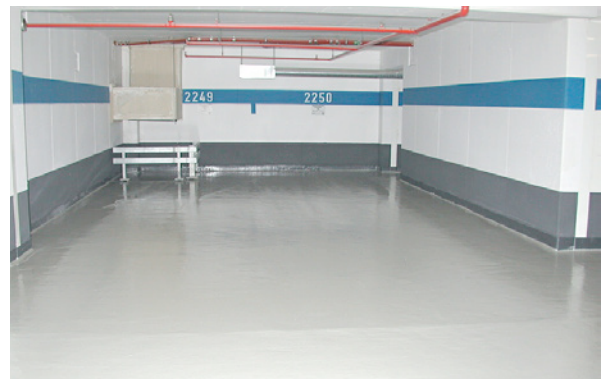
Bild 5.36: Teilfläche in einer Tiefgarage nach dem Abdichten der Risse und dem Abschluss der Instandsetzungsarbeiten
