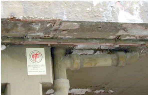
Bild 3.22: Undichtigkeiten an Rohrleitungsanschlüssen von Einläufen
