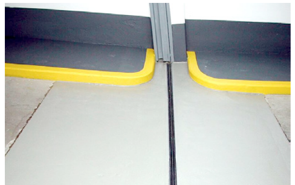
Bild 5.151: Dehnfuge nach der Instandsetzung
