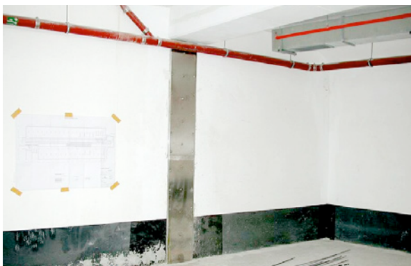
Bild 5.109: Dehnungsfuge nach der Instandsetzung (Ausgangszustand siehe Bild 5.105)
