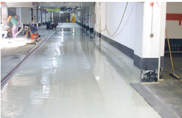
Bild 5.213: Verstärkter Bodenplattenbereich nach Abschluss der Beschichtungsarbeiten
