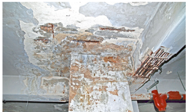
Bild 3.8: Erhebliche und langandauernde Durchfeuchtungen an einem Installationsschacht führten zu starker Korrosion am Stahlbeton. Die Tragfähigkeit des Stahlbetonbalkens ist durch den hohen Abrostungsgrad gefährdet!
