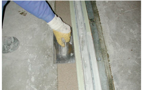
Bild 5.63: Glätten der Epoxidharzmörteloberfläche, Einbringen eines Kellenschnittes entlang des sichtbar bleibenden Stahlprofils für den Anschluss des Oberflächenschutzsystems
