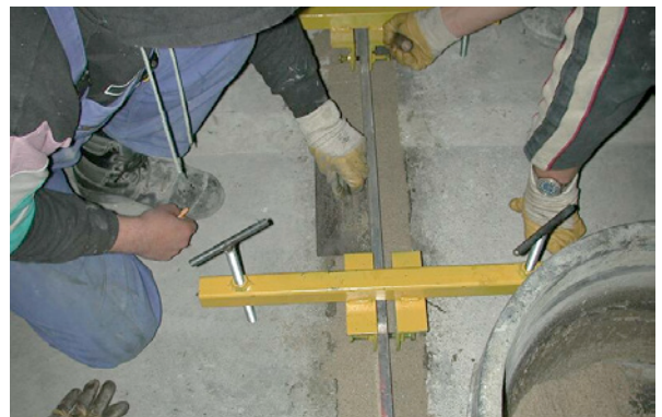
Bild 5.82: Haltevorrichtung zur Gefälleausrichtung der Fugenabstellung
