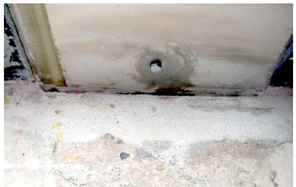
Bild 5.110: Anschlussdetail zur Bodenplatte
