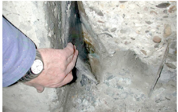
Bild 5.121: Unwirksames Dichtungsprofil im Anschlussbereich Rampe – Dehnfuge
