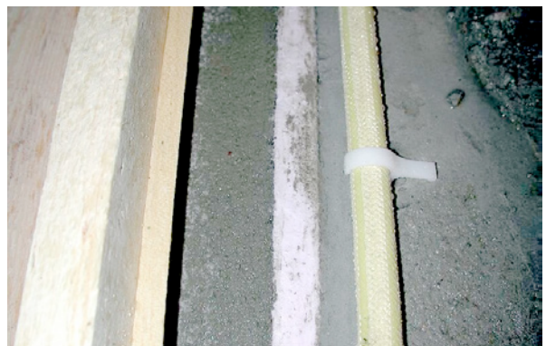
Bild 5.123: Detail aus Bild 5.122. Fugenabstellung-Injektionsschlauch
