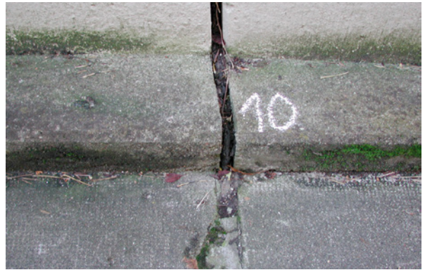
Bild 3.27: Ausgebrochene Fugenflanken an den Rampenanschlussfugen
