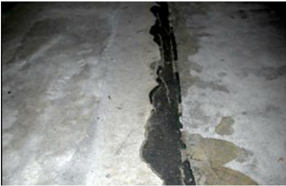
Bild 5.68: Ausgangszustand der Fugen einer Bodenfläche
