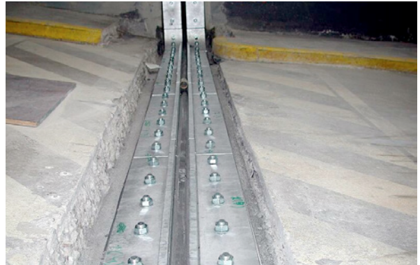
Bild 5.143: Fertig eingebautes Dehnfugenabdichtungsprofil
