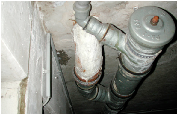
Bild 3.21: Undichte Fuge an Rohrdurchführung
