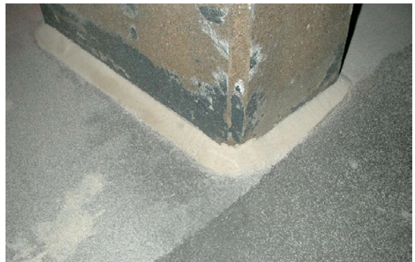
Bild 5.200: Einbringen eines Epoxidharzmörtelkeils in die Anschlussbereiche zwischen horizontalen und vertikalen zu schützenden Flächen, hier Bodenplatte – Stütze
