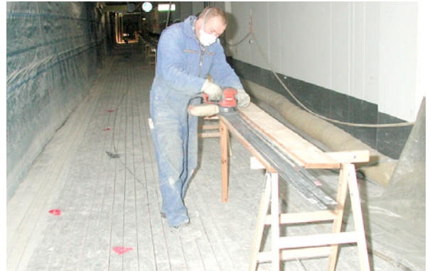
Bild 5.175: Vorbereitung der Verstärkungselemente für das Kleben
