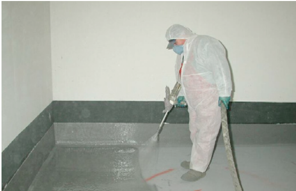
Bild 5.205: Zweilagiges Aufbringen der Flüssigfolie
