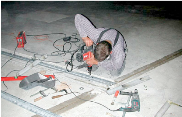
Bild 5.52: Einbringen und Ausrichten der vorgefertigten Stahlwinkel der Dehnfugenkonstruktion
