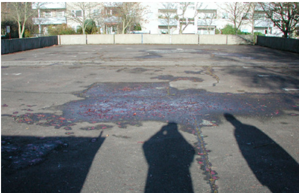
Bild 3.34: Pfützenbildung im Verlauf der Dehnfuge
