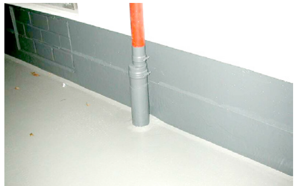
Bild 5.214: Detail Sockelausbildung – Rohrdurchführung
