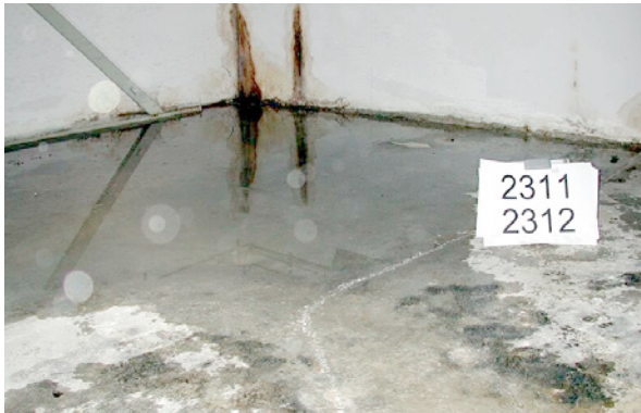
Bild 5.5: Sowohl Trennrisse der Bodenplatte als auch der Wände der wasserundurchlässigen Stahlbetonkonstruktion können wasserführend werden.
