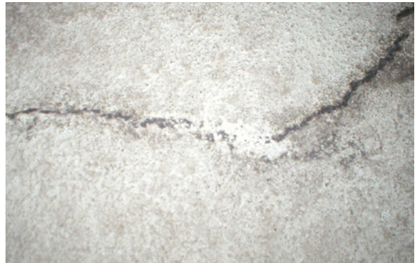
Bild 3.45: (Riss aus Bild 3.44) Bei näherer Betrachtung betrifft der Riss die obere, starre Verschleißschicht des rissüberbrückenden Oberflächenchutzsystems, die darunterliegende elastisch Dichtungsschicht (hwd) ist funktionstüchtig.
