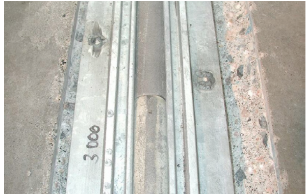
Bild 5.53: Ausgerichtete und über Verbundanker (Anker verschweißt) befestigte Stahlprofile. Mittig ist das Abdeckprofil erkennbar.
