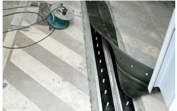
Bild 5.137: Einlegen des Abdichtungsfugenbandes
