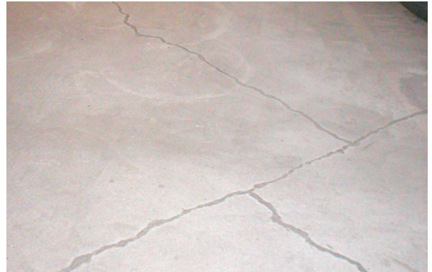
Bild 5.90: Fugenbild der Bodenplatte vor der Instandsetzung
