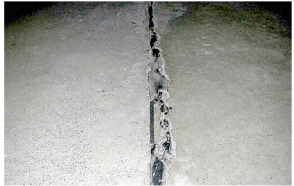
Bild 5.44: Unwirksame Bewegungsfuge mit Betonabplatzungen im Bereich der Fahrgasse der Tiefgarage
