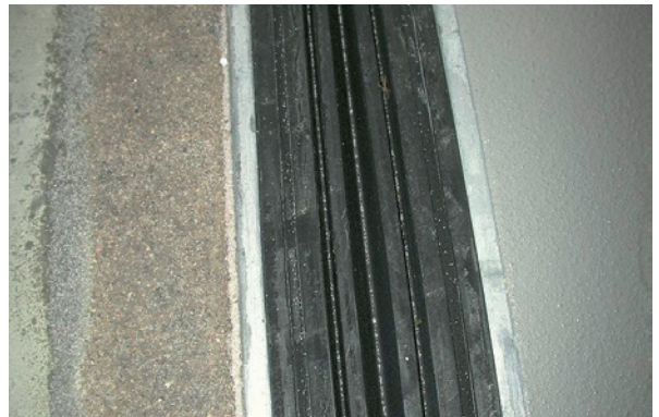
Bild 5.69: Zustand der Dehnfugen einer Bodenfläche nach der Instandsetzung
