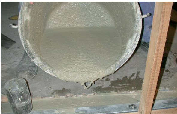
Bilder 5.56, 5.57: Untergießen der ausgerichteten Winkelprofile mit zementgebundenem Vergussmörtel
