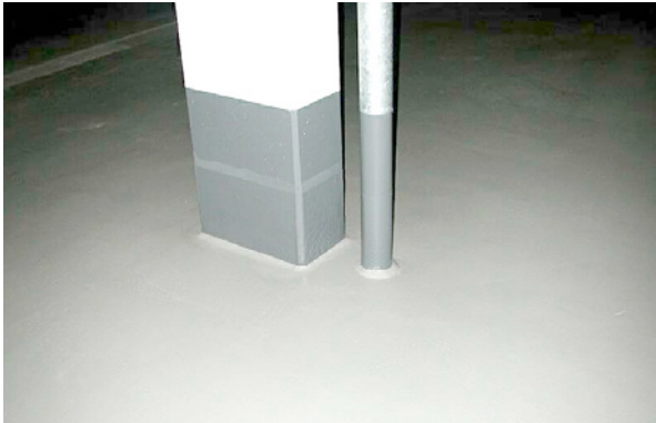
Bild 5.215: Detail Stützenanschluss – Bodenplatte-Rohrdurchführung
