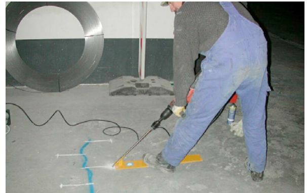
Bild 5.18: Bohren der Bohrkanaäle zur Aufnahme der Einfüllstutzen mit der Bohrlehre mit Hilfe der aufgezeichneten Bohrstellen. Zur Dokumentation der Rissinjektion sind die Risse nummeriert.
