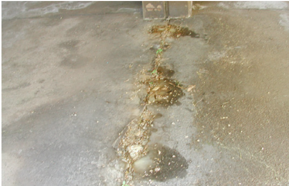
Bild 3.32: Hoher Verschleißzustand einer Dehnungsfuge im Überfahrbereich
