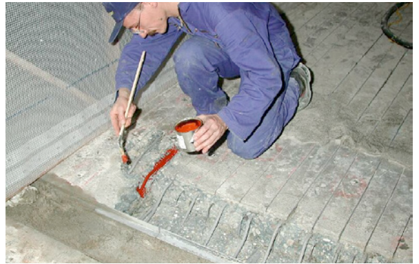
Bild 5.155: Aufbringen von Kunstharzkorrosionsschutz auf die Bewehrung
