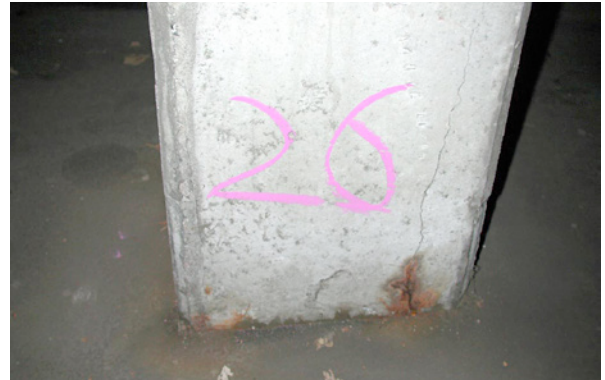
Bild 3.55: Rissbildung an Stützenfuß über korrodiertem Bewehrung
