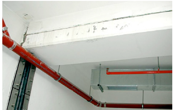
Bild 5.106: Dehnfuge nach dem Einbau der Unterkonstruktion der Dehnfugenkonstruktion
