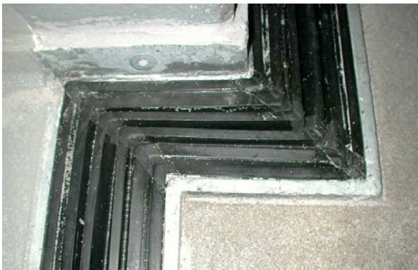
Bild 5.75: Dehnfugendetail
