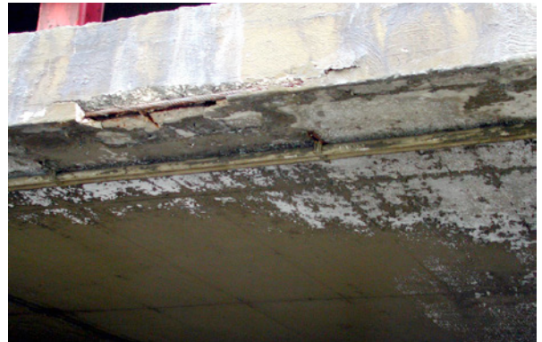
Bild 3.50: Betonabplatzung an einer Plattentropfkante eines Parkdecks infolge unzureichender Mindestbetondeckung und konstruktiver Gestaltung
