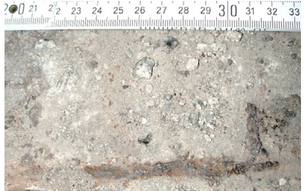
Bild 3.57: Deutliche Querschnittsverminderung durch chlorid-induzierte Korrosion
