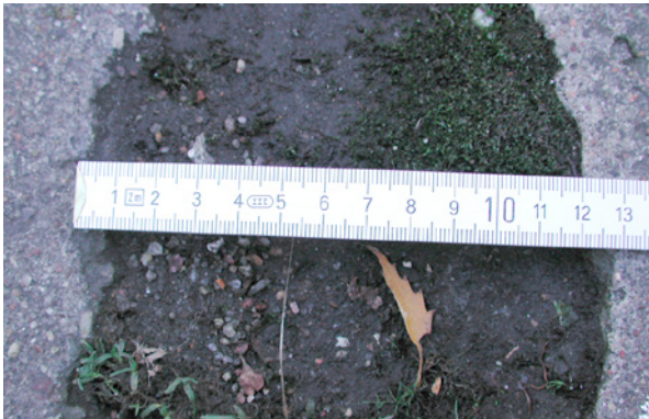
Bild 3.19: Fugen mit in ihrem Verlauf verschiedener Fugenbreite
