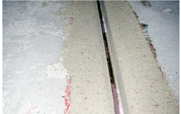
Bild 5.84: Die Kanten der Fugenflanken wurden mit einem gefertigten Schlitten über das ausgerichtete Richtscheit gezogen und in den Mörtel eingepreßt.
