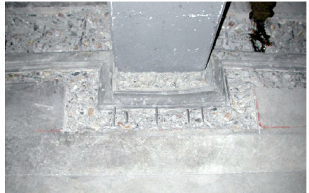
Bild 5.51: Ist-Zustand des Dehnfugenverlaufs im Bereich einer Stütze
