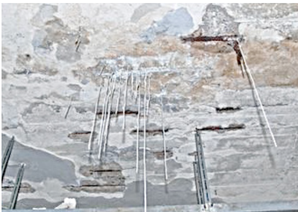
Bild 3.7: Komplexe Stahlbetonkorrosion im Wirkungsbereich eines Risses
