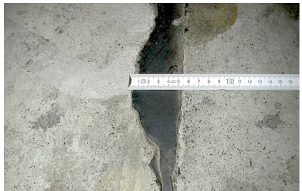
Bild 5.40: Ausgangszustand einer Bodenfuge, größte Fugenbreite: 54 mm
