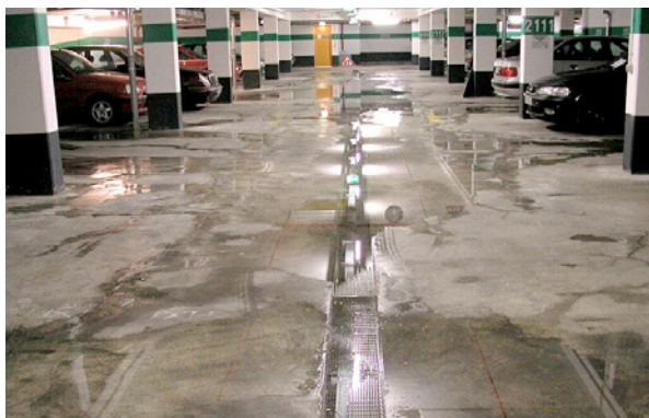
Bild 5.1: Durch Trennrisse, die sich bei Abkühlung der wasserundurchlässigen Stahlbetonkonstruktion öffnen, dringt eine für die Verdunstungsrinne nicht aufnehmbare Wassermenge ein.
