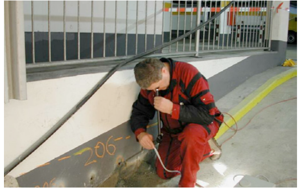
Bild 5.119: Endoskopie des Rampenanschlussbereiches
