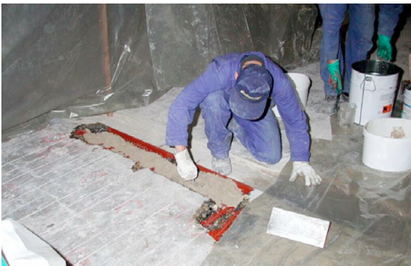
Bild 5.156: Einbringen von Epoxidharzmörtel auf eine Haftbrücke zur erforderlichen Vergrößerung der Betondeckung
