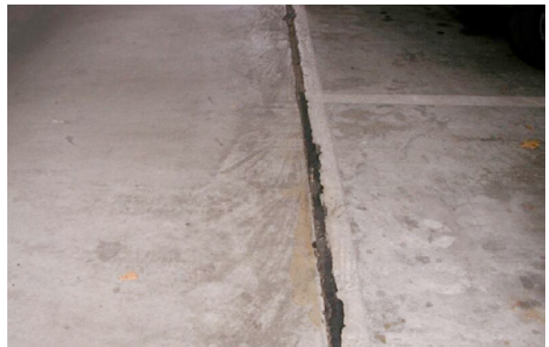
Bild 5.76: Zustand einer Arbeitsfuge vor der Instandsetzung
