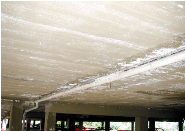
Bild 3.12: Langfristig hingegenommene undichte Fuge
