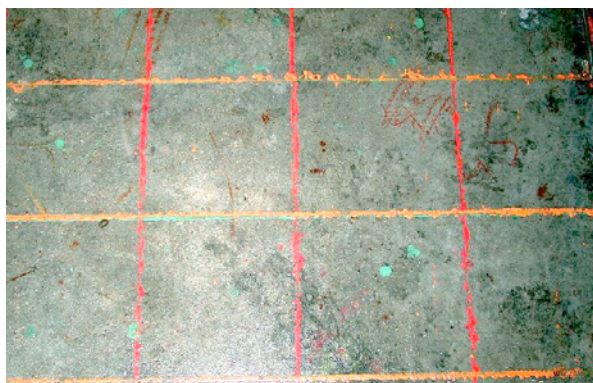
Bild 5.166: Markieren der einzubringenden Schlitzes für die Verstärkungselemente entsprechend der Vorgaben des Statikers
