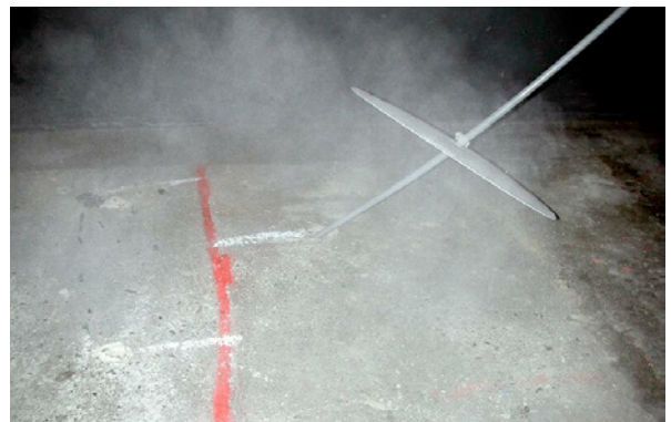
Bild 5.24: Durch das Ausblasen kann indirekt die Durchgängigkeit der Bohrungen zum Riss bzw. Hohlraum geprüft werden.
