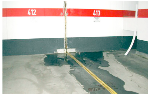
Bild 5.94: Undichte Dehnfuge in einer Tiefgarage bei größerem Grundwasserstand
