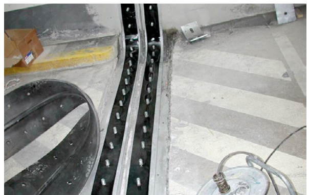
Bild 5.135: Einbau des ersten Teils der Abdichtung
