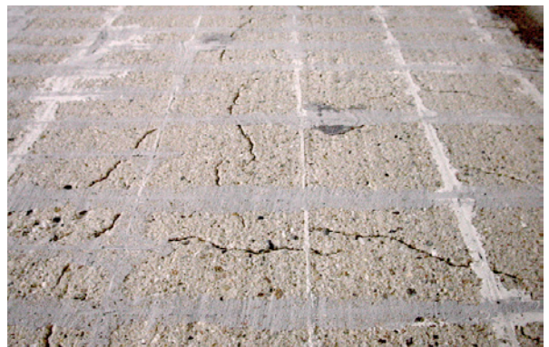
Bild 5.196: Für die Beschichtungsarbeiten vorbereitete Betonoberfläche
