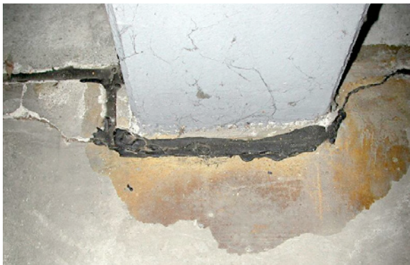
Bild 5.41: Ausgangszustand einer Randfuge mit breiten Abplatzungen zwischen Bodenfläche und einer aufgehenden Stütze einer Tiefgarage vor der Instandsetzung
