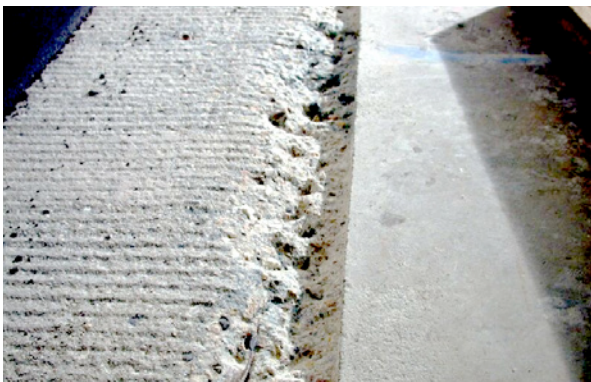
Bild 5.162: Fertiggestellter Mörtelanschlussbereich (links gefräster Bereich)
