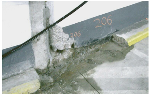
Bild 5.113: Entfernen der Sockelausbildung im Wand-Bodenplattenanschluss der Dehnfugen
