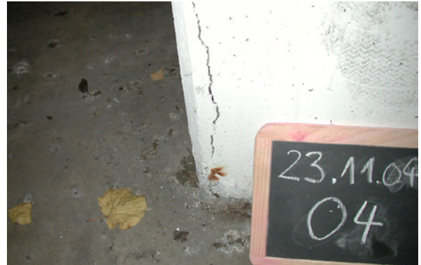
Bild 3.53: Kantenabplatzungen infolge von Bewehrungskorrosion der Stützenanschlussbewehrung
