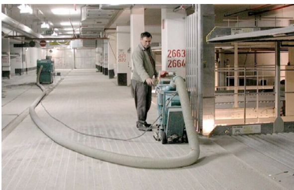
Bild 5.193: Kugelstrahlen nach dem Fräsen
