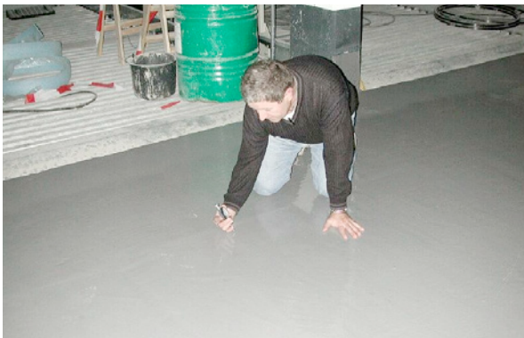
Bild 5.207: Prüfung der Schichtdicke
