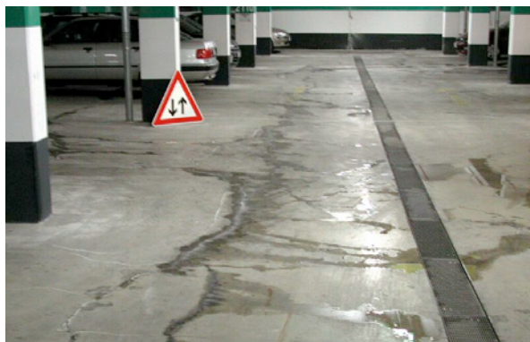
Bild 5.2: Längs und quer zur Bauwerksachse verlaufende Trennrisse können bei Abkühlung der wasserundurchlässigen Stahlbetonkonstruktion infolge Rissbreitenvergrößerung wasserführend werden.
