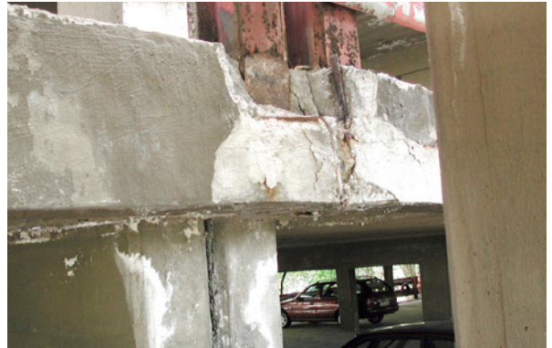
Bild 3.16: Randbereich der Deckenplatte (zu geringe Betondeckung, zu geringe Fugenbreite, keine Fugenabdichtung, Korrosion der Einbauteile durch unzureichenden Korrosionsschutz)
