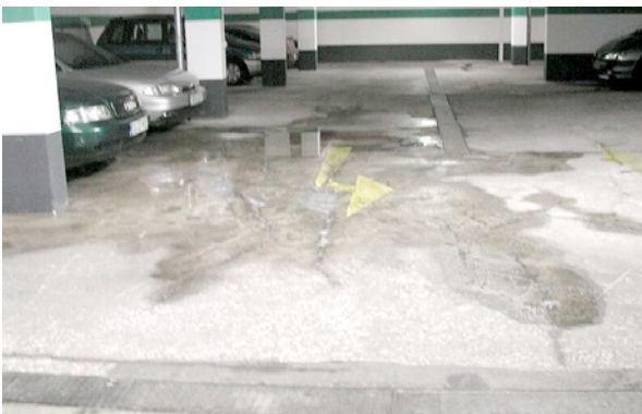
Bild 5.225: Wasserführende Risse in der Bodenplatte der wasserundurchlässigen Stahlbetonkonstruktion
