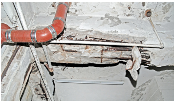
Bild 4.3: (Detail aus Bild 4.2) Bewehrungskorrosion und Betonabplatzungen im Wirkungsbereich einer langfristigen Durchfeuchtungsstelle, einhergehend mit einer Querschnittsverminderung an der Stütze und dem Balken
