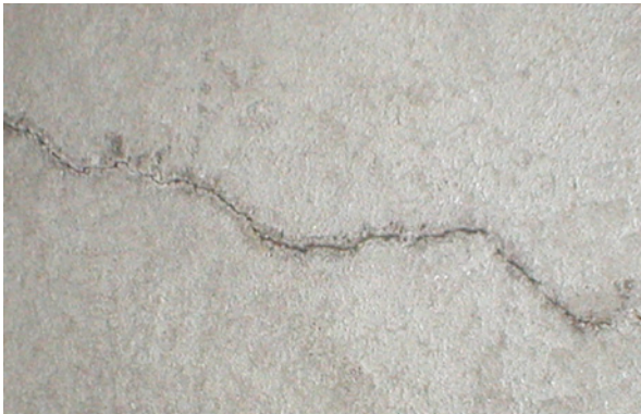
Bild 3.44: Sicht auf der Oberfläche des Oberflächenenschutzsystems OS 11 abzeichnender Riss
