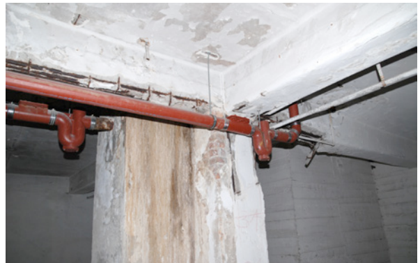
Bild 4.2: Über längere Zeit hingegenommene Durchfeuchtungen im Bereich eines Installationsschachtes führen zu Schäden, die die Tragfähigkeit des Stahlbetons in Frage stellen.
