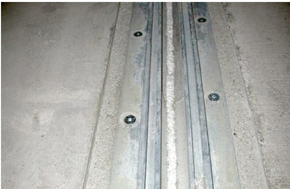
Bild 5.60: Untergossene Winkelprofile nach der Untergrundvorbereitung (Abstellung des Fugenraumes mit Schaumpolystyrolstreifen)
