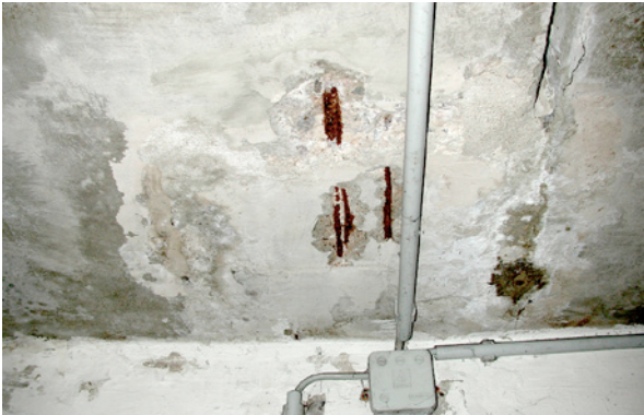
Bild 3.58: Chloridinduzierte Bewehrungskorrosion an der Deckenunterseite in der Nähe einer undichten Fuge
