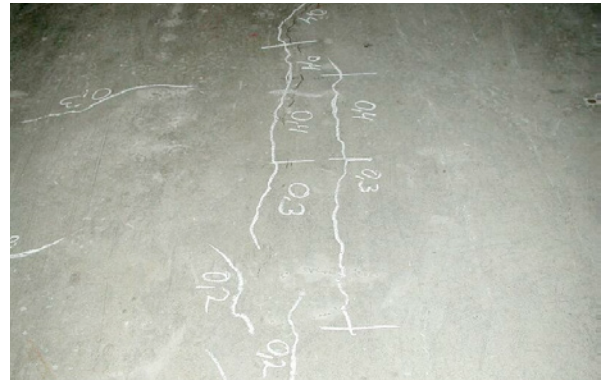
Bild 5.6: Der Verlauf der an der Oberfläche sichtbaren Risse sollte schon im noch trockenen Zustand gekennzeichnet werden, wobei die Ausgangsrisssbreite an der Bauteiloberfläche mit erfasst wird.
