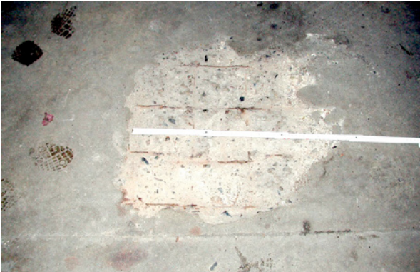
Bild 3.56: Freigelegte korrodierte obere Bewehrungslage einer Tiefgaragenbodenplatte
