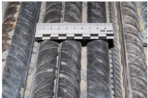
Bild 3.6: Zu dichte obere Bewehrungslage
