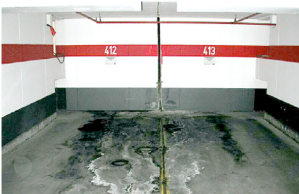
Bild 5.93: Undichte Dehnfuge in einer Tiefgarage bei geringerem Grundwasserstand
