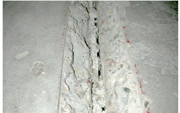
Bild 5.78: Fuge nach dem Ausstemmen des eingeschnittenen Betons der Fugenflanken und der Entnahme des alten Fugendichtstoffes
