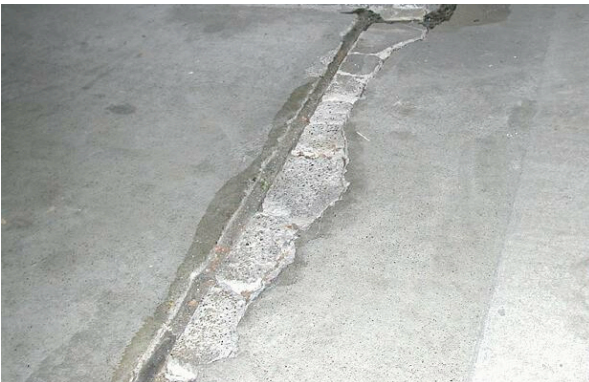
Bild 5.45: Einseitige Betonabplatzungen an einer Dehnfuge im Bereich einer Überfahrt der Tiefgarage
