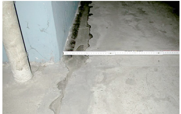
Bild 5.38: Ausgangszustand einer Randfuge zwischen Bodenfläche und einer aufgehenden Wand einer Tiefgarage vor der Instandsetzung
