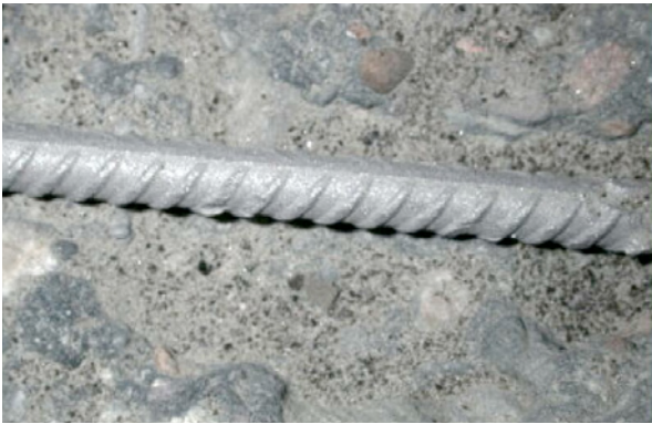
Bild 5.154: Sandgestrahlte freigelegte Bewehrung
