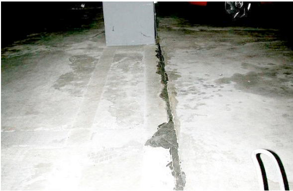
Bild 5.43: Dehnfuge mit großen Fugenbreitenschwankungen und Abplatzungen der Fugenflanken vor der Fugeninstandsetzung
