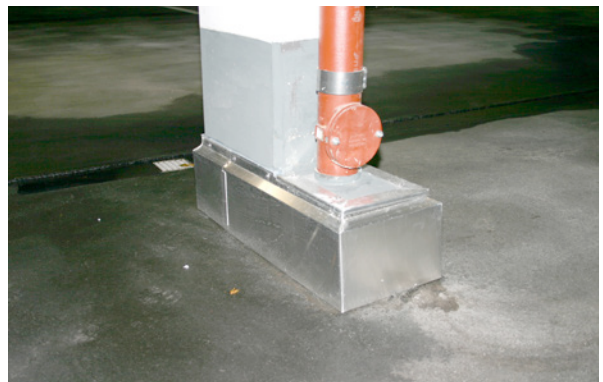
Bild 4.24: Sockelbereich einer Stütze mit integrierter Durchdringung
