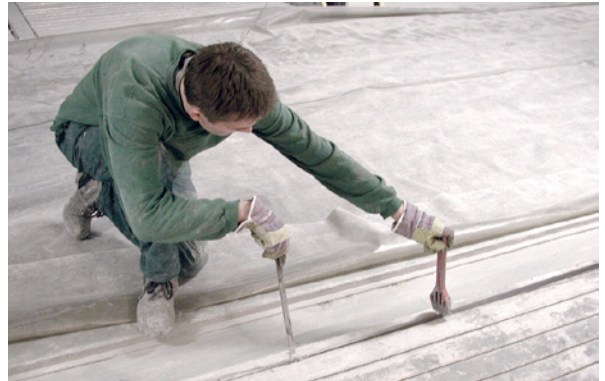
Bild 5.184: Nacharbeiten und Korrektur der Lage der Verstärkungselemente
