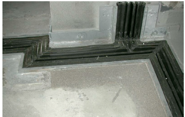
Bild 5.74: Dehnfugenanschlussbereich
