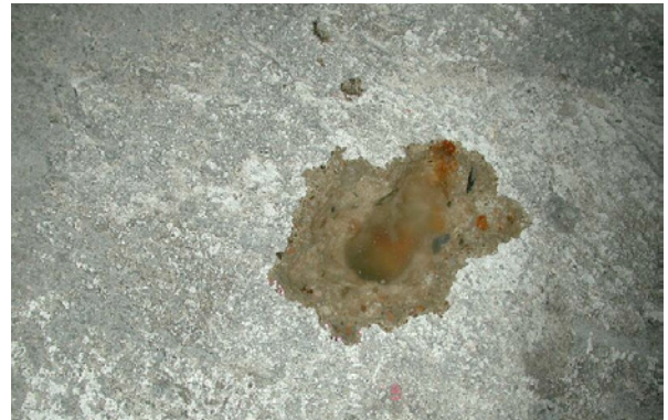
Bild 5.32: Vergossene Bohrung eines Einfüllstutzens
