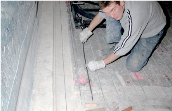
Bild 5.183: Einbau der Verstärkungselemente
