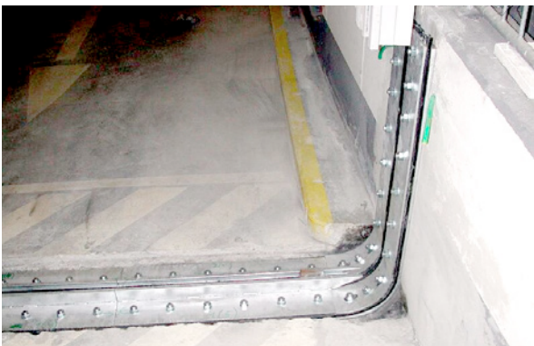
Bild 5.140: Ansicht der kompletten eingebauten unteren Abdichtungsebene
