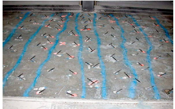
Bild 5.28: Gerissener Bodenplattenbereich einer Tiefgaragenbodenplatte mit eingebrachten Einfüllstutzen
