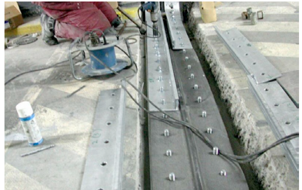
Bild 5.139: Ausrichten der oberen Fugenprofile
