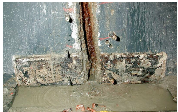
Bild 5.97: Unwirksames Fassen des Leckwassers an der Fuge
