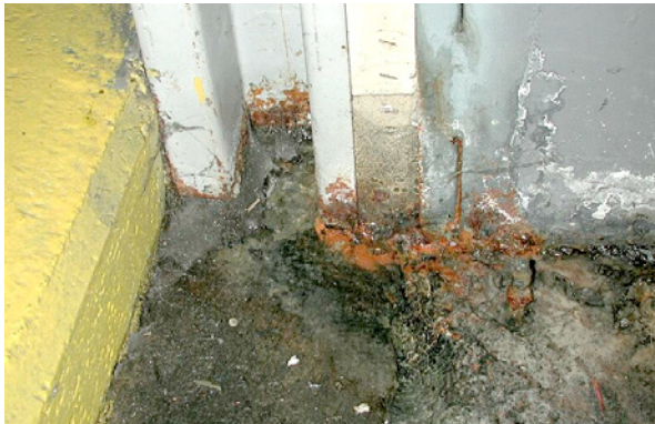
Bild 5.114: Ist-Zustand im Fußbereich der Dehnfuge nach Entfernen des Sockels
