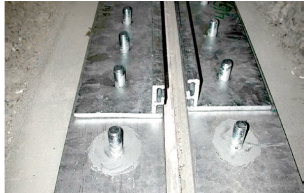
Bild 5.127: Anpassung und Ausrichtung der Stahlprofile
