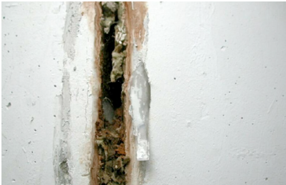
Bild 5.95: Wassergesättigtes Dämm-Material in der Fuge
