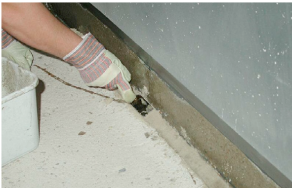
Bild 5.199: Einbringen eines Epoxidharzmörtelkeils in die Anschlussbereiche zwischen horizontalen und vertikalen zu schützenden Flächen, hier Bodenplatte – Decke/Wand
