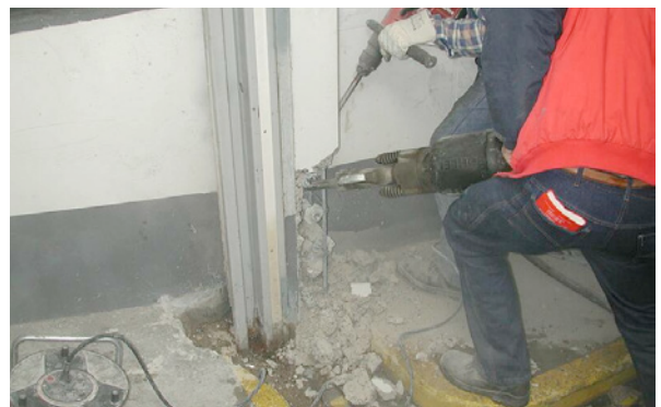
Bild 5.112: Entfernen der Wandvorlagen der Stahlbetonwände im Dehnfugenbereich
