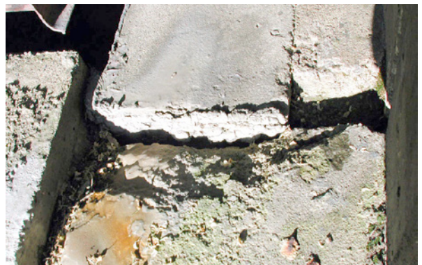
Bild 3.18: Zu gering dimensionierte Fertigteilfugen, schlechte Instandhaltung
