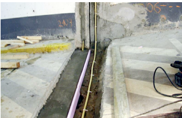
Bild 5.122: Reprofilierung der Dehnfugenflanken, Abdichtung des Rampenanschlusses mittels Injektionsschlauch
