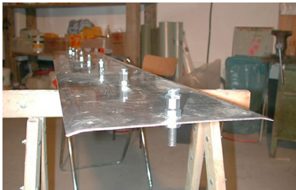
Bild 5.98: Vorgefertigtes Abdeckprofil für die Dehnfuge mit eingebauten Einfüllstutzen für die geplante Verfüllung der Dehnfuge mit Acrylatgel
