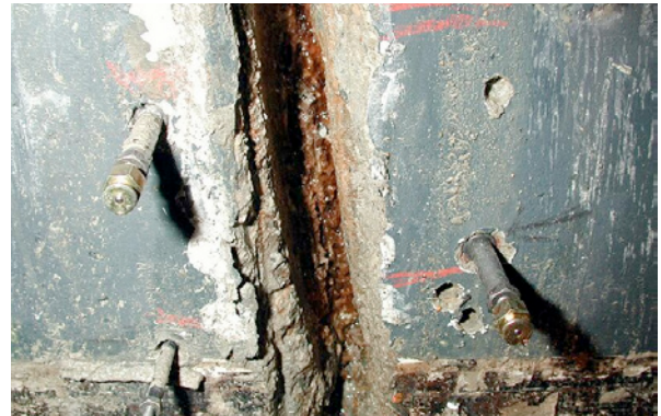
Bild 5.96: Undichte Dehnfuge nach Injektionen mit Acrylatgel
