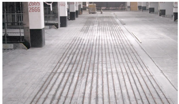
Bild 5.173: Längs der Bauwerksachse eingebrachte Schlitzte zur Aufnahme der Verstärkungselemente (quer verlaufen die blau markierten Risse)
