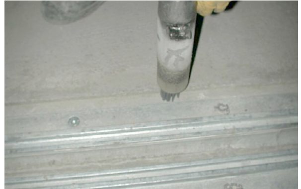
Bild 5.59: Untergrundvorbereitung der Vergussmörtelflächen mit der Nadelpistole
