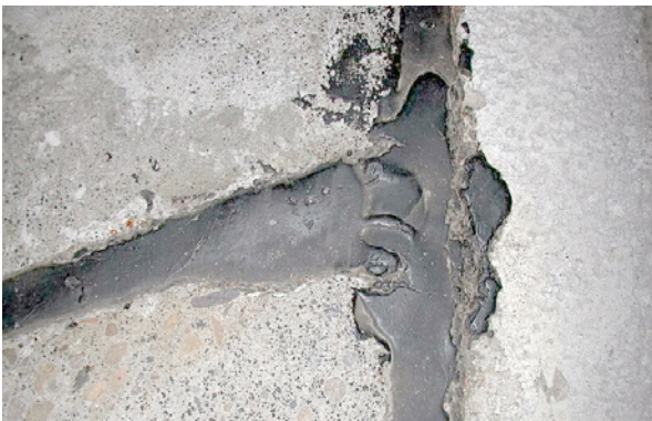
Bild 5.70: Anschluss einer Dehnfuge an eine Arbeitsfuge vor der Instandsetzung
