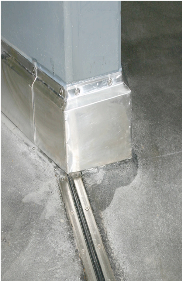
Bild 4.25: Wandanschluss einer Bewegungsfuge
