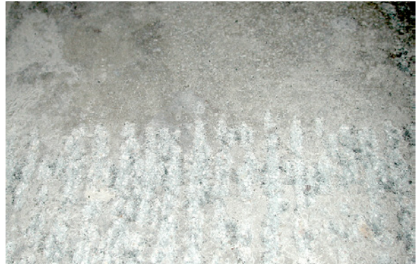
Bild 5.192: Zustand der gefrästen Betonoberfläche
