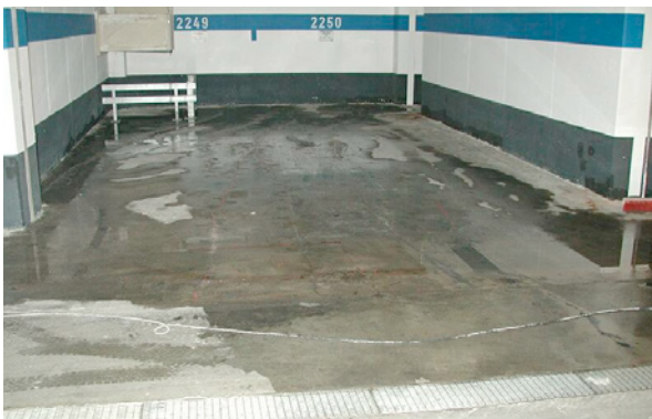
Bild 5.35: Teilfläche in einer Tiefgarage vor dem Abdichten der Risse
