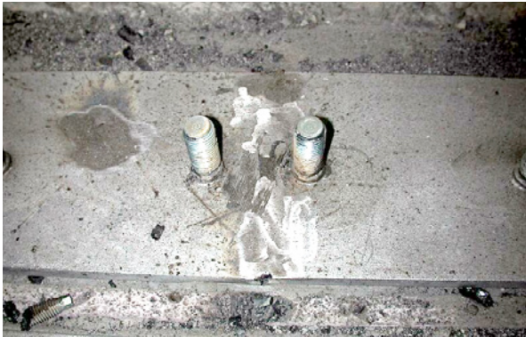
Bild 5.132: Verankerte untere Abdichtungsebene
