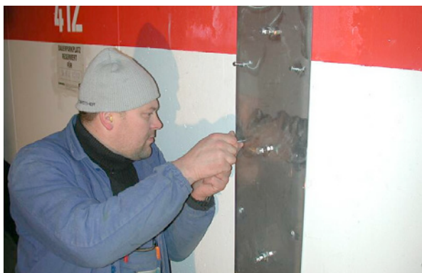
Bild 5.100: Befestigung des Abdeckprofils und Abdichtung des Verfüllraums der Dehnfuge
