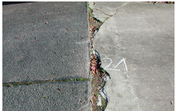
Bild 3.29: Ausgebrochene Fugenflanken an Rampenfuge
