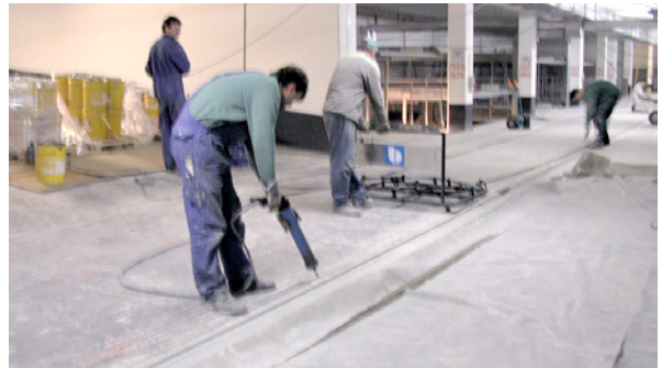
Bild 5.181: Arbeitsschritte von Verstärkungsarbeiten in einer Tiefgarage, vorne Einbringen des Klebers, mittig Einbringen des Verstärkungselementes vom Abrollwagen, hinten Korrektur der Lage des Verstärkungselementes
