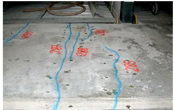
Bild 5.34: Injizierte Risse nach Abschluss der Rissabdichtung
