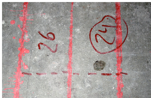
Bild 5.167: Kennzeichnung der vorhandenen Betondeckung (Grenzgebiete)
