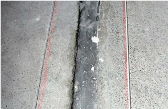
Bild 5.77: Einschnneiden der Fugenflanken
