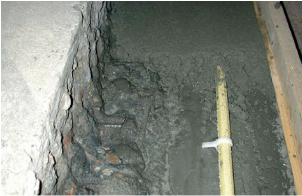
Bild 5.124: Reprofilierung des Rampenanschlusses
