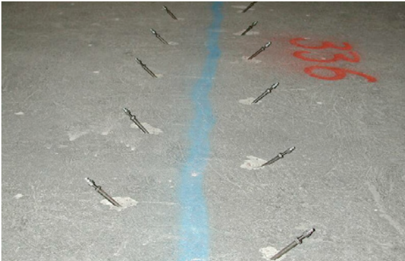
Bild 5.27: Gemäß Instandsetzungsrichtlinie wechselseitig um 45° geneigt eingebrachte Einfüllstutzen
