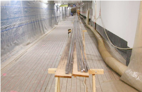
Bild 5.174: Auf Länge geschnittene Verstärkungselemente
