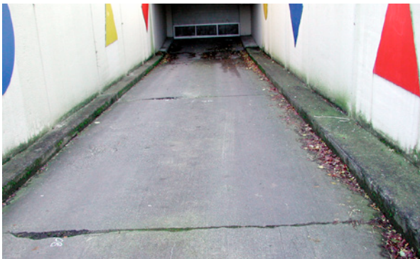
Bild 3.28: Schlechter Wartungszustand der Rampenzufahrt, ausgebrochene Fugenränder, verschlissener Fugendichtstoff, ungleichmäßige Fugenbreite, schlechte Reinigung
