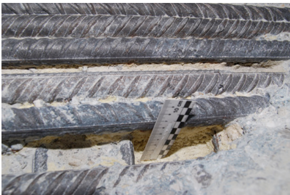
Bild 3.5: Zu enge obere Bewehrungslagen stellen die Betonierbarkeit der Bauteile in Frage, unterhalb der Bewehrung bilden sich Hohlräume infolge unzureichender Verdichtung.
