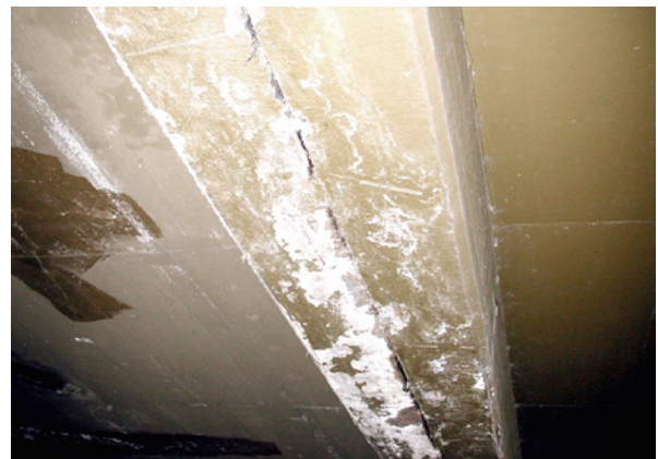
Bild 3.15: Undichte Bauwerksfugen zwischen zwei Randbalken der Deckenfelder
