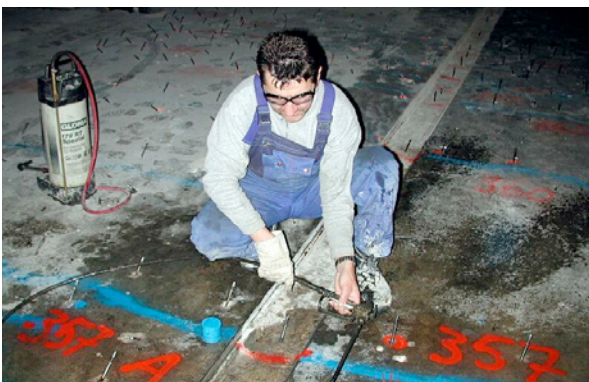
Bild 5.29: Rissinjektion ohne Verdämmung der Risse
