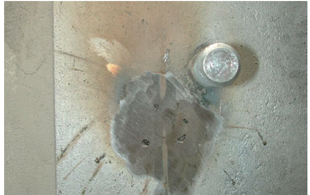
Bild 5.131: Verschweißen und Verschleifen des Ankers
