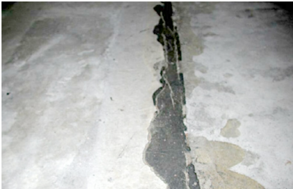
Bild 5.37: Ausgangszustand von Fugen einer Bodenfläche einer Tiefgarage vor der Instandsetzung
