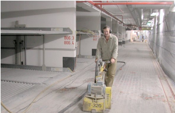
Bild 5.191: Leichtes Fräsen der verstärkten Tiefgaragen-Bereiche
