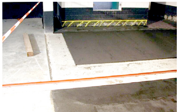
Bild 5.163: Erhöhung der Betondeckung im Verstärkungsbereich mit Epoxidharzmörtel (dunkle Flächen)
