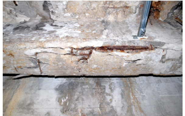
Bild 3.59: Starke Abrostung durch hohen Feuchte- und Chloridgehalt, Einschränkung der Tragfähigkeit
