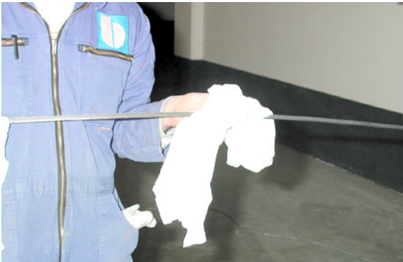
Bild 5.176: Reinigung der Verstärkungselemente vor dem Kleben
