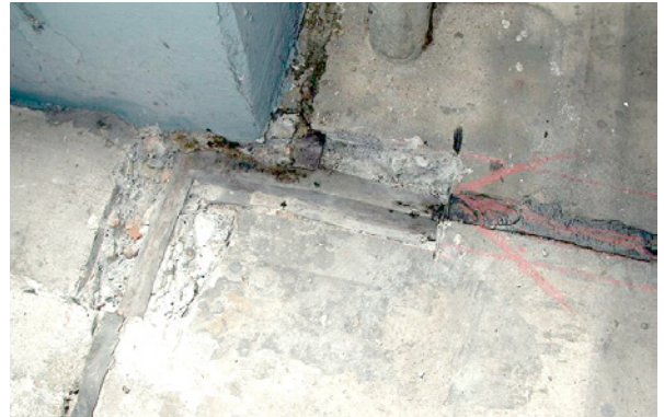
Bild 5.49: Freigelegter Dehnfugenbandanschluss im Anschlussbereich zwischen Bodenplatte und aufgehender Wand
