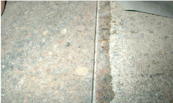
Bild 5.201: Begrenzen der Arbeitsabschnitte durch Kellschnitt in frisch eingebrachten Mörtel bzw. Einschnitten (siehe Bild 5.202)
