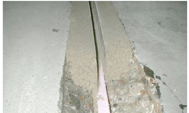
Bild 5.80: Grundieren mit Epoxidharz und Einbau des Epoxidharzmörtels zur Reprofilierung der Fugenflanken (Profilierung siehe Bild 5.83)
