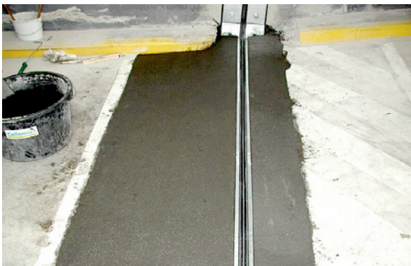
Bild 5.146: Fertig reprofilierte Fugenflanken nach Einbau der Dehnfugenkonstruktion
