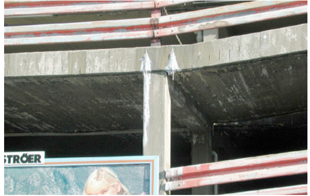
Bild 3.25: Salzablagerungen an den Fugen der Rampenkonstruktion, mangelhafte Betondeckung an den Tropfkanten
