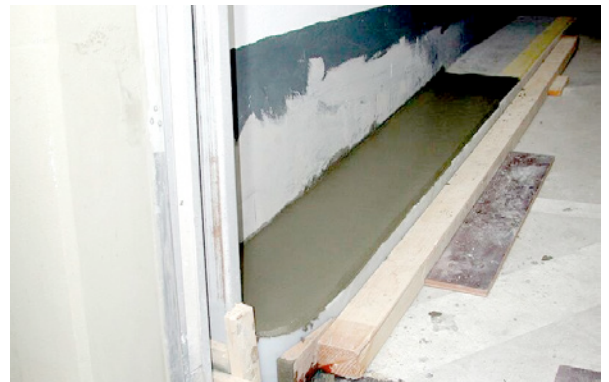
Bild 5.149: Einbau des Sockels im Bereich der Rampe
