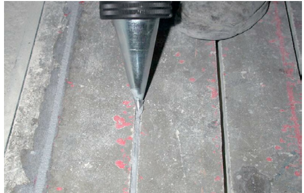
Bild 5.180: Mündungsstück der Kleberpistole
