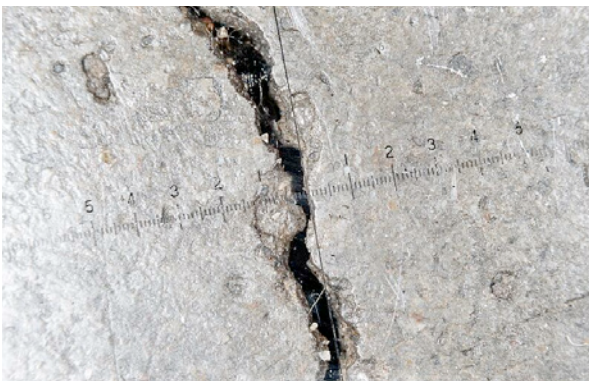
Bild 5.13: Messung und Dokumentation der Ausgangsrisssbreite an der Bauteiloberfläche.
