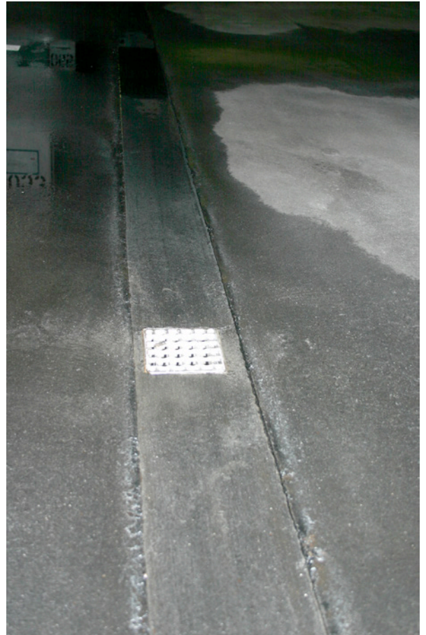
Bild 4.26: Rinnenausbildung mit Einlauf im Gussasphalt
