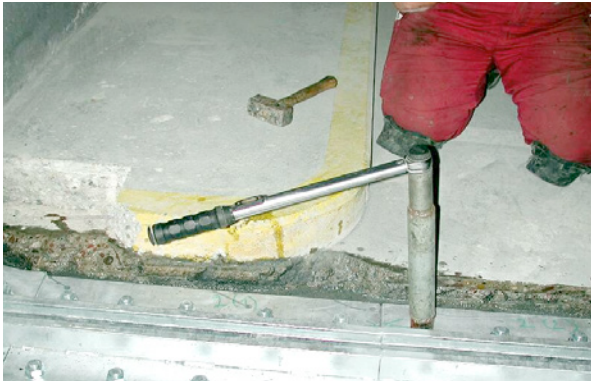
Bild 5.142: Nachspannen der Abdichtungsprofile
