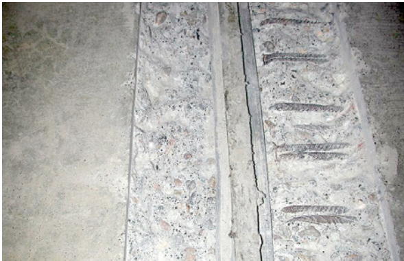
Bild 5.50: Deutlich sichtbare Unterschiede der vorgefundnenen Betondeckung an den Fugenflanken der Dehnfuge
