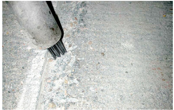
Bild 5.161: Untergrundvorbereitung der freigestemten Bereiche mit der Nadelpistole
