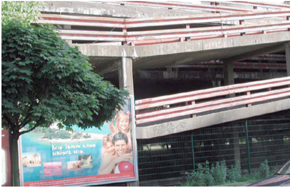
Bild 3.24: An der Rampe sichtbarer schlechter Wartungszustand eines Parkdecks
