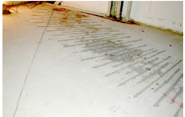
Bild 5.186: Verstärkung eines Einzerrisses (»Vernadeln«)
