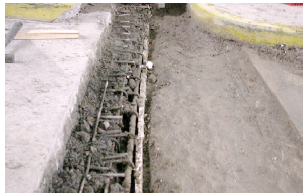
Bild 5.117: Freilegen der Stahlbetonanschlussbereiche und Abstellung der Fuge
