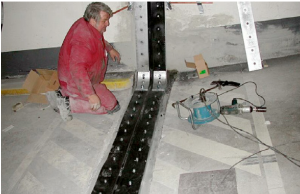
Bild 5.138: Aufbringen der oberen Fugenprofile
