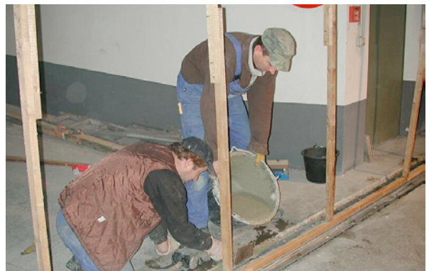
Bilder 5.56, 5.57: Untergießen der ausgerichteten Winkelprofile mit zementgebundenem Vergussmörtel
