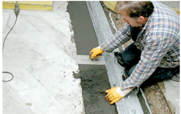
Bild 5.145: Einbau von Kunstharzmörtel
