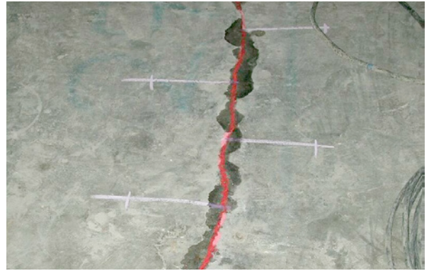
Bild 5.16: Die wasserbeständige Markierung der Bohrausgangspunkte und des Rissverlaufs ist notwendig für die ordnungsgemäße Durchführung der abdichtenden Rissinjektionen.
