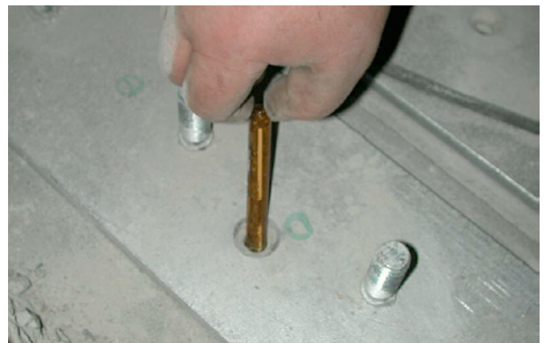
Bild 5.129: Einbau der Kunstharzampulle
