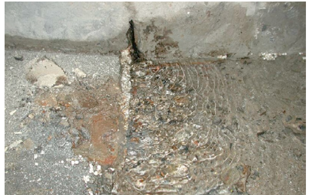
Bild 5.115: Deutlich sichtbare hohe Intensität des Wasserdurchtritts in der Dehnfuge am Rampenanschluss
