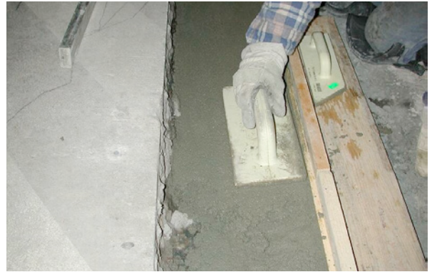
Bild 5.125: Reprofilierung der Fugenflanken, Vorbereitung zur Aufnahme der Dehnfugenabdichtungskonstruktion
