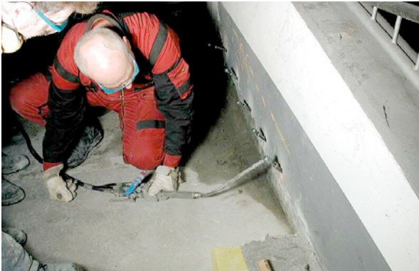
Bild 5.118: Vergelung des Rampenanschlussbereiches (undichte Arbeitsfuge)
