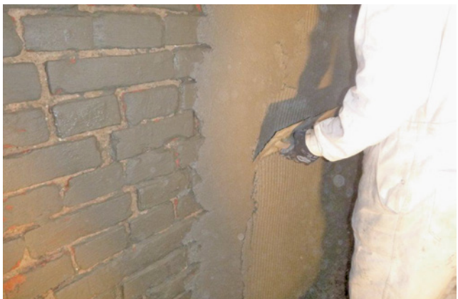
Bild 71 Sperrputzsystem (Bildquelle: Braun Bauwerksabdichtung, Weingarten)
