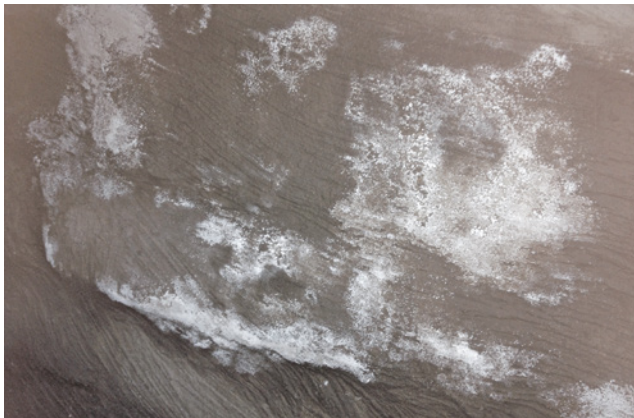
Bild 81 Salzausblühungen auf Zementputz
