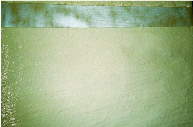
Bild 68 Kennzeichnung des zweiten Auftrags (Bildquelle: Becker Bauwerksabdichtungen, Großbeeren)
