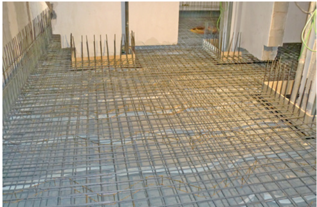
Bild 4 Einteilung der Betonierabschnitte und Einbau der Bewehrung (Bildquelle: Schleiff Bauflächentechnik GmbH & Co. KG, Erkelenz)
