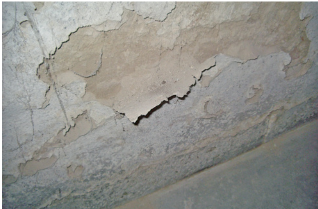
Bild 28 Anstrich- und Putzschäden einer durchfeuchteten Kellerwand
