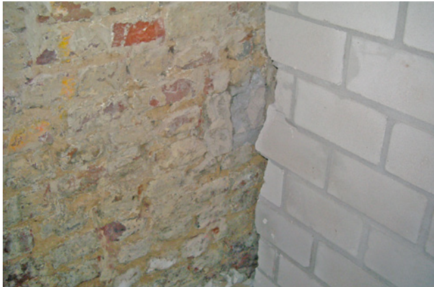
Bild 58 Wandschlitzeinbindende Querwand (Bildquelle: AMS, Gutenswegen)
