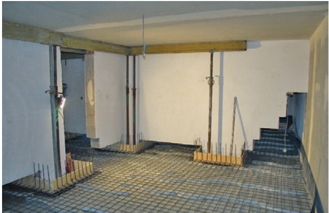
Bild 7 Einteilung der Betonierabschnitte und vorbereitende Arbeiten (Bildquelle: Schleiff Bauflächentechnik GmbH & Co. KG, Erkelenz)
