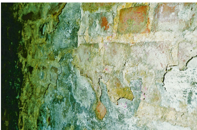
Bild 38 Putzerstörung
