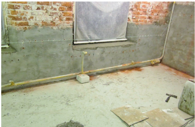
Bild 48 Untergrundvorbereitungen abgeschlossen, mit Bohrlochkette (Bildquelle: MARKO Bautenschutz, Gnarrenburg)
