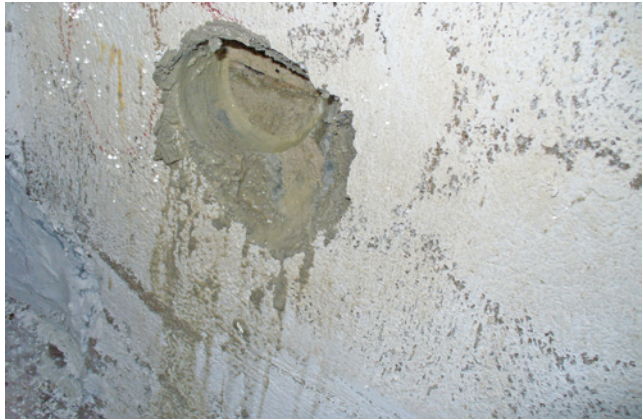
Bild 86 Bohrkernentnahme (Bildquelle: Schleiff Bauflächentechnik, Erkelenz)
