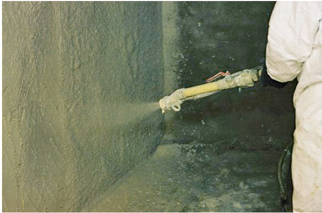
Bild 35 Sperrputzauftrag mittels Putzmaschine (Bildquelle: Adolphs Bautenschutz, Engelskirchen)
