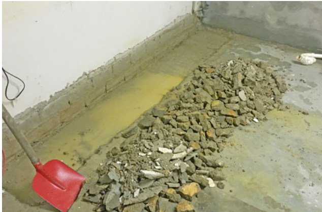
Bild 77 Wand-Sohlenanschlussbereich freigelegt (Bildquelle: Peter Gessert, Süderdeich)
