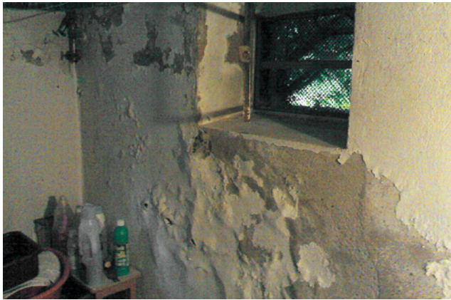
Bild 21 Salzgeschädigtes Mauerwerk
