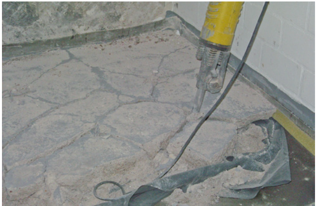
Bild 40 Rückbau eines Estrichbelages (Bildquelle: Schleiff Bauflächentechnik, Erkelenz)
