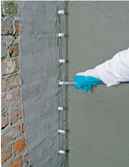
Bild 102 Injektion mit Niederdruck (Bildquelle: Remmers Baustofftechnik, Lönigen)
