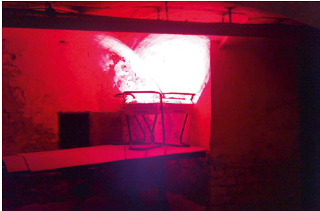
Bild 110 Infrarot-Hellstrahler (Gas)
