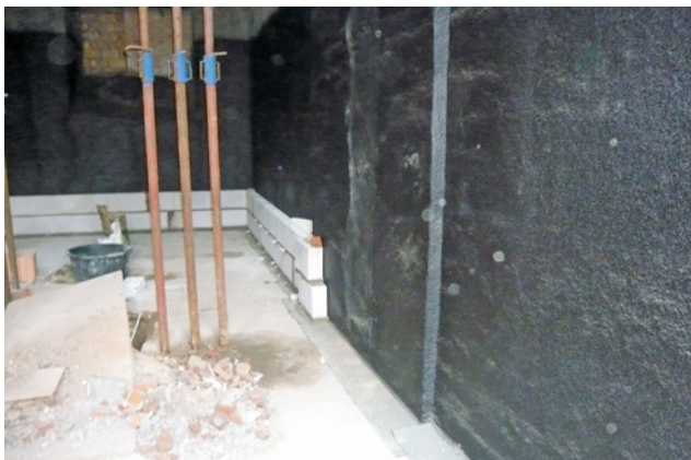
Bild 84 Bituminöse Innenabdichtung mit Vormauerschale als Wanne-in-Wanne-System
