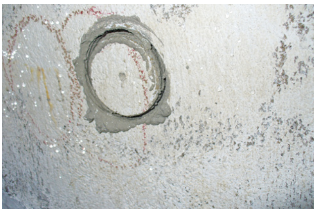
Bild 85 Bohrkernbohrung (Bildquelle: Schleiff Bauflächentechnik, Erkelenz)
