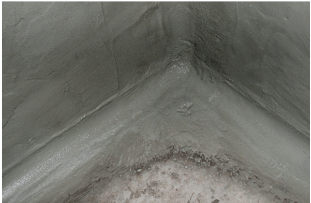
Bild 70 Inneneckenausrundung mit Dichtungsmörtel (Bildquelle: Becker Bauwerksabdichtungen, Großbeeren)
