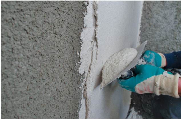
Bild 90 Sanierputzauftrag (Bildquelle: Andre von Grönheim-Benten, Lindern)
