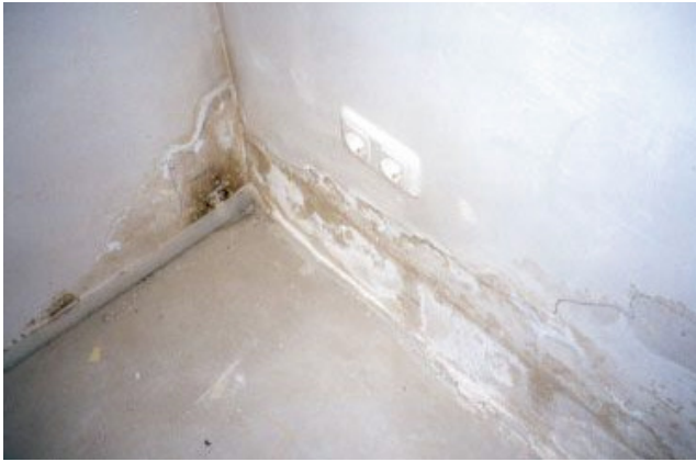
Bild 51 Schadensbild Wand-Sohlenanschluss (Bildquelle: R. Spigatis)
