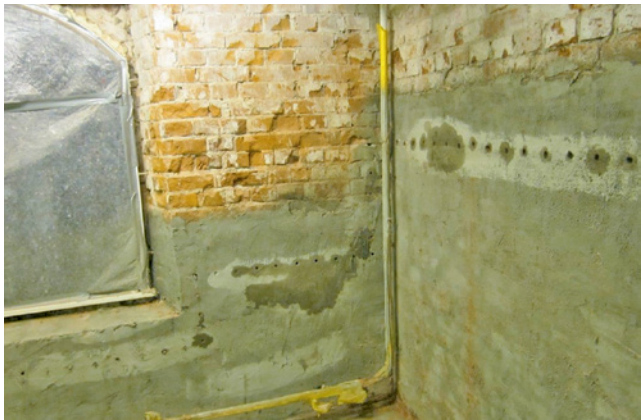
Bild 32 Anschluss der Bohrlochsperrung am Kopfpunkt der Innenabdichtung (Bildquelle: MARKO Bautenschutz, Gnarrenburg)
