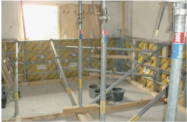
Bild 3 Passgenaue Schalelemente (Bildquelle: Schleiff Bauflächentechnik GmbH & Co. KG, Erkelenz)
