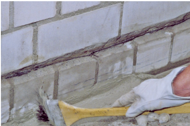
Bild 52 Nutvorbereitung (Bildquelle: MARKO Bautenschutz, Gnarrenburg)
