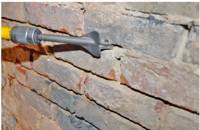
Bild 41 Fugen ausräumen (Bildquelle: Dittmann Bausanierung, Oranienburg)
