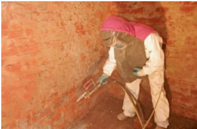
Bild 42 Untergrundvorbehandlung mittels Strahlen (Bildquelle: Paul Mastall, Löningen)
