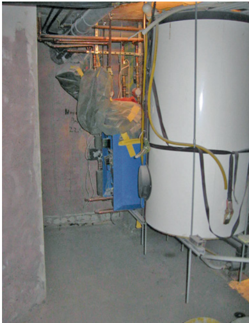
Bild 6 Umbau und Aufhängung der Heizungsanlage (Bildquelle: Schleiff Bauflächentechnik GmbH & Co. KG, Erkelenz)
