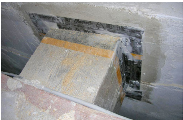
Bild 127 Detaildarstellung der Ummantelung eines Holzbalkens mit dampfbremsendem Klebeband vor dem Anbringen einer kapillaraktiven Innendämmung
