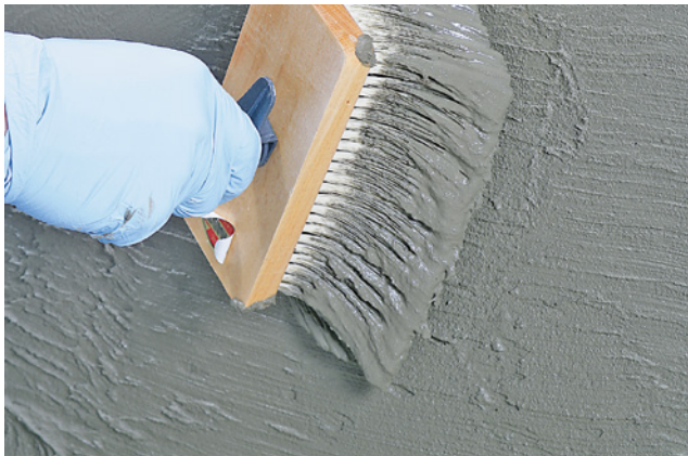
Bild 64 MDS-Schlämmauftrag (Bildquelle: Remmers Baustofftechnik, Löningen)
