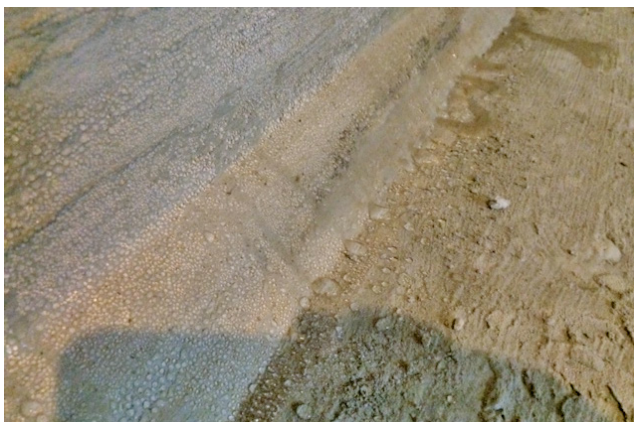
Bild 61 Kondensat auf der Innenabdichtung
