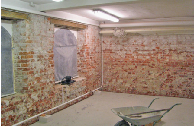
Bild 46 Untergrundvorbereitungen (Bildquelle: MARKO Bautenschutz, Gnarrenburg)
