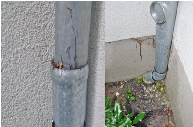
Bild 20 Eine verstopfte Regenentwässerung ist die Ursache der Durchfeuchtung im Keller. Die Veränderung des Lastfalls überfordert die vorhandene Abdichtung. Die partielle Innenabdichtung führt in diesem Beispiel nicht zum Erfolg.
