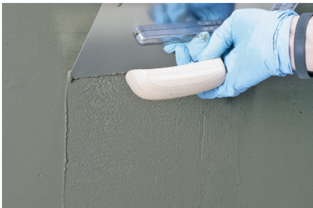
Bild 65 MDS-Spachtelauftrag (Bildquelle: Remmers Baustofftechnik, Löningen)
