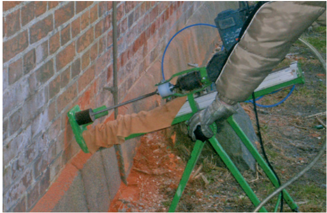
Bild 101 Bohrstände (Bildquelle: Georgy Mauersägetechnik, Blankenhain)
