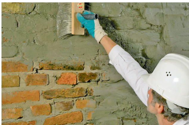
Bild 49 Haftschrämmenauftrag (Bildquelle: Remmers Baustofftechnik, Lönningen)
