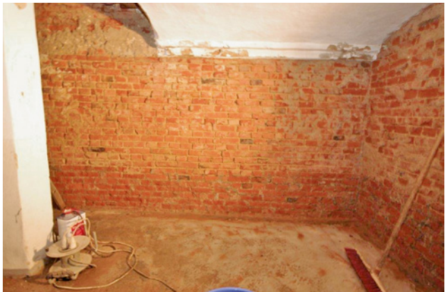
Bild 43 Untergrund- vorbereitungen, abgeschlossen (Bildquelle: Paul Mastall, Löningen)
