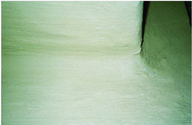
Bild 54 Außenecke gebrochen und Dichtungskehle im Übergangsbereich Außenecke- Wand-Sohle
