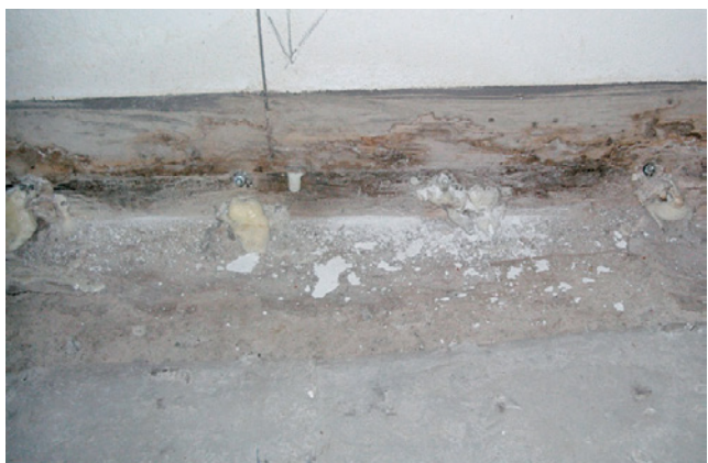
Bild 36 Vordichtung mit PUR-Schaum (Bildquelle: AMS, Gutenswegen)
