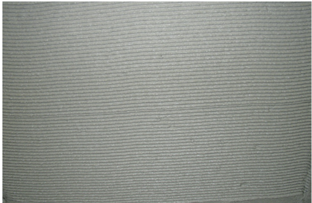
Bild 73 Spitzzahnaufkämmung des Sanierputzes (Bildquelle: Fa. Lorenz Andresen Sanierungstechnik, Handewitt)
