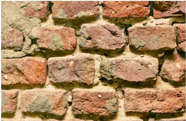
Bild 47 Gestrahltes Ziegelmauerwerk
