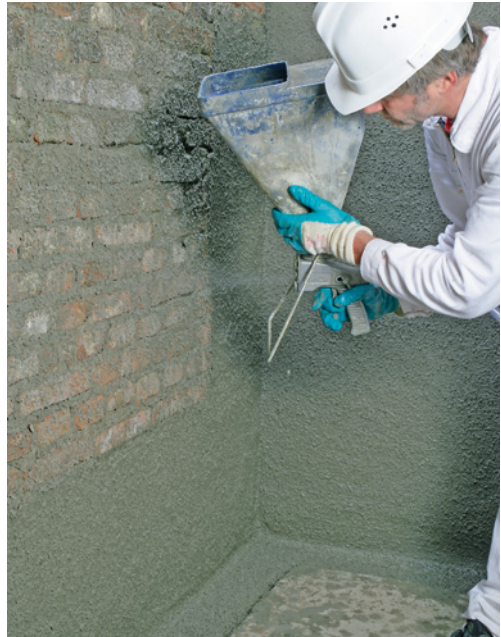
Bild 89 Spritzbewurfauftrag mit Trichterpistole; links Innenwand, auf saugfähigem Mauerwerk: 50 bis 70 % Deckungsfläche; rechts Außenwand mit MDS-Abdichtung: 100 % Deckungsfläche (Bildquelle: Remmers Baustofftechnik, Lönningen)
