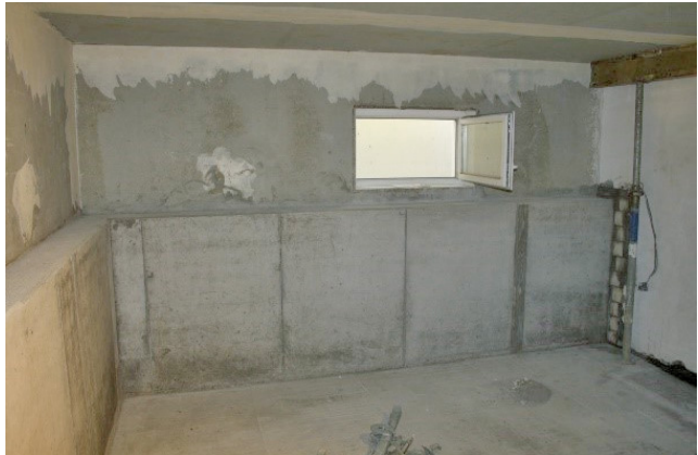
Bild 15 Fertige Weiße Wanne im Rohbauzustand (Bildquelle: Schleiff Bauflächentechnik GmbH & Co. KG, Erkelenz)
