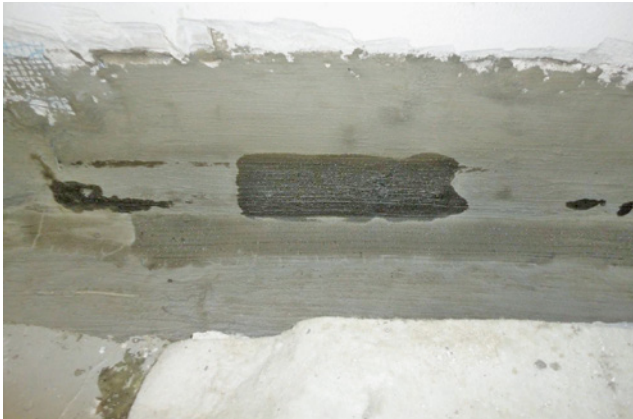
Bild 37 Undichter Wand-Sohlenanschluss
