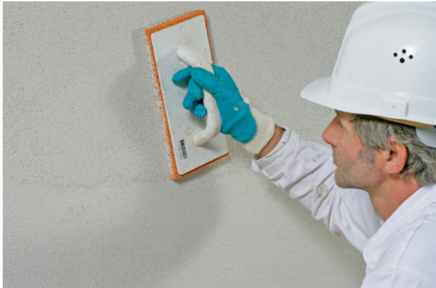
Bild 95 Sanierputz ausreiben (Bildquelle: Remmers Baustofftechnik, Löningen)
