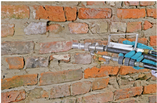
Bild 44 Wirbelstrahlverfahren (Bildquelle: Remmers Baustofftechnik, Löningen)
