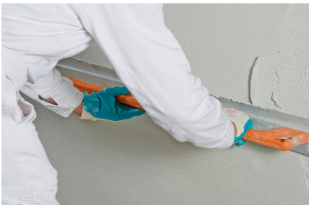
Bild 93 Sanierputz kartätschen (Bildquelle: Remmers Baustofftechnik, Löningen)
