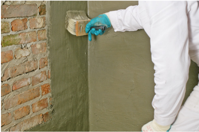
Bild 34 MDS teil- bzw. vollflächig mittels Schlämmverfahren auftragen (Bildquelle: Remmers Baustofftechnik, Lönningen)
