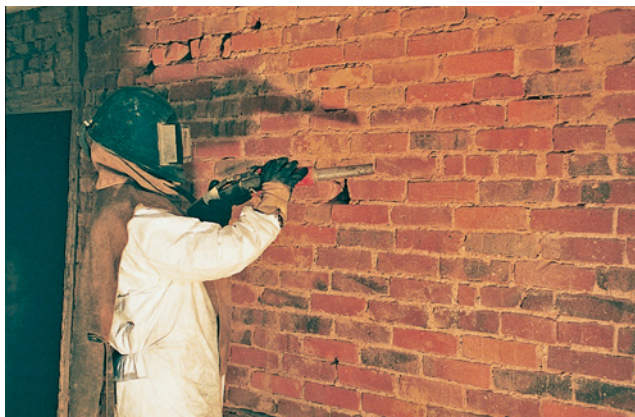
Bild 88 Sandstrahlverfahren zur Untergrundvorbereitung
