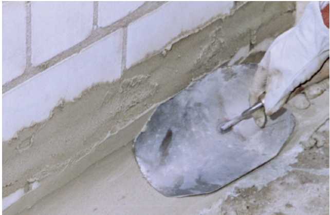
Bild 53 Nutverschluss und Dichtkehlenausrundung (Bildquelle: MARKO Bautenschutz, Gnarrenburg)
