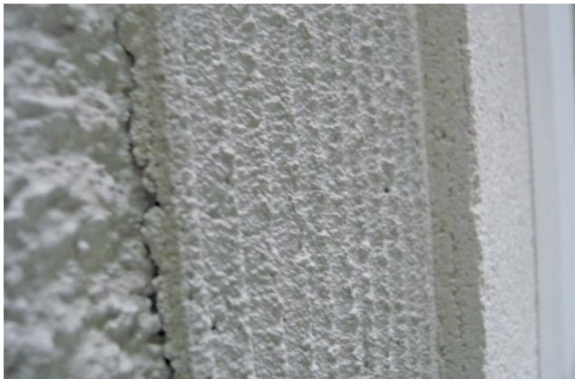
Bild 99 Zweilagiges Sanierputzsystem mit Deckschicht (Bildquelle: Adolphs Bautenschutz, Engelskirchen)
