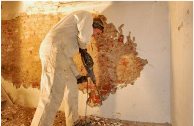
Bild 39 Putzrückbau mittels Abbauhammer (Bildquelle: Paul Mastall, Löningen)
