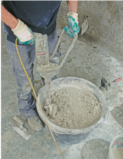
Bild 83 Sanierputzaufbereitung mit Doppelwellenmischer (Bildquelle: Andre von Grönheim-Benten, Lönningen)
