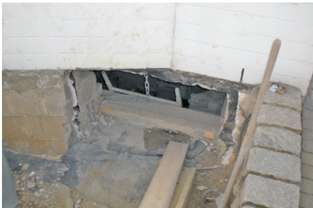
Bild 2 Herstellung eines Baustellenzugangs (Bildquelle: Schleiff Baufächentechnik GmbH & Co. KG, Erkelenz)
