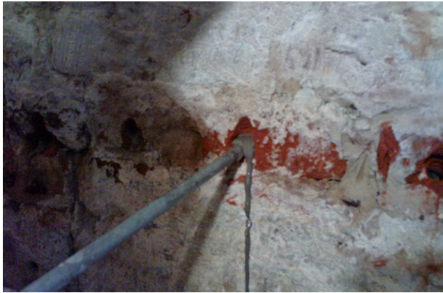
Bild 22 Verfüllen von Hohlräumen
