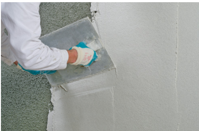
Bild 92 Sanierputz auftragen (Bildquelle: Remmers Baustofftechnik, Löningen)
