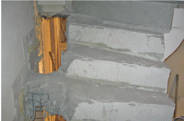
Bild 5 Vorbereitete Kellertreppe (Bildquelle: Schleiff Bauflächentechnik GmbH & Co. KG, Erkelenz)
