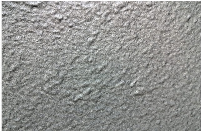
Bild 67 MDS-Oberfläche, gespritzt und mit Druckluft zerstäubt (Bildquelle: Becker Bauwerksabdichtungen, Großbeeren)
