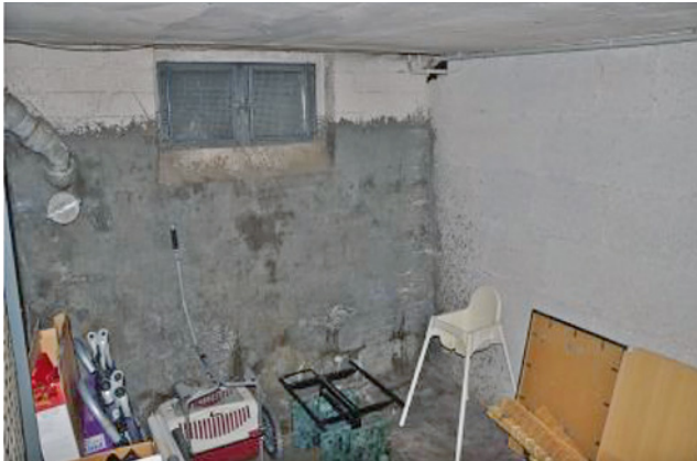
Bild 19 Funktionslose Innenabdichtung
