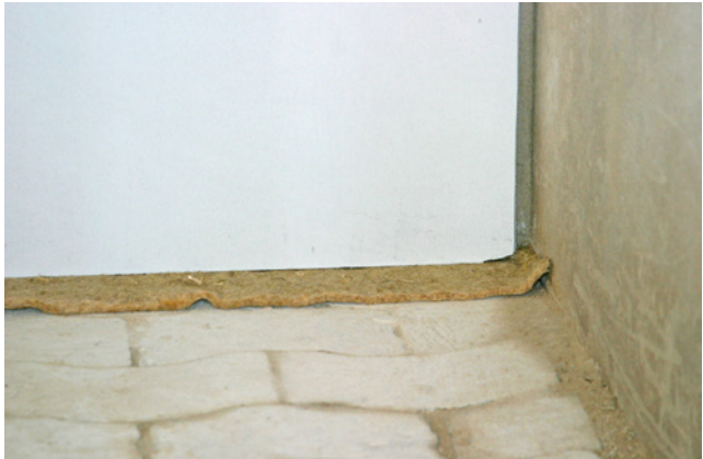
Bild 126 Einbau eines Randtrennstreifens im Boden-Aufstandsbereich der Innendämmung (Bildquelle: Calsitherm Silikatbaustoffe, Paderborn)
