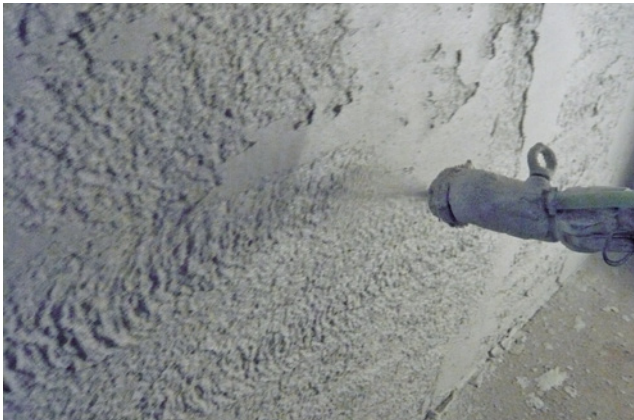
Bild 91 Sanierputzauftrag mit Putzmaschine (Bildquelle: Jörg Möller, Mellingen)
