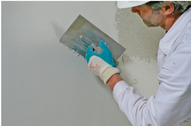
Bild 96 Sanierputz/Feinputz (Bildquelle: Remmers Baustofftechnik, Löningen)
