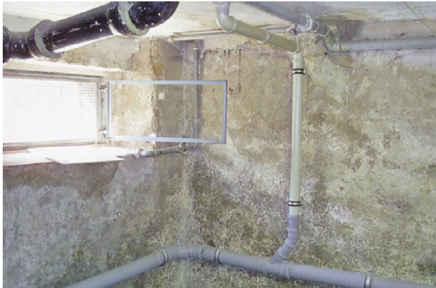
Bild 27 Feuchte- und salzgeschädigter Keller
