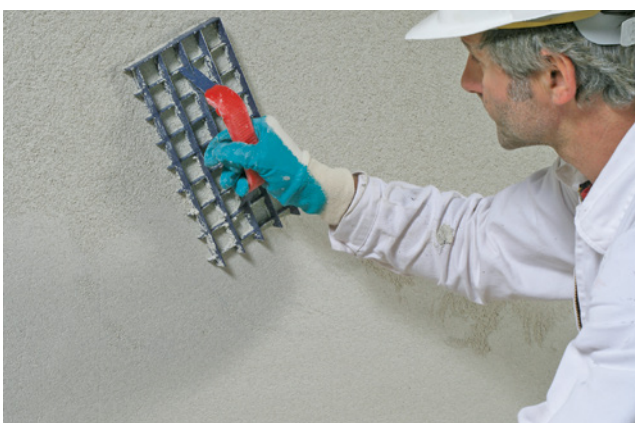
Bild 94 Sanierputz rapportieren (Bildquelle: Remmers Baustofftechnik, Löningen)
