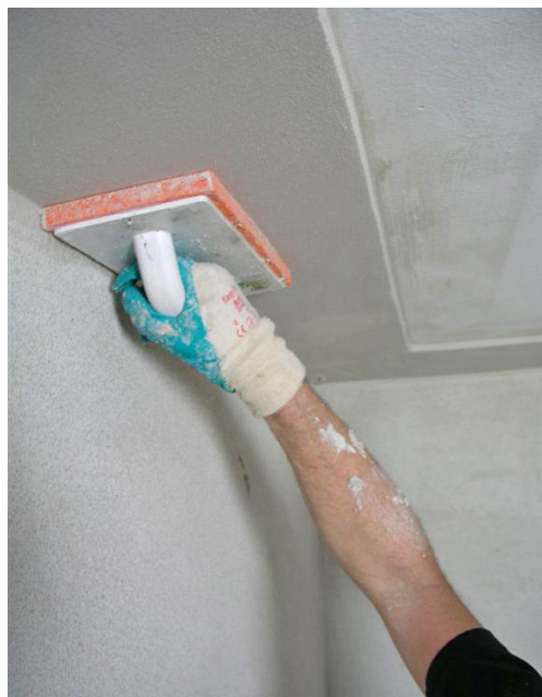
Bild 130 Anbringen und Verspachteln eines Dämmkeils an einbindender Betondecke (Bildquelle: Remmers GmbH, Lönningen)
