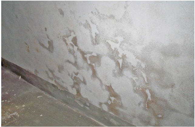
Bild 69 Durchfeuchtungs- schaden eines Baustellensperrputzes (Bildquelle: Gerhard Schlauch, Erkelenz)
