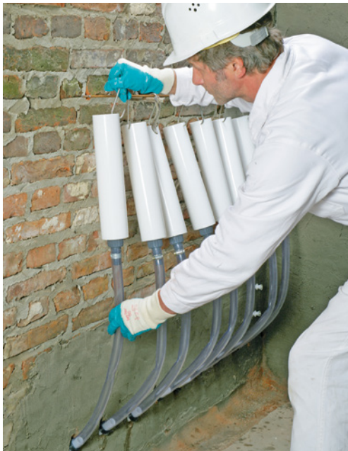
Bild 100 Drucklose Injektion mit Vorratsbehälter (Bildquelle: Remmers Baustofftechnik, Lönningen)
