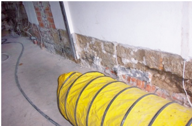
Bild 108 Eine hohe Luftumwälzung ist wichtig für die schnelle Trocknung von Oberflächen.
