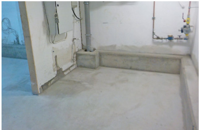
Bild 12 Fertigstellung eines Weißen Sockels mit verstärkter Bodenplatte (Bildquelle: Schleiff Bauflächentechnik GmbH & Co. KG, Erkelenz)
