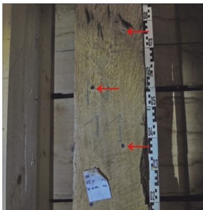
Abb. 31: Holzschutz am Eichensparren: Der Abstand der Packer ist zu groß; die Menge des vergällten Holzes zu klein.
