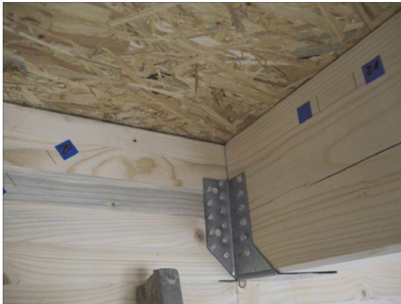
Abb. 13: nach der Sanierung augenscheinlicher, jedoch nicht innenraumluftherevanter Bläueschaden an Vollholzbalken
