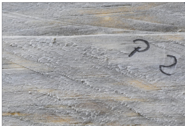
Abb. 10: beim Reinigen mit Pads ist die Faserrichtung zu beachten
