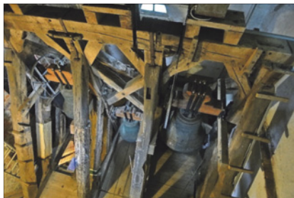
Abb. 41: Historischer Glockenstuhl mit Lebendbefall durch Gescheckten Nagekäfer an einigen Balken. Für die große Glocke wurde ca. 1955 am Glockenstuhl Aussparungen vorgenommen, hier wurden Fraßgänge angeschnitten (Pfeile).
