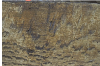
Abb. 3: Altes Eichenholz mit Bearbeitungsspuren durch ein Breitbeil.
