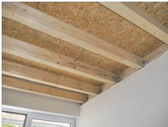
Abb. 8: Schimmelschaden infolge Neubaufeuchte, der sichtbare Schaden ist < als 0,5 m 2 , der tatsächliche Schimmelschaden ist gemäß [1] in die Kategorie 3 einzustufen
