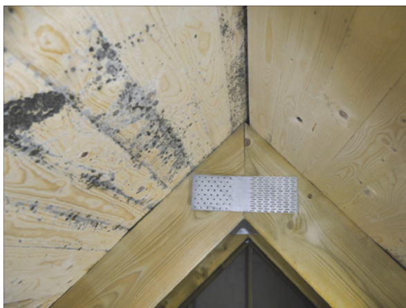
Abb. 2: durch Neubaufeuchte und fehlendes Feuchtemanagement auf der Baustelle verursachter Schimmelschaden
