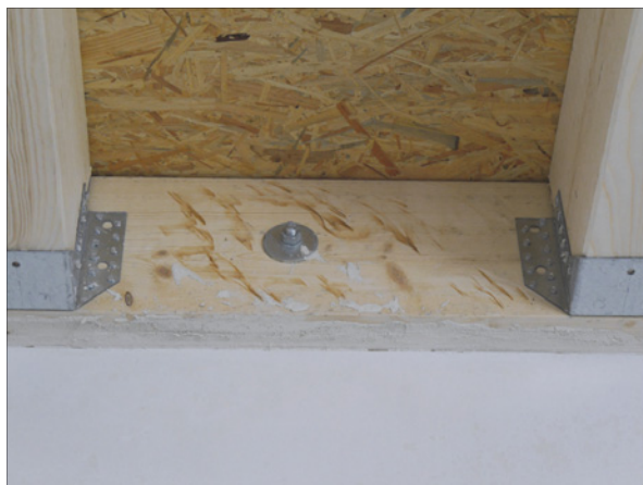
Abb. 9: durch den Einsatz einer ungeeigneten Sanierungsmethode durch eine Firma ohne Sachkunde wurden Oberflächen augenscheinlich nicht gereinigt und der Schimmelfall nachweislich nicht entfernt, an der Holzoberfläche sind optische Folgeschäden entstanden
