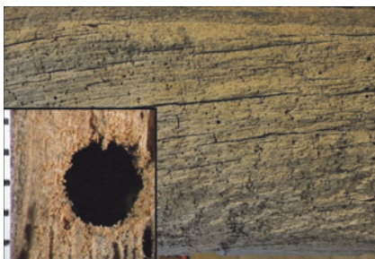
Abb. 8: Zugstrebe aus Eiche des historischen Dachstuhls mit einer oberflächlichen Fäule (mutmaßlich Moderfäule) aus einer Zeit mit massiven Dachschäden, zudem Schäden durch Gescheckten und Gewöhnlichen Nagekäfer; Eckbild: fast rundes Ausschlupfloch; Maßstab mit Millimetern.
