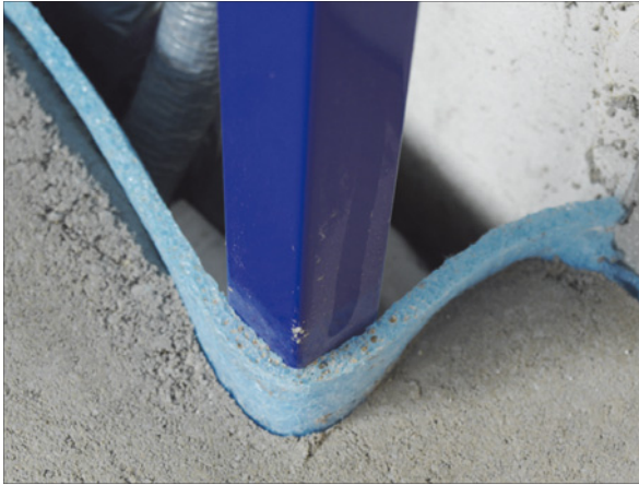
Abb. 14: Staubablagerung auf senkrechter Oberfläche, augenscheinlich ist die Feinreinigung nicht erfolgreich durchgeführt worden
