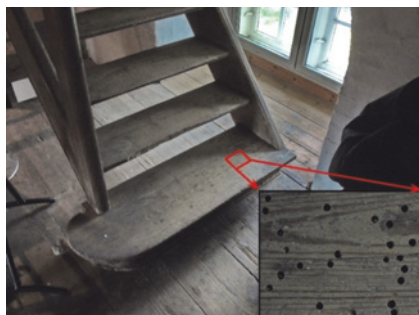
Abb. 20: Treppenaufgang mit einer Stufe aus Nadelholz, die einen Schaden durch den Gescheckten Nagekäfer aufweist. Eckbild: Detail der Ausschlupflöcher.
