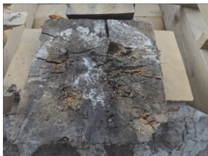
Abb. 29: Balkenkopf Nr. 9: Befall mit Echtem Hausschwamm mit sehr wenig Befall des Gescheckten Nagekäfers. Entfernung zum Moderfäule-Schaden von Abb. 30: wenige Meter.
