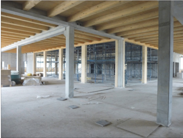
Abb. 3: Nunmehr in mehreren Bundesländern auch ohne Abweichung möglich: Unbekleideter Massivholzbau bis zur Gebäudeklasse 5
