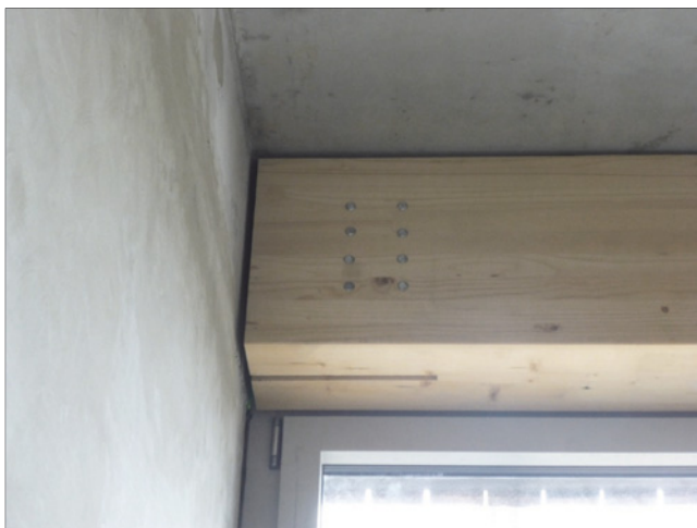
Abb. 9: Mischbauweise mit nichtbrennbarem notwendigen Treppenraum
