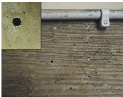
Abb. 21: Ausschlupflöcher des Gewöhnlichen Nagekäfers (kleine Löcher) und des Gescheckten Nagekäfers (große Löcher) nebeneinander. Nur der Gescheckte Nagekäfer ist bei Eichenholz auf einen Pilzbefall angewiesen, zumindest als junge Larve. Ob das auch für das gezeigte Nadelholz gilt, ist unklar.
