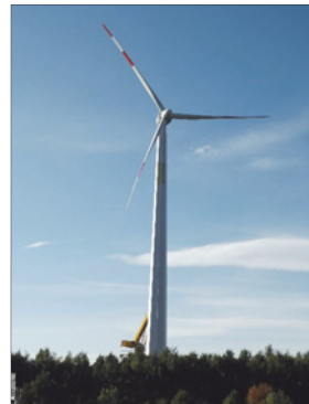
Abb. 23: Erste Windenergieanlage der Megawatt-Klasse mit Holzturm [13]
