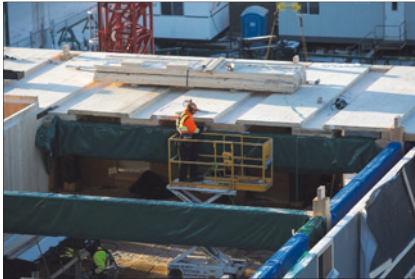
Abb. 26: Deckensystem mit Hohlräumen für Installationen [12]
