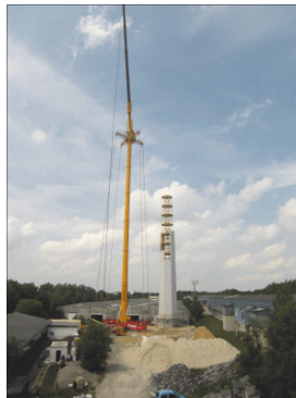
Abb. 22: Montage der Plattenelemente mit Fixierung am Lehrgerüst [13]
