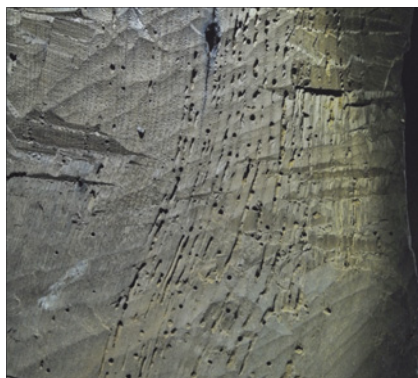
Abb. 12: Angeschnittene Fraßgänge belegen die Anwesenheit eines Schadens durch den Gescheckten Nagekäfer vor 1955 (Detail aus Abb. 41). In diesem Jahre wurden die Glocken nach dem Krieg wieder aufgehängt. Die Fraßgänge folgen den Jahrringen und sind meist im Frühholz.
