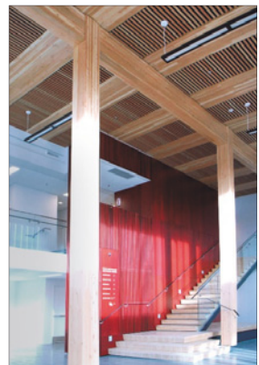
Abb. 30: Deckensystem mit installierter Technik und Holz-verbundung [12]
