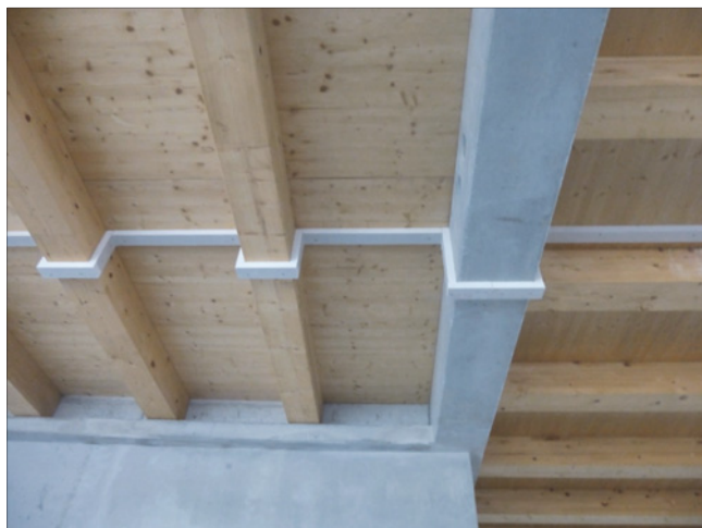
Abb. 12: Für den Einzelfall mit dem Hersteller abgestimmte Trockenbaubekleidung des Massivholzbauteils vor dem Anschluss einer klassifizierten Trockenbauwand
