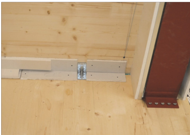
Abb. 7: Bekleidete Fugenausbildung massiver Holzbauteile
