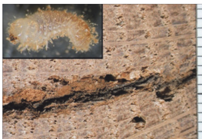
Abb. 23: Detail von Abb. 22: Fäule und Insektenbefall in den eingeschlossenen Holzrissen/-spalten: Jüngere Larven des Gescheckten Nagekäfers fressen in den stärker mit Moderfäulepilzen und Bakterien befallenen Bereichen; Millimeter-Skala; Eckbild: junge Larve, ca. 4 mm lang.
