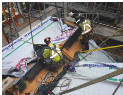
Abb. 20: Montage des Podests mit den herausstehenden HSK-Lochblechen [12]
