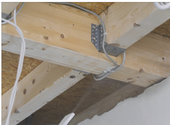
Abb. 12: Reinigung von Vollholz mittels Trockeneisstrahlens
