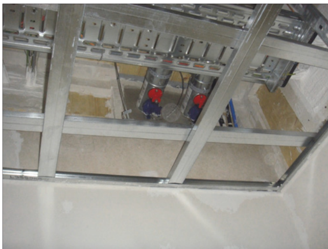
Abb. 15: Einbau von Absperrvorrichtungen, für die bereits eine Leistungserklärung als bauaufsichtlicher Anwendbarkeitsnachweis vorgelegt werden konnte
