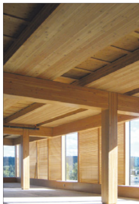
Abb. 29: Brettsperrholz-Decken-Paneele auf einem Skelett aus Brettschichtholz [12]
