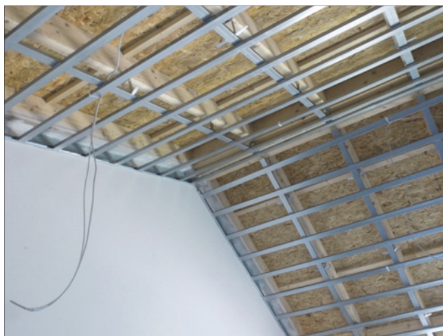
Abb. 13: Anschlusssituation für eine Trennwand zwischen zwei Nutzungseinheiten
