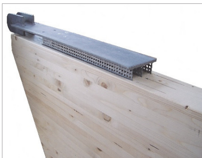
Abb. 6: Einsetzen des Stahlformteils auf der Zugseite
