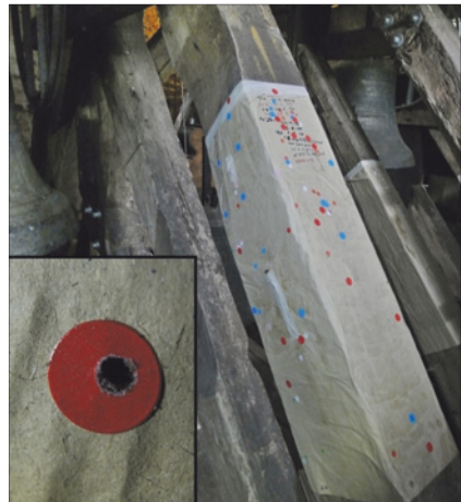
Abb. 39: Lebendbefall mit Geschecktem Nagekäfer: Insekten-Abklebungen des Monitorings an einem historischen Glockenstuhl mit viel Befall. Eckbild: Bei den Kontrollen werden Ausschlupflöcher geschlossen, aber zuweilen vom nächsten Käfer wieder durchfressen.
