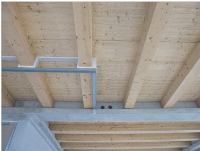
Abb. 16: Vorbereitete massive nichtbrennbare Konstruktion für die Durchdringungen
