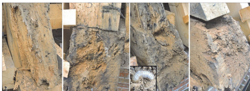
Abb. 10: Dach-Sanierung: Typische verdeckte Schadbilder mit Insekten- und Fäule-Schaden an Balkenköpfen und Sparrenfüßen (Nr. 2-5) auf der Nordseite (rund die Hälfte der Balkenköpfe zeigten massiven Schäden), nur wenige Balkenköpfe waren vollständig intakt; so z. B. der Sparrenfuß Nr. 1. Die verdeckten Fäule-Nester wurden erst mit der Dachöffnung sichtbar. Es ist unklar, wie weit sich die Larven in ihrer bisweilen über zehn Jahre dauernden Entwicklung die Sparren entlang hoch fressen können. Fäule-Schäden: Kellerschwamm, Moderfäulepilze mit Beteiligung des Gelben Porenschwammes/Braunfäuletramete ( Antrodia xantha (Fr.: Fr.) Ryv.); Eckbild: Larve aus dem Holz.
