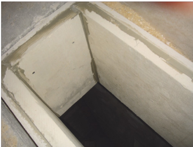
Abb. 14: Leibungsauskleidung vor dem Einbau eines Abschottungssystems mit Begründung einer Abweichung nach § 85a MBO
