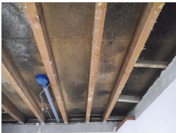
Abb. 3: Schimmelschaden der Kategorie 3 an einer Flachdachkonstruktion, Ursache: ungenügende Luftdichtheit führte zu erheblichen Schimmelschäden in der Nutzungsphase
