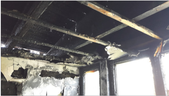
Abb. 6: Holz brennt berechenbar ab
