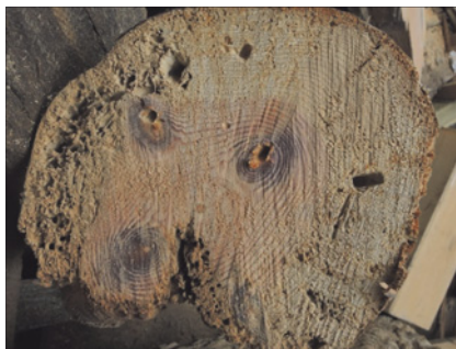
Abb. 28: Nadelholzbalken mit Braunfäule im Splint- und Kernholz: Nur die faulen Teile wurden vom Gescheckten Nagekäfer besiedelt.
