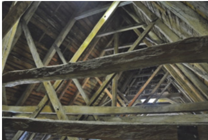
Abb. 2: Historischer Dachstuhl vor der Renovierung. Da das alte Tragwerk statisch nicht mehr ausreichte, wurde ein zweiter Dachstuhl in den bestehenden eingebaut.
