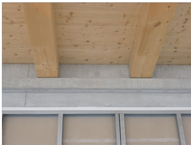
Abb. 11: Zulässiger Anschluss der klassifi- zierten Trockenbau- wand an ein nicht- brennbares Massivbauteil
