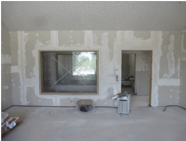
Abb. 4: Bekleidetes Holzrahmentragwerk
