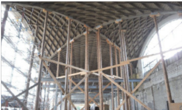
Abb. 1: abgestützte Partie des Zollingerdaches mit seiner typischen Rautenstruktur im alten Schlachthof von Regensburg (Bildquelle: Firma Bennert)
