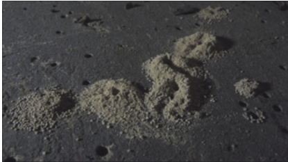
Abb. 16: Ausgeworfenes und z. T. zerwühltes Bohrmehl von Xestobium rufovillosum ; hochwahrscheinlich durch einen Prädator wie den Blauen Fellkäfer ( Korynetes caeruleus ). Prädatoren fressen lebende wie auch tote Larven bzw. Käfer im Holz, so dass ihr Auftreten nicht zwingend ein Beweis für einen Lebendbefall ist.
