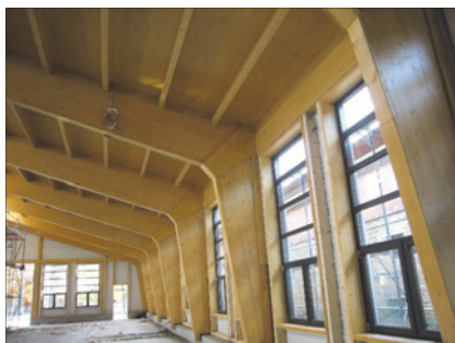
Abb. 10: Rahmenecke mit einer Feuerwiderstandsdauer von 30 Minuten [5]
