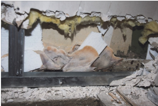
Abb. 2: Deutlich erkennbare Bewuchsgrenze vom Schwammmyzel am Dämmstoff
