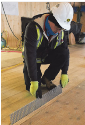
Abb. 28: Einschieben der Verbinder von der Oberseite [12]
