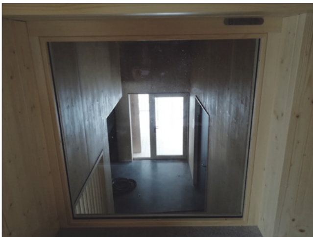
Abb. 18: Ohne Leinwandbekleidung eingesetzte Brandschutzverglasung
