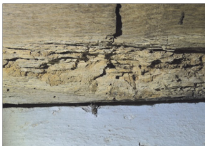
Abb. 25: Typischer Kombinationsschaden: Weißfäule-Erreger und Gescheckter Nagekäfer an einem Streichbalken aus Eiche.
