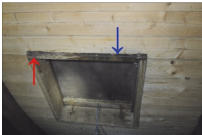
Abb. 40: Ungewöhnlicher Wassereintritt: Das Wasser tritt bei ungünstiger Windrichtung an den Schalungskanten am Lukenkasten auf der Innenseite aus (blauer Pfeil), wobei die Schalung kaum Wasserflecken zeigt. Die Hölzer des Lukenkastens zeigen oben schon kleine Fäule-Schäden (roter Pfeil).
