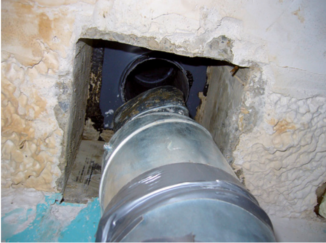
Bild 2.13: Pfusch des Lüftungsbauers: Die Rohre sind nicht sauber abgeschlossen.
