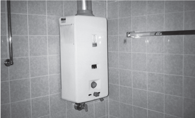
Abb. 20: Alter Durchlauferhitzer
