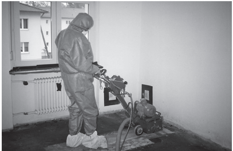
Abb. 25: Entfernung teerhaltiger Bodenschicht
