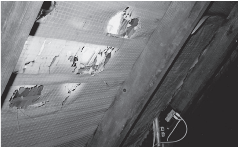
Abb. 15: Poröse Dachabdichtung
