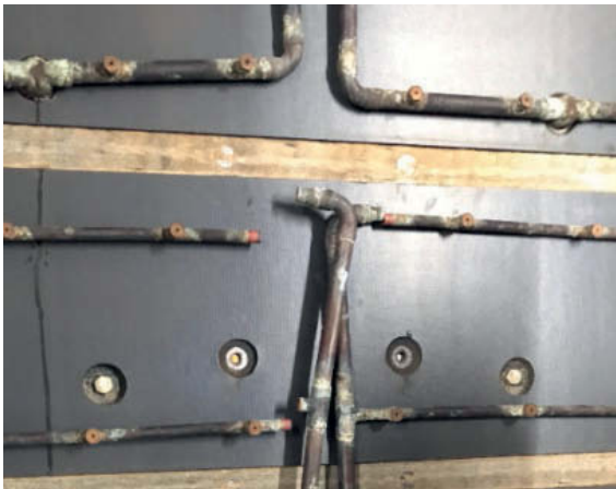
Bild 2: Defekte Lötstelle Sprühleitung > unkontrollierter Wasseraustritt
