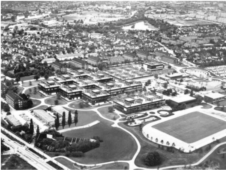
Abbildung 4: Hochschule der Bundeswehr Hamburg, Vogelperspektive auf das Universitätsgelände nach Bauabschluss, 1970er Jahre, Quelle: Heinle, Wischer und Partner: Hochschule der Bundeswehr Hamburg, Stuttgart 1977, S. 7.
