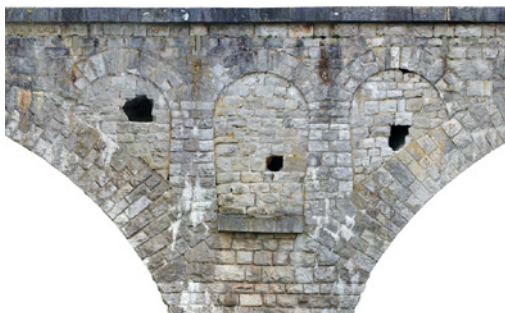
Bild 13 Auflagnaher Bereich der Ostbrücke (1889) mit Spargewölben [Messbildstelle Dresden]
