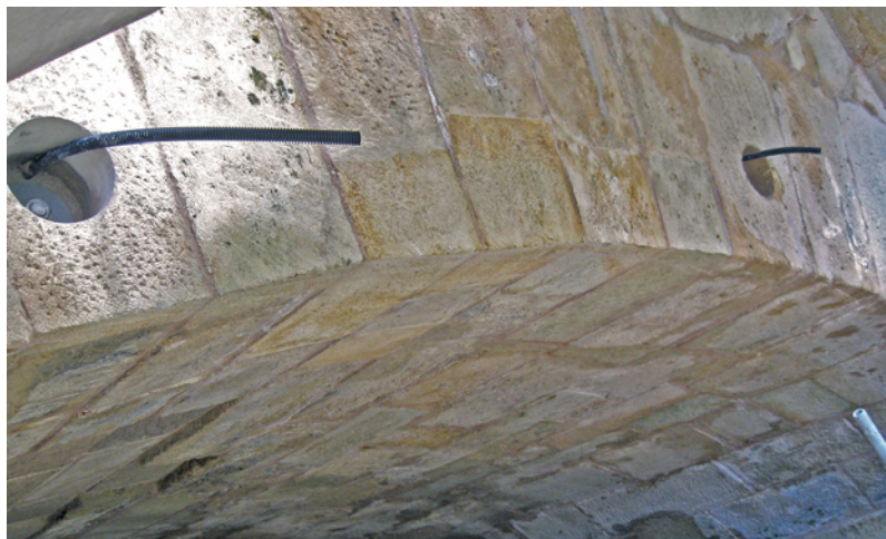
Bild 11 Ankerköpfe für Querverspannung vom Einbau der Vierungen als Bohrlochverschluss
