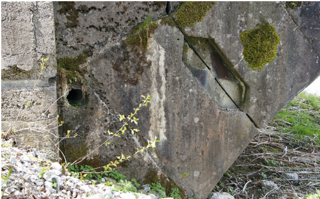
Bild 12 Aus Gussstahl hergestelltes Gelenk am Widerlager der Brücke Lautrach (Foto: Holzer 2012)
