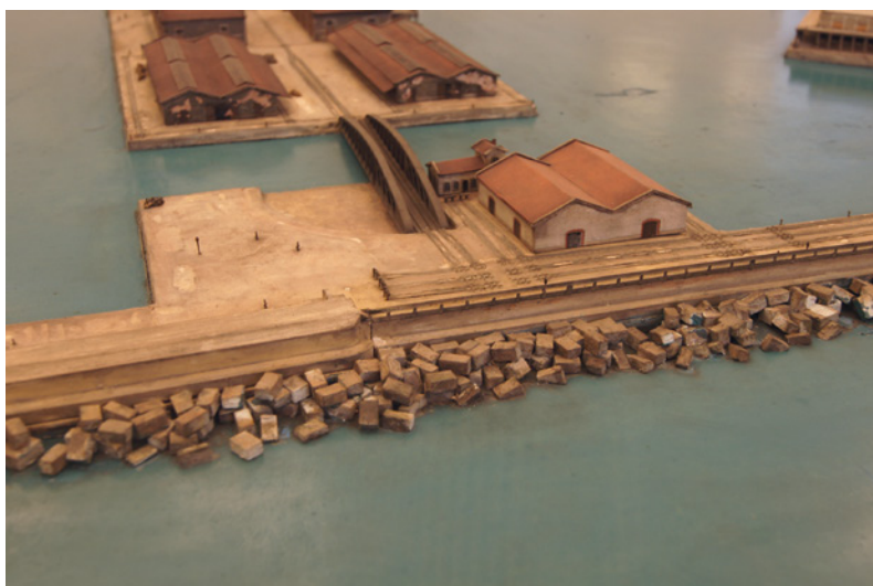
Bild 3 Wellenbrecher des Hafens von Marseille aus Betonblöcken (1855–61; zeitgenössisches Modell, heute im Conservatoire des Arts et Métiers, Paris. (Foto: Holzer 2014)
