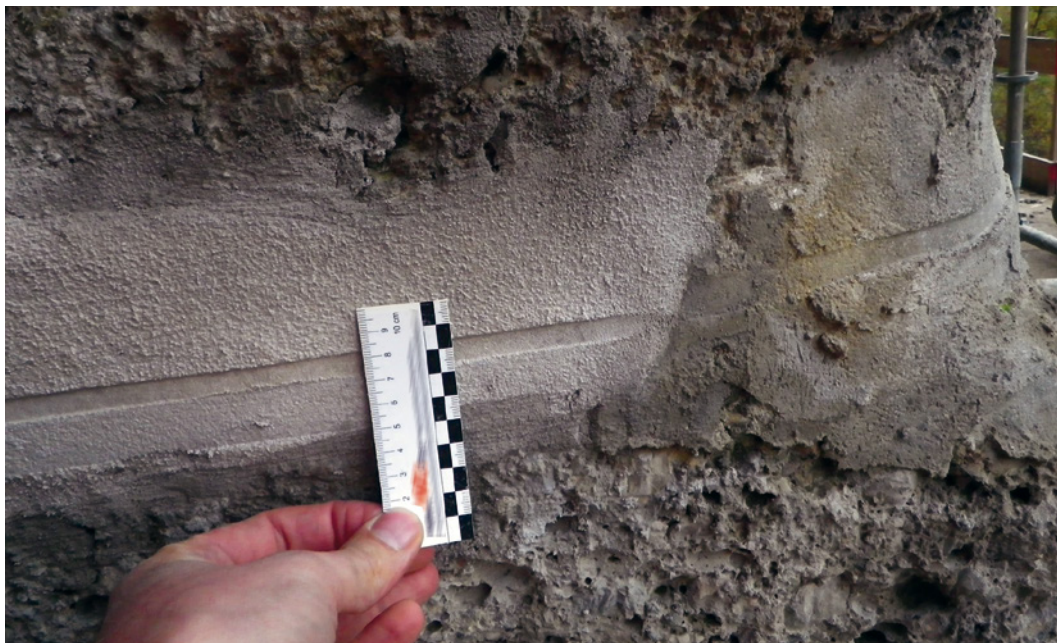
Bild 4 Detail ausgeführte Fugeninstandsetzung, an den Bestand angrenzend
