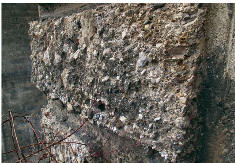
Bild 3 Ansicht Natursteinquader des rustizierten Gewölb- bogens mit Verwitterungs- schäden, 2012
