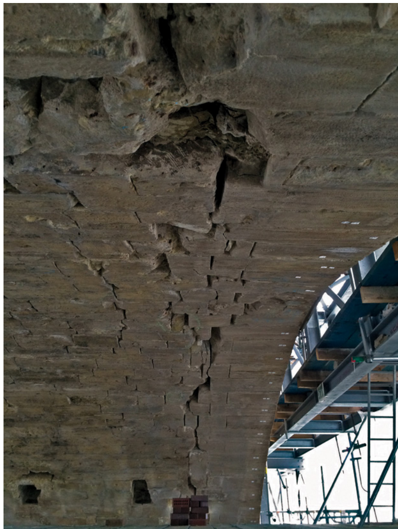
Bild 6 Abreißen des Schildbogens vom Gewölbe
