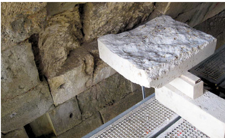
Bild 13 »Krone« aus Kalkstein vor Einbau (aus Block mittels 3D-Scan gefräst)
