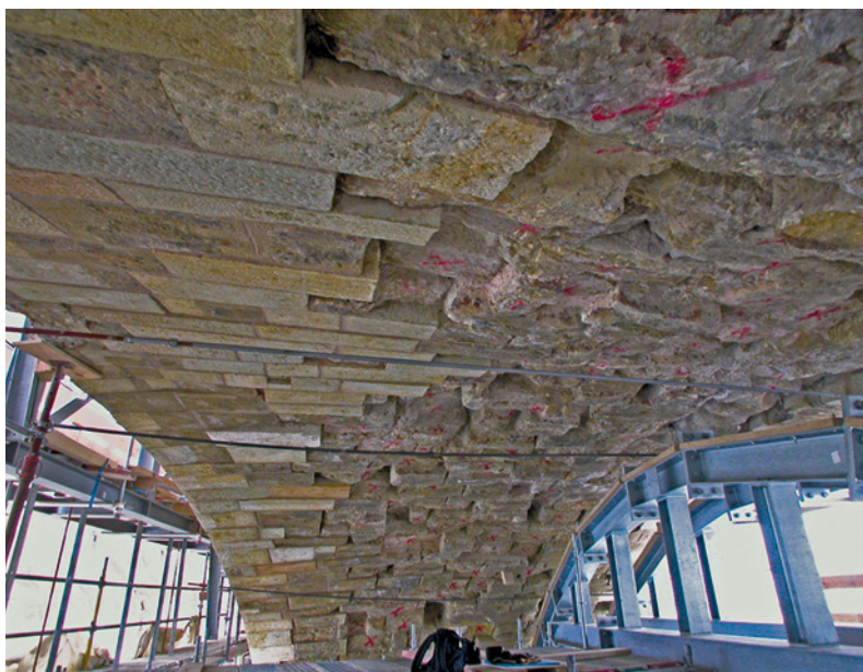
Bild 7 Baubehelf: Bogenunterstützung aus Stahl
