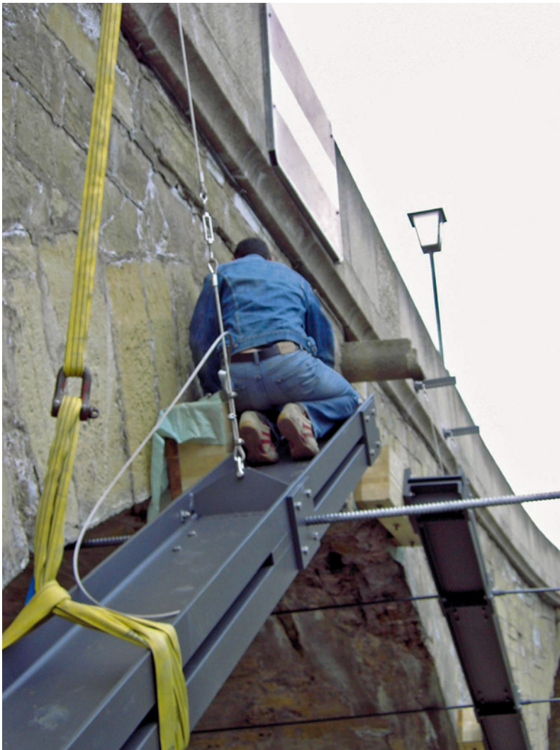
Bild 2 Einbau der Notsicherungen (Querverspannungen) am Bogen XII, 2005
