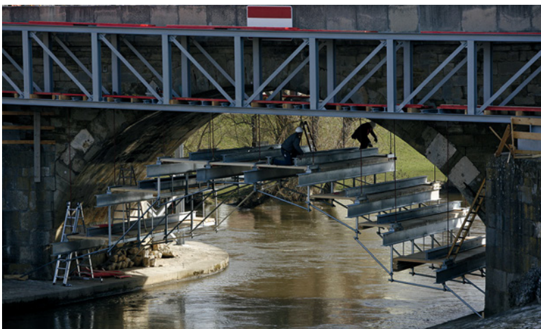
Bild 17 Montage der Hängegerüste an Gerüstfachwerkträgern
