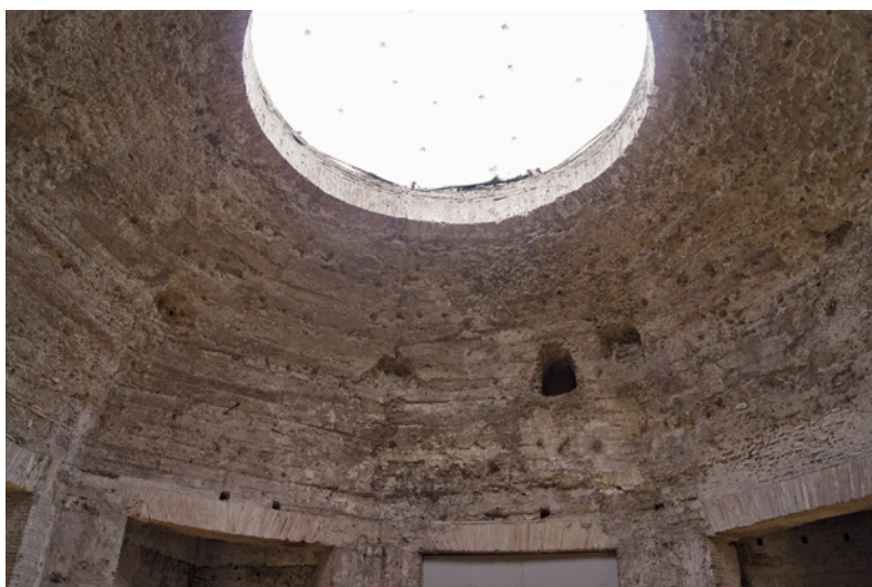
Bild 1 Das Klostergewölbe der Aula Ottagona der Domus Aurea des Nero in Rom – frühes Meisterwerk der altrömischen Opus-Caementicium-Bauweise. Deutlich sind die Schalbrettabdrücke zu erkennen. (Foto: Holzer 2015)
