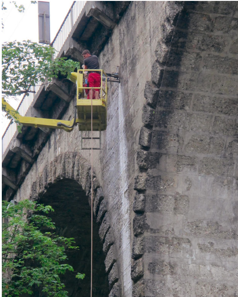
Bild 2 Durchführung der Bohrkernentnahme vom Hubsteiger, 2013
