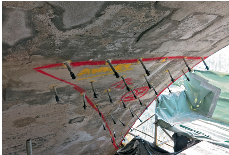
Bild 4 Es erfolgten gezielte Injektionen der mit Radar auskartierten inhomogenen Bereiche.
