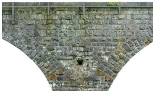
Bild 14 Auflagnaher Bereich der Westbrücke (1907) ohne Spargewölbe [Messbildstelle Dresden]
