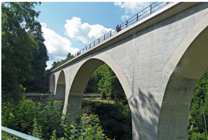
Bild 4 Laufenmühlviadukt an der Strecke Welzheim-Schorn- dorf. Nach der Sanierung ist der Dreigelenkbogen etwas deutlicher hervor- gehoben.
