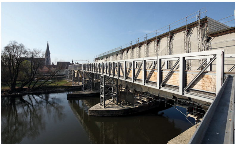
Bild 16 Behelfssteg vor dem eingehausten Bauabschnitt
