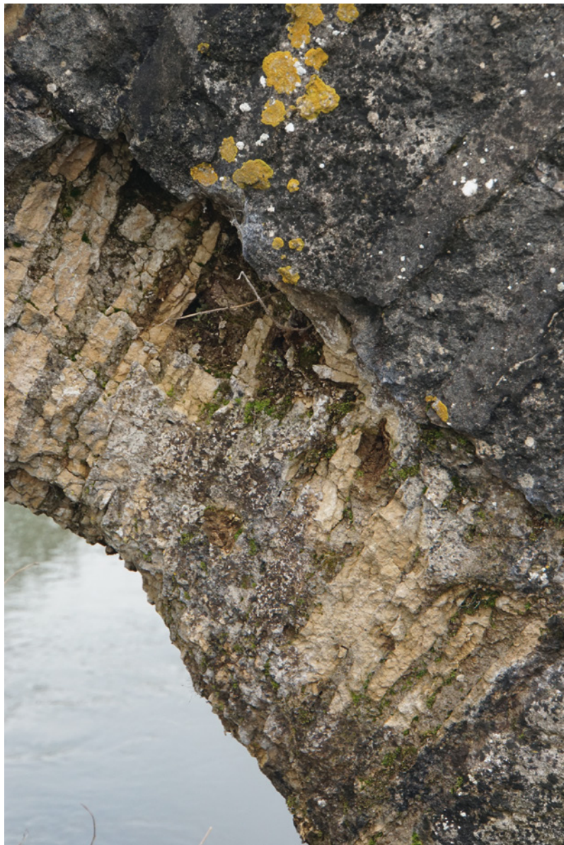
Bild 6 Radiale Anordnung der Bruchsteinplatten am Bogen der Brücke Éguilly (Lacordaire 1829; Foto: Holzer 2018)
