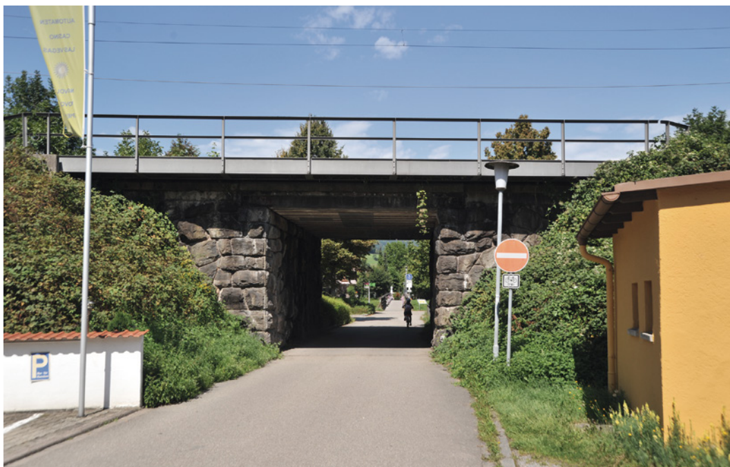
Bild 1 WiB-Brücke der Schwarzwaldbahn über die Gartenstraße in Hausach
